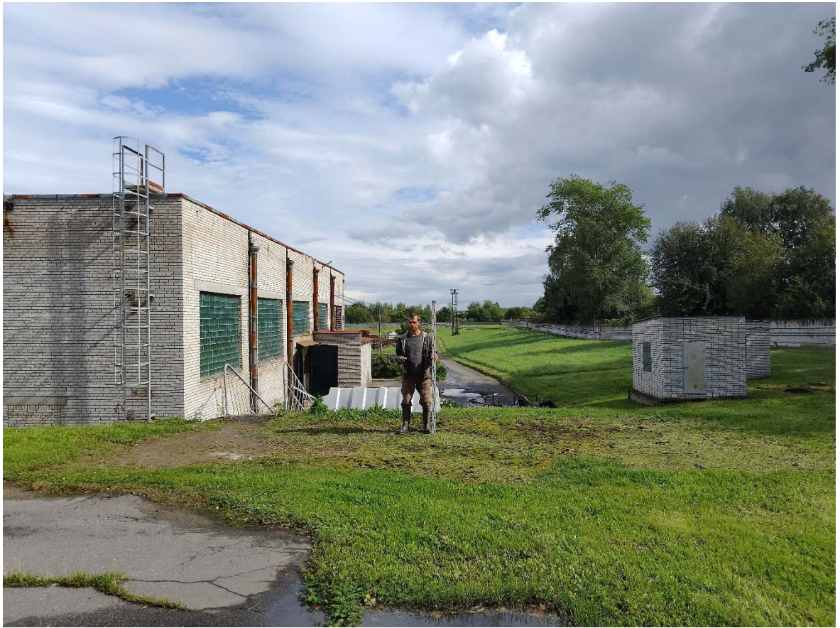
Рис. 26. СПб-2025. Тярлево, Фильтровское ш., д. 7. Точка фотофиксации 5, вид с запада.
