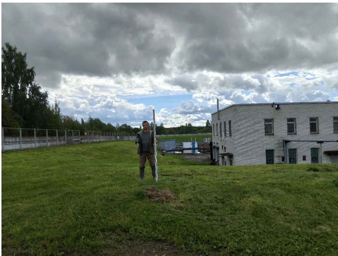
Рис. 21. СПб-2025. Тярлево, Фильтровское ш., д. 7. Точка фотофиксации 2, вид с севера.
