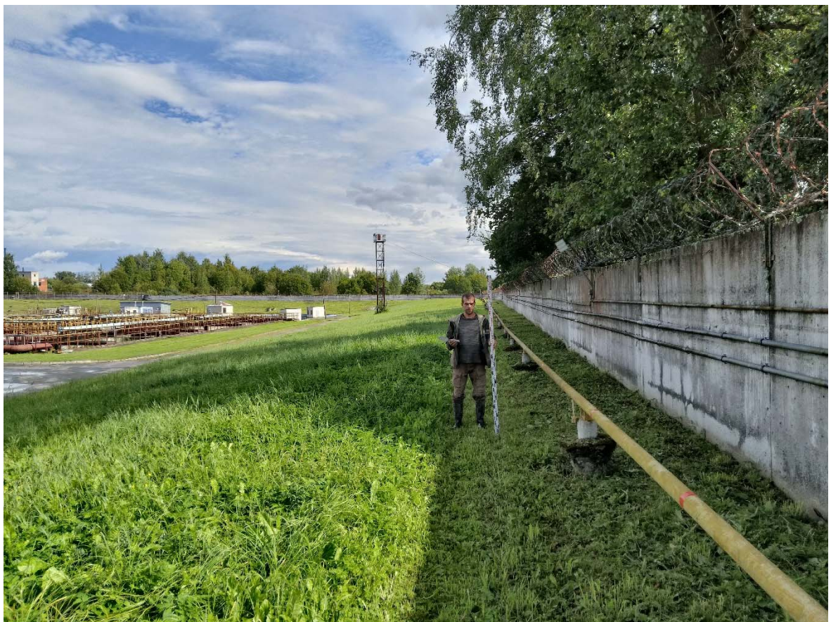
Рис. 25. СПб-2025. Тярлево, Фильтровское ш., д. 7. Точка фотофиксации 4, вид с запада.
