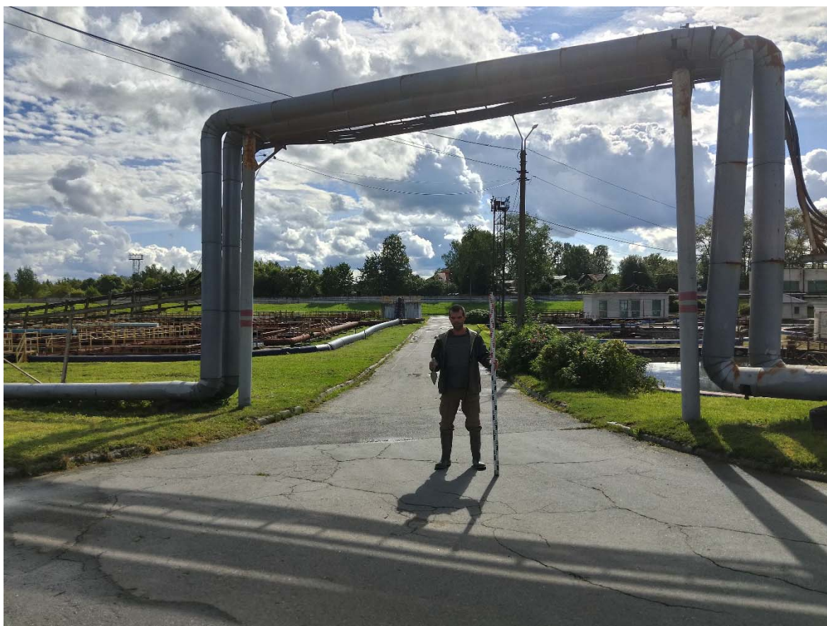
Рис. 41. СПб-2025. Тярлево, Филътровское ш., д. 7. Точка фотофиксации 8, вид с севера.
