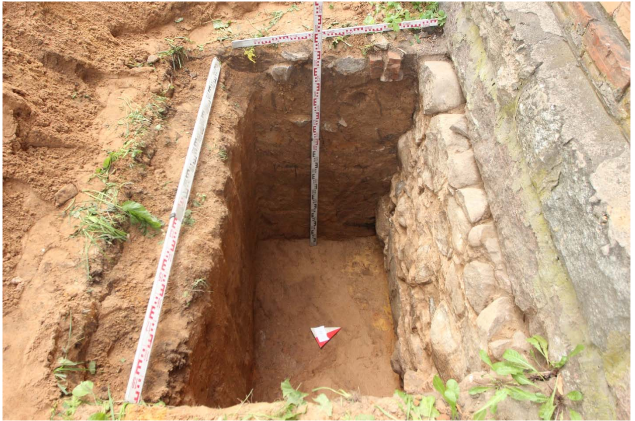
Рис. 63. СПб-2025. Тярлево, Фильтровское ш., д. 7. Шурф 3, фиксация по уровню окончания работ. Южная стенка.
