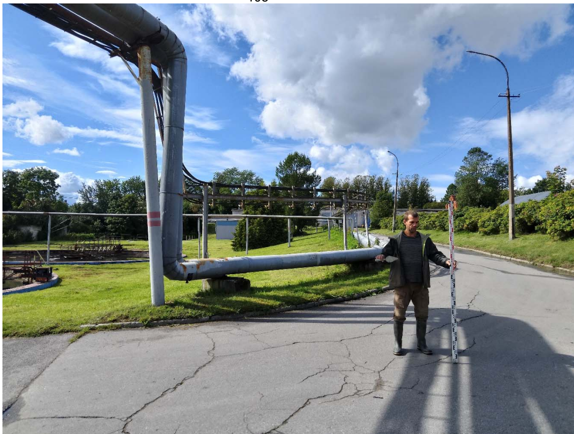
Рис. 40. СПб-2025. Тярлево, Филътровское ш., д. 7. Точка фотофиксации 8, вид с востока.
