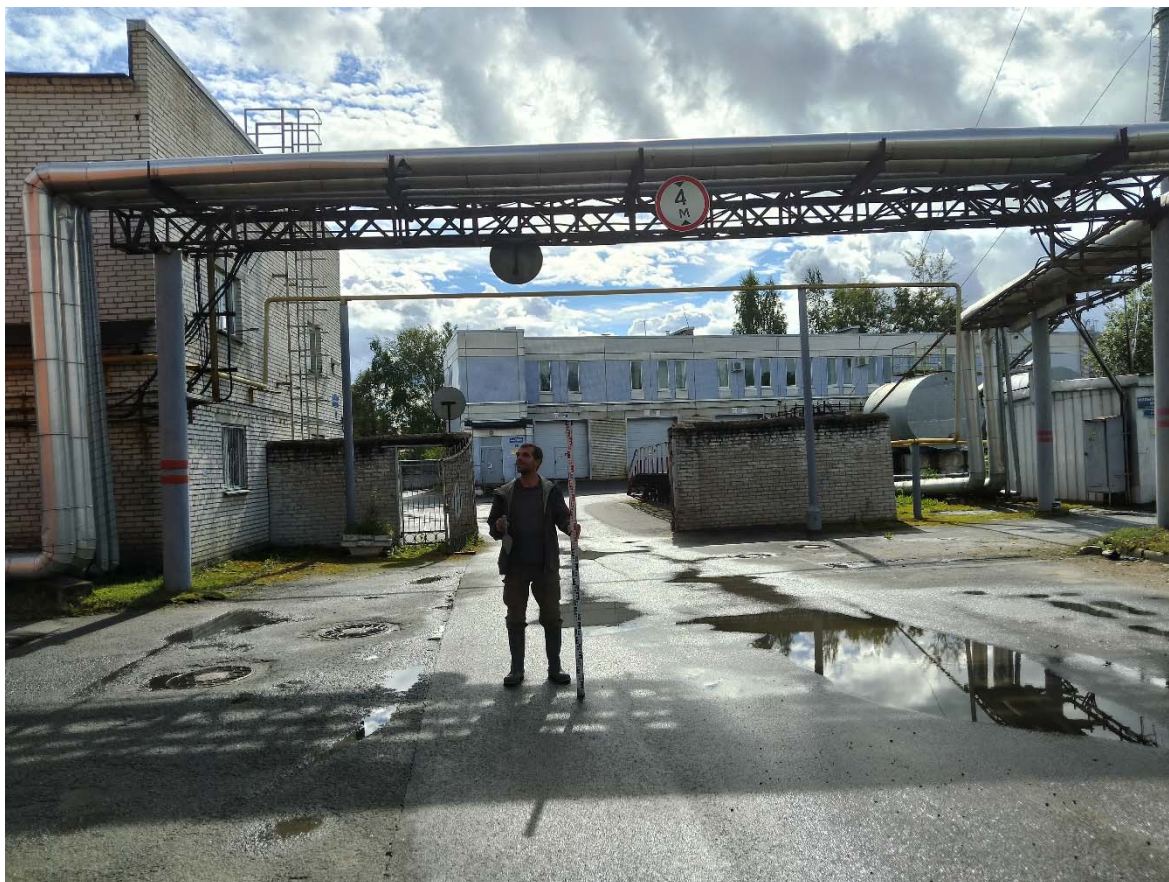
Рис. 33. СПб-2025. Тярлево, Фильтровское ш., д. 7. Точка фотофиксации 6, вид с севера.
