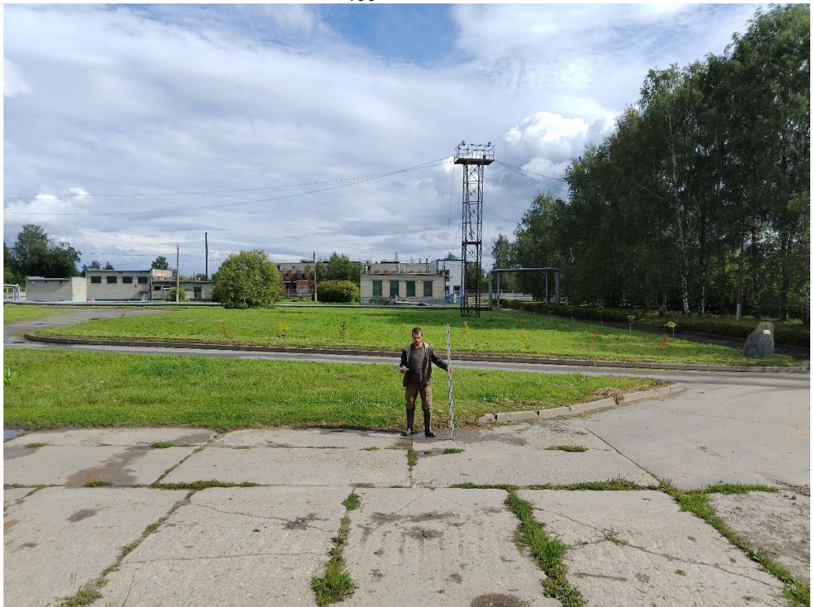
Рис. 42. СПБ-2025. Тярлево, Фильтровское ш., д. 7. Точка фотофиксации 9, вид с запада.
