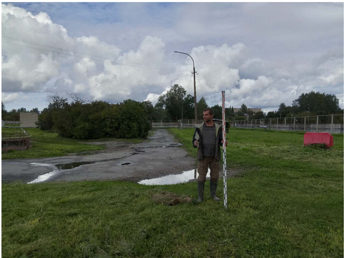
Рис. 19. СПб-2025. Тярлево, Филътровское ш., д. 7. Точка фотофиксации 2, вид с юга.
