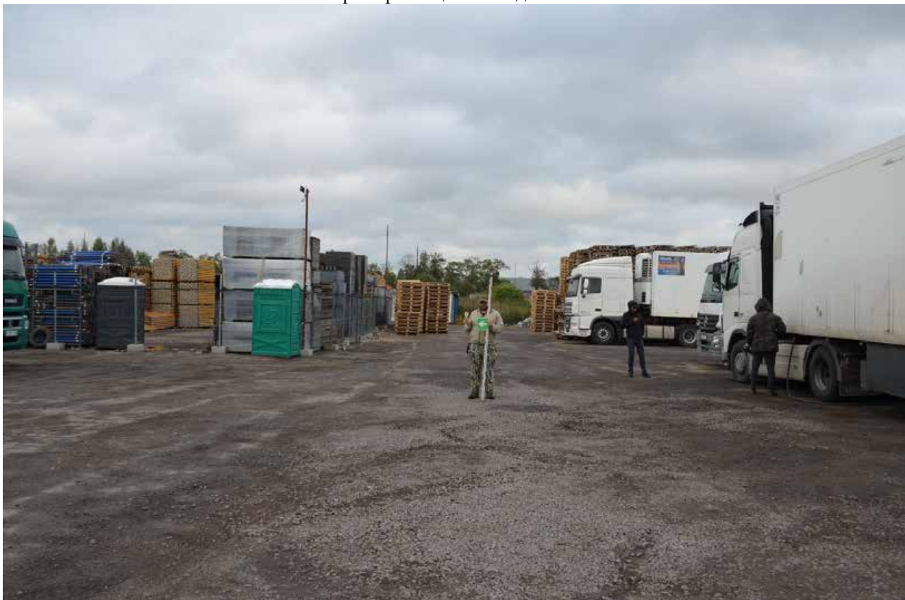
Рис. 23. Санкт-Петербург, пос. Шушары, Московское ш., участок 1327, (юго-восточнее дома 54, литера А по Московскому шоссе), земельный участок с кадастровым номером: 78:42:0015108:2266. Точка фотофиксации 2. Вид с 3.
