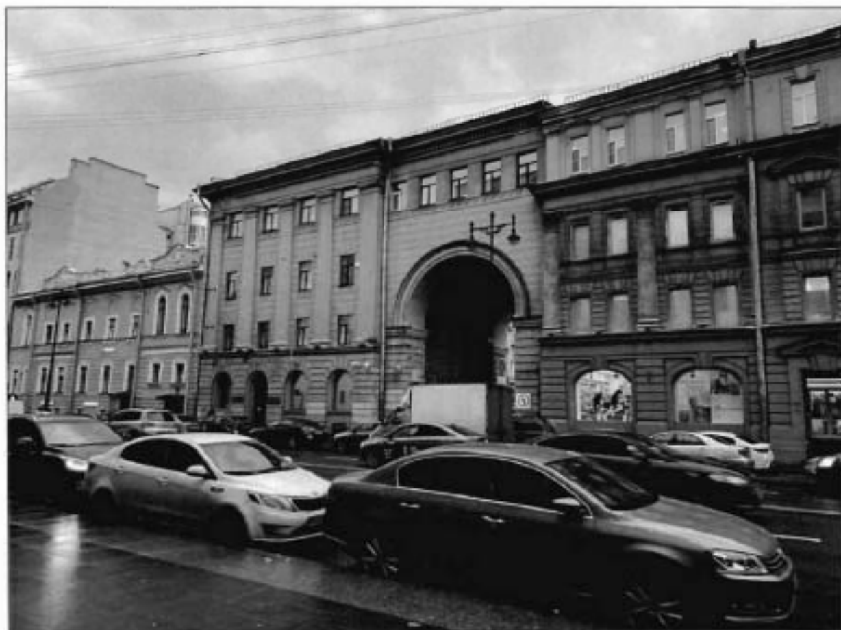
1. Западный лицевой фасад части объекта культурного наследия.
