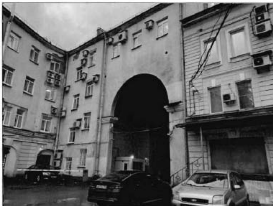
7. Восточный дворовой фасад части объекта культурного наследия.
