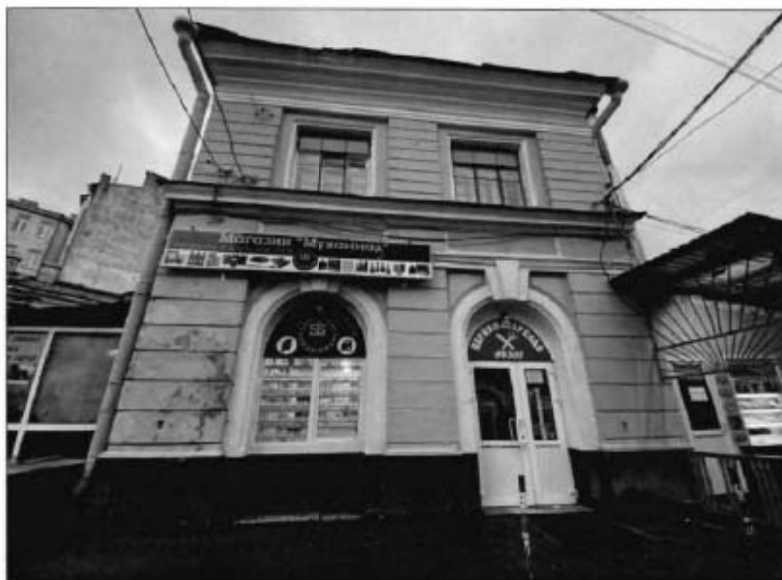
12. Северный фасад части объекта культурного наследия.
