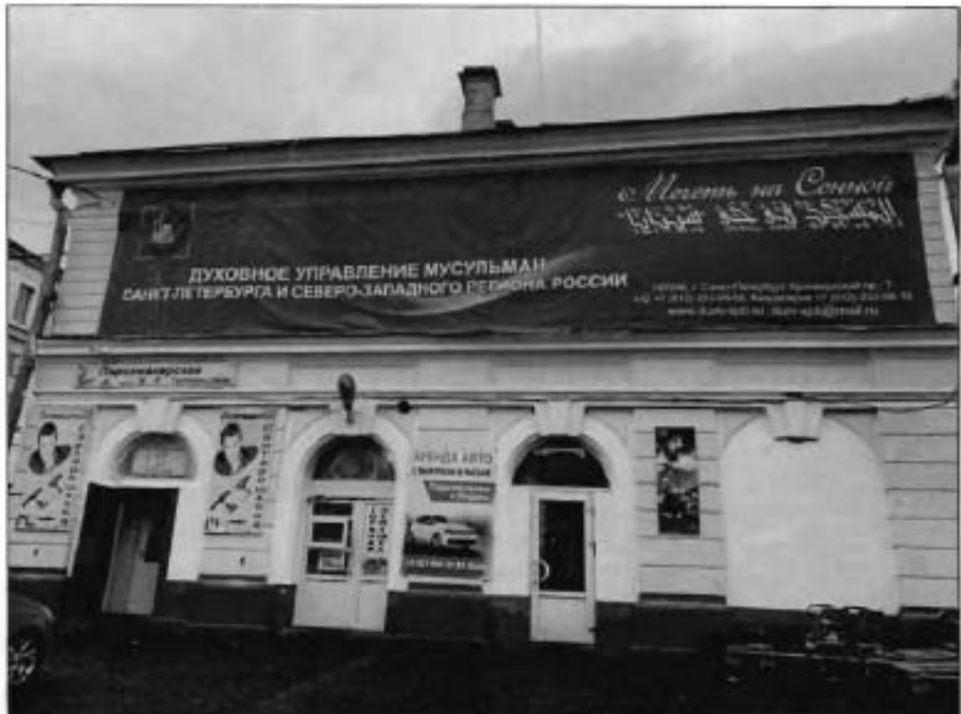
10. Южный фасад части объекта культурного наследия.
