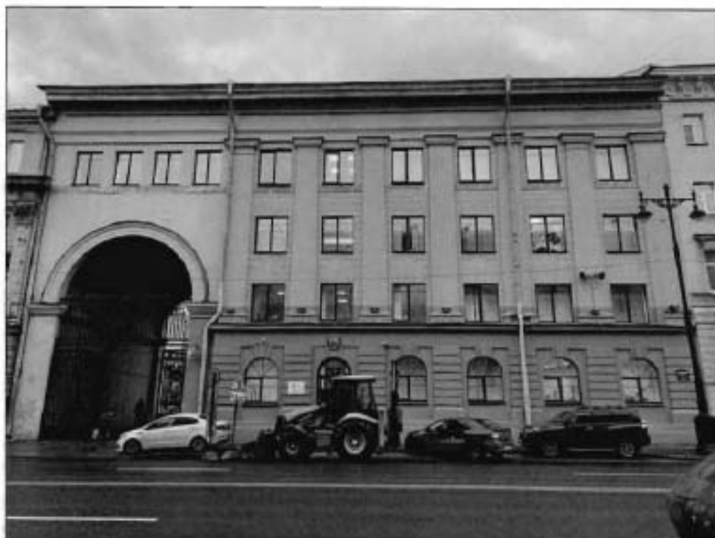
6. Западный лицевой фасад части объекта культурного наследия.
