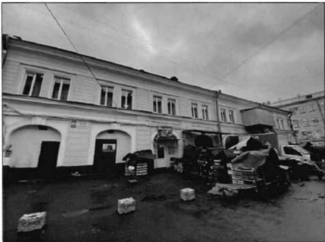
11. Фрагмент восточного фасада части объекта культурного наследия.
