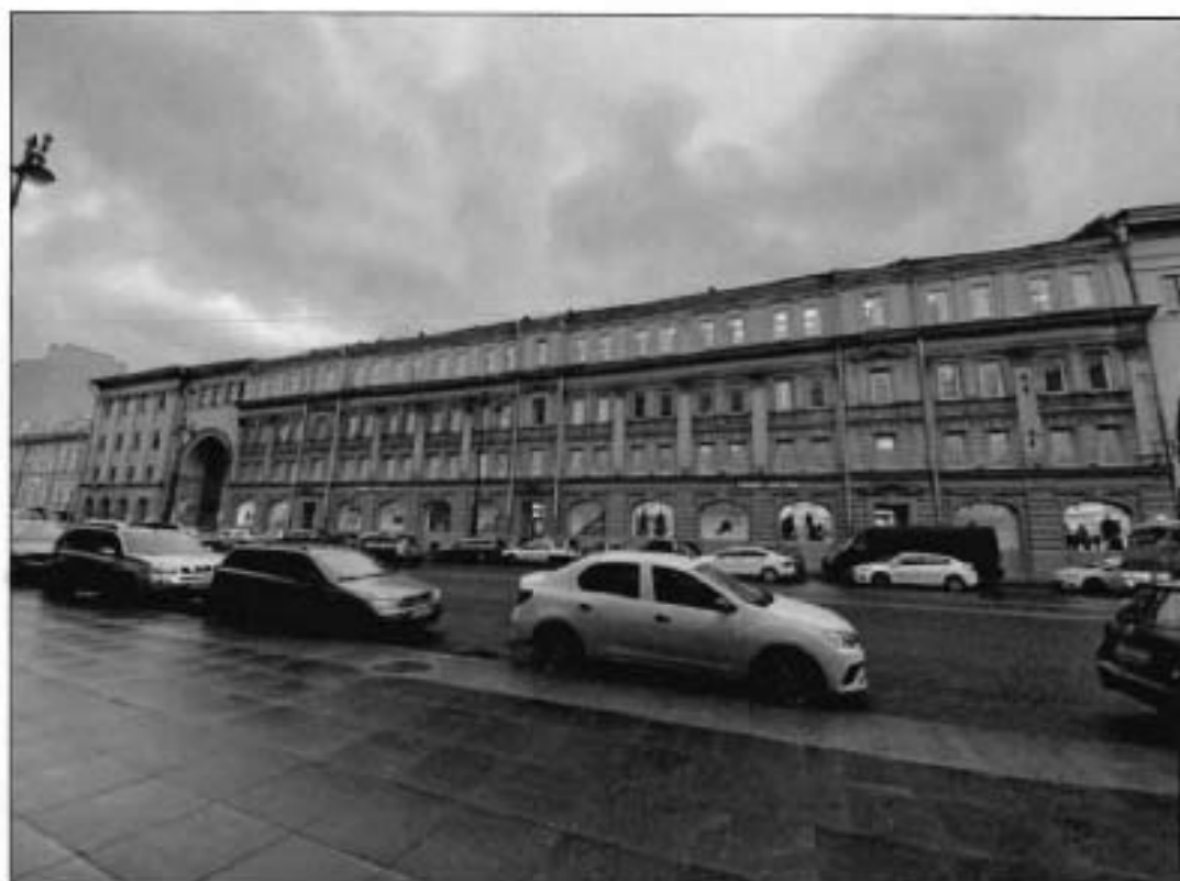
4. Западный лицевой фасад части объекта культурного наследия.
