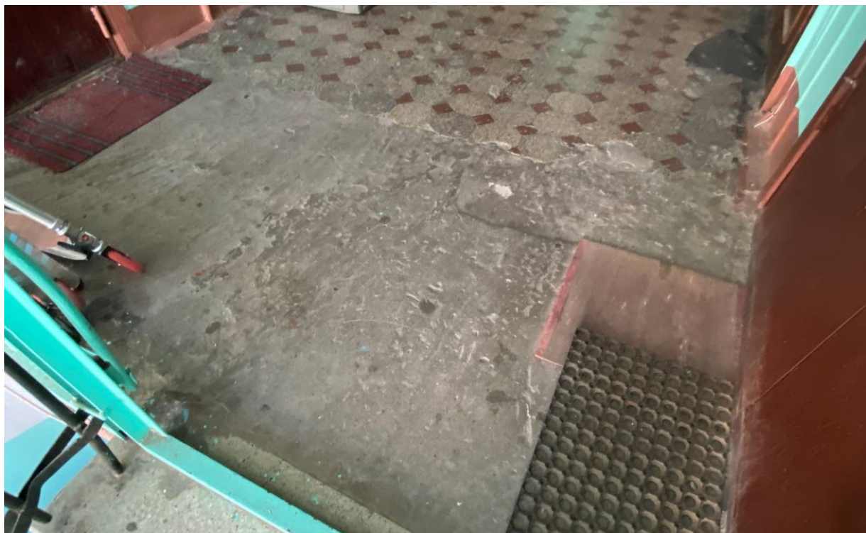
64. Поперечный дворовый флгель. Парадная лестница ЗЛК. Последствия попадания авиабомбы. Бетонная заливка части площадки 5 этажа.
