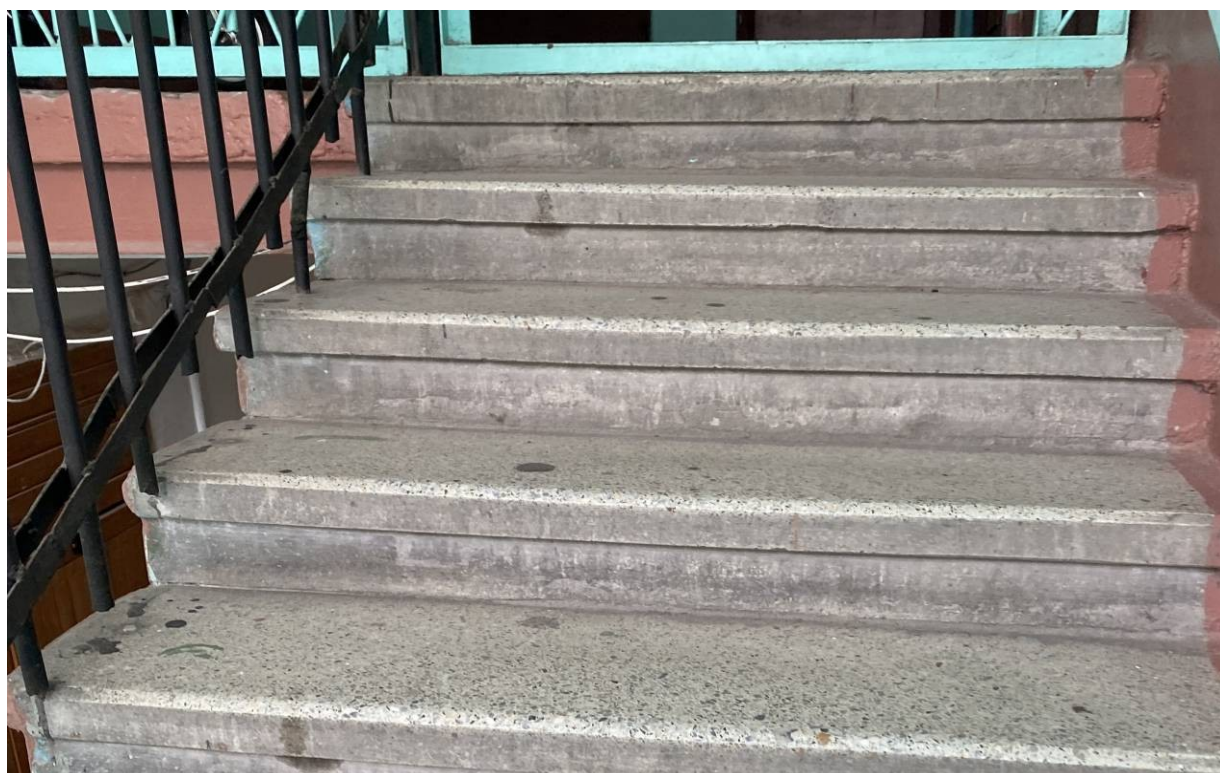
65. Поперечный дворовый флгель. Парадная лестница ЗЛК. Последствия попадания авиабомбы. Бетонные ступени перед площадкой 5 этажа.
