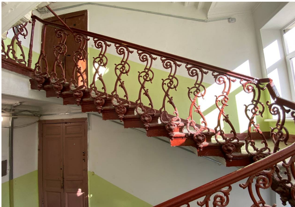
25. Лицевой дом. Парадная лестница 1ЛК. Ограждение.
