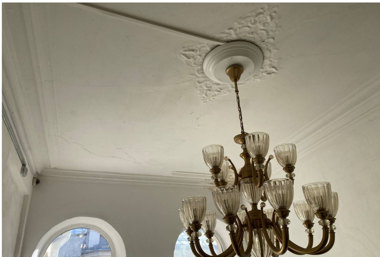
28. Лицевой дом. Парадная лестница 1ЛК. Оформление перекрытия.
