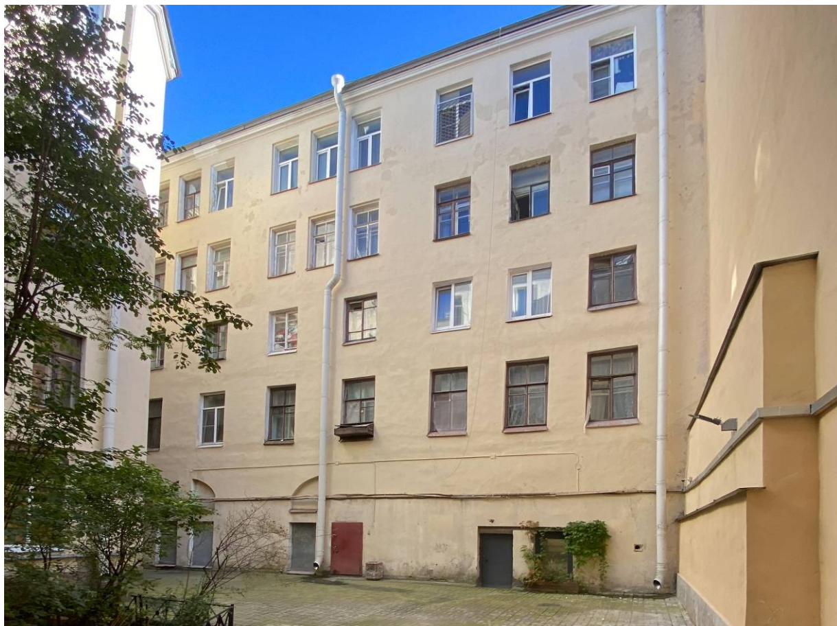
46. Юго-восточный двор. Восточный дворовый флигель. Фасад.
