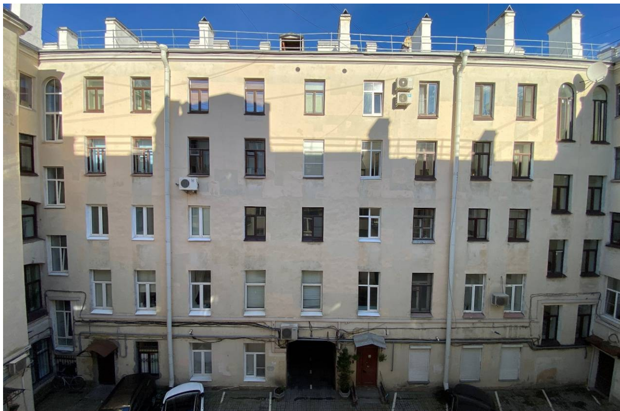
22. Лицевой дом. Дворовый (южный) фасад.
