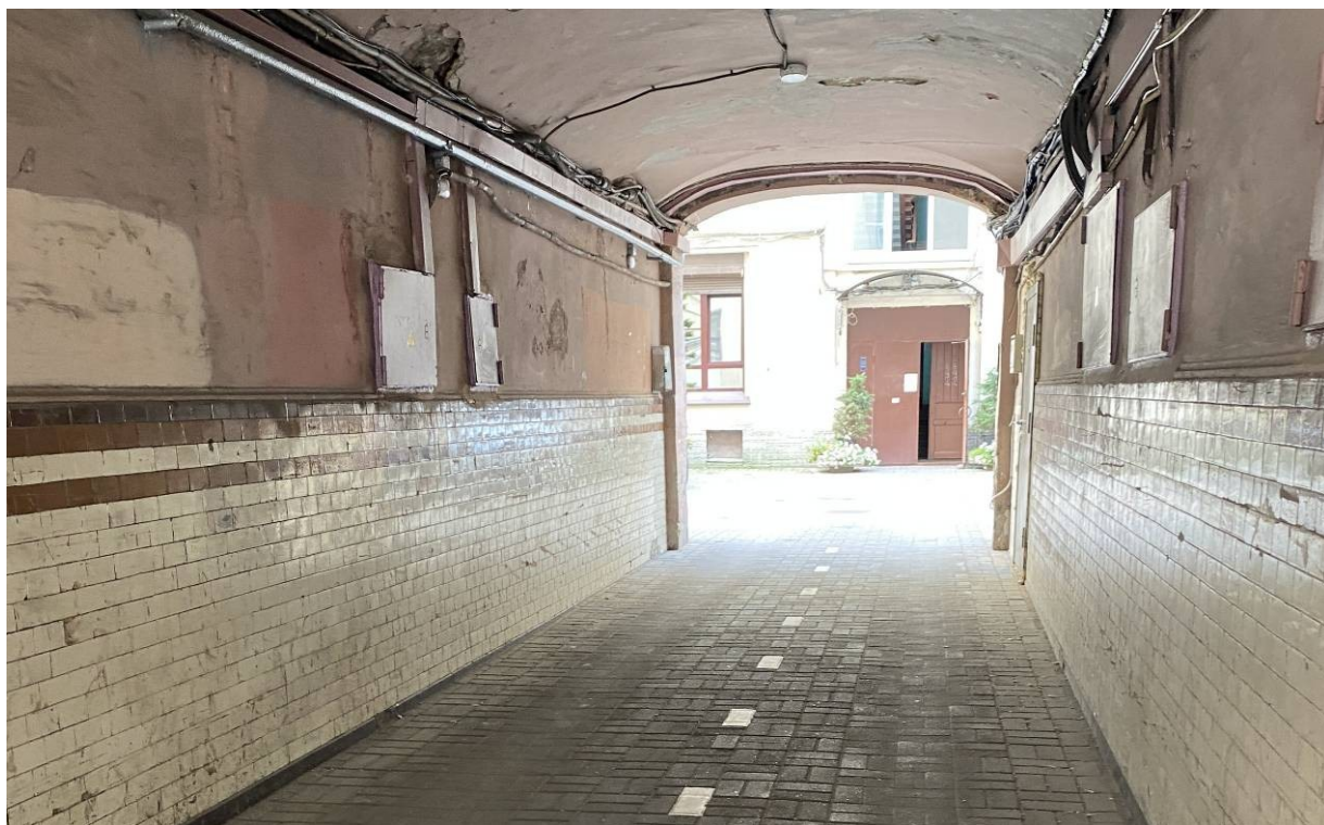
21. Воротный проезд. Вид в сторону северного двора.
