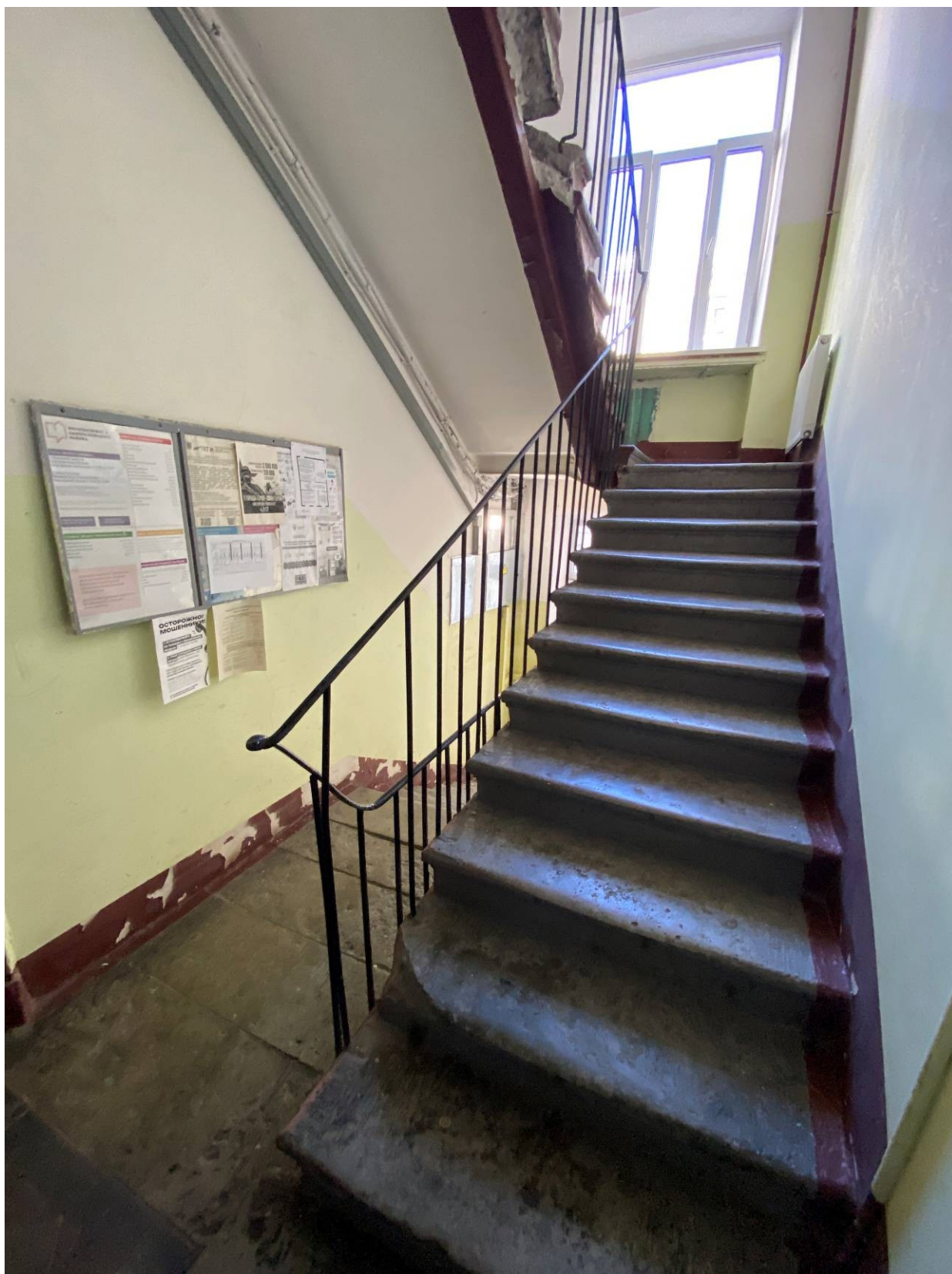
40. Западный дворовый флигель. «Черная» лестница 5ЛК. Марши.
