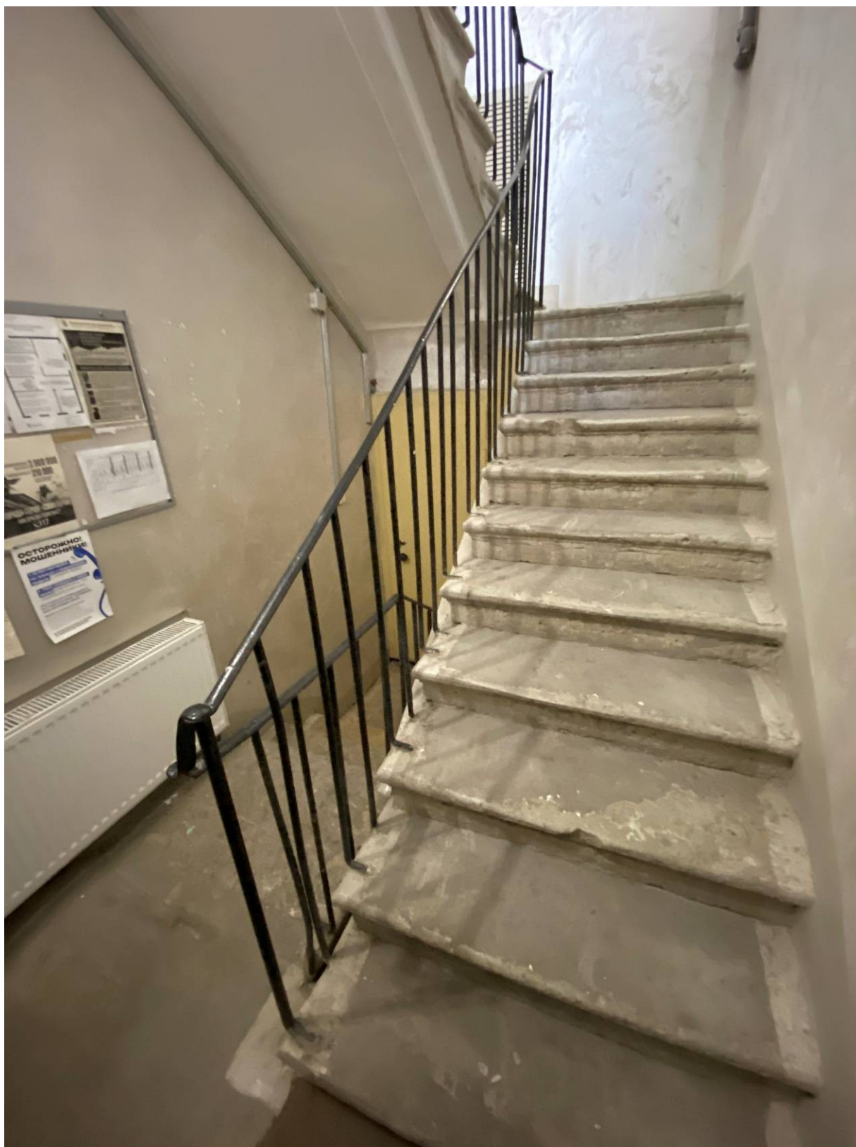
35. Лицевой дом. «Черная» лестница 4ЛК. Первый марш.
