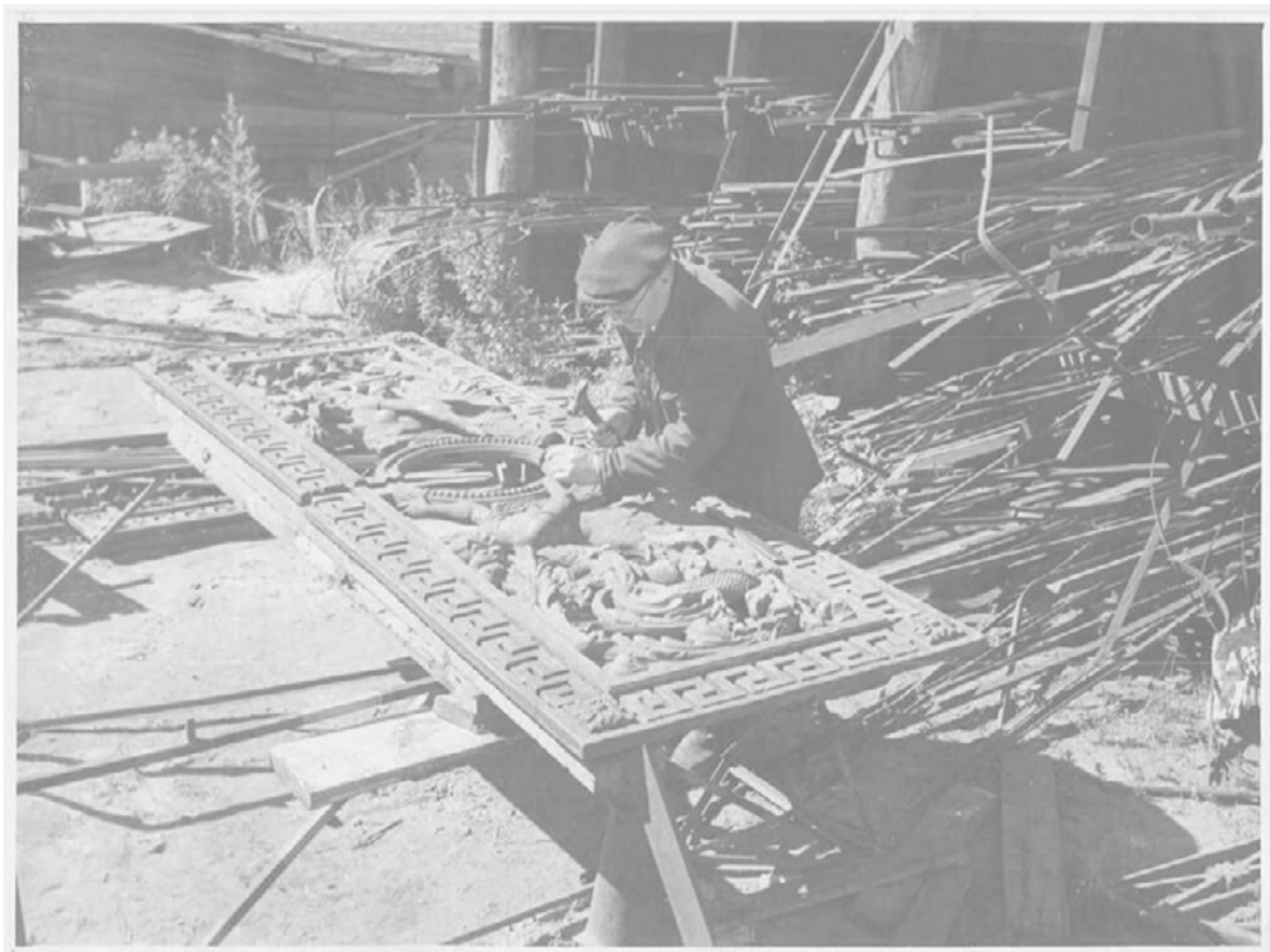
51. Литейный мост. Сборка чугунной решетки. Фотография СПб ГБУ «Мостотрест». Источник: https://www.prilib.ru/item/1166017
