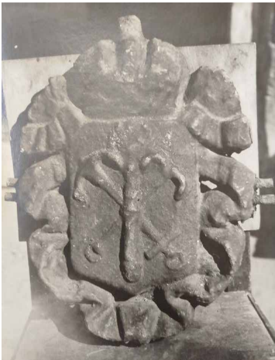
40. Деталь решетки Литейного моста (герб) до расчистки от масляных окрасок. 1966 ЦГАНТД СПб. Ф. 488. Оп. 319. Д. 87.
