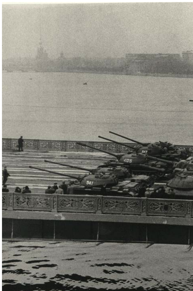
55. Испытания под нагрузкой заново построенного Литейного моста.
