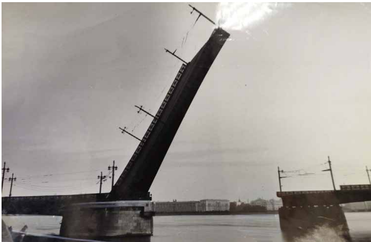
57. Разводной пролет Литейного моста после реконструкции 1966-1967 гг. СПб ГБУ «Мостотрест». Папка № 100. Литейный мост. Фотографии.
