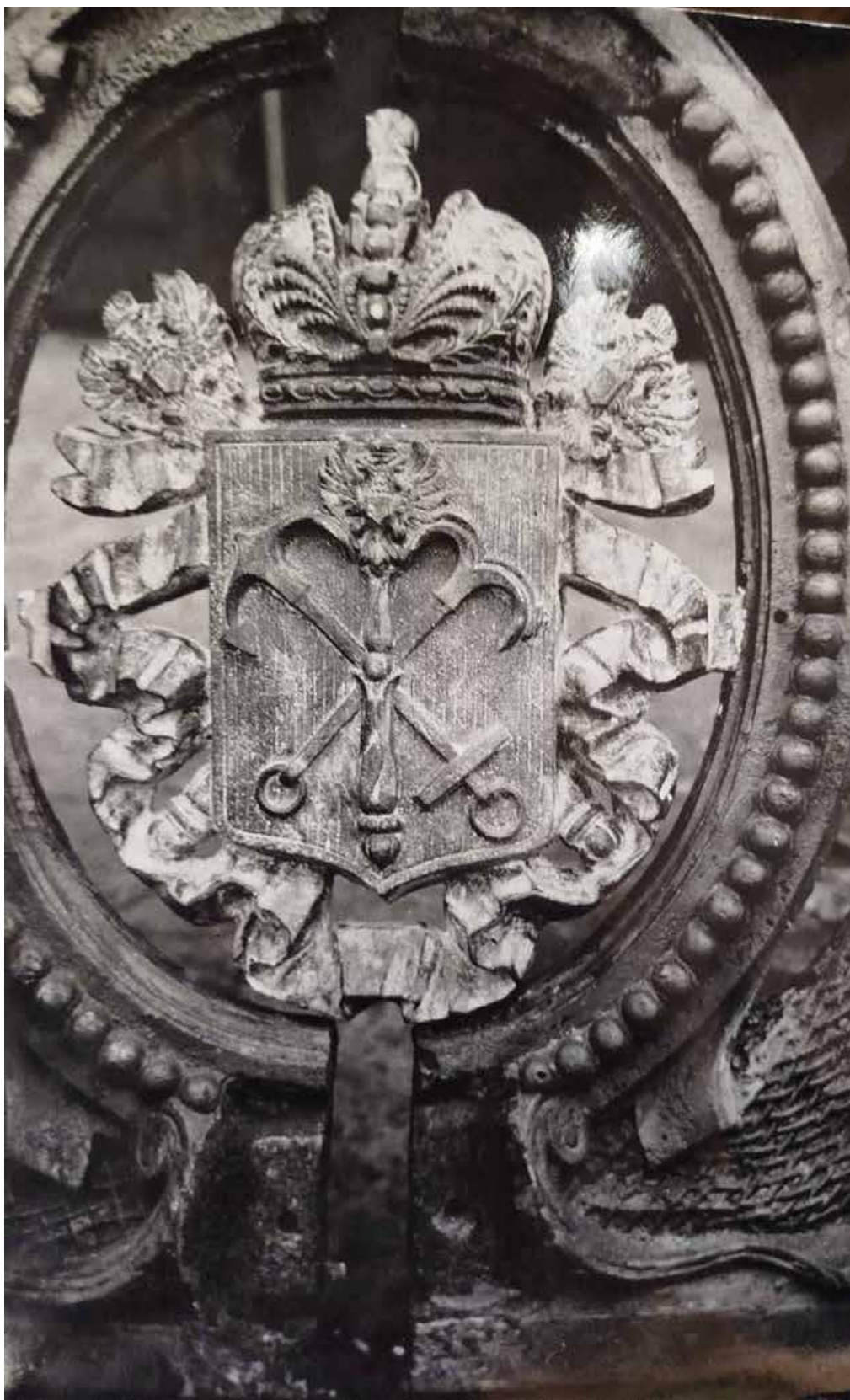
42. Герб Санкт-Петербурга в звене ограждения Литейного моста в процессе реставрации. СПб ГБУ «Мостотрест». Папка № 100. Литейный мост. Фотографии.
