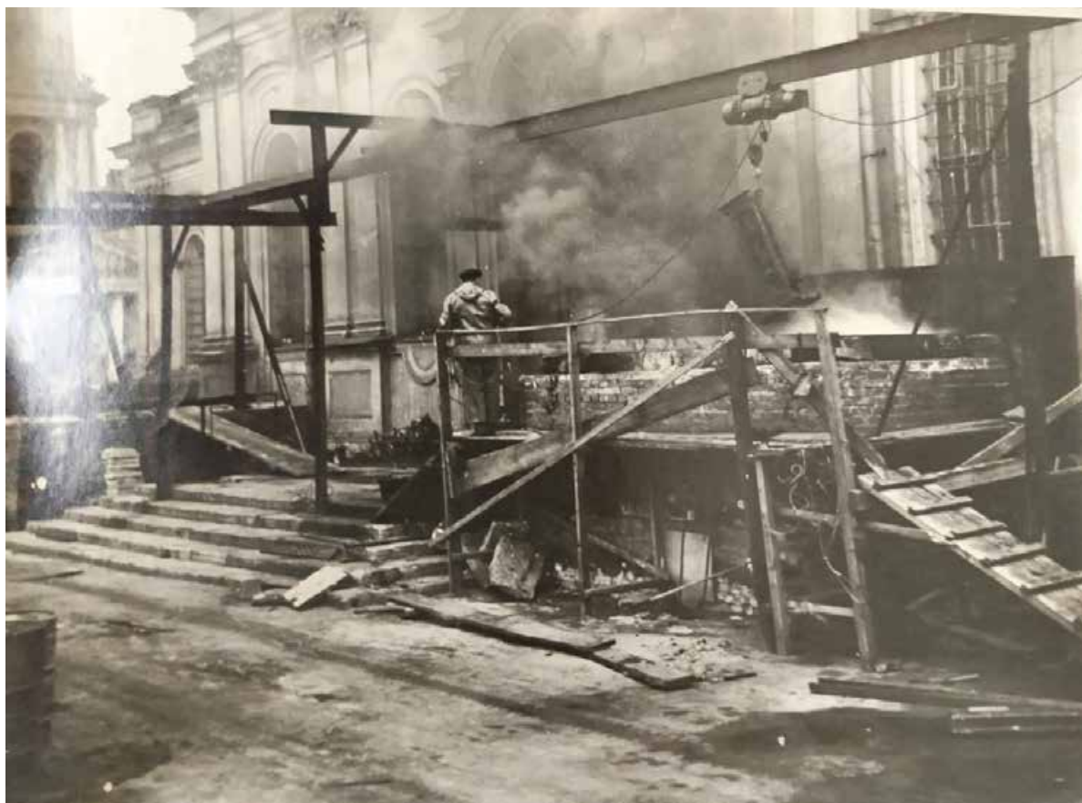
44. Химическая очистка перил в крупногабаритных ваннах. 1966. ЦГАНТД СПб. Ф. 488. Оп. 319. Д. 87.
