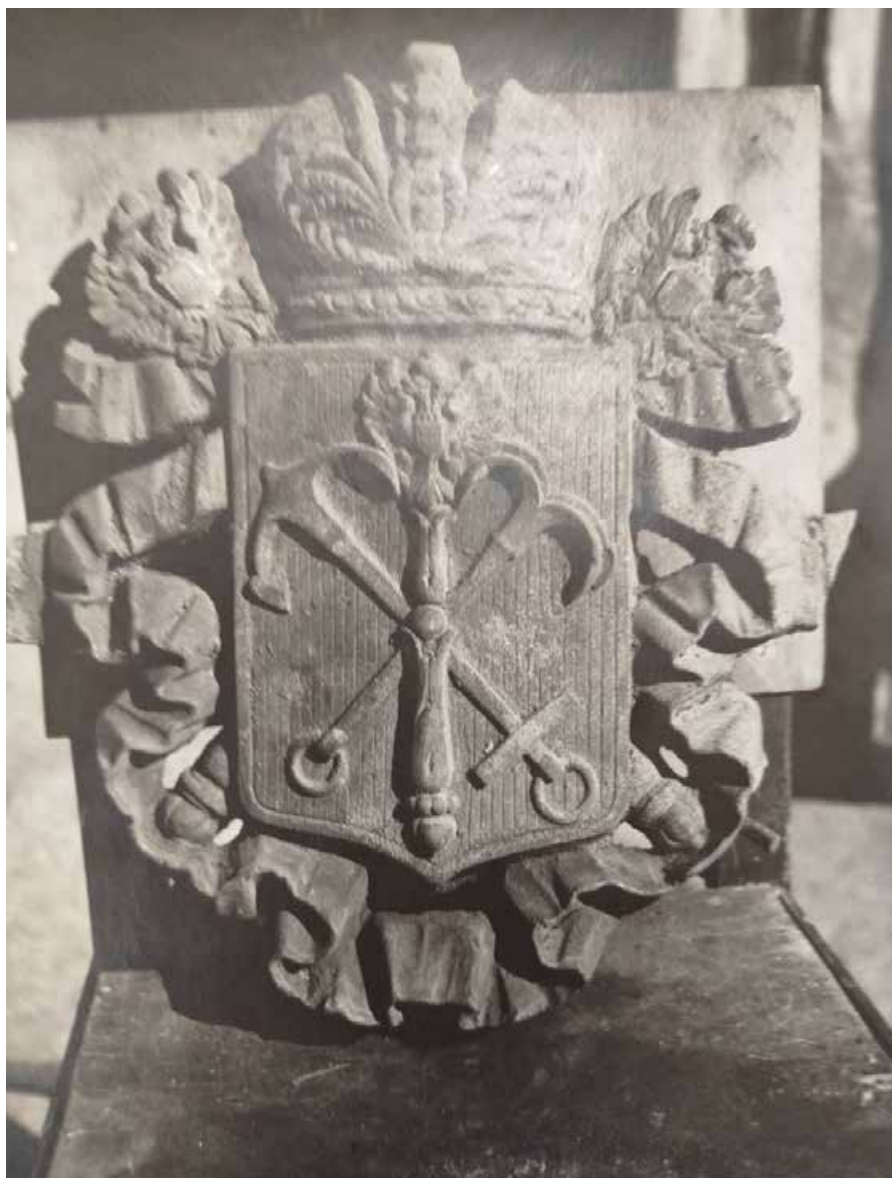
43. Деталь решетки (герб) после расчистки наслоений масляных красок. 1966. ЦГАНТД СПб. Ф. 488. Оп. 319. Д. 87.
