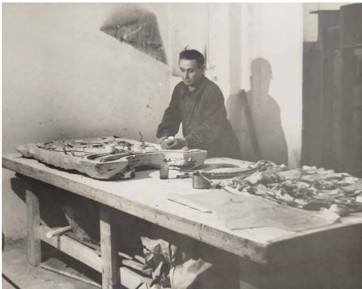
47. Литейный мост. Изготовление кусочечной формы фрагмента перил (в гипсе). Исполнил Н. Быстров. Ноябрь 1966. ЦГАНТД СПб. Ф. 488. Оп. 319. Д. 87.
