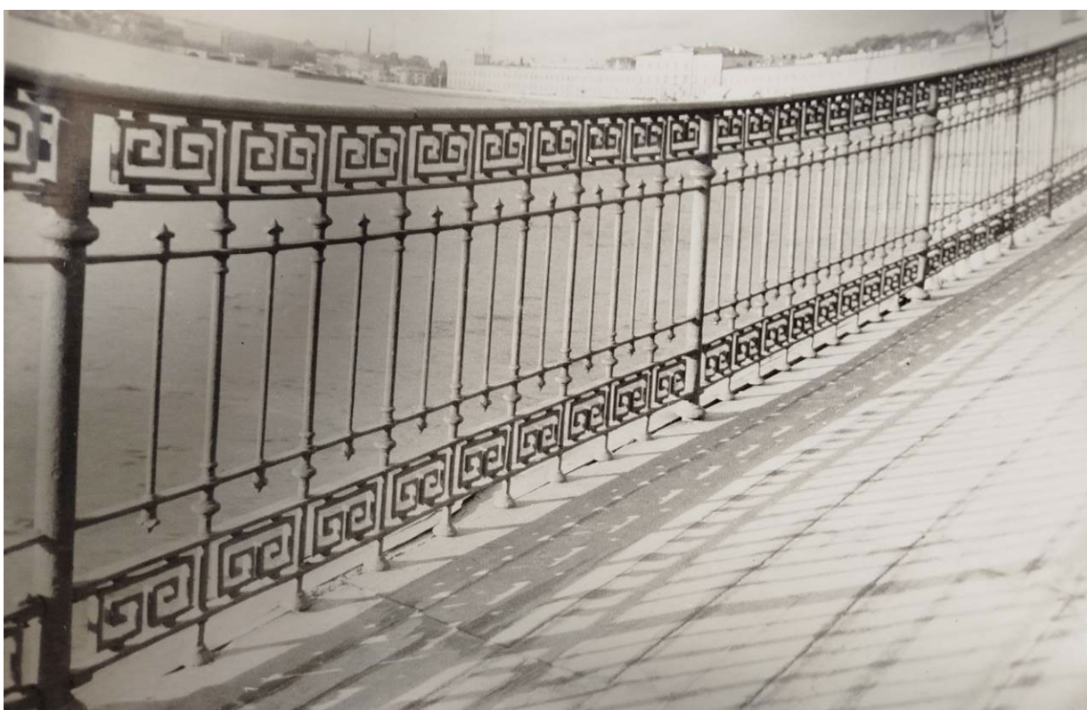
31. Ограждение разводного пролета до реконструкции Литейного моста 1966-1967. СПб ГБУ «Мостотрест». Папка № 100. Литейный мост. Фотографии.
