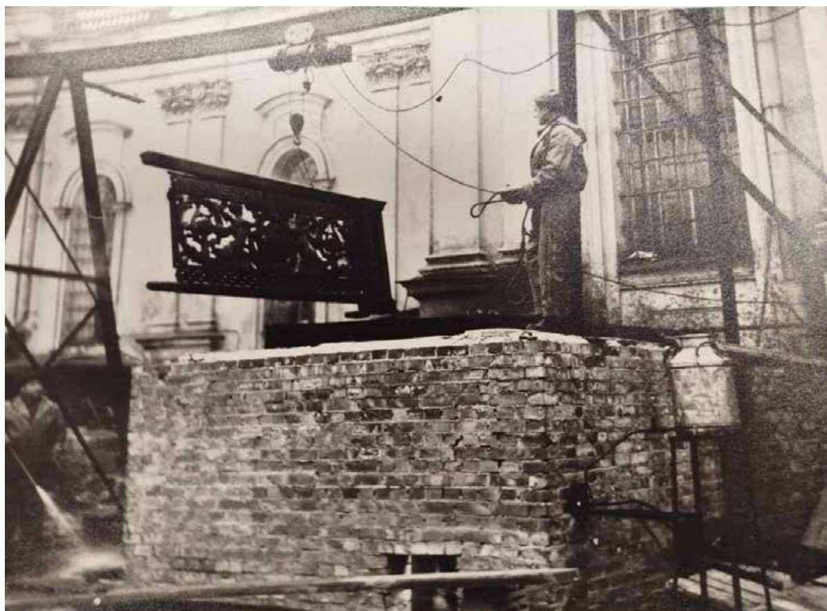
45. Подъем звена перил из ванны после химической очистки от старой масляной краски. 1966. ЦГАНТД СПб. Ф. 488. Оп. 319. Д. 87.
