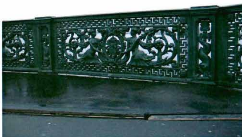
3. Решётка перильного ограждения. Фрагмент
