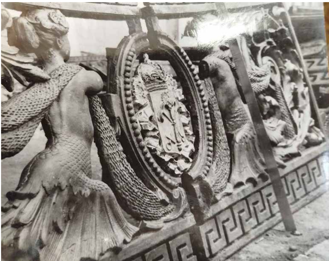
41. Звено ограждения Литейного моста в процессе реставрации. 1967-1868 гг. СПб ГБУ «Мостотрест». Папка № 100. Литейный мост. Фотографии.
