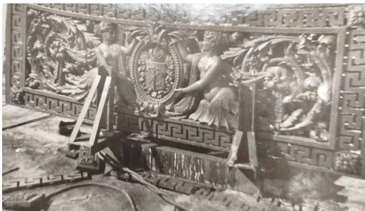
54. Литейный мост. Звено после реставрации. 1966. ЦГАНТД СПб. Ф. 488. Оп. 319. Д. 87.
