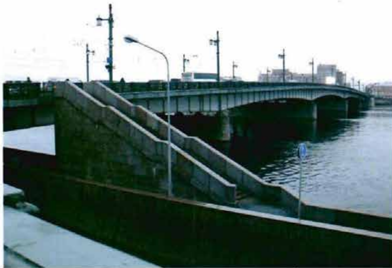
1. Вид на мост со стороны низового фасада
