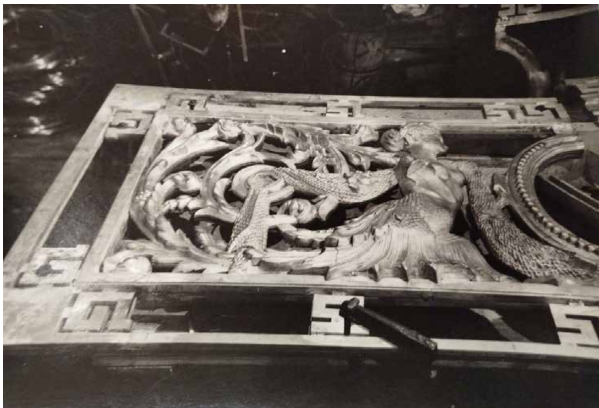
49. Литейный мост. Модель из алюминия под чугунное литье (половина). 1966. ЦГАНТД СПб. Ф. 488. Оп. 319. Д. 87.
