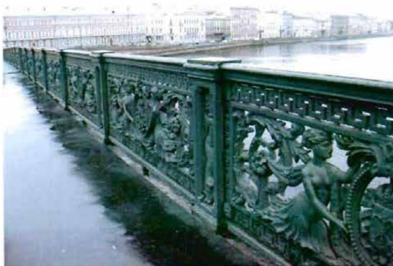
2. Перильное ограждение. Общий вид
