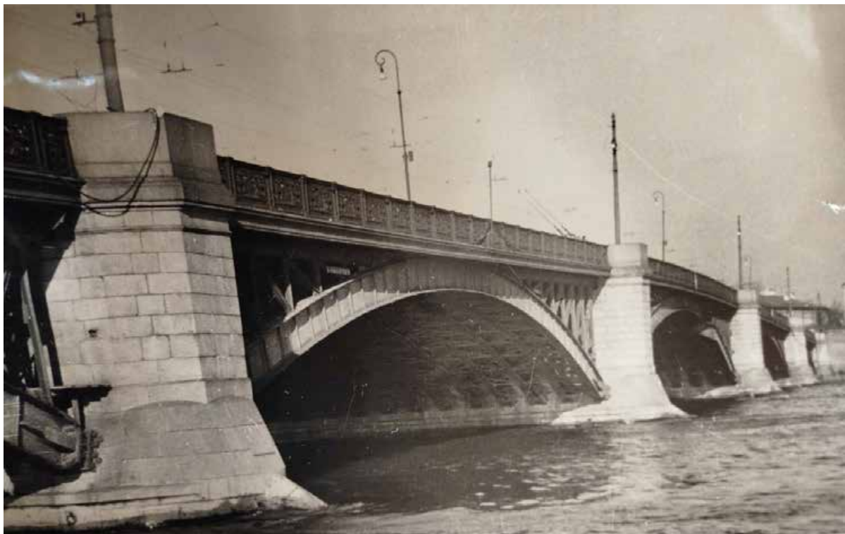
32. Литейный мост. Опоры № 2, 5. Проектное задание реконструкции Литейного моста через реку Неву. Том IX. Материалы изысканий и обследования.
