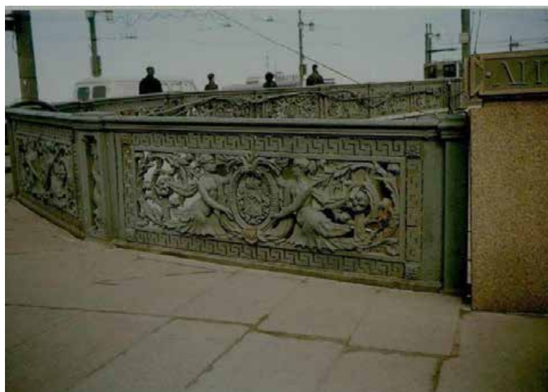
64. Ограждение Литейного (Александра II) моста. 1875-1879 гг., 1966-1968 гг. Съемка 1991 г. Паспорт памятника «Ограждение Литейного моста». КГИОП. П. 201 М. Инв. № 1258.
