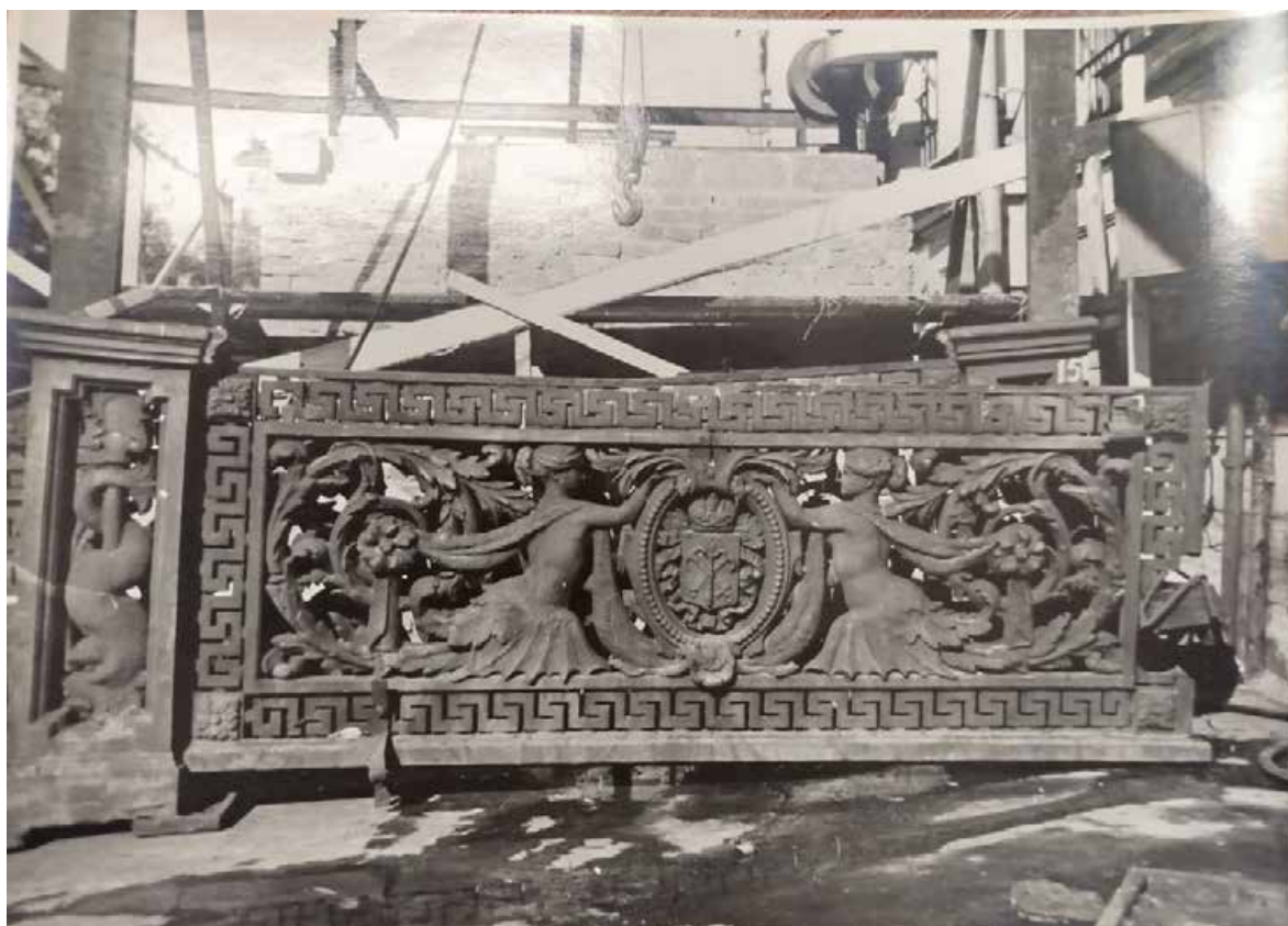
52. Звено решетки Литейного моста. Подготовка к загрузке в ванну для расчистки. 1966. ЦГАНТД СПб. Ф. 488. Оп. 319. Д. 87.
