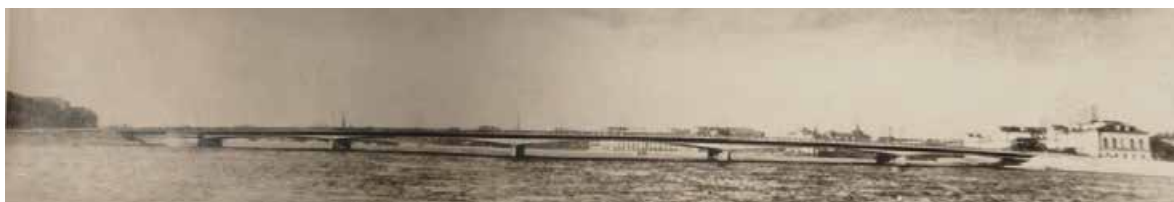
58. Литейный мост после реконструкции 1966-1967 гг. СПб ГБУ «Мостотрест». Папка № 100. Литейный мост. Фотографии.
