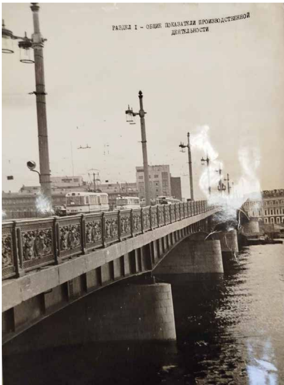
59. Литейный мост после реконструкции 1966-1967 гг. СПб ГБУ «Мостотрест». Папка № 100. Литейный мост. Фотографии.
