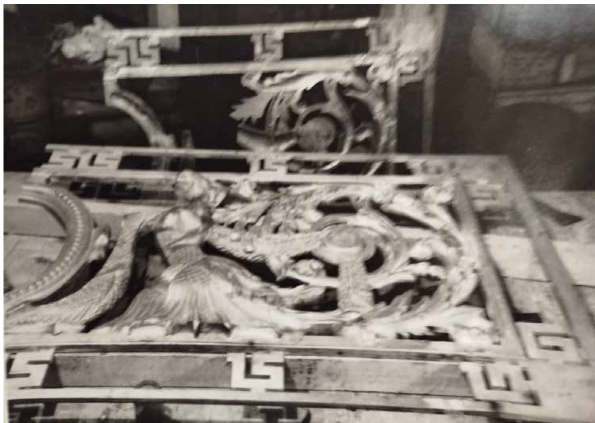
50. Литейный мост. Модель из алюминия под чугунное литье (половина). 1966. ЦГАНТД СПб. Ф. 488. Оп. 319. Д. 87.
