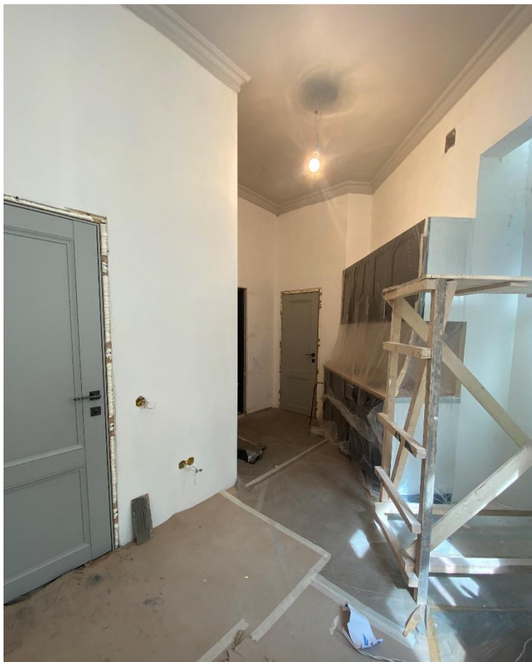
Фото 15. Помещение кухни, общий вид.
