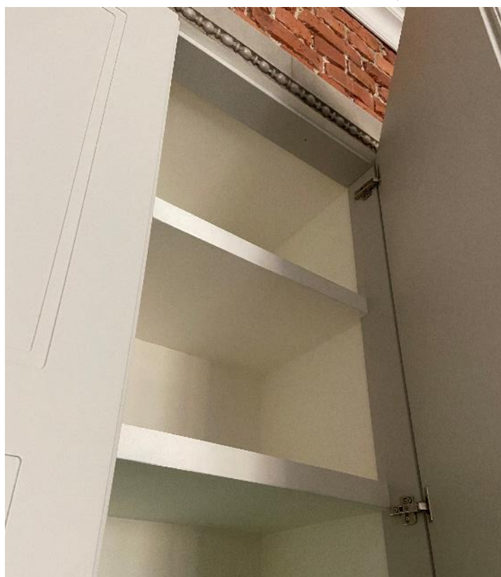
Фото 28. Встроенный шкаф в помещении 9.
