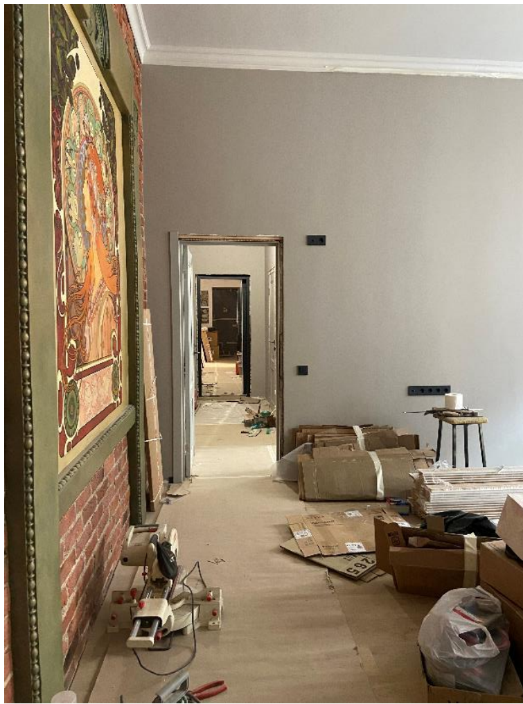
Фото 29. Вид помещения 10 и коридора.
