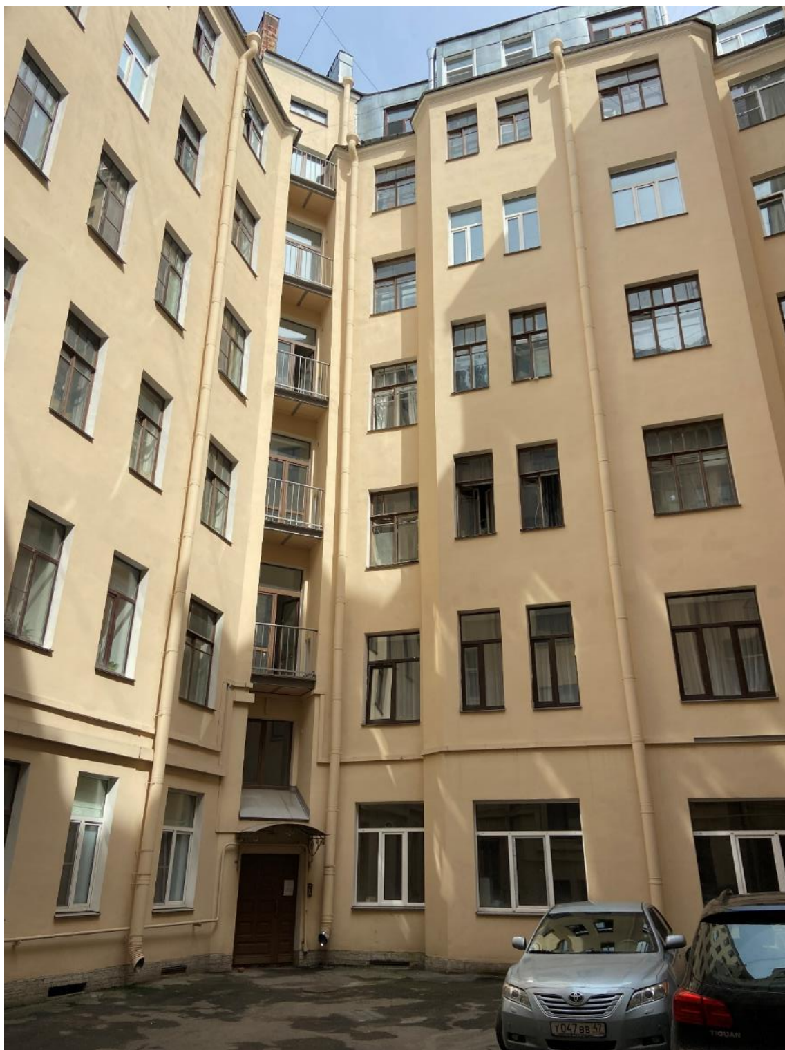
Фото 5. Фрагмент фасада юго-восточного двора.
