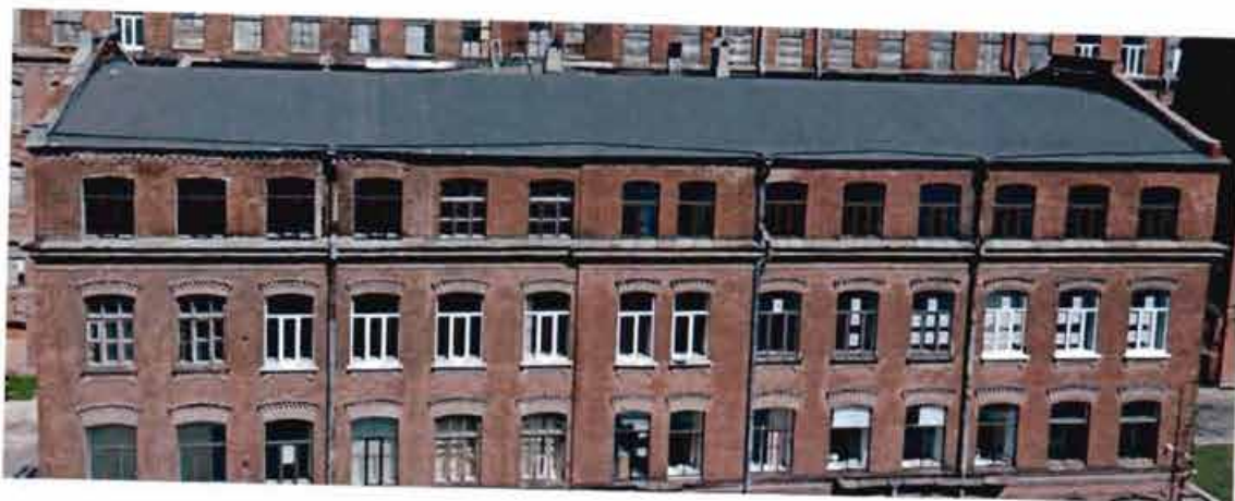
15. Кровля объекта культурного наследия.
