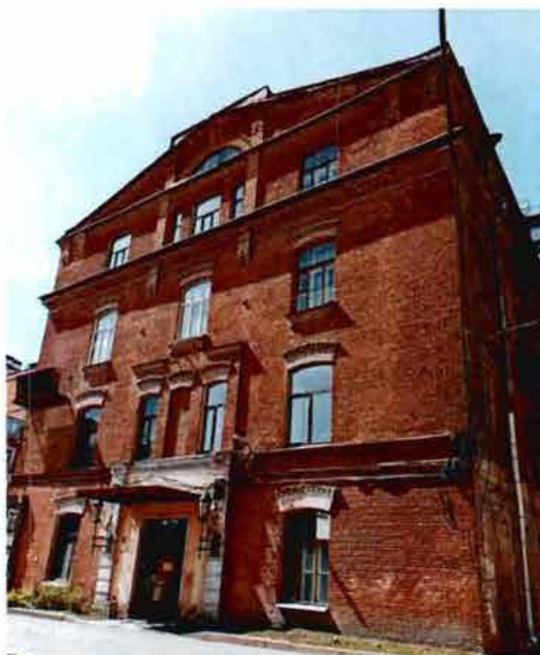
2. Общий вид. Восточный фасад объекта культурного наследия.
