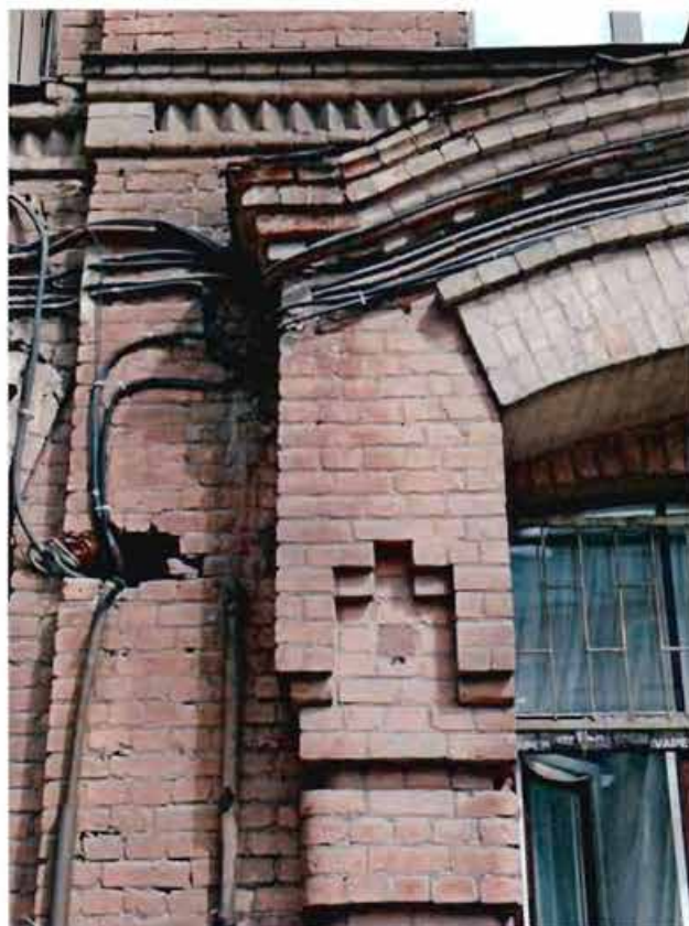
9. Фрагмент. Южный фасад объекта культурного наследия.
