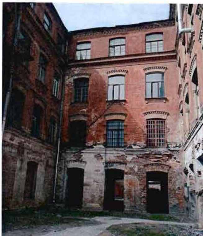
5. Общий вид. Восточный фасад объекта культурного наследия.
