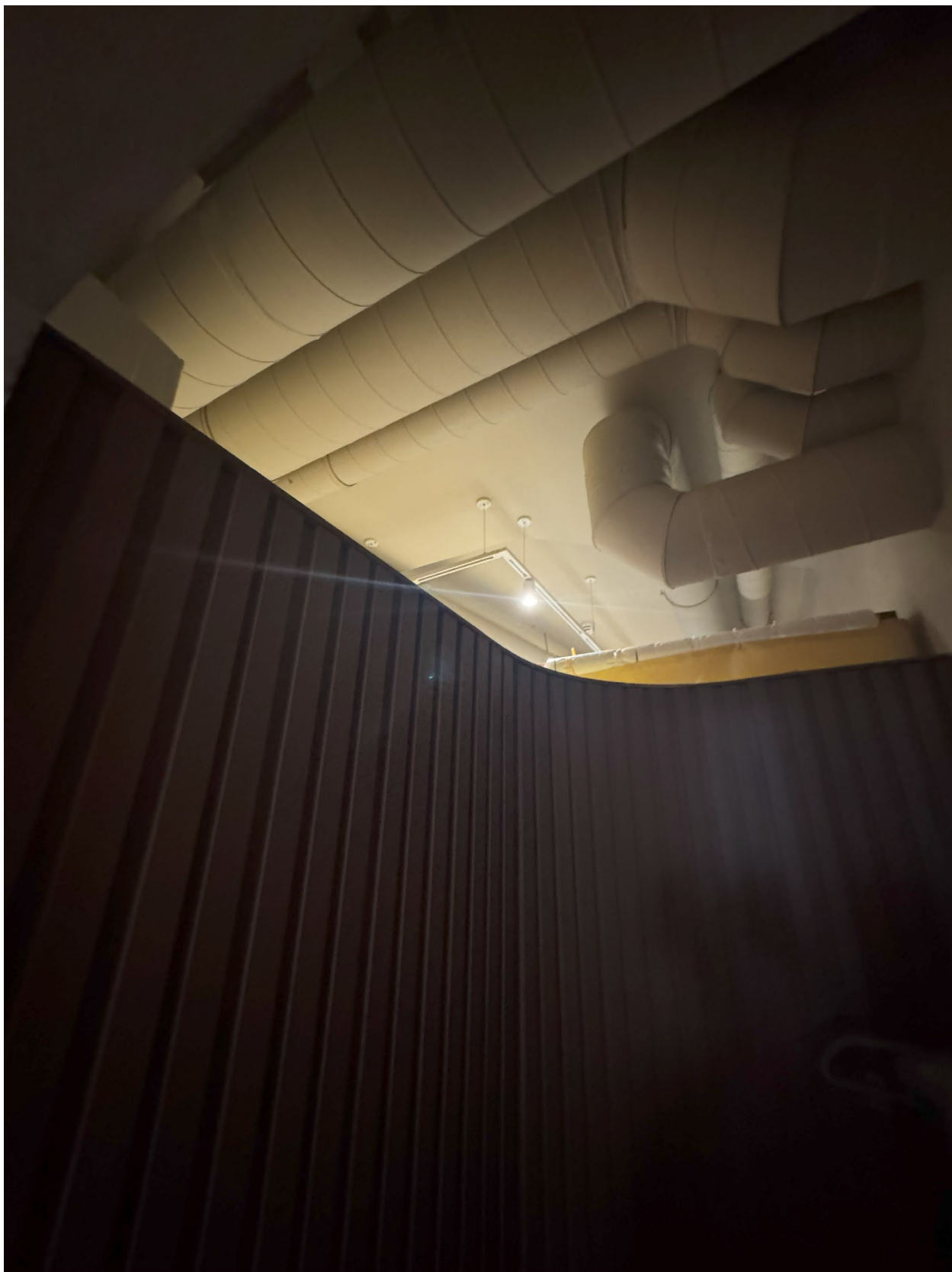
Фото 5. Общий вид на помещение № 1-Н. Дата фотофиксации: 26.09.2025г.
