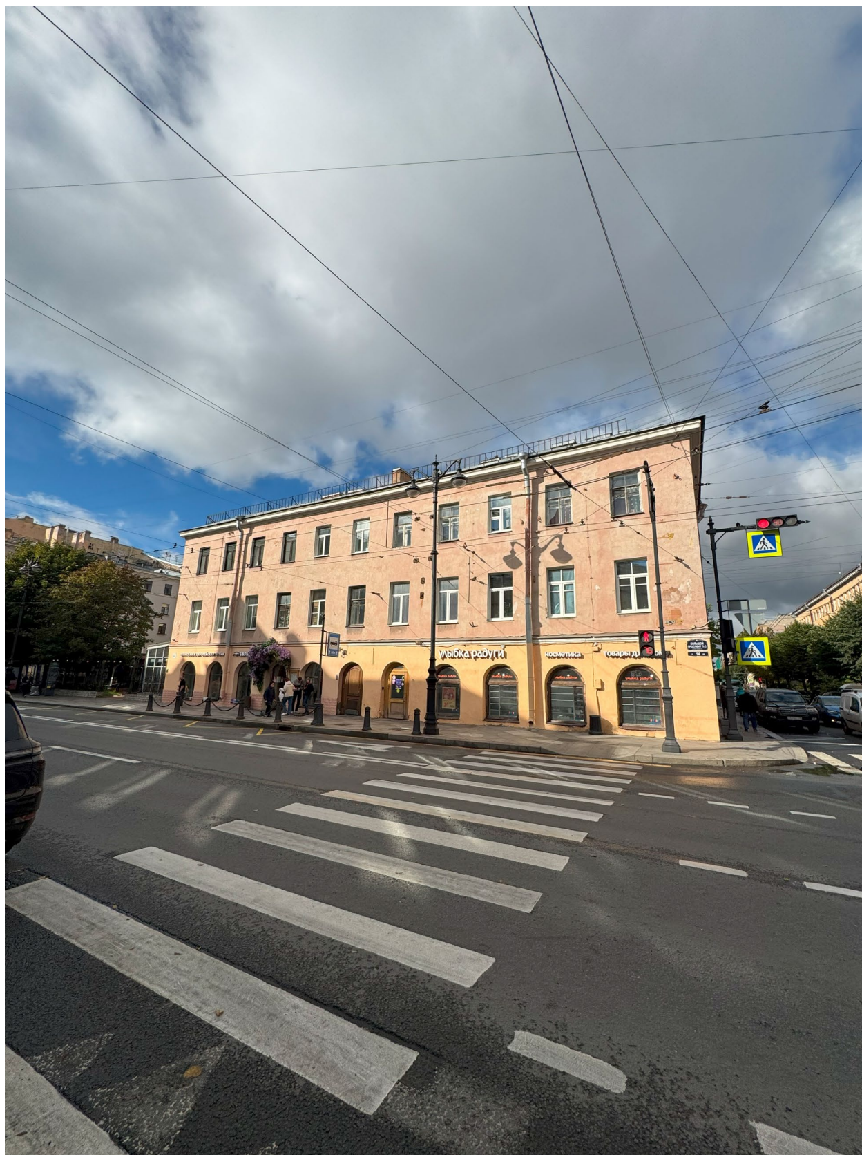
Фото 21. Общий вид на объект. Дата фотофиксации: 26.09.2025г.
