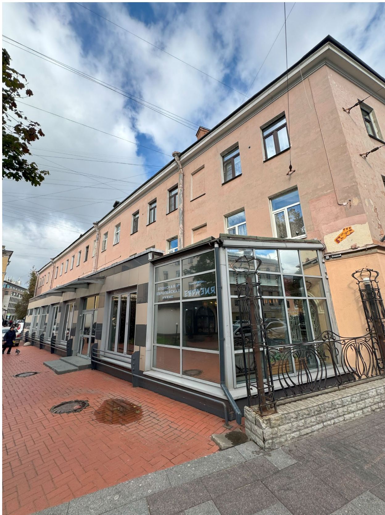
Фото 30. Общий вид на помещение № 1-Н со стороны лицевого фасада. Дата фотофиксации: 26.09.2025г.
