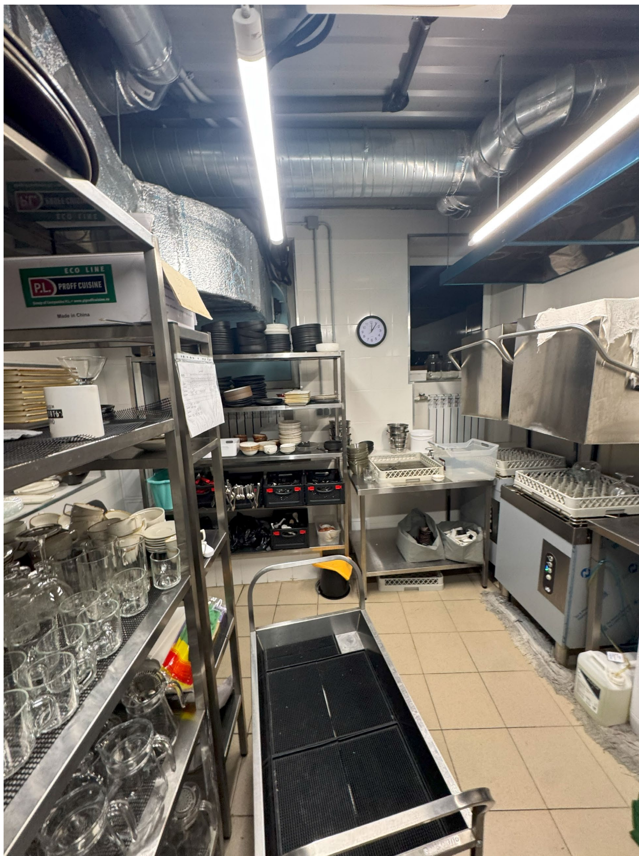
Фото 22. Общий вид на помещение № 1-Н. Дата фотофиксации: 26.09.2025г.
