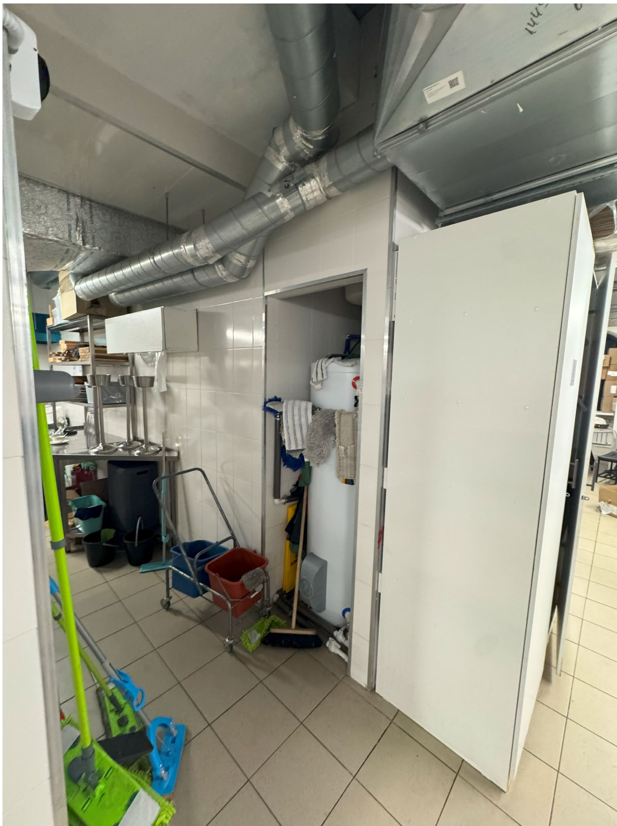
Фото 20. Общий вид на помещение № 1-Н. Дата фотофиксации: 26.09.2025г.
