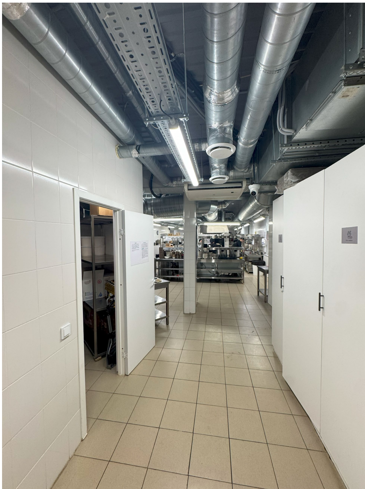
Фото 17. Общий вид на помещение № 1-Н. Дата фотофиксации: 26.09.2025г.
