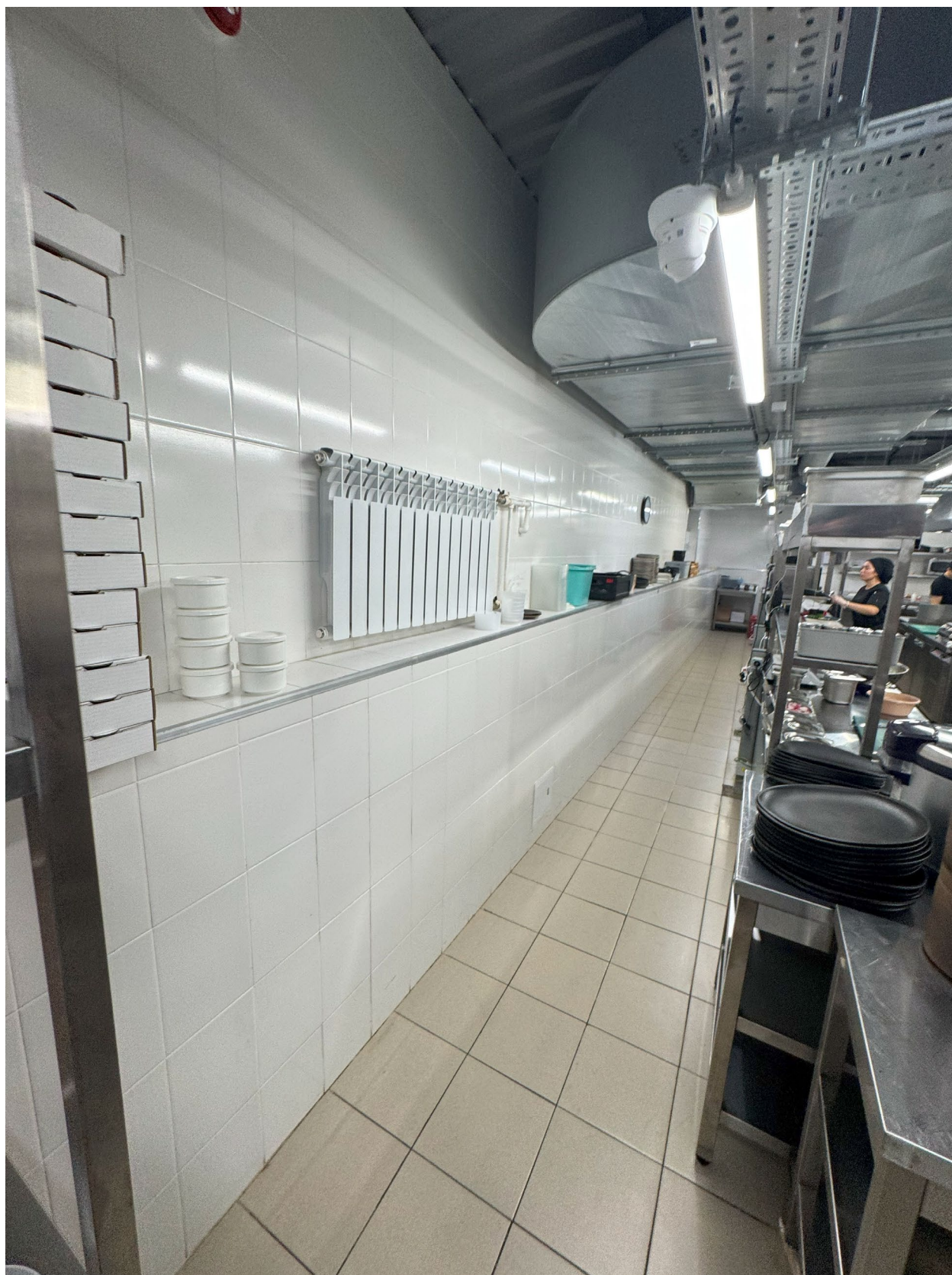
Фото 19. Общий вид на помещение № 1-Н. Дата фотофиксации: 26.09.2025г.
