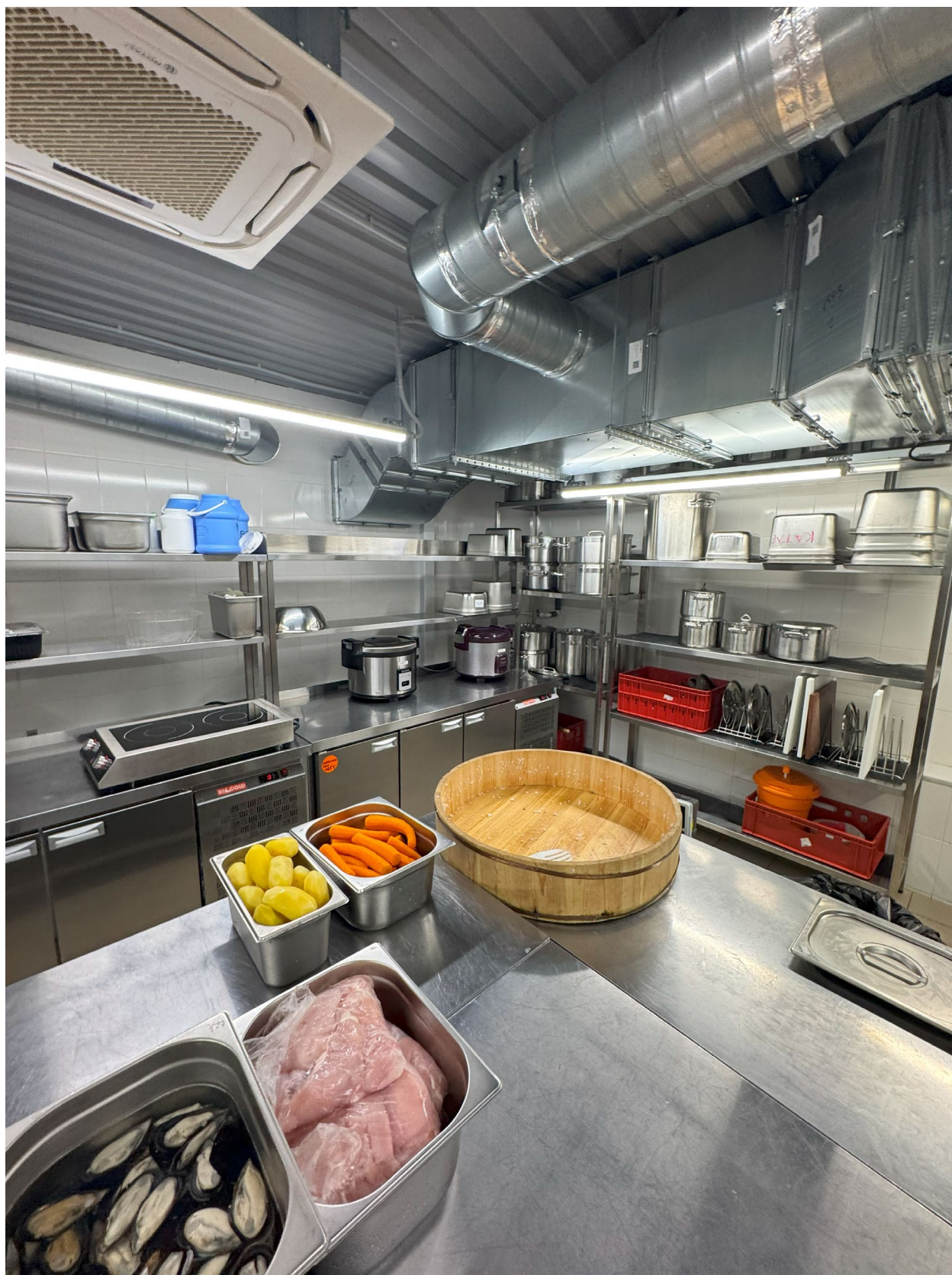
Фото 26. Общий вид на помещение № 1-Н. Дата фотофиксации: 26.09.2025г.
