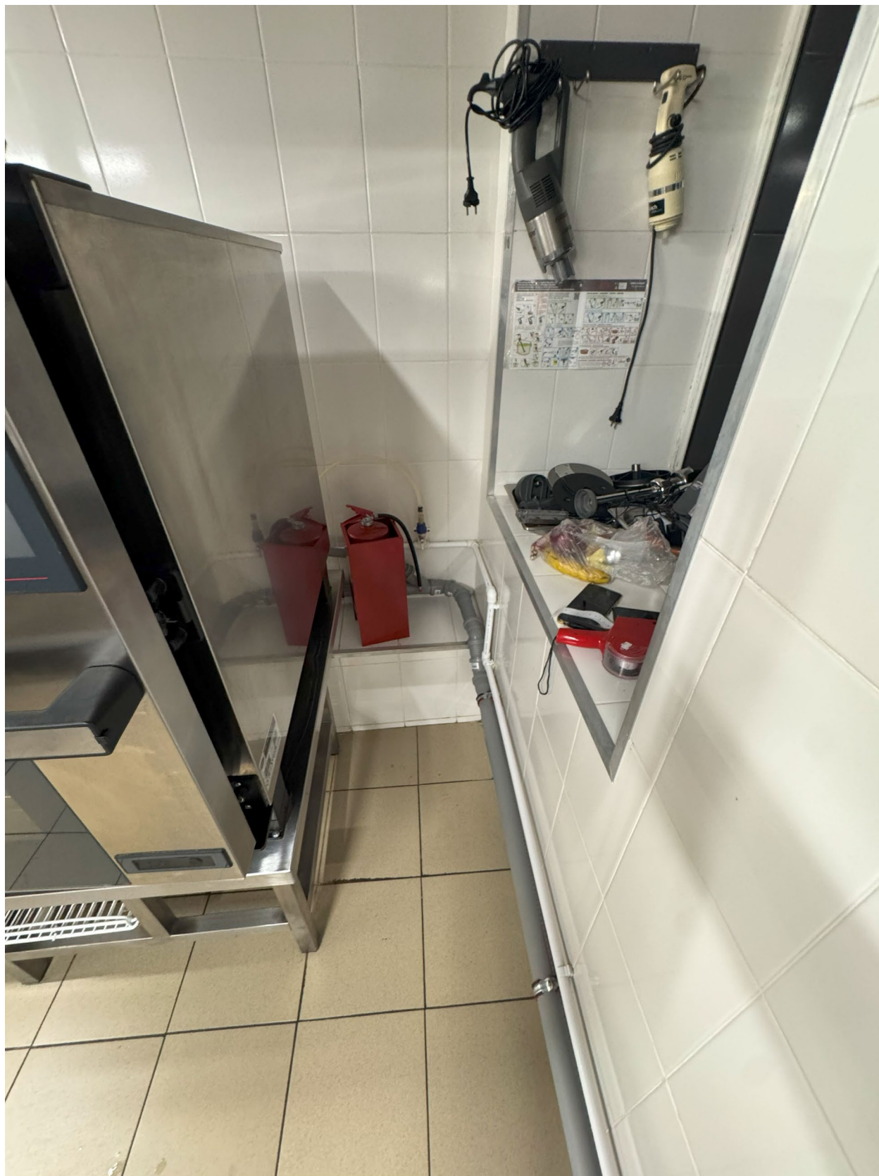
Фото 25. Общий вид на помещение № 1-Н. Дата фотофиксации: 26.09.2025г.
