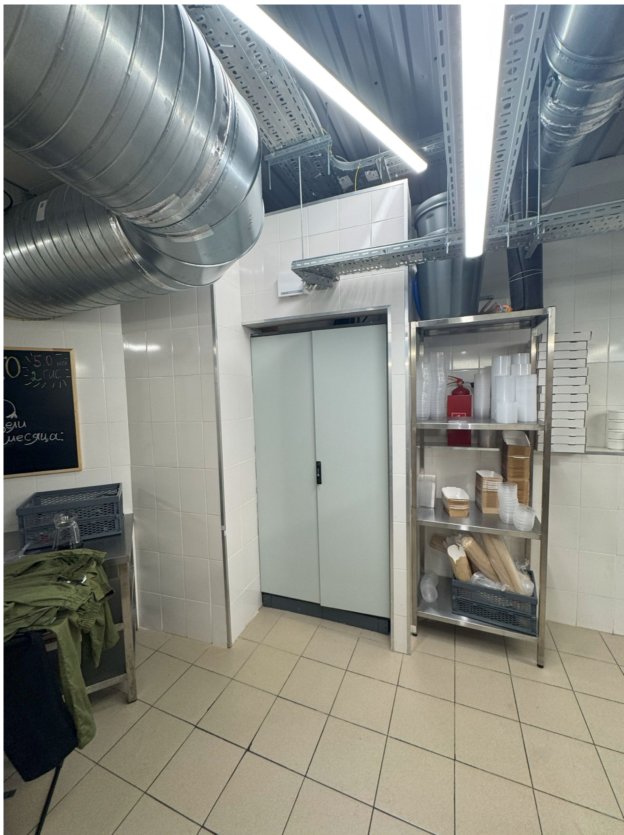
Фото 18. Общий вид на помещение № 1-Н. Дата фотофиксации: 26.09.2025г.
