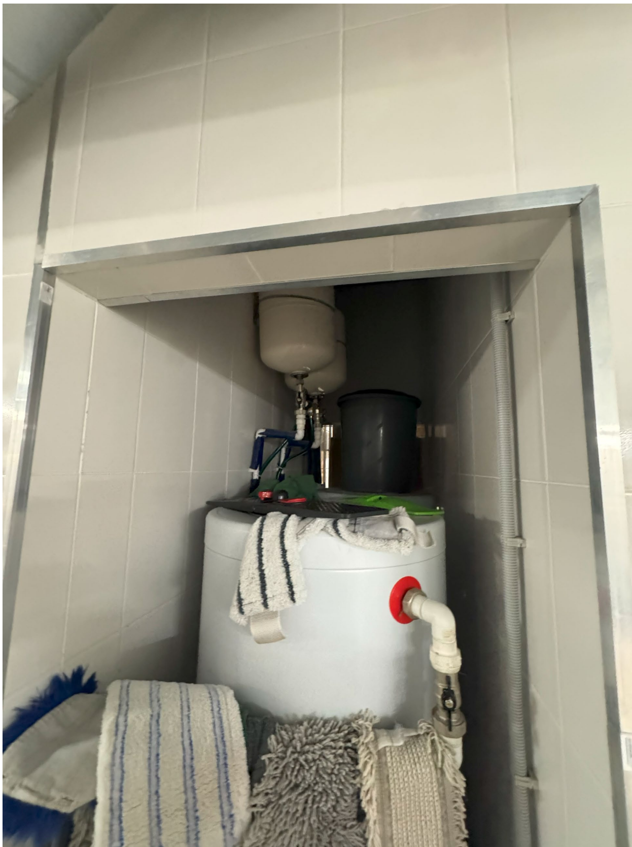
Фото 21. Общий вид на помещение № 1-Н. Дата фотофиксации: 26.09.2025г.
