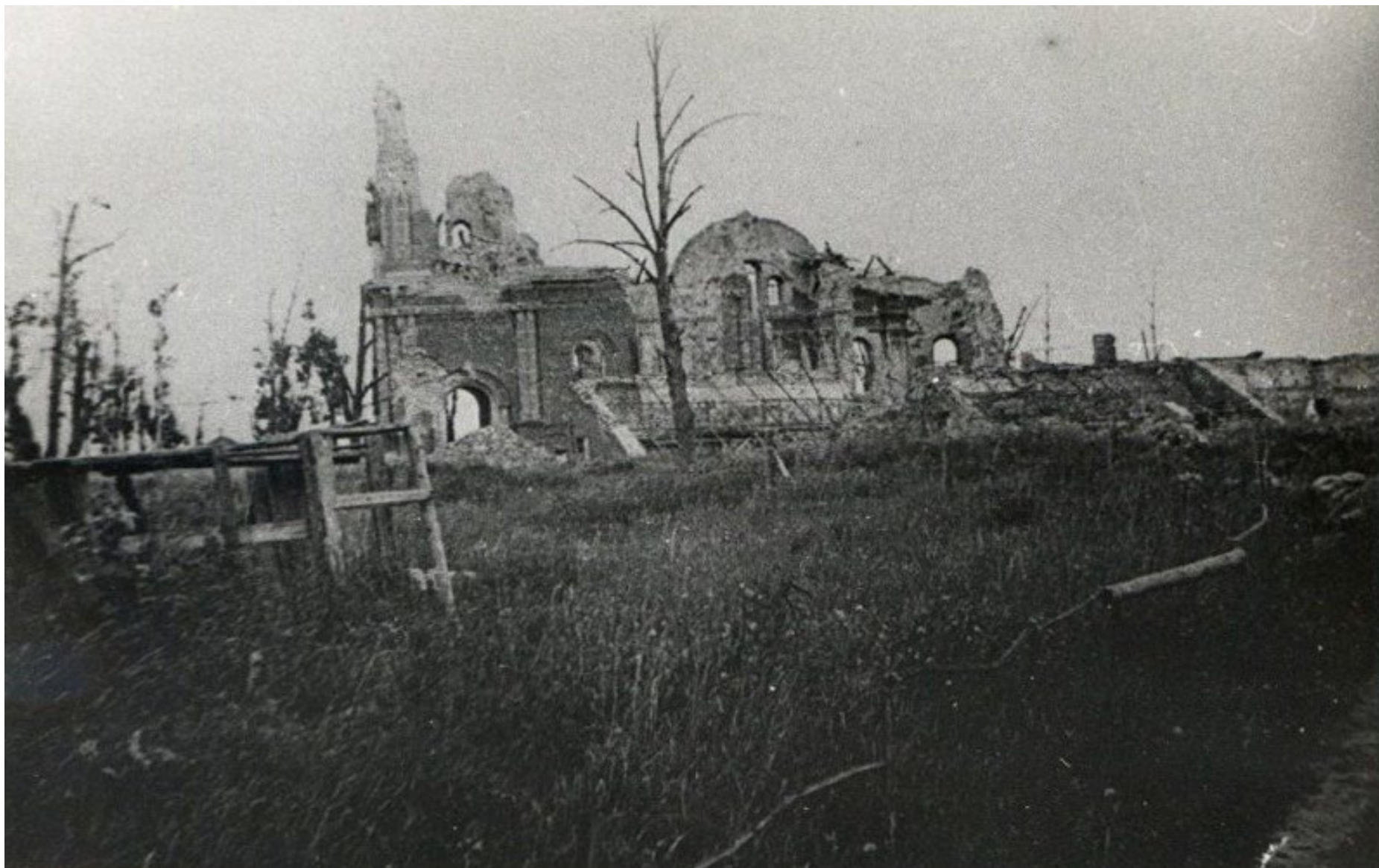
25. Разрушенная церковь Живоначальной Троицы в Петергофе 1943 // ПДМП Инв. №5044-фд
