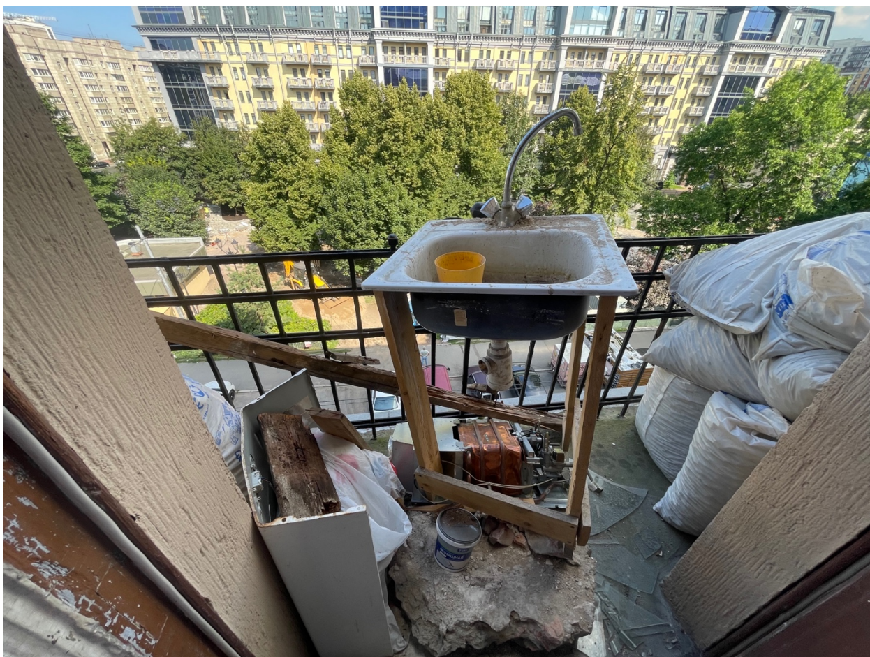
12.Общий вид балкона.
