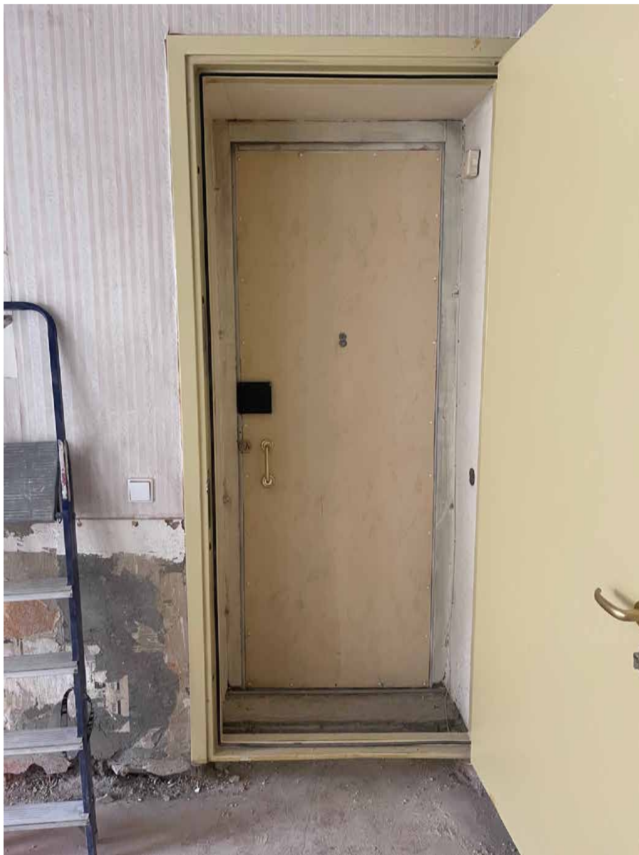
20. Вид входной двери изнутри.
