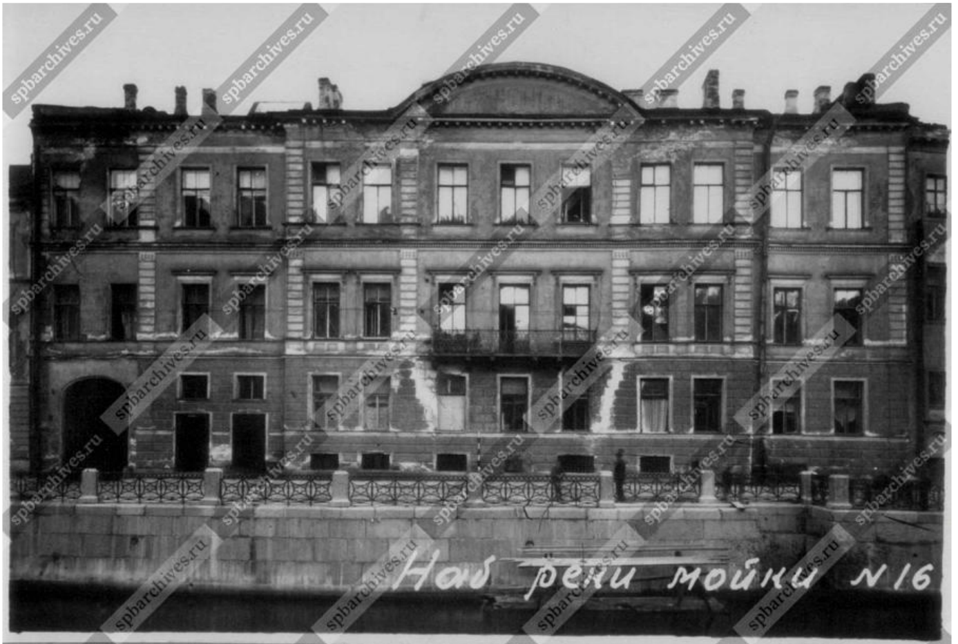
Рис.10. Фасад дома №16 на наб. р. Мойки. 1960 г. ЦГАКФФД СПб Оп.1ГР-49. Ед.хр.75508.
