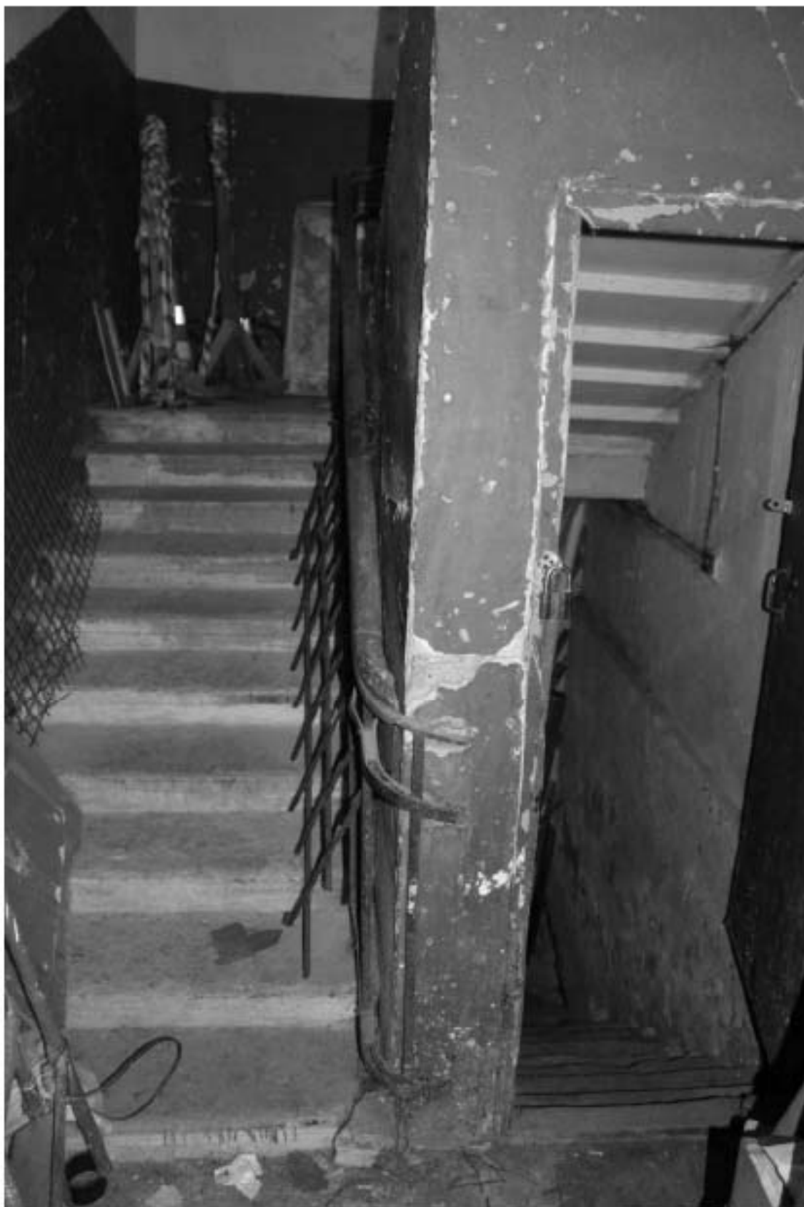
Фото 65. Выявленный объект культурного наследия «Доходный дом». Вид на лестницу ЗЛК в уровне 1-го этажа.
