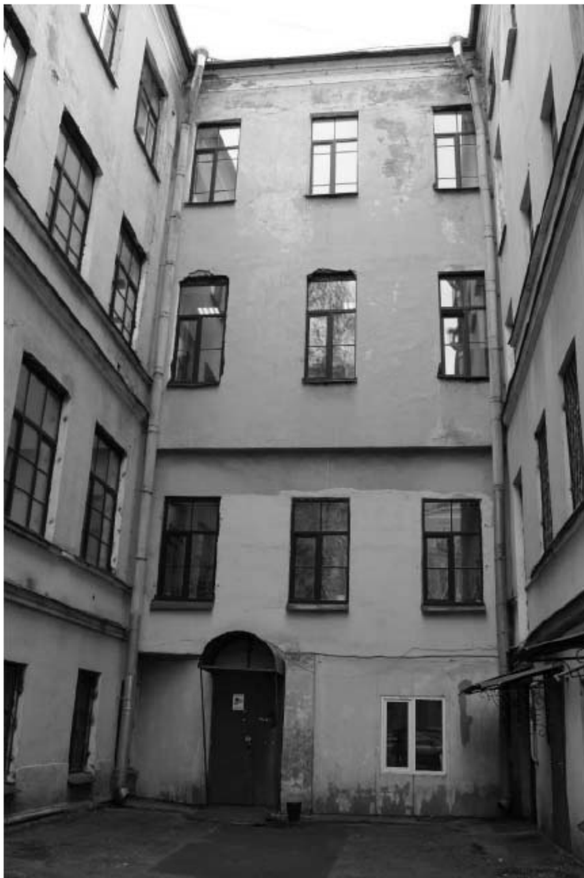
Фото 49. Вид на дворовые фасады четырехэтажной части двух-четырёхэтажного корпуса выявленного объекта культурного наследия «Здание Марининской женской гимназии», обращенные во внутренний двор.
