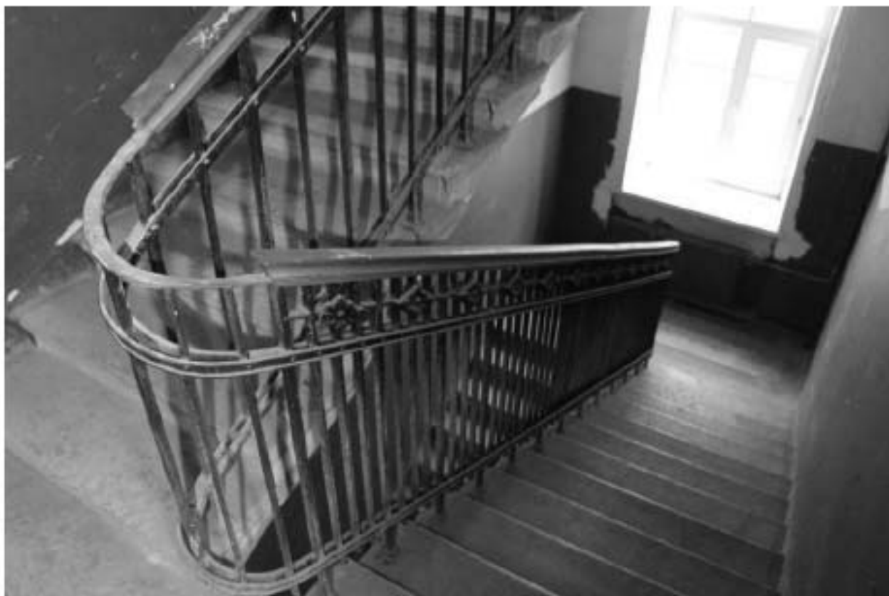
Фото 102. Выявленный объект культурного наследия «Доходный дом». Вид на лестницу 5ЛК в уровне 3-го этажа.
