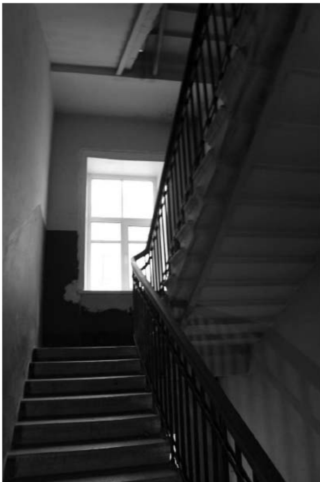
Фото 105. Выявленный объект культурного наследия «Доходный дом». Вид на лестницу 5ЛК в уровне 4-го – 5-го этажей
