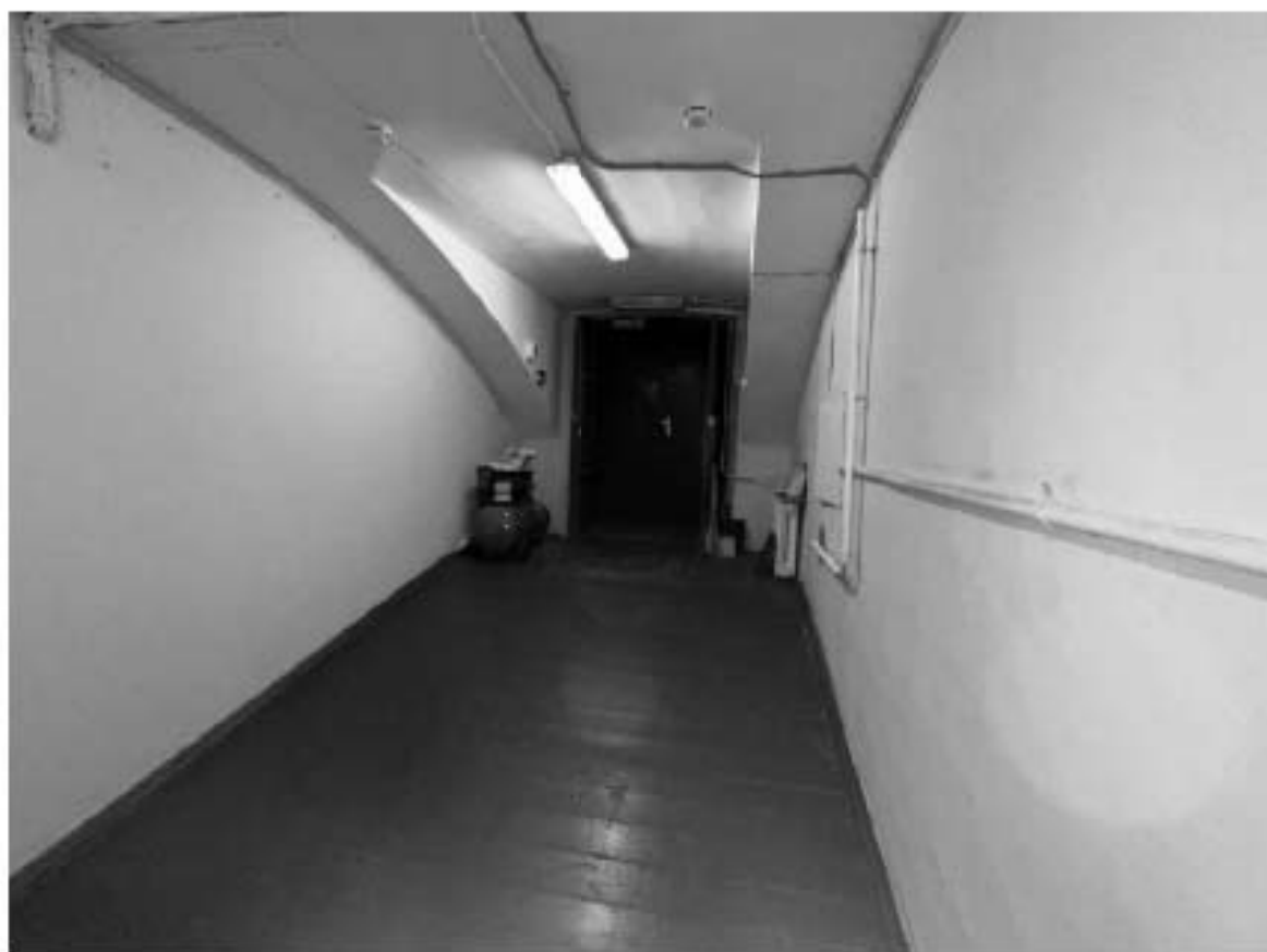
Фото 227. Выявленный объект культурного наследия «Здание Марининской женской гимназии». Вид на внутренние помещения цокольного этажа.
