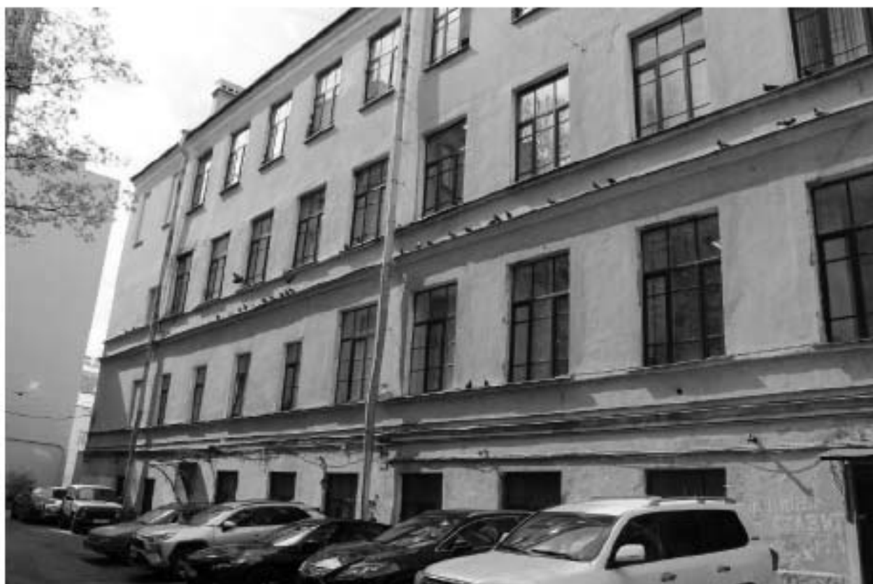
Фото 45. Вид на юго-восточный дворовый фасад четырехэтажной части двух-четырёхэтажного корпуса выявленного объекта культурного наследия «Здание Марининской женской гимназии».
