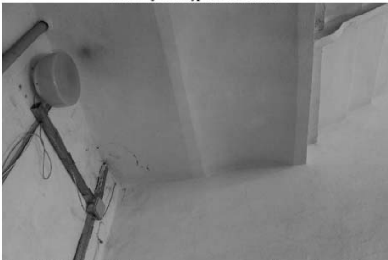
Фото 120. Выявленный объект культурного наследия «Доходный дом». Вид на лестницу БЛК в уровне 4-го этажа.
