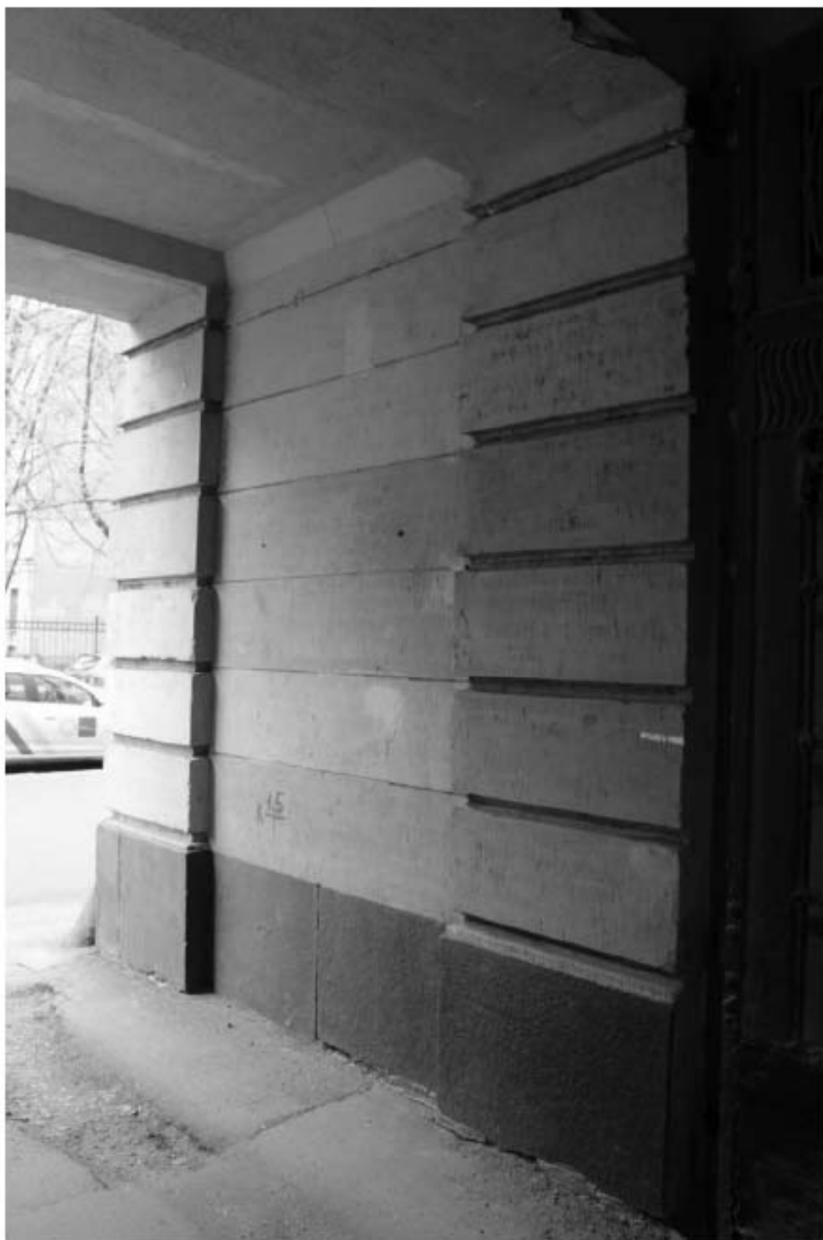
Фото 11. Вид на воротный проезд лицевого корпуса выявленного объекта культурного наследия «Доходный дом».
