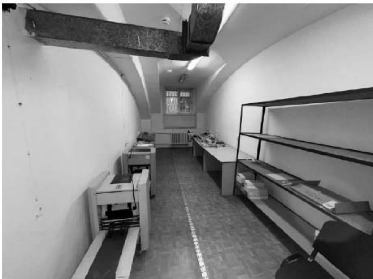
Фото 225. Выявленный объект культурного наследия «Здание Марининской женской гимназии». Вид на внутренние помещения цокольного этажа.
