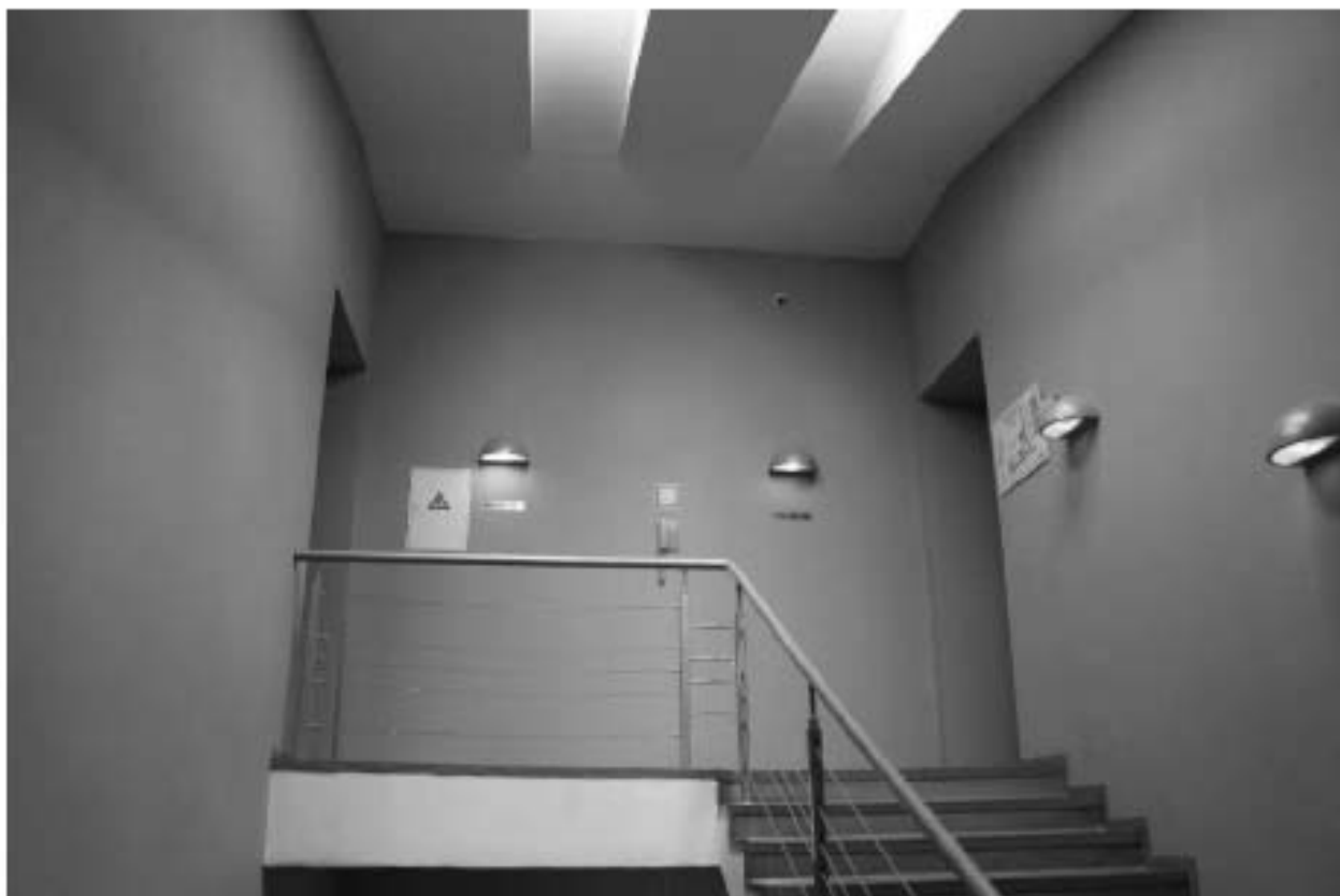
Фото 203. Выявленный объект культурного наследия «Здание Марининской женской гимназии». Вид на лестницу 1ЛК (Загородный пр., д. 13, лит. А) в уровне мансардного этажа.
