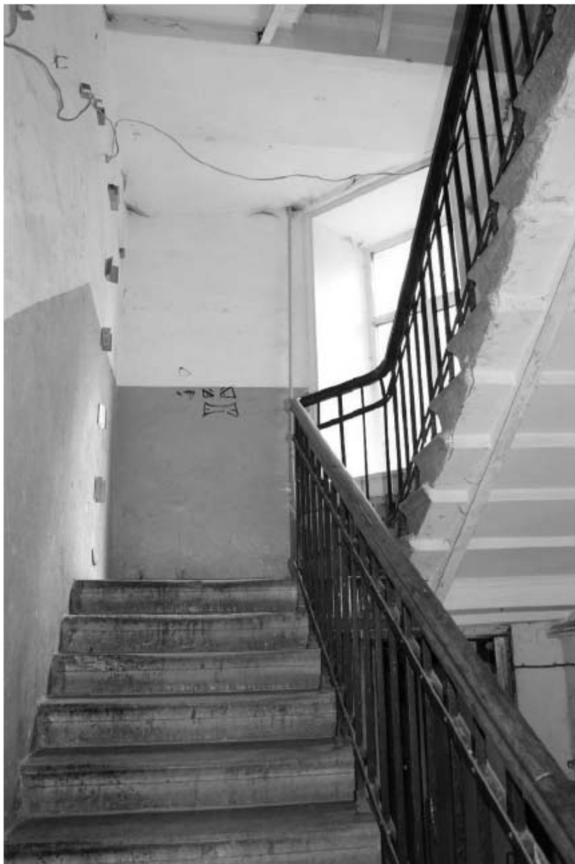
Фото 112. Выявленный объект культурного наследия «Доходный дом». Вид на лестницу БЛК в уровне 1-го – 2-го этажей.
