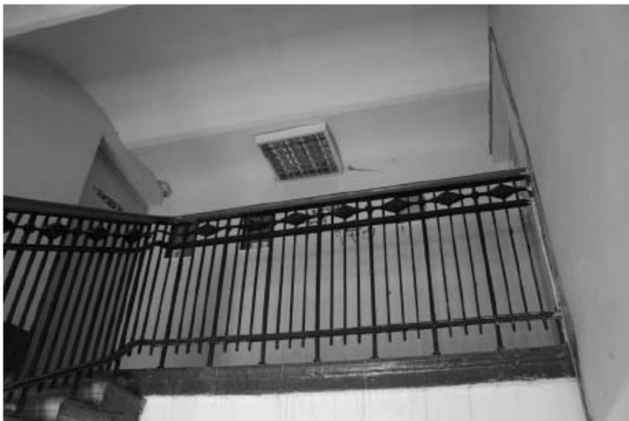
Фото 135. Выявленный объект культурного наследия «Доходный дом». Вид на лестницу 7ЛК в уровне чердачного этажа.
