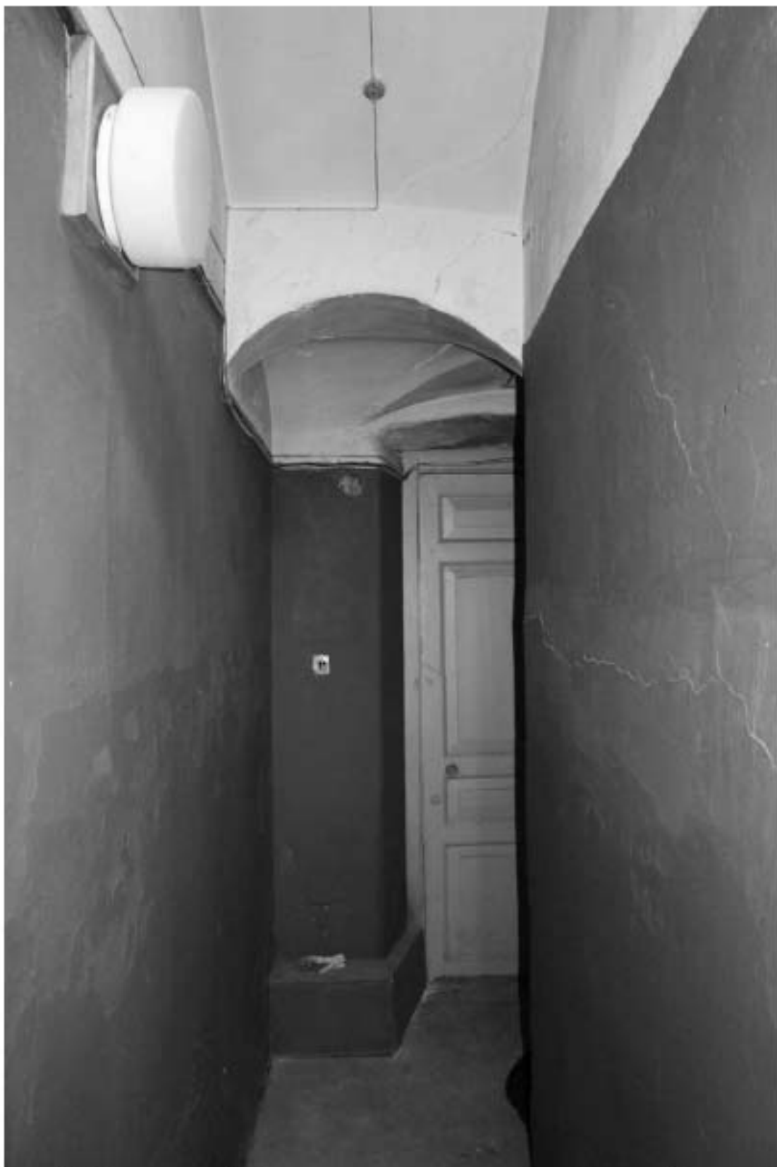
Фото 150. Выявленный объект культурного наследия «Здание Марининской женской гимназии». Вид на лестницу 9ЛК (ул. Ломоносова, д. 11-13, лит. А) в уровне 1-го этажа.
