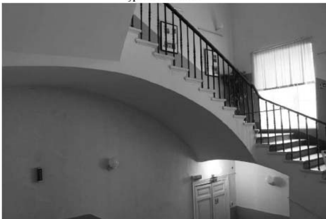
Фото 166. Выявленный объект культурного наследия «Здание Марининской женской гимназии». Вид на лестницу 10ЛК (ул. Ломоносова, д. 11-13, лит. А) в уровне 1-го этажа.
