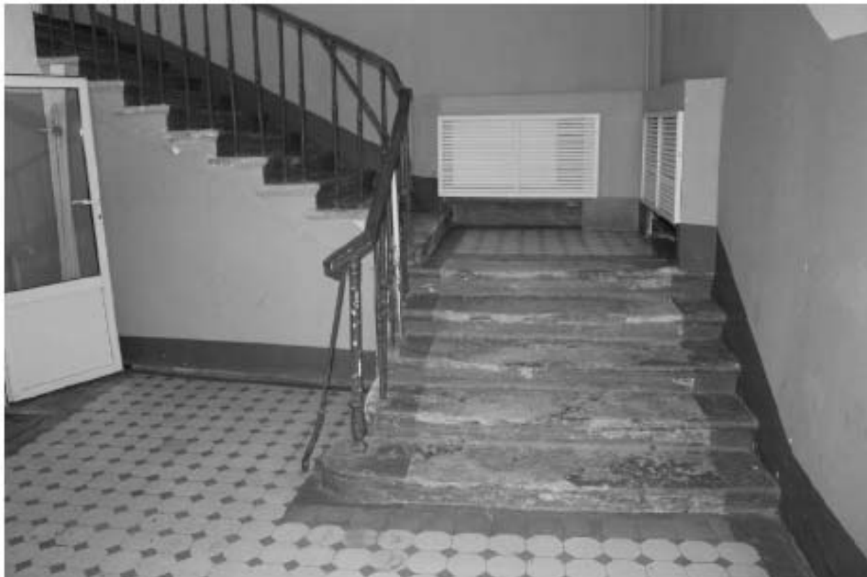
Фото 164. Выявленный объект культурного наследия «Здание Марининской женской гимназии». Вид на лестницу 10ЛК (ул. Ломоносова, д. 11-13, лит. А) в уровне цокольного этажа.
