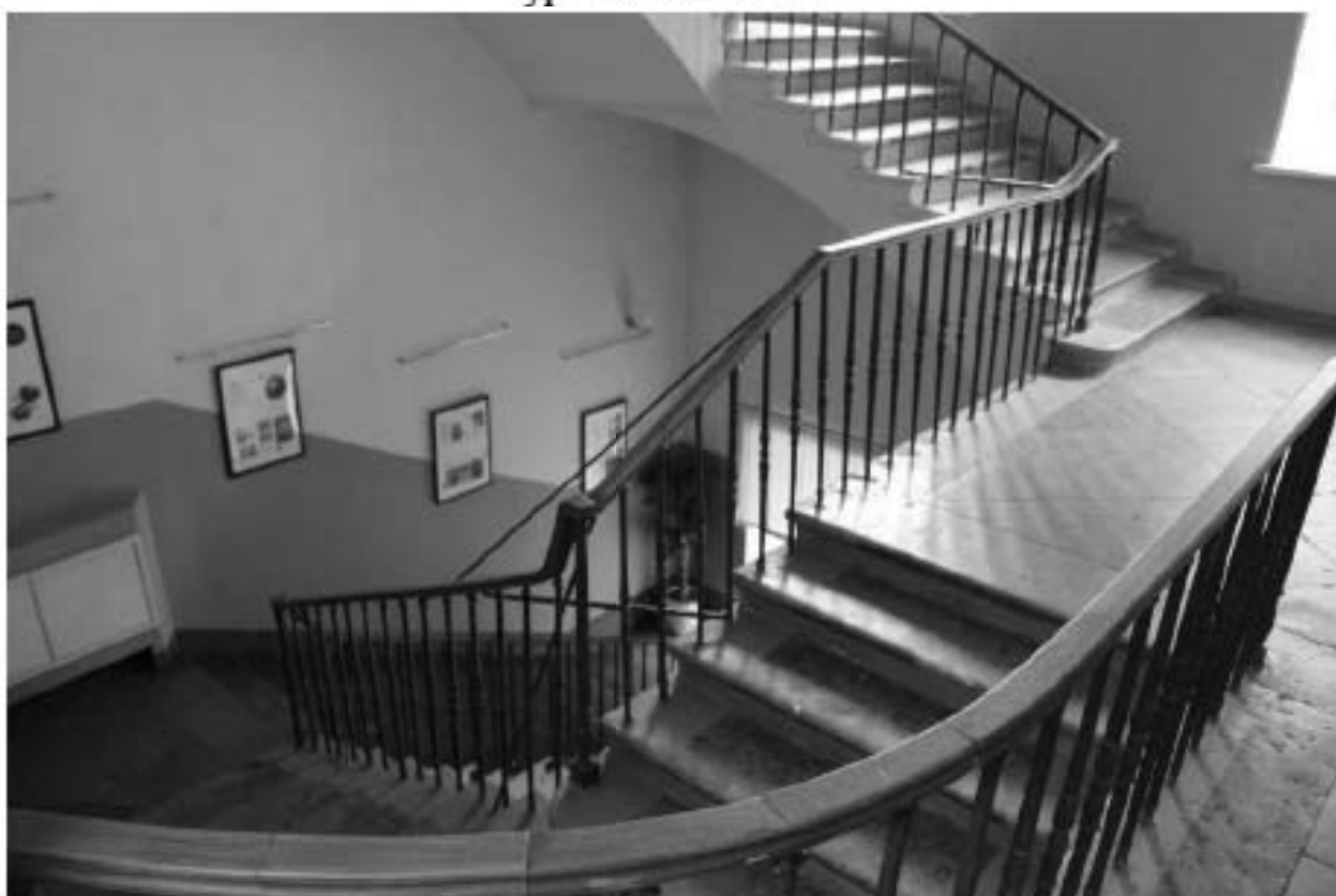
Фото 170. Выявленный объект культурного наследия «Здание Марининской женской гимназии». Вид на лестницу 10ЛК (ул. Ломоносова, д. 11-13, лит. А) в уровне 2-го этажа.
