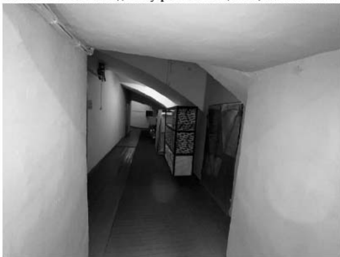
Фото 226. Выявленный объект культурного наследия «Здание Марининской женской гимназии». Вид на внутренние помещения цокольного этажа.
