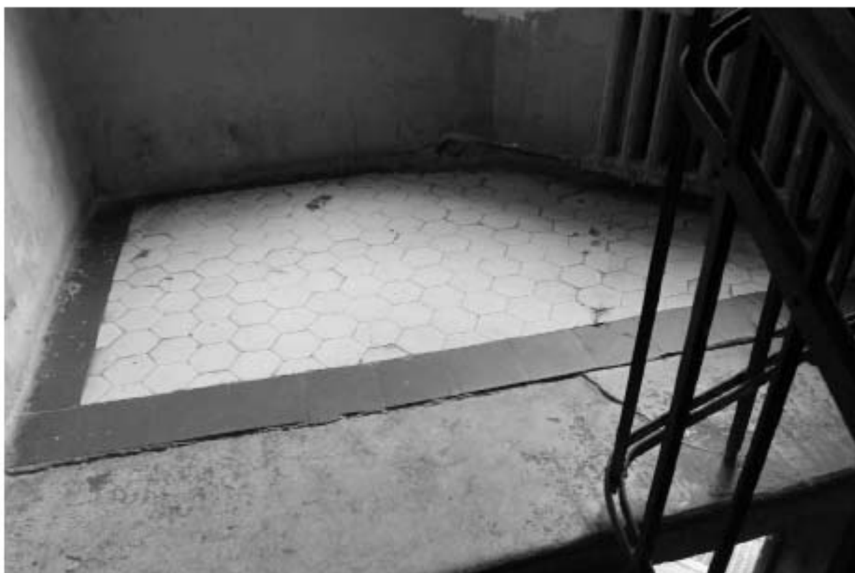
Фото 113. Выявленный объект культурного наследия «Доходный дом». Вид на лестницу БЛК в уровне 1-го – 2-го этажей.
