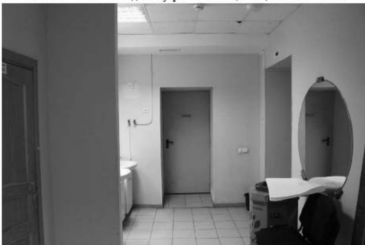
Фото 233. Выявленный объект культурного наследия «Здание Марининской женской гимназии». Вид на внутренние помещения цокольного этажа.
