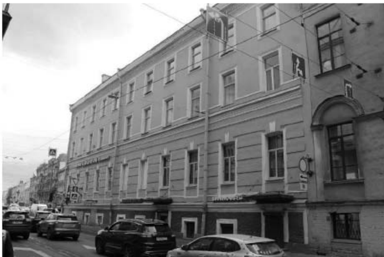
Фото 34. Вид на лицевой фасад по улице Ломоносова углового трехэтажного корпуса выявленного объекта культурного наследия «Здание Марининской женской гимназии».
