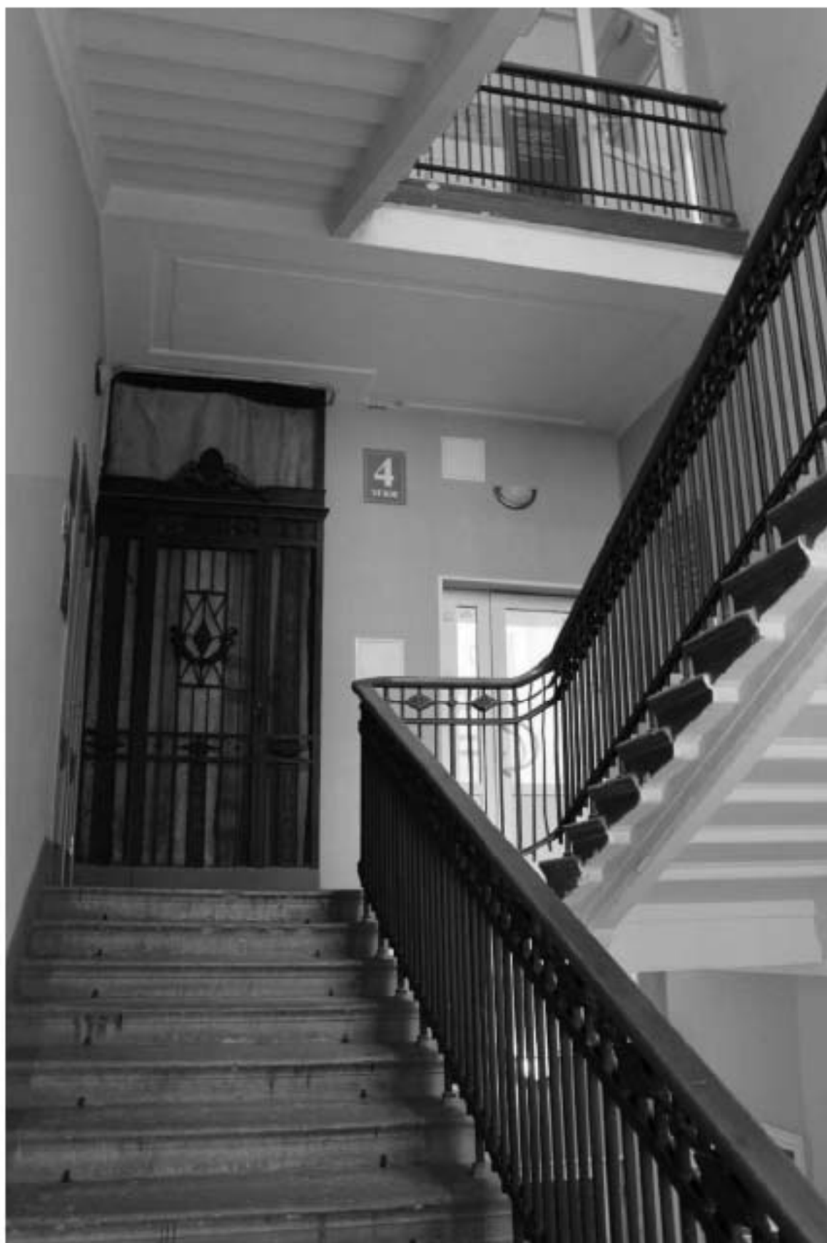
Фото 95. Выявленный объект культурного наследия «Доходный дом». Вид на лестницу 4ЛК в уровне 4-го этажа.
