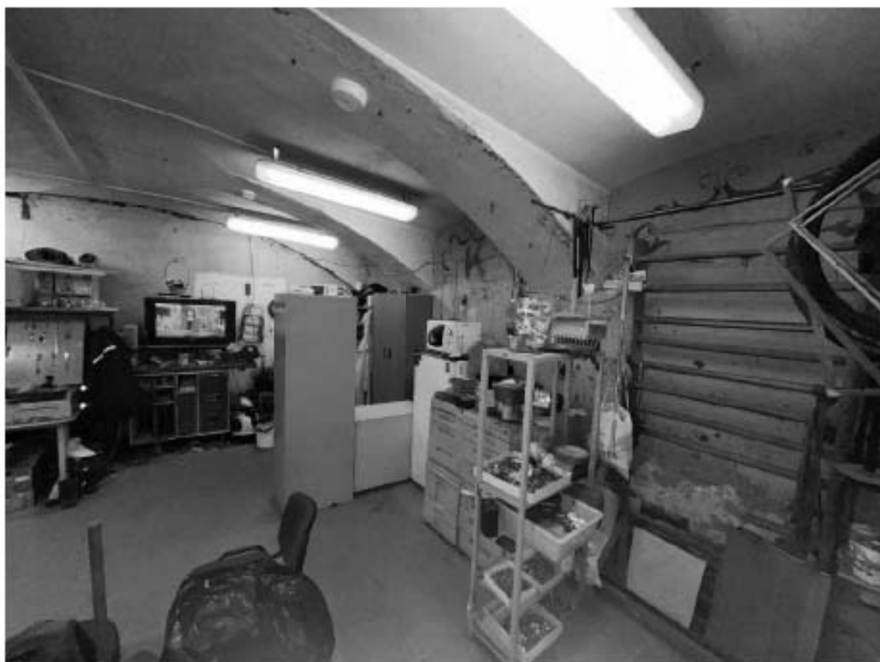
Фото 219. Выявленный объект культурного наследия «Здание Марининской женской гимназии». Вид на внутренние помещения цокольного этажа.
