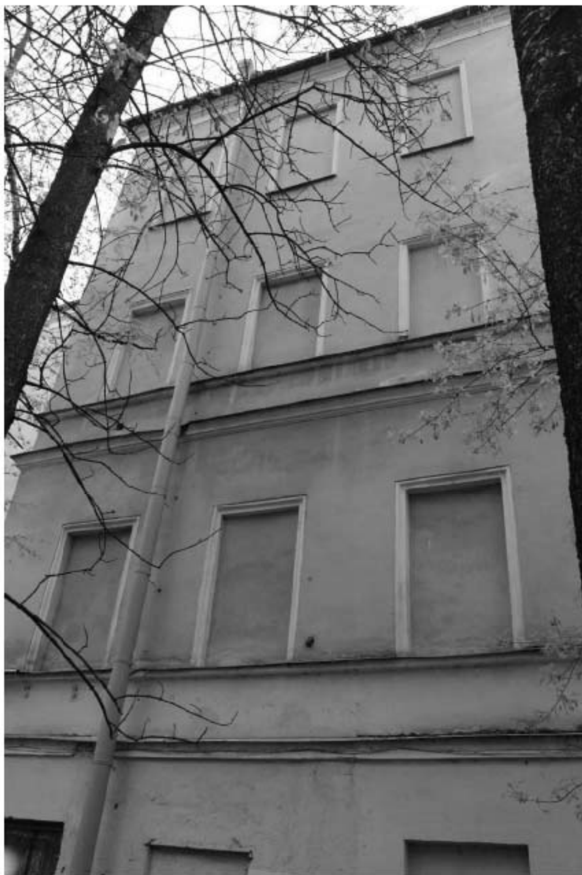
Фото 50. Вид на дворовые фасады четырехэтажной части двух-четырёхэтажного корпуса выявленного объекта культурного наследия «Здание Марининской женской гимназии», обращенные во внутренний двор.
