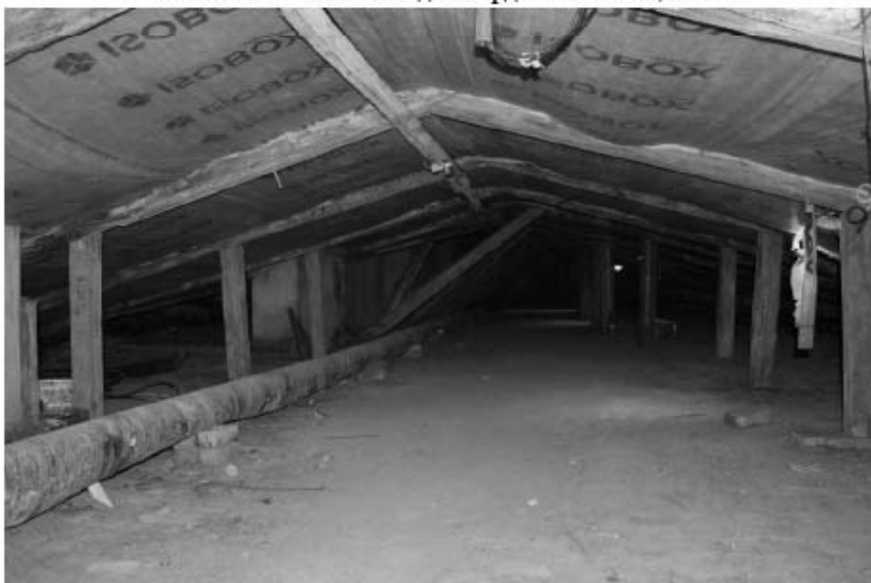
Фото 181. Выявленный объект культурного наследия «Здание Марининской женской гимназии». Вид на чердачные помещения.
