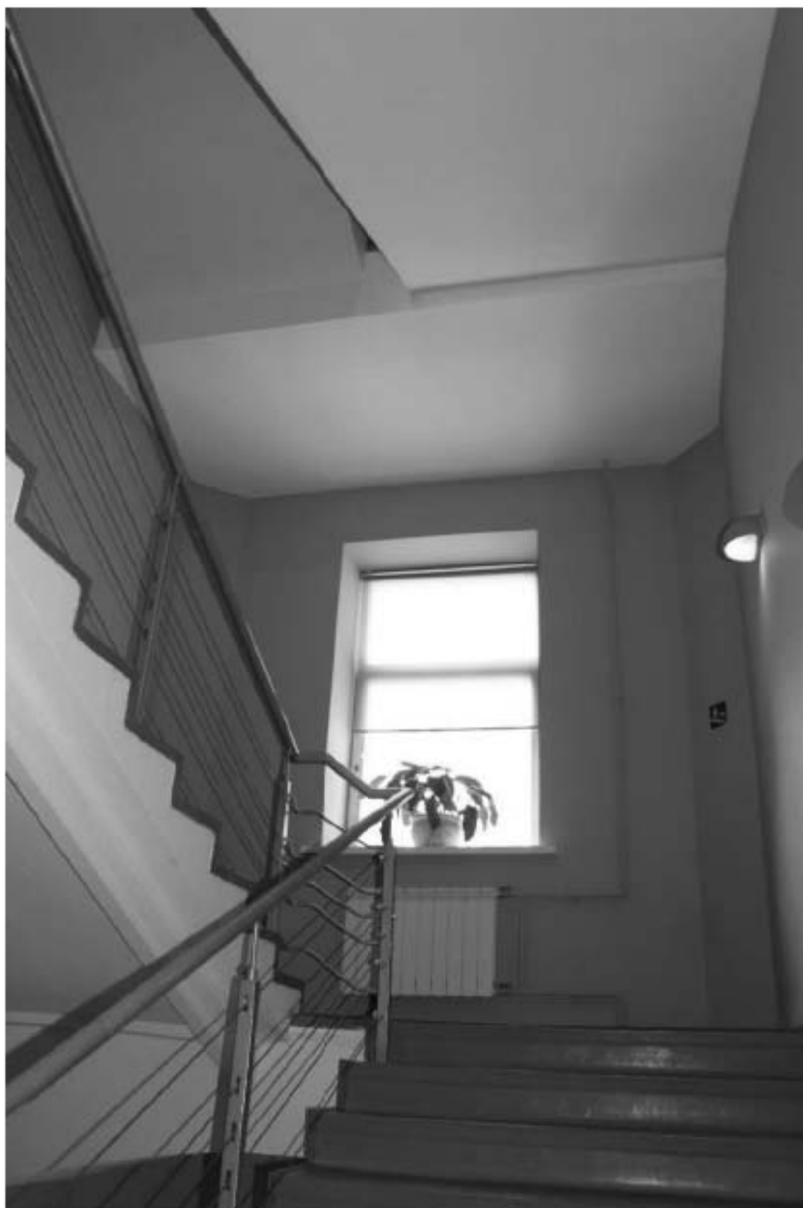
Фото 200. Выявленный объект культурного наследия «Здание Марининской женской гимназии». Вид на лестницу 1ЛК (Загородный пр., д. 13, лит. А) в уровне 2-го – 3-го этажей.
