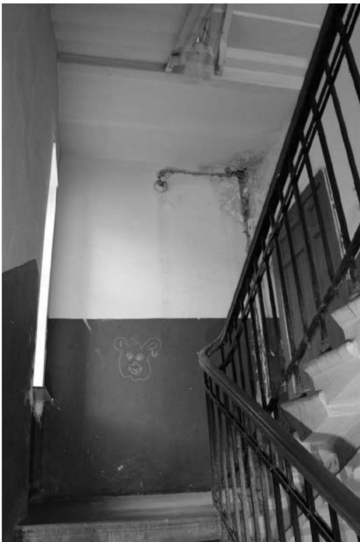
Фото 104. Выявленный объект культурного наследия «Доходный дом». Вид на лестницу 5ЛК в уровне 4-го этажа.
