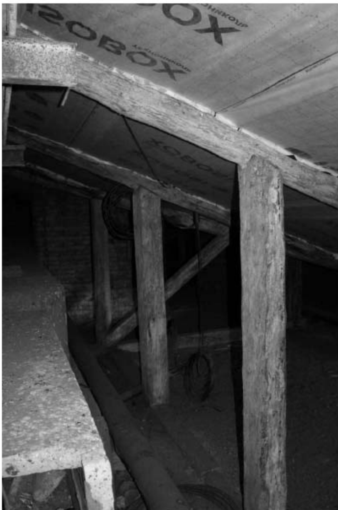
Фото 84. Выявленный объект культурного наследия «Доходный дом». Вид на чердачные помещения.
