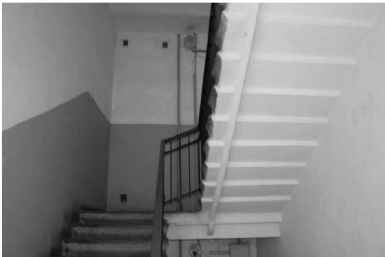
Фото 119. Выявленный объект культурного наследия «Доходный дом». Вид на лестницу БЛК в уровне 4-го этажа.
