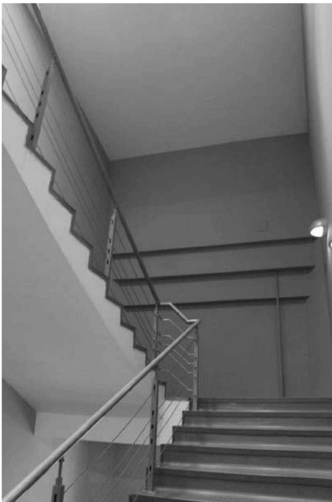
Фото 202. Выявленный объект культурного наследия «Здание Марининской женской гимназии». Вид на лестницу 1ЛК (Загородный пр., д. 13, лит. А) в уровне 3-го - мансардного этажей.
