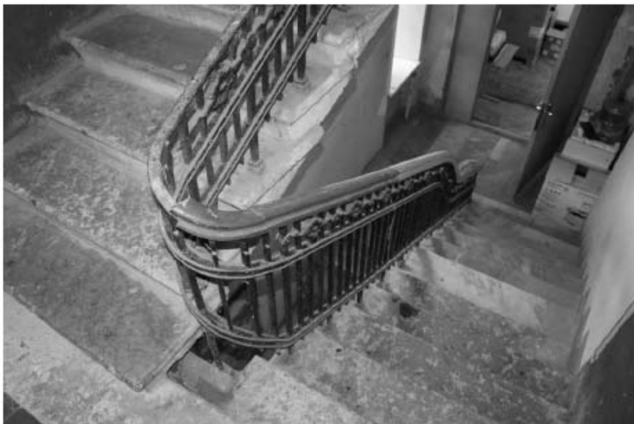
Фото 99. Выявленный объект культурного наследия «Доходный дом». Вид на лестницу 5ЛК в уровне 1-го – 2-го этажей.
