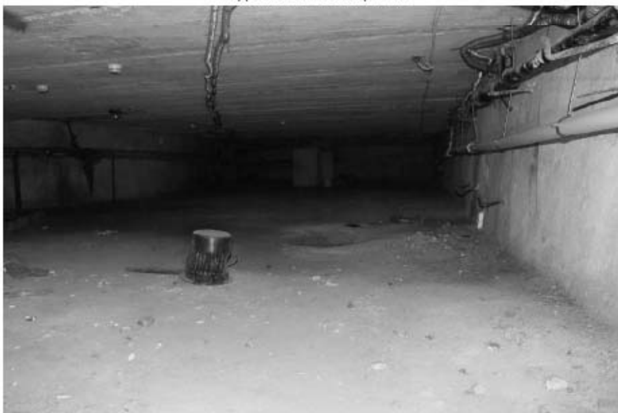
Фото 69. Выявленный объект культурного наследия «Доходный дом». Вид на подвальные помещения.
