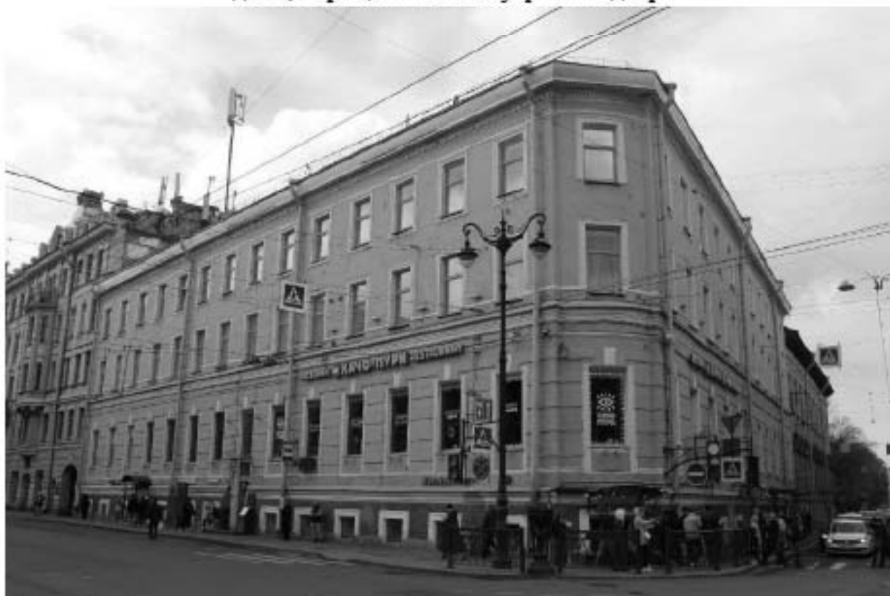
Фото 31. Вид на лицевые фасады углового трехэтажного корпуса выявленного объекта культурного наследия «Здание Марининской женской гимназии».
