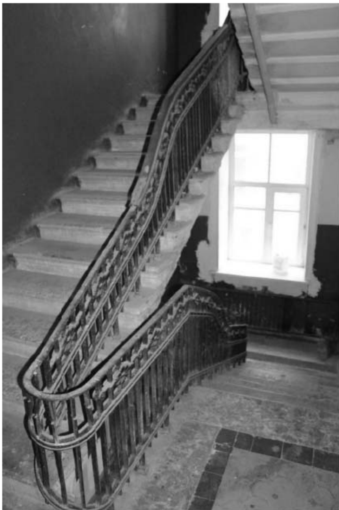
Фото 100. Выявленный объект культурного наследия «Доходный дом». Вид на лестницу 5ЛК в уровне 2-го этажа.
