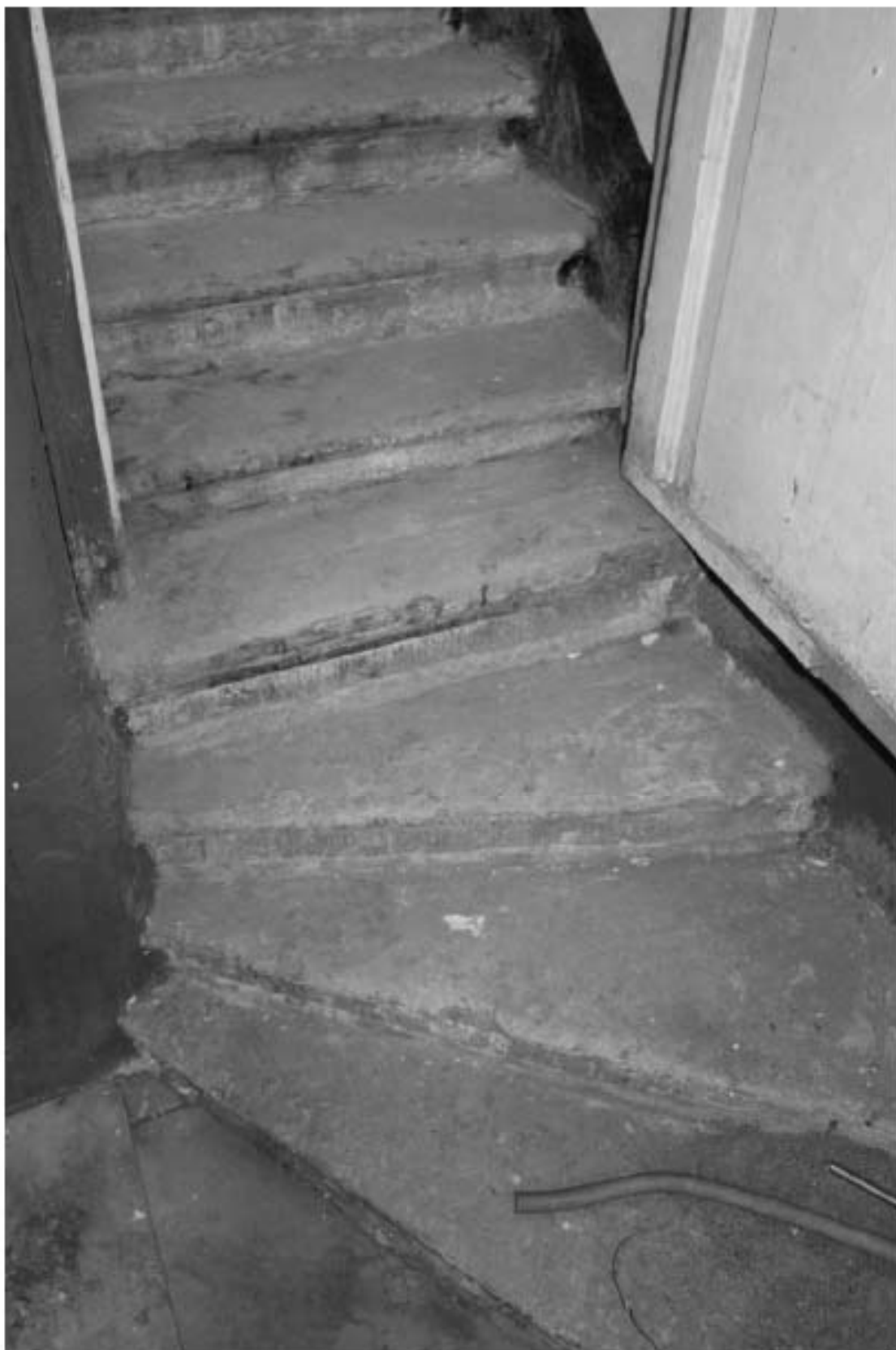
Фото 151. Выявленный объект культурного наследия «Здание Марининской женской гимназии». Вид на лестницу 9ЛК (ул. Ломоносова, д. 11-13, лит. А) в уровне 1-го этажа.
