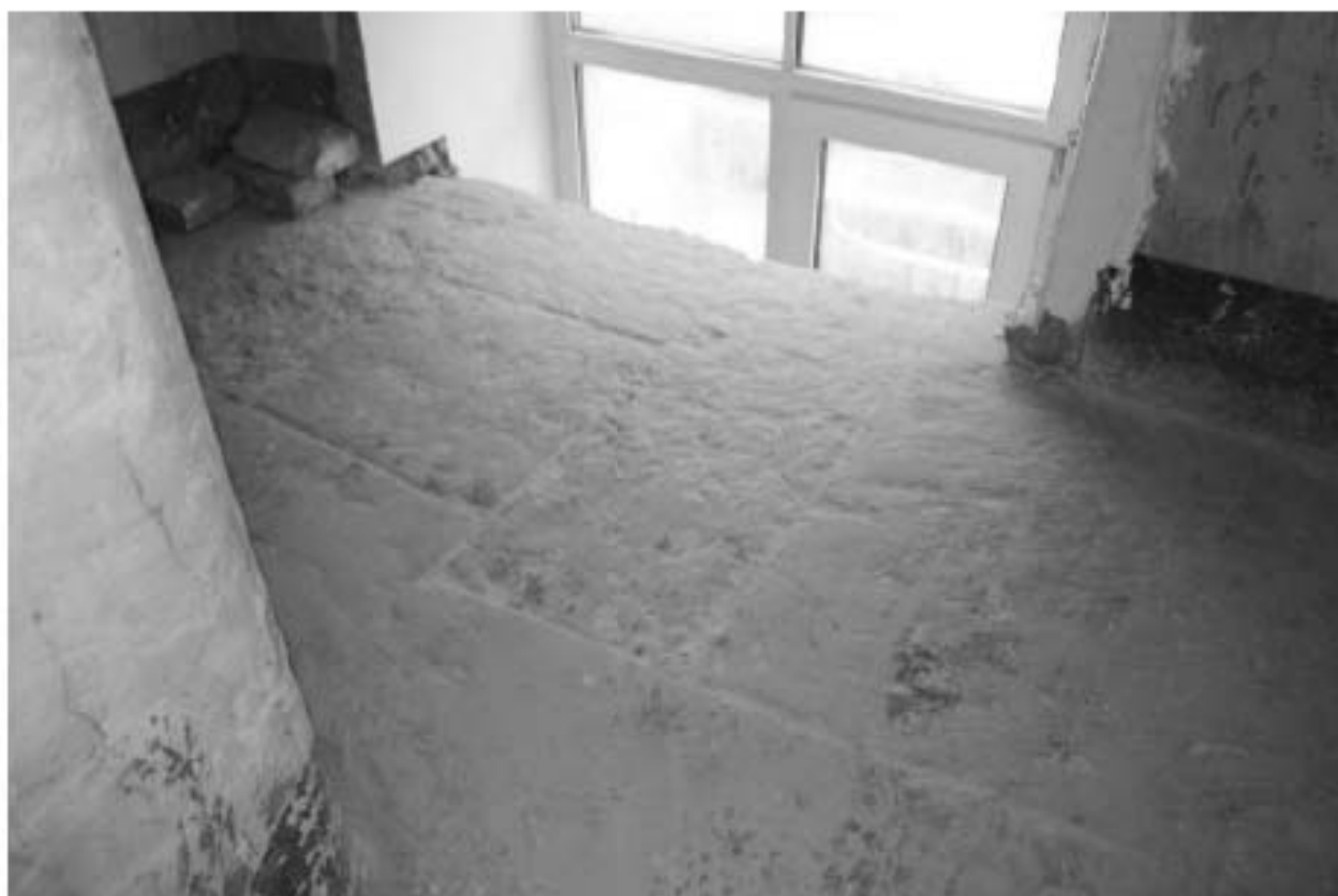
Фото 154. Выявленный объект культурного наследия «Здание Марининской женской гимназии». Вид на лестницу 9ЛК (ул. Ломоносова, д. 11-13, лит. А) в уровне 2-го – 3-го этажей.
