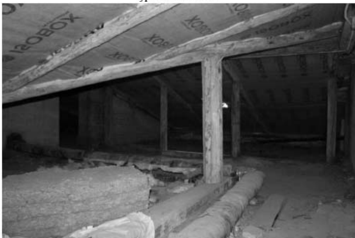
Фото 179. Выявленный объект культурного наследия «Здание Марининской женской гимназии». Вид на чердачные помещения.
