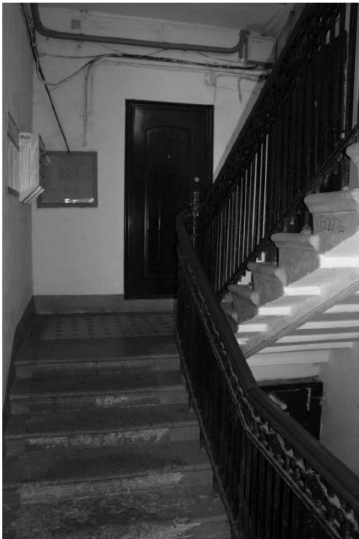
Фото 136. Выявленный объект культурного наследия «Доходный дом». Вид на лестницу 8ЛК в уровне 1-го этажа.
