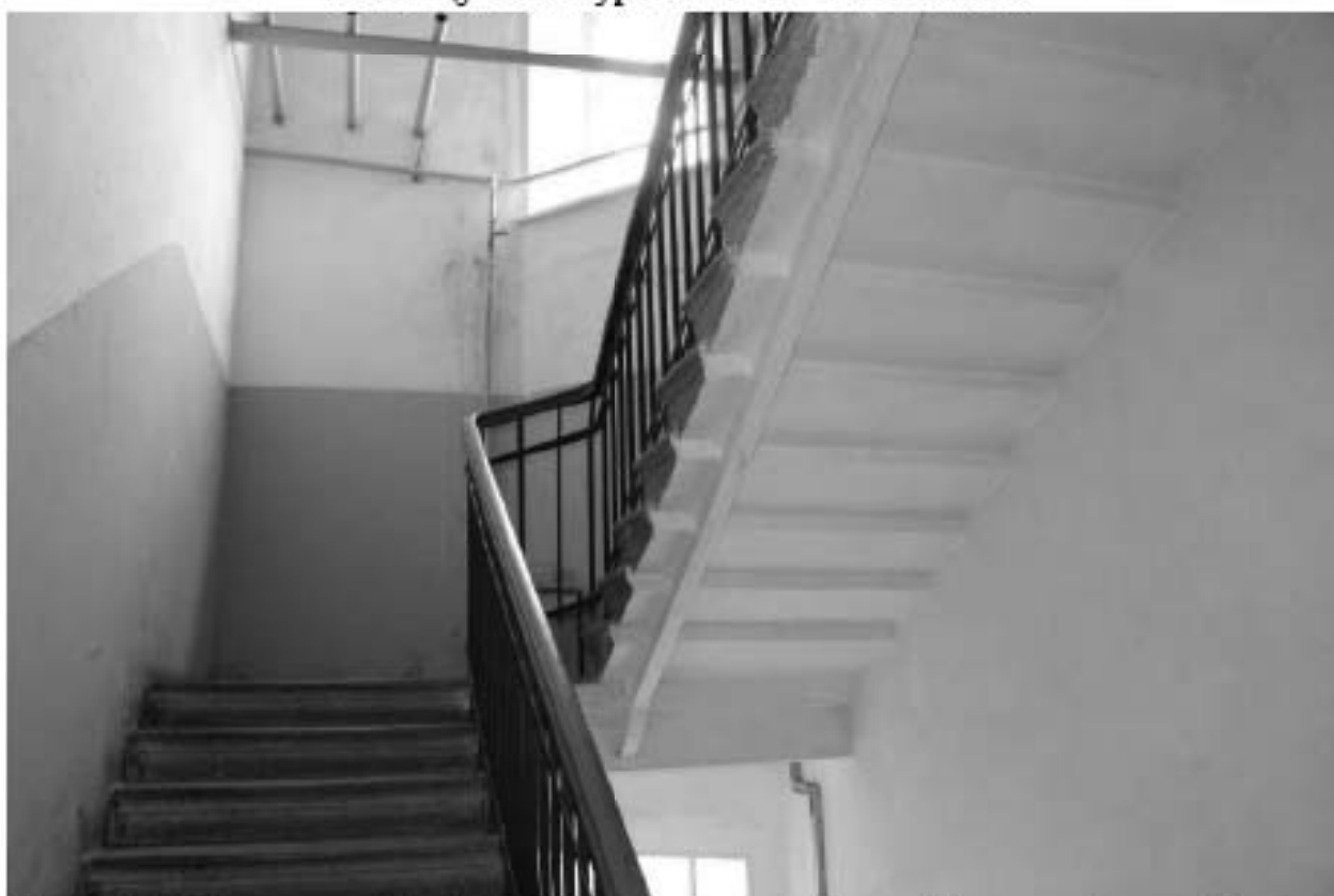
Фото 122. Выявленный объект культурного наследия «Доходный дом». Вид на лестницу БЛК в уровне 4-го – 5-го этажей.
