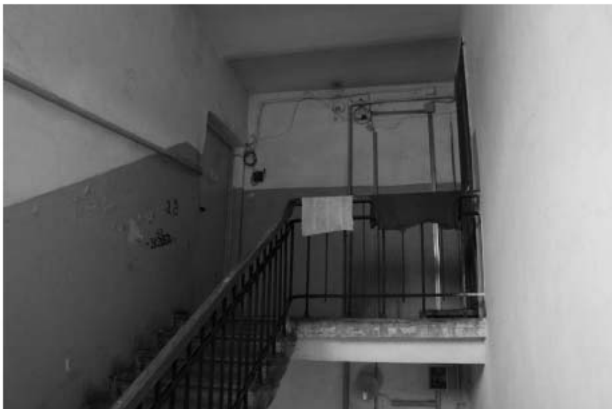
Фото 123. Выявленный объект культурного наследия «Доходный дом». Вид на лестницу 6ЛК в уровне 5-го этажа.
