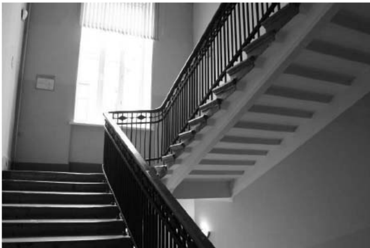
Фото 96. Выявленный объект культурного наследия «Доходный дом». Вид на лестницу 4ЛК в уровне 4-го – 5-го этажей.
