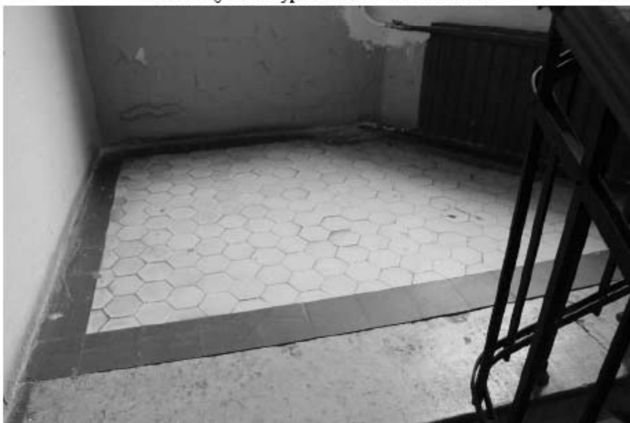
Фото 118. Выявленный объект культурного наследия «Доходный дом». Вид на лестницу БЛК в уровне 3-го – 4-го этажей.
