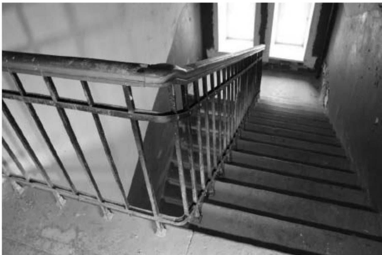
Фото 107. Выявленный объект культурного наследия «Доходный дом». Вид на лестницу 5ЛК в уровне чердачного этажа.
