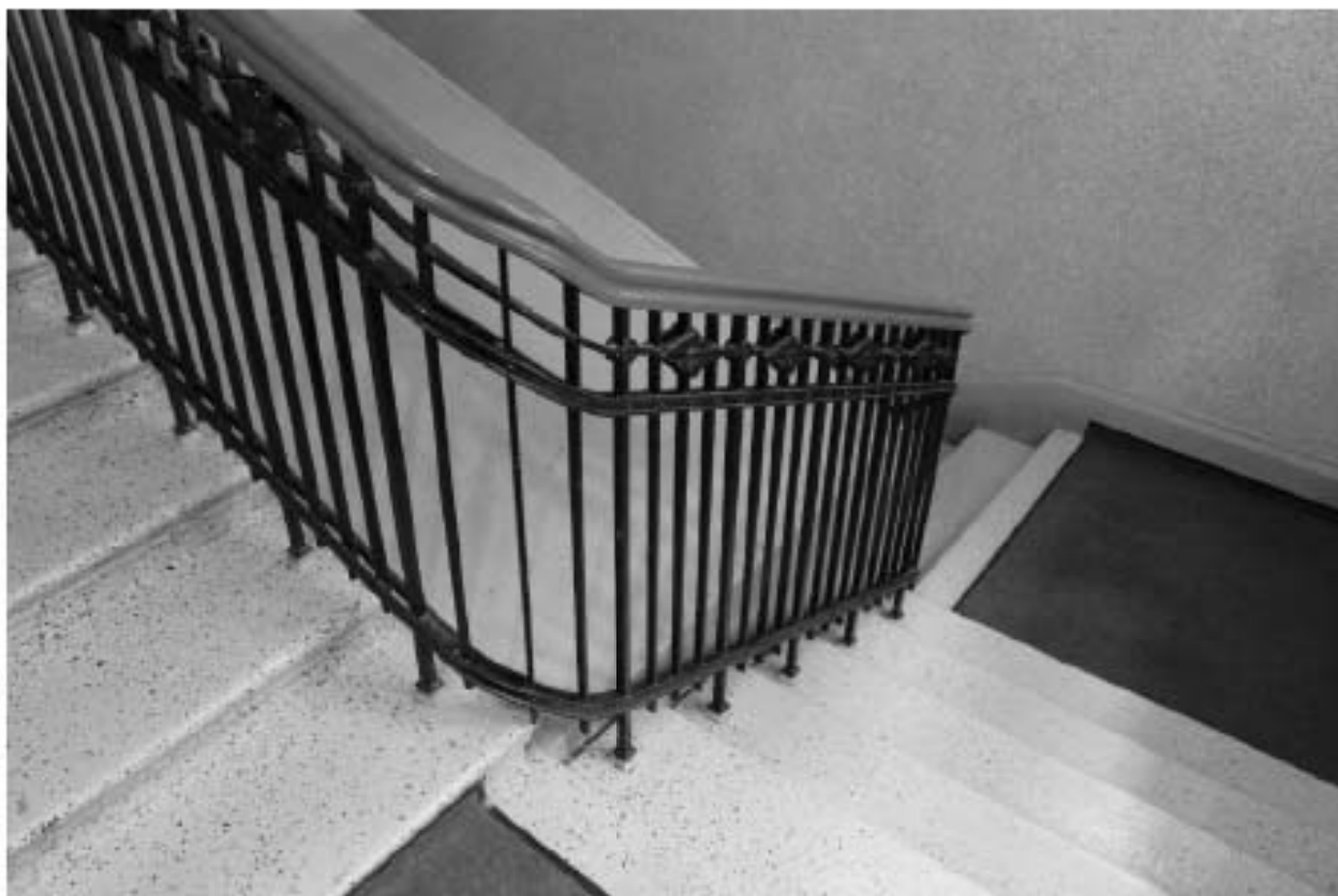
Фото 56. Выявленный объект культурного наследия «Доходный дом». Вид на лестницу 2ЛК в уровне 1-го – 2-го этажей.
