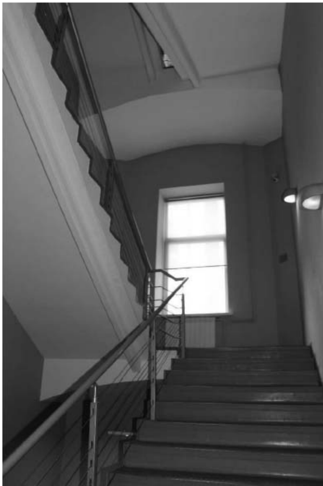
Фото 198. Выявленный объект культурного наследия «Здание Марининской женской гимназии». Вид на лестницу 1ЛК (Загородный пр., д. 13, лит. А) в уровне 1-го – 2-го этажей.
