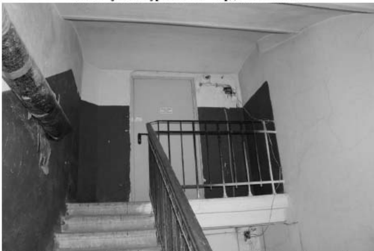
Фото 81. Выявленный объект культурного наследия «Доходный дом». Вид на лестницу 3ЛК в уровне чердачного этажа.
