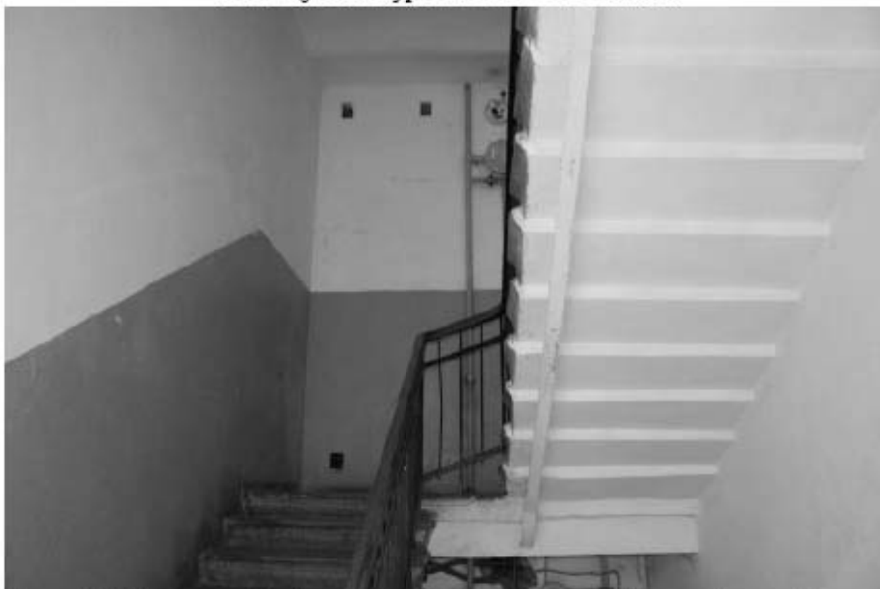
Фото 116. Выявленный объект культурного наследия «Доходный дом». Вид на лестницу БЛК в уровне 3-го этажа.
