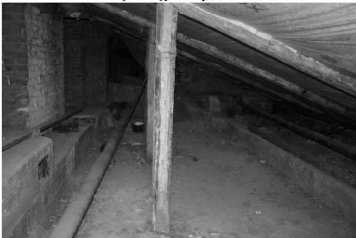
Фото 108. Выявленный объект культурного наследия «Доходный дом». Вид на чердачные помещения.
