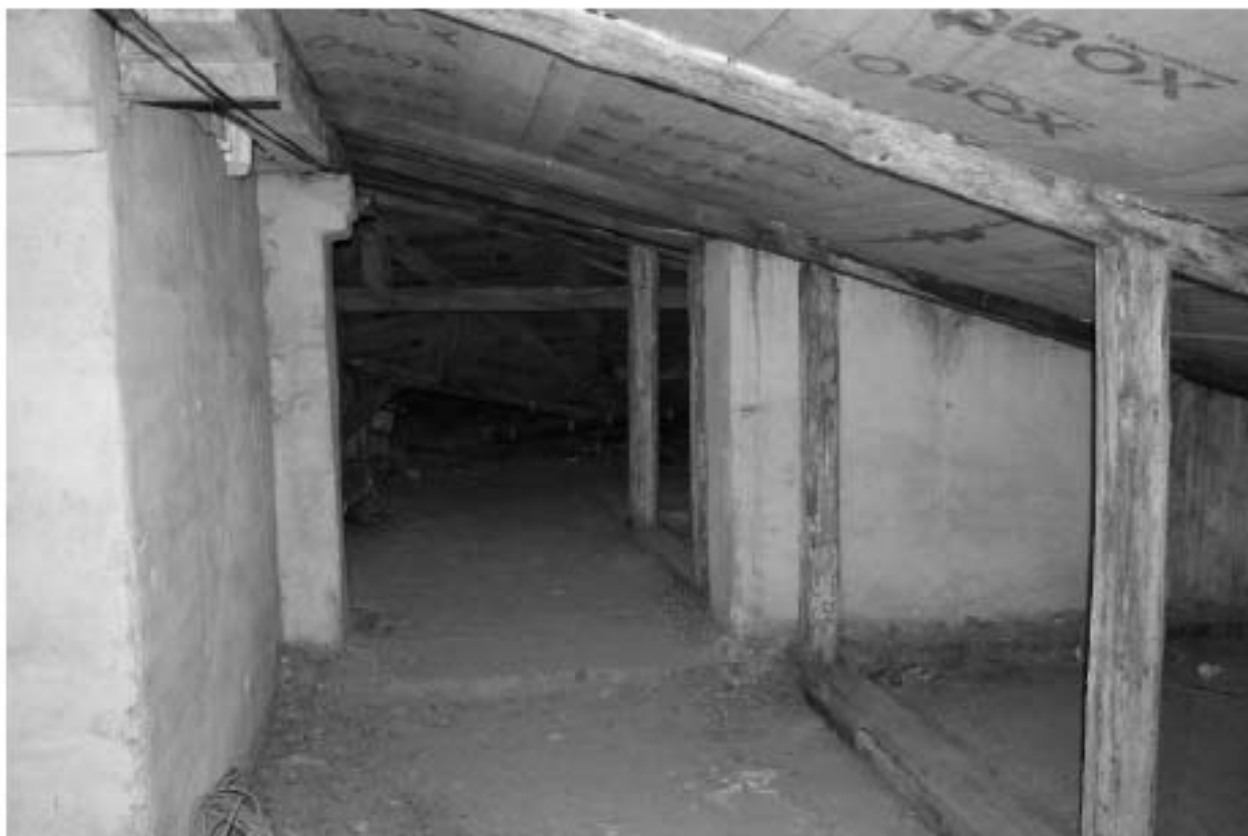
Фото 182. Выявленный объект культурного наследия «Здание Марининской женской гимназии». Вид на чердачные помещения.
