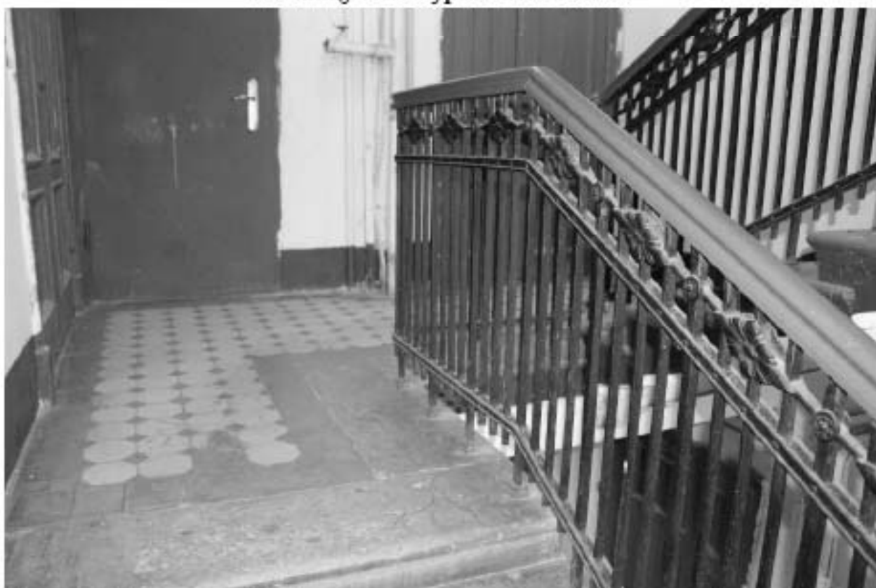
Фото 126. Выявленный объект культурного наследия «Доходный дом». Вид на лестницу 7ЛК в уровне 2-го этажа.
