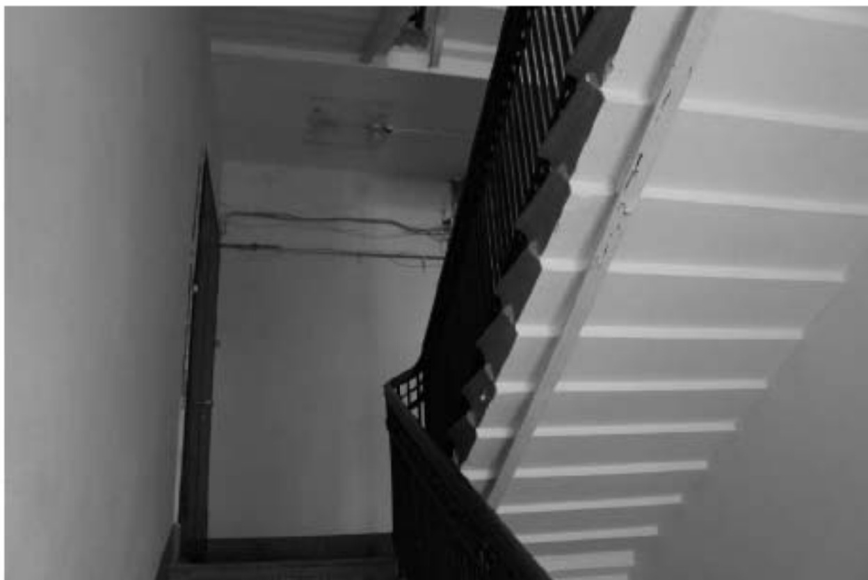
Фото 141. Выявленный объект культурного наследия «Доходный дом». Вид на лестницу 8ЛК в уровне 4-го этажа.
