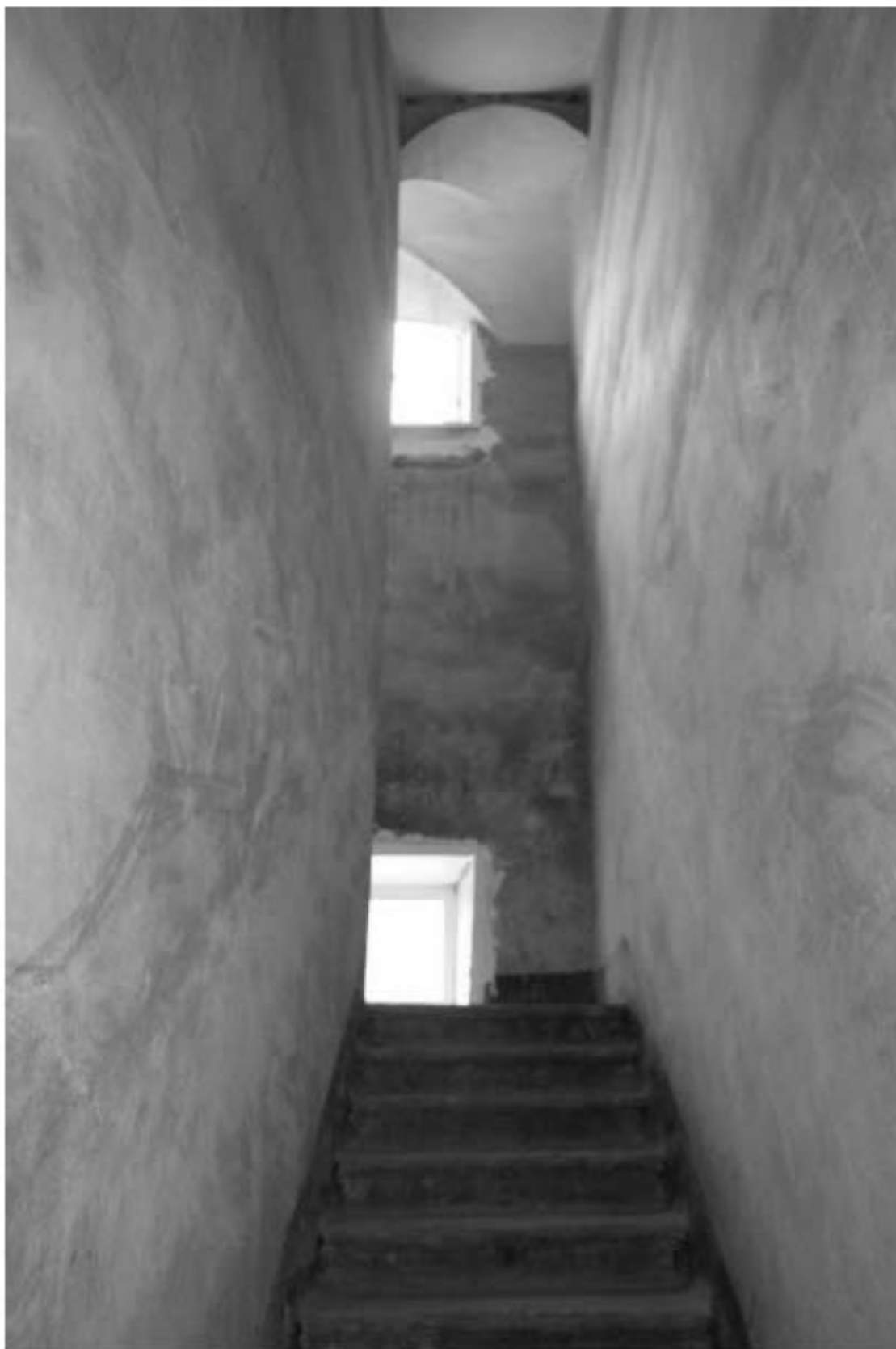
Фото 153. Выявленный объект культурного наследия «Здание Марининской женской гимназии». Вид на лестницу 9ЛК (ул. Ломоносова, д. 11-13, лит. А) в уровне 2-го – 3-го этажей.
