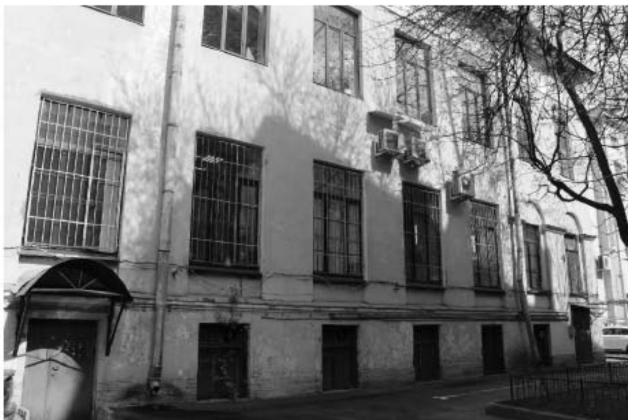
Фото 43. Вид на дворовый фасад двухэтажной части двух-четырёхэтажного корпуса выявленного объекта культурного наследия «Здание Марининской женской гимназии».
