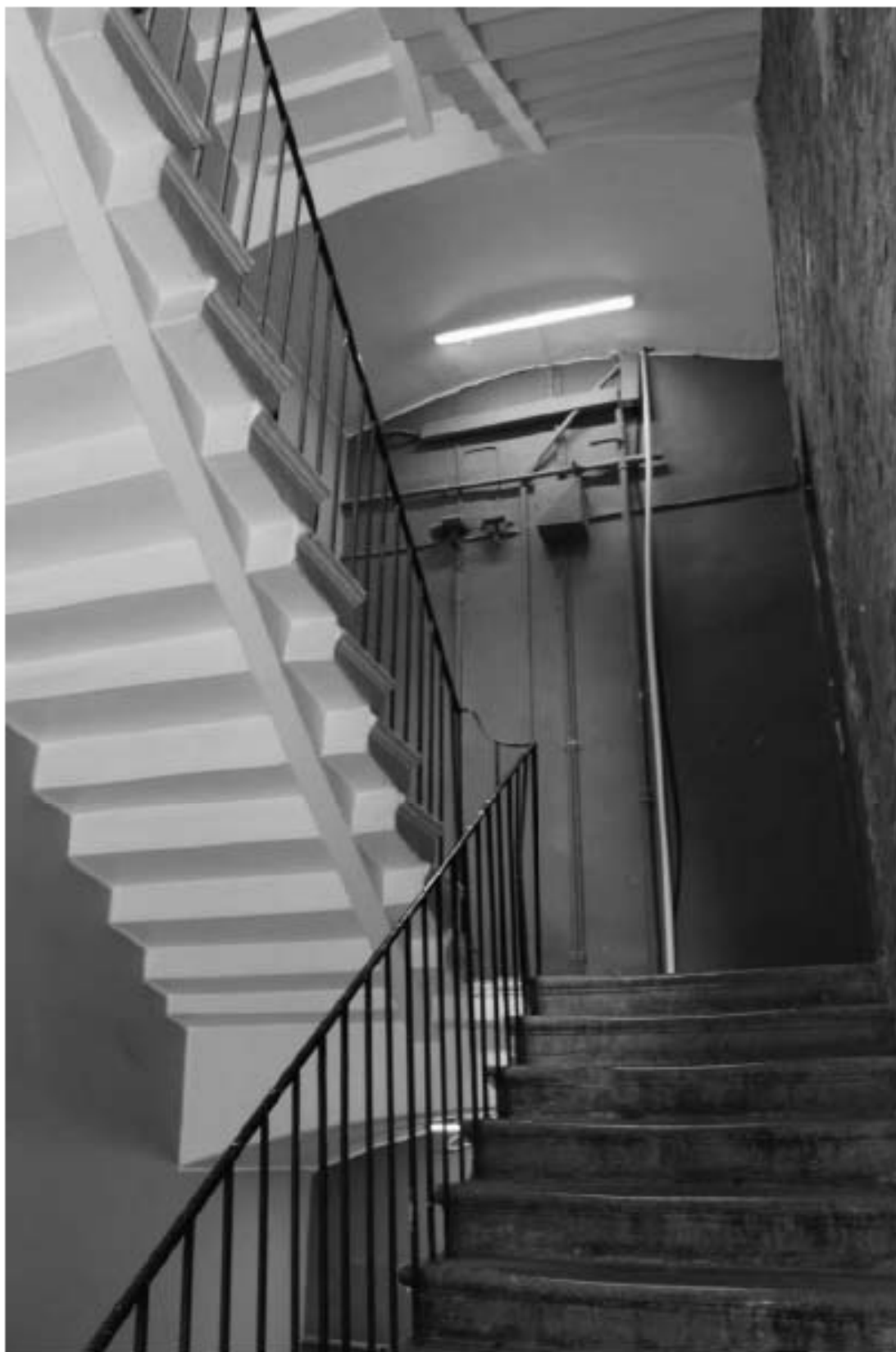
Фото 212. Выявленный объект культурного наследия «Здание Марининской женской гимназии». Вид на лестницу 5ЛК (Загородный пр., д. 13, лит. А) в уровне 2-го этажа.
