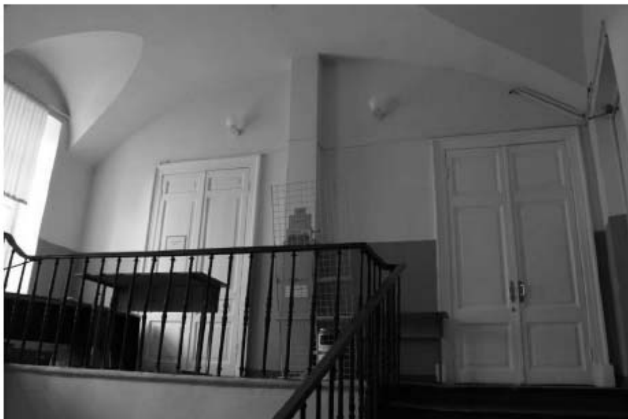
Фото 165. Выявленный объект культурного наследия «Здание Марининской женской гимназии». Вид на лестницу 10ЛК (ул. Ломоносова, д. 11-13, лит. А) в уровне 1-го этажа.
