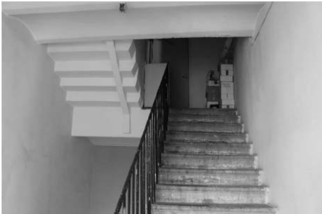
Фото 209. Выявленный объект культурного наследия «Здание Марининской женской гимназии». Вид на лестницу 4ЛК (Загородный пр., д. 13, лит. А) в уровне мансардного этажа.
