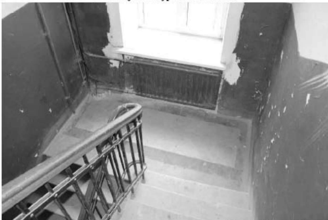
Фото 73. Выявленный объект культурного наследия «Доходный дом». Вид на лестницу ЗЛК в уровне 2-го – 3-го этажей.
