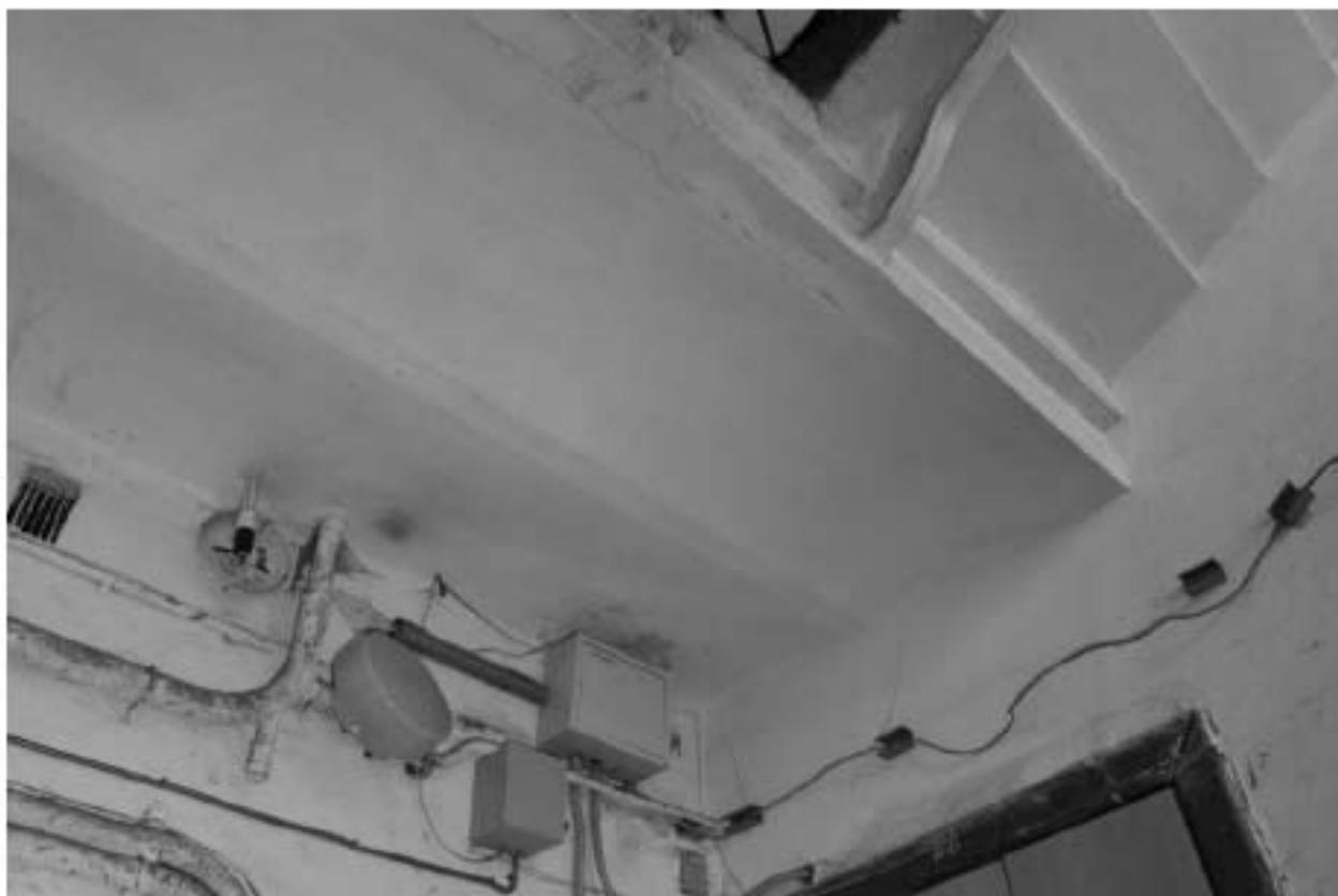
Фото 111. Выявленный объект культурного наследия «Доходный дом». Вид на лестницу БЛК в уровне 1-го этажа.
