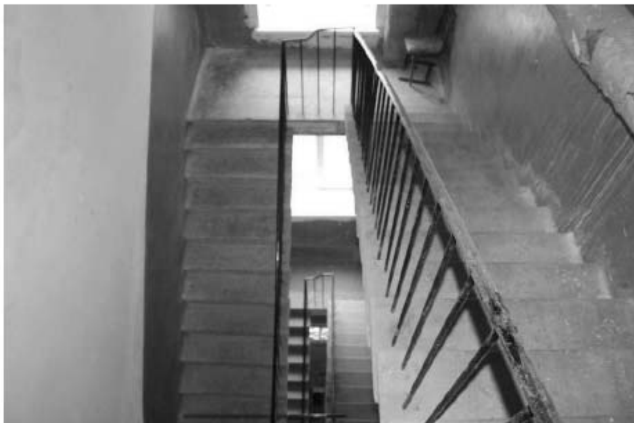
Фото 178. Выявленный объект культурного наследия «Здание Марининской женской гимназии». Вид на лестницу 12ЛК (ул. Ломоносова, д. 11-13, лит. А) в уровне 4-го этажа.
