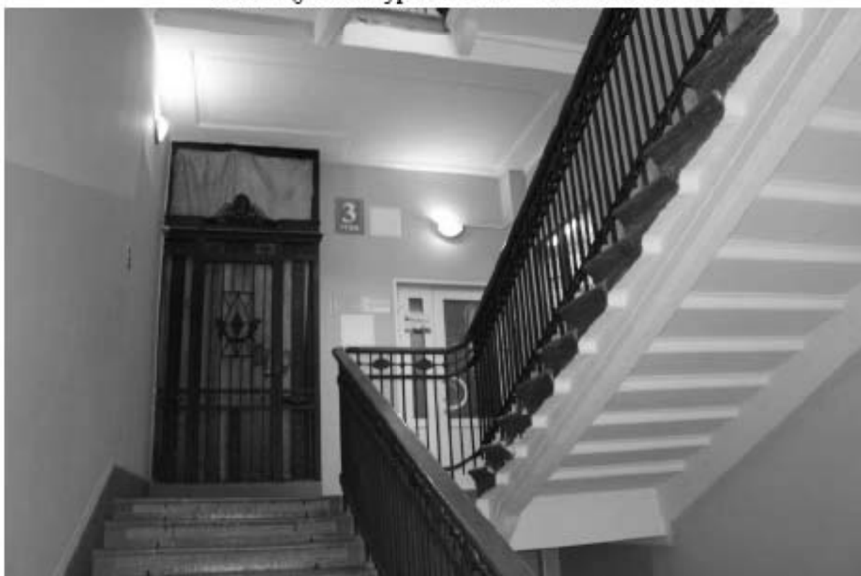
Фото 93. Выявленный объект культурного наследия «Доходный дом». Вид на лестницу 4ЛК в уровне 3-го этажа.
