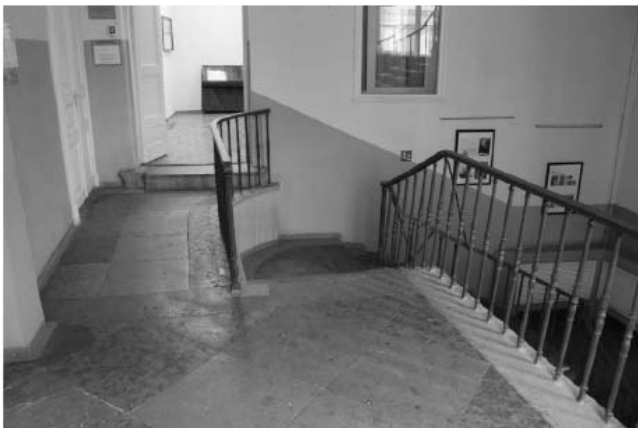
Фото 169. Выявленный объект культурного наследия «Здание Марининской женской гимназии». Вид на лестницу 10ЛК (ул. Ломоносова, д. 11-13, лит. А) в уровне 2-го этажа.
