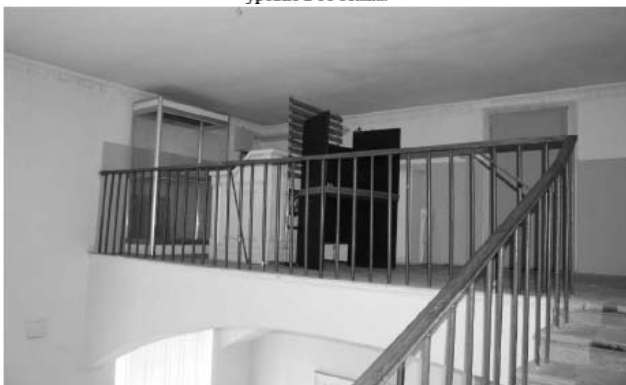
Фото 172. Выявленный объект культурного наследия «Здание Марининской женской гимназии». Вид на лестницу 10ЛК (ул. Ломоносова, д. 11-13, лит. А) в уровне чердачного этажа.
