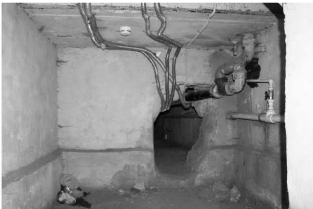
Фото 68. Выявленный объект культурного наследия «Доходный дом». Вид на подвальные помещения.
