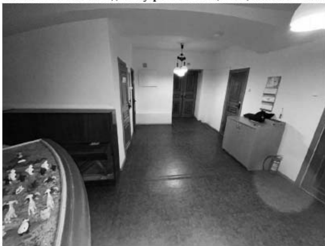
Фото 222. Выявленный объект культурного наследия «Здание Марининской женской гимназии». Вид на внутренние помещения цокольного этажа.
