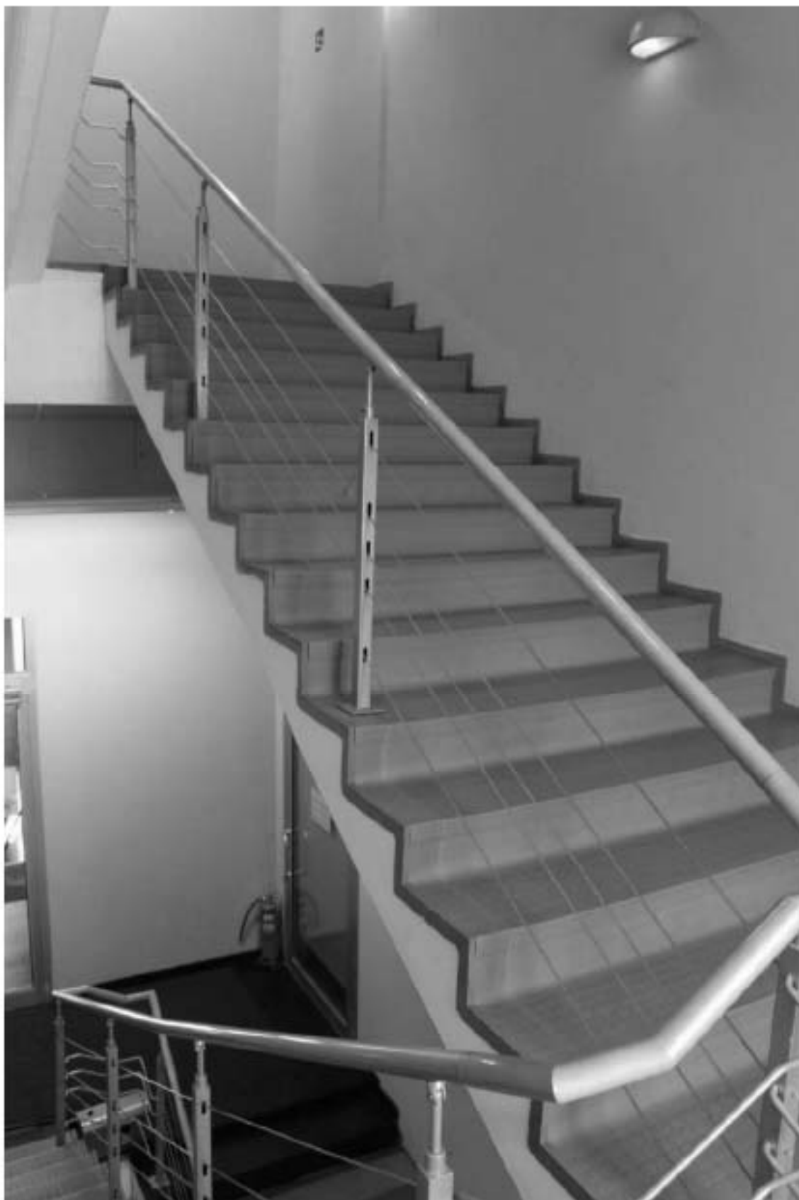
Фото 199. Выявленный объект культурного наследия «Здание Марининской женской гимназии». Вид на лестницу 1ЛК (Загородный пр., д. 13, лит. А) в уровне 2-го – 3-го этажей.
