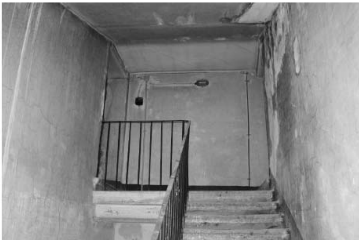
Фото 163. Выявленный объект культурного наследия «Здание Марининской женской гимназии». Вид на лестницу 9ЛК (ул. Ломоносова, д. 11-13, лит. А) в уровне чердачного этажа.
