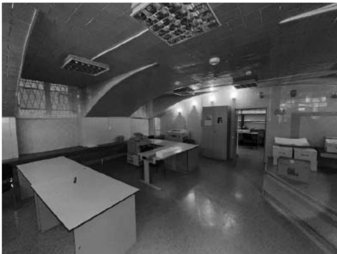
Фото 223. Выявленный объект культурного наследия «Здание Марининской женской гимназии». Вид на внутренние помещения цокольного этажа.
