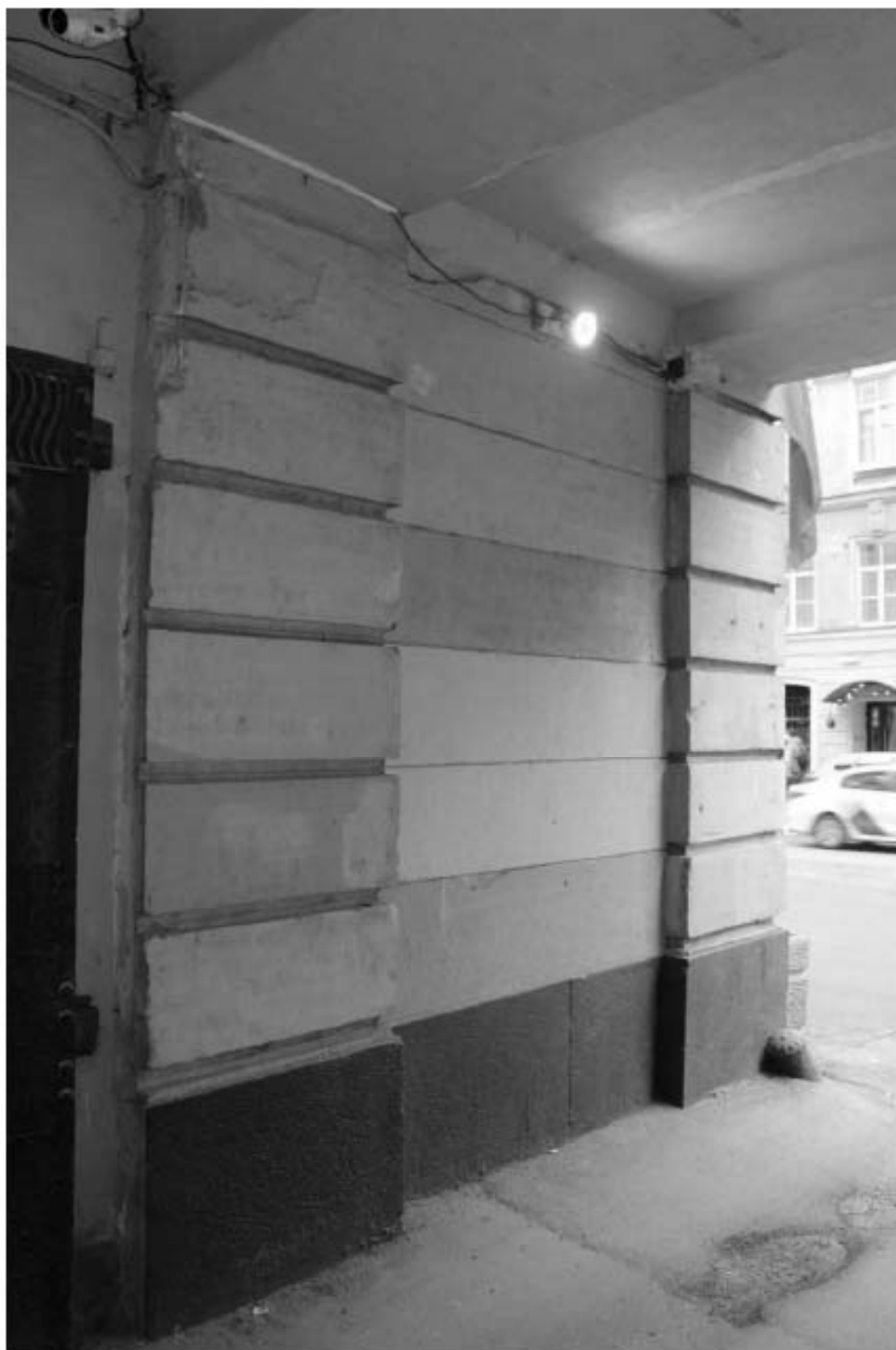
Фото 12. Вид на воротный проезд лицевого корпуса выявленного объекта культурного наследия «Доходный дом».
