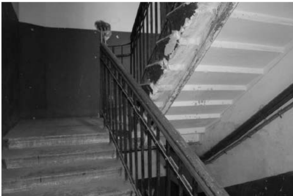
Фото 72. Выявленный объект культурного наследия «Доходный дом». Вид на лестницу ЗЛК в уровне 2-го этажа.
