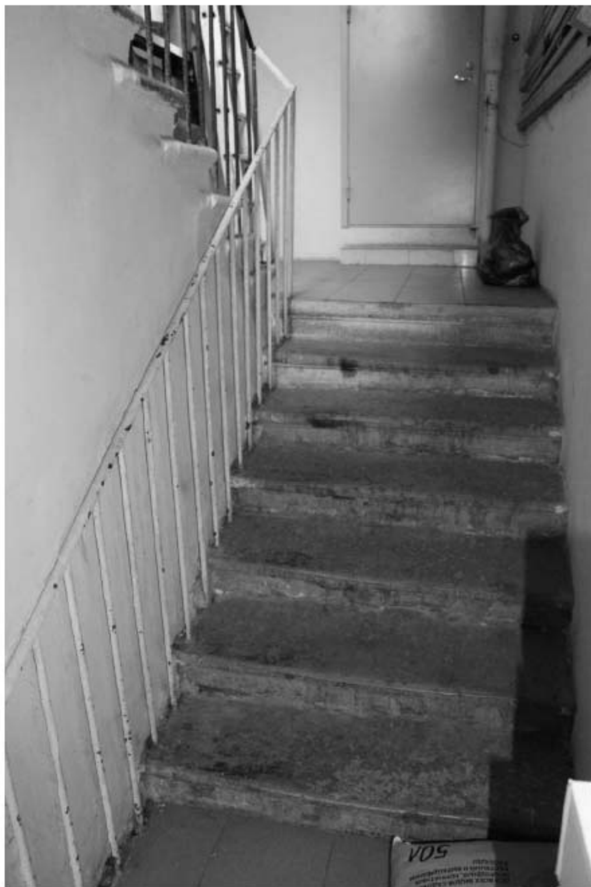
Фото 204. Выявленный объект культурного наследия «Здание Марининской женской гимназии». Вид на лестницу 4ЛК (Загородный пр., д. 13, лит. А) в уровне 1-го этажа.
