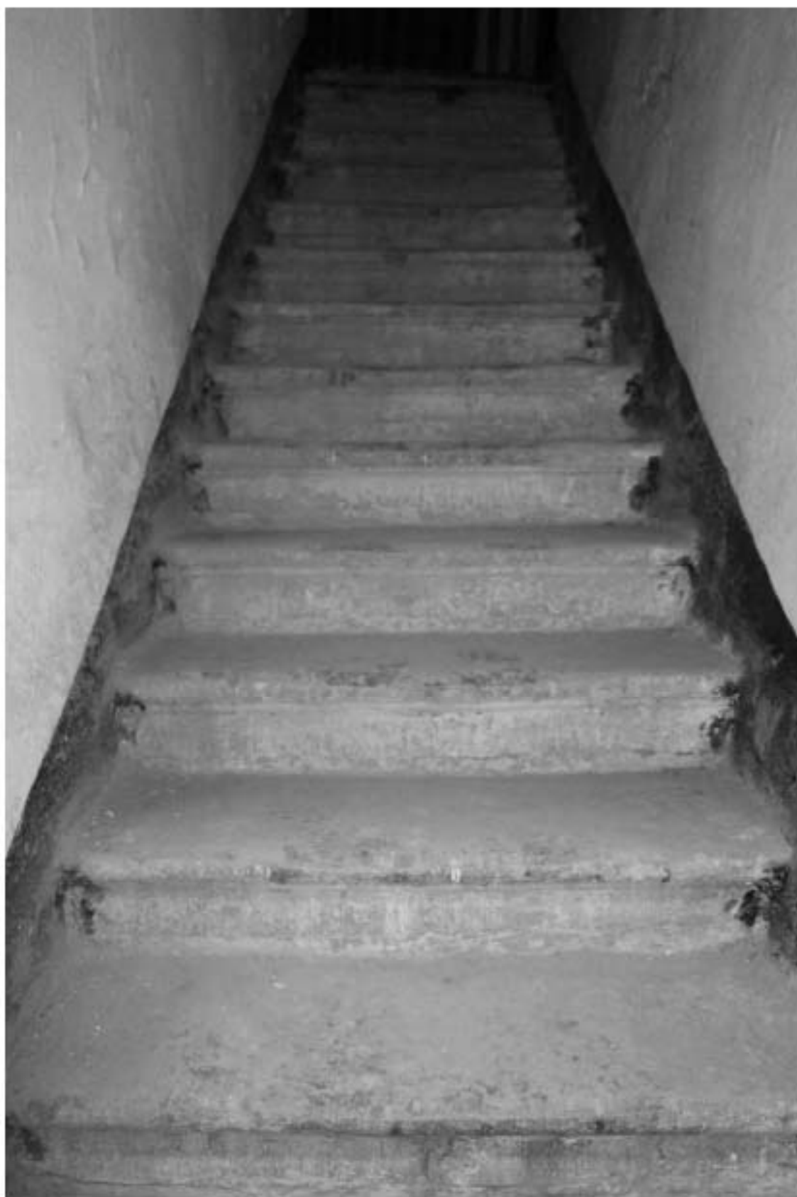
Фото 152. Выявленный объект культурного наследия «Здание Марининской женской гимназии». Вид на лестницу 9ЛК (ул. Ломоносова, д. 11-13, лит. А) в уровне 1-го этажа.
