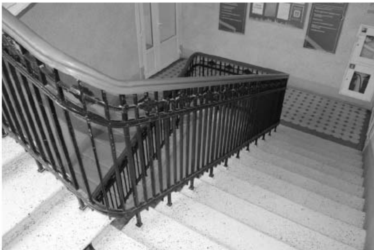
Фото 60. Выявленный объект культурного наследия «Доходный дом». Вид на лестницу 2ЛК в уровне 3-го – 4-го этажей.
