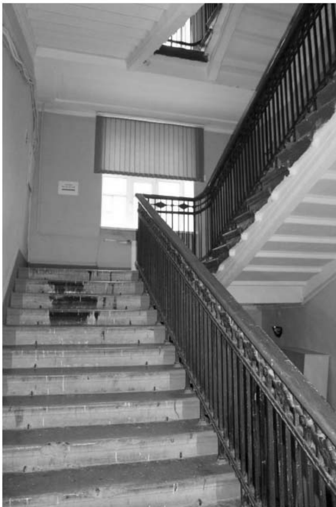
Фото 89. Выявленный объект культурного наследия «Доходный дом». Вид на лестницу 4ЛК в уровне 1-го – 2-го этажей.
