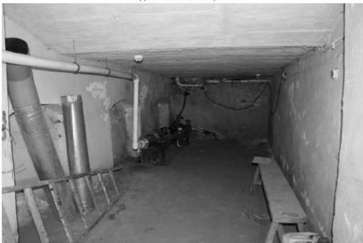
Фото 67. Выявленный объект культурного наследия «Доходный дом». Вид на подвальные помещения.
