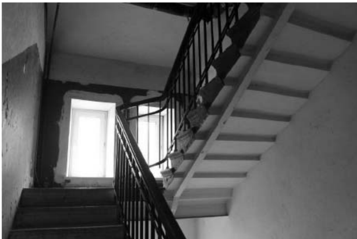
Фото 80. Выявленный объект культурного наследия «Доходный дом». Вид на лестницу 3ЛК в уровне 5-го – чердачного этажей.
