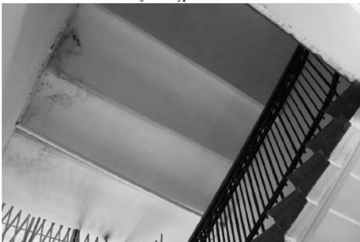
Фото 134. Выявленный объект культурного наследия «Доходный дом». Вид на перекрытие лестницы 7ЛК.
