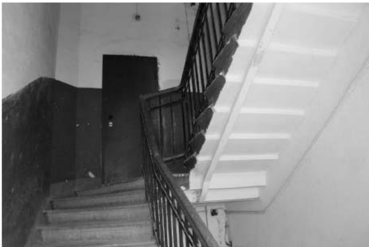
Фото 78. Выявленный объект культурного наследия «Доходный дом». Вид на лестницу ЗЛК в уровне 5-го этажа.
