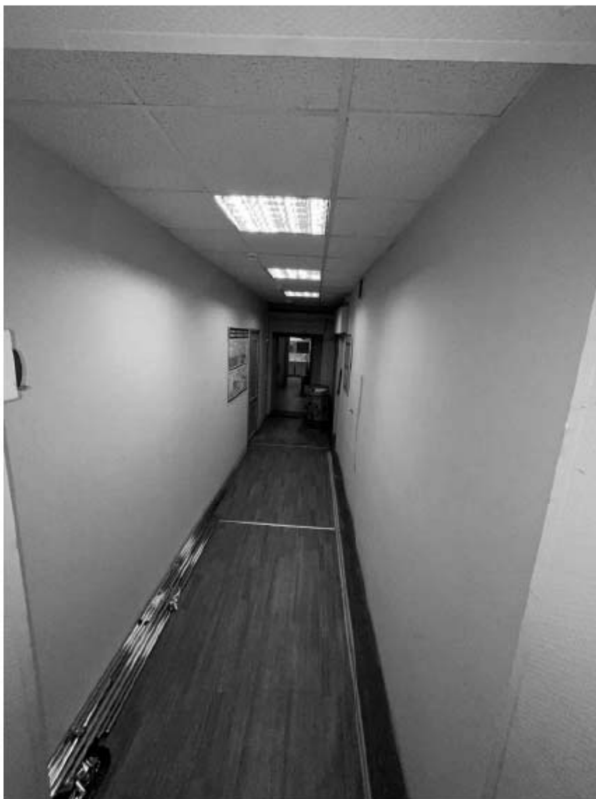
Фото 231. Выявленный объект культурного наследия «Здание Марининской женской гимназии». Вид на внутренние помещения цокольного этажа.
