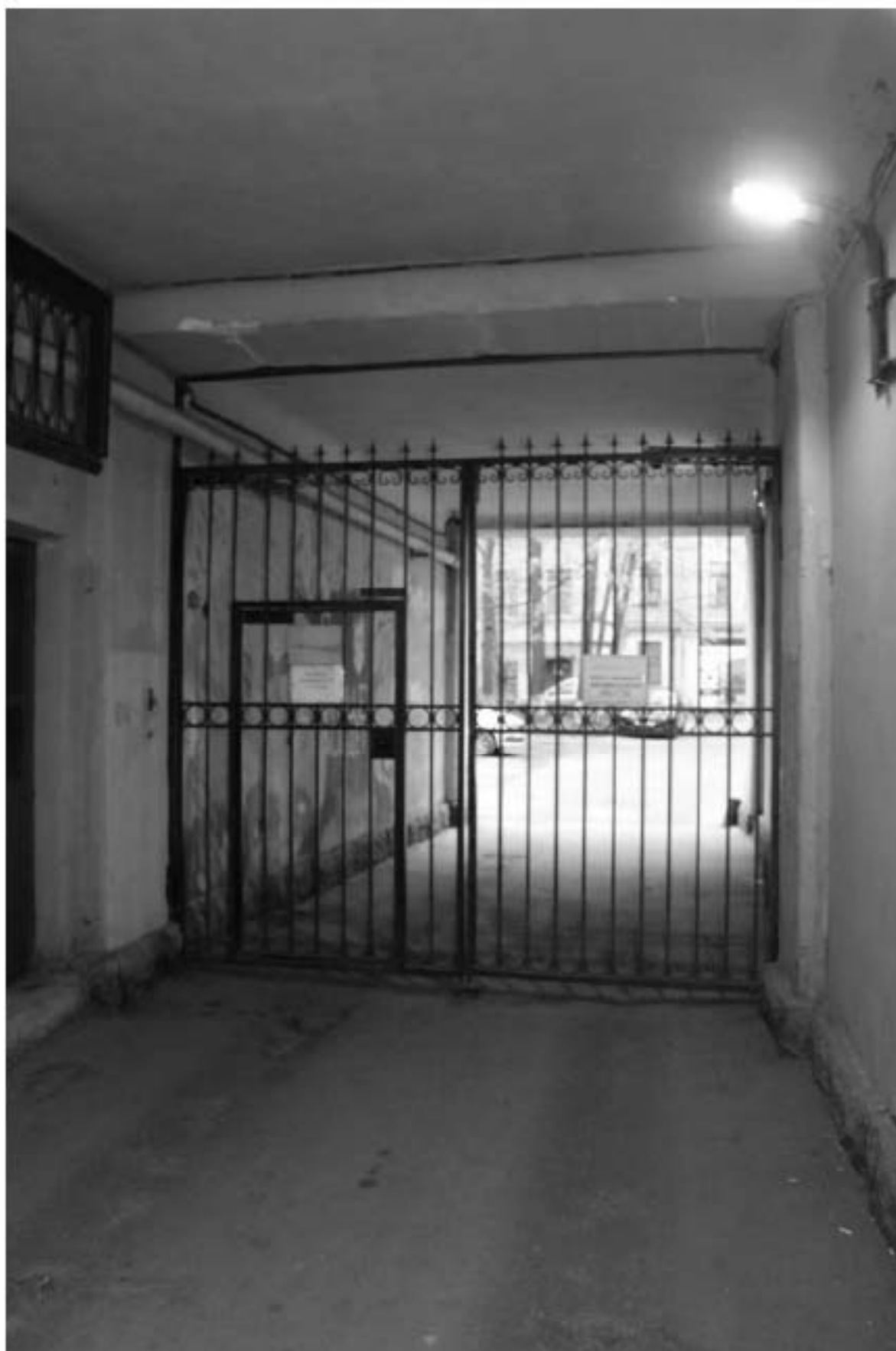
Фото 15. Вид на воротный проезд лицевого корпуса выявленного объекта культурного наследия «Доходный дом».
