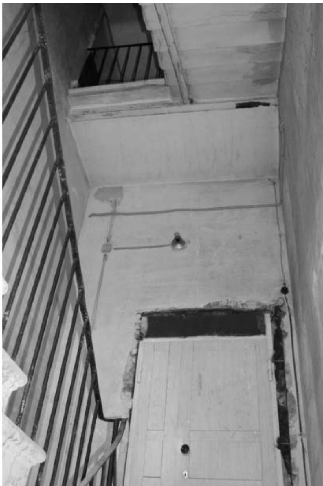
Фото 161. Выявленный объект культурного наследия «Здание Марининской женской гимназии». Вид на лестницу 9ЛК (ул. Ломоносова, д. 11-13, лит. А) в уровне 4-го этажа.
