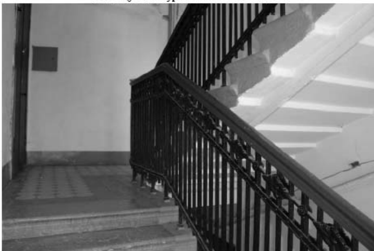
Фото 138. Выявленный объект культурного наследия «Доходный дом». Вид на лестницу 8ЛК в уровне 2-го этажа.
