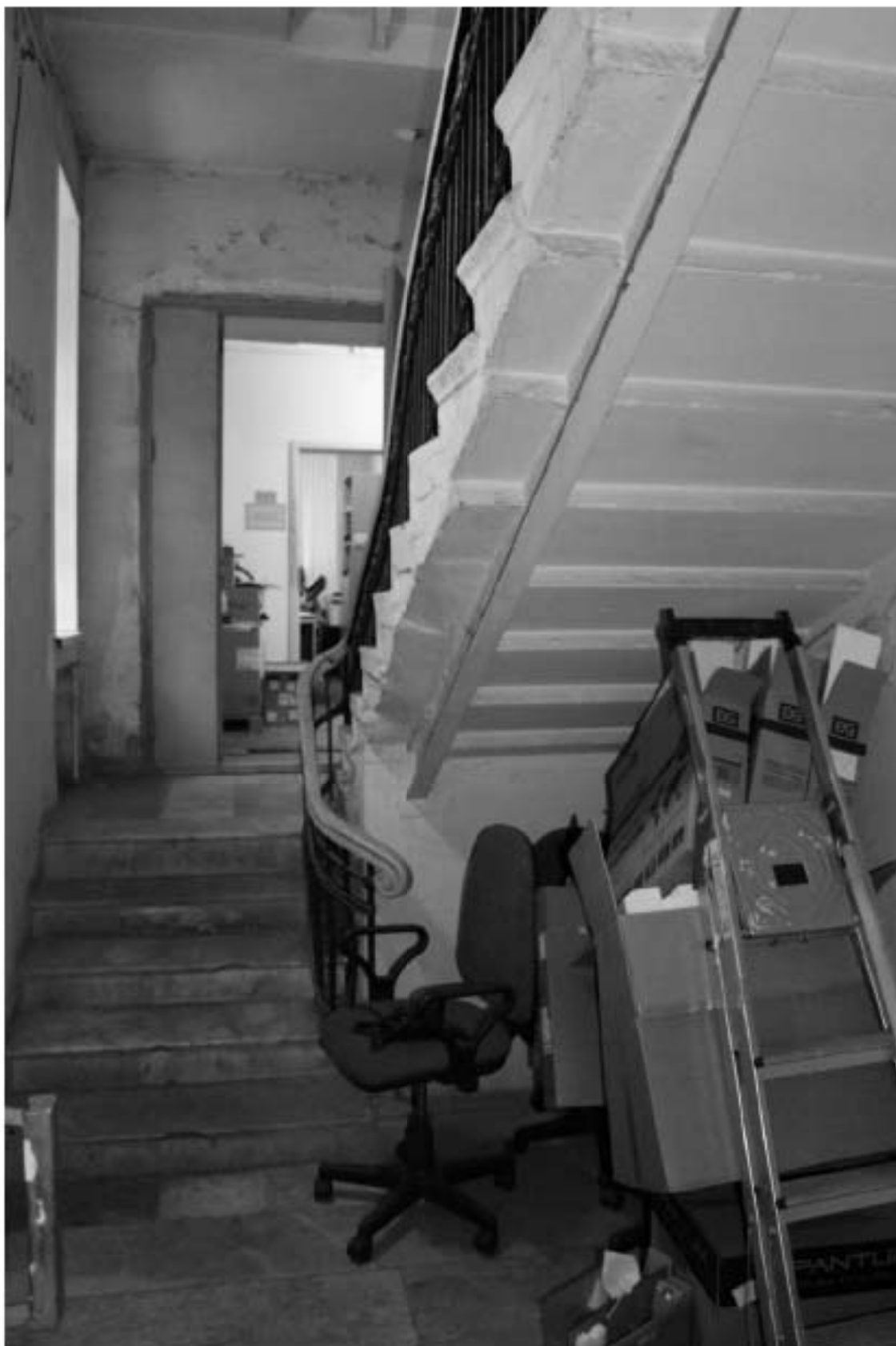
Фото 98. Выявленный объект культурного наследия «Доходный дом». Вид на лестницу 5ЛК в уровне 1-го этажа.
