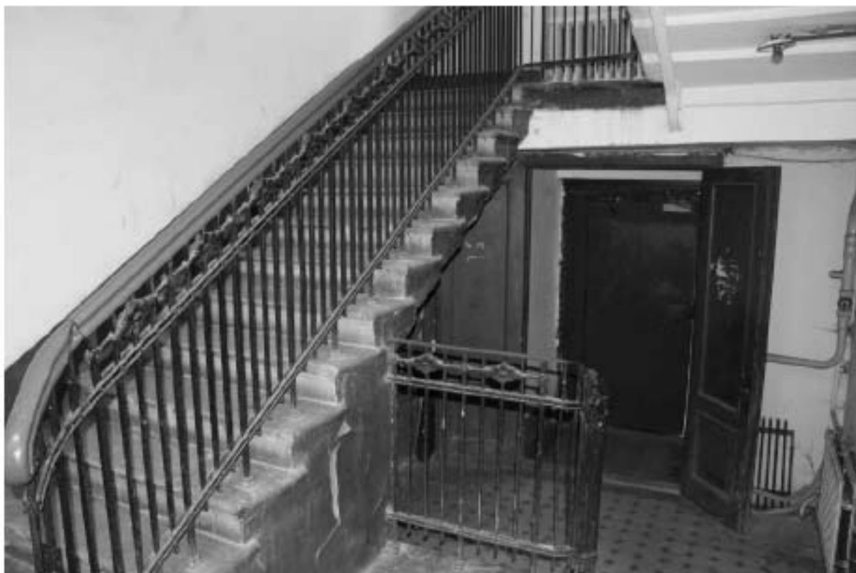
Фото 125. Выявленный объект культурного наследия «Доходный дом». Вид на лестницу 7ЛК в уровне 1-го этажа.
