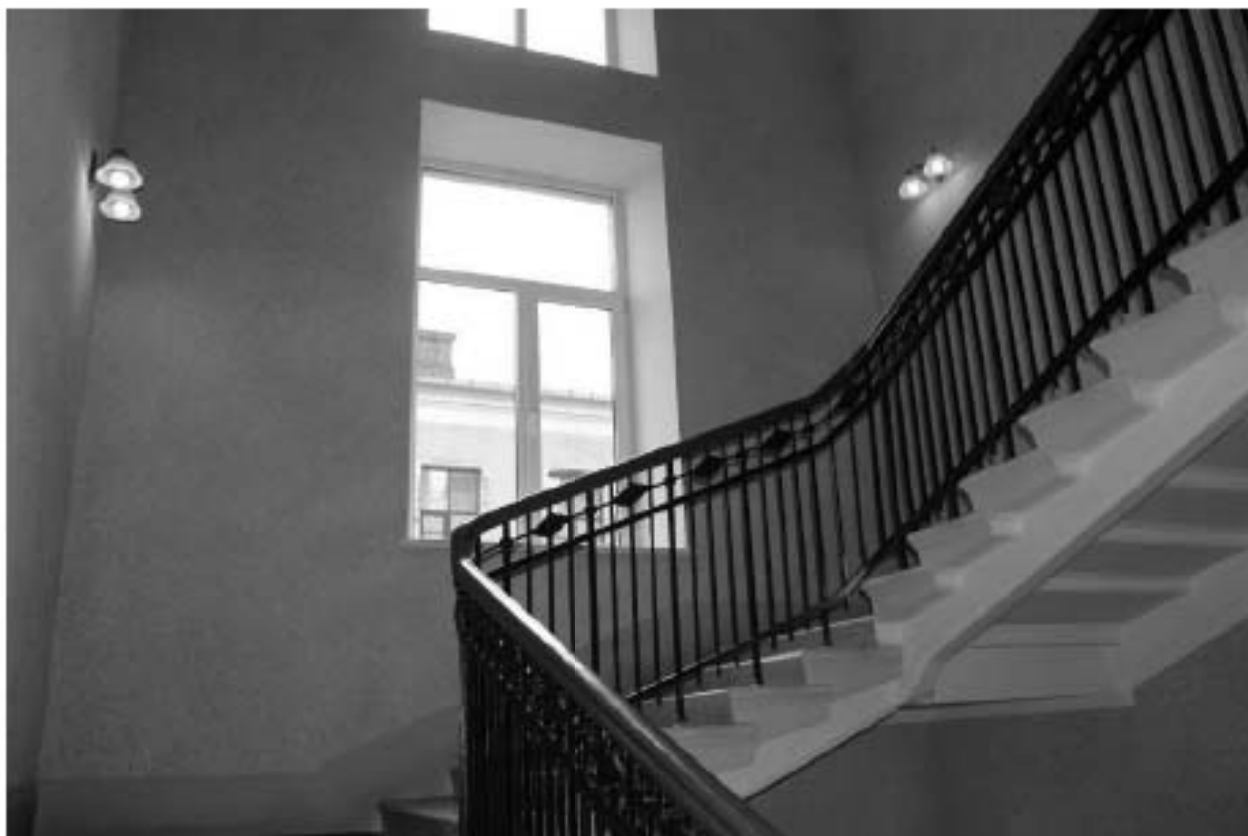
Фото 62. Выявленный объект культурного наследия «Доходный дом». Вид на лестницу 2ЛК в уровне 4-го – 5-го этажей.
