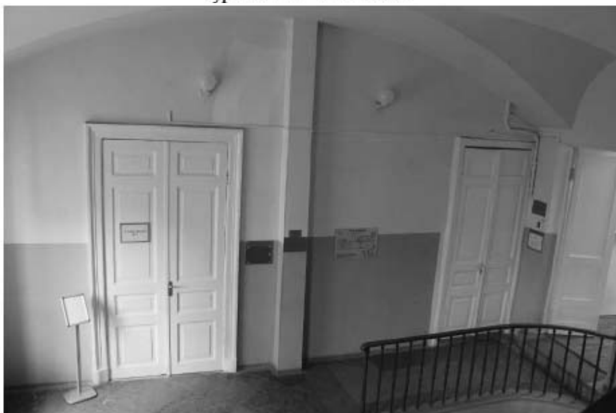
Фото 168. Выявленный объект культурного наследия «Здание Марининской женской гимназии». Вид на лестницу 10ЛК (ул. Ломоносова, д. 11-13, лит. А) в уровне 2-го этажа.
