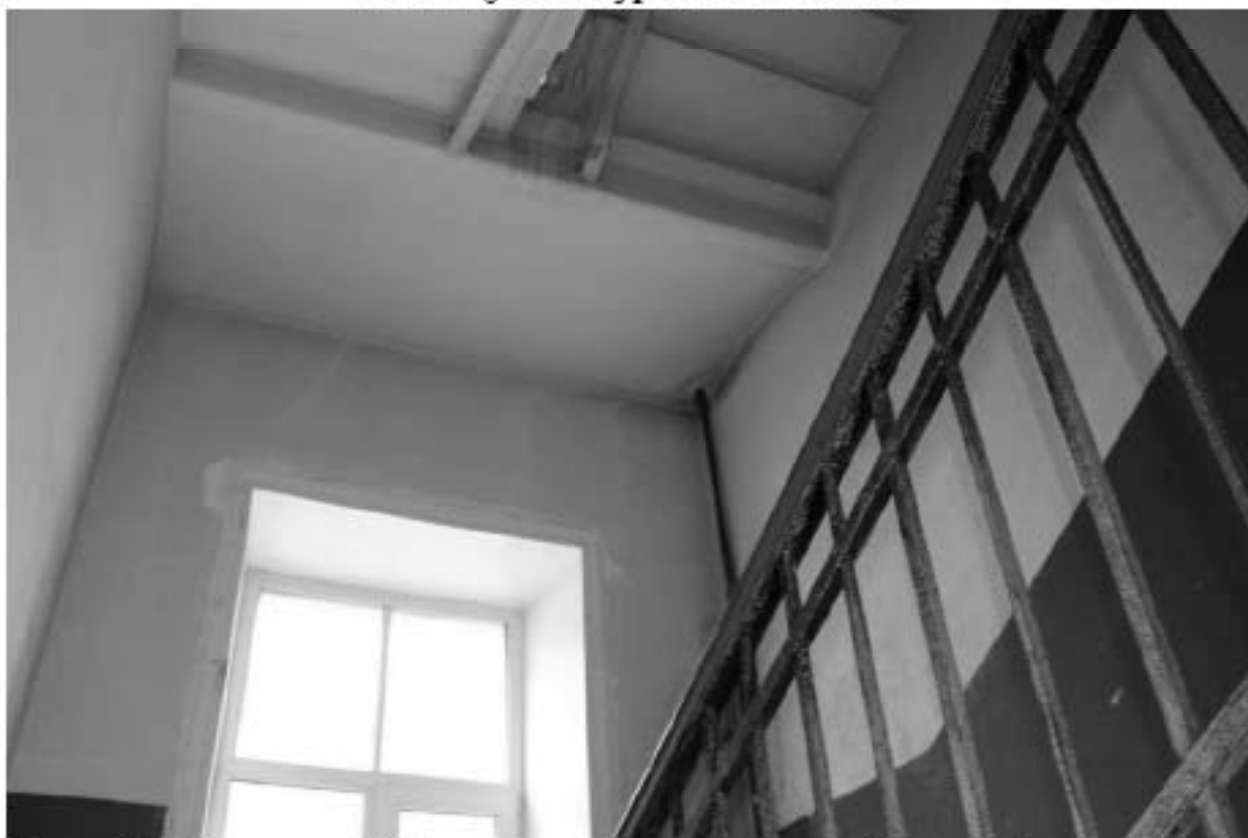
Фото 103. Выявленный объект культурного наследия «Доходный дом». Вид на лестницу 5ЛК в уровне 3-го – 4-го этажей.
