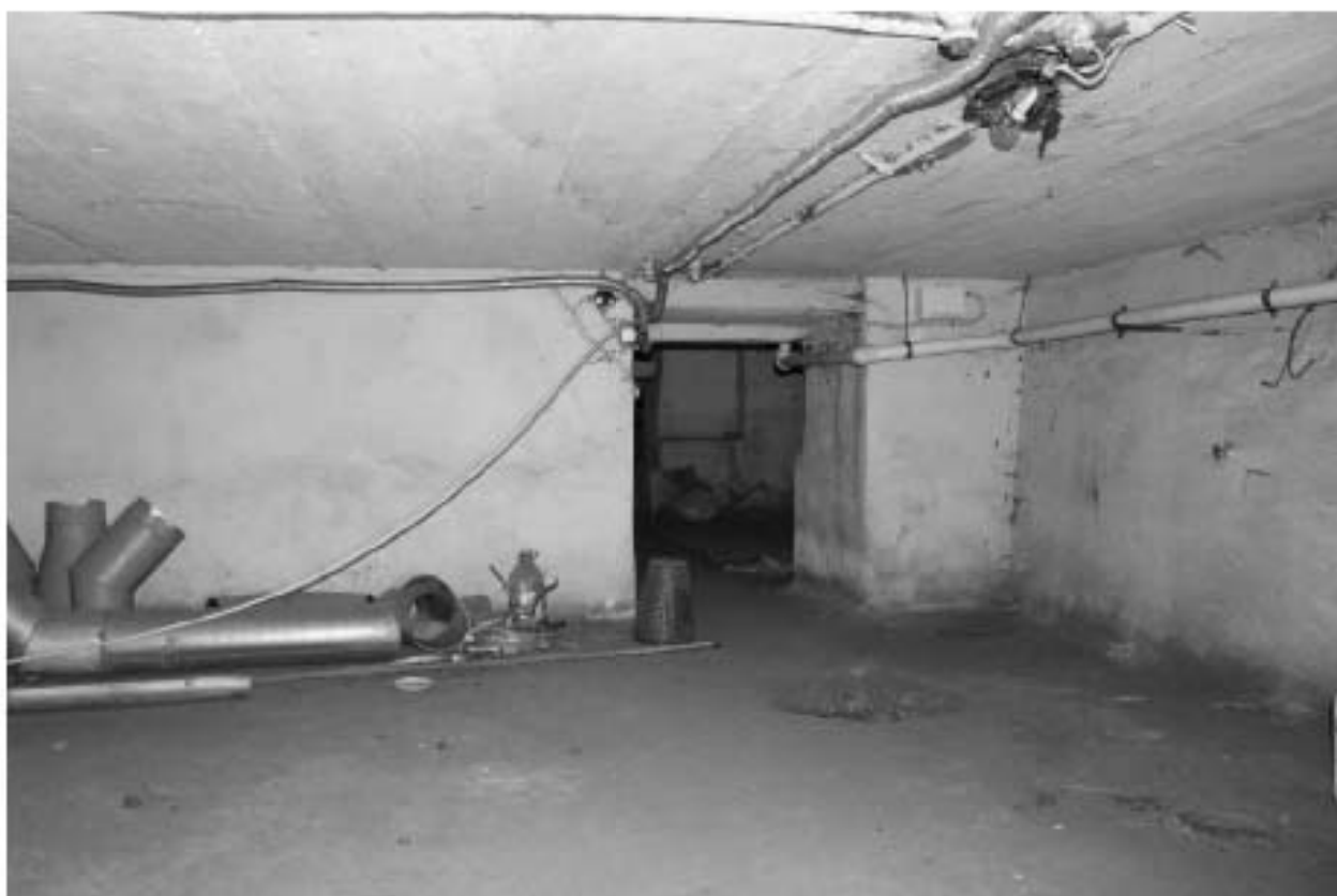
Фото 66. Выявленный объект культурного наследия «Доходный дом». Вид на подвальные помещения.
