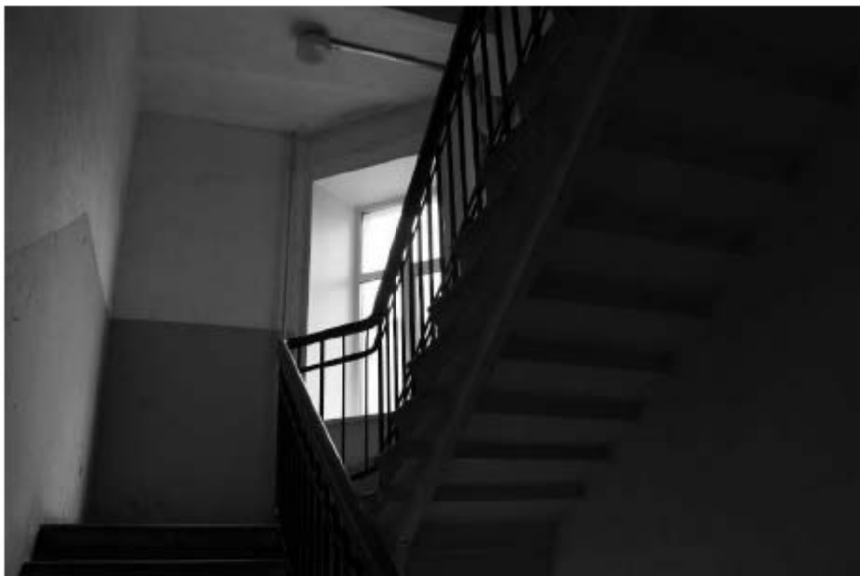
Фото 121. Выявленный объект культурного наследия «Доходный дом». Вид на лестницу БЛК в уровне 4-го – 5-го этажей.
