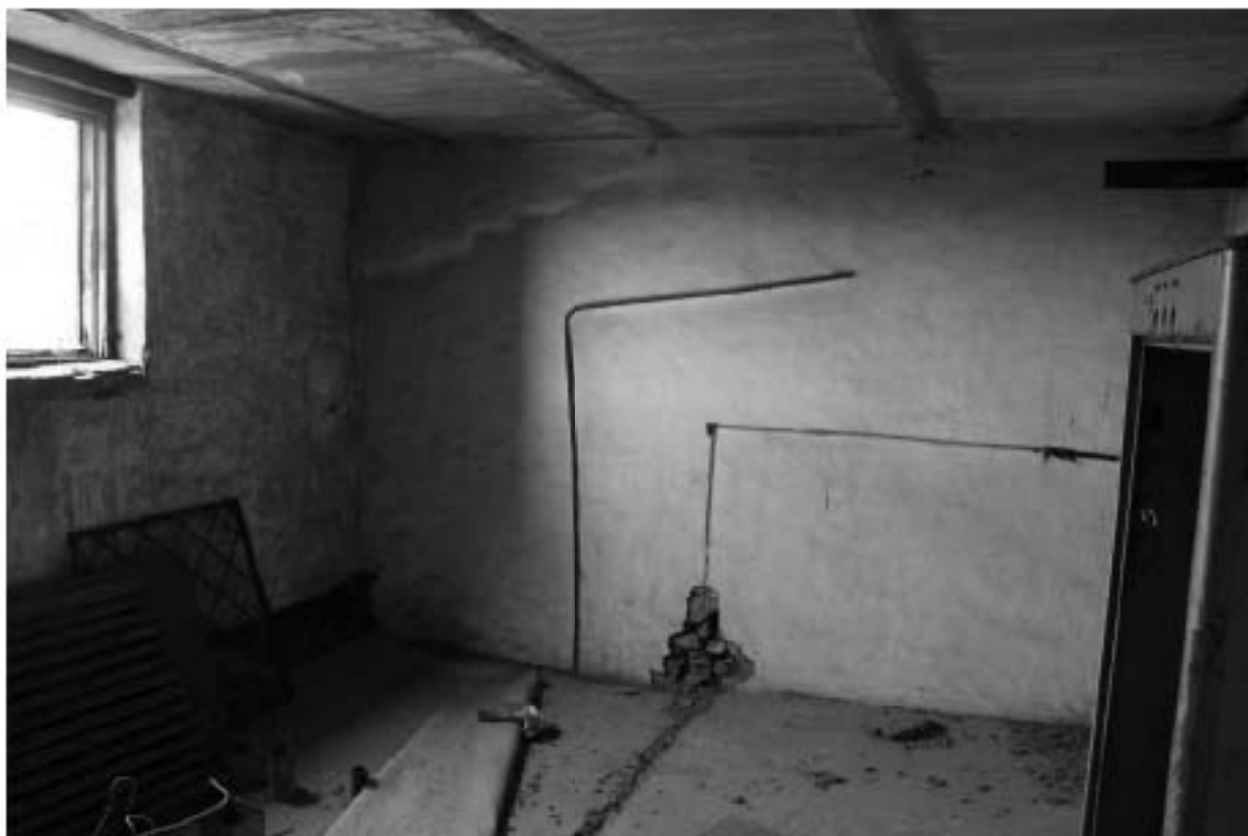
Фото 85. Выявленный объект культурного наследия «Доходный дом». Вид на чердачные помещения.
