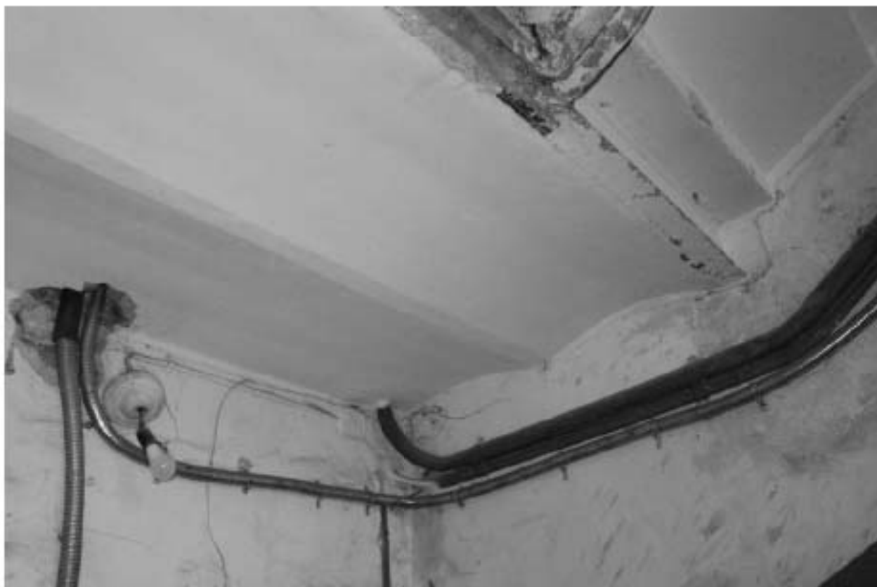
Фото 70. Выявленный объект культурного наследия «Доходный дом». Вид на лестницу 3ЛК в уровне 1-го – этажа.
