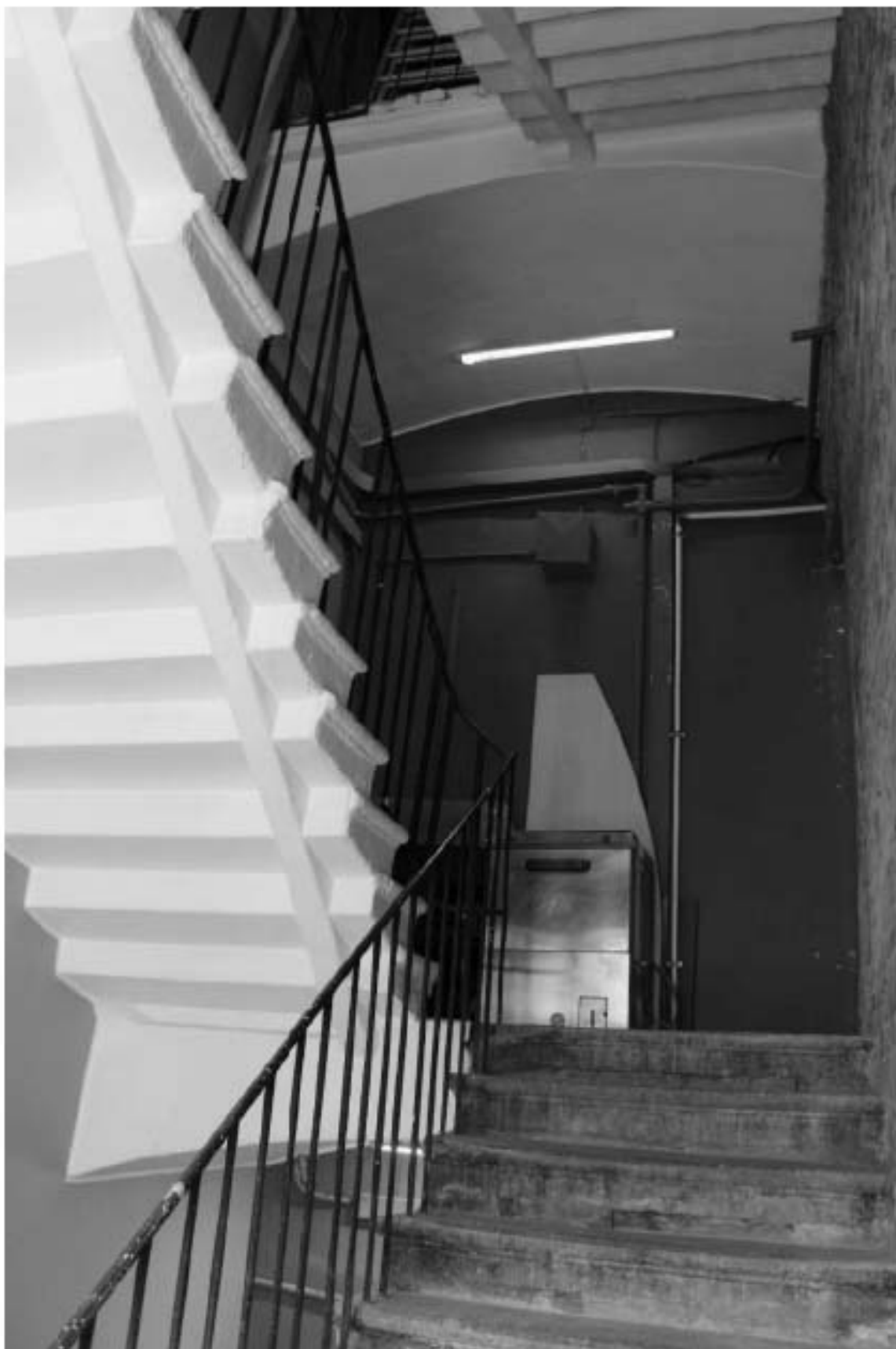
Фото 214. Выявленный объект культурного наследия «Здание Марининской женской гимназии». Вид на лестницу 5ЛК (Загородный пр., д. 13, лит. А) в уровне 3-го этажа.
