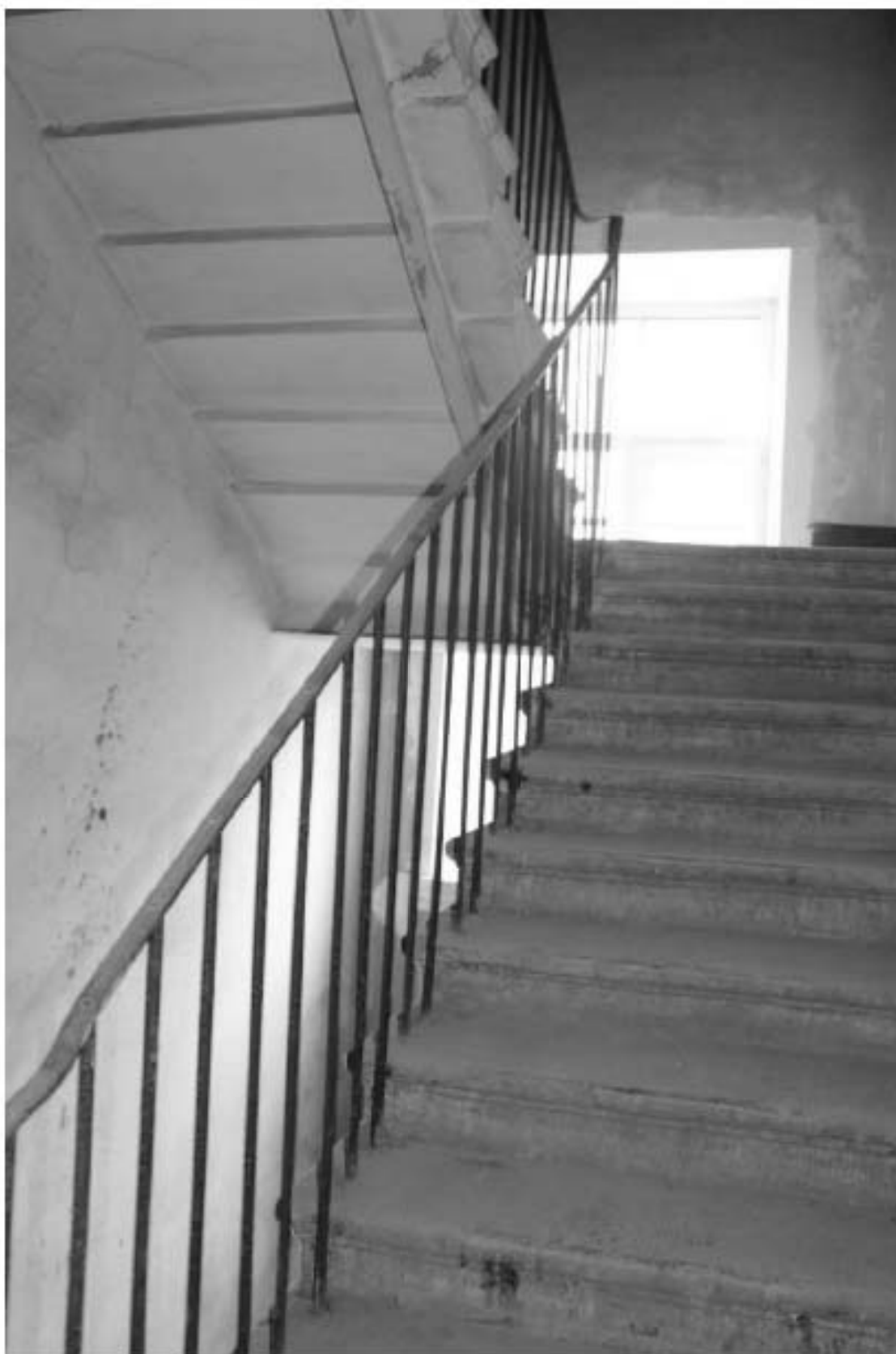
Фото 162. Выявленный объект культурного наследия «Здание Марининской женской гимназии». Вид на лестницу 9ЛК (ул. Ломоносова, д. 11-13, лит. А) в уровне 4-го - чердачного этажей.
