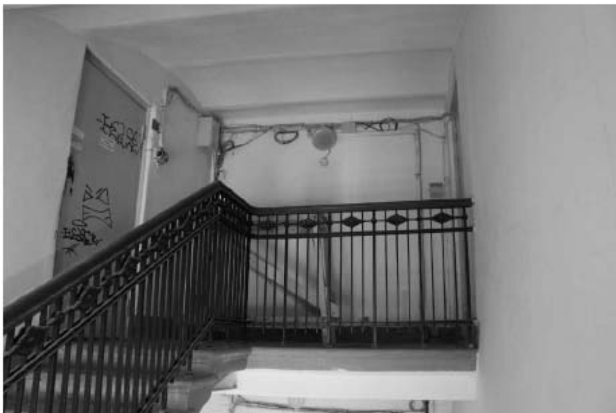
Фото 145. Выявленный объект культурного наследия «Доходный дом». Вид на лестницу 8ЛК в уровне чердачного этажа.
