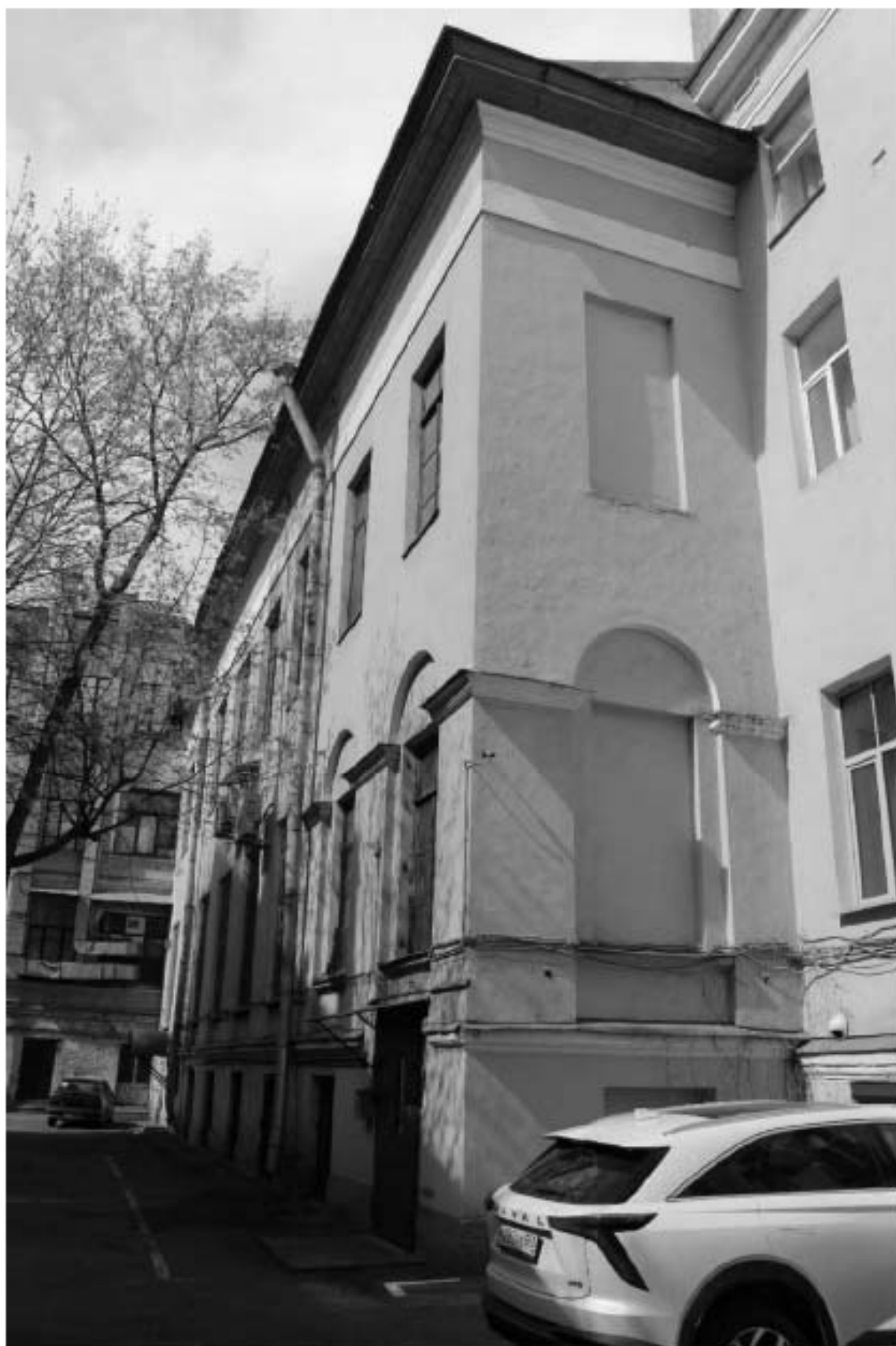
Фото 42. Вид на дворовый фасад двухэтажной части двух-четырёхэтажного корпуса выявленного объекта культурного наследия «Здание Марининской женской гимназии».
