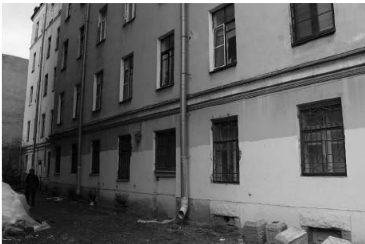
Фото 7. Вид на юго-западный фасад южного дворового корпуса выявленного объекта культурного наследия «Доходный дом».
