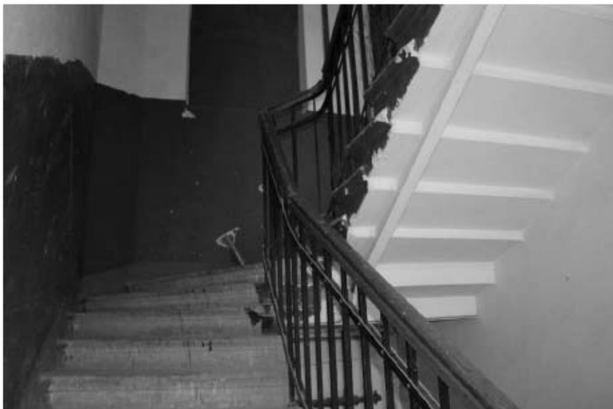
Фото 74. Выявленный объект культурного наследия «Доходный дом». Вид на лестницу ЗЛК в уровне 3-го этажа.
