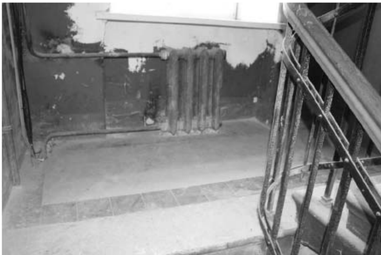
Фото 76. Выявленный объект культурного наследия «Доходный дом». Вид на лестницу ЗЛК в уровне 3-го – 4-го этажей.
