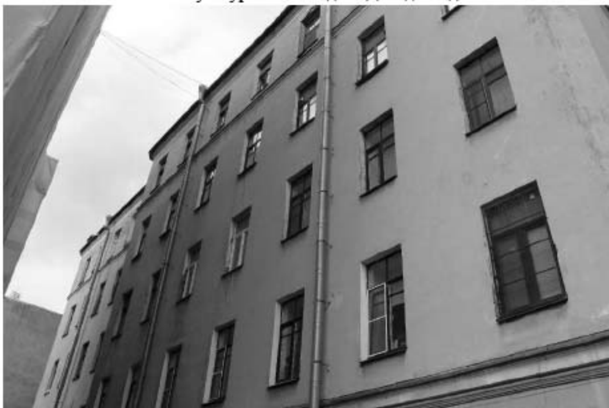
Фото 8. Вид на юго-западный фасад южного дворового корпуса выявленного объекта культурного наследия «Доходный дом».
