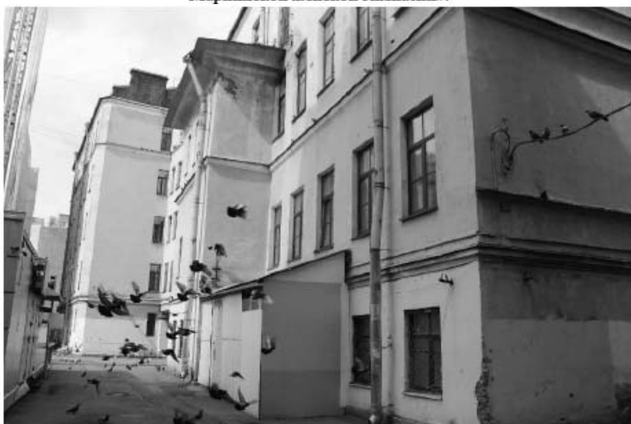
Фото 46. Вид на юго-западный дворовый фасад четырехэтажной части двух-четырёхэтажного корпуса выявленного объекта культурного наследия «Здание Марининской женской гимназии».
