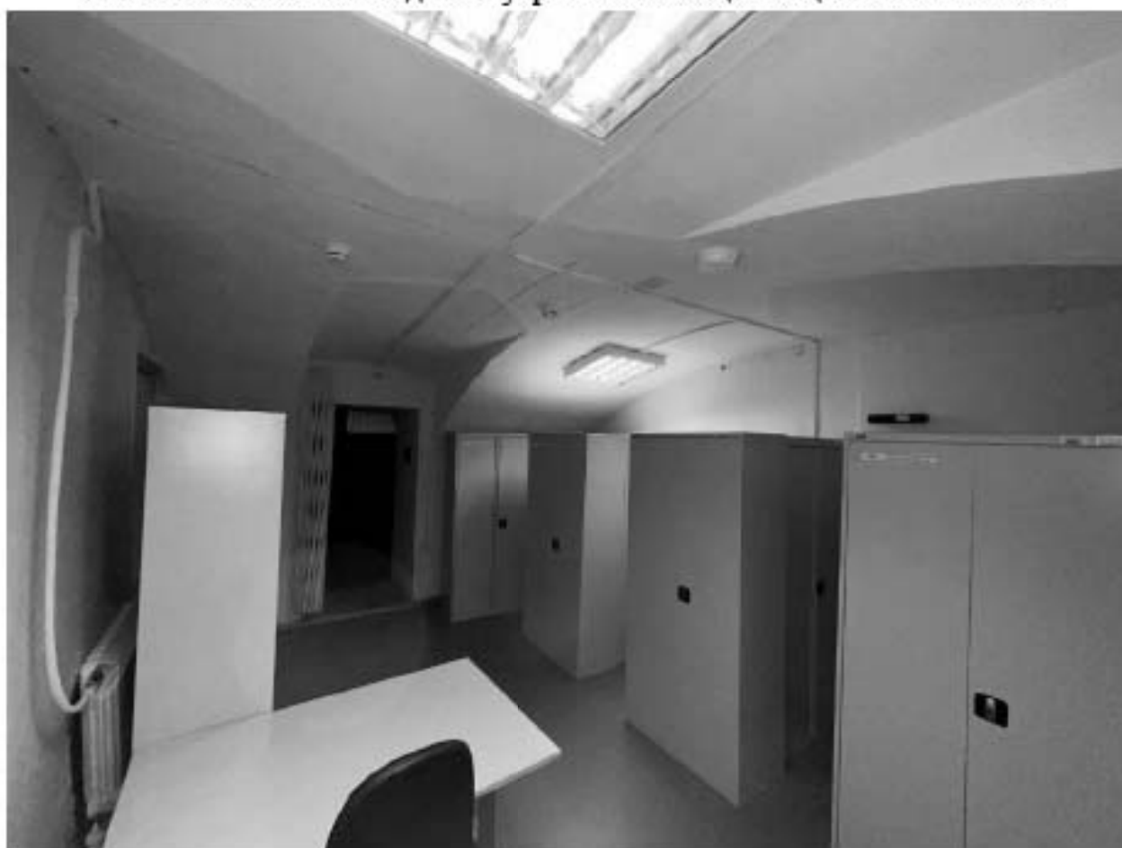
Фото 235. Выявленный объект культурного наследия «Здание Марининской женской гимназии». Вид на внутренние помещения цокольного этажа.
