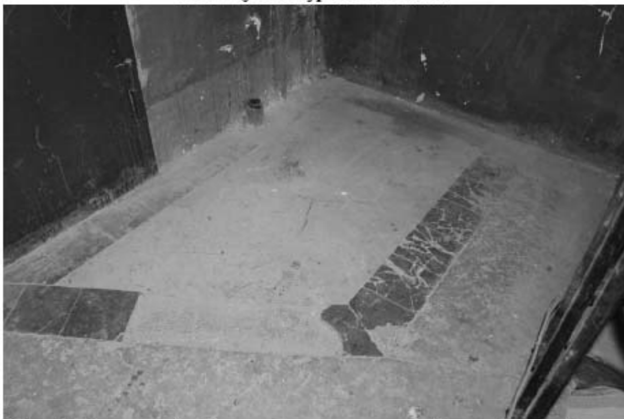
Фото 79. Выявленный объект культурного наследия «Доходный дом». Вид на лестницу ЗЛК в уровне 5-го этажа.
