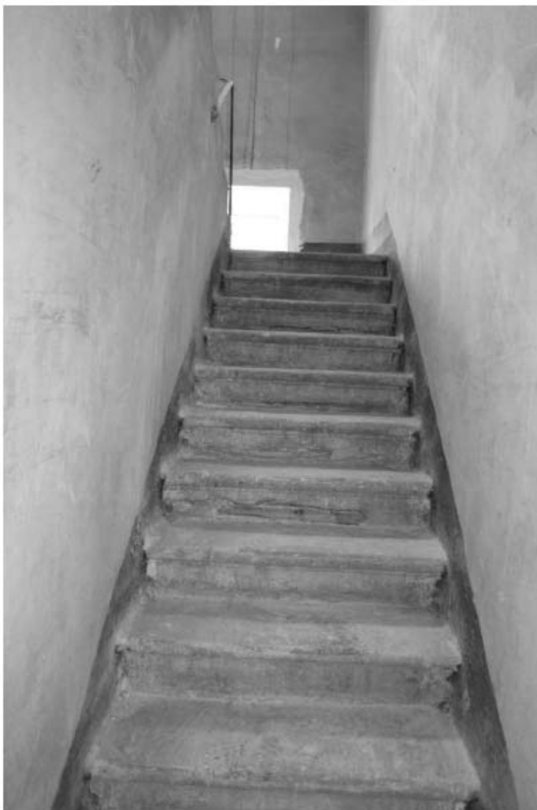
Фото 159. Выявленный объект культурного наследия «Здание Марининской женской гимназии». Вид на лестницу 9ЛК (ул. Ломоносова, д. 11-13, лит. А) в уровне 3-го – 4-го этажей.
