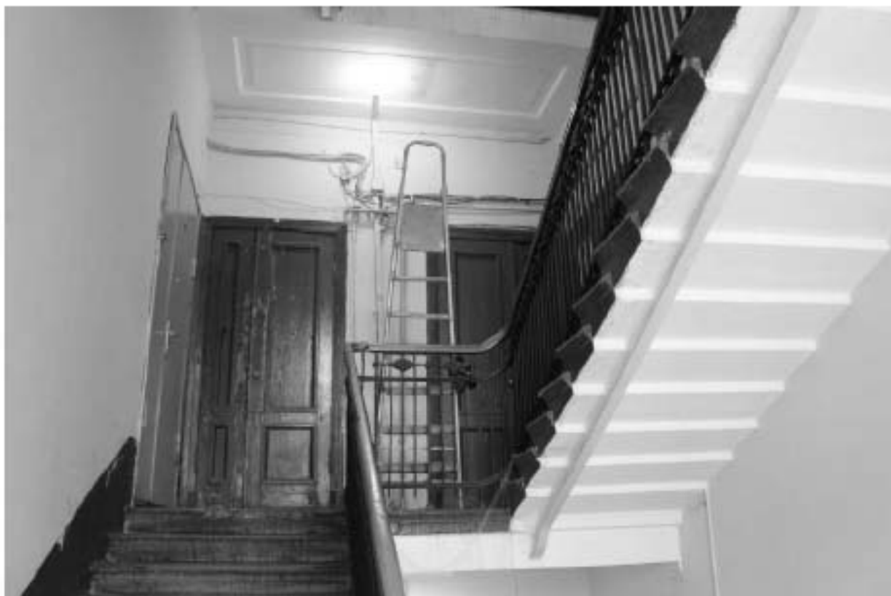
Фото 133. Выявленный объект культурного наследия «Доходный дом». Вид на лестницу 7ЛК в уровне 5-го этажа.
