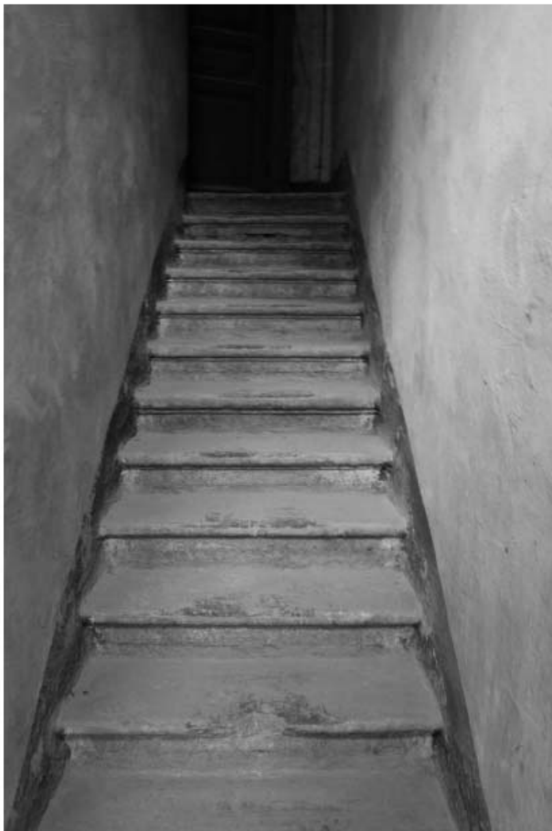
Фото 156. Выявленный объект культурного наследия «Здание Марининской женской гимназии». Вид на лестницу 9ЛК (ул. Ломоносова, д. 11-13, лит. А) в уровне 2-го этажа.
