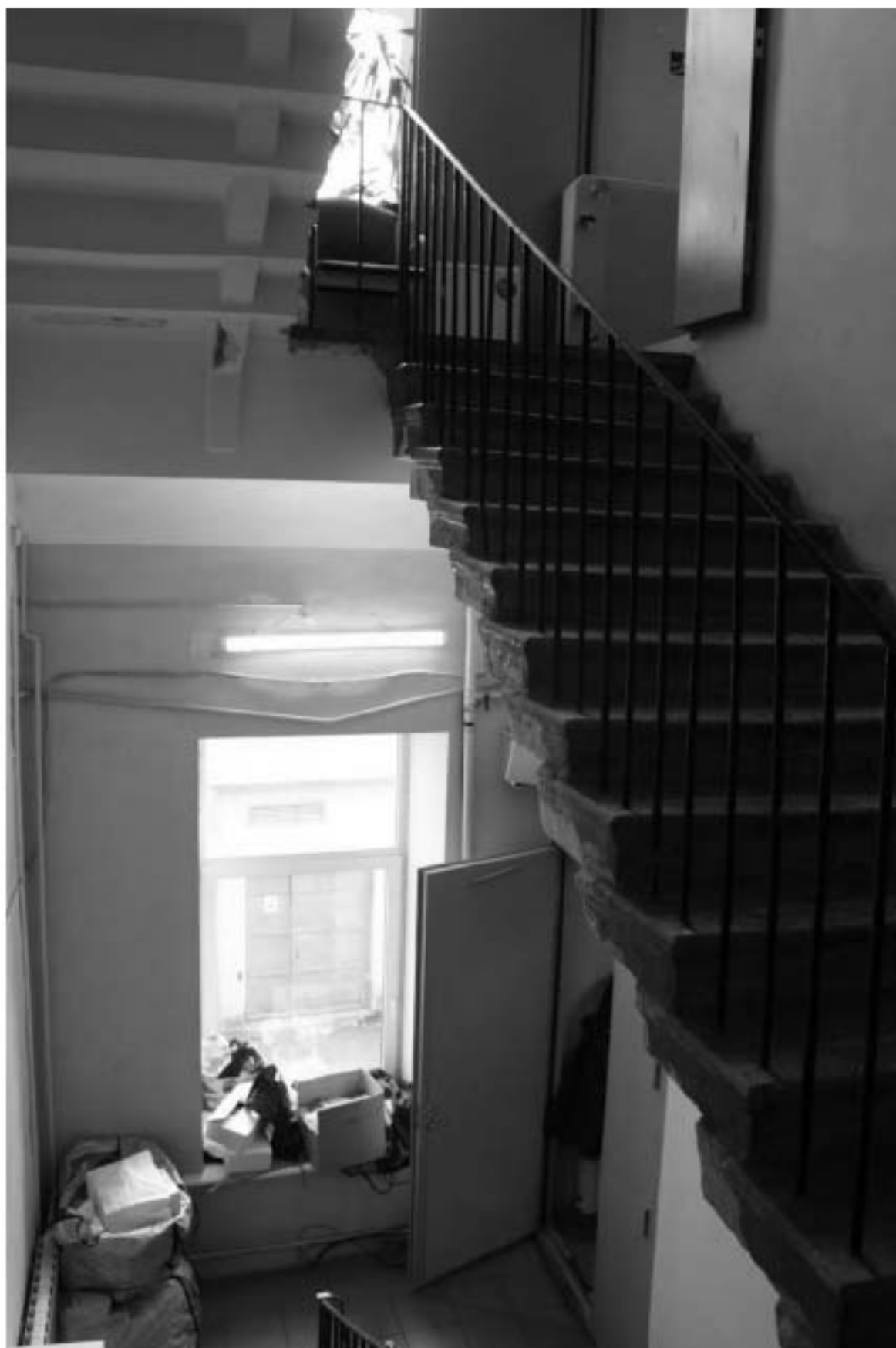
Фото 207. Выявленный объект культурного наследия «Здание Марининской женской гимназии». Вид на лестницу 4ЛК (Загородный пр., д. 13, лит. А) в уровне 2-го – 3-го этажей.
