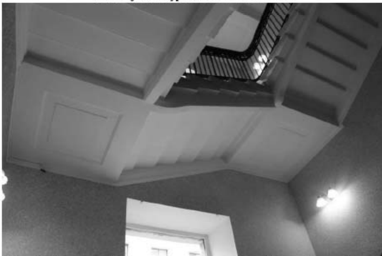
Фото 59. Выявленный объект культурного наследия «Доходный дом». Вид на лестницу 2ЛК в уровне 2-го – 3-го этажей.
