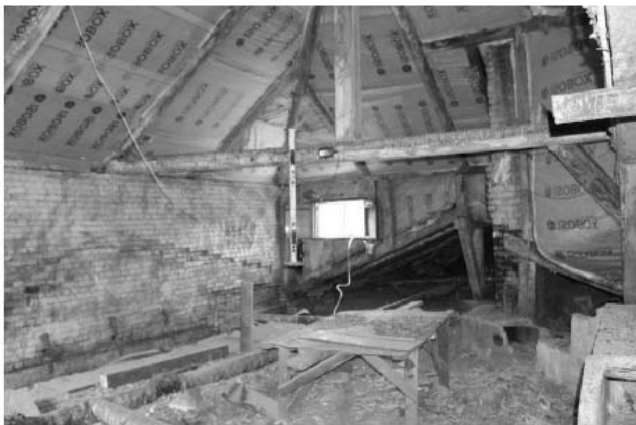
Фото 83. Выявленный объект культурного наследия «Доходный дом». Вид на чердачные помещения.
