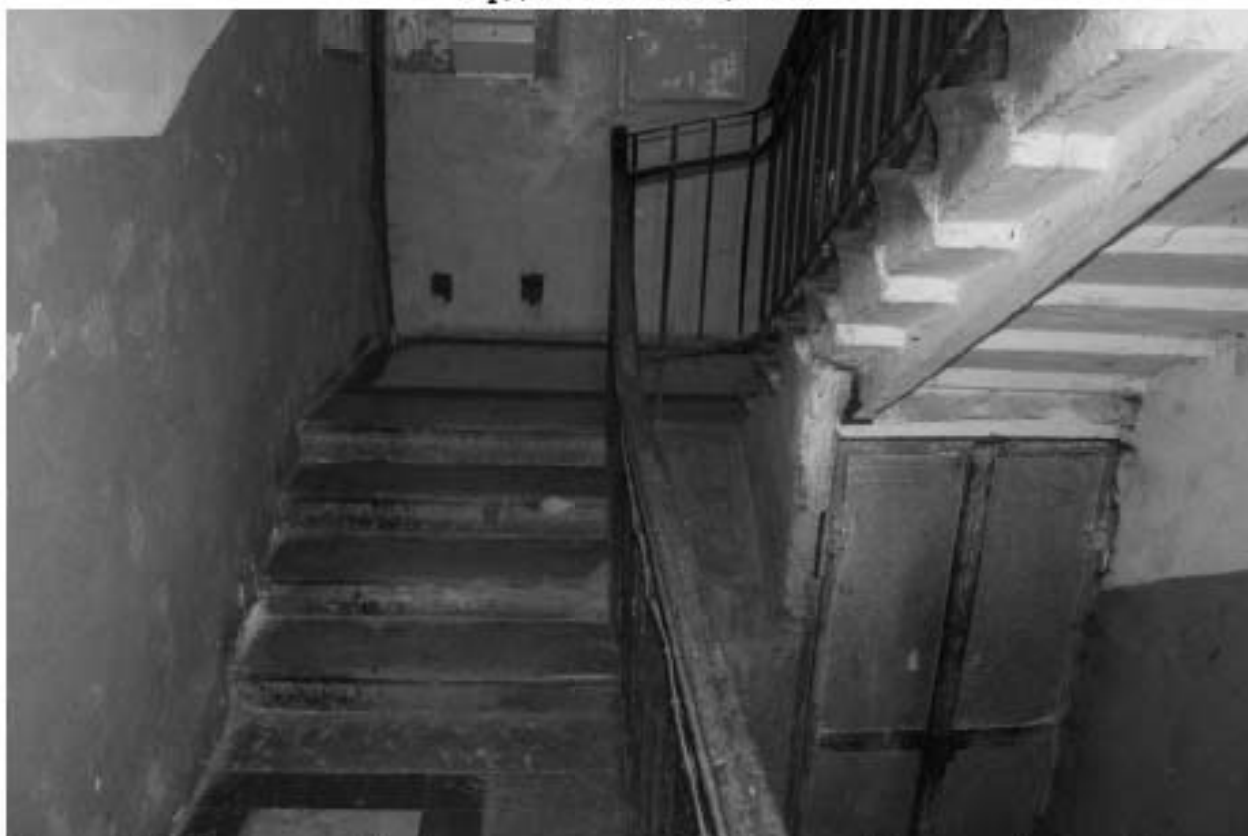
Фото 110. Выявленный объект культурного наследия «Доходный дом». Вид на лестницу БЛК в уровне 1-го этажа.
