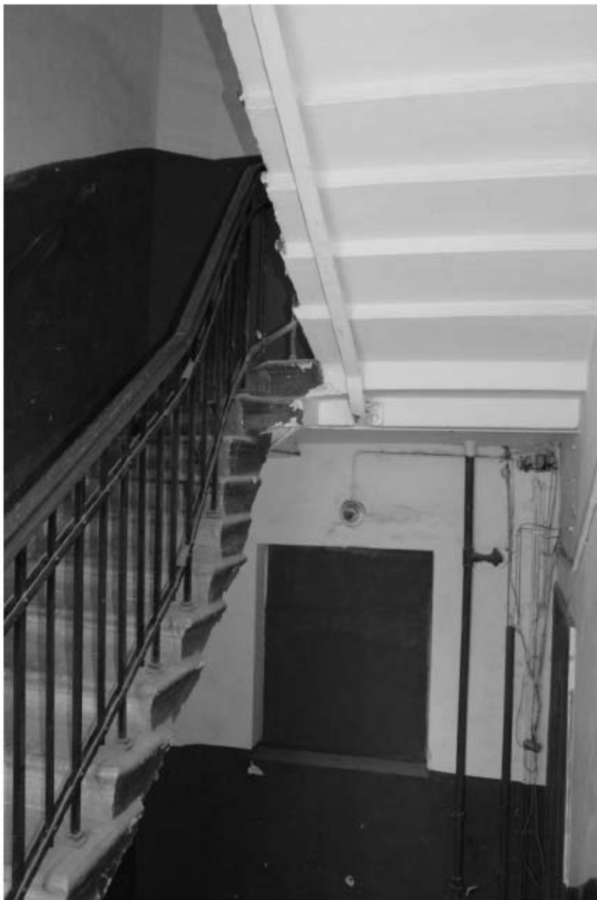
Фото 77. Выявленный объект культурного наследия «Доходный дом». Вид на лестницу ЗЛК в уровне 4-го – 5-го этажей.
