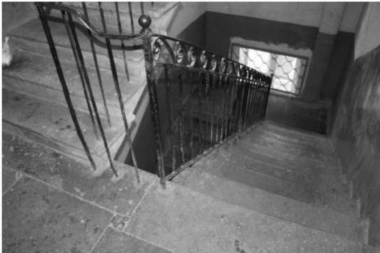
Фото 175. Выявленный объект культурного наследия «Здание Марининской женской гимназии». Вид на лестницу 12ЛК (ул. Ломоносова, д. 11-13, лит. А) в уровне 2-го этажа.
