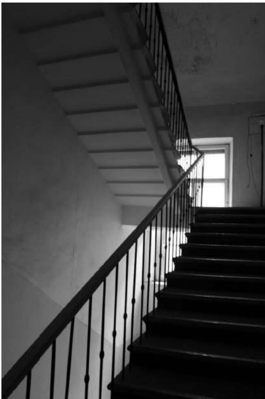
Фото 187. Выявленный объект культурного наследия «Здание Марининской женской гимназии». Вид на лестницу 11ЛК по ул. Ломоносова, д. 11-13, лит. А, 6ЛК по Загородному пр., д. 13, лит. А в уровне 3-го – 4-го этажей.
