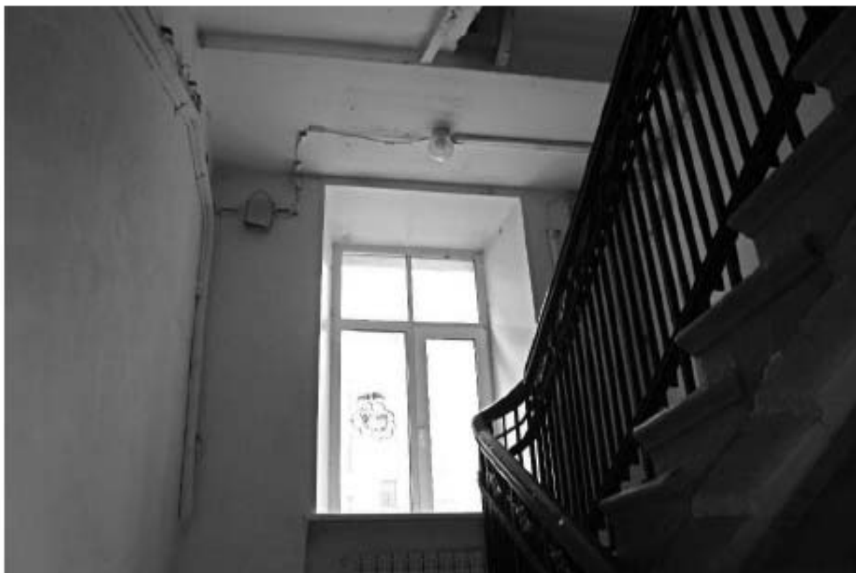
Фото 137. Выявленный объект культурного наследия «Доходный дом». Вид на лестницу 8ЛК в уровне 1-го – 2-го этажей.
