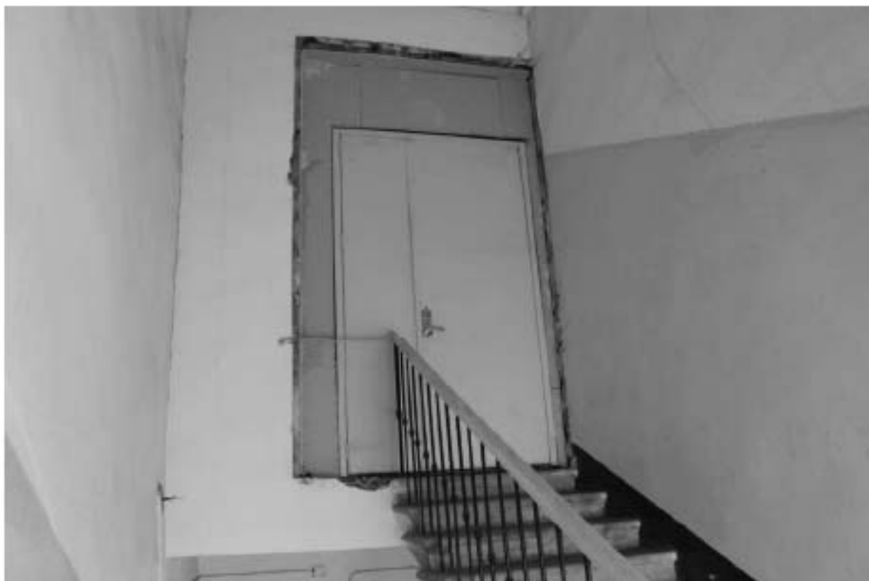
Фото 188. Выявленный объект культурного наследия «Здание Марининской женской гимназии». Вид на лестницу 11ЛК по ул. Ломоносова, д. 11-13, лит. А, 6ЛК по Загородному пр., д. 13, лит. А в уровне 4-го этажа.
