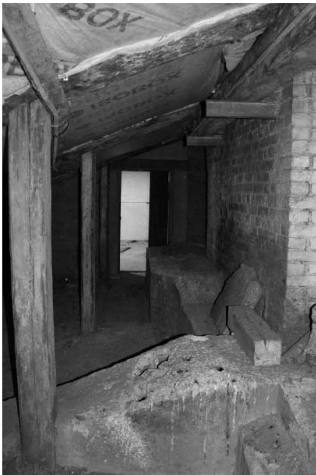
Фото 82. Выявленный объект культурного наследия «Доходный дом». Вид на чердачные помещения.
