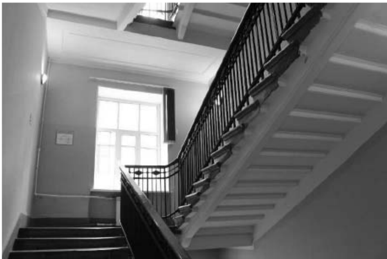
Фото 94. Выявленный объект культурного наследия «Доходный дом». Вид на лестницу 4ЛК в уровне 3-го – 4-го этажей.
