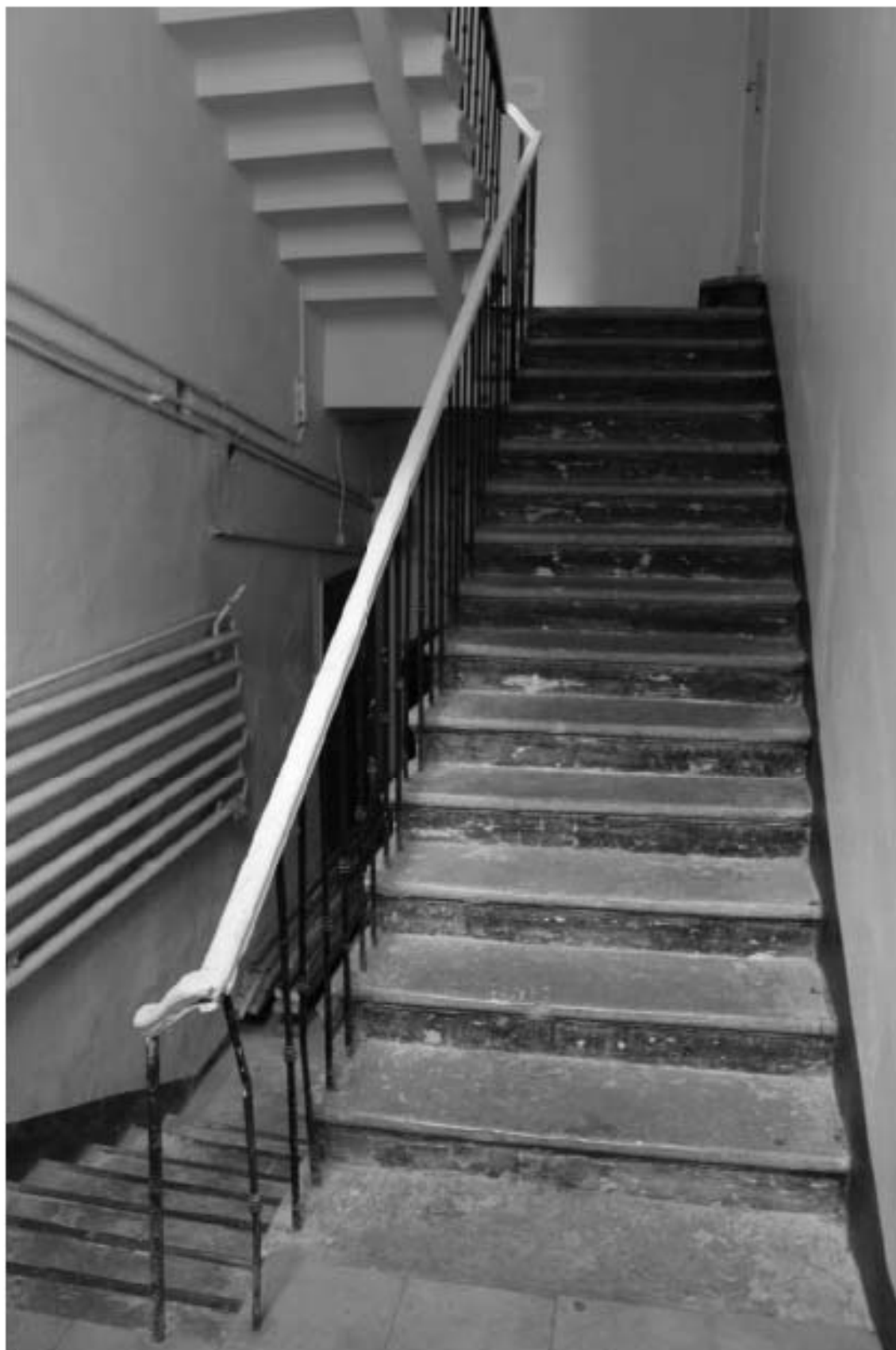
Фото 184. Выявленный объект культурного наследия «Здание Марининской женской гимназии». Вид на лестницу 11ЛК по ул. Ломоносова, д. 11-13, лит. А, 6ЛК по Загородному пр., д. 13, лит. А в уровне 1-го этажа.
