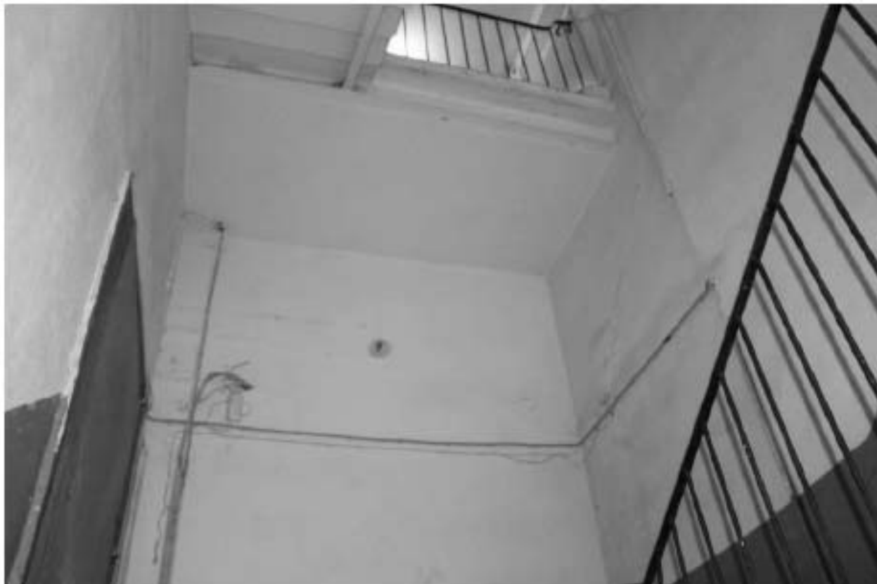
Фото 177. Выявленный объект культурного наследия «Здание Марининской женской гимназии». Вид на лестницу 12ЛК (ул. Ломоносова, д. 11-13, лит. А) в уровне 3-го этажа.
