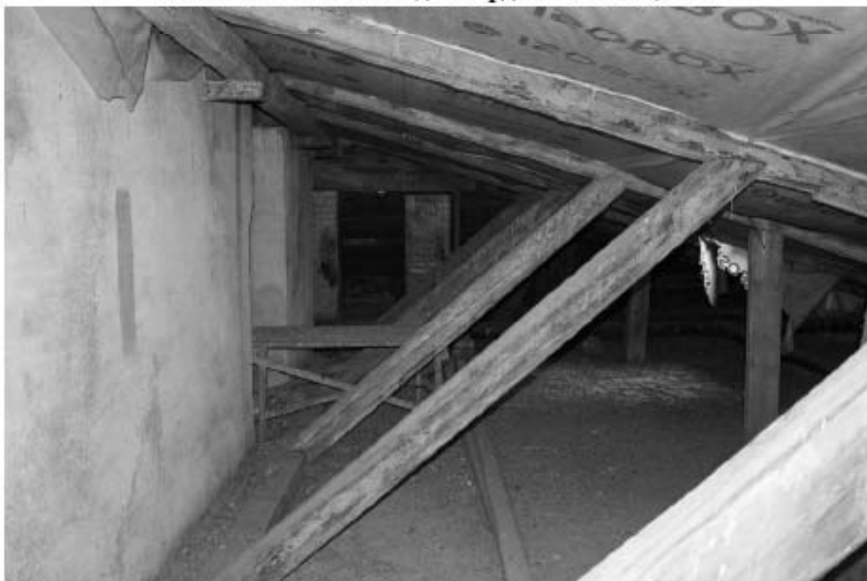
Фото 183. Выявленный объект культурного наследия «Здание Марининской женской гимназии». Вид на чердачные помещения.
