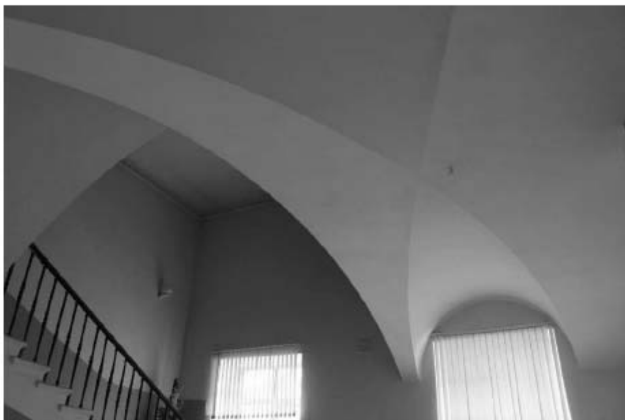
Фото 171. Выявленный объект культурного наследия «Здание Марининской женской гимназии». Вид на лестницу 10ЛК (ул. Ломоносова, д. 11-13, лит. А) в уровне 2-го этажа.
