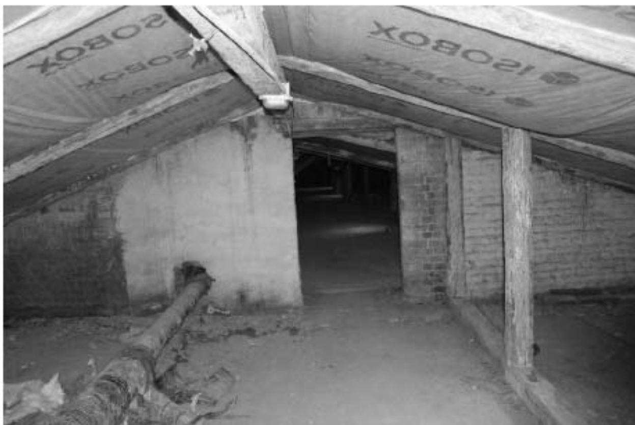
Фото 180. Выявленный объект культурного наследия «Здание Марининской женской гимназии». Вид на чердачные помещения.
