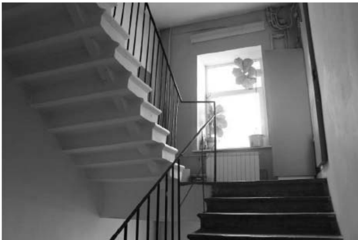
Фото 208. Выявленный объект культурного наследия «Здание Марининской женской гимназии». Вид на лестницу 4ЛК (Загородный пр., д. 13, лит. А) в уровне 3-го этажа.
