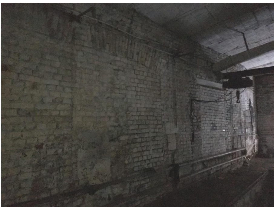
Фото 8. Выявленный объект культурного наследия «Доходные дома М.С. Воронина», расположенный по адресу: Санкт-Петербург, Адмиралтейский район, наб. реки Мойки, д. 82, литера А, Б, Ш. Надворный флигель (литера Ш), помещение 41(Н), поздняя закладка проемов.
