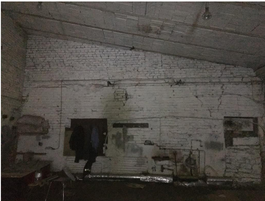
Фото 6. Выявленный объект культурного наследия «Доходные дома М.С. Воронина», расположенный по адресу: Санкт-Петербург, Адмиралтейский район, наб. реки Мойки, д. 82, литера А, Б, Ш. Надворный флигель (литера Ш), помещение 41(Н), внутренняя перегородка, разделяющая помещения флигеля.
