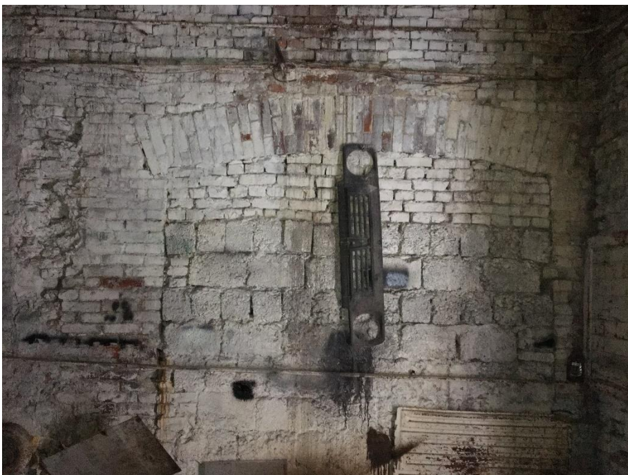
Фото 9. Выявленный объект культурного наследия «Доходные дома М.С. Воронина», расположенный по адресу: Санкт-Петербург, Адмиралтейский район, наб. реки Мойки, д. 82, литера А, Б, Ш. Надворный флигель (литера Ш), помещение 41(Н), закладка проема.
