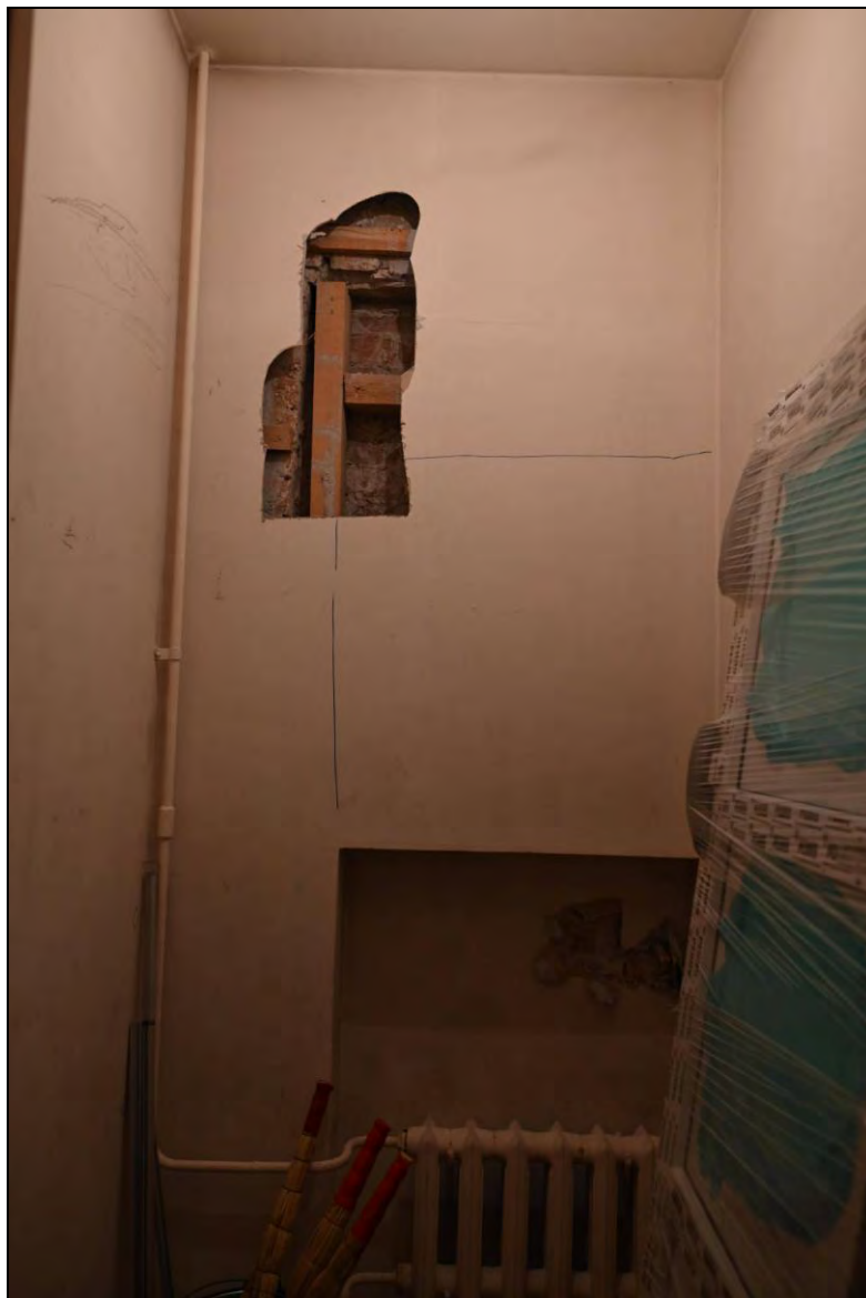
17. Выявленный объект культурного наследия «Дом Зыковых». Фрагмент интерьера квартиры № 31. Помещение № 6 (согласно техническому паспорту на квартиру). Выполнено вскрытие в рамках обследования помещений квартиры.
