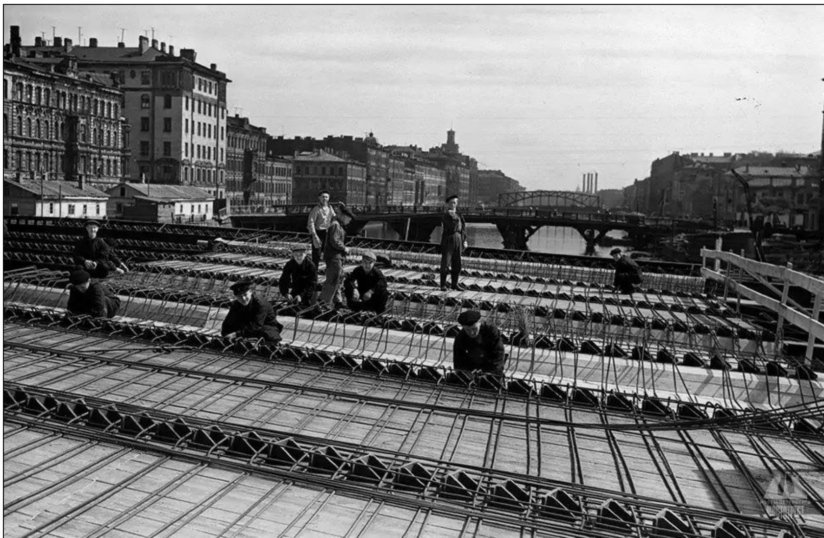
Илл. 36. Строительство Египетского моста. Фотография. 1954 – 1955 гг. Автор съемки: неизвестен.
