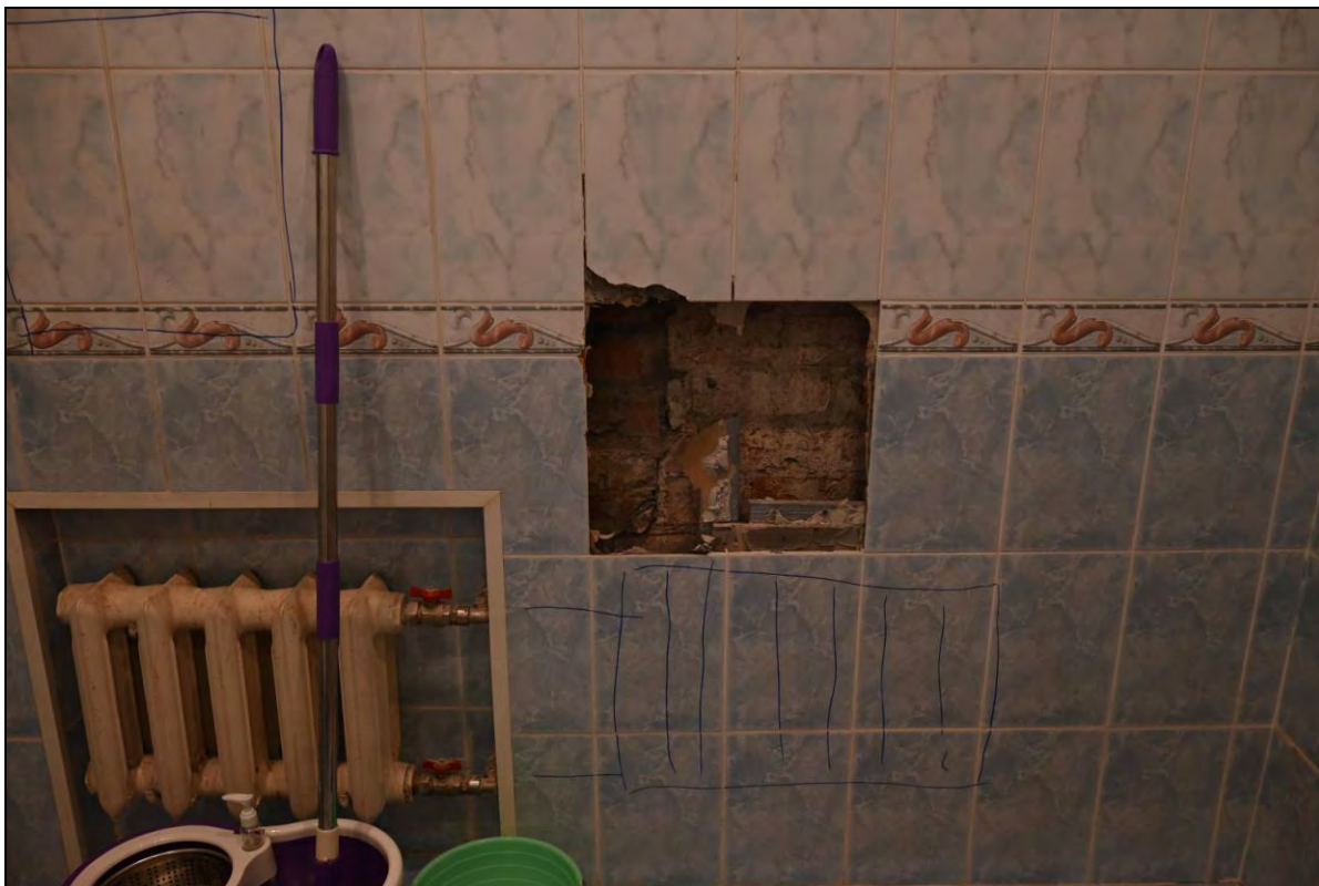
21. Выявленный объект культурного наследия «Дом Зыковых». Фрагмент интерьера квартиры № 31. Помещение № 5 (согласно техническому паспорту на квартиру). Выполнено вскрытие в рамках обследования помещений квартиры.
