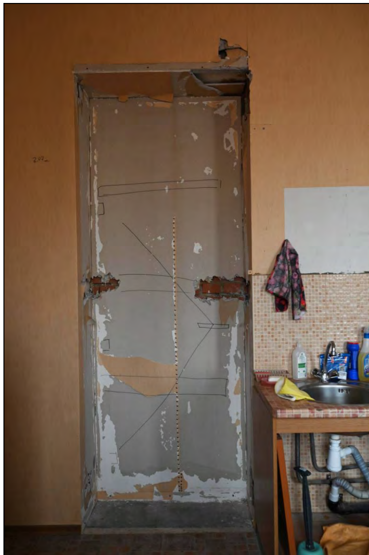
29. Выявленный объект культурного наследия «Дом Зыковых». Фрагмент интерьера квартиры № 31. Помещение № 7 (согласно техническому паспорту на квартиру). Дверной проем на черную лестницу, заложенный на момент проведения обследования.
