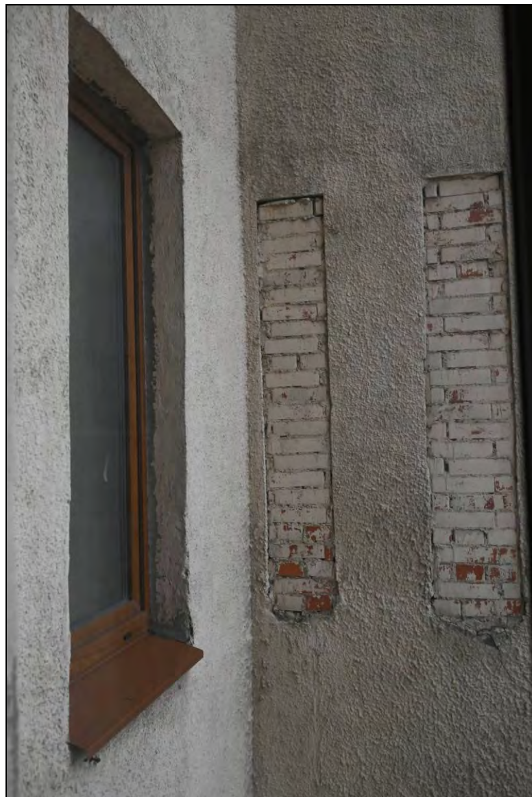
27. Выявленный объект культурного наследия «Дом Зыковых». Фрагмент интерьера квартиры № 31. Помещение № 7 (согласно техническому паспорту на квартиру). Вид из окна на заложенные оконные проемы.
