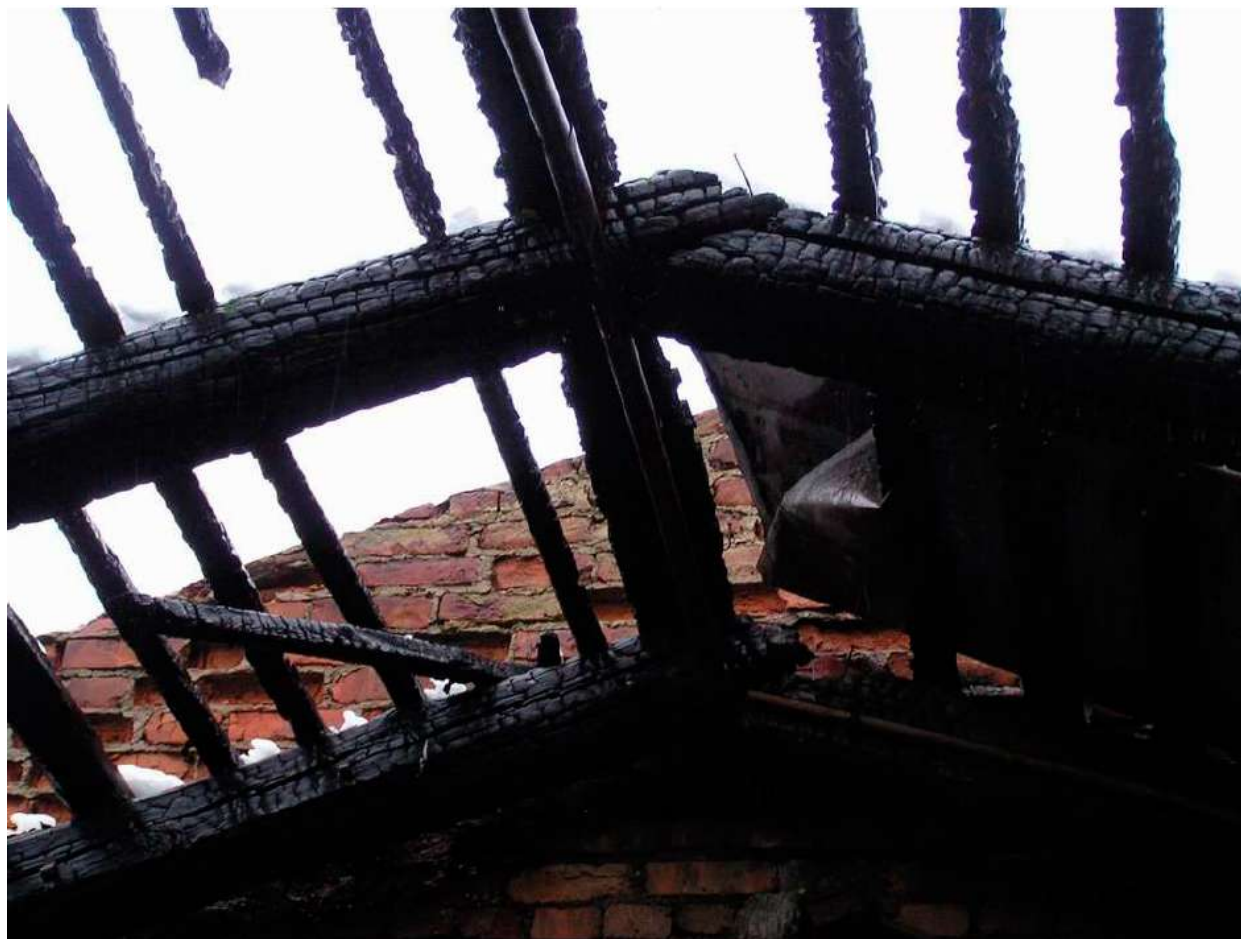
94. Кинотеатр «Спартак» после пожара. Стропильная система крыши. Интернет-ресурс.
