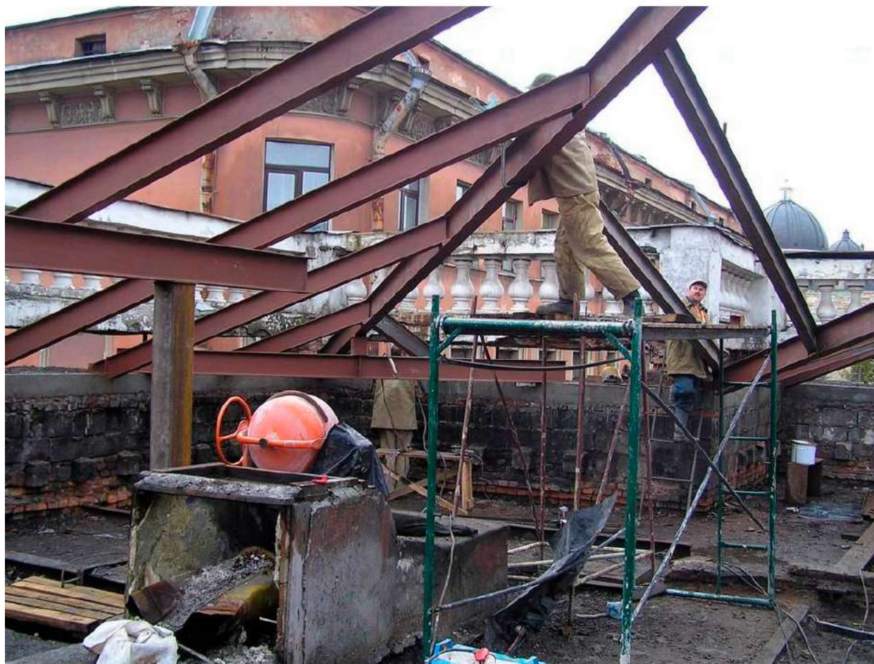
95. Кинотеатр «Спартак» 2008 г. Работы по замене стропильной системы крыши Интернет-ресурс.
