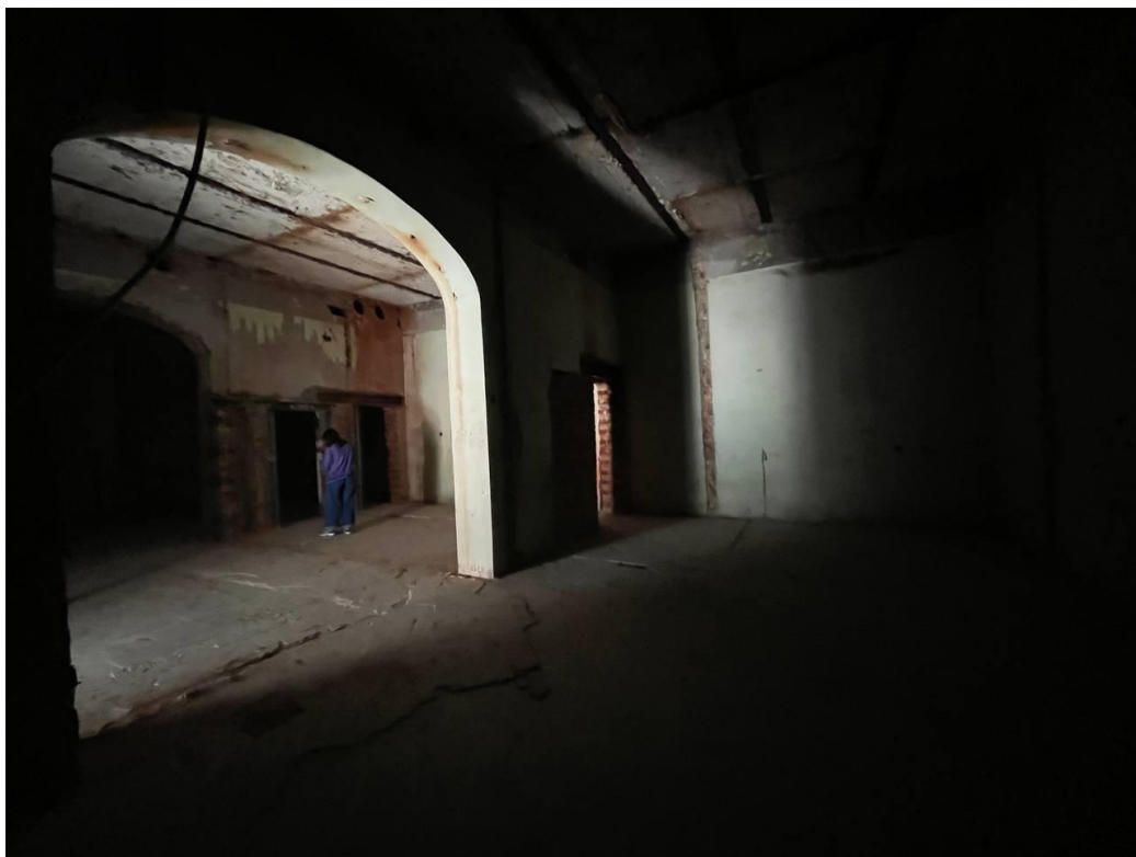
Фото 7. Интерьер пом. 9-Н объекта культурного наследия регионального значения «Дом Э.Г. Шведерского»
