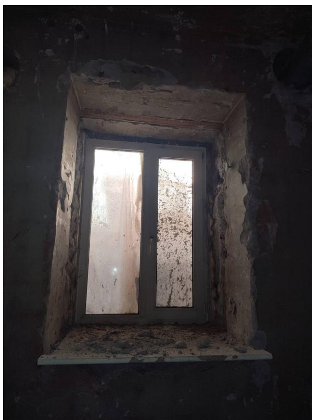
Фото 14. Интерьер пом. 9-Н объекта культурного наследия регионального значения «Дом Э.Г. Шведерского»
