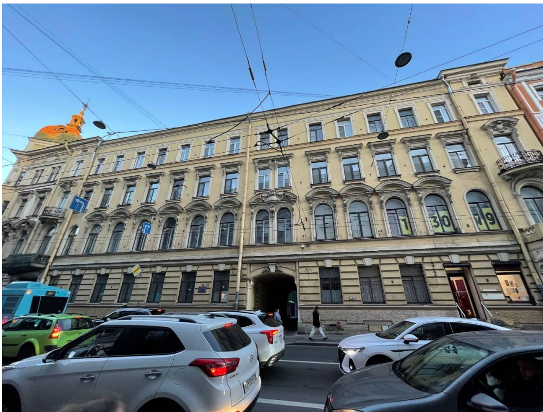
Фото 5. Фрагмент лицевого фасада объекта культурного наследия регионального значения «Дом Э.Г. Шведерского»
