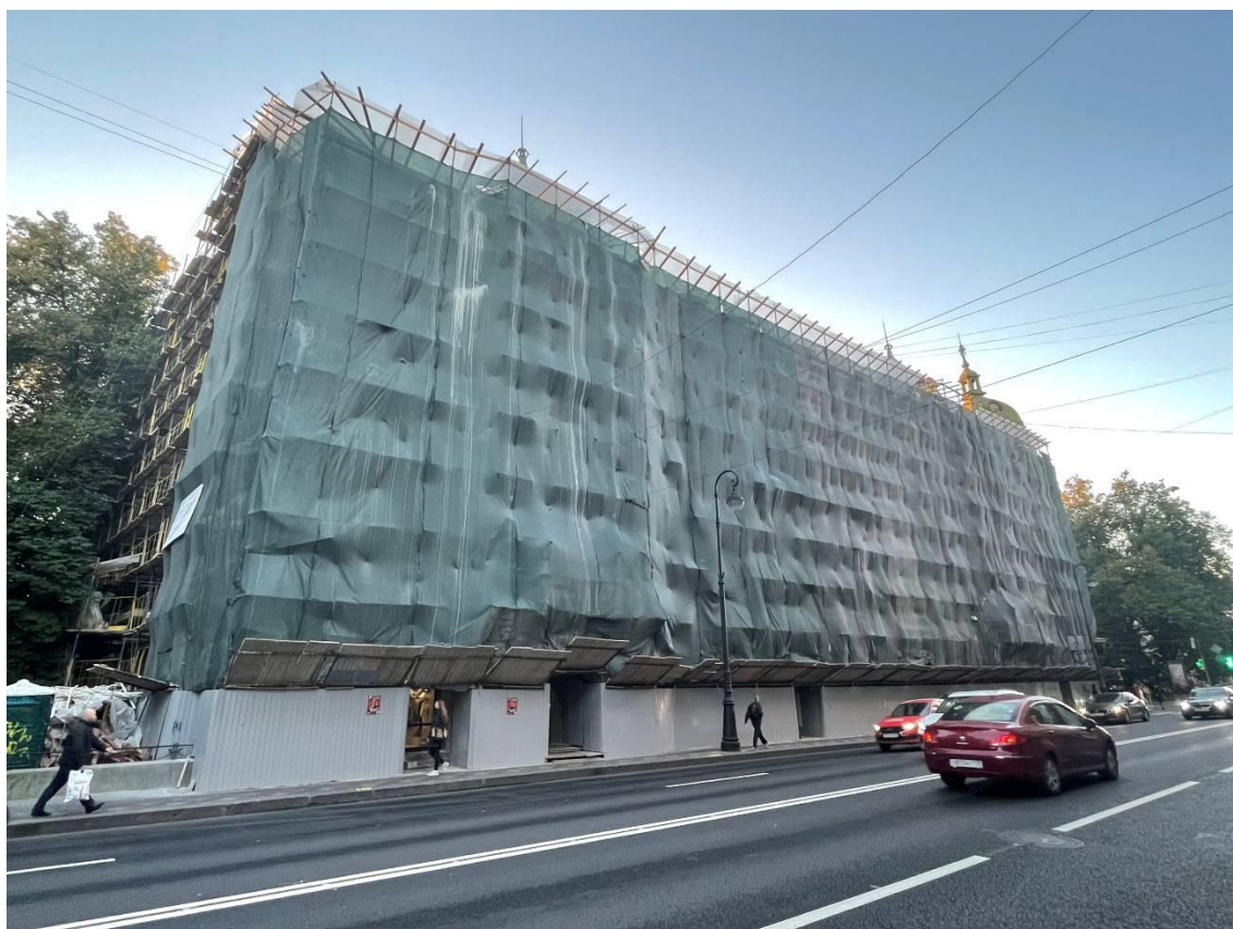
Фото 2. Фрагмент лицевого фасада объекта культурного наследия регионального значения «Дом Э.Г. Шведерского»
