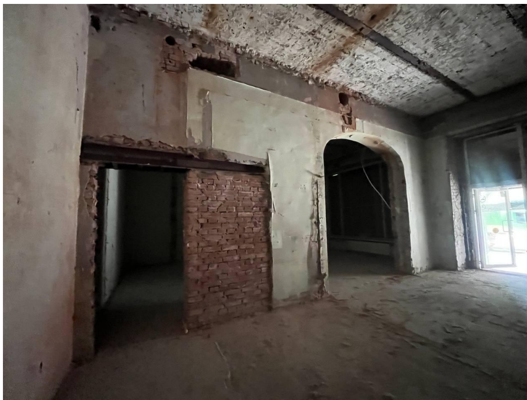
Фото 12. Интерьер пом. 9-Н объекта культурного наследия регионального значения «Дом Э.Г. Шведерского»
