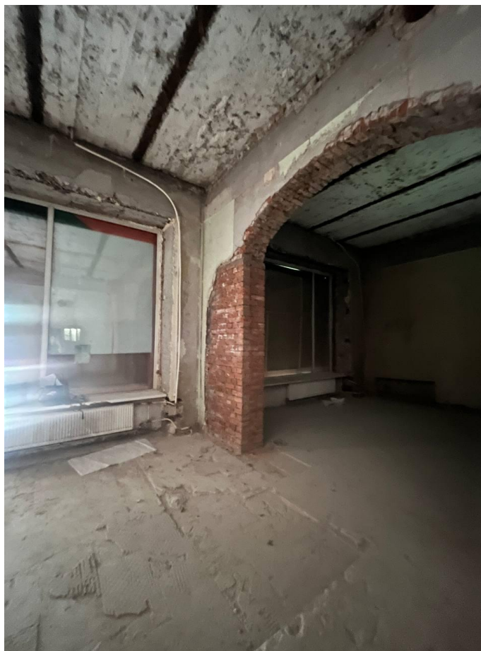
Фото 11. Интерьер пом. 9-Н объекта культурного наследия регионального значения «Дом Э.Г. Шведерского»
