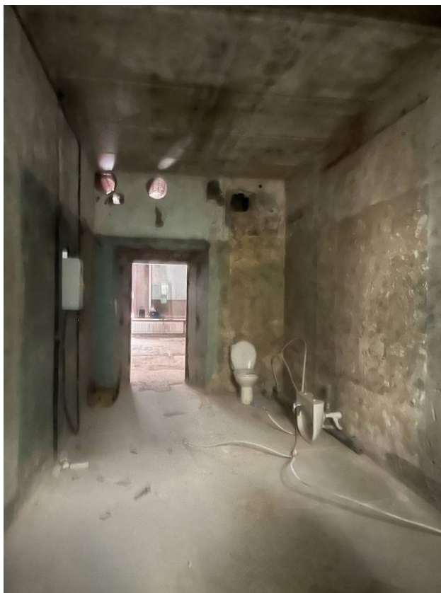
Фото 13. Интерьер пом. 9-Н объекта культурного наследия регионального значения «Дом Э.Г. Шведерского»
