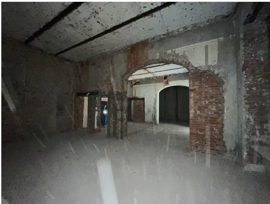
Фото 9. Интерьер пом. 9-Н объекта культурного наследия регионального значения «Дом Э.Г. Шведерского»
