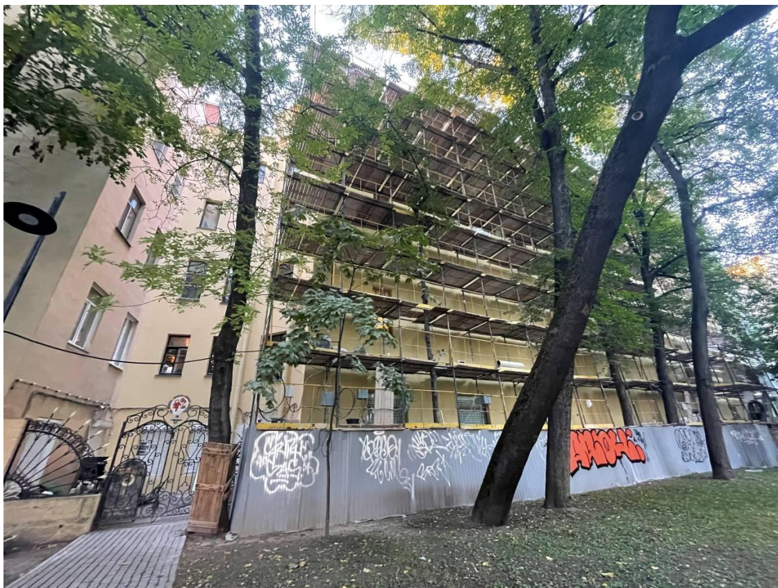
Фото 1. Фрагмент лицевого фасада объекта культурного наследия регионального значения «Дом Э.Г. Шведерского»
