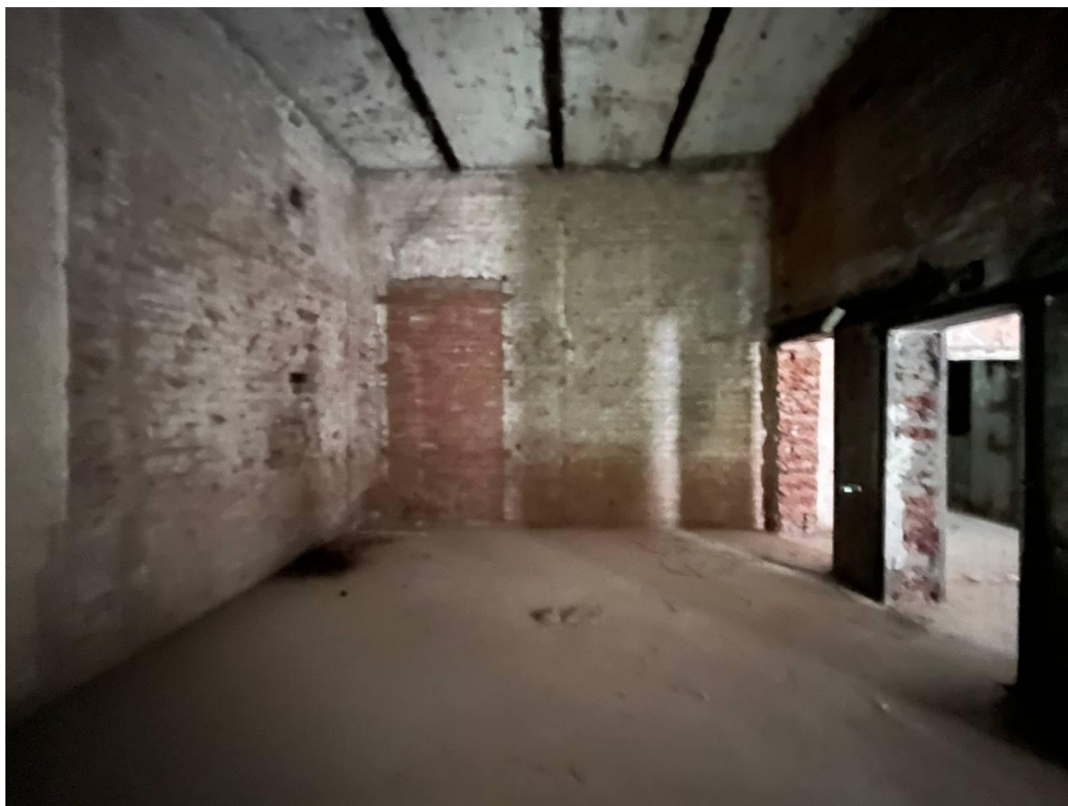
Фото 10. Интерьер пом. 9-Н объекта культурного наследия регионального значения «Дом Э.Г. Шведерского»
