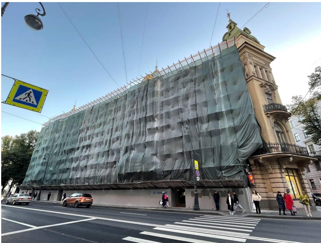
Фото 3. Фрагмент лицевого фасада объекта культурного наследия регионального значения «Дом Э.Г. Шведерского»
