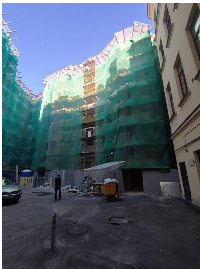
Фото 6. Фрагмент дворового фасада объекта культурного наследия регионального значения «Дом Э.Г. Шведерского»
