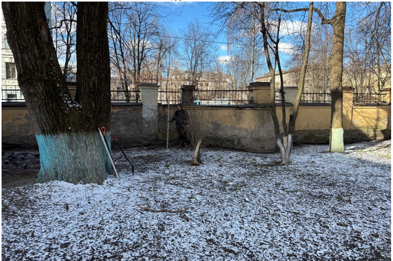
Рис. 38. СПб-2025. Василеостровский р-н. 14-я линия В.О. д. 57-61. Шурф №2. Вид до начала работ. Вид с востока
