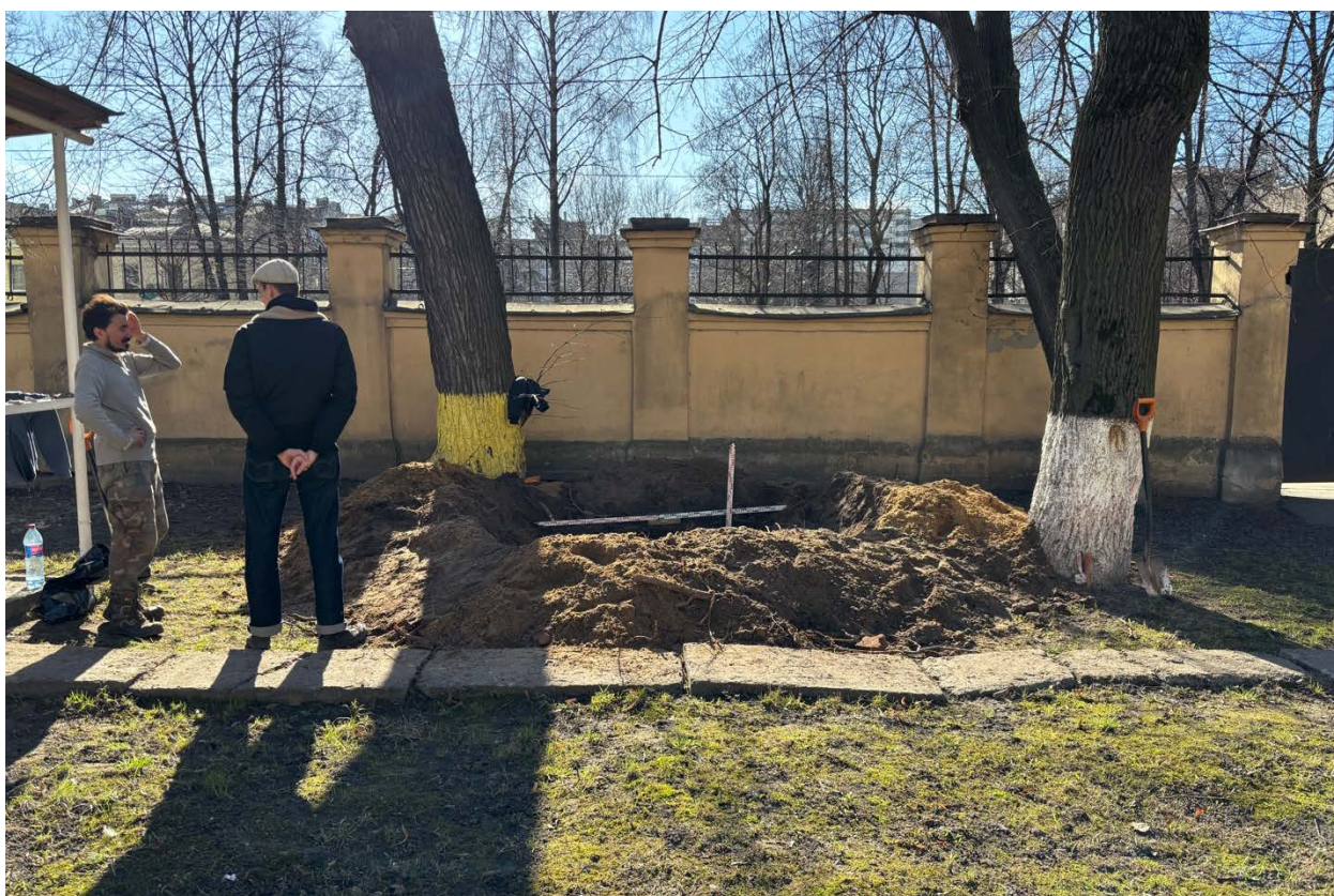
Рис. 22. СПБ-2025. Василеостровский р-н. 14-я линия В.О. д. 57-61. Шурф №1. Вид выкопанного шурфа. Вид с востока
