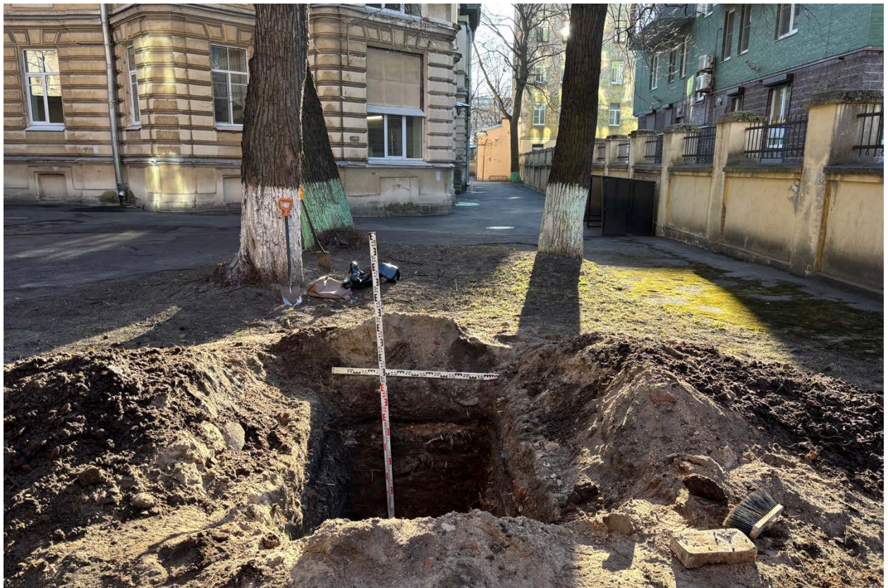
Рис. 55. СПб-2025. Василеостровский р-н. 14-я линия В.О. д. 57-61. Шурф №3. Вид выкопанного шурфа. Вид с востока
