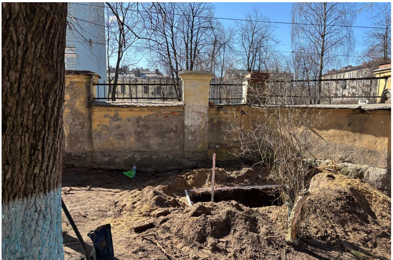
Рис. 39. СПб-2025. Василеостровский р-н. 14-я линия В.О. д. 57-61. Шурф №2. Вид выкопанного шурфа. Вид с востока
