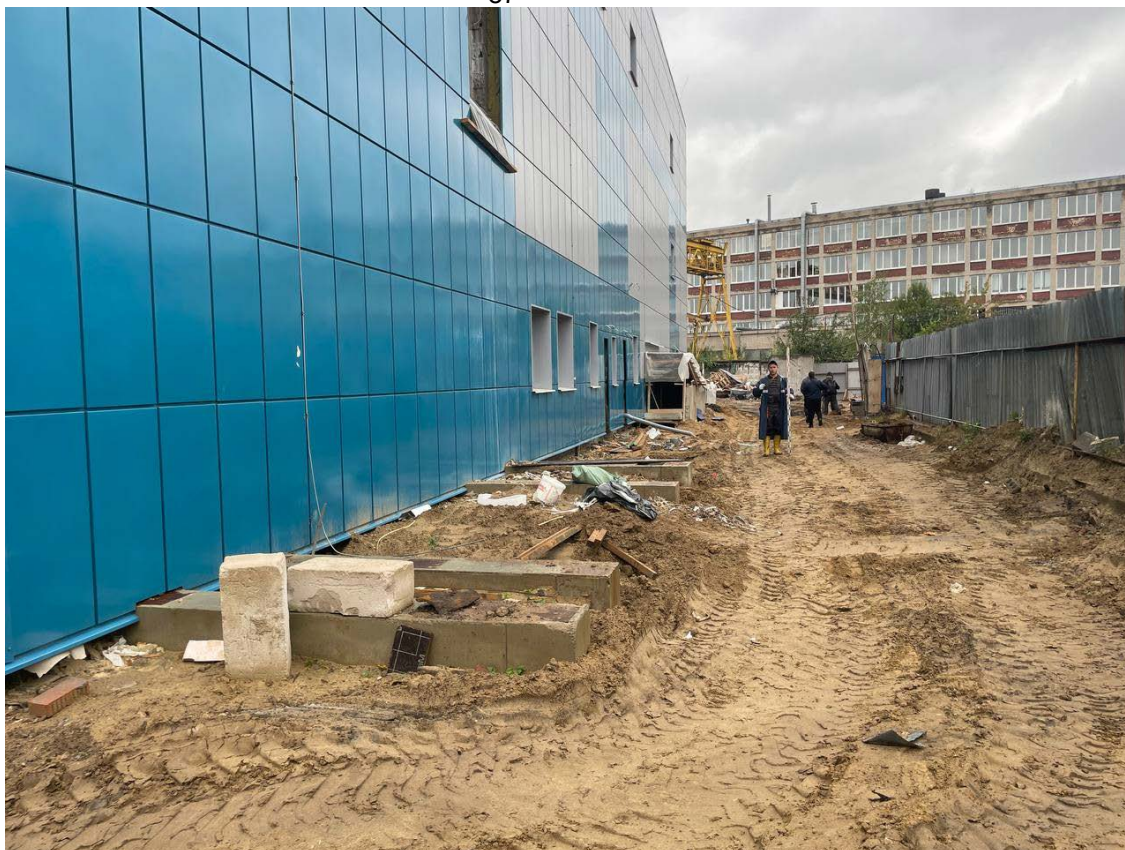
Рис. 21. СПб-2025. Литовская ул., 21, к. 2А. КН: 78:10:0005114:24. Точка фотофиксации 4, вид с юга.
