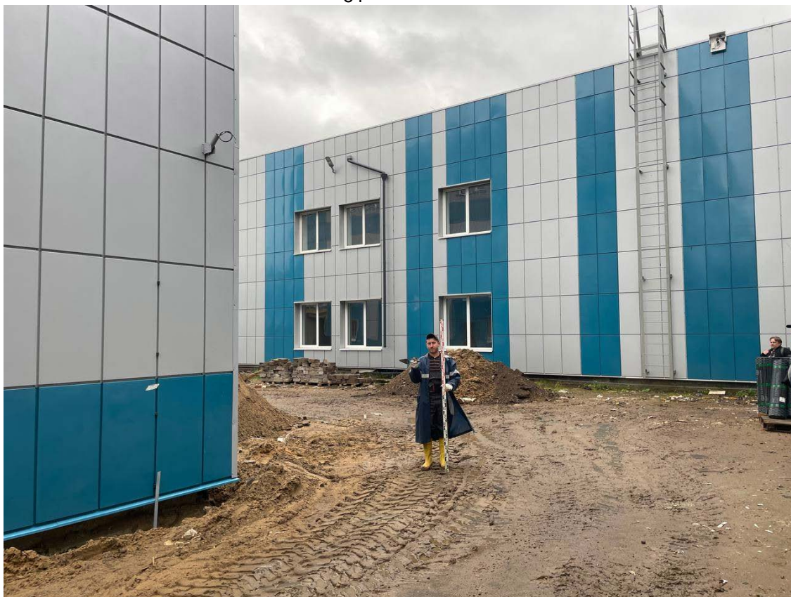
Рис. 15. СПб-2025. Литовская ул., 21, к. 2А. КН: 78:10:0005114:24. Точка фотофиксации 1, вид с запада.
