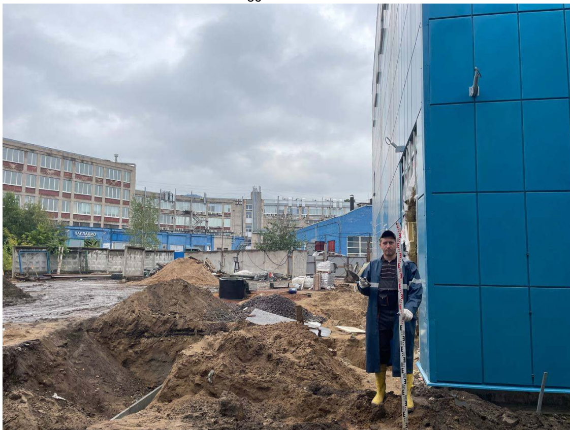
Рис. 19. СПб-2025. Литовская ул., 21, к. 2А. КН: 78:10:0005114:24. Точка фотофиксации 3, вид с запада.
