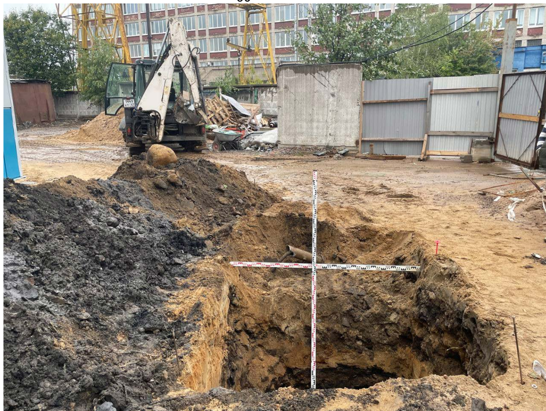
Рис. 27. СПб-2025. Литовская ул., 21, к. 2А. КН: 78:10:0005114:24. Шурф 1, фиксация по уровню окончания работ, вид с юго-востока.
