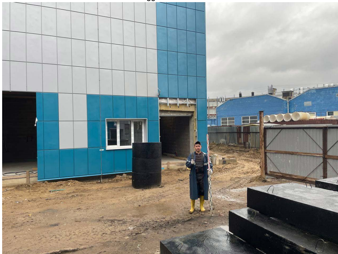
Рис. 23. СПб-2025. Литовская ул., 21, к. 2А. КН: 78:10:0005114:24. Точка фотофиксации 6, вид с юга.
