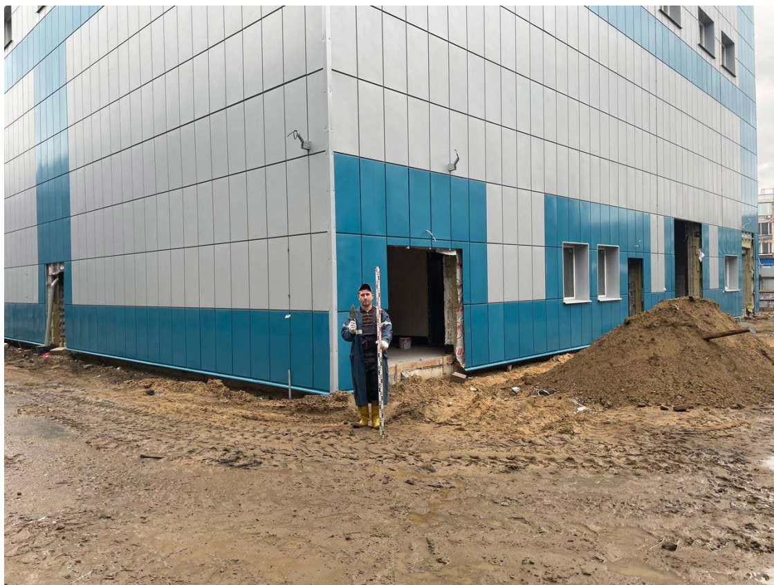
Рис. 16. СПб-2025. Литовская ул., 21, к. 2А. КН: 78:10:0005114:24. Точка фотофиксации 1, вид с юга.
