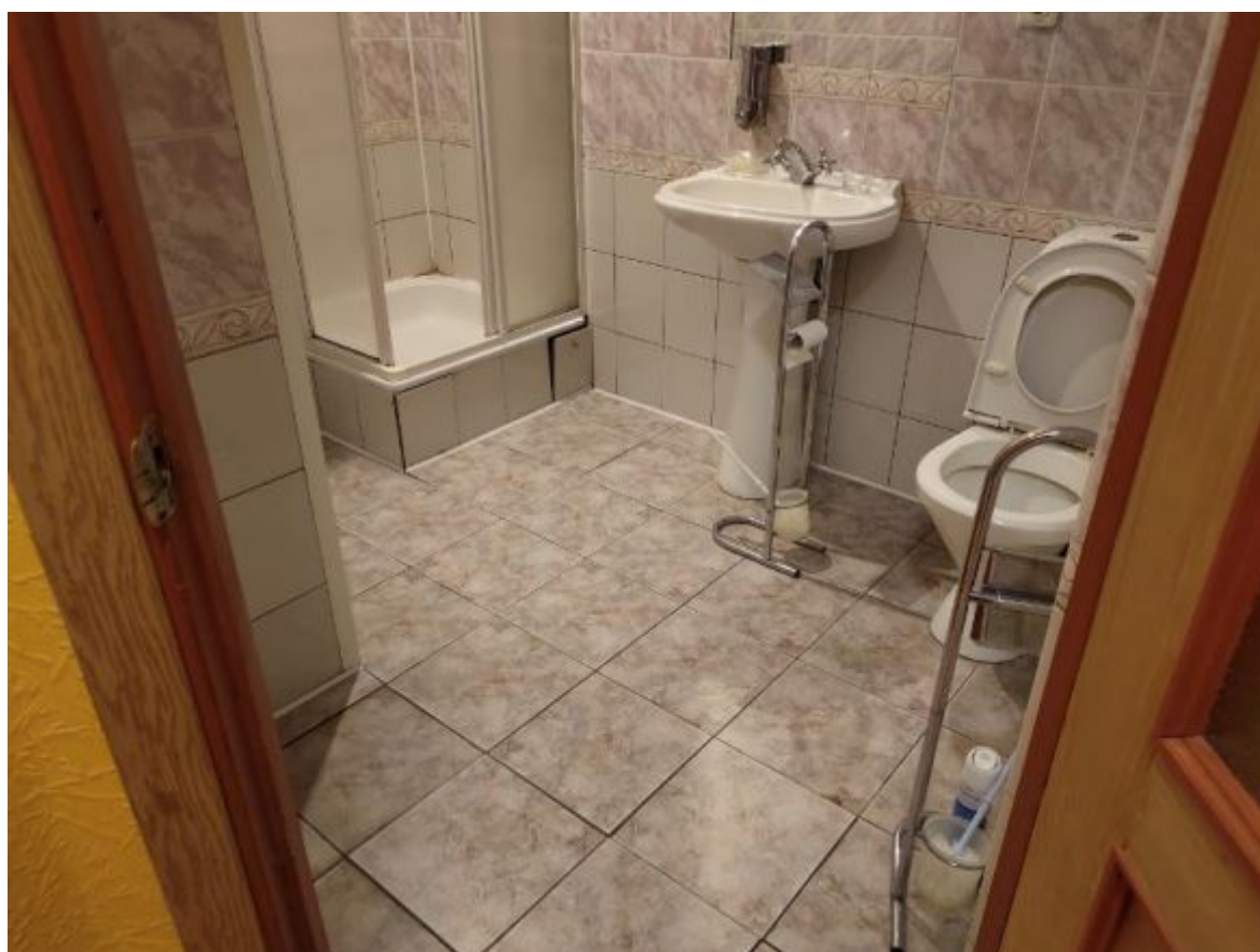
34. ОКН регионального значения «Бывший дом Толстого (фасады)» (г. Санкт-Петербург, Фонтанки р. наб., 54; Рубинштейна ул., 15-17) Помещение квартиры № 232.
