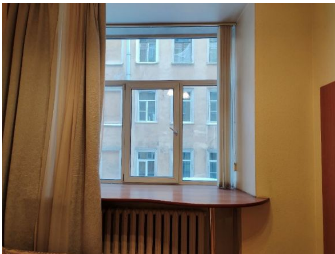
16. ОКН регионального значения «Бывший дом Толстого (фасады)» (г. Санкт-Петербург, Фонтанки р. наб., 54; Рубинштейна ул., 15-17) Помещение квартиры № 232.
