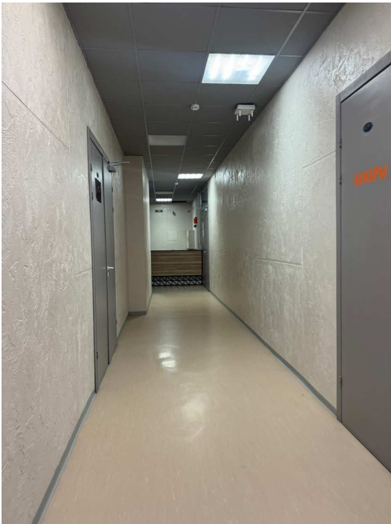
Фото 49. Вид на интерьер помещения объекта культурного наследия.
