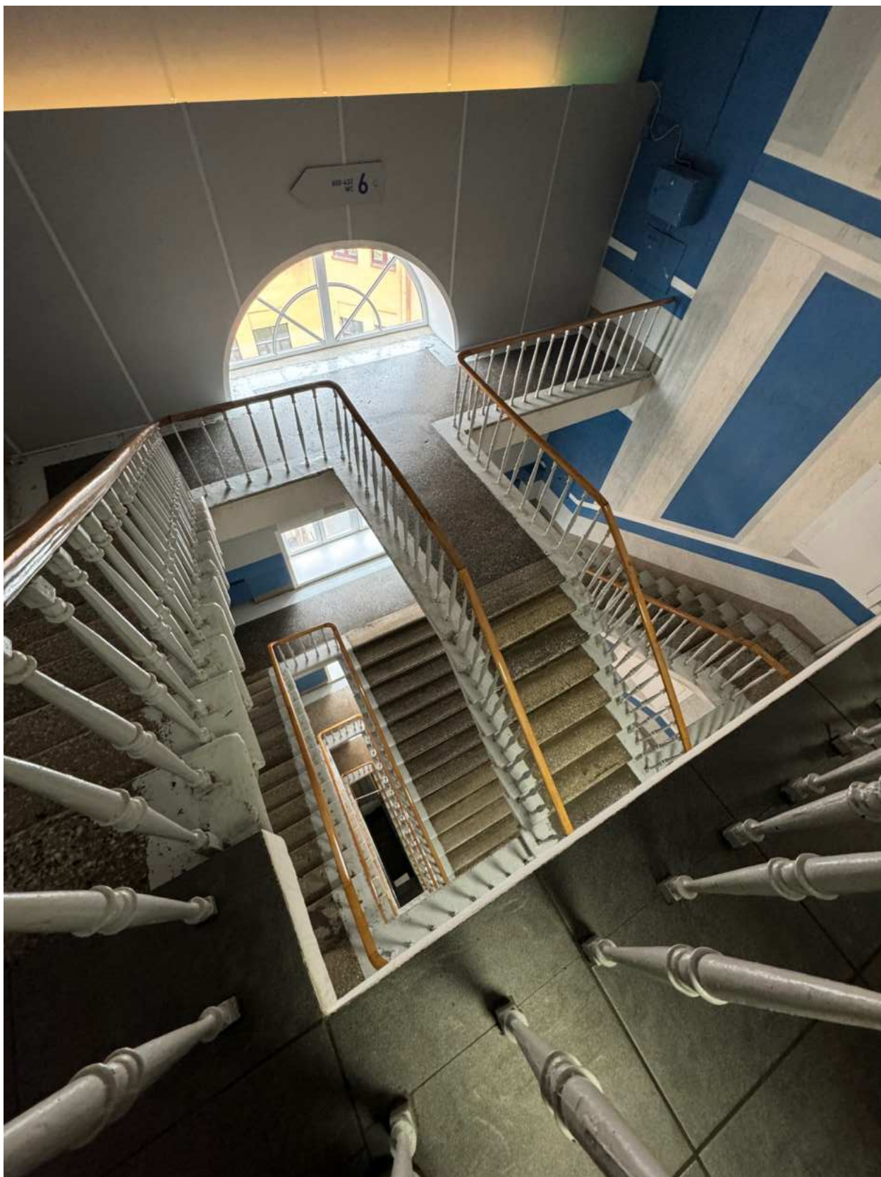
Фото 12. Вид на парадную лестницу объекта культурного наследия.
