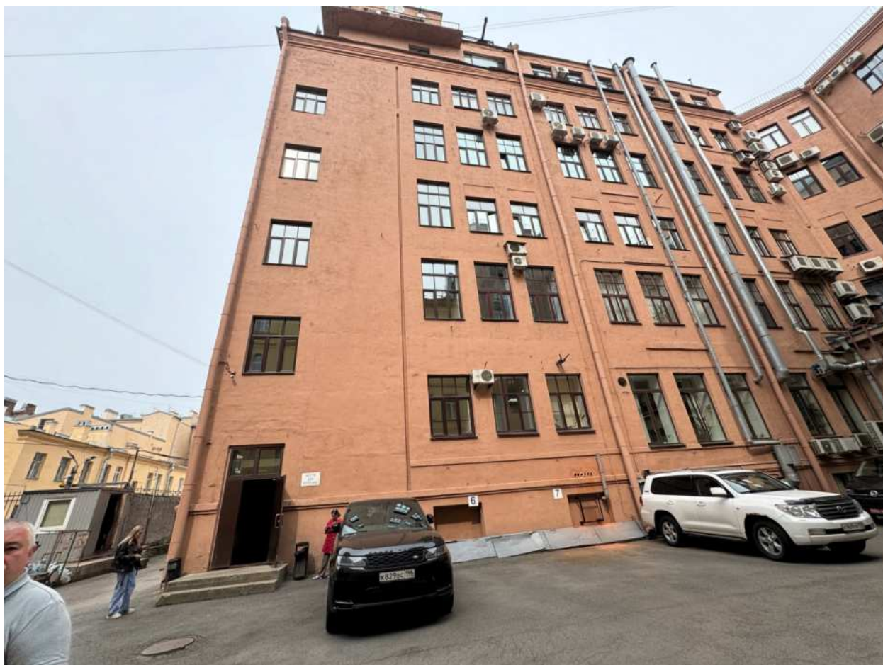
Фото 7. Вид на дворовые фасады объекта культурного наследия.
