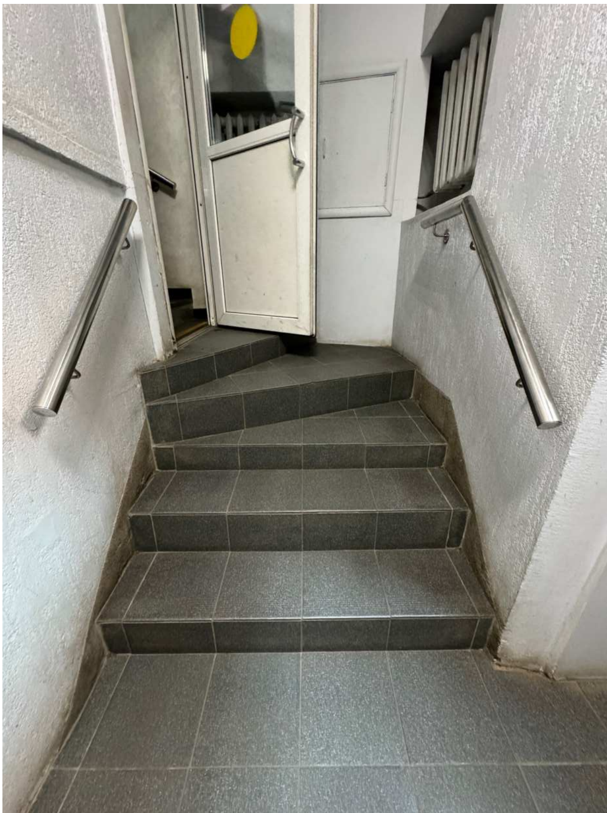
Фото 88. Вид на интерьер помещения объекта культурного наследия.
