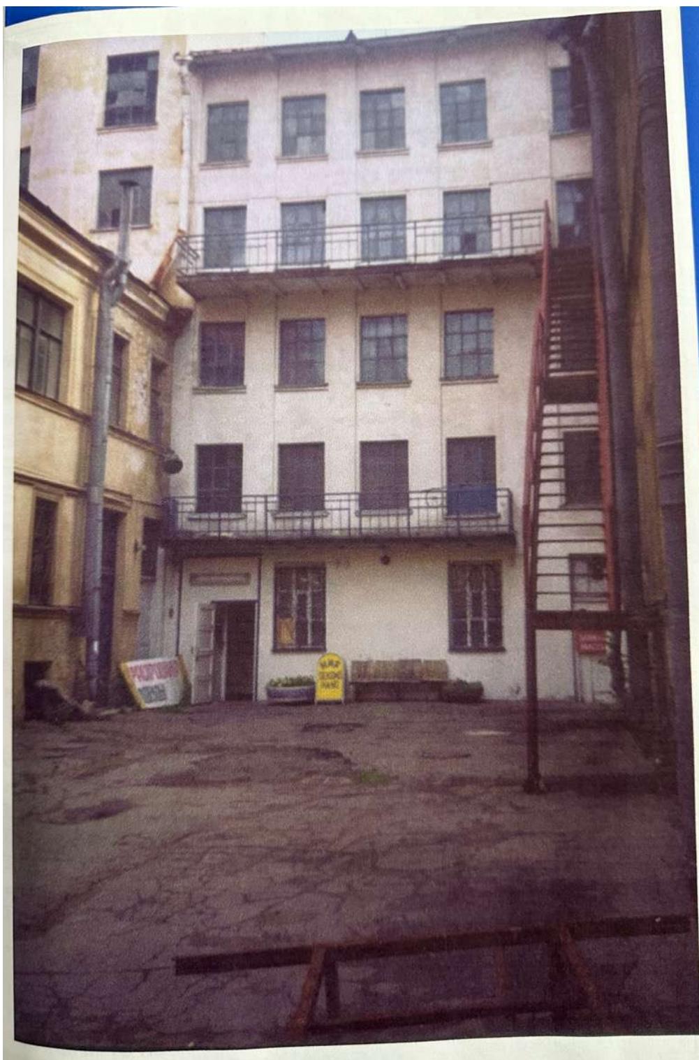
135. Дворовой фасад. Объемно-пространственное и архитектурное решение реконструкции дома 25 по 8 линии В.О. СПб, 2003 г. Архив КГИОП П 1500-Л ин. 1024
