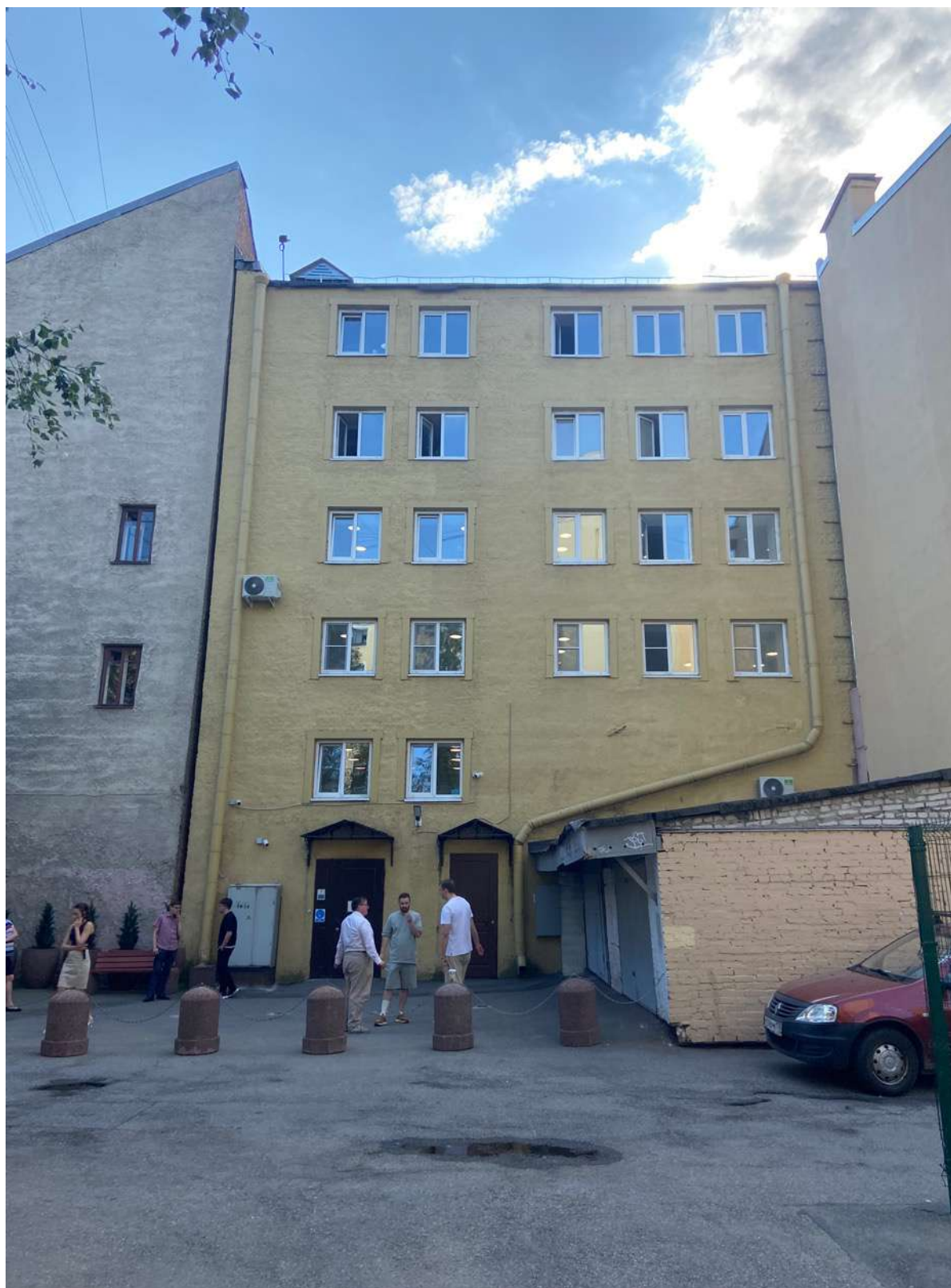
5. Фасад дворового корпуса
