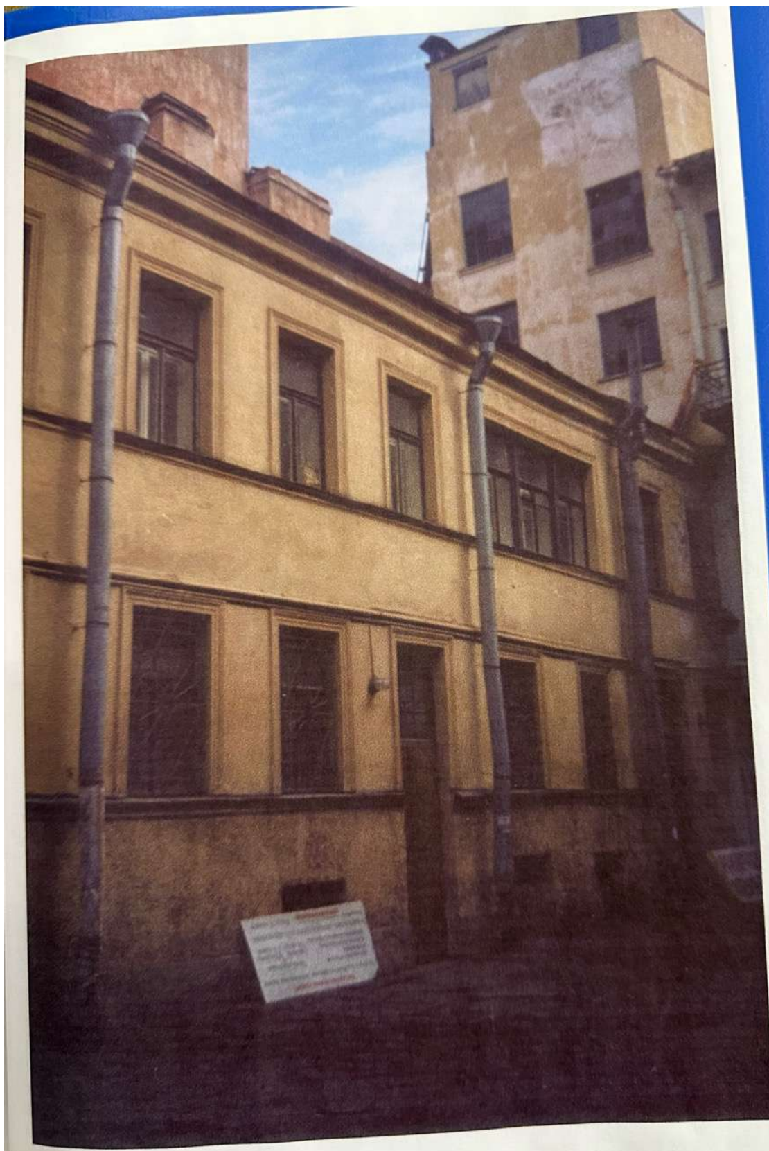
134. Дворовой фасад. Объемно-пространственное и архитектурное решение реконструкции дома 25 по 8 линии В.О. СПб, 2003 г. Архив КГИОП П 1500-Л ин. 1024
