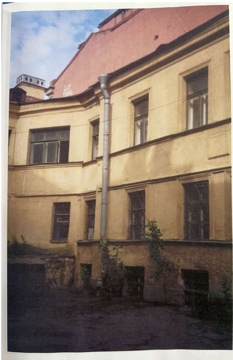
133. Дворовой фасад. Объемно-пространственное и архитектурное решение реконструкции дома 25 по 8 линии В.О. СПб, 2003 г. Архив КГИОП П 1500-Л ин. 1024
