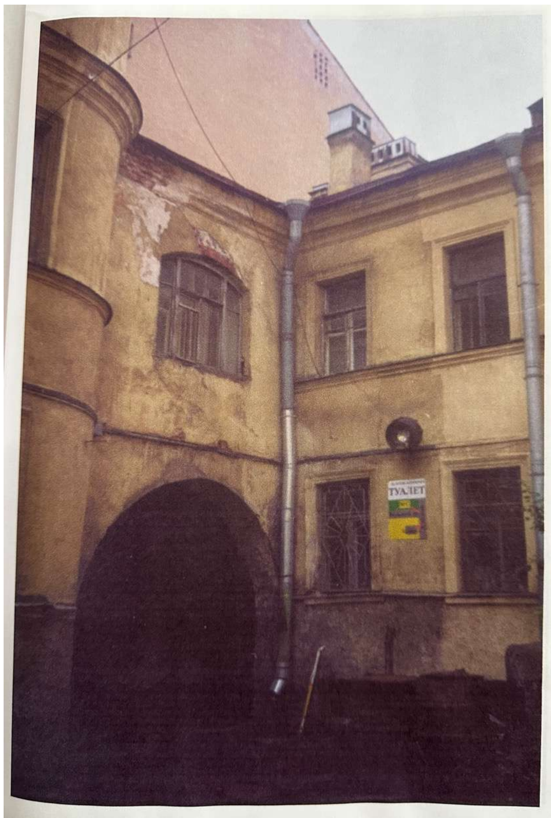
132. Дворовой фасад. Объемно-пространственное и архитектурное решение реконструкции дома 25 по 8 линии В.О. СПб, 2003 г. Архив КГИОП П 1500-Л ин. 1024
