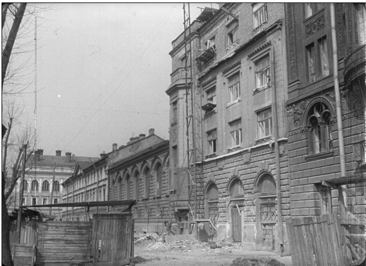
31. Реконструкция здания Ленинградской студии кинохроники. 1958-1965 гг.
