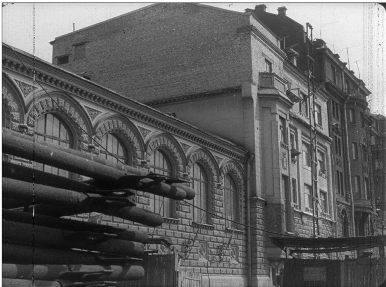
32. Реконструкция здания Ленинградской студии кинохроники. 1958-1965 гг.
