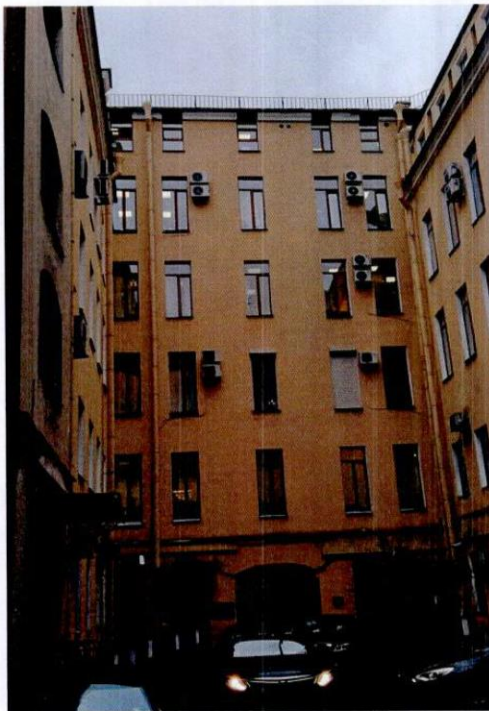
2. Вид на восточный дворовый фасад объекта культурного наследия
