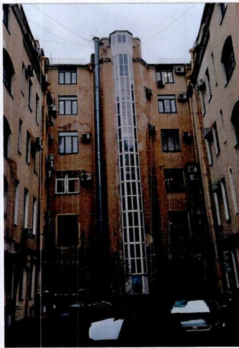
3. Вид на западный дворовый фасад объекта культурного наследия
