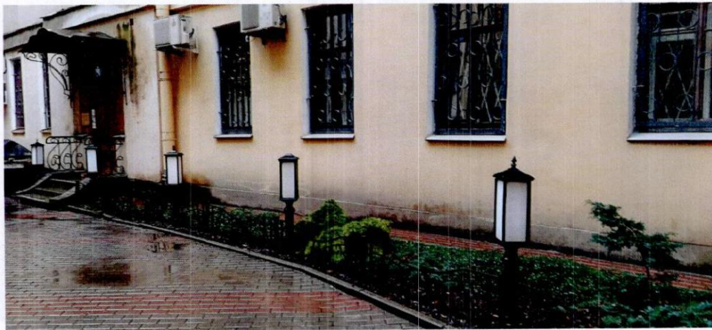
4. Вид на газонный участок вдоль фасада объекта культурного наследия
