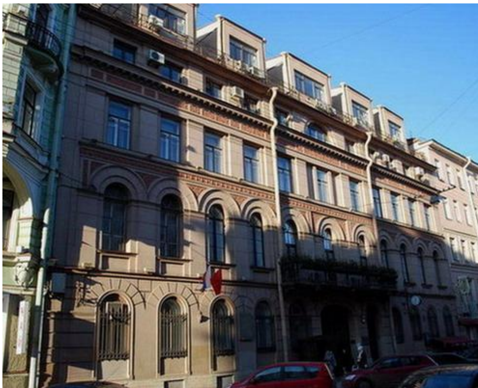
10. Дом жилой страхового общества «Саламандра и др.» по адресу: г. Санкт-Петербург, ул. Караванная, дом 9, литера А (г. Санкт-Петербург, ул. Караванная, дом 9). Главный (лицевой) фасад. Фотография. 2009 г. Приведено на: https://www.citywalls.ru/
