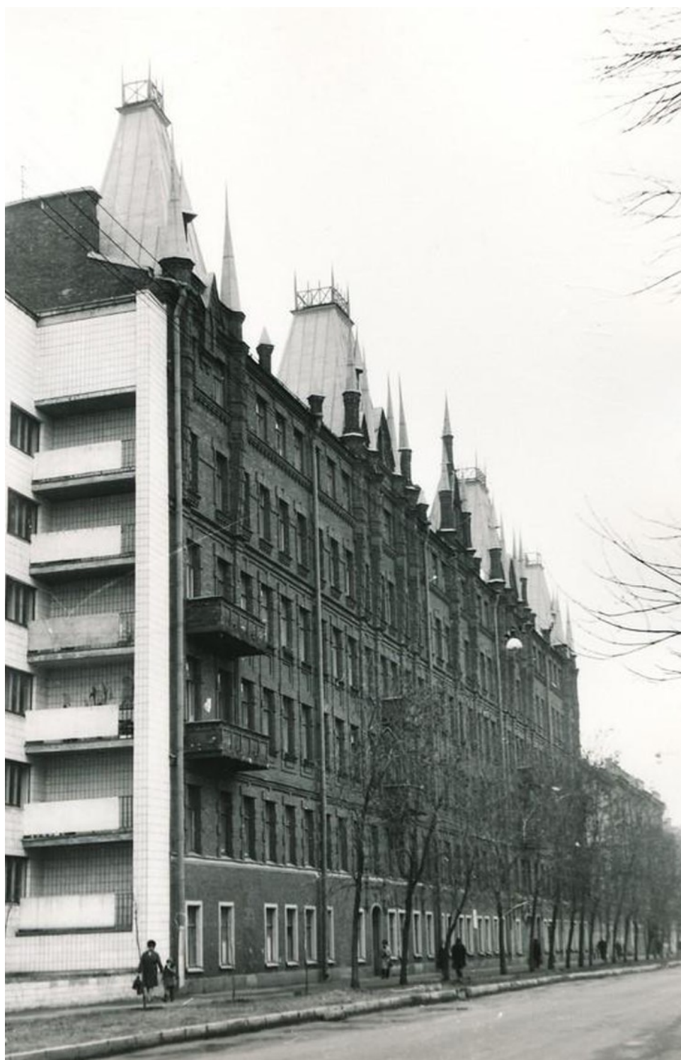
Илл. 41. Вид части центрального фасада жилого дома № 46 по 5-й линии (бывший доходный дом А.А. Еремеевой, архитектор М.Ф. Еремеев, 1903- 1905 гг). 25 апреля 1979 г. ЦГАКФФД СПб. Фотодокументы. Опись 1АР-162. Ед. хр. 238519.
