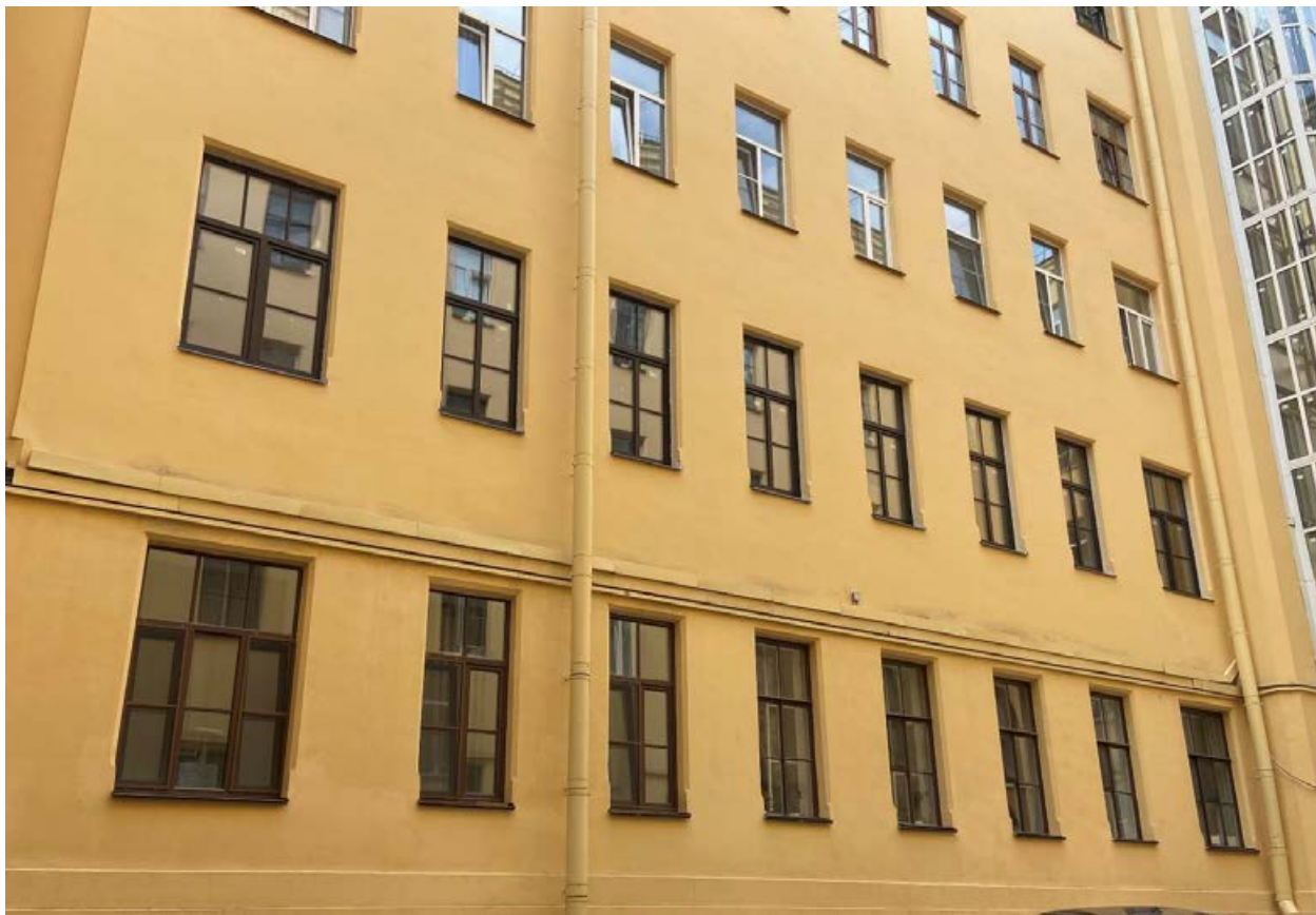
Фото 5. Оконные заполнения, в уровне второго этажа – окна кв.3.
