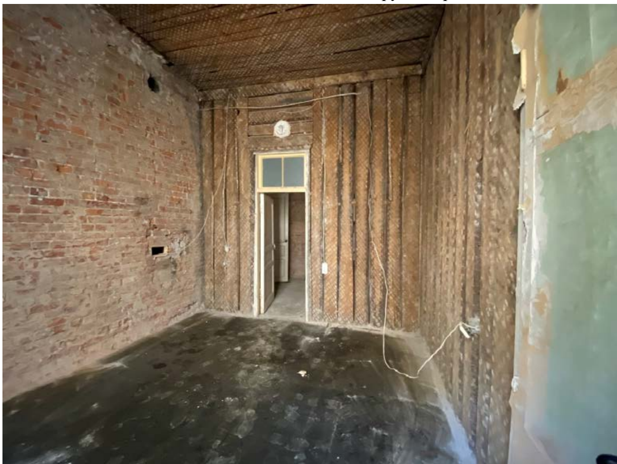
Фото 12. Помещение 7, вид на вход.
