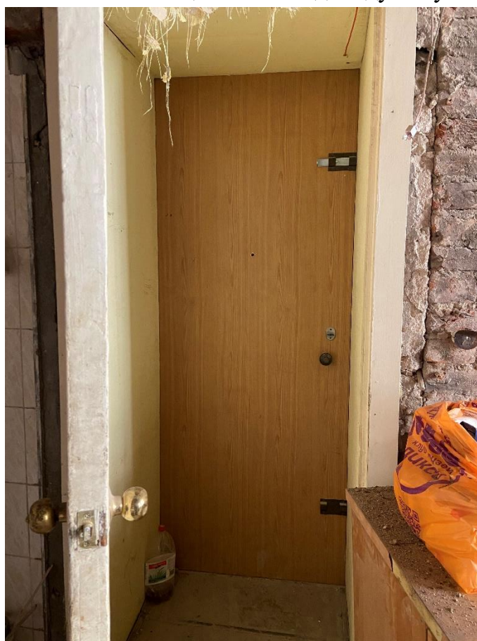
Фото 20. Вид на дверной проем и заполнение на 2 ЛК.
