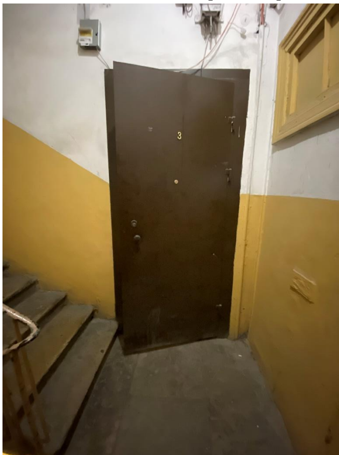
Фото 8. Поздняя входная дверь со стороны 2ЛК.
