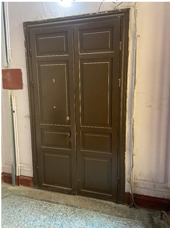
Фото 7. Поздняя входная дверь со стороны 1ЛК.
