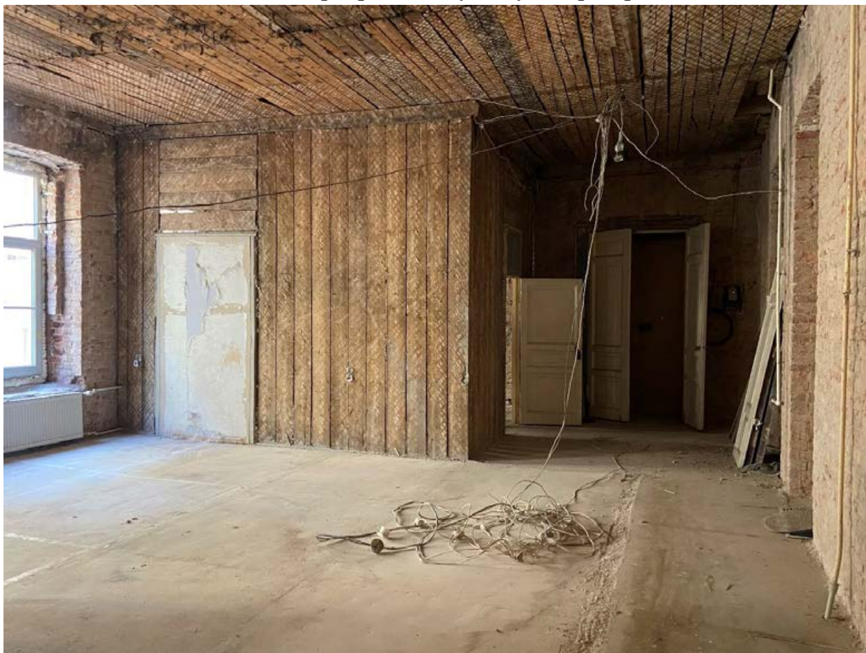
Фото 10. Вид на перегородку помещения 7.
