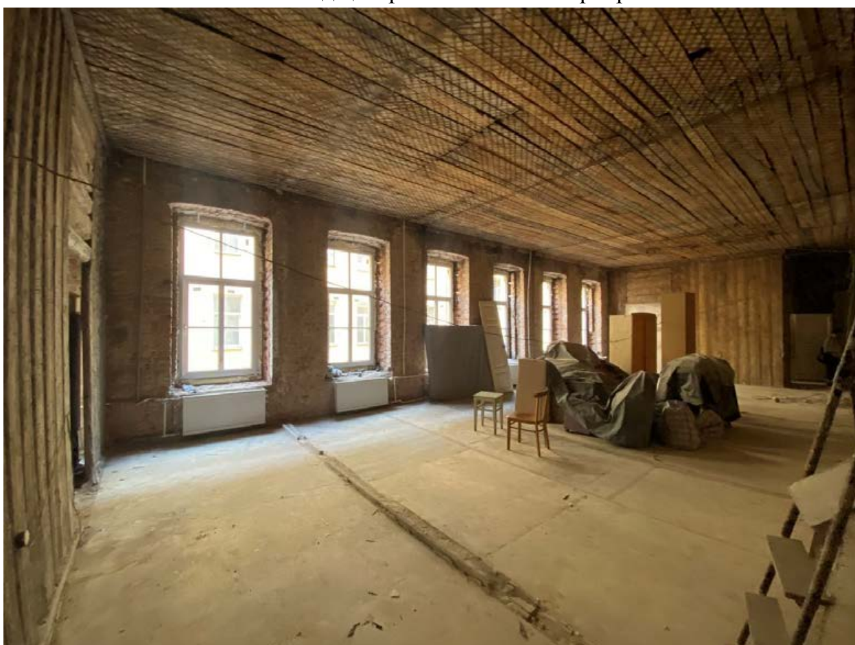
Фото 14. Общий вид квартиры 3, отсутствуют перегородки и отделка.
