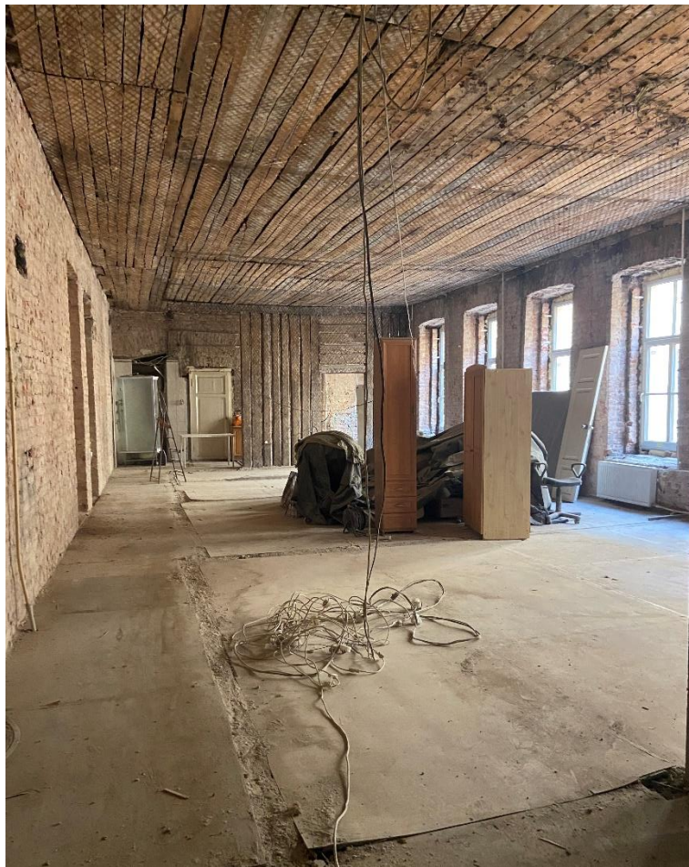
Фото 9. Общий вид квартиры 3. Отсутствуют перегородки и отделка.
