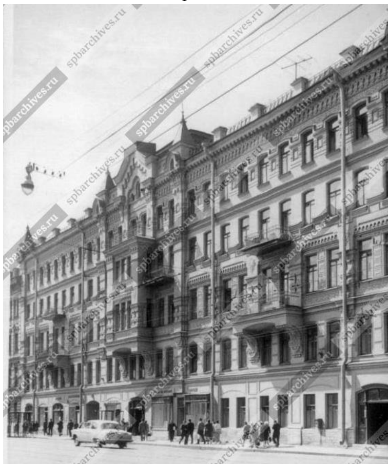
Илл. 58. Вид дома №31 на Литейном проспекте (бывший доходный дом Императорского человеколюбивого общества, архитектор Ф.С.Харламов, 1877-1880 гг.). 10.07.1967 г. Автор съёмки: Н.А. Науменков. ЦГАКФФД СПб. Фотодокументы. Опись 1БР-49. Ед.хр.61976.
