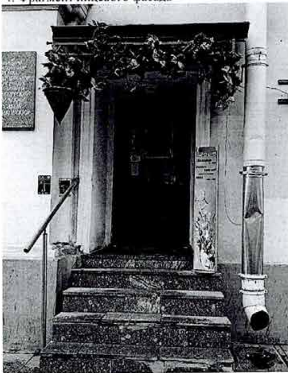
6. Фрагмент лицевого фасада
