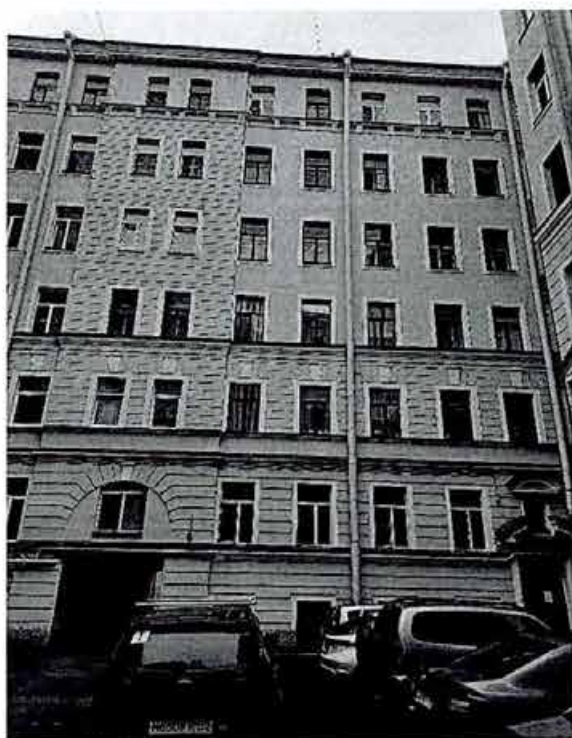
12. Фрагмент дворового фасада
