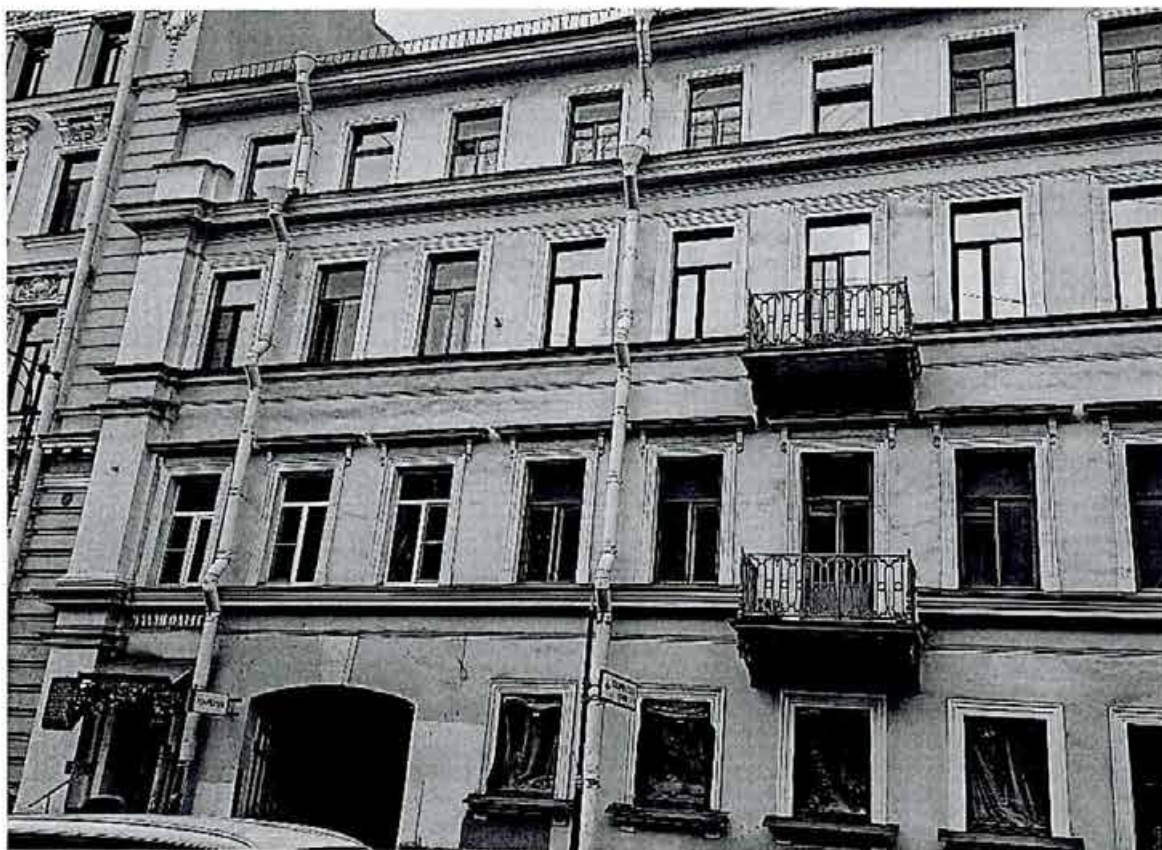
2. Фрагмент лицевого фасада
