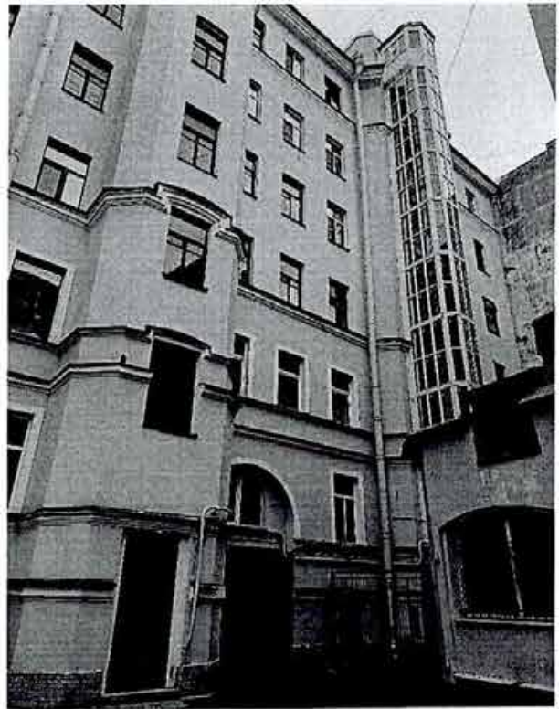
21. Фрагмент дворового фасада
