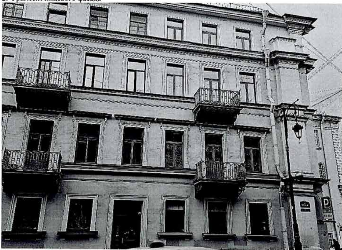
3. Фрагмент лицевого фасада
