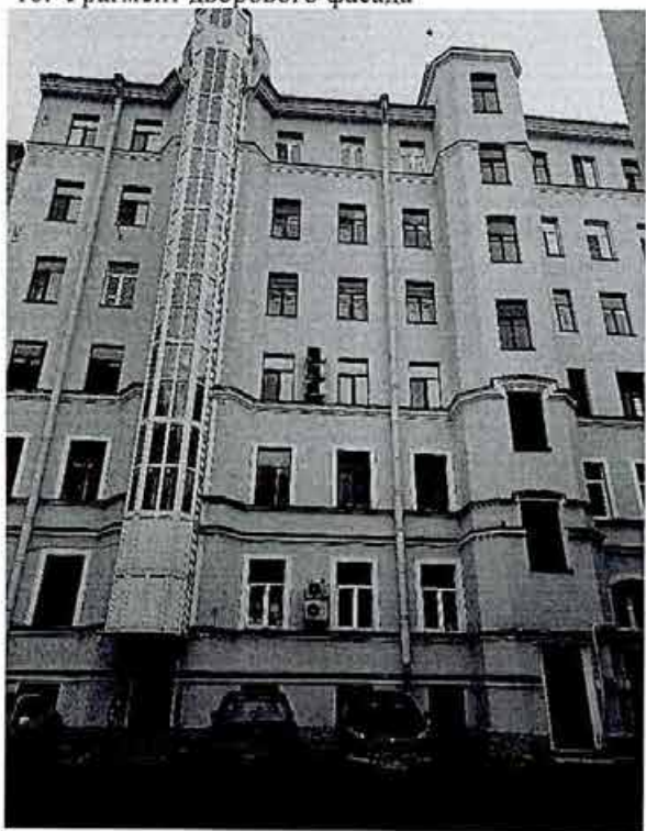
18. Фрагмент дворового фасада
