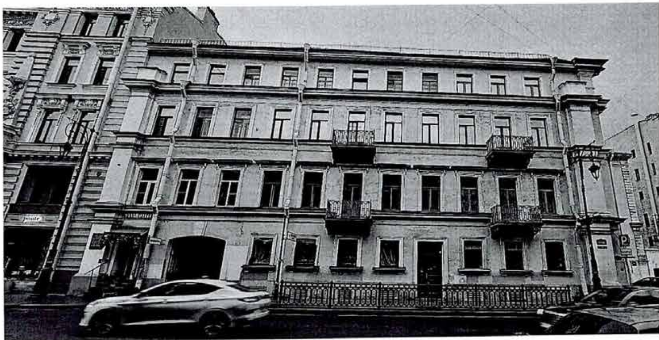
1. Лицевой фасад (общий вид)
