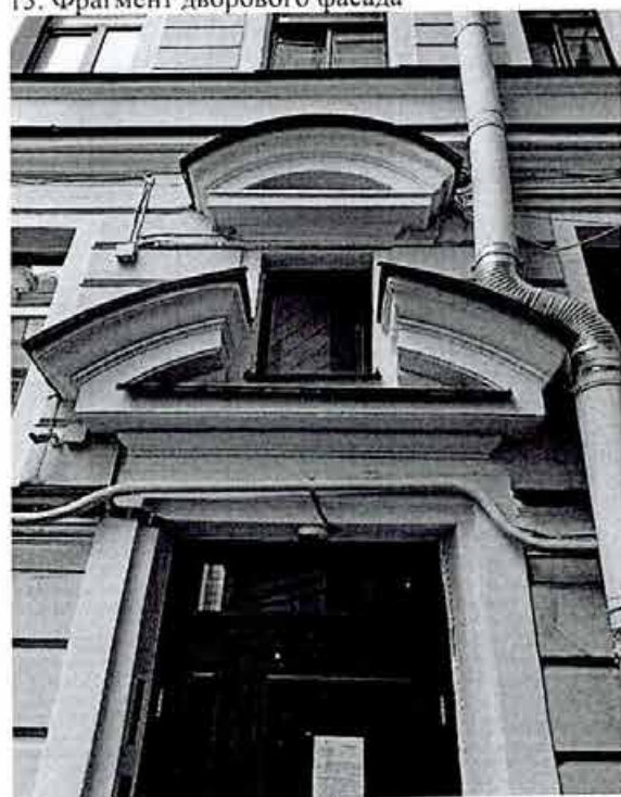
15. Фрагмент дворового фасада
