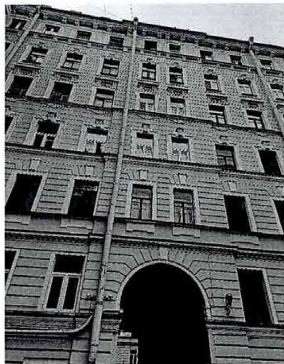
13. Фрагмент дворового фасада
