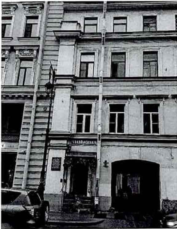
4. Фрагмент лицевого фасада
