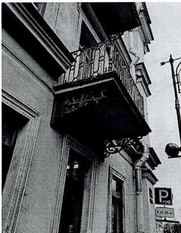
8. Фрагмент лицевого фасада
