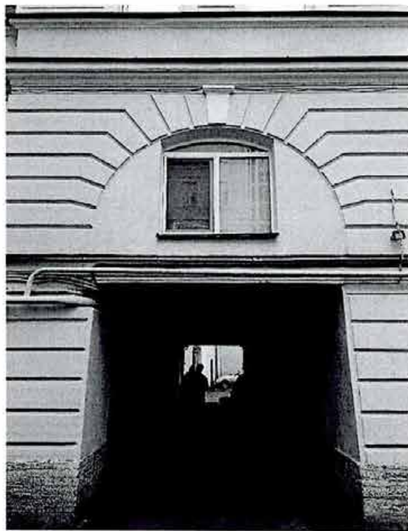
17. Фрагмент дворового фасада
