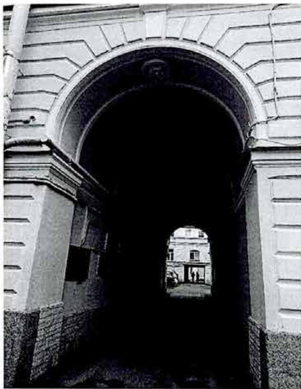
16. Фрагмент дворового фасада
