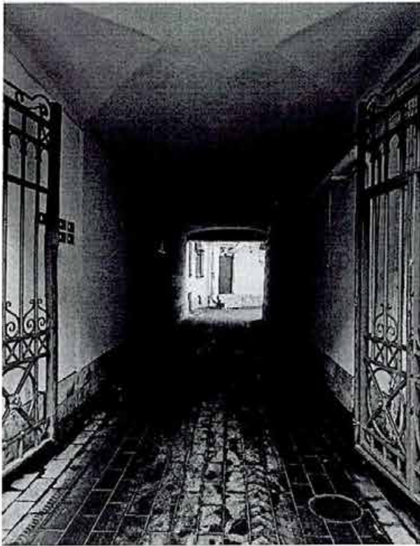
20. Фрагмент дворового фасада
