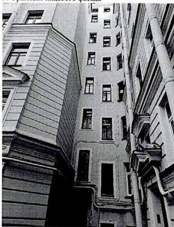
11. Фрагмент дворового фасада
