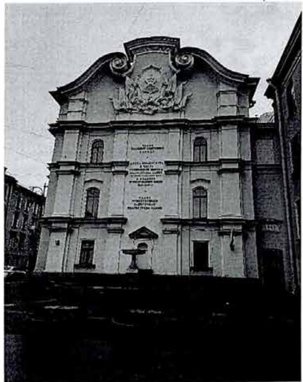
5. Фрагмент лицевого фасада
