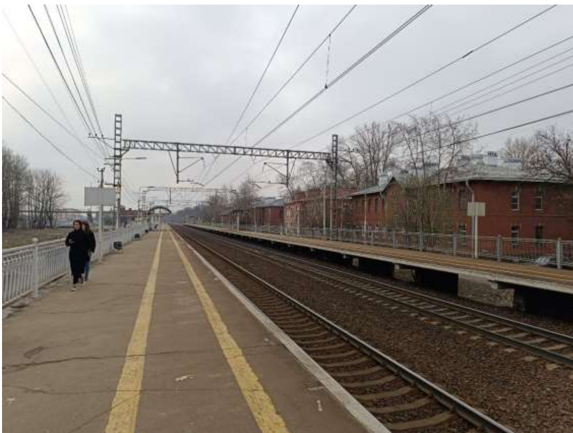
Фото 4. ОКН регионального значения «Историческая железнодорожная станция «Фарфоровский пост»». Общий вид на здания ансамбля.
