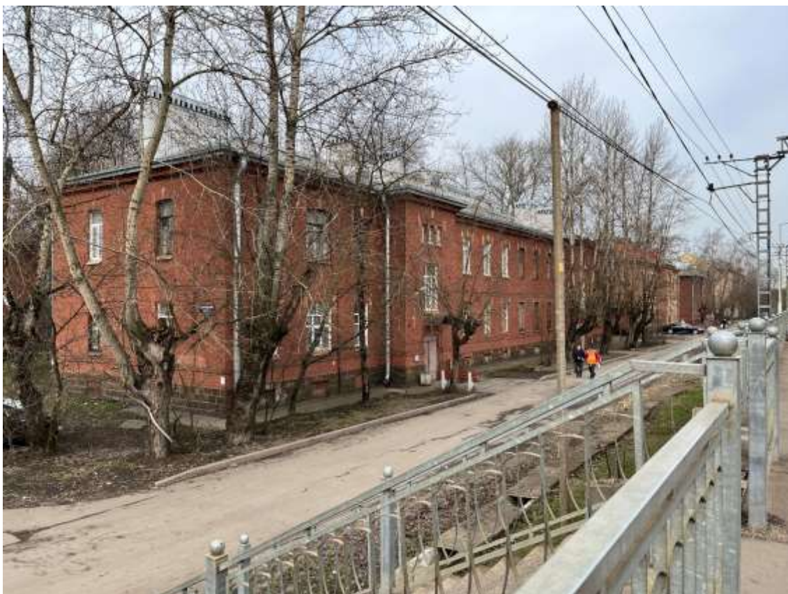
Фото 7. ОКН регионального значения «Историческая железнодорожная станция «Фарфоровский пост»». Общий вид на здание по адресу: Фарфоровский пост, 48.
