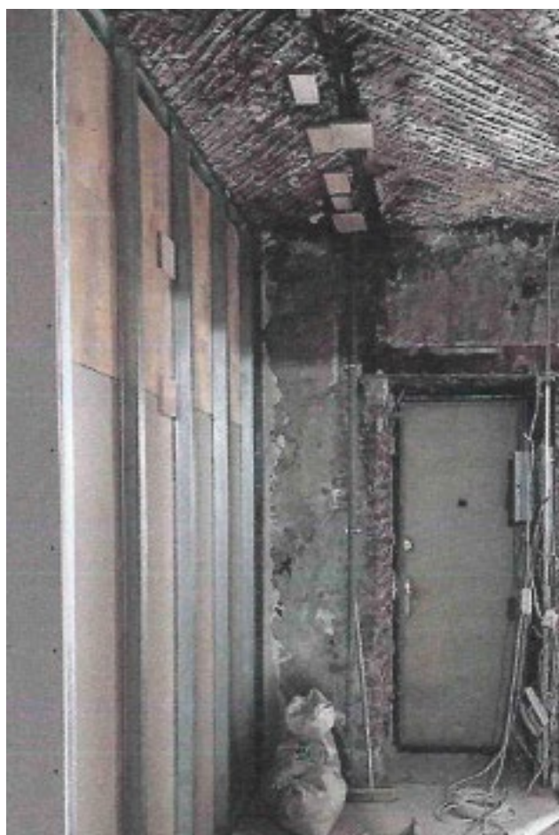
Фото 8. Вид на выход на «черную» лестницу.
