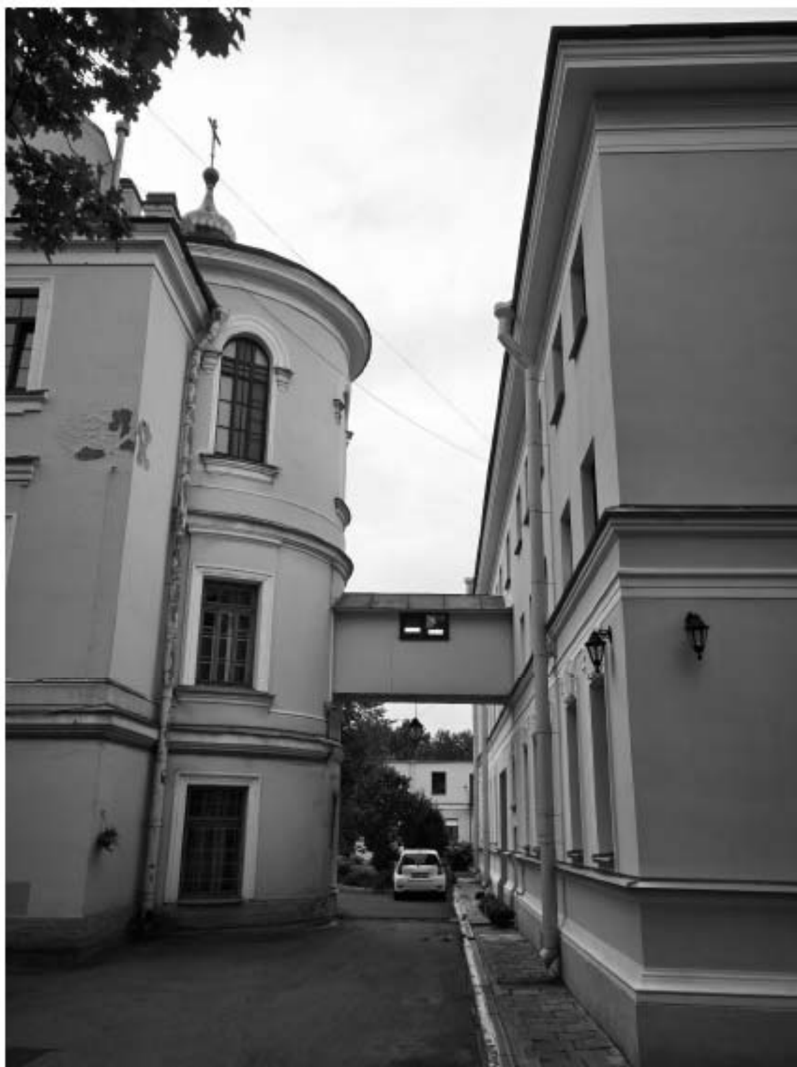
Фото 4. Вид на ОКН на южный фасад. На уровне второго этажа – технический переход в главное здание в апсиду Церкви святого апостола Иоанна Богослова.
