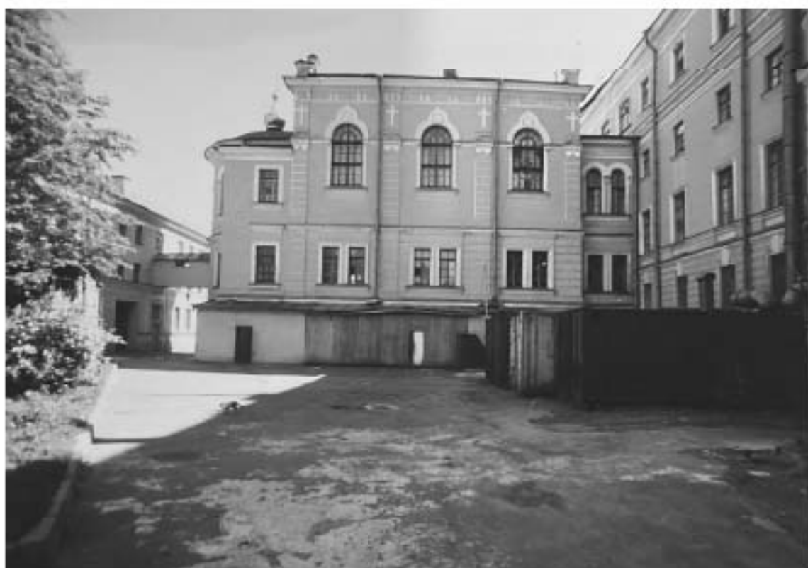
45. 1999 Ансамбль Санкт-Петербургской Духовной семинарии. Западный фасад Церковного корпуса. Слева – здание больницы с переходом. Авт. В.П. Орлов. Архив КГИОП, Паспорт памятника.
