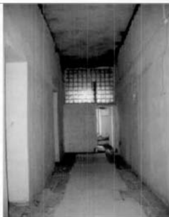
10. Коридор. Общий вид. Академический квартирный флигель.
