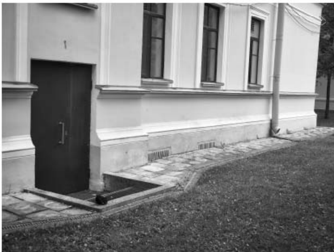
Фото 10. Служебный вход из прудка на северном фасаде ОКН. (Поднятие культурного слоя).
