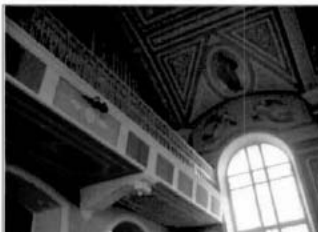
7. Балкон. Интерьер помещения акдемического храма.
