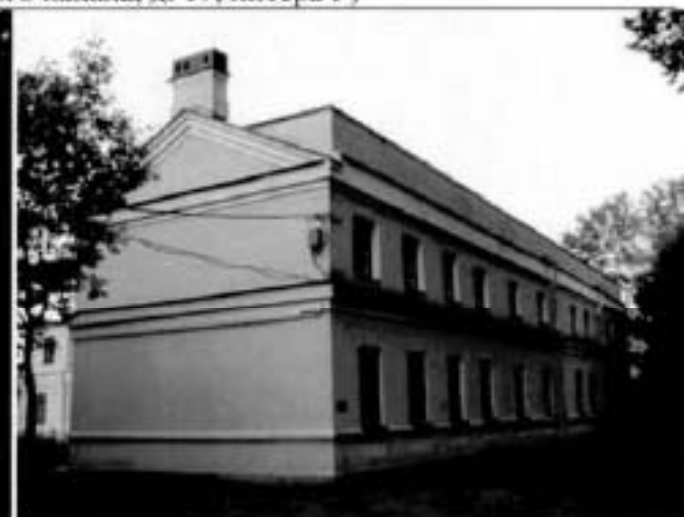
2. Восточный торцевой, северный фасады.
