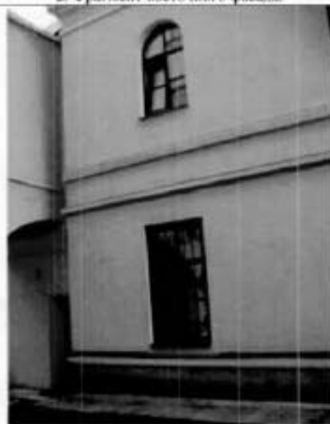
4. Фрагмент западного фасада.
