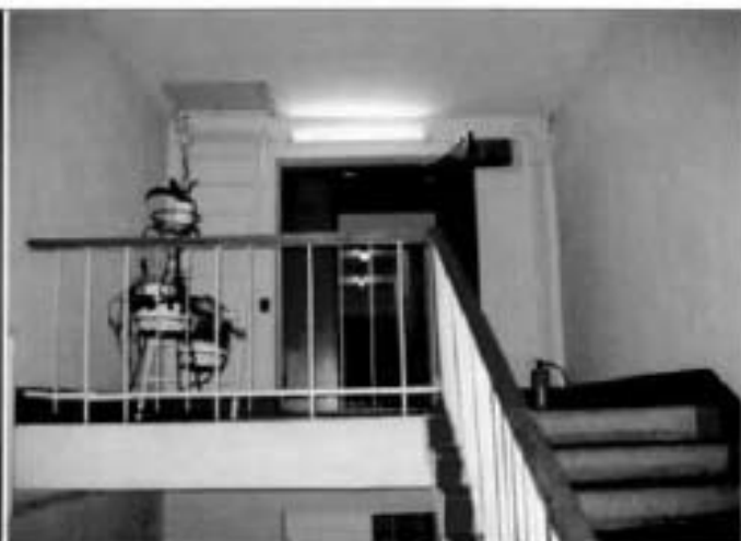
10. Лестница. Общий вид
