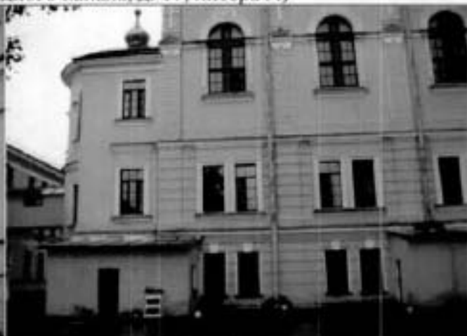
2. Фрагмент западного фасада.
