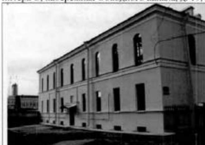
1. Восточный фасад. Академический квартирный флигель.
