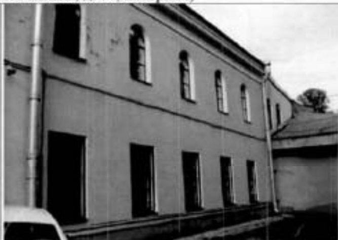
2. Фрагмент восточного фасада.
