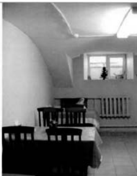
16. Подвал. Общий вид. Казачий квартирный флигель.
