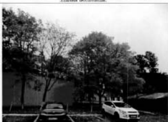
8. Вид со стороны западного фасада Служебного корпуса.
