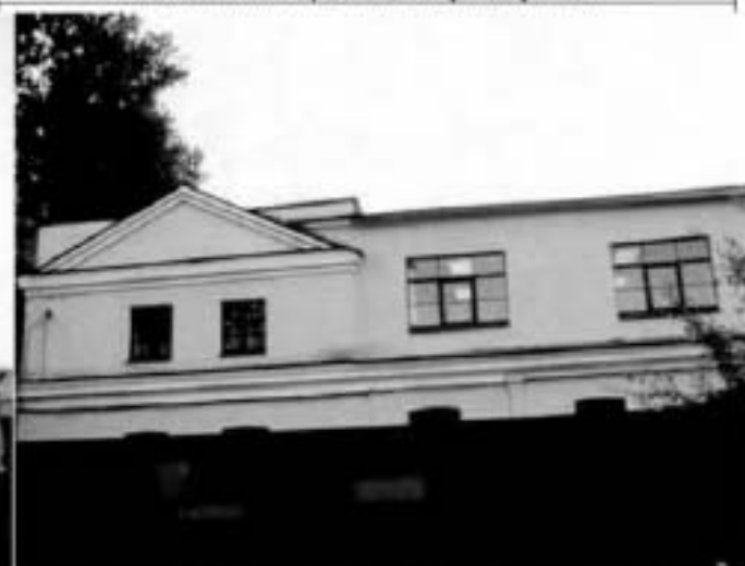
4. Фрагмент западного фасада.
