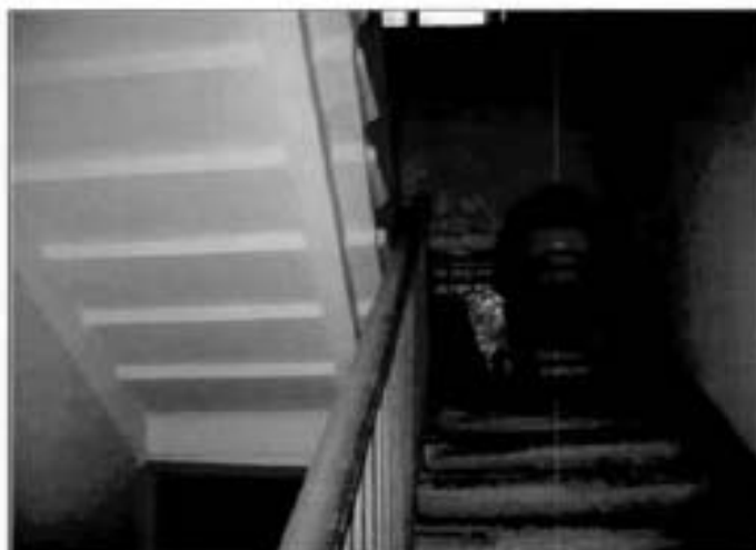
9. Лестница. Общий вид
