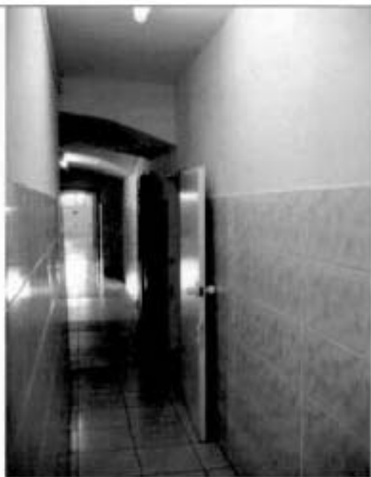
15. Подвал. Общий вид. Казачий квартирный флигель.
