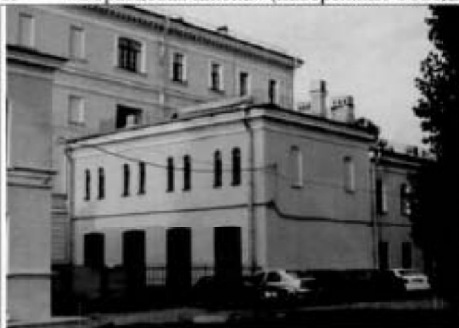
1. Южный, восточный фасад.
