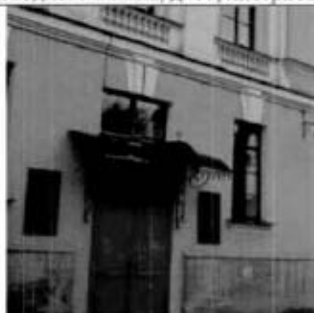
2. Дверной проем южного фасада.
