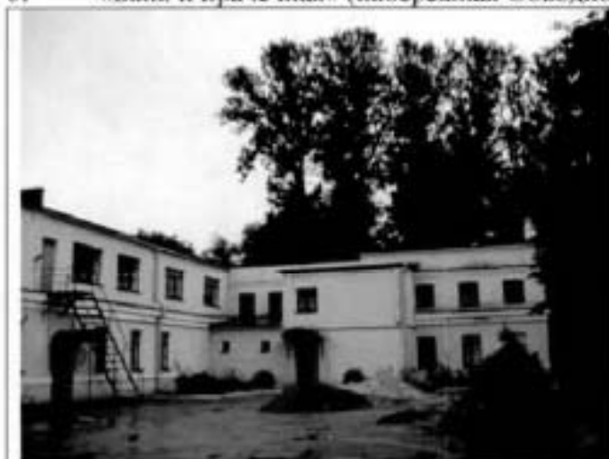
1. Южный, восточный фасады.
