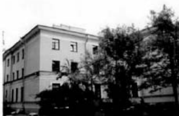
5. Северный, восточный фасады.
