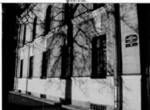
14. Южный фасад. Казачий квартирный флигель.
