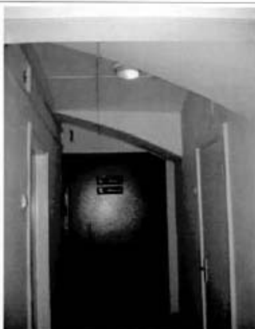
20. Помещение цокольного этажа.
