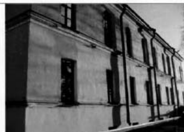
13. Западный фасад. Казачий квартирный флигель.
