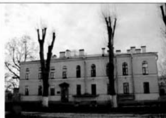
11. Восточный фасад. Казачий квартирный флигель.
