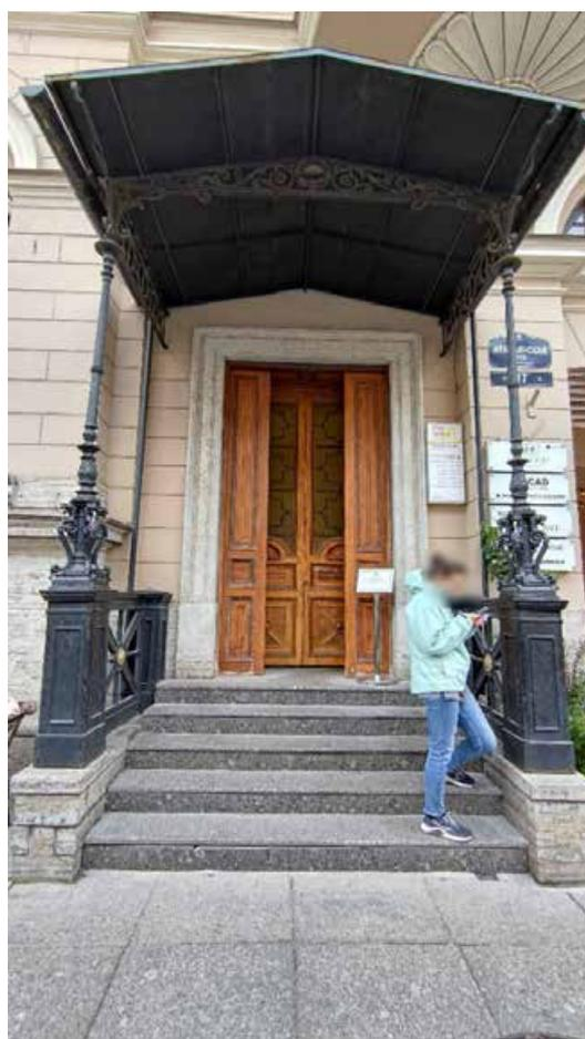
Фото 2. Прямоугольное в плане крыльцо в пять ступеней, с устоями известняковой плиты (северный фасад). Общий вид. Дата фотофиксации: 09.10.25
