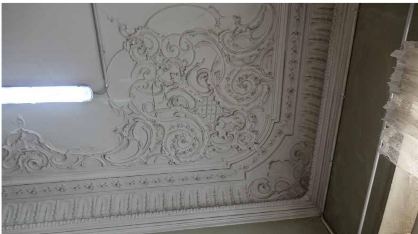
Фото 182. Зеркало плафона в обрамлении лепнины с разноформатными рокайльными элементами, в углах композиции из растительных завитков, цветочных гирлянд и трельяжной сетки. Помещение 19 (48-Н). Фрагмент. Дата фотофиксации: 26.06.25
