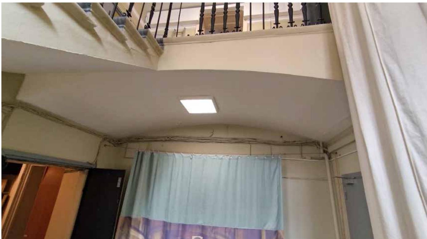
Фото 163. Цилиндрический свод площадки 3-го этажа главной лестницы. Общий вид. Дата фотофиксации: 26.06.25+
