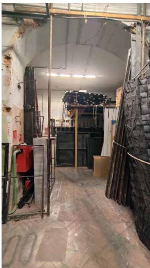
Фото 224. Арочный проем с трехцентровой перемычкой между помещениями. Общий вид. Дата фотофиксации: 26.06.25
