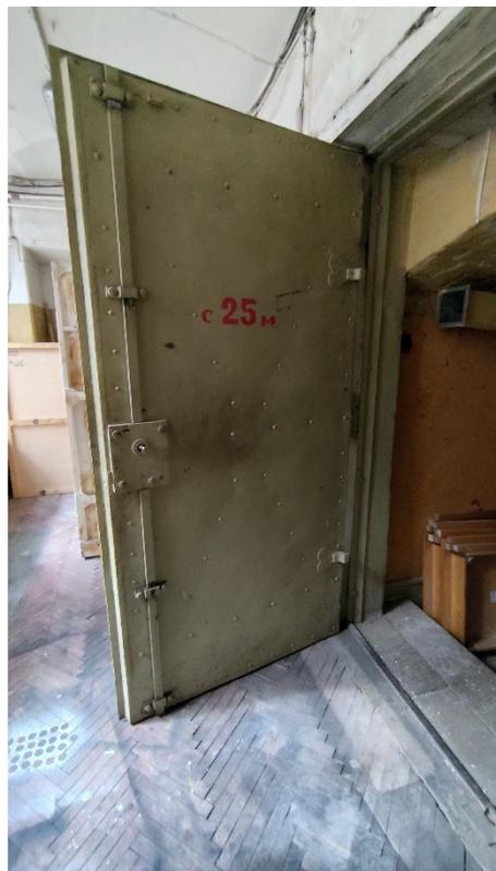
Фото 228. Металлическая клепаная сейфовая дверь с замком между помещениями 12 и 13 (48-Н) в уровне этажа. Общий вид. Дата фотофиксации: 26.06.25
