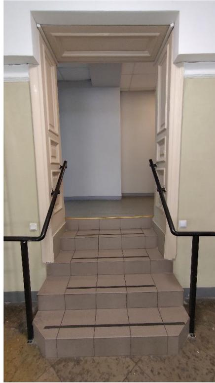
Фото 146. Портал с деревянными филенчатыми панелями. Вход в помещения 53-Н со стороны площадки главной лестницы. Общий вид. Дата фотофиксации: 26.06.25
