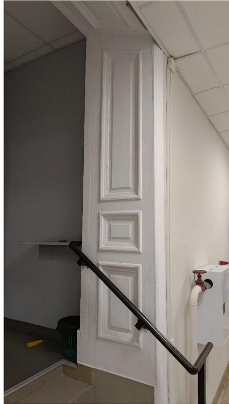
Фото 124. Портал с деревянными филенчатыми панелями в помещение 3 (52-Н). Фрагмент. Дата фотофиксации: 26.06.25
