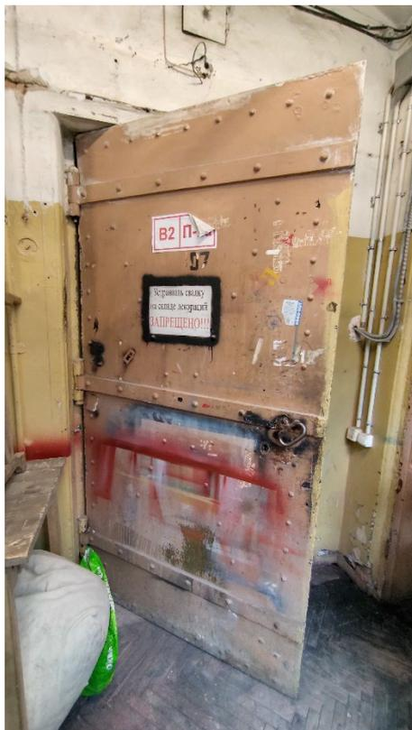
Фото 229. Металлическая клепаная сейфовая дверь с замком между помещениями 12 и 13 (48-Н) в уровне этажа. Общий вид. Дата фотофиксации: 26.06.25
