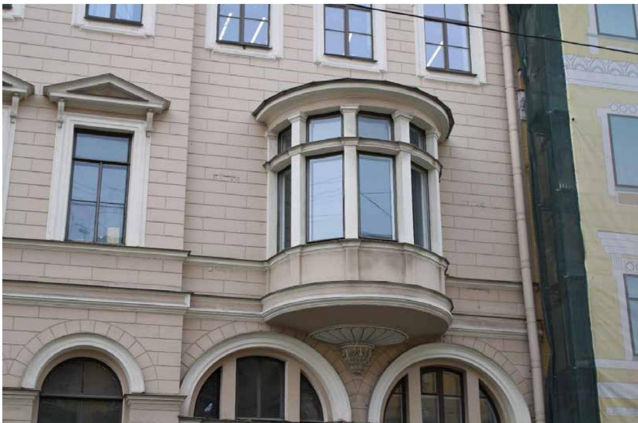
Фото 14. Эркер, полуциркульный в плане, в западной, западающей части фасада, в уровне второго этажа, с лепной композицией в основании, в виде многолепестковой полурозетки с бусами с фиалом из акантовых листьев в центре, увенчанный профилированным выносным карнизом. Общий вид. Дата фотофиксации: 09.10.25
