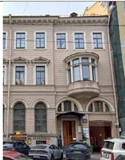
Эркер, полуциркульный в плане, в западной, западающей части фасада, в уровне второго этажа, с лепной композицией в основании, в виде многолепестковой полурозетки с бусами с фиалом из акантовых листьев в центре, увенчанный профилированным выносным карнизом; декорирован гладкими пилястрами на постаментах в межоконных простенках; профилированный межоконный карниз эркера, разделяющий оконные проемы на две части;
