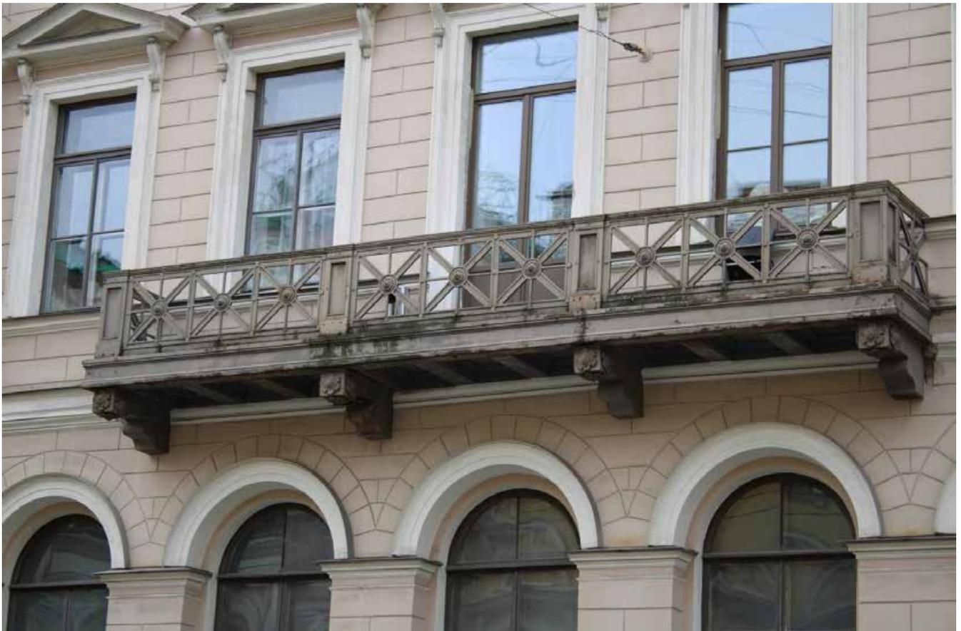
Фото 16. Прямоугольный в плане балкон в уровне 2-го этажа, на три световых оси, расположенный в центральной части выступающей плоскости фасада, на четырех чугунных кронштейнах. Общий вид. Дата фотофиксации: 09.10.25
