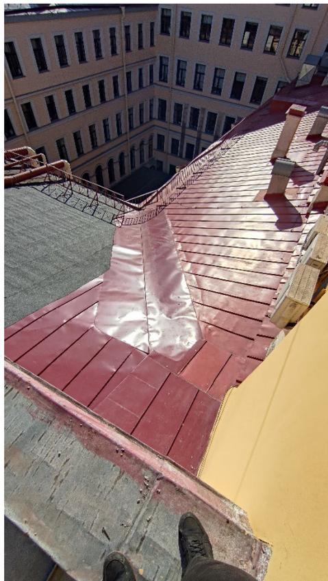
Фото 44. Угловой стык кровли. Фрагмент. Дата фотофиксации: 09.10.25
