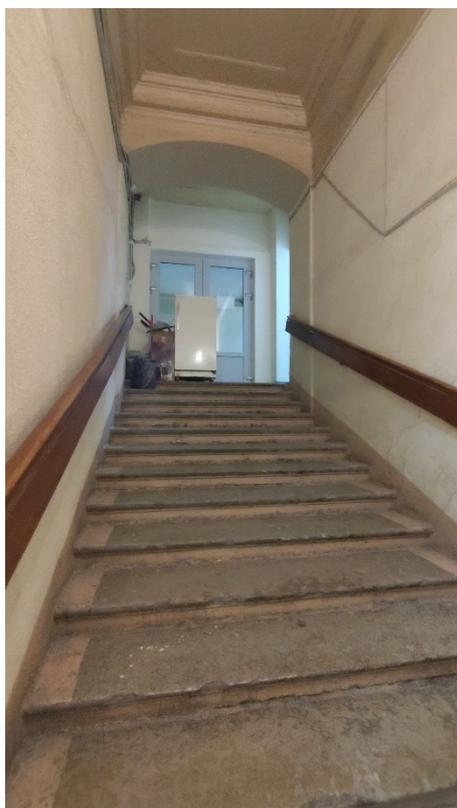
Фото 212. Средистенная лестница между верхним уровнем вестибюля и площадкой первого этажа парадной лестницы, со ступенями лещадной плиты и петлями ковродержателя. Общий вид со стороны объёма вестибюля. Дата фотофиксации: 26.06.25
