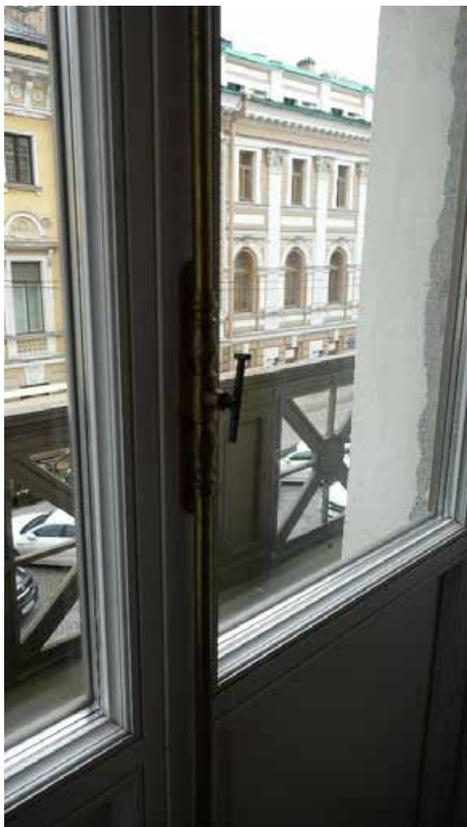
Фото 187. Поворотный шпингалет на дверном заполнении балкона в помещении 5 (51-Н). Фрагмент.
