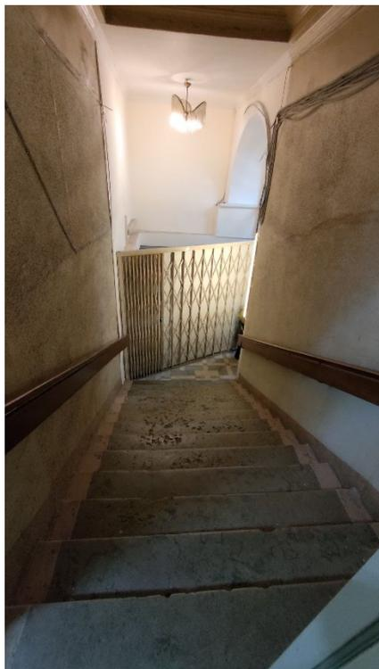
Фото 211. Средистенная лестница между верхним уровнем вестибюля и площадкой первого этажа парадной лестницы, со ступенями лещадной плиты и петлями ковродержателя. Общий вид с площадки 1-го этажа и антресоли 1-го этажа. Дата фотофиксации: 26.06.25
