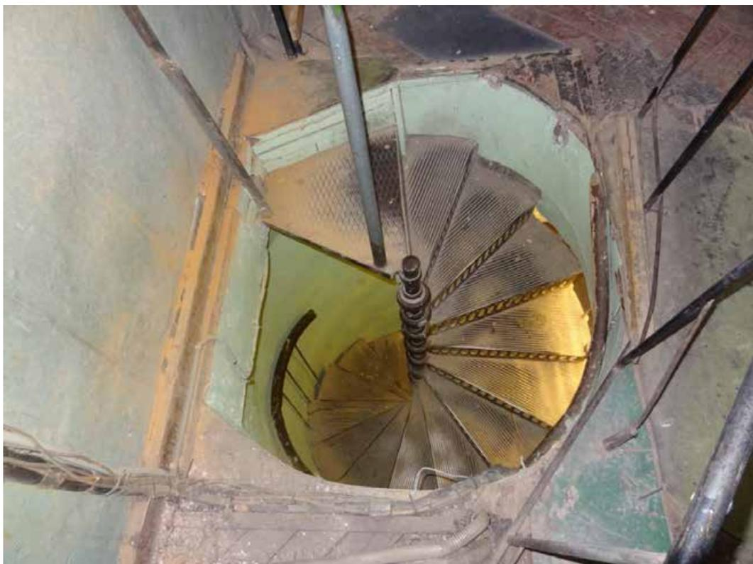
Фото 234. Металлическая винтовая лестница, расположенная в восточной части лицевого корпуса в уровне цокольного – 1-го этажей. Общий вид в уровне 1-го этажа. Дата фотофиксации: 26.06.25
