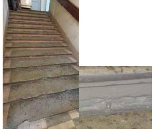
главная лестница, в центральной части здания, в уровне 1-3-го этажей, трехмаршевая, с коротким маршем, соединяющим уровни межэтажной площадки, площадки 1-3-го этажей на цилиндрических сводах, ступени лещадной плиты (проступь с валиком) – габариты, местоположение;
