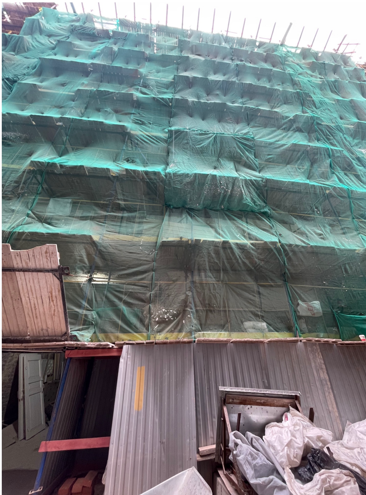
1. Фрагмент дворового фасада.
