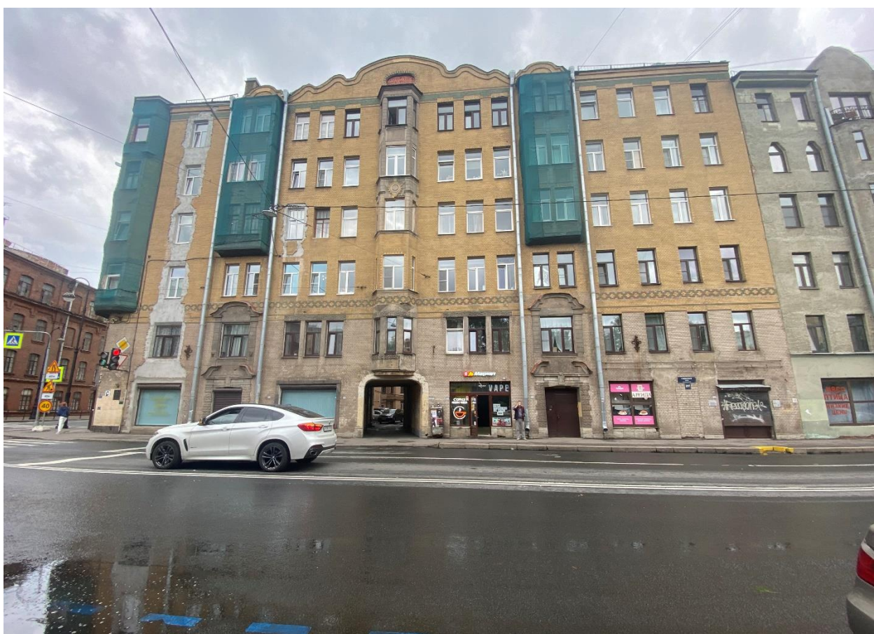
Фото 2. Лицевой фасад исследуемого объекта по Гаванской улице.
