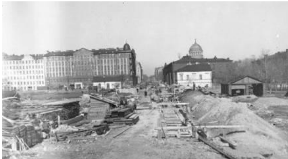
Илл. 41. Сооружение канализации на Васильевском острове. Вид траншеи для коллектора (фрагмент фото). 1925 г. Электронный портал pastvu.com .
