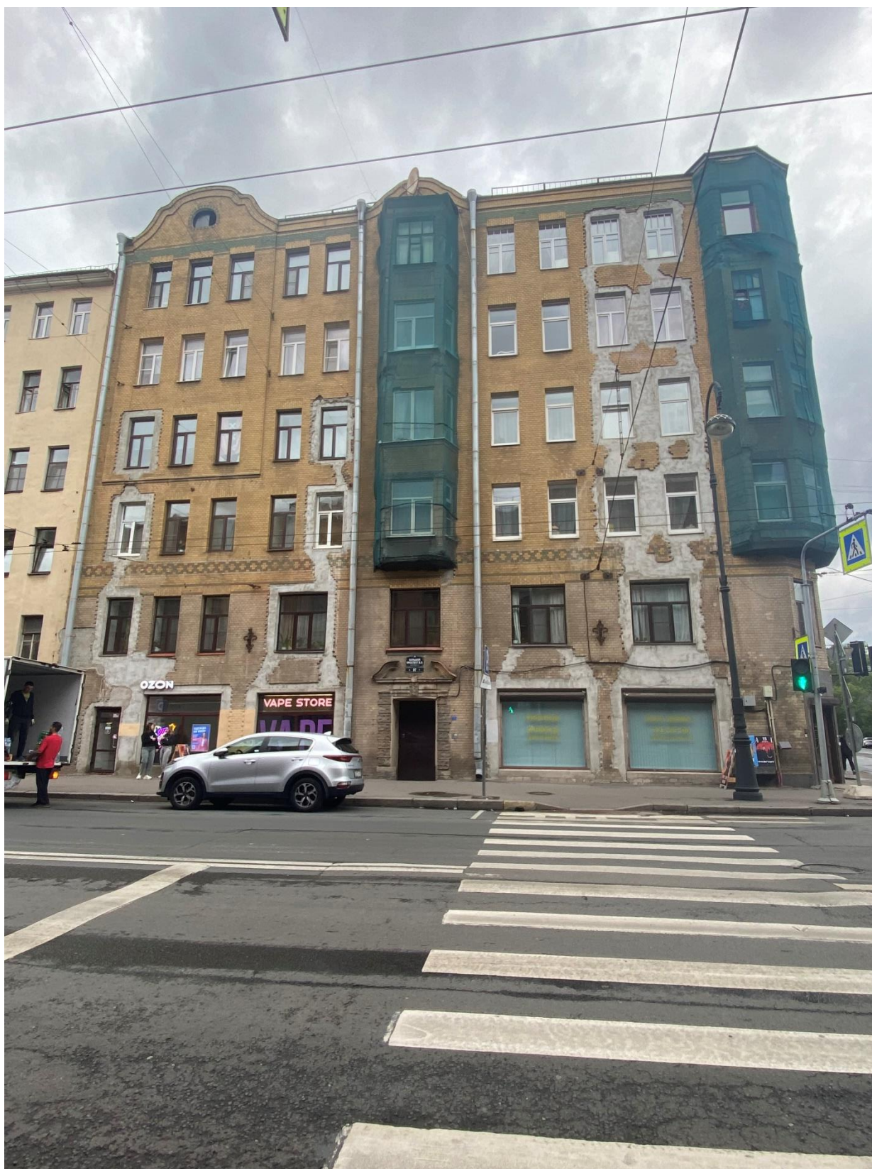
Фото 3. Лицевой фасад исследуемого объекта по Большому пр. В.О.
