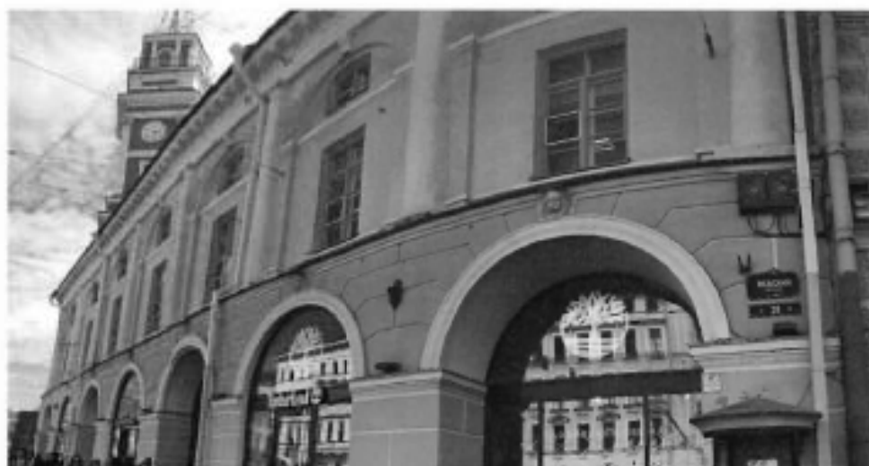
1. Лицевой фасад. Общий вид.
