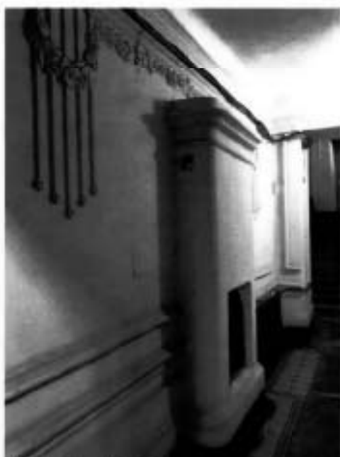
16. Помещение Л-1 объекта культурного наследия. Фото выполнено 22.03.2024.
