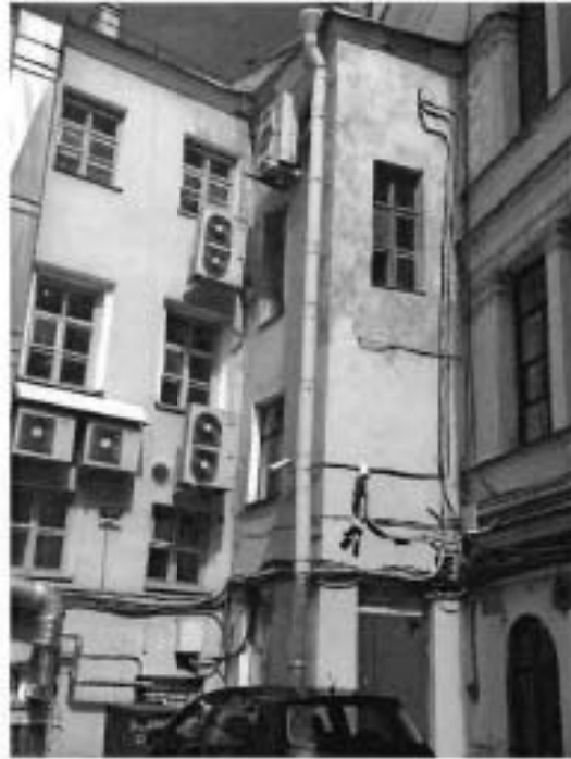
3. Дворовый фасад. Фрагмент.
