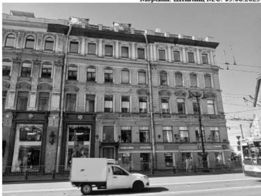
2. «Дом А.И. Трейберга» (Невский пр., д. 11/2, лит. А). Лицевой фасад по Невскому пр. (фрагмент). Фото мест установки оборудования и прокладки кабельных трасс. Штиглиц М.С. 05.08.2025.
