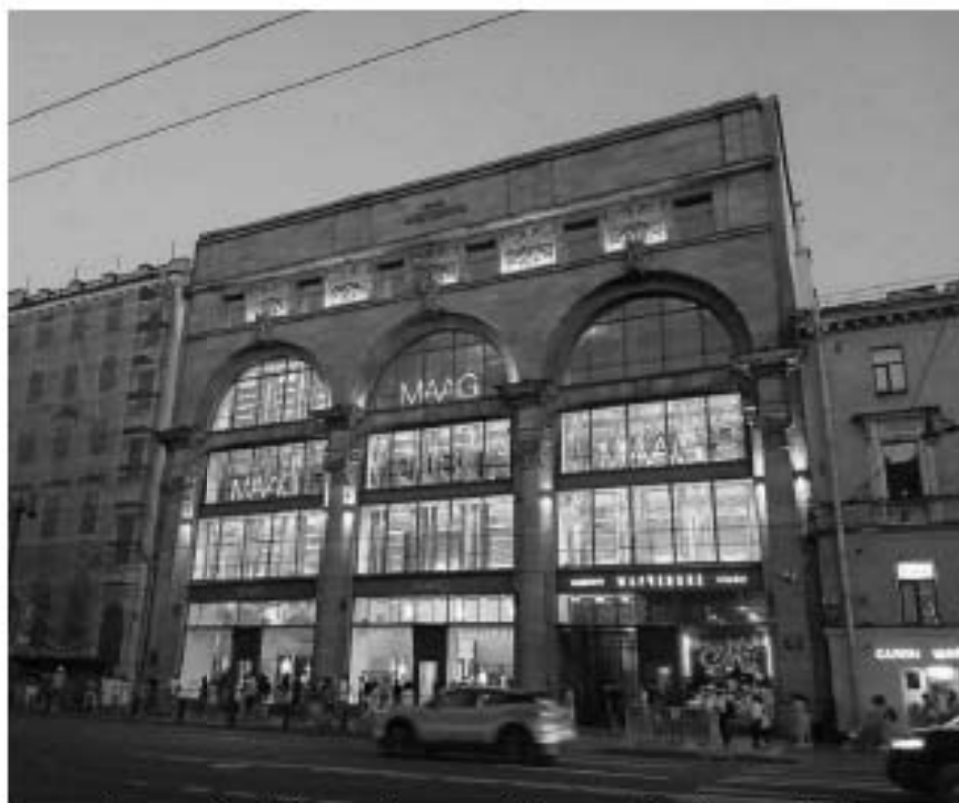
7. «Бывший дом Мертенса (фасады)» (Невский пр., д. 21, лит. А). Лицевой фасад по Невскому пр. Штиглиц М.С. 05.08.2025.
