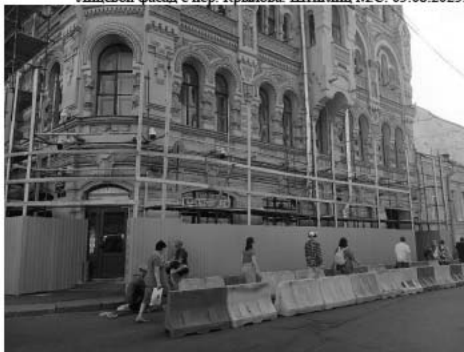
40. «Собственный дом архитектора Н.П. Басина» (пер. Крылова, д. 7/5, лит. А). Лицевой фасад с пер. Крылова (фрагмент). Фото мест установки оборудования и прокладки кабельных трасс. Штиглиц М.С. 05.08.2025.
