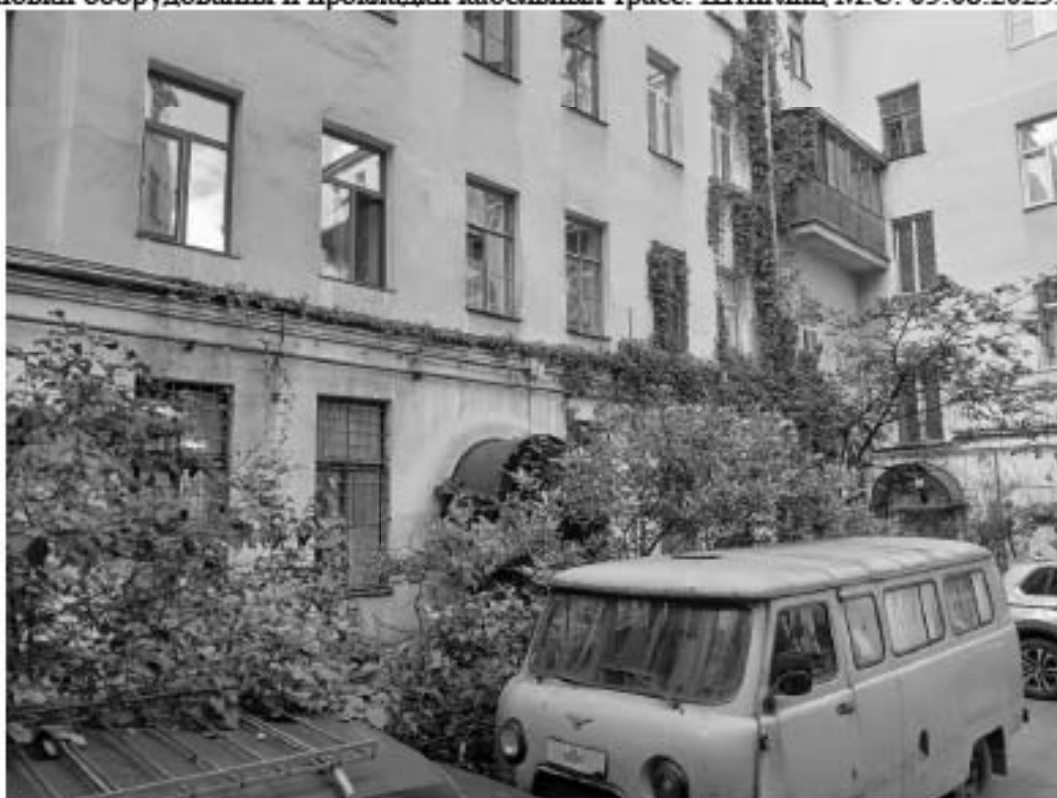
50. «Дом Яковлевых» (ул. Маяковского, д. 1/96, лит. А). Дворовые фасады. Фото мест установки оборудования и прокладки кабельных трасс. Штиглиц М.С. 05.08.2025.
