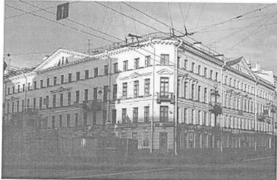
Фото 1. Лицевой фасад здания.
