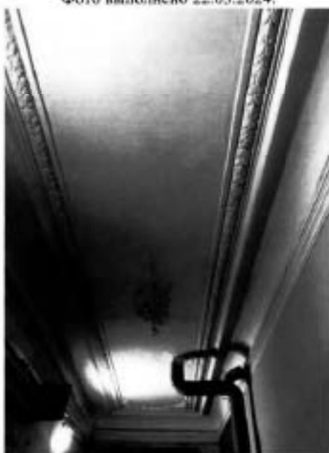
20. Помещение Л-5 объекта культурного наследия. Фото выполнено 22.03.2024.
