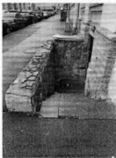
11. Приемок по западному лицевому фасаду (17.11.2021).
