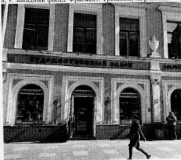
8, 9. Западный фасад. Фрагмент. Трещины, загрязнение окрасочного слоя.
