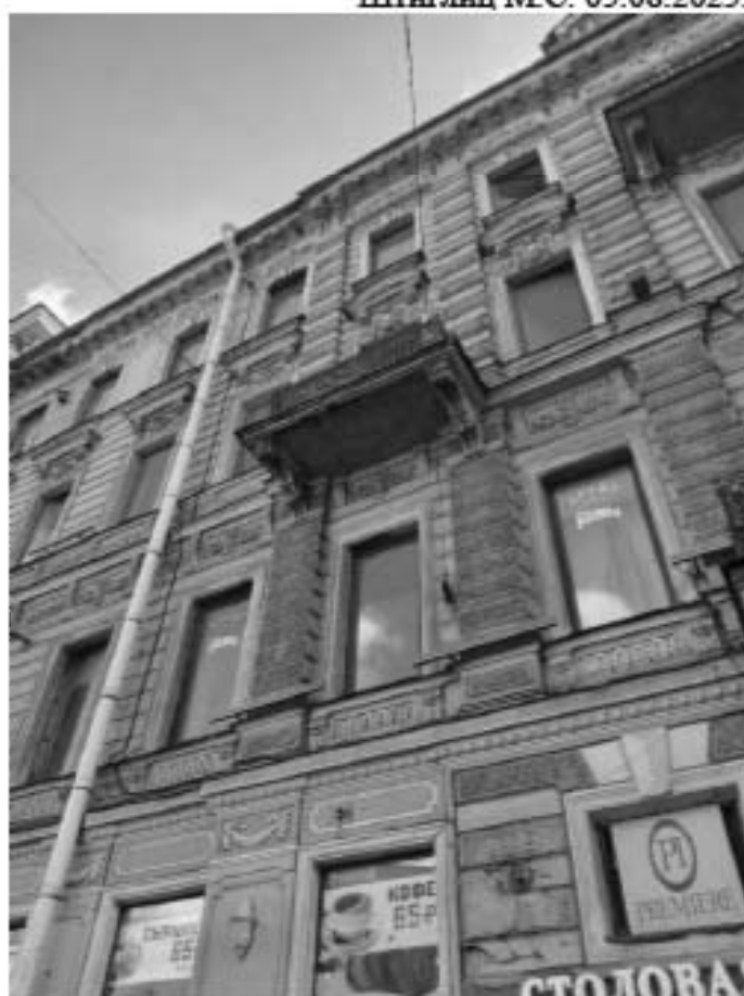
10. «Дом А.Г. Чадаева» (Невский пр., д. 53, лит. А). Лицевой фасад по Невскому пр. (фрагмент). Фото мест установки оборудования и прокладки кабельных трасс. Штиглиц М.С. 05.08.2025.
