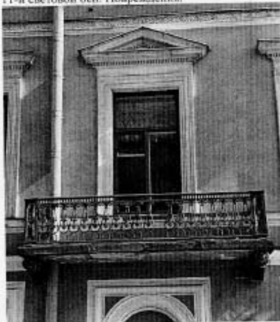
8, 9. Западный фасад. Фрагмент. Трещины, загрязнение окрасочного слоя.
