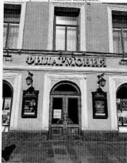
11. Южный лицевой фасад. Фрагмент. Фасад окрашен разными колерами.
