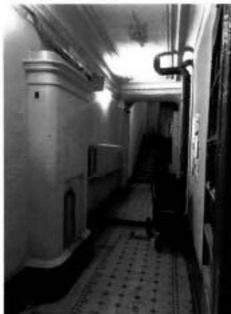
19. Помещение Л-5 объекта культурного наследия. наследия
