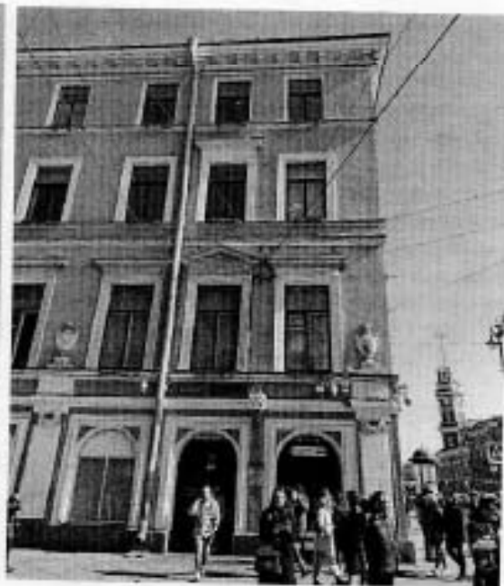
5. Западный фасад. Фрагмент.
