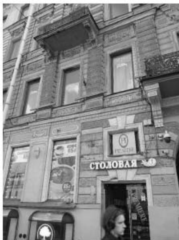
11. «Дом А.Г. Чадаева» (Невский пр., д. 53, лит. А). Лицевой фасад по Невскому пр. (фрагмент). Фото мест установки оборудования и прокладки кабельных трасс. Штиглиц М.С. 05.08.2025.
