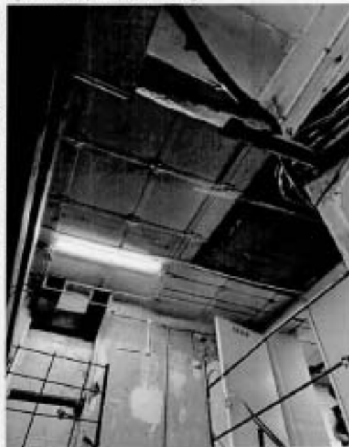
31. Отделка потолка стальными листами (пом. 8-Н, ч.п. 9, 1 этаж).
