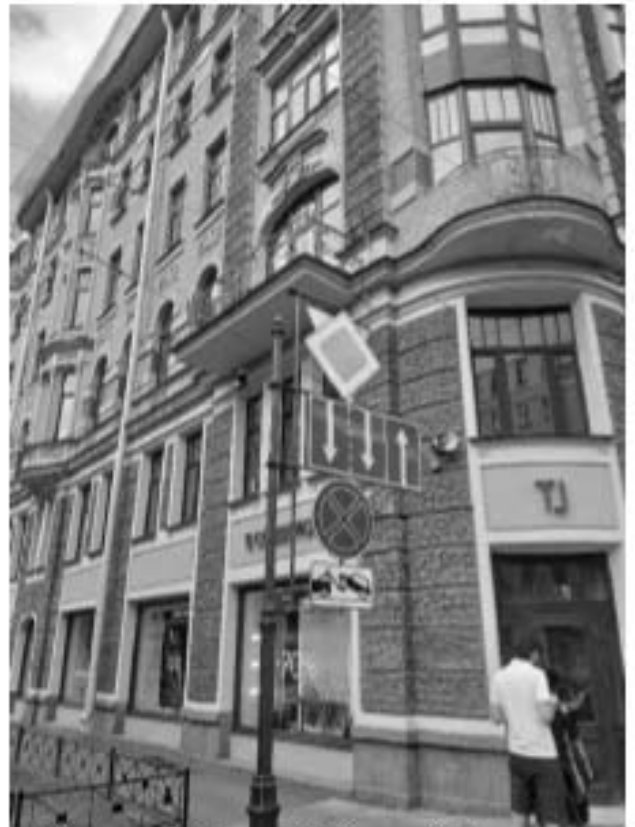
27. «Дом И.И. Круглова». Невский пр., д. 147, лит. А. Лицевой фасад по ул. профессора Ивашенцова (фрагмент). Фото мест установки оборудования и прокладки кабельных трасс. Штиглиц М.С. 05.08.2025.
