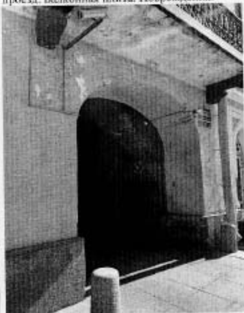
8, 9. Западный фасад. Фрагмент. Трещины, загрязнение окрасочного слоя.
