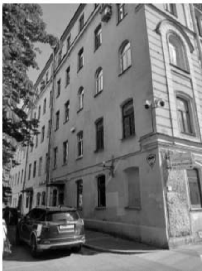
43. «Дом Яковлевых» (ул. Маяковского, д. 1/96, лит. А). Лицевой фасад по ул. Маяковского. (фрагмент). Фото мест установки оборудования и прокладки кабельных трасс. Штиглиц М.С. 05.08.2025.
