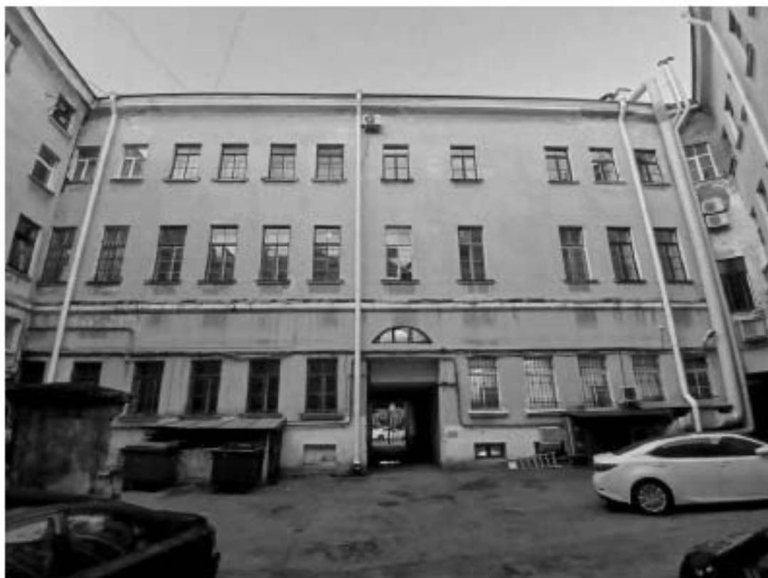
35. «Дом Антонова («Дом Аламини»)» (наб. реки Мойки, д. 1/8, лит. А). Дворовые фасады. Фото мест установки оборудования и прокладки кабельных трасс. Штиглиц М.С. 05.08.2025.
