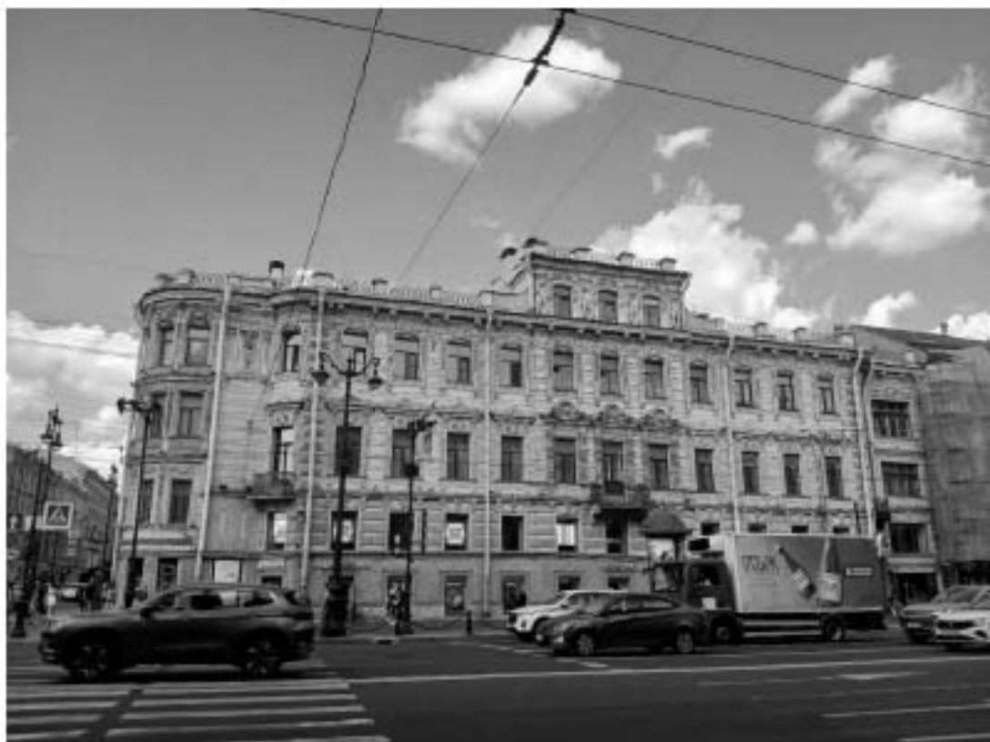
41. «Дом Яковлевых» (ул. Маяковского, д. 1/96, лит. А). Лицевой фасад по Невскому пр. Штиглиц М.С. 05.08.2025.
