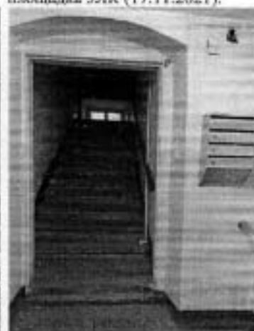
72. Промежуточная площадка 3ЛК (17.11.2021).
