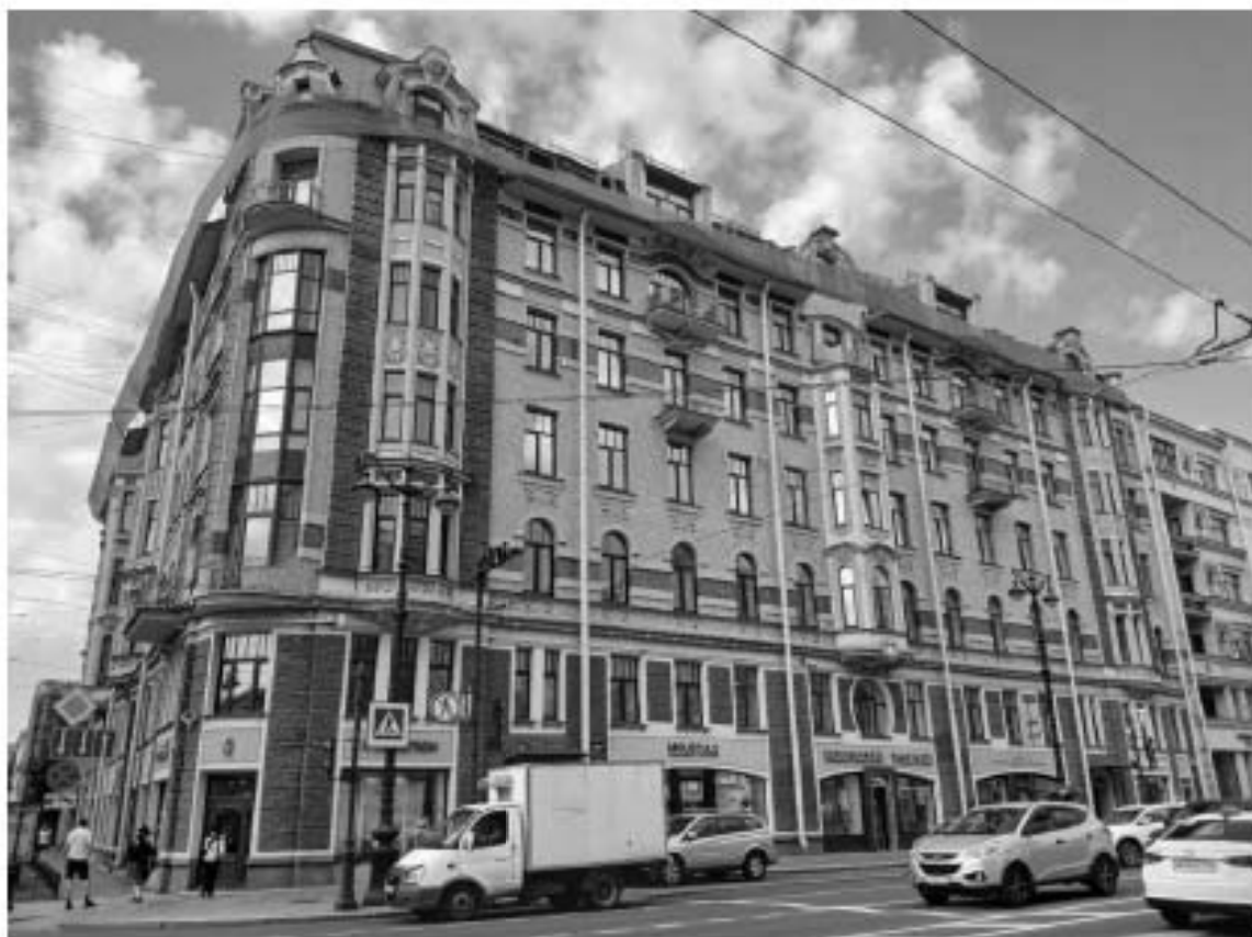
25. «Дом И.И. Круглова». Невский пр., д. 147, лит. А. Лицевой фасад по Невскому пр. Штиглиц М.С. 05.08.2025.
