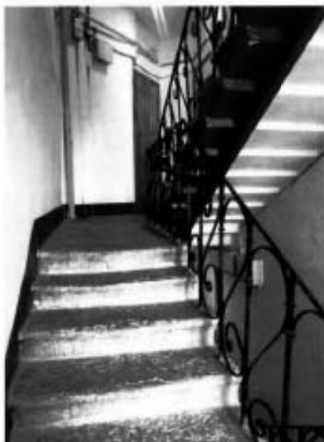
18. Помещение Л-4 объекта культурного наследия. Фото выполнено 22.03.2024.
