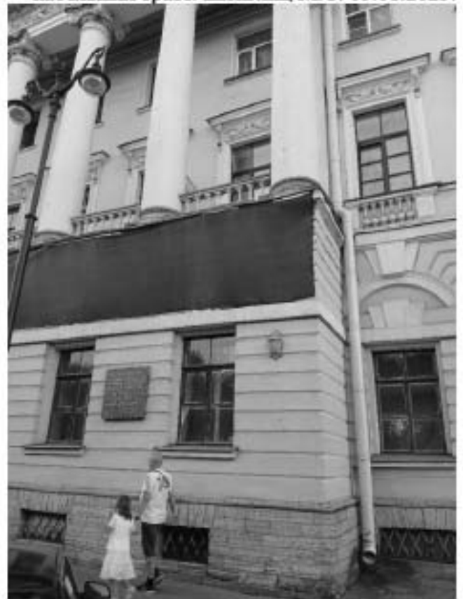
34. «Дом Антонова («Дом Адамини»)» (наб. реки Мойки, д. 1/8, лит. А). Лицевой фасад Марсово поле. (фрагмент). Фото мест установки оборудования и прокладки кабельных трасс. Штиглиц М.С. 05.08.2025.
