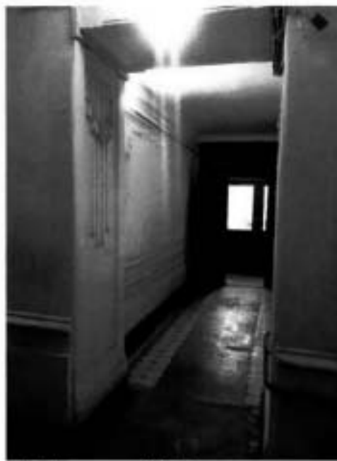
15. Помещение Л-1 объекта культурного наследия. Фото выполнено 22.03.2024.
