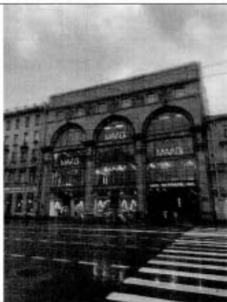
1. Лицевой фасад общий вид
