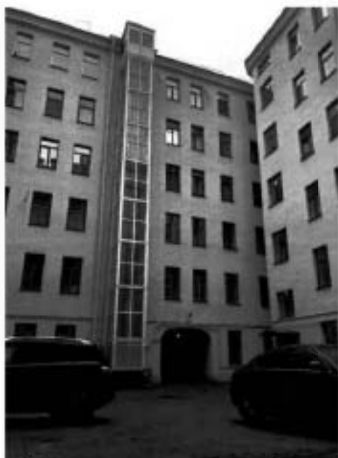
6. Фрагмент северо-восточного фасада и части территории южного двора объекта культурного наследия. Фото выполнено 22.03.2024.
