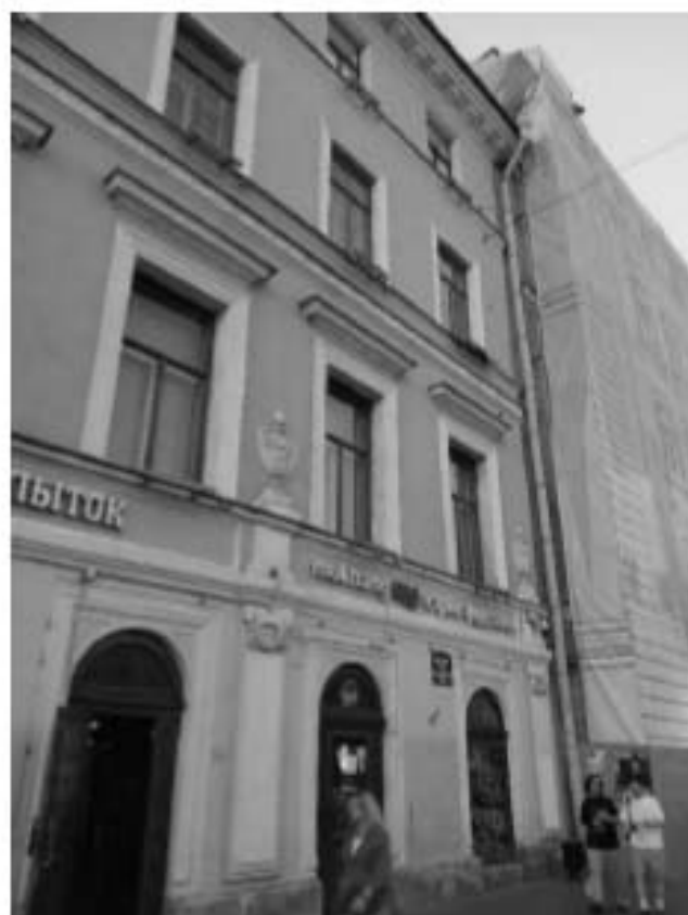
23. «Дом Энгельгардта В.В. (Санкт-Петербургский учетный и ссудный банк)». Невский пр., д. 30, лит. А. Лицевой фасад по Невскому пр. (фрагмент). Фото мест установки оборудования и прокладки кабельных трасс. Штиглиц М.С. 05.08.2025.
