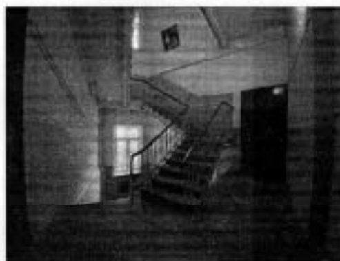
67-68. Лестничная клетка 2ЛК (17.11.2021).
