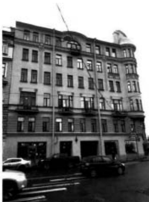
2. Северо-восточный фасад объекта культурного наследия. Фото выполнено 22.03.2024
