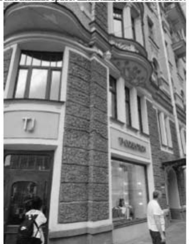
28. «Дом И.И. Круглова». Невский пр., д. 147, лит. А. Лицевой фасад по Невскому пр. (фрагмент). Фото мест установки оборудования и прокладки кабельных трасс. Штиглиц М.С. 05.08.2025.
