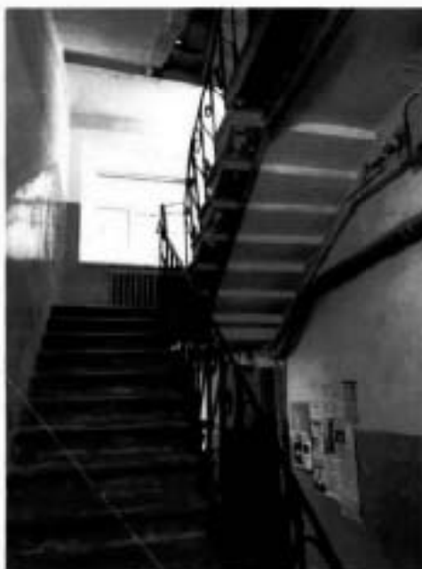
24. Помещение Л-7 объекта культурного наследия. Фото выполнено 22.03.2024.
