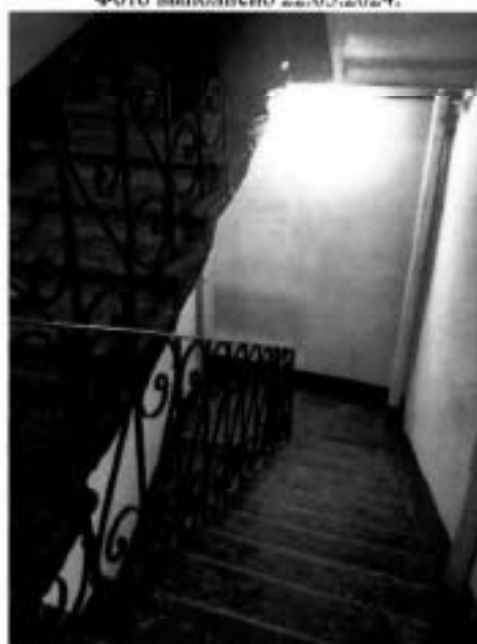
17. Помещение Л-3 объекта культурного наследия. Фото выполнено 22.03.2024.
