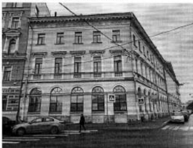
10. Западный лицевой фасад по Аптекарскому переулку (17.11.2021).
