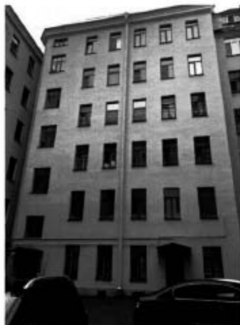
7. Фрагмент северо-восточного фасада и части территории южного двора объекта культурного наследия. Фото выполнено 22.03.2024.
