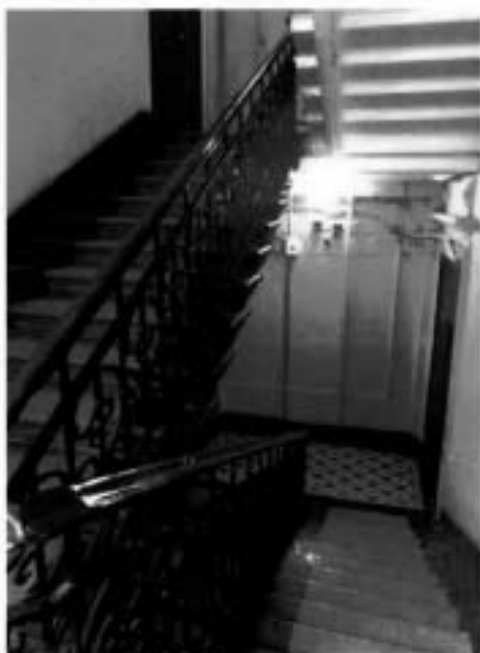
14. Помещение Л-2 объекта культурного наследия. Фото выполнено 22.03.2024.
