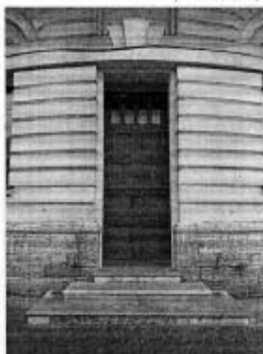
13. Вход в пом. 46-Н со стороны южного лицевого фасада (17.11.2021).
