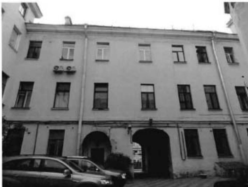
5. Дворовый фасад корпуса по набережной реки Мойки.
