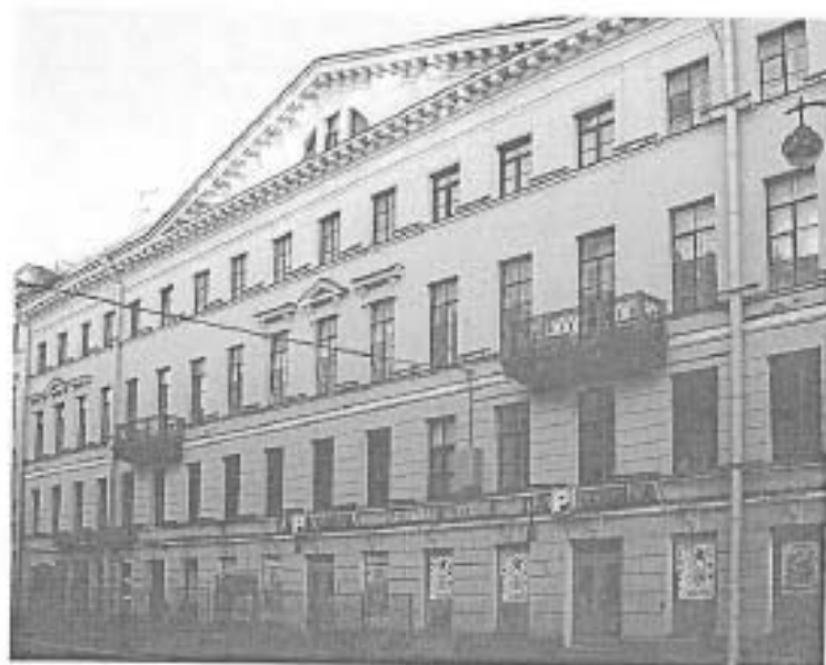
Фото 2. Лицевой фасад здания.
