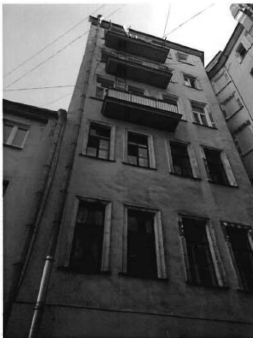
4. Дворовый фасад. Фрагмент.
