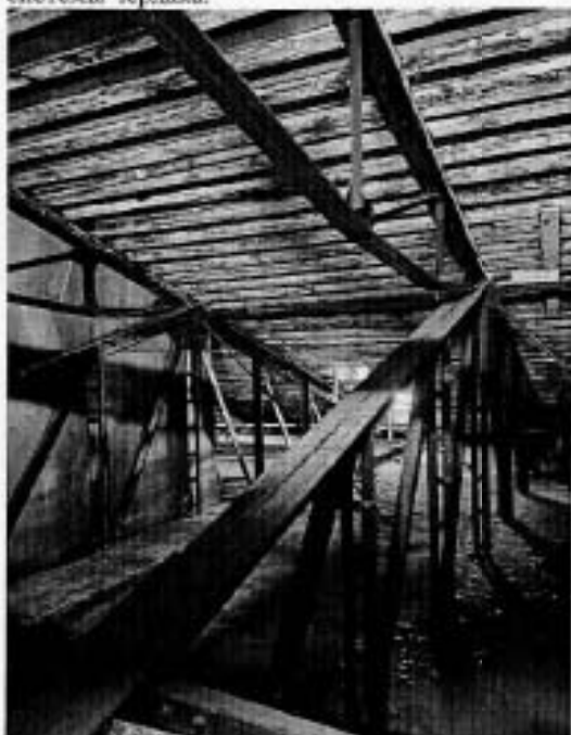
58. Металлические балки стропильной системы чердака.
