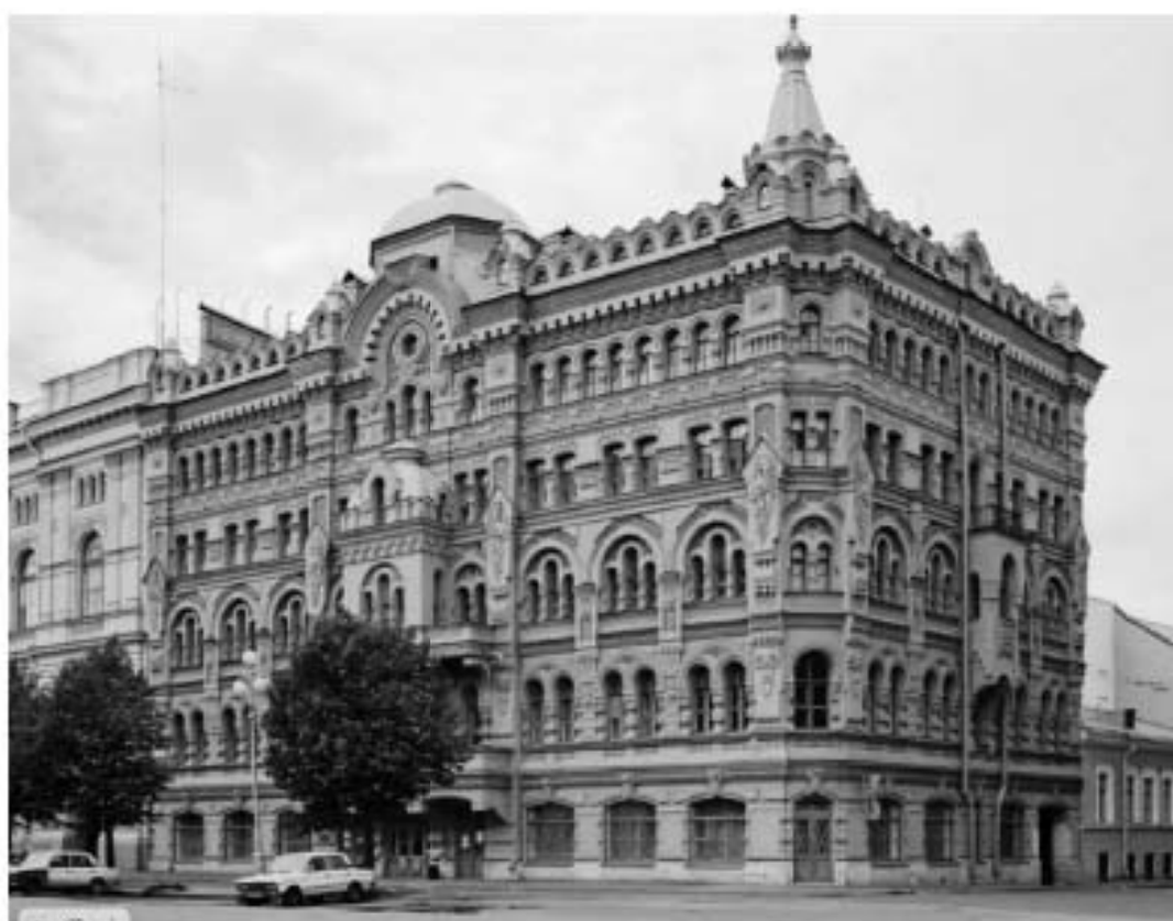
15. «Собственный дом архитектора Н.П. Басина» (пер. Крылова, д. 7/5, лит. А). 1996. pastvu.com .
