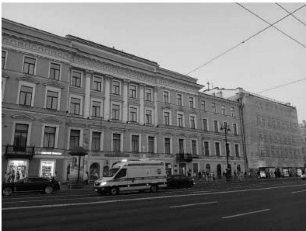
21. «Дом Энгельгардта В.В. (Санкт-Петербургский учетный и ссудный банк)». Невский пр., д. 30, лит. А. Лицевой фасад по Невскому пр. (фрагмент). Фото мест установки оборудования и прокладки кабельных трасс. Штиглиц М.С. 05.08.2025.
