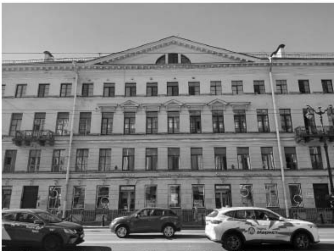
17. «Дом Чаплиных» (Невский пр., д. 13/9, лит. А). Лицевой фасад по Невскому пр. (фрагмент). Фото мест установки оборудования и прокладки кабельных трасс. Штиглиц М.С. 05.08.2025.
