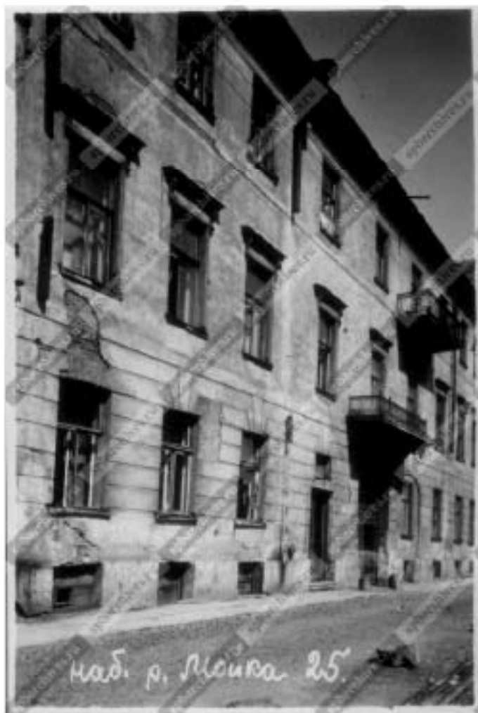
28. «Особняк А.И. Эбелинг» (Мойки наб. реки, д. 25, лит. А). 1960 г. Вид фасада дома № 25 на наб. реки Мойки. ЦГАКФФД СПб Гр 75520.
