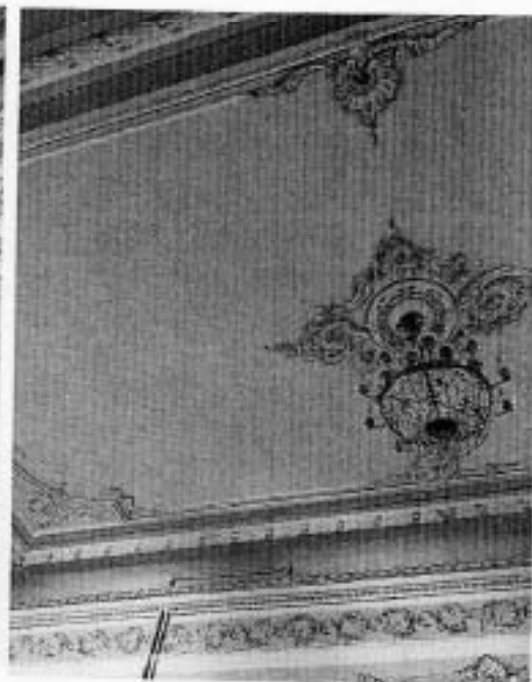
28, 29. Светло-бежевое фойе перед Концертным залом (пом. 3-Н, ч.п. 20, 2 этаж). Повреждение окрасочного слоя (трещина).
