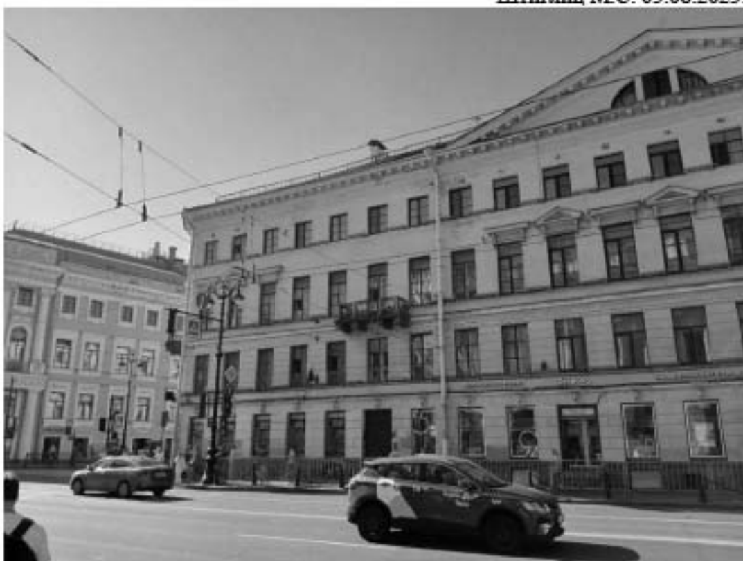
18. «Дом Чаплиных» (Невский пр., д. 13/9, лит. А). Лицевой фасад по Невскому пр. (фрагмент). Фото мест установки оборудования и прокладки кабельных трасс. Штиглиц М.С. 05.08.2025.
