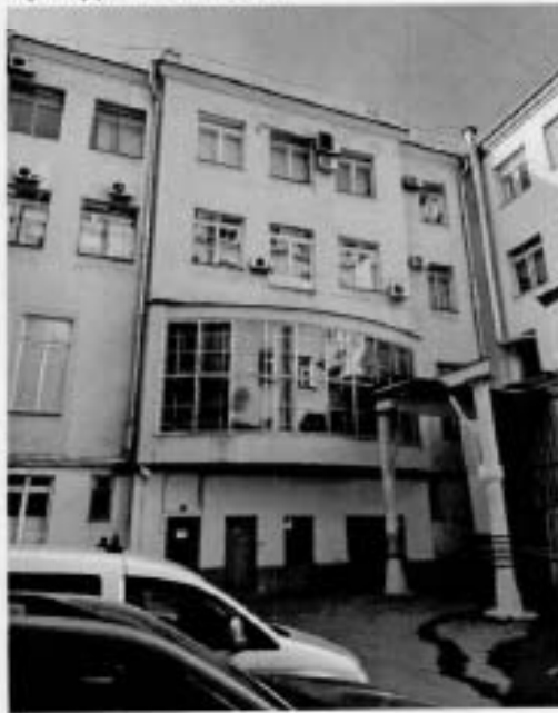
9. Северный дворной фасад объекта культурного наследия.
