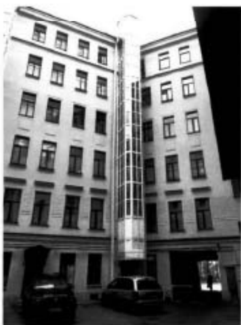
8. Северо-восточный и северо-западный фасад северного двора объекта культурного наследия. Фото выполнено 22.03.2024.
