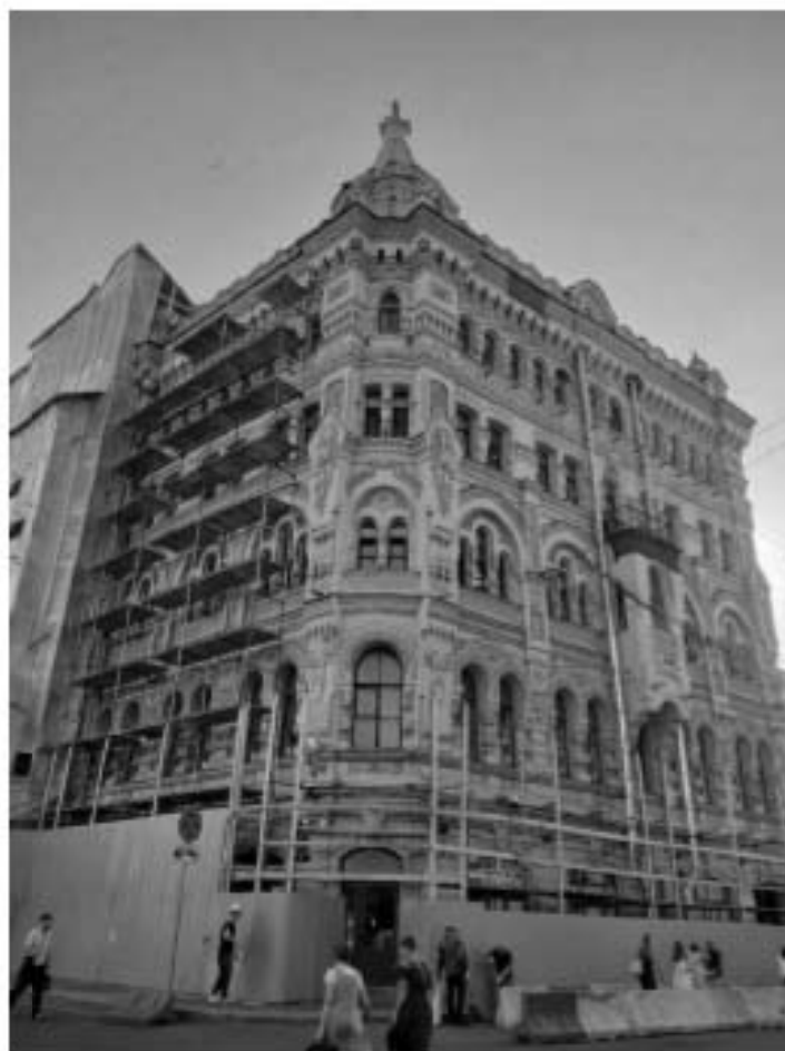
39. «Собственный дом архитектора Н.П. Басина» (пер. Крылова, д. 7/5, лит. А). Лицевой фасад с пер. Крылова. Штиглиц М.С. 05.08.2025.
