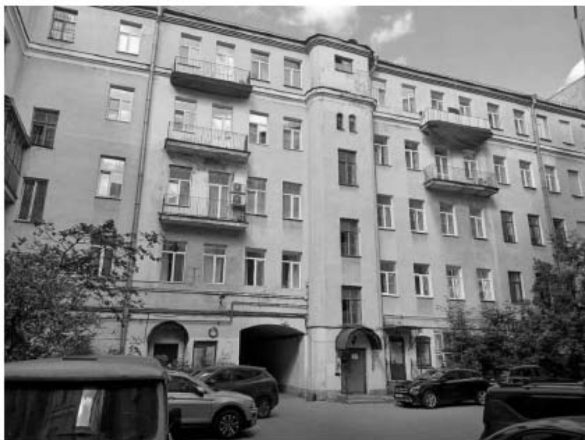
51. «Дом Яковлевых» (ул. Маяковского, д. 1/96, лит. А). Дворовые фасады. Фото мест установки оборудования и прокладки кабельных трасс. Штиглиц М.С. 05.08.2025.
