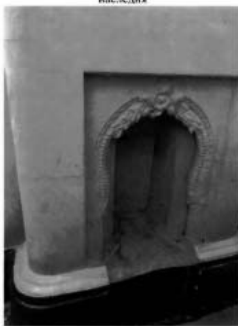
21. Помещение Л-5 объекта культурного наследия. Фото выполнено 22.03.2024.
