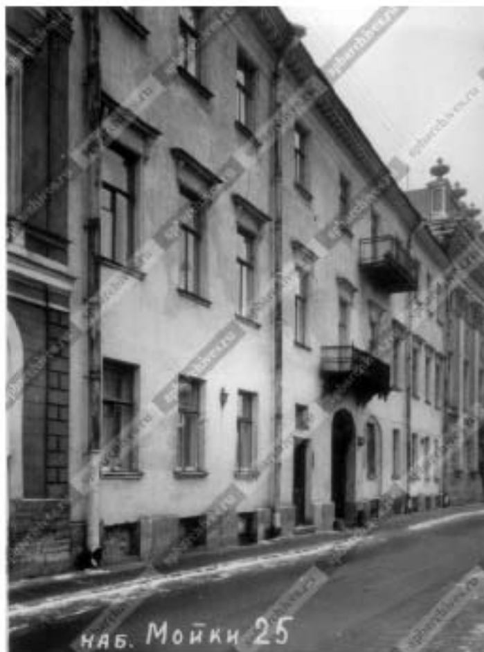
29. «Особняк А.И. Эбелинг» (Мойки наб. реки, д. 25, лит. А). 1960 г. Вид фасада дома № 25 на наб. реки Мойки. ЦГАКФФД СПб Гр 75519.
