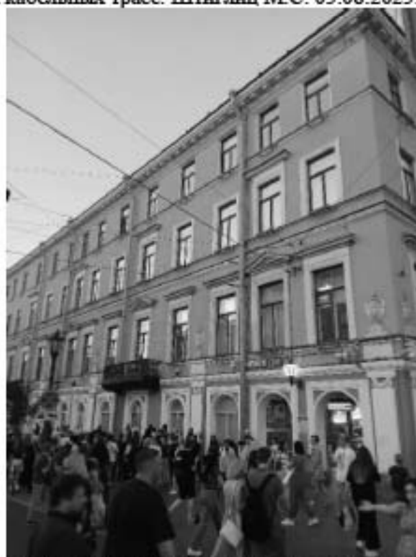
24. «Дом Энгельгардта В.В. (Санкт-Петербургский учетный и ссудный банк)». Невский пр., д. 30, лит. А. Лицевой фасад по наб. канала Грибоедова (фрагмент). Фото мест установки оборудования и прокладки кабельных трасс. Штиглиц М.С. 05.08.2025.
