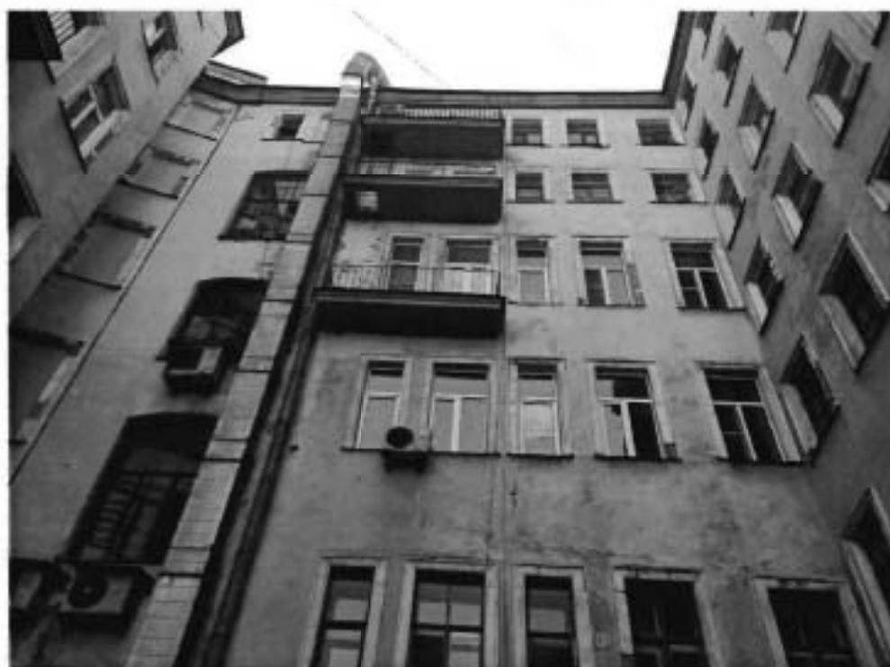
3. Дворовый фасад. Фрагмент.
