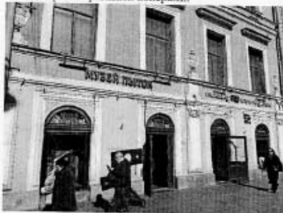
12. Южный лицевой фасад. Фрагмент. Фасад окрашен разными колерами.
