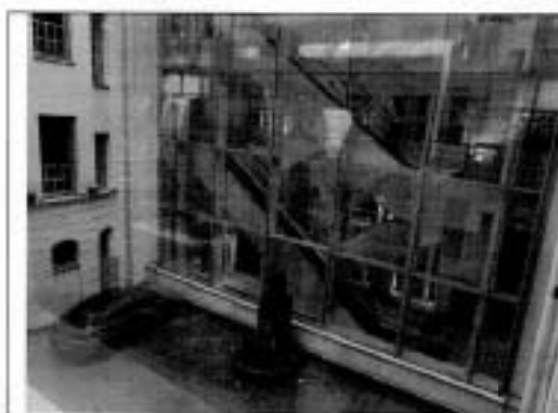
5. Фрагмент дворового фасада с фонтаном
