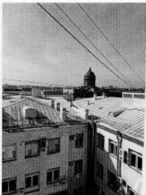
59. Кровля лицевых корпусов.
