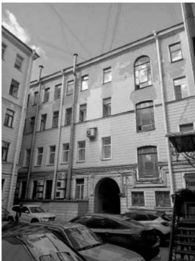
13. «Дом А.Г. Чадаева» (Невский пр., д. 53, лит. А). Дворовые фасады. Фото мест установки оборудования и прокладки кабельных трасс. Штиглиц М.С. 05.08.2025.
