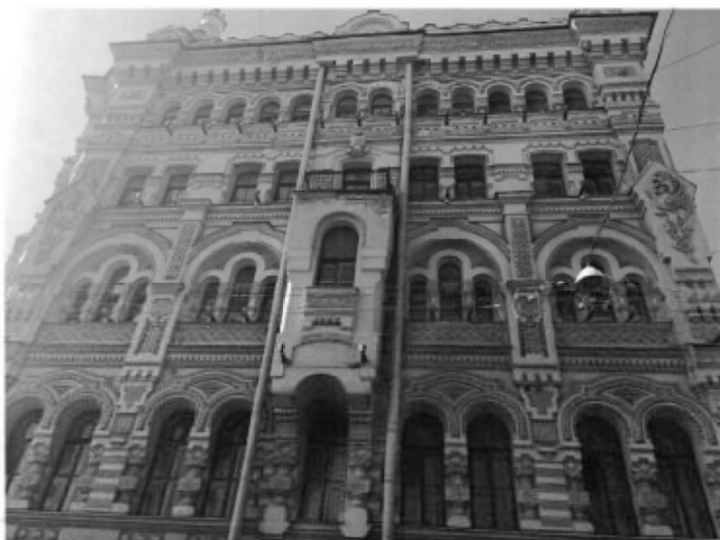
1. Лицевой фасад. Общий вид.
