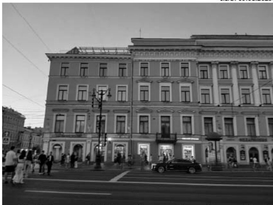
20. «Дом Энгельгардта В.В. (Санкт-Петербургский учетный и ссудный банк)». Невский пр., д. 30, лит. А. Лицевой фасад по Невскому пр. (фрагмент). Фото мест установки оборудования и прокладки кабельных трасс. Штиглиц М.С. 05.08.2025.
