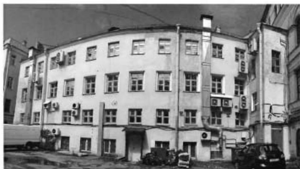
2. Дворовый фасад. Общий вид.
