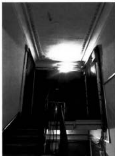
23. Помещение Л-5 объекта культурного наследия. Фото выполнено 22.03.2024.
