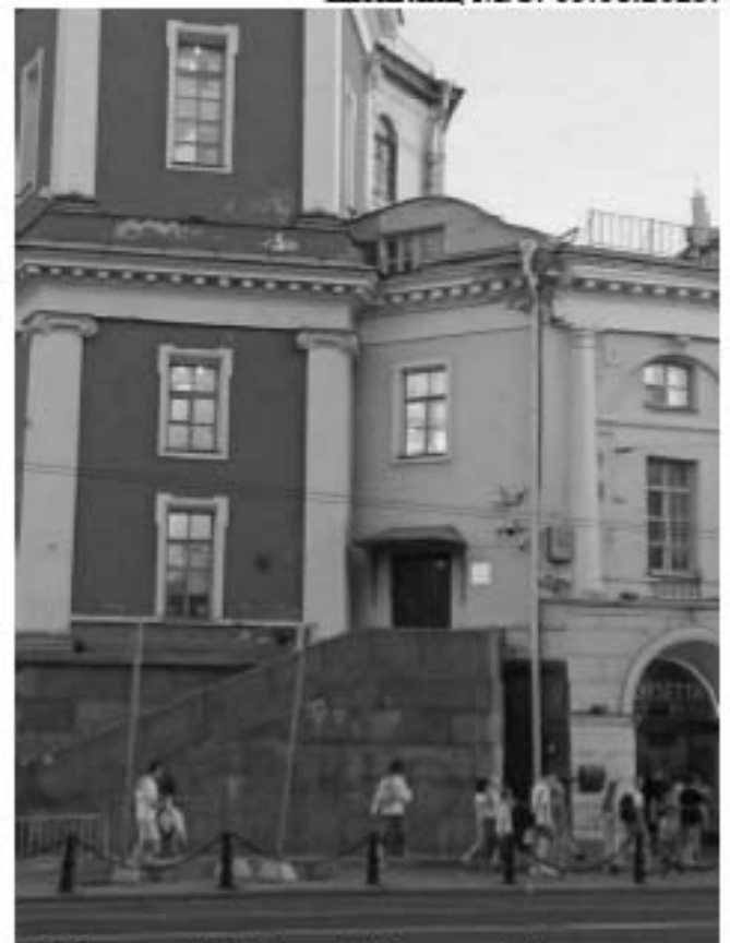
6. «Серебряные ряды» (Невский пр., д. 29-31, лит. А). Лицевой фасад по Невскому пр. Фото мест установки оборудования и прокладки кабельных трасс. Штиглиц М.С. 05.08.2025.
