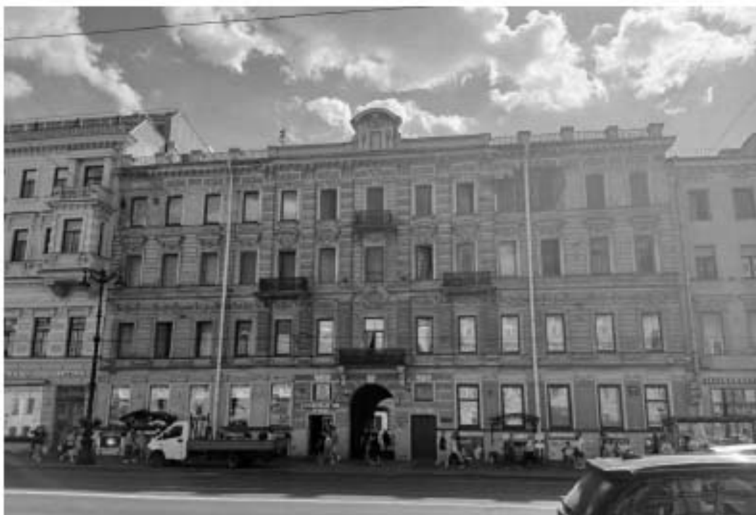
9. «Дом А.Г. Чадаева» (Невский пр., д. 53, лит. А). Лицевой фасад по Невскому пр. Штиглиц М.С. 05.08.2025.
