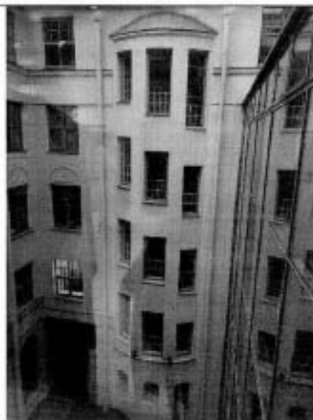
2. Фрагмент дворового фасада
