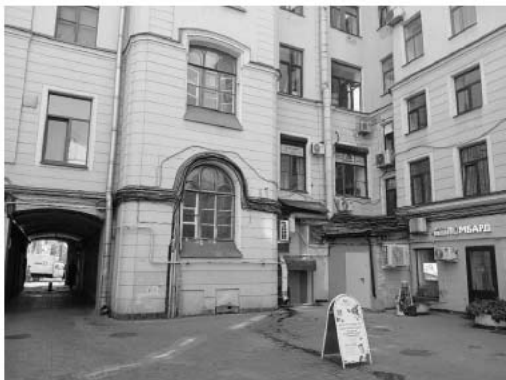
31. «Дом М.И. Лопатина (в составе «Дома товарищества «Григорий Бенингсон» (Доходный дом М.И. Лопатина. Здание панорамы «Голгофа» - бывший кинотеатр «Коллизей»)). Невский пр., д. 100, лит. А. Арочный проезд. Фото мест установки оборудования и прокладки кабельных трасс. Штиглиц М.С. 05.08.2025.
