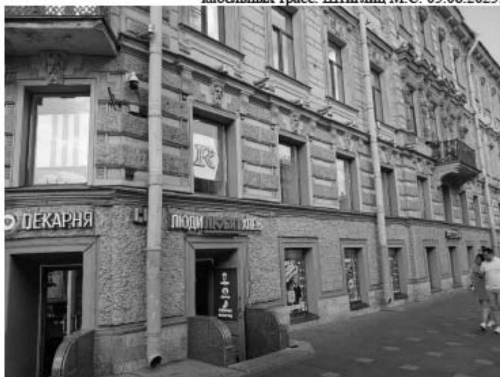
44. «Дом Яковлевых» (ул. Маяковского, д. 1/96, лит. А). Лицевой фасад по Невскому пр. (фрагмент). Фото мест установки оборудования и прокладки кабельных трасс. Штиглиц М.С. 05.08.2025.
