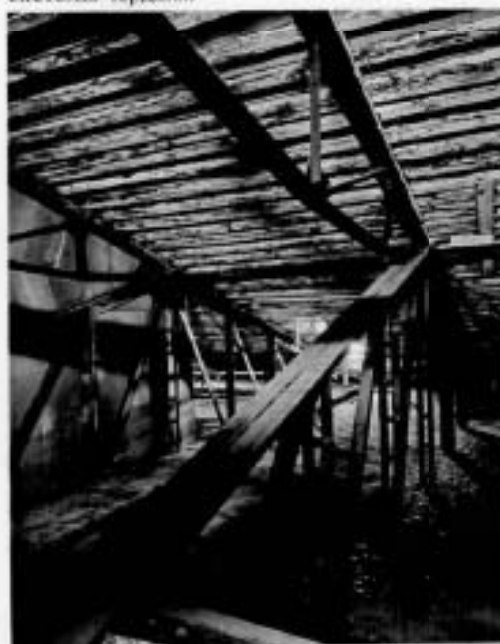
32. Металлические балки стропильной системы чердака.
