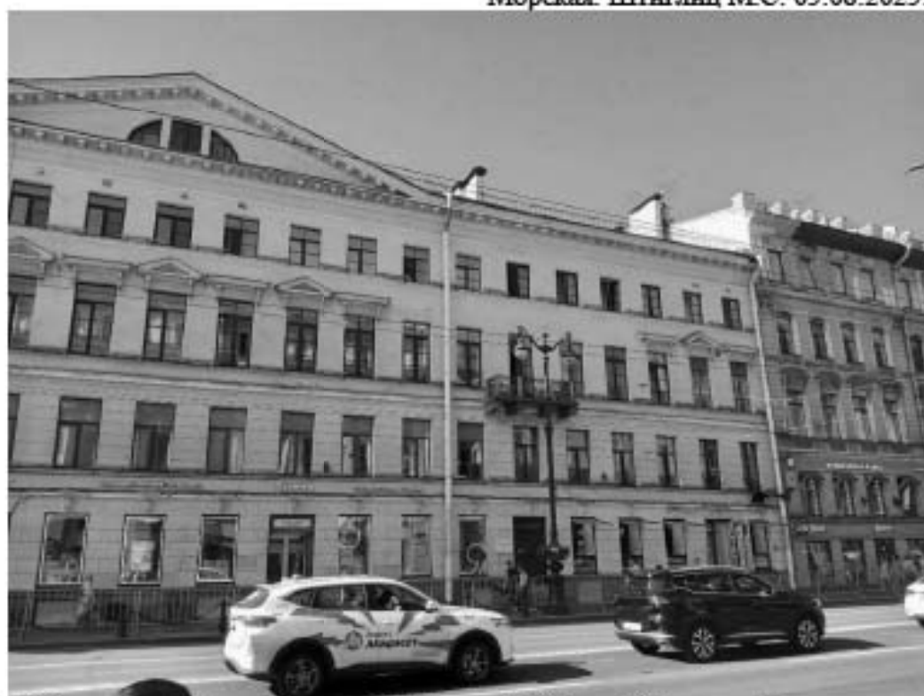
16. «Дом Чаплиных» (Невский пр., д. 13/9, лит. А). Лицевой фасад по Невскому пр. (фрагмент). Фото мест установки оборудования и прокладки кабельных трасс. Штиглиц М.С. 05.08.2025.
