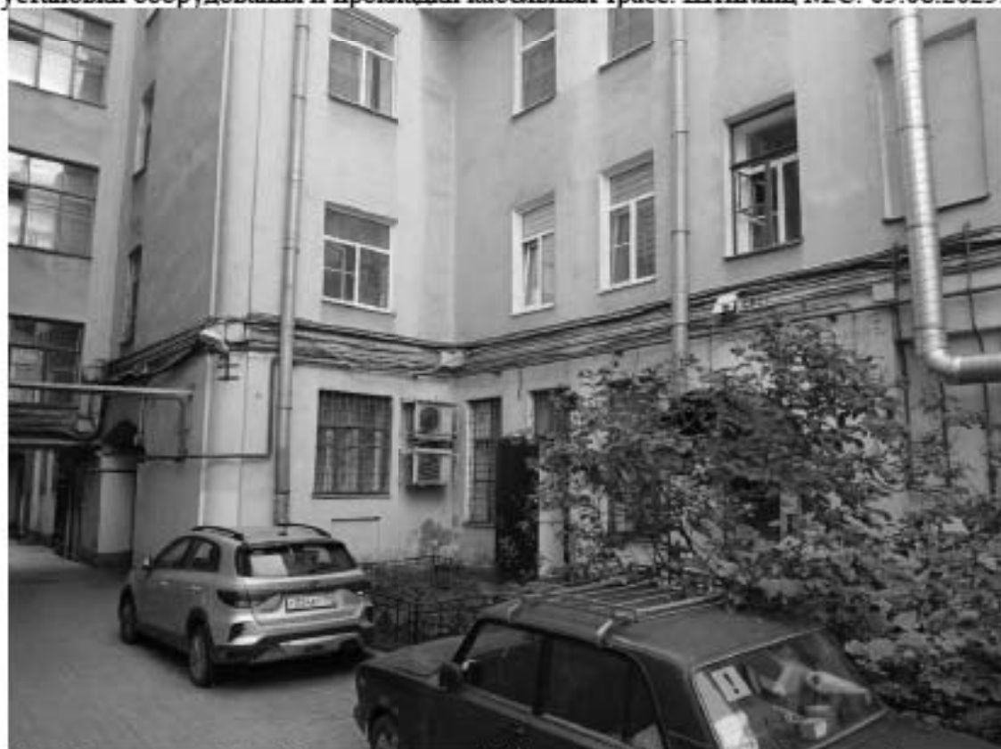
48. «Дом Яковлевых» (ул. Маяковского, д. 1/96, лит. А). Дворовые фасады. Фото мест установки оборудования и прокладки кабельных трасс. Штиглиц М.С. 05.08.2025.
