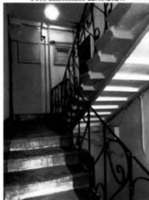
25. Помещение Л-8 объекта культурного наследия. Фото выполнено 22.03.2024.
