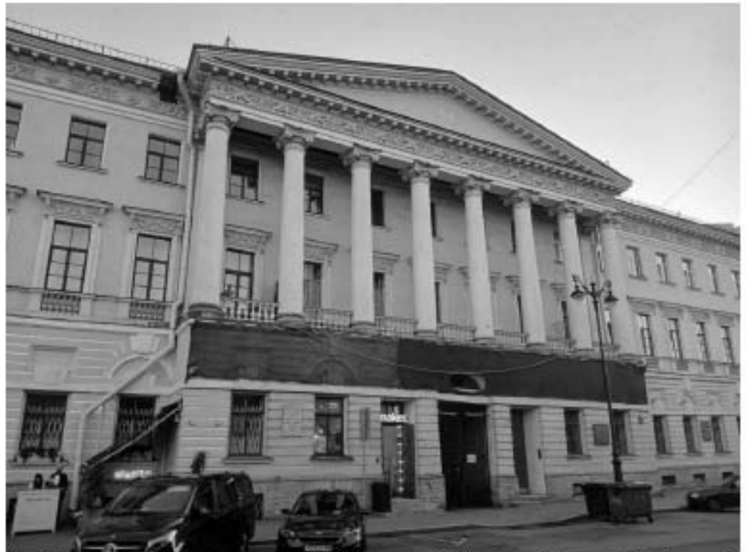
33. «Дом Антонова («Дом Адамини»)» (наб. реки Мойки, д. 1/8, лит. А). Лицевой фасад Марсово поле. (фрагмент). Фото мест установки оборудования и прокладки кабельных трасс. Штиглиц М.С. 05.08.2025.
