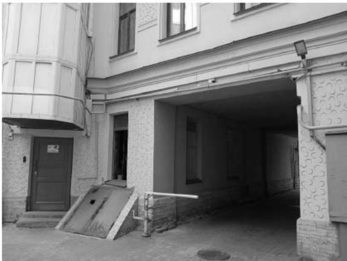
55. «Дом, где в 1907 г. жил Бонч-Бруевич В.Д.» (Херсонская ул., д. 1/7, лит. Арочный проезд. Фото мест установки оборудования и прокладки кабельных трасс. Штиглиц М.С. 05.08.2025.
