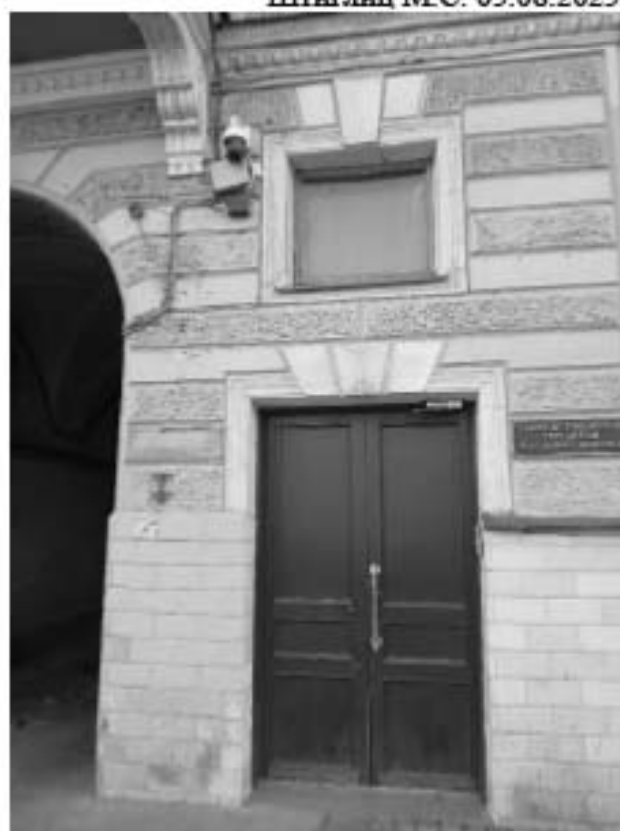
12. «Дом А.Г. Чадаева» (Невский пр., д. 53, лит. А). Лицевой фасад по Невскому пр. (фрагмент). Фото мест установки оборудования и прокладки кабельных трасс. Штиглиц М.С. 05.08.2025.
