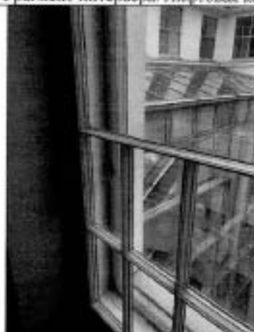
10. Фрагмент интерьера. Фрагмент оконного заполнения главной лестницы
