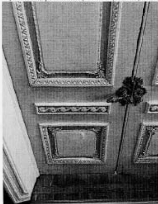
32, 33. Концертный зал. (пом. 3-Н, ч.п. 39, 2 этаж). Повреждения окрасочного слоя.
