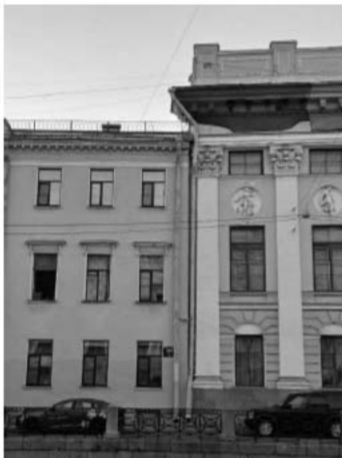
37. «Особняк А.И. Эбелинг» (наб. реки Мойки, д. 25, лит. А). Лицевой фасад по наб. реки Мойки. (фрагмент). Фото мест установки оборудования и прокладки кабельных трасс. Штиглиц М.С. 05.08.2025.
