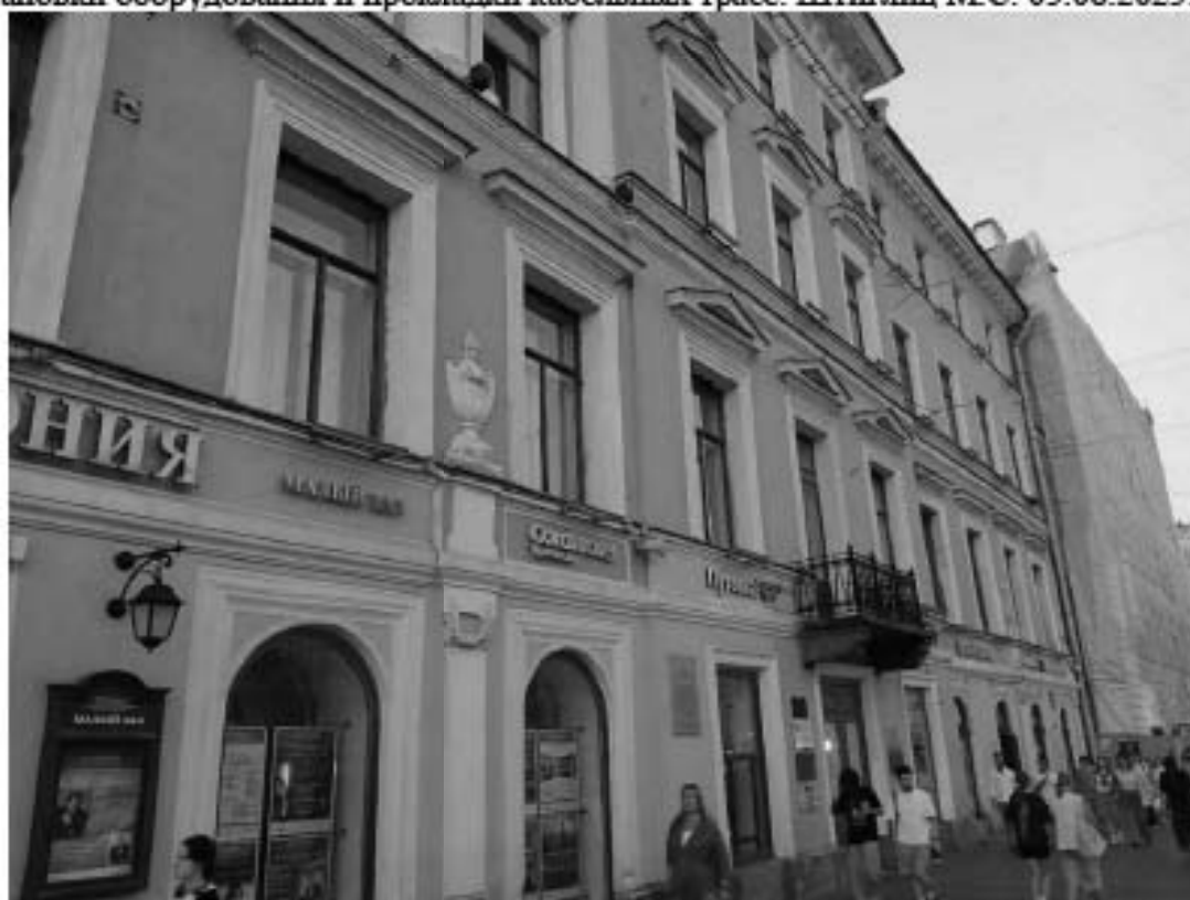
22. «Дом Энгельгардта В.В. (Санкт-Петербургский учетный и ссудный банк)». Невский пр., д. 30, лит. А. Лицевой фасад по Невскому пр. (фрагмент). Фото мест установки оборудования и прокладки кабельных трасс. Штиглиц М.С. 05.08.2025.
