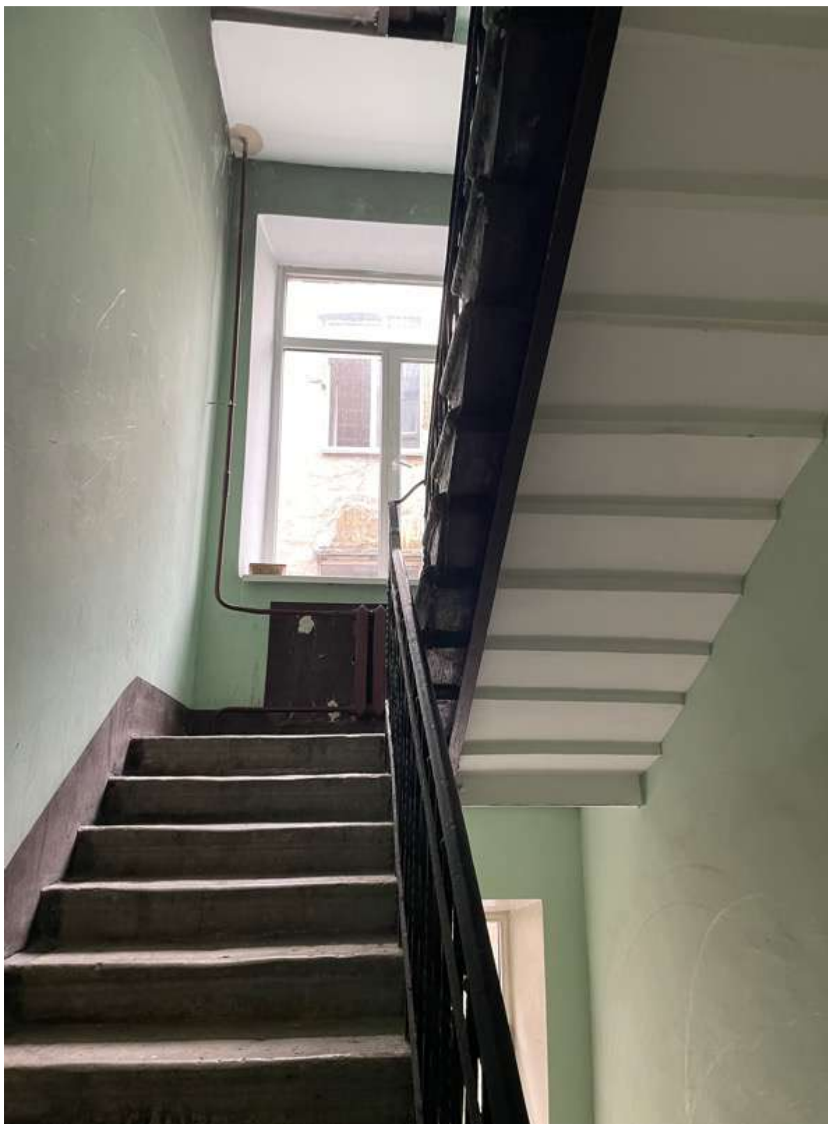
40. Фрагмент интерьера лестницы Л-3
