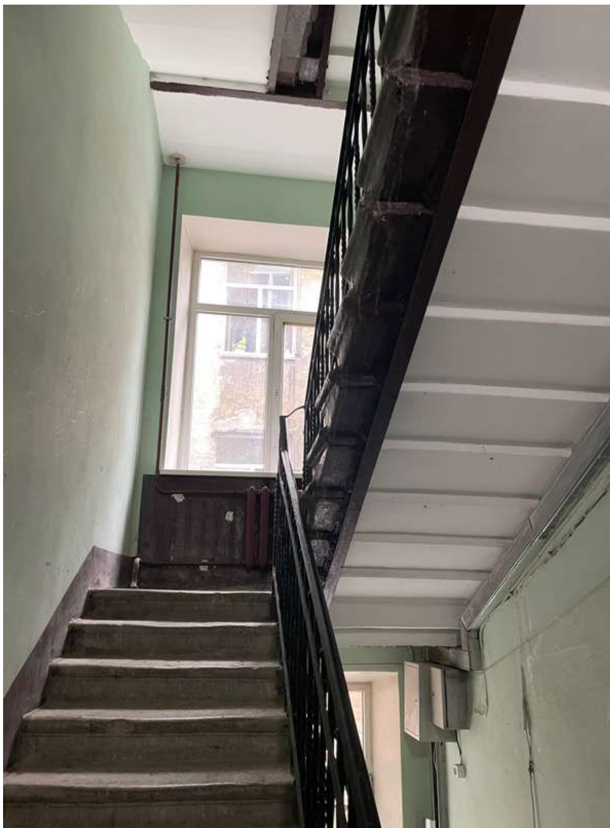
38. Фрагмент интерьера лестницы Л-3
