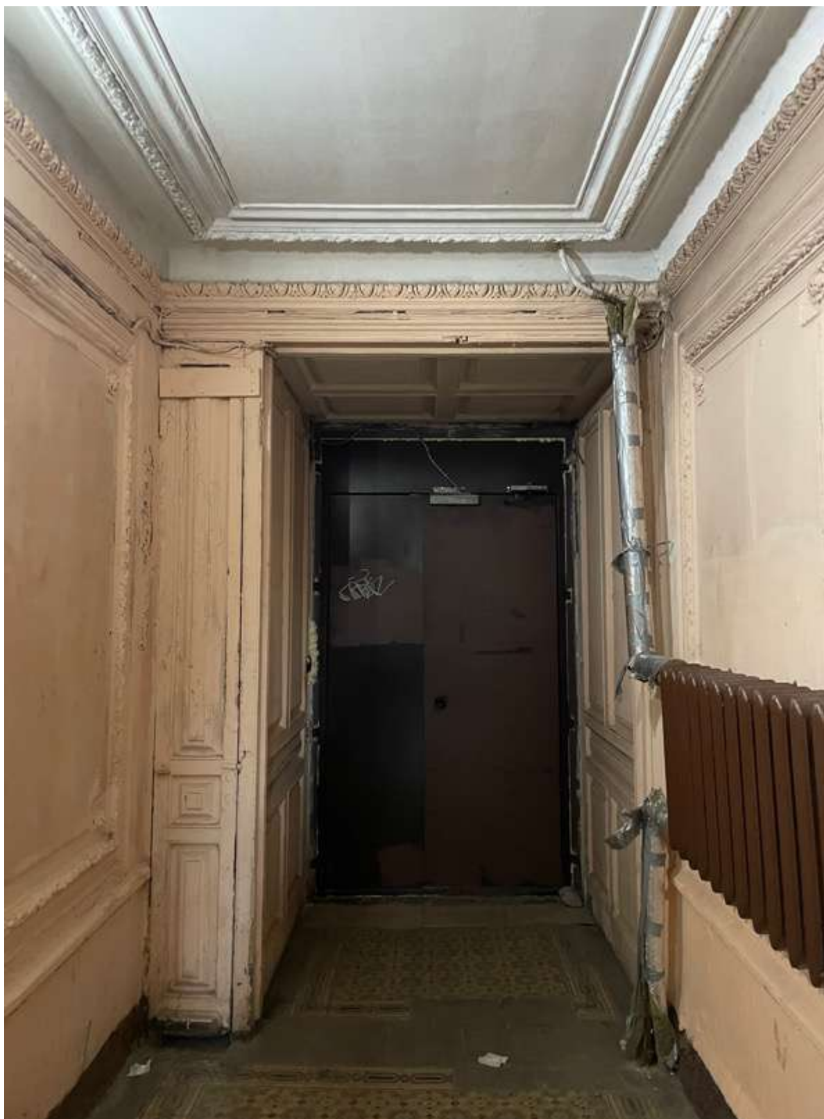
24. Фрагмент интерьера лестницы Л-1
