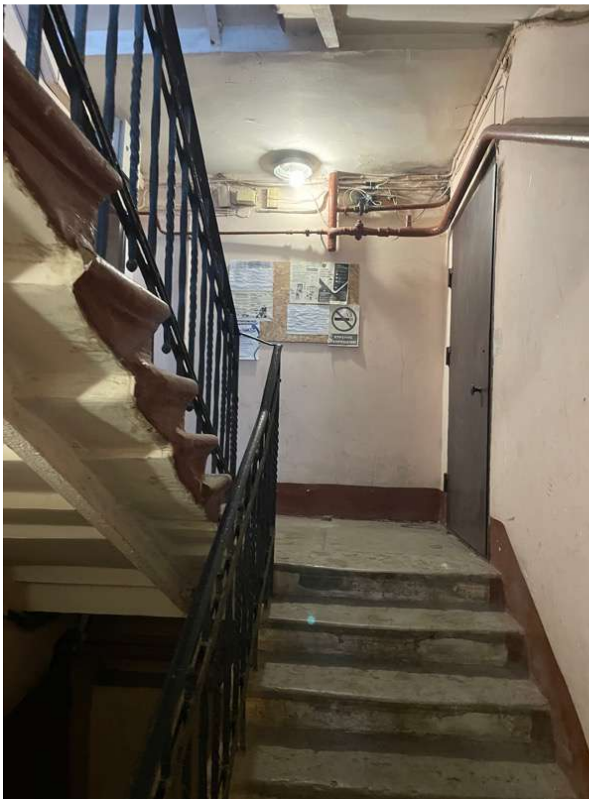
21. Фрагмент интерьера лестницы Л-2
