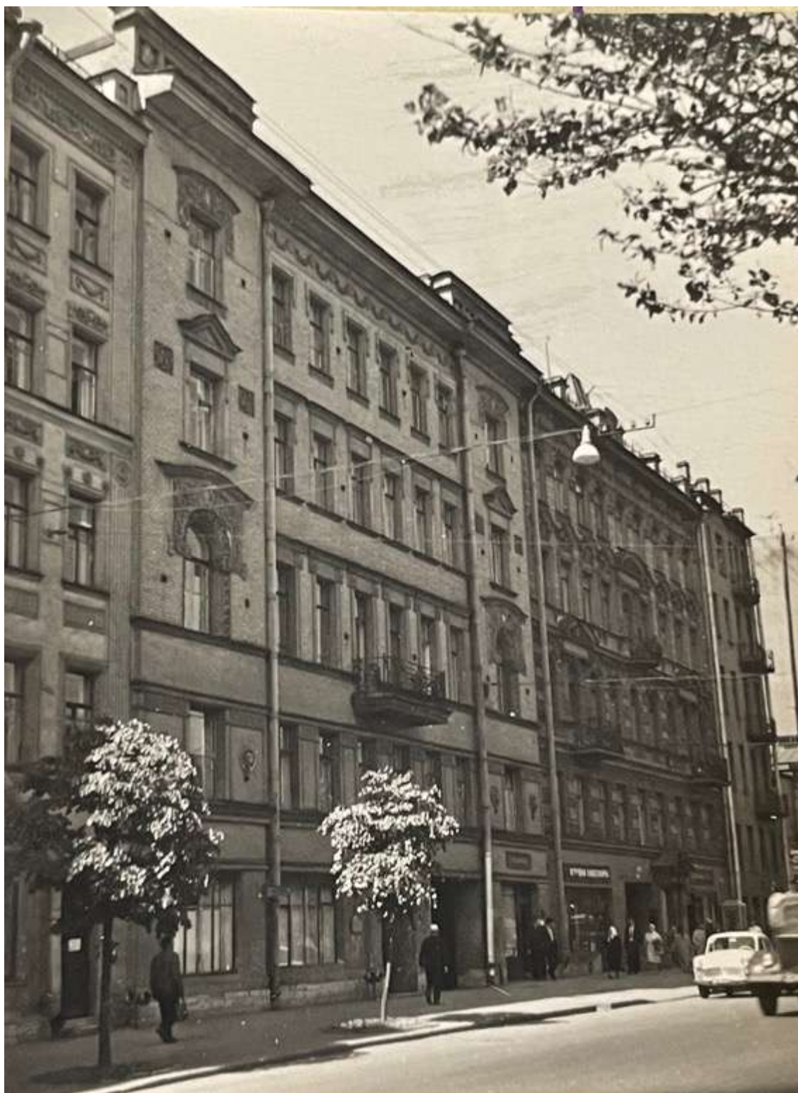
77.Лиговский, 135. 1967 г. Архив КГИОП
