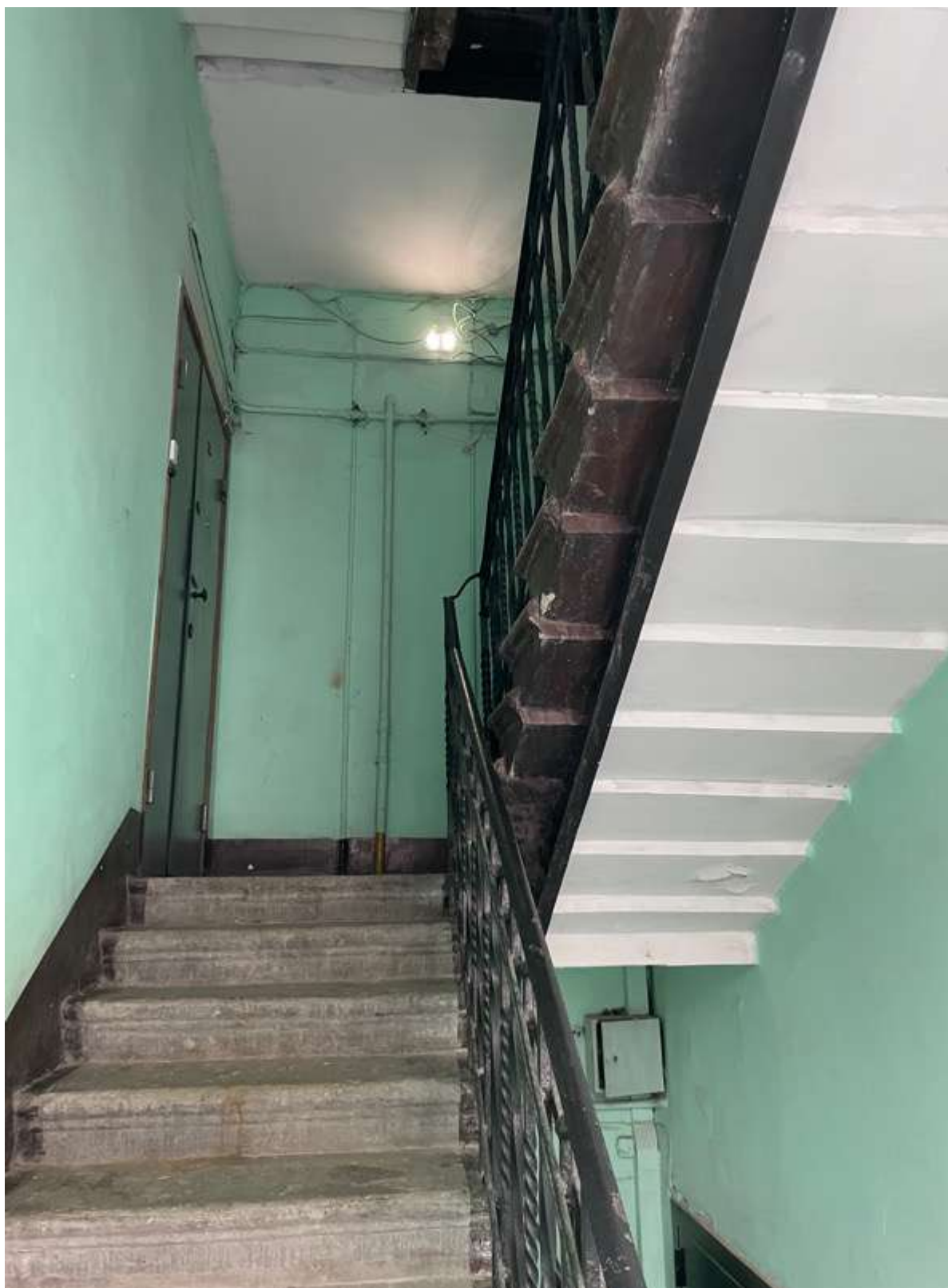
43. Фрагмент интерьера лестницы Л-3
