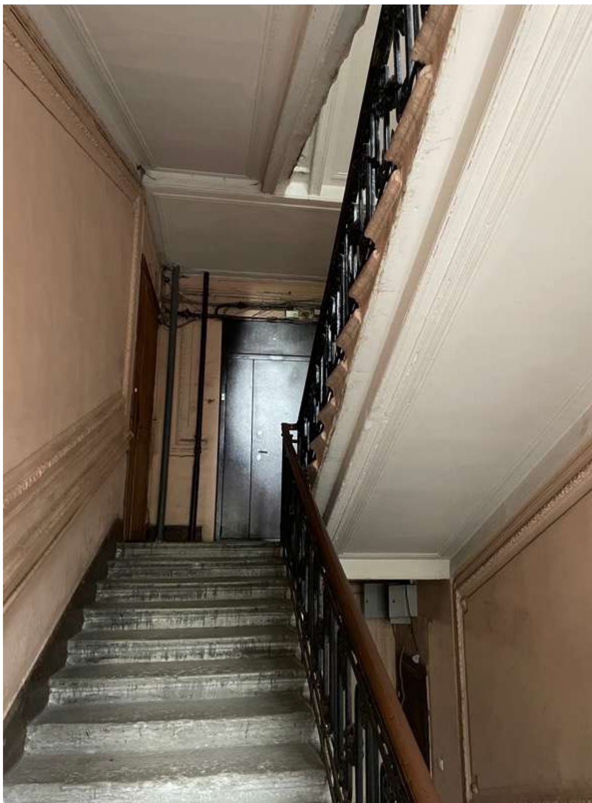
26. Фрагмент интерьера лестницы Л-1
