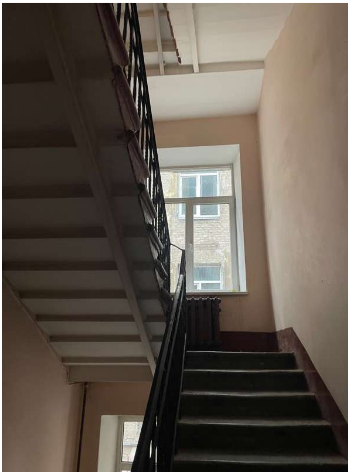
14. Фрагмент интерьера лестницы Л-2
