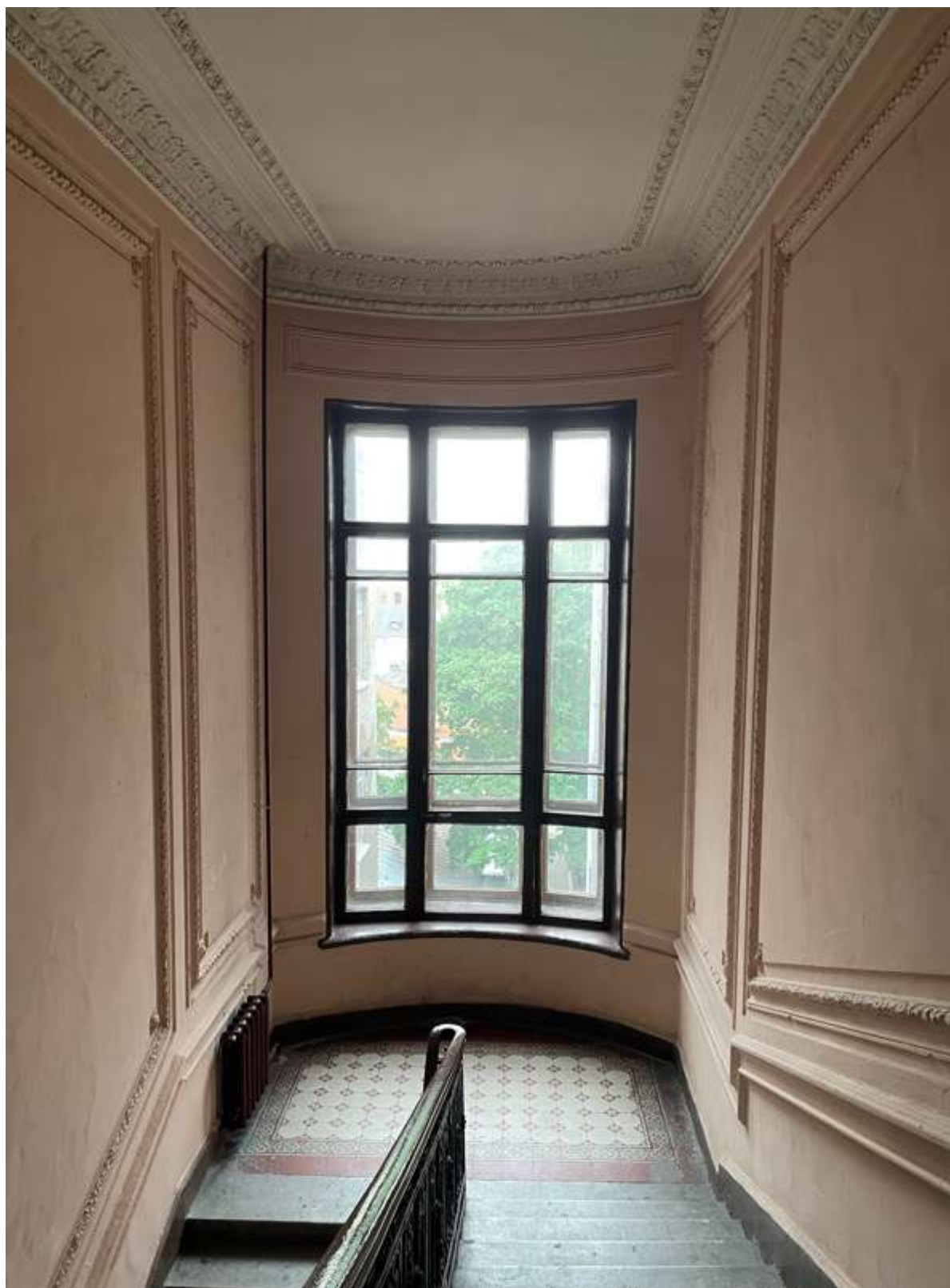
34. Фрагмент интерьера лестницы Л-1
