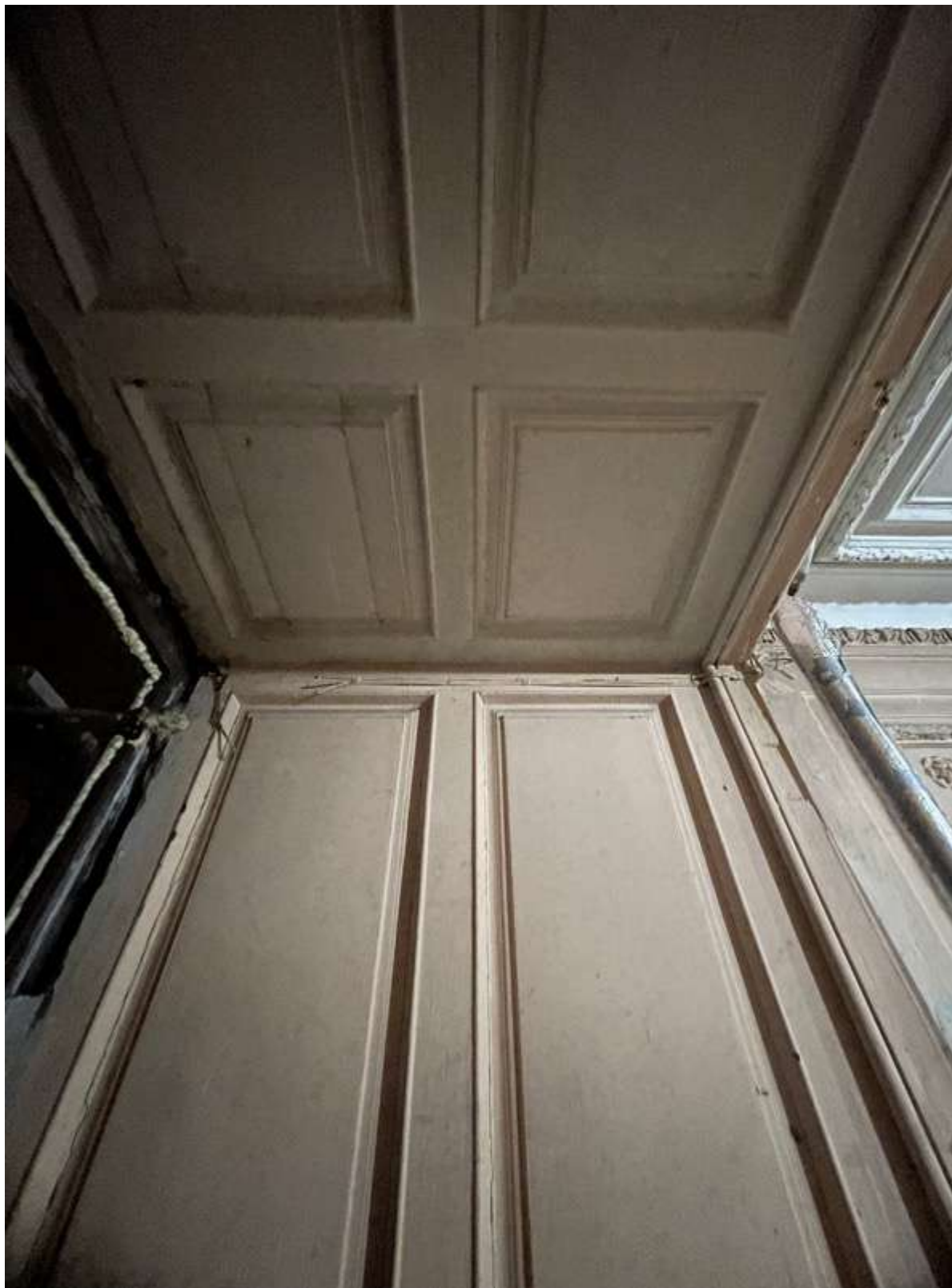
22. Фрагмент интерьера лестницы Л-1
