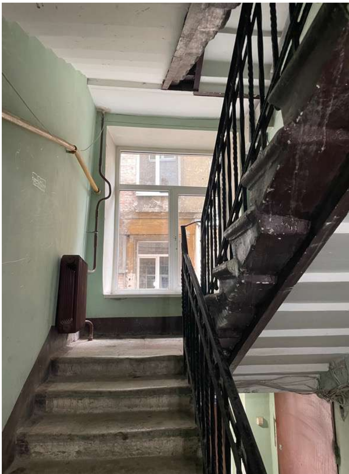
36. Фрагмент интерьера лестницы Л-3
