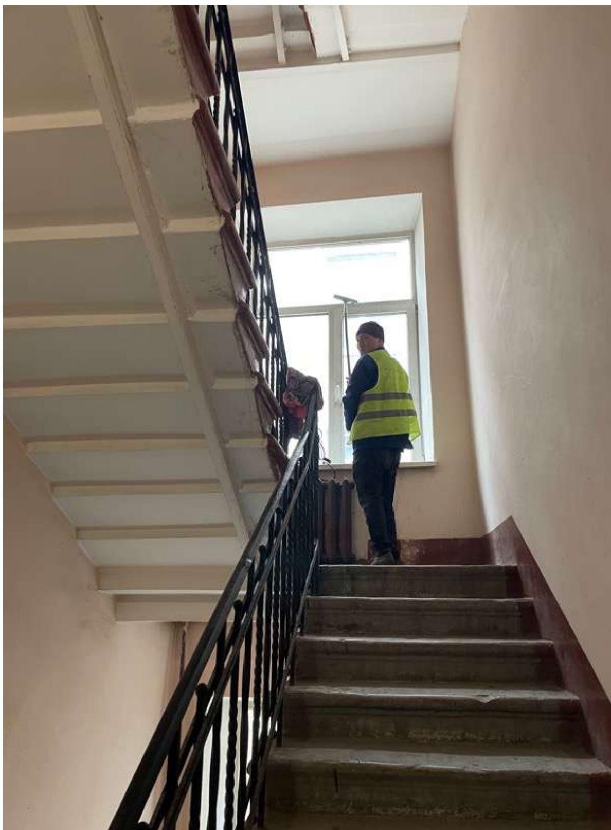
16. Фрагмент интерьера лестницы Л-2
