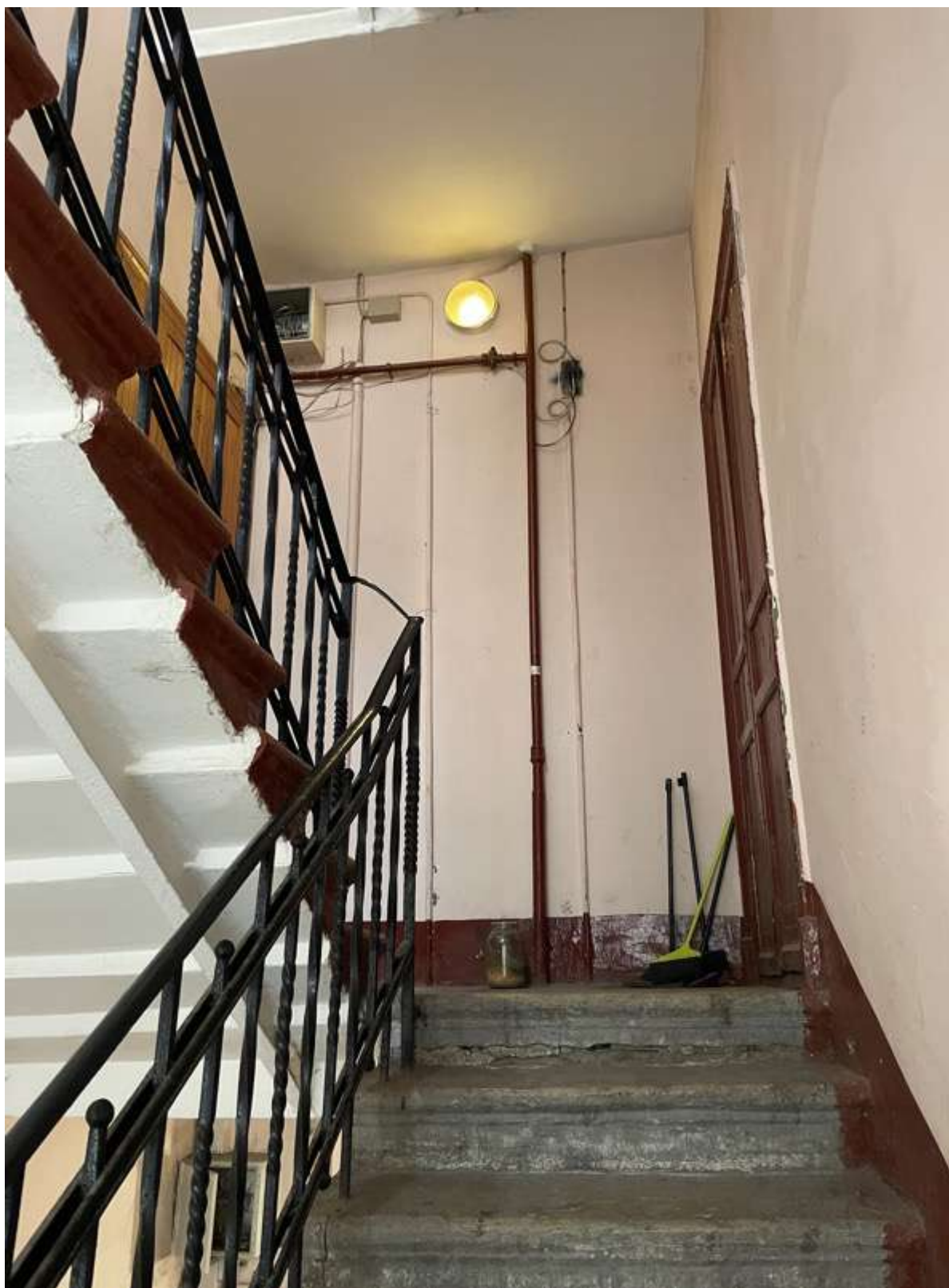
17. Фрагмент интерьера лестницы Л-2
