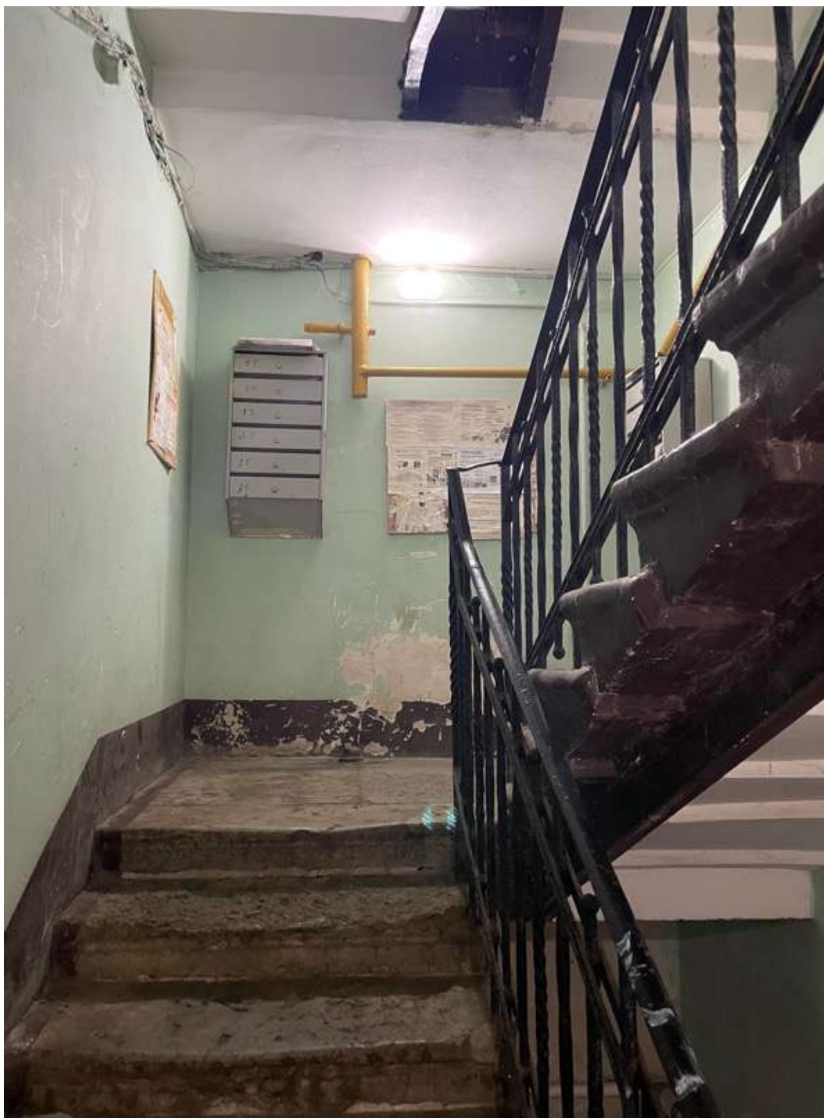
35. Фрагмент интерьера лестницы Л-3
