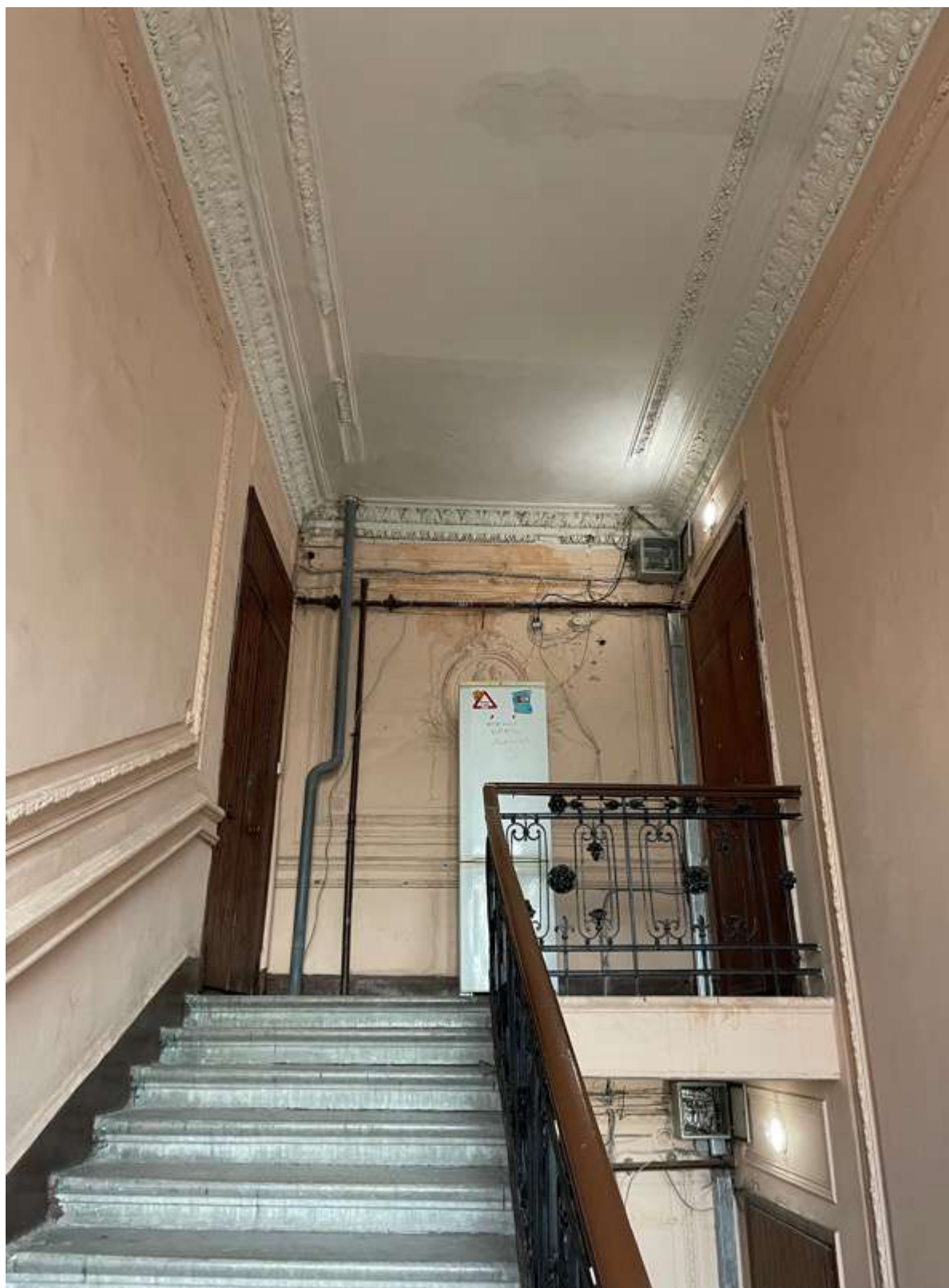
33. Фрагмент интерьера лестницы Л-1
