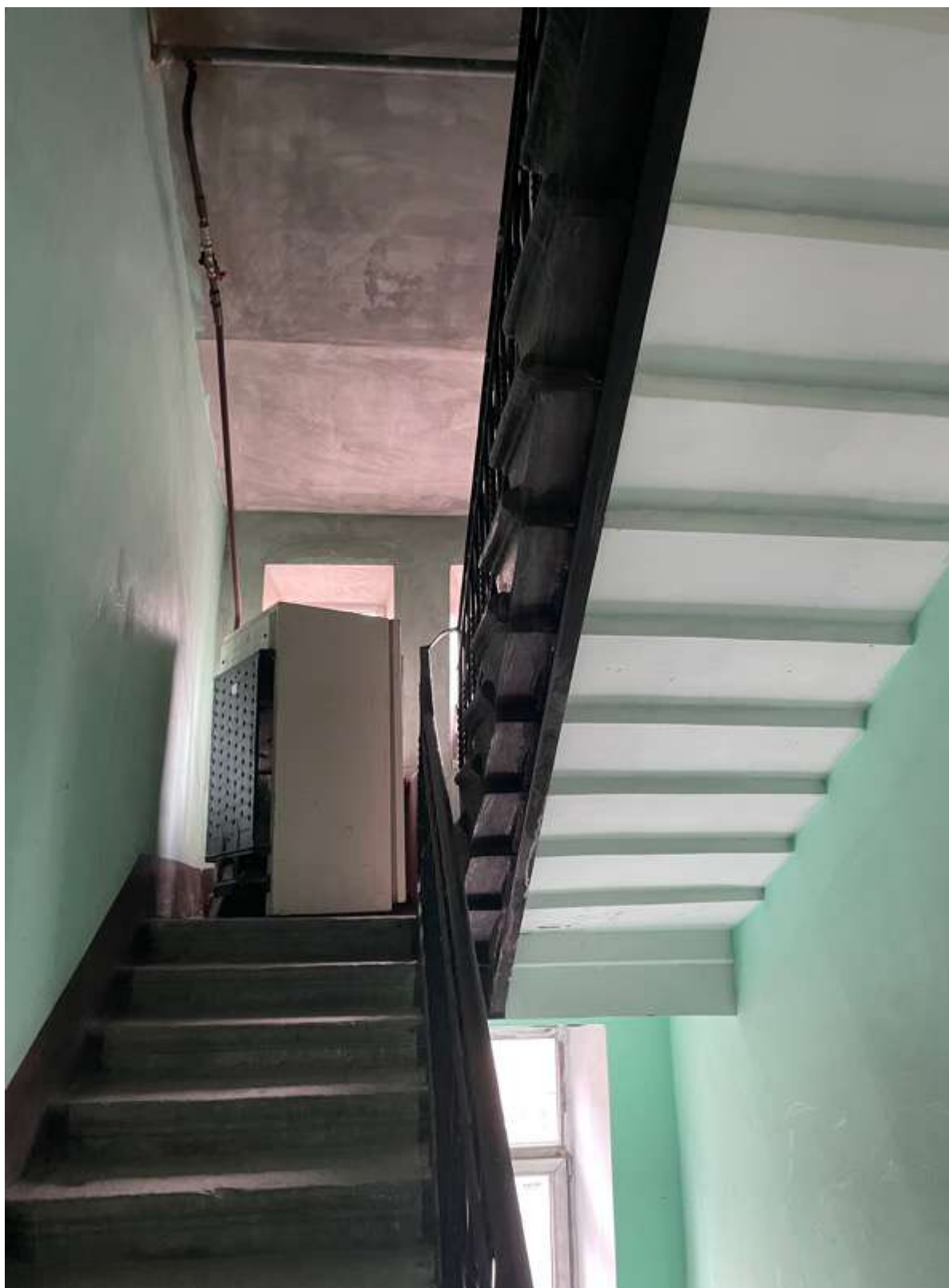
44. Фрагмент интерьера лестницы Л-3
