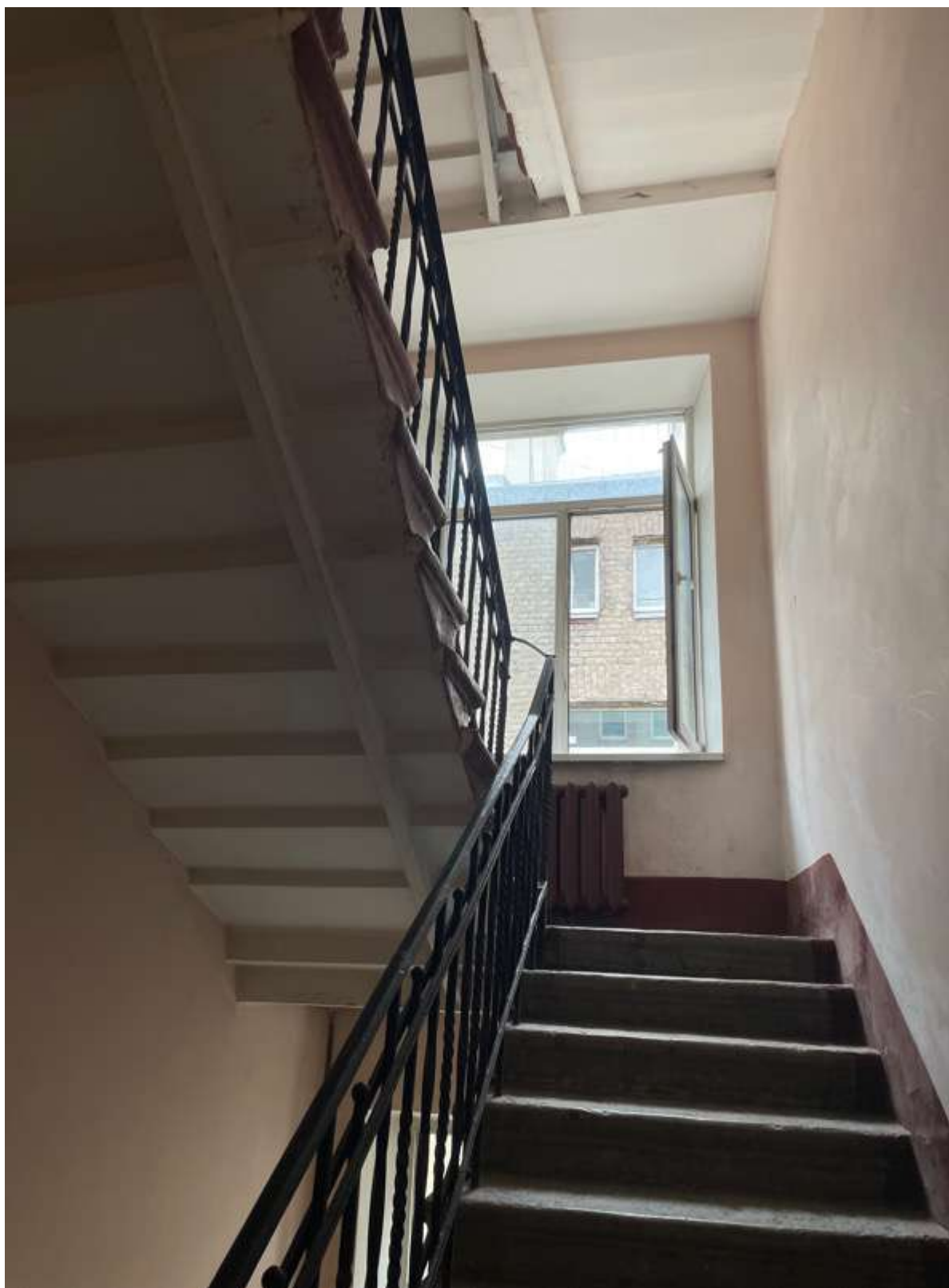
18. Фрагмент интерьера лестницы Л-2
