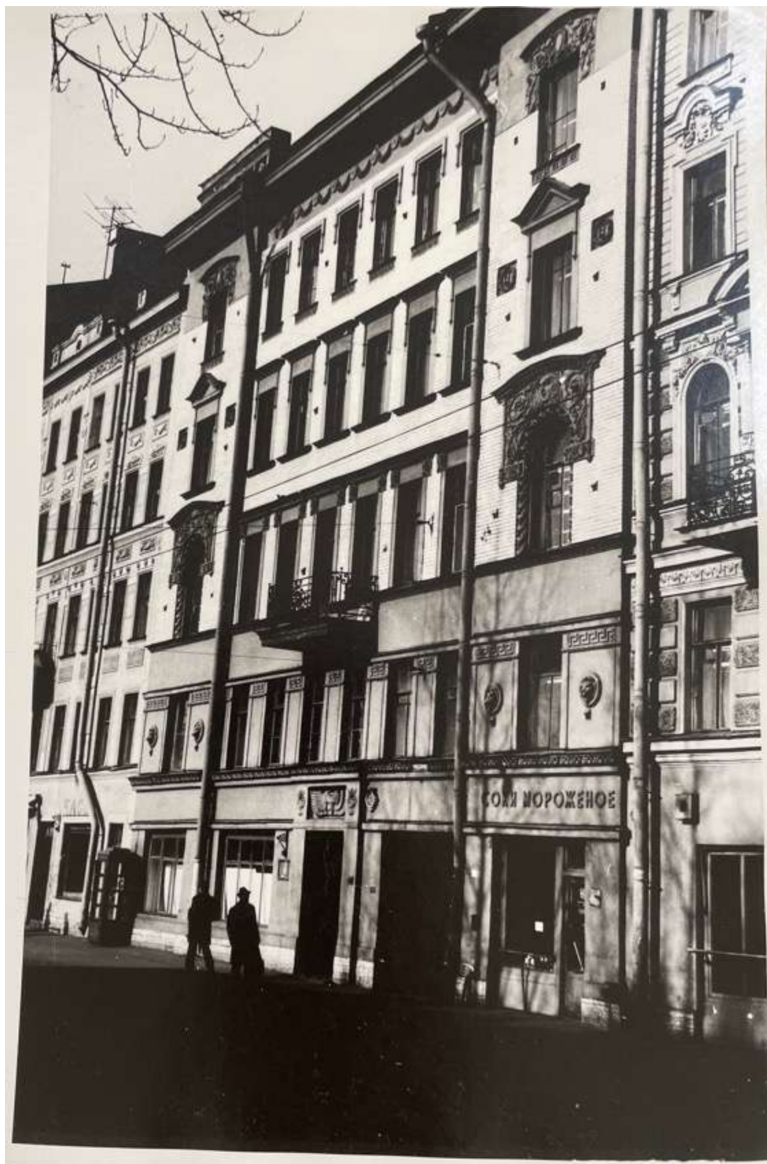
79.Лиговский, 135. 1979 г. Архив КГИОП
