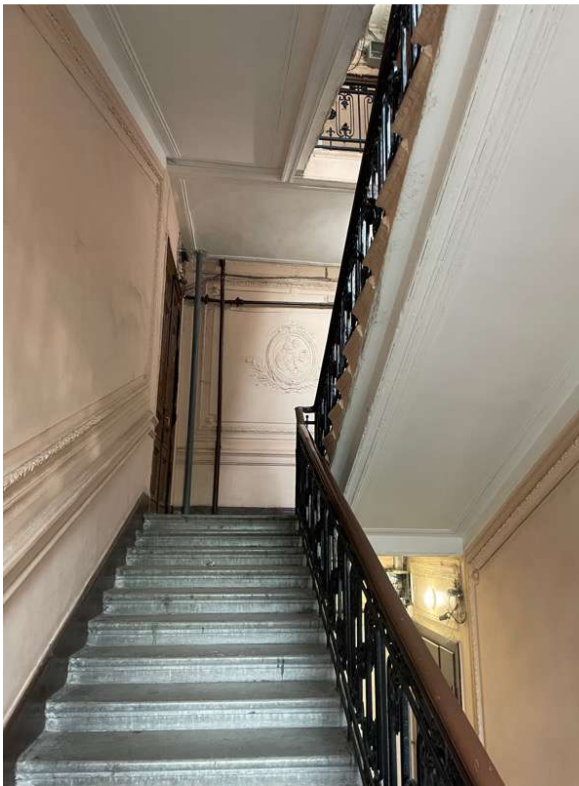
31. Фрагмент интерьера лестницы Л-1
