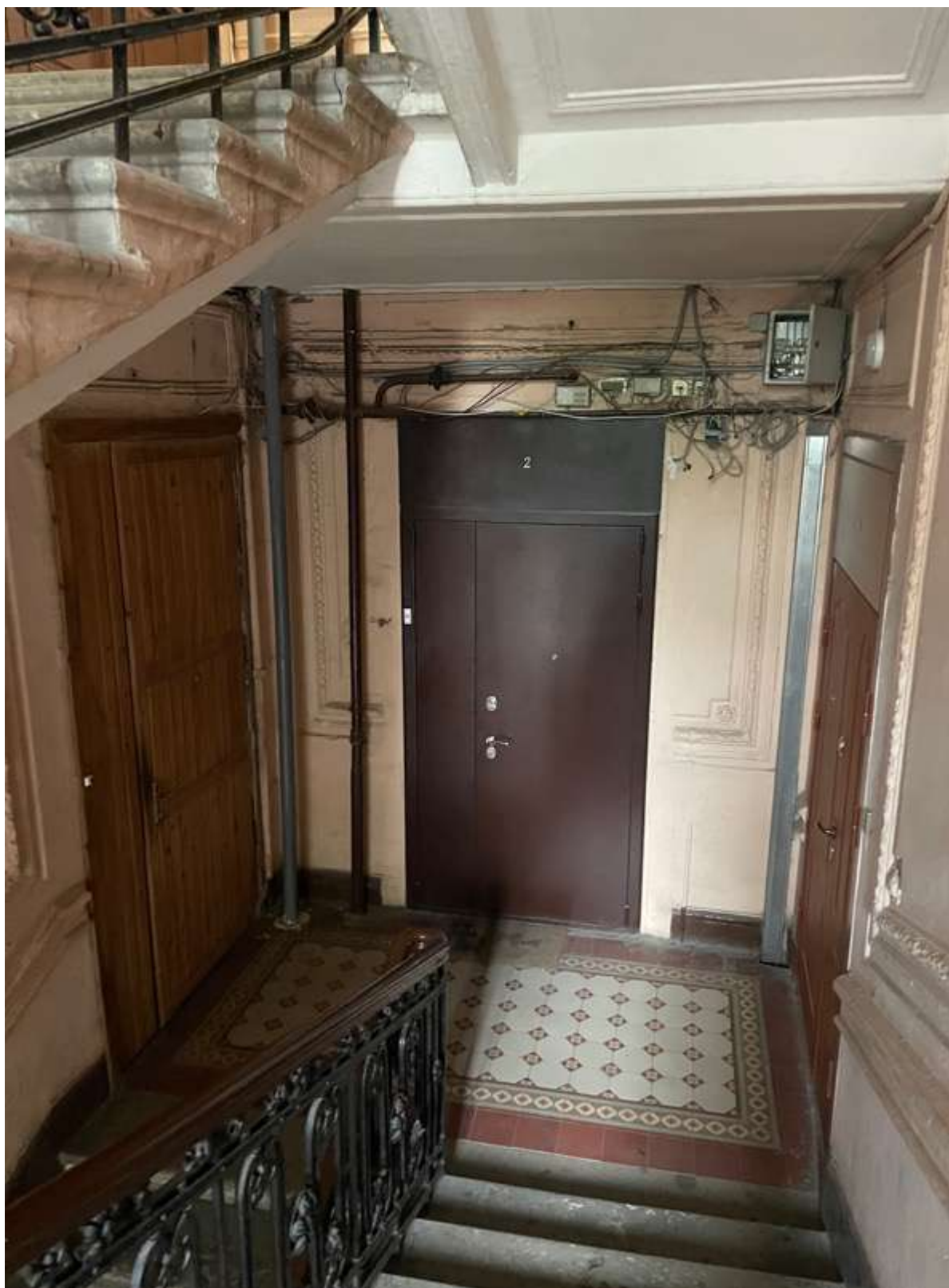
28. Фрагмент интерьера лестницы Л-1
