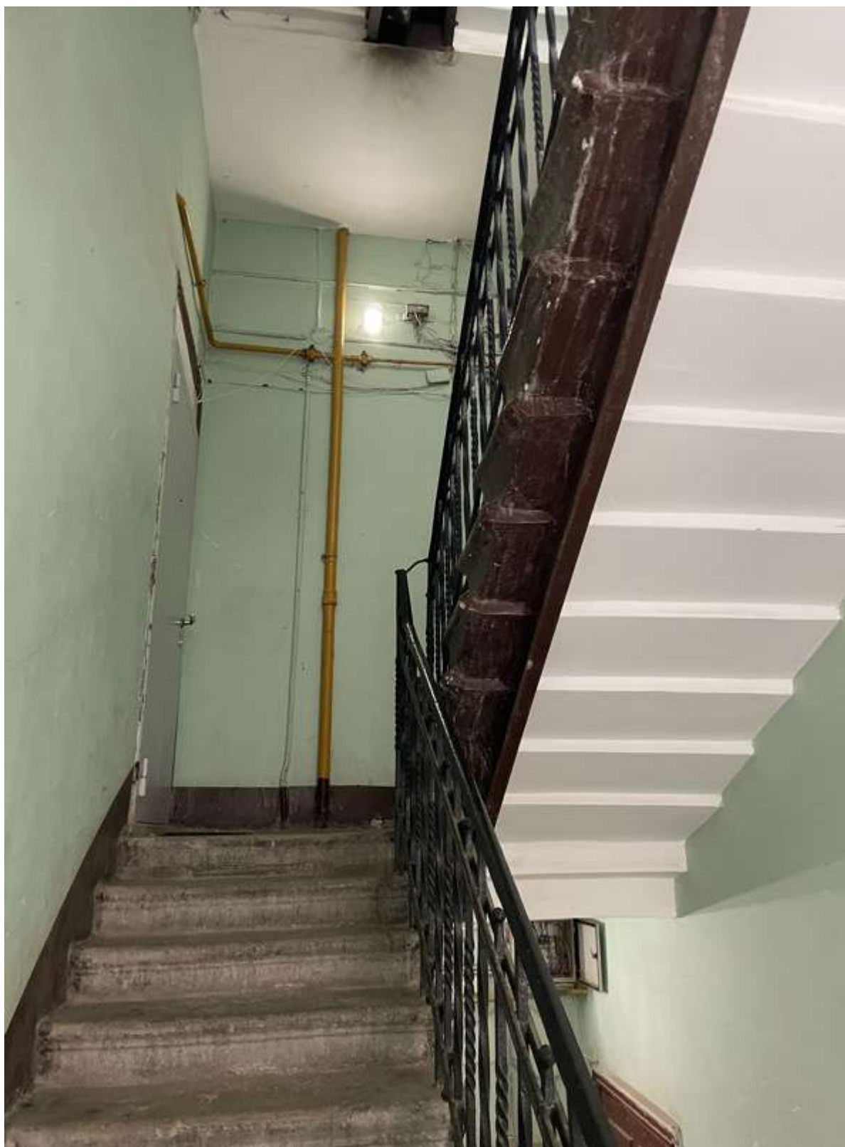
39. Фрагмент интерьера лестницы Л-3
