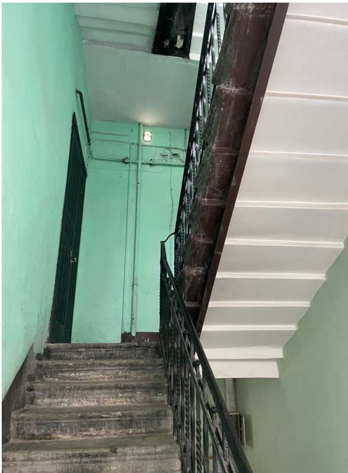
41. Фрагмент интерьера лестницы Л-3
