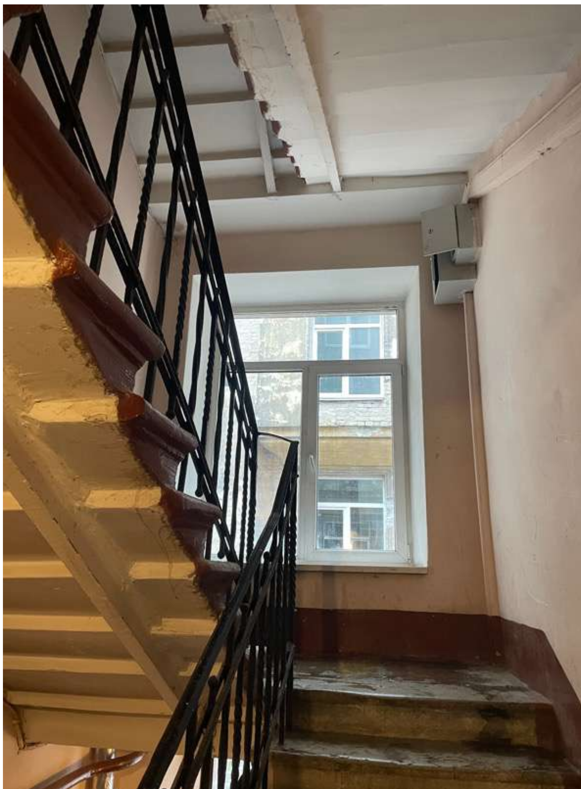
12. Фрагмент интерьера лестницы Л-2
