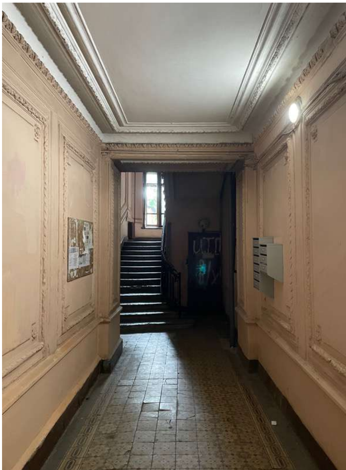
23. Фрагмент интерьера лестницы Л-1
