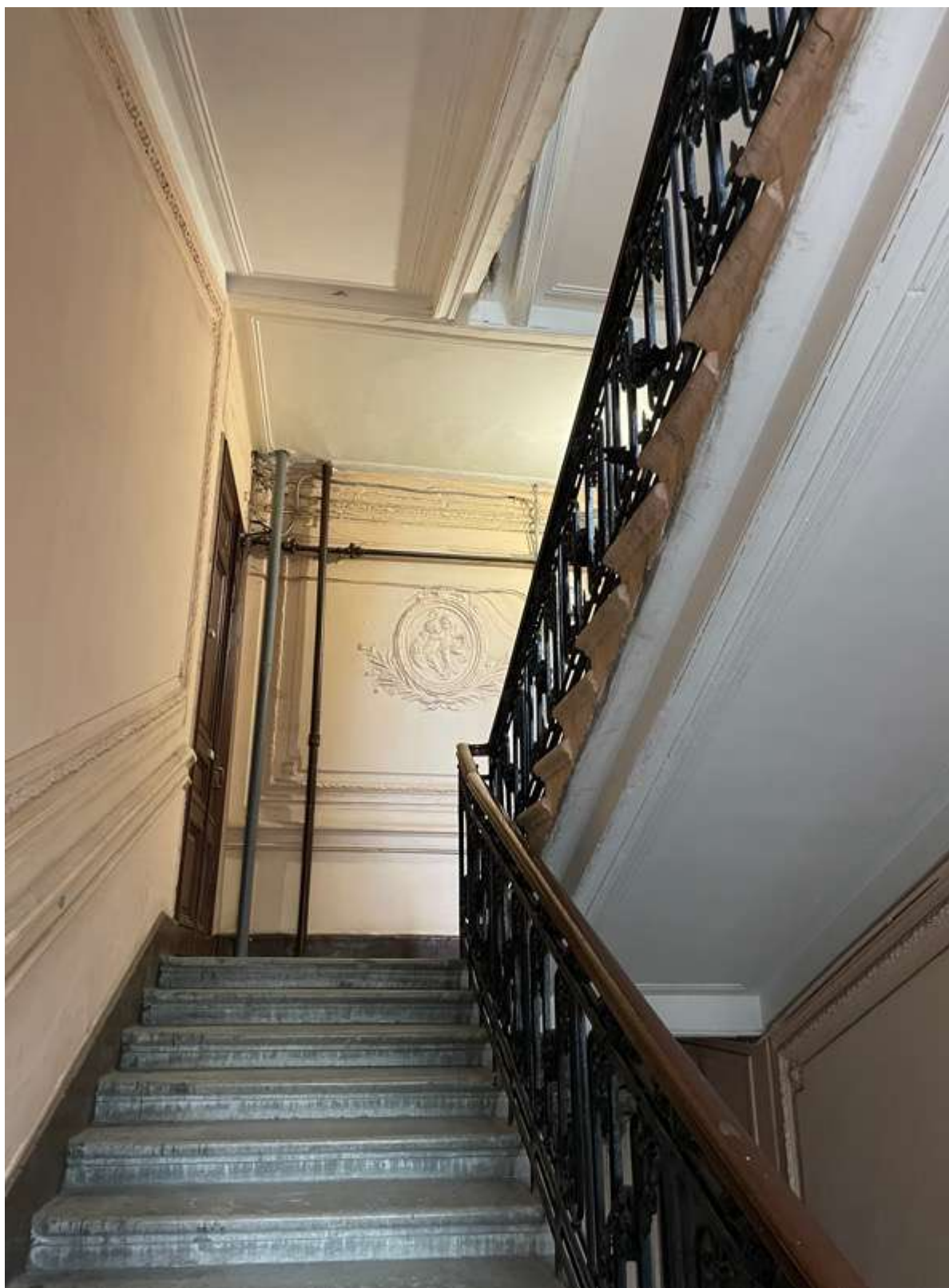
29. Фрагмент интерьера лестницы Л-1
