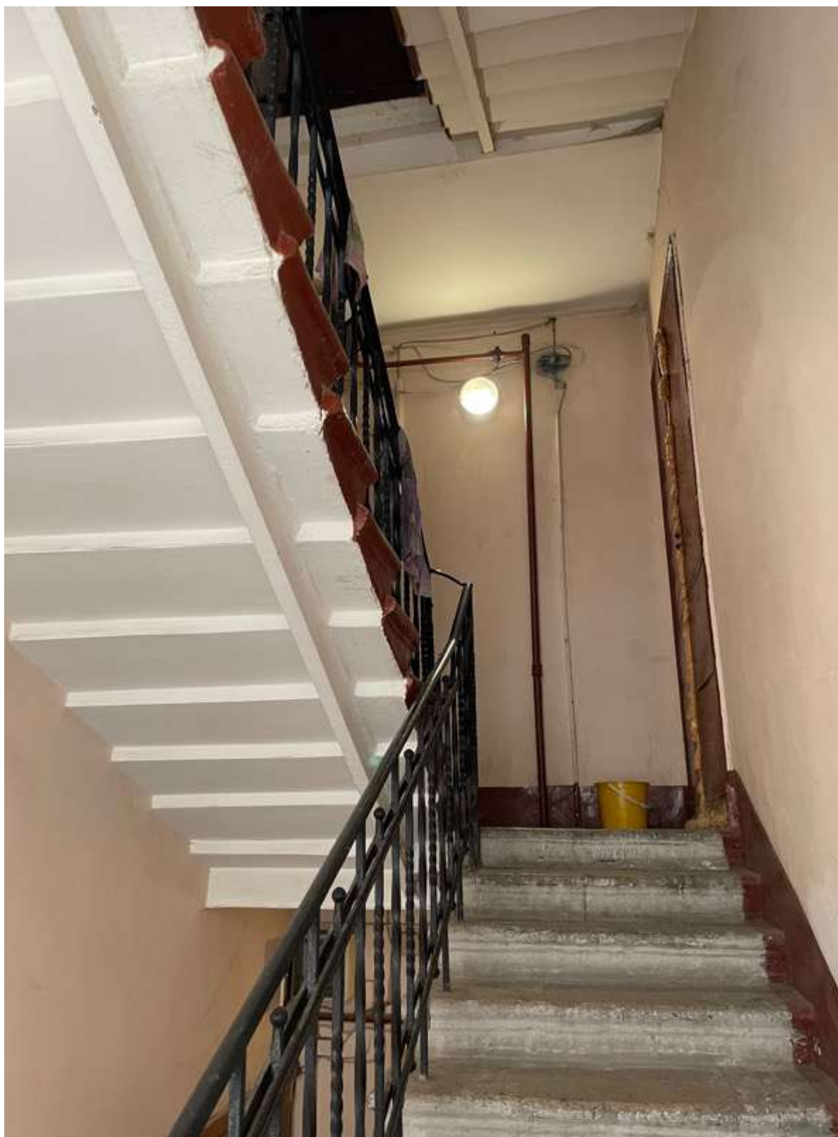
19. Фрагмент интерьера лестницы Л-2
