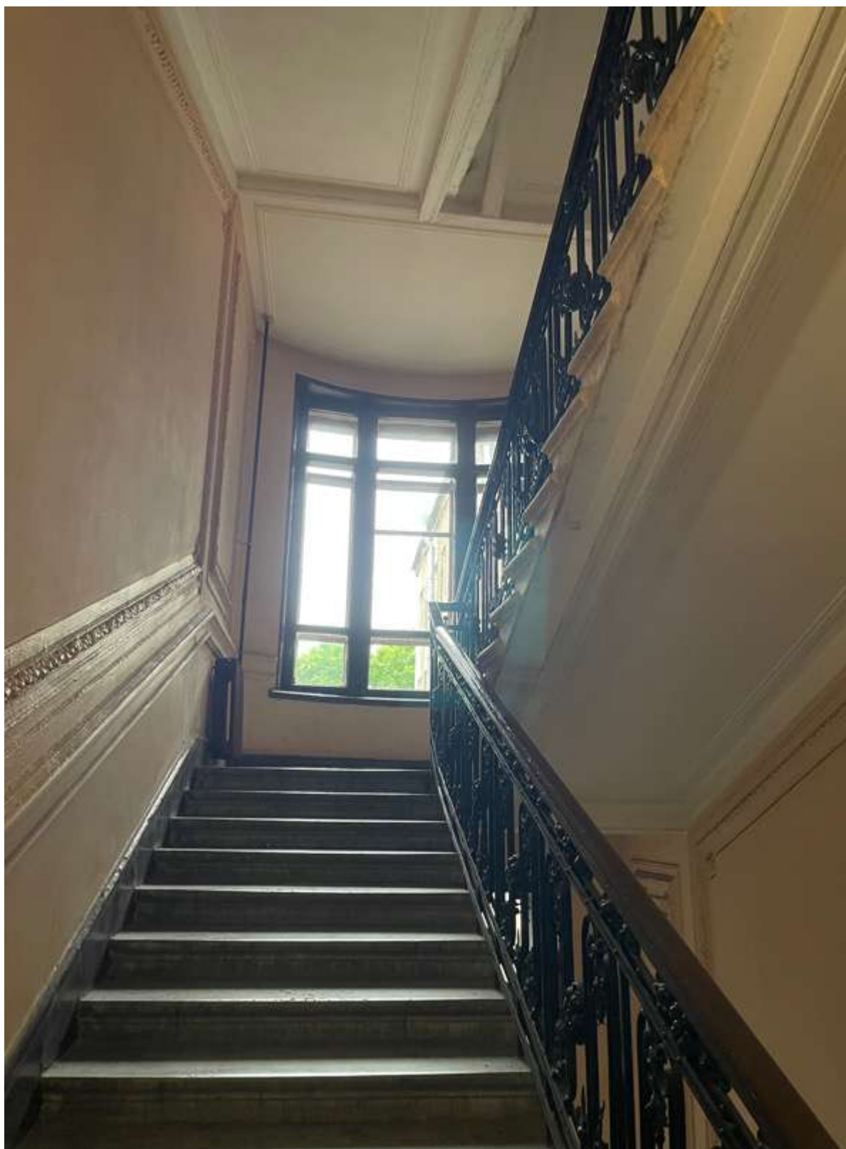
30. Фрагмент интерьера лестницы Л-1
