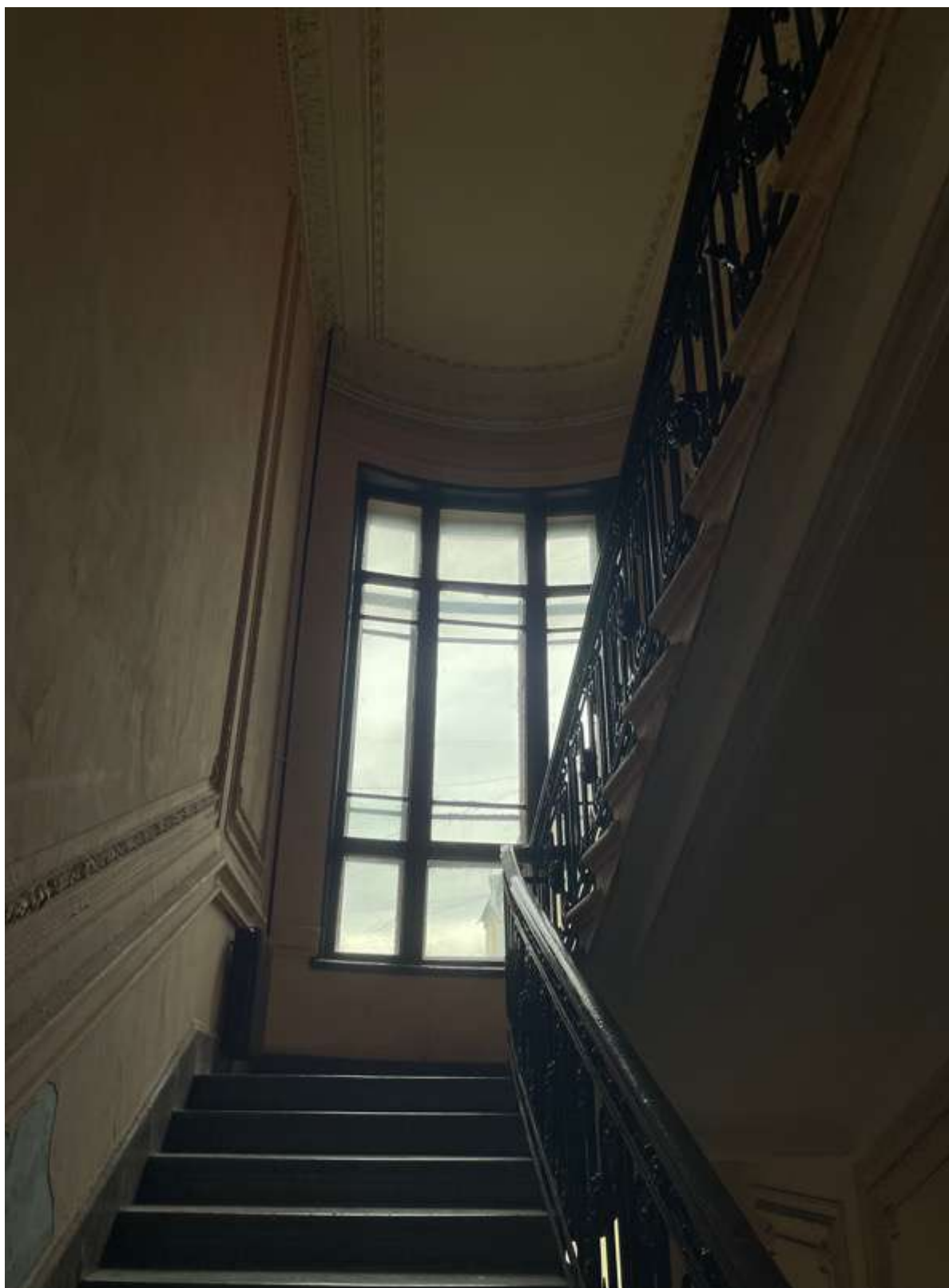
32. Фрагмент интерьера лестницы Л-1
