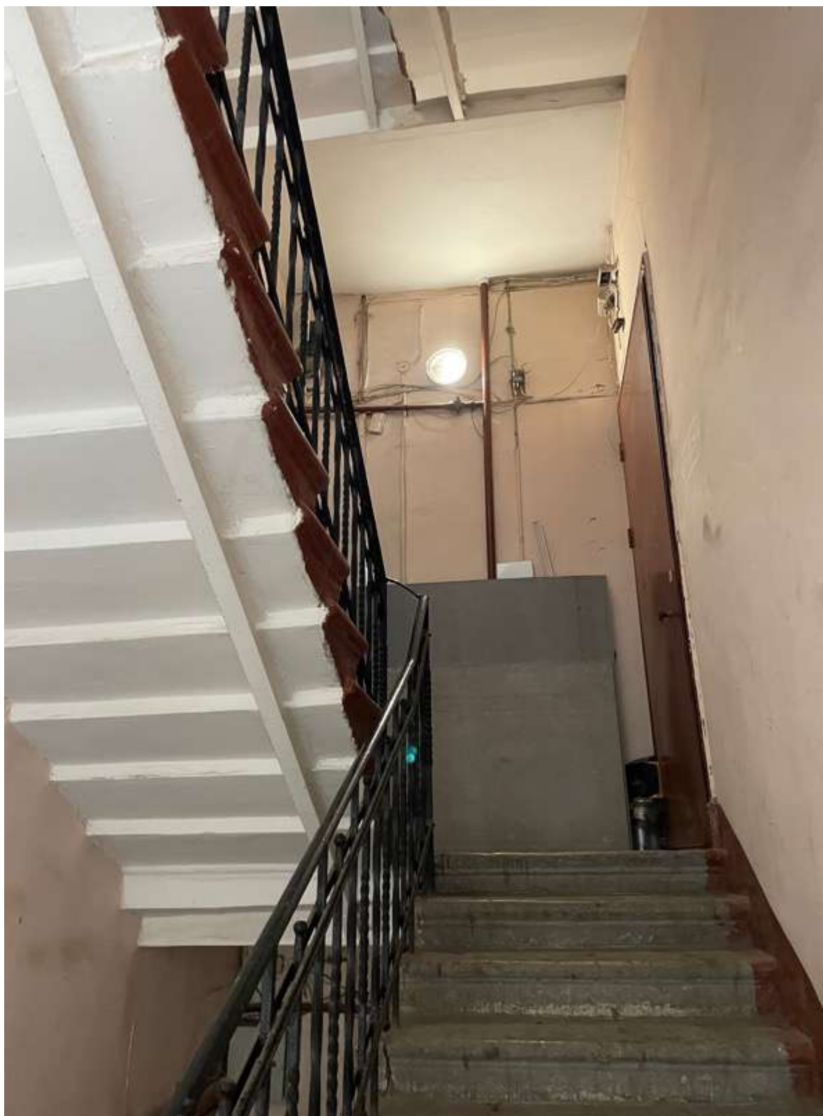
15. Фрагмент интерьера лестницы Л-2
