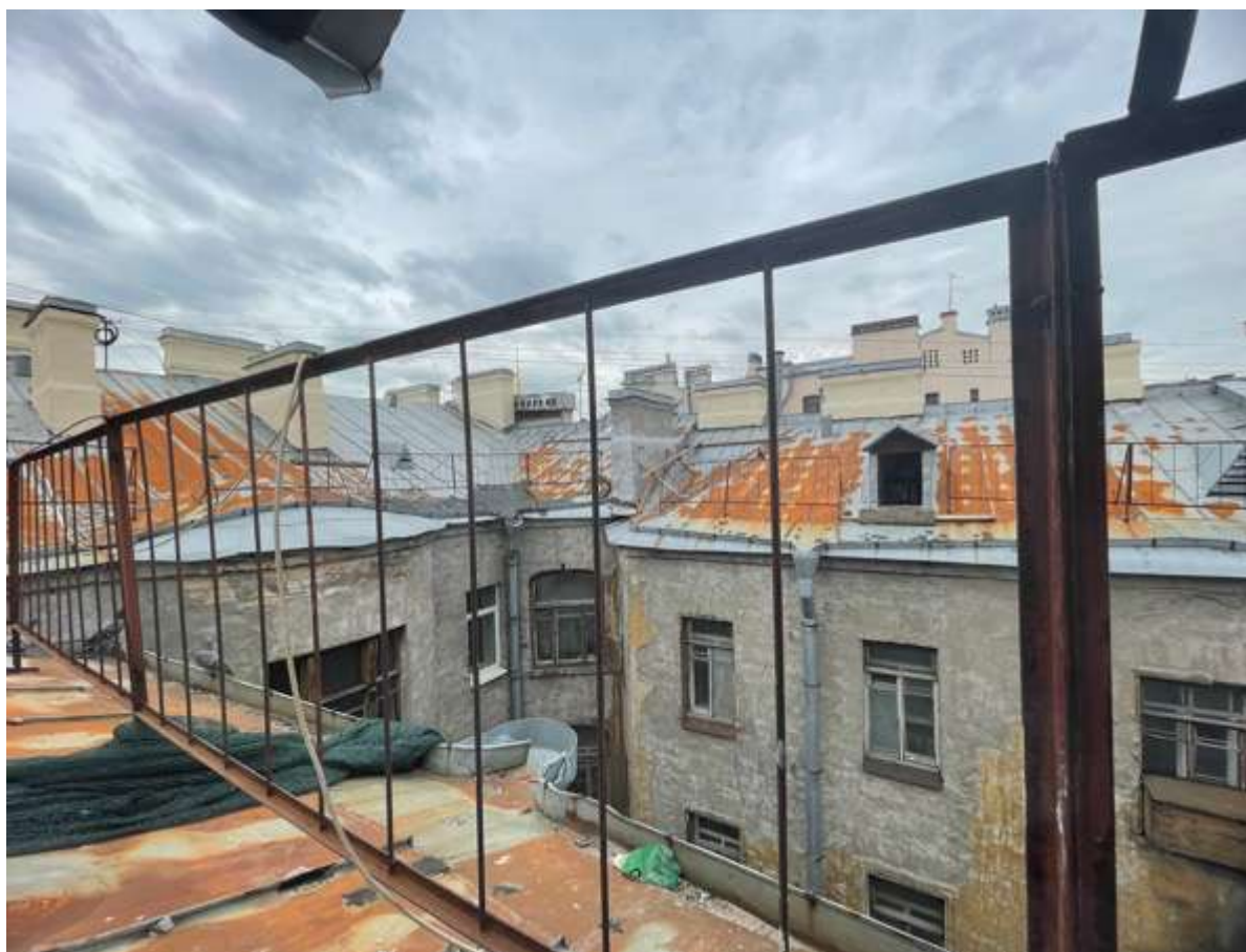
45. Вид на крыши здания
