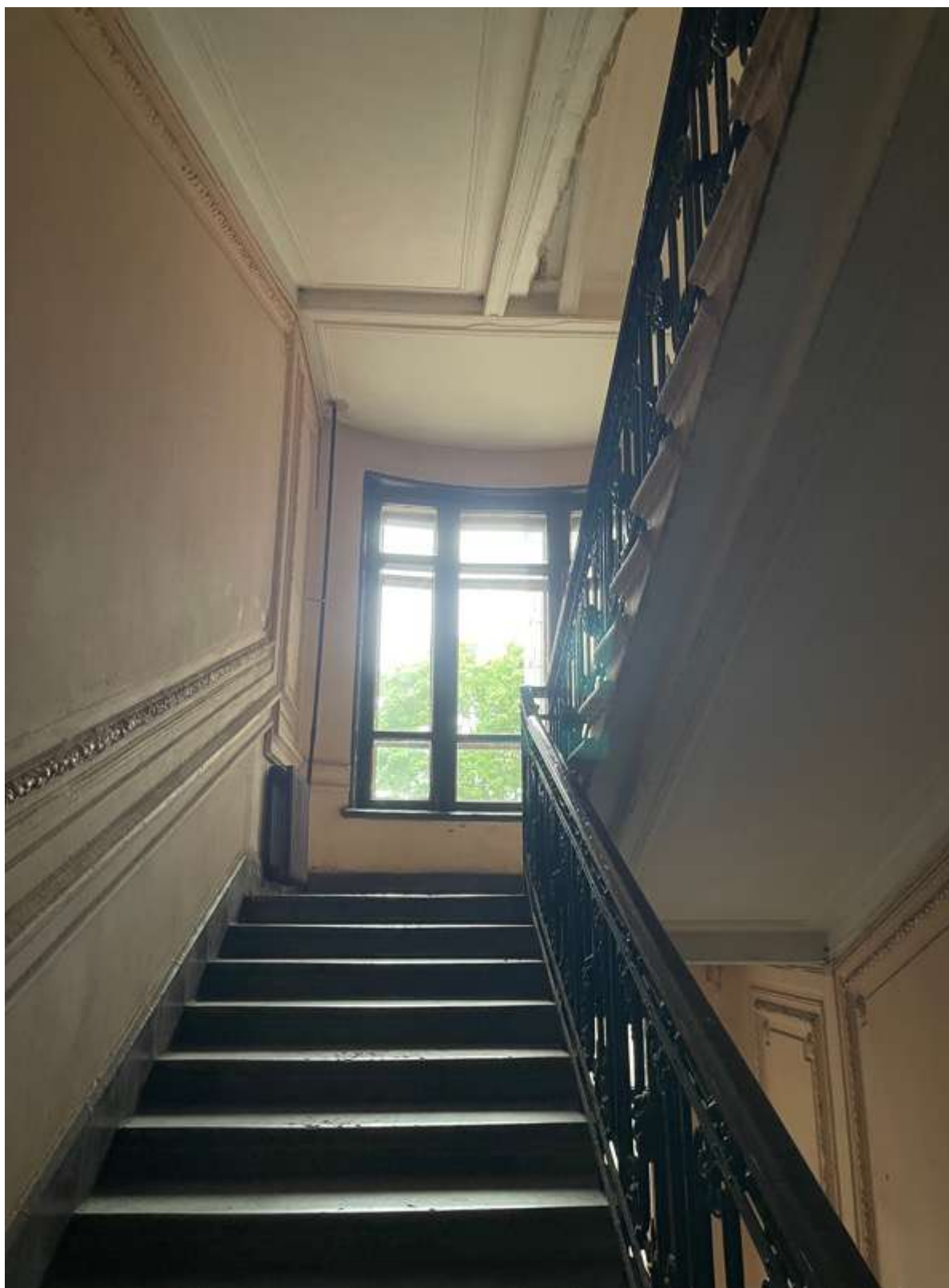
27. Фрагмент интерьера лестницы Л-1
