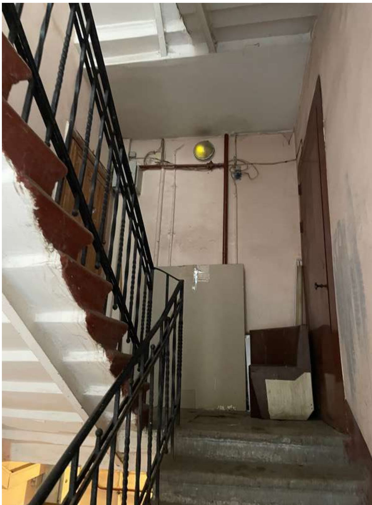
13. Фрагмент интерьера лестницы Л-2
