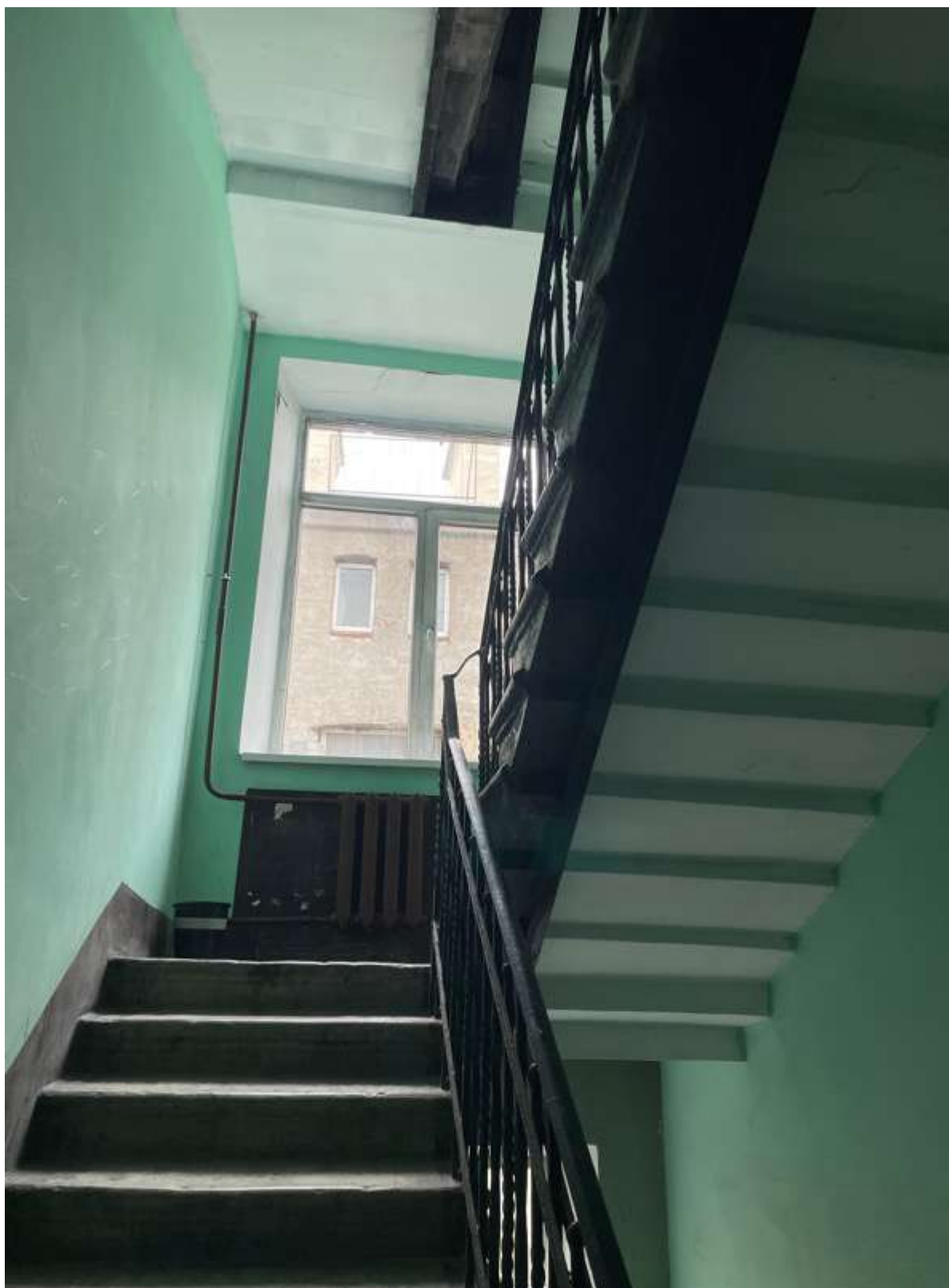
42. Фрагмент интерьера лестницы Л-3
