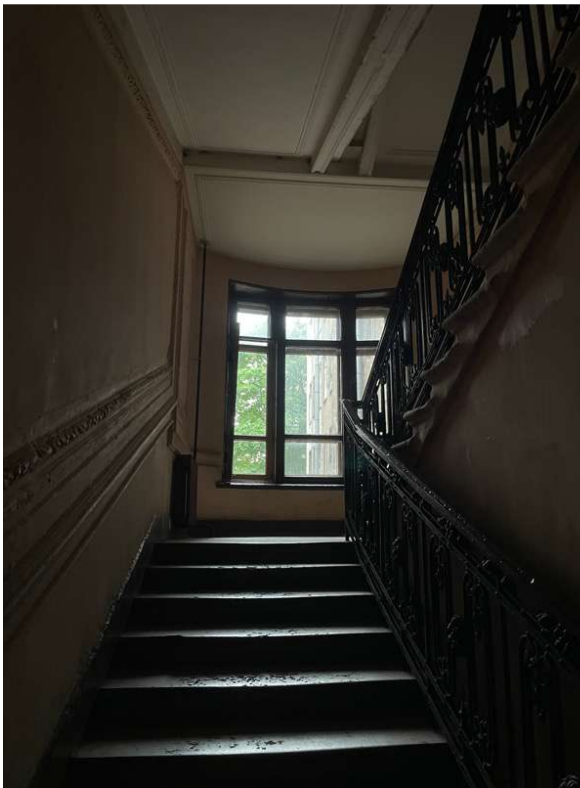
25. Фрагмент интерьера лестницы Л-1
