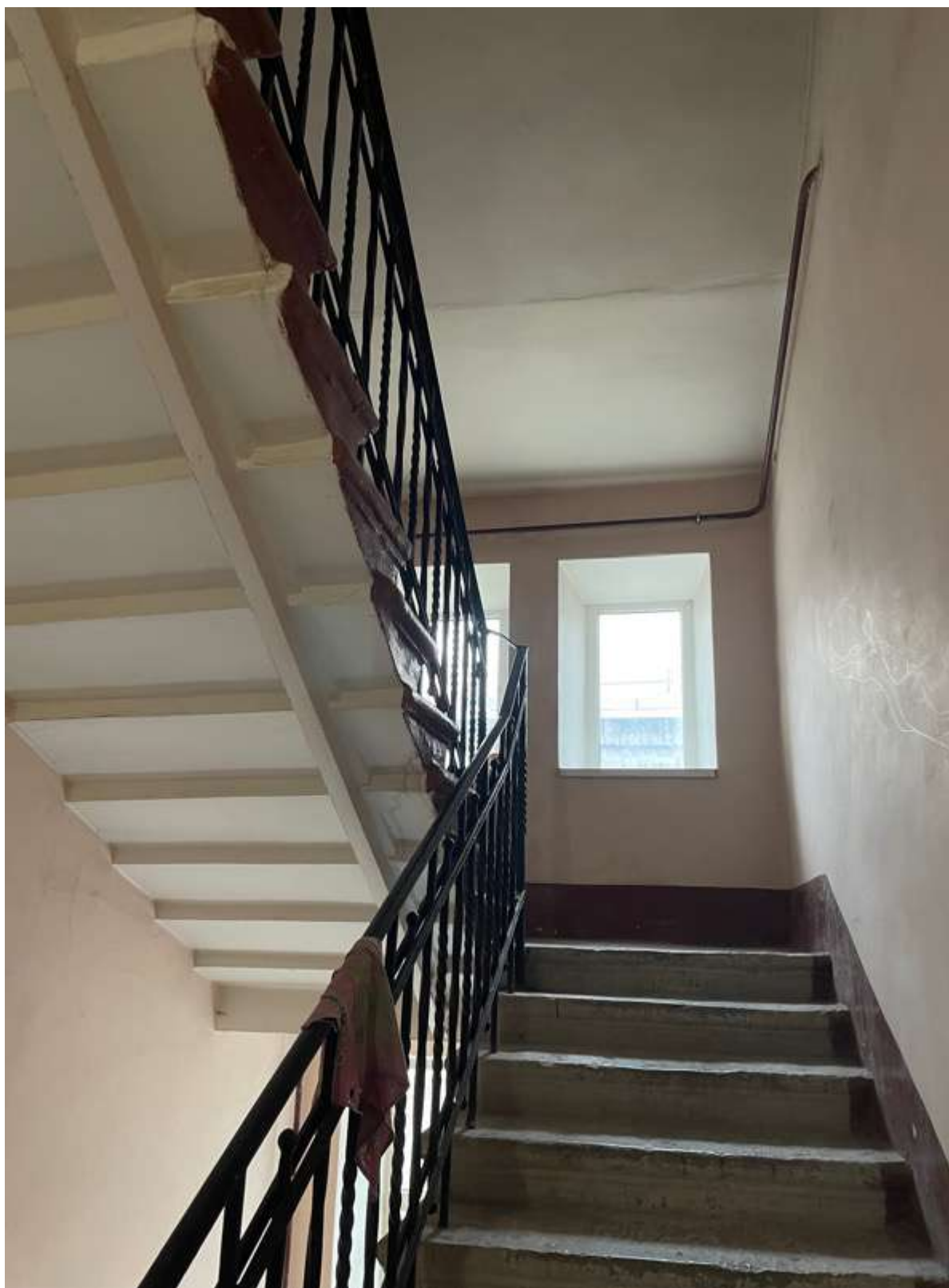
20. Фрагмент интерьера лестницы Л-2
