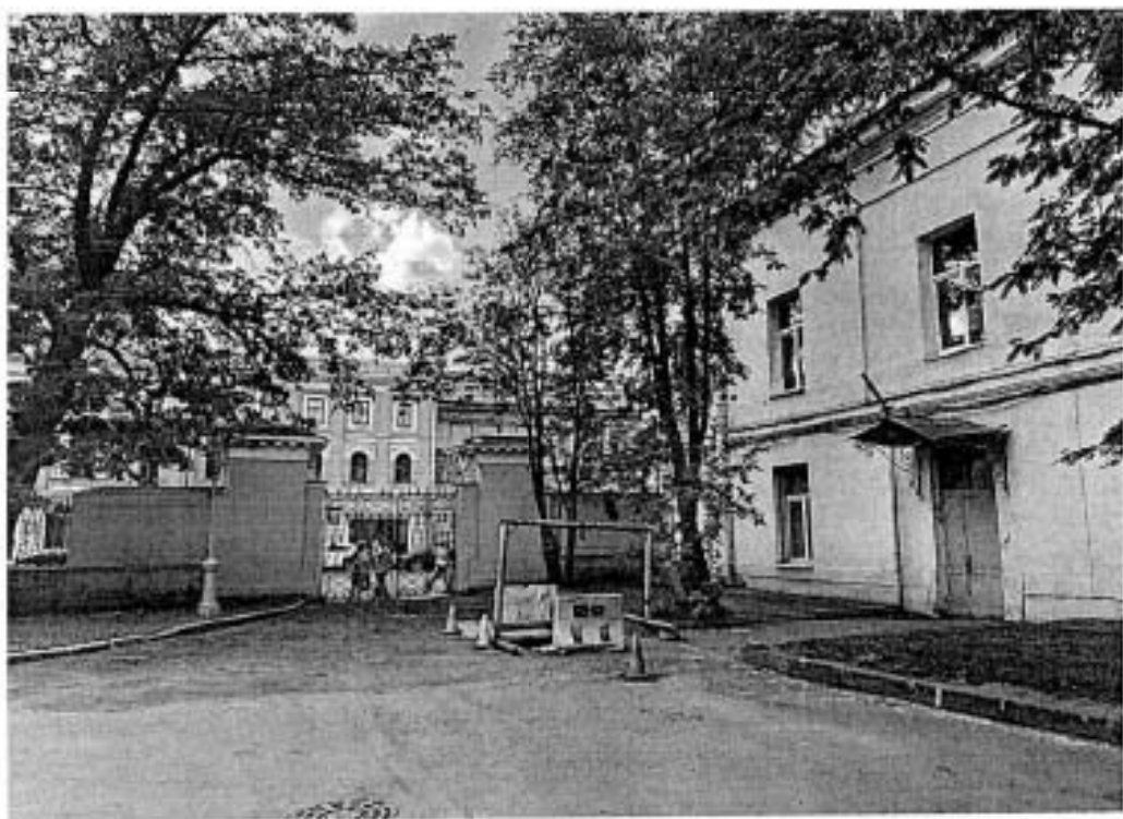
2. Дворовый фасад корпуса лит.Б
