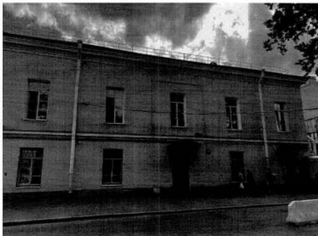
5. Фрагмент дворовых фасадов корпуса лит.В
