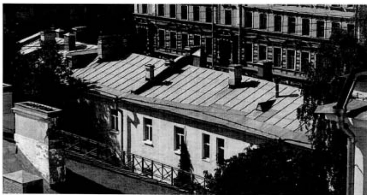
2. Крыша корпуса лит.Б
