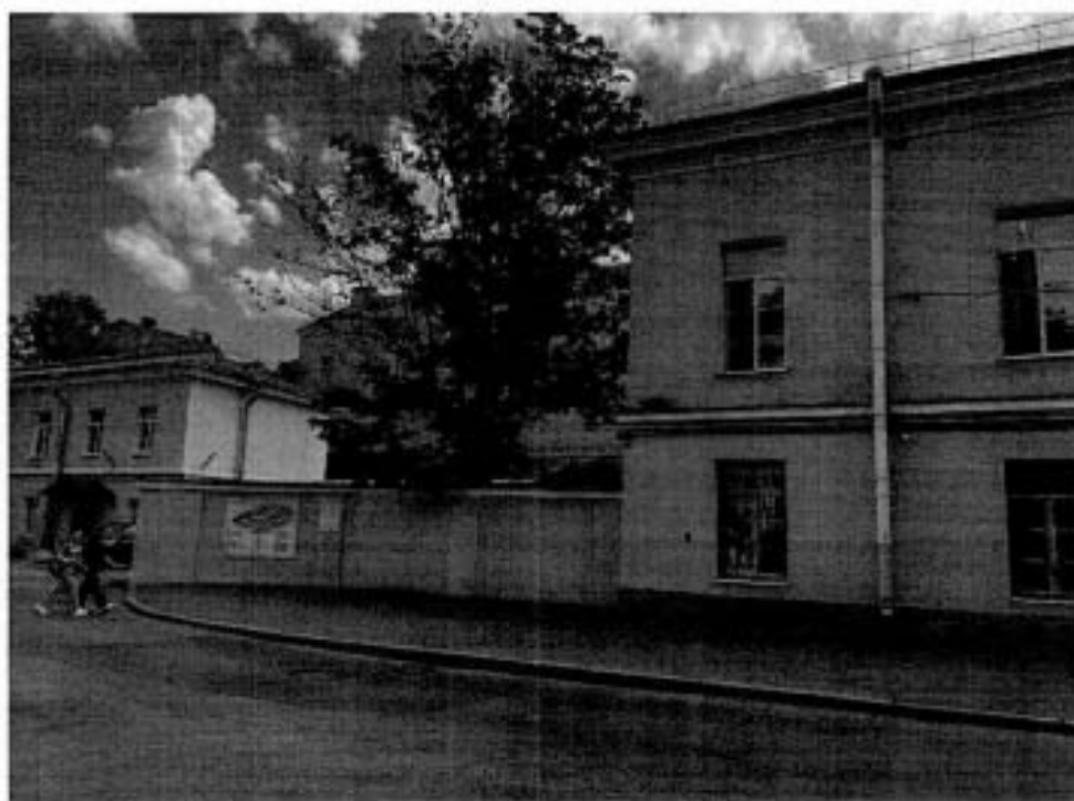
10. Ограда с южной стороны комплекса, примыкающая к боковому корпусу лит.В
