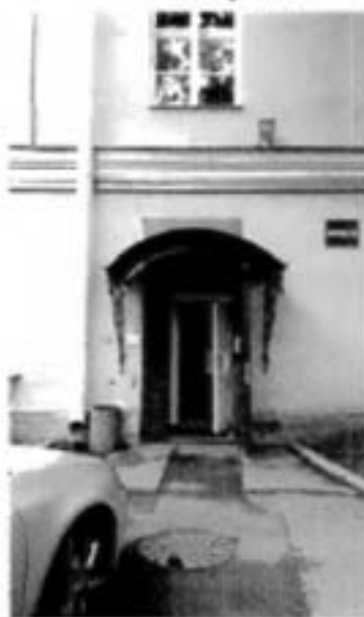
19. Вход с восточной стороны
