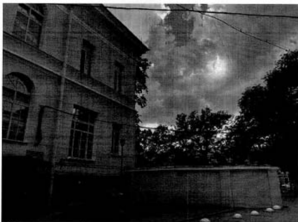
12. Ограда с северной стороны комплекса, примыкающая к Корпусу главному
