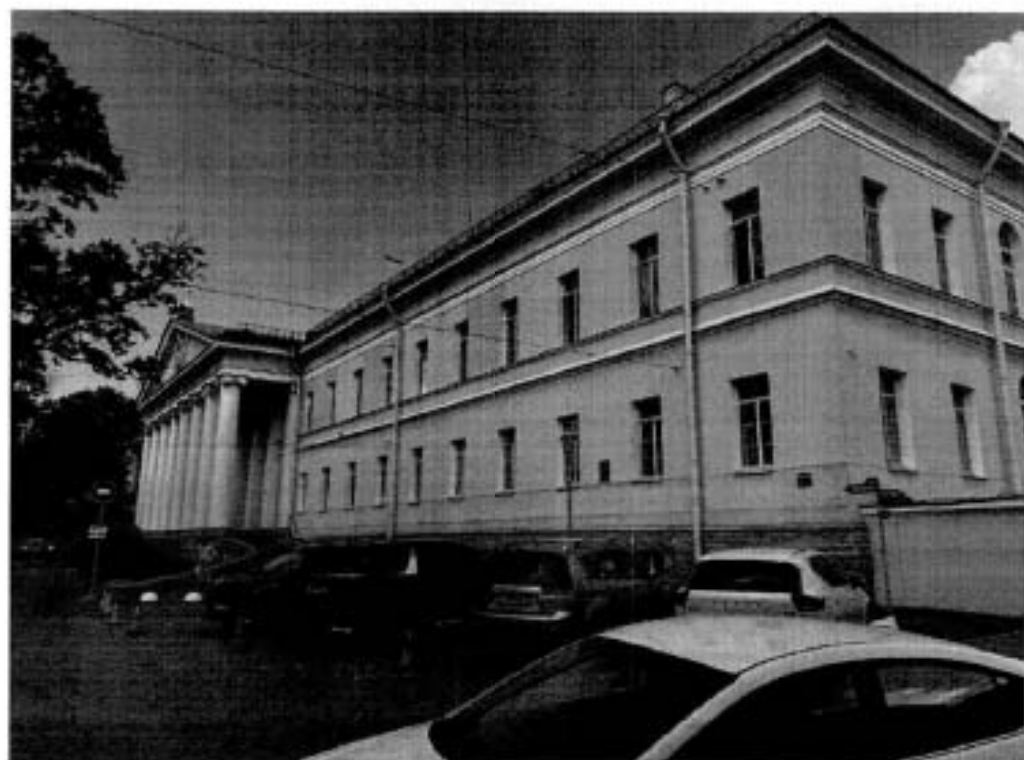
2. Фрагмент лицевого фасада по Литейному пр.
