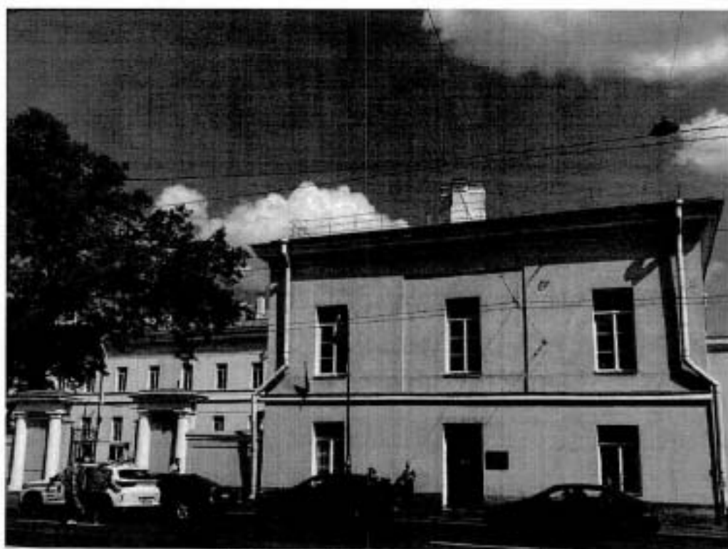
6. Лицевой фасад корпуса лит.В
