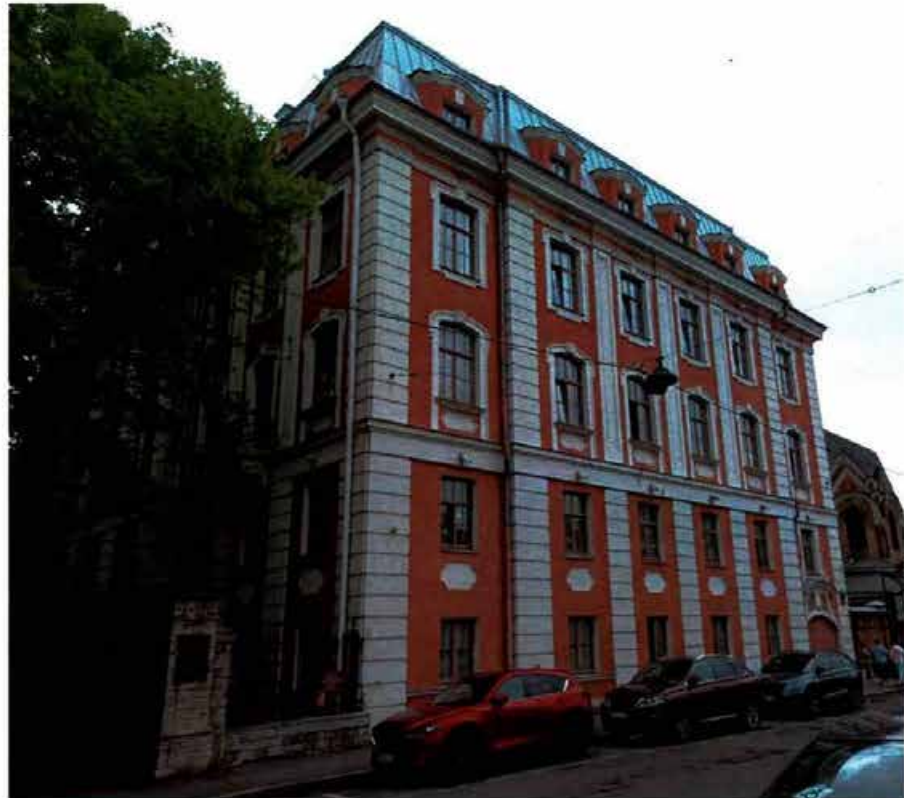
1. Общий вид западного фасада объекта культурного наследия.
