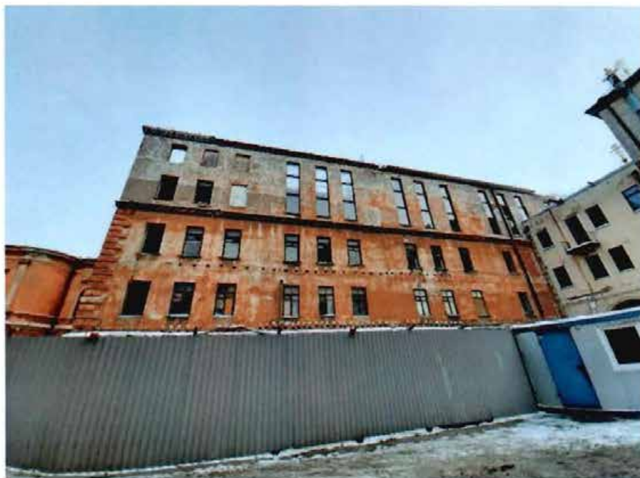
3. Вид на южный фасад объекта культурного наследия
