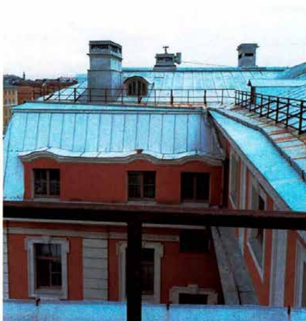
16. Кровля объекта культурного наследия.
