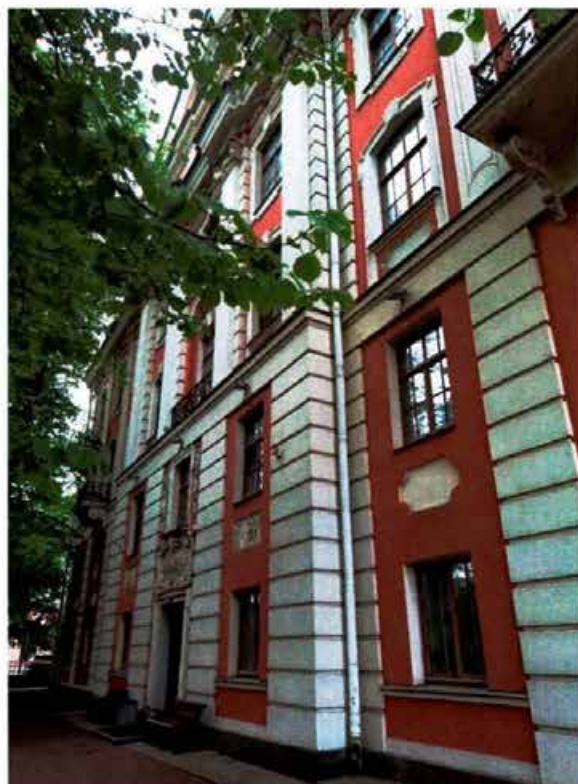
3. Общий вид северного фасада объекта культурного наследия.
