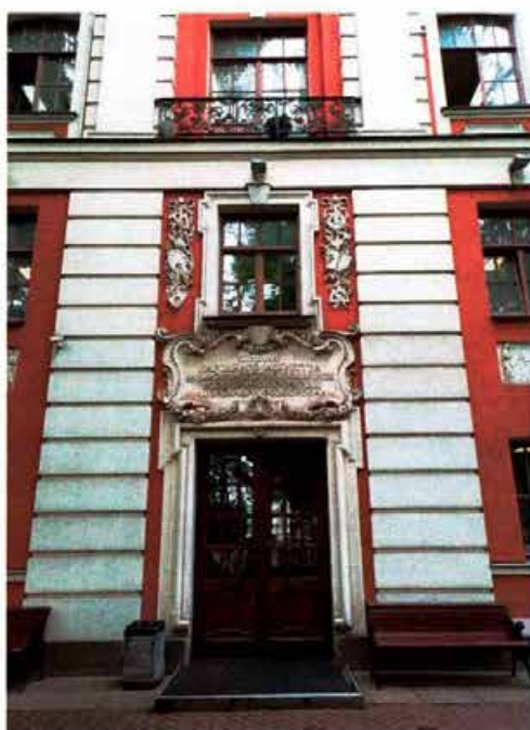
6. Фрагмент северного фасада объекта культурного наследия.
