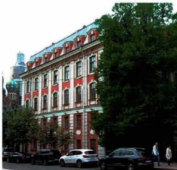
2. Общий вид восточного фасада объекта культурного наследия.
