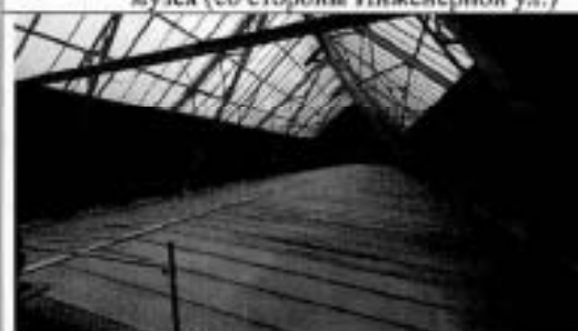
Фото 13. Фрагмент конструкций крыши (световой фонарь)
