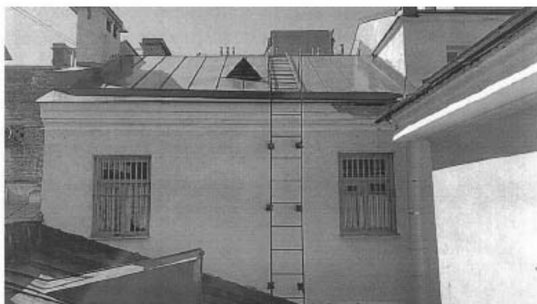
Фрагмент дворового фасада
