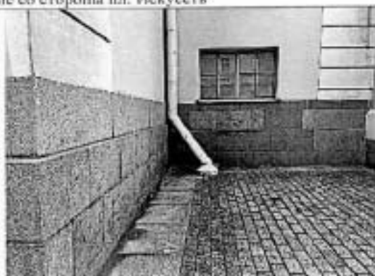
Фото 3. Фрагмент отделки фасада. Гранитный покров, отмостка, элемент водосточной системы
