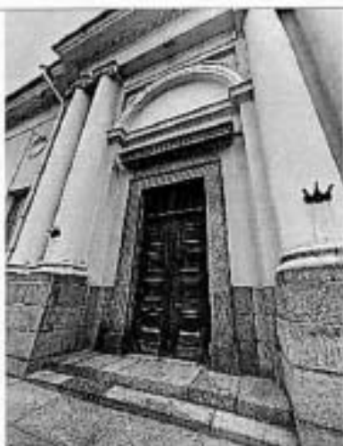
Фото 4. Фрагмент портала (по Инженерной ул.)
