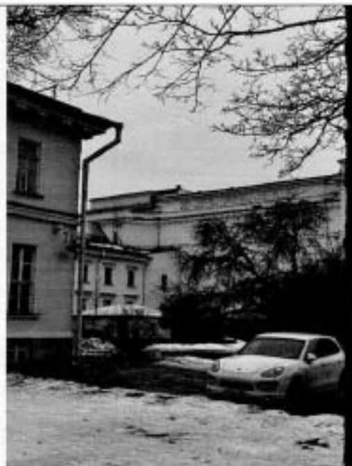
Фото 12. Фрагмент дворового фасада
