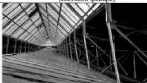
Фото 16. Фрагмент конструкций крыши (световой фонарь)
