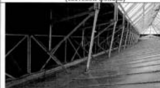
Фото 15. Фрагмент конструкций крыши (световой фонарь)
