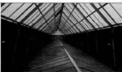
Фото 14. Фрагмент конструкций крыши (световой фонарь)
