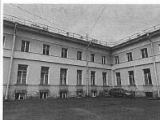
Фото 3. Фрагмент дворового фасада
