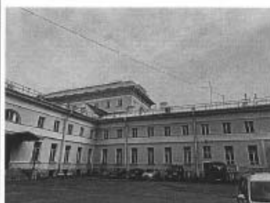
Фото 4. Фрагмент дворового фасада
