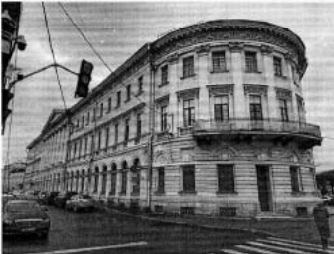
12. Общий вид на южный лицевой фасад и полукруглую часть (17.11.2021).
