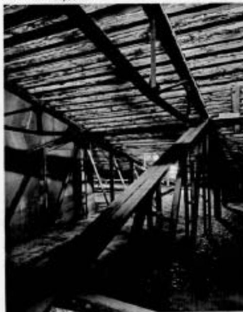
32. Металлические балки стропильной системы чердака.
