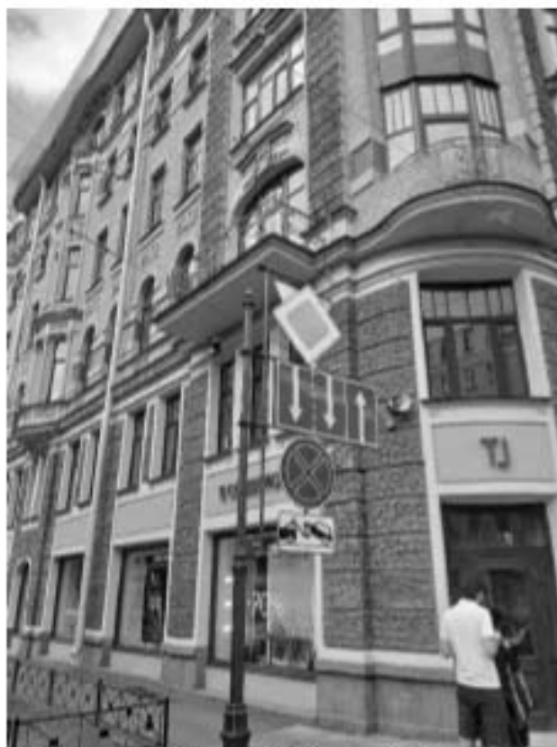
27. «Дом И.И. Круглова». Невский пр., д. 147, лит. А. Лицевой фасад по ул. профессора Ивашенцова (фрагмент). Фото мест установки оборудования и прокладки кабельных трасс. Штиглиц М.С. 05.08.2025.
