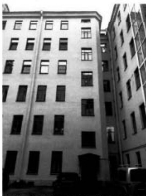
4. Северо-западный фасад южного двора объекта культурного наследия. Фото выполнено 22.03.2024.
