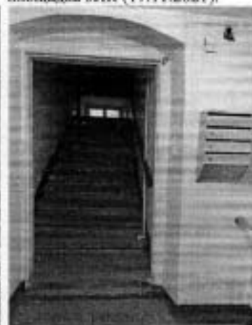
72. Промежуточная площадка 3ЛК (17.11.2021).
