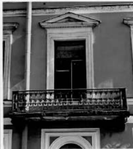
5. Западный фасад. Фрагмент. Балкон по 11-й световой оси.
