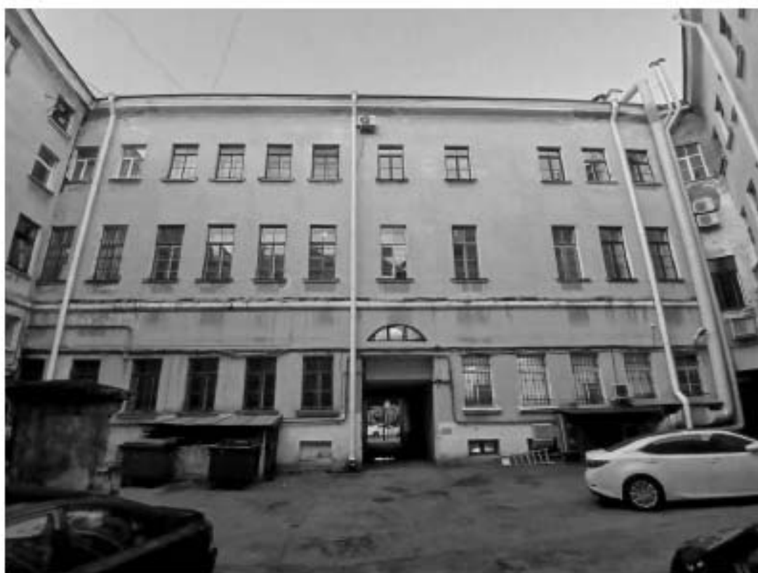
35. «Дом Антонова («Дом Аламини»)» (наб. реки Мойки, д. 1/8, лит. А). Дворовые фасады. Фото мест установки оборудования и прокладки кабельных трасс. Штиглиц М.С. 05.08.2025.
