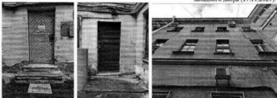
45. Фрагмент фасада западного двора (17.11.2021).
