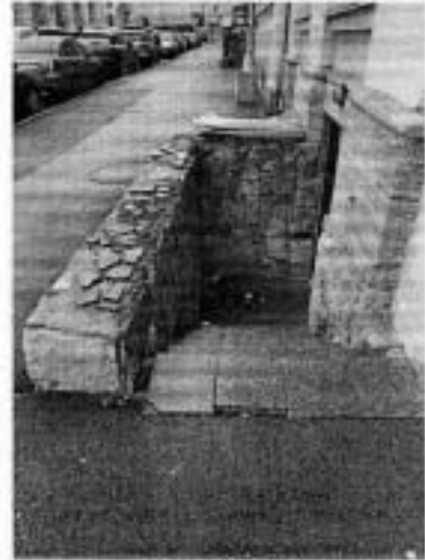
11. Приемок по западному лицевому фасаду (17.11.2021).
