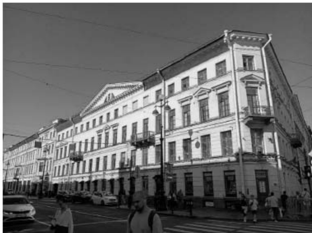
15. «Дом Чаплиных» (Невский пр., д. 13/9, лит. А). Лицевой фасад по ул. Большая Морская. Штиглиц М.С. 05.08.2025.
