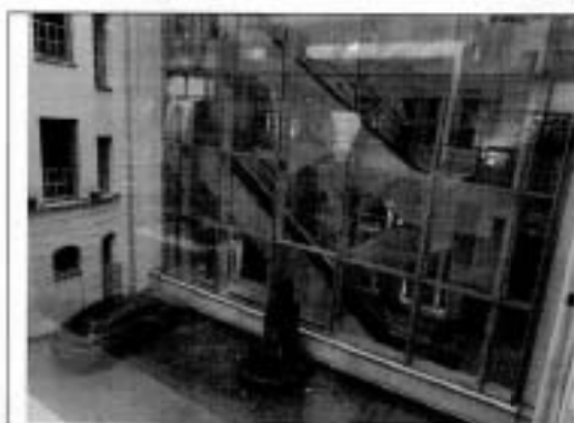
5. Фрагмент дворового фасада с фонтаном
