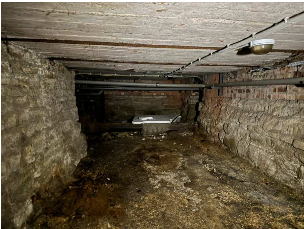
Фото 17. Вид на подвальное помещение объекта культурного наследия.
