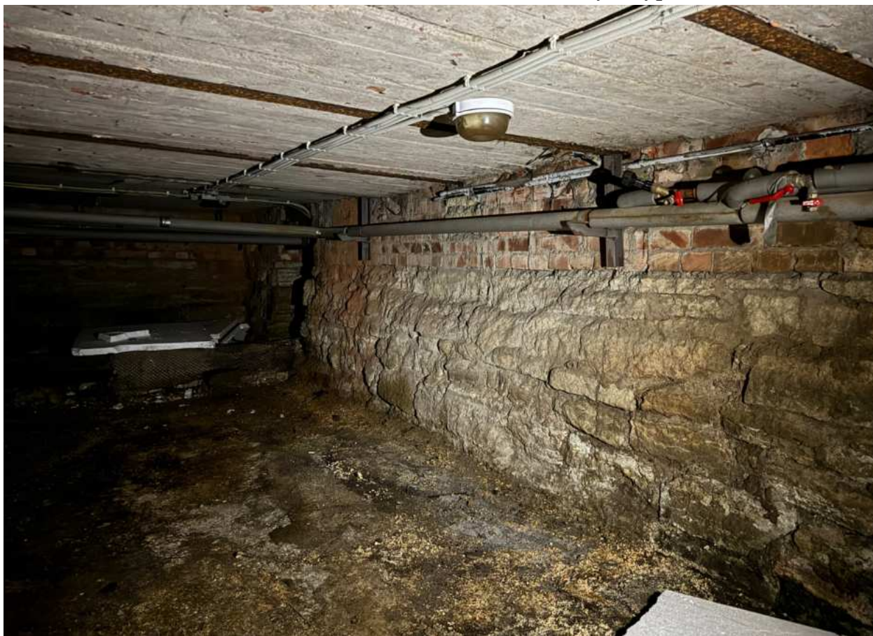
Фото 18. Вид на подвальное помещение объекта культурного наследия.
