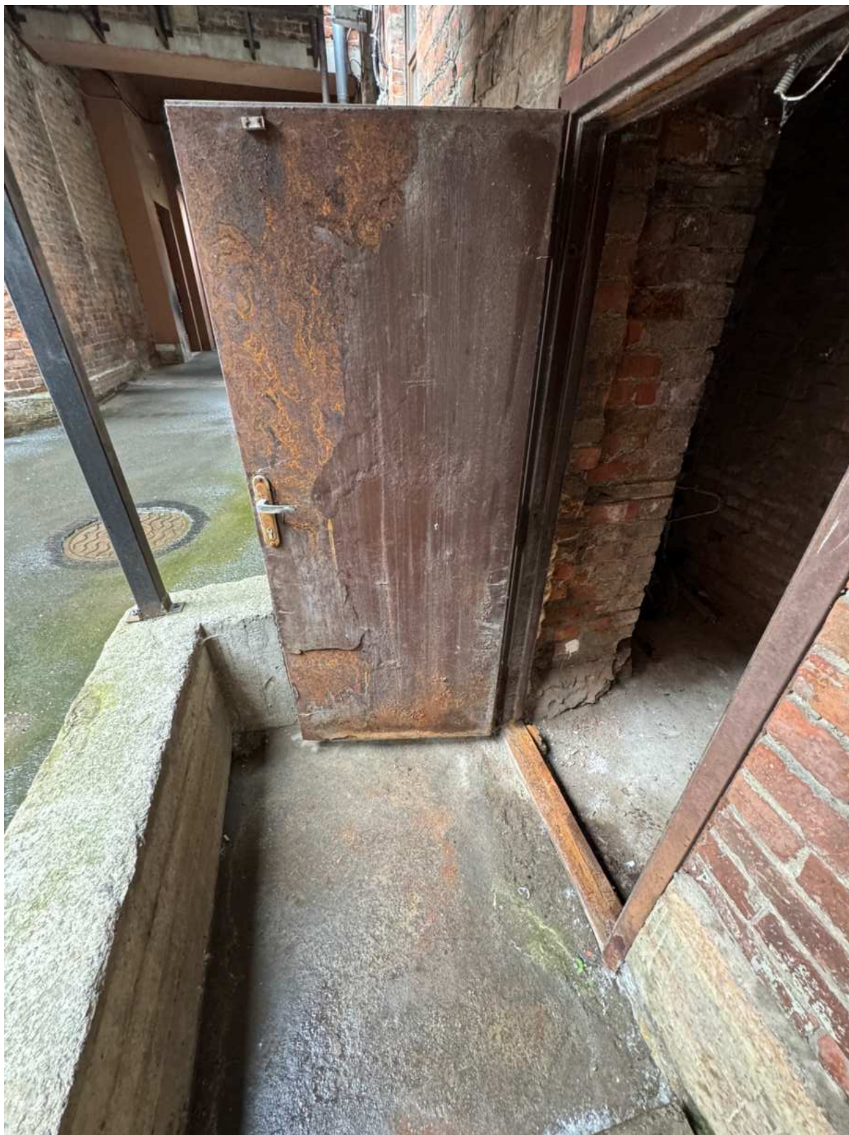
Фото 16. Вход в подвальное помещение объекта культурного наследия.
