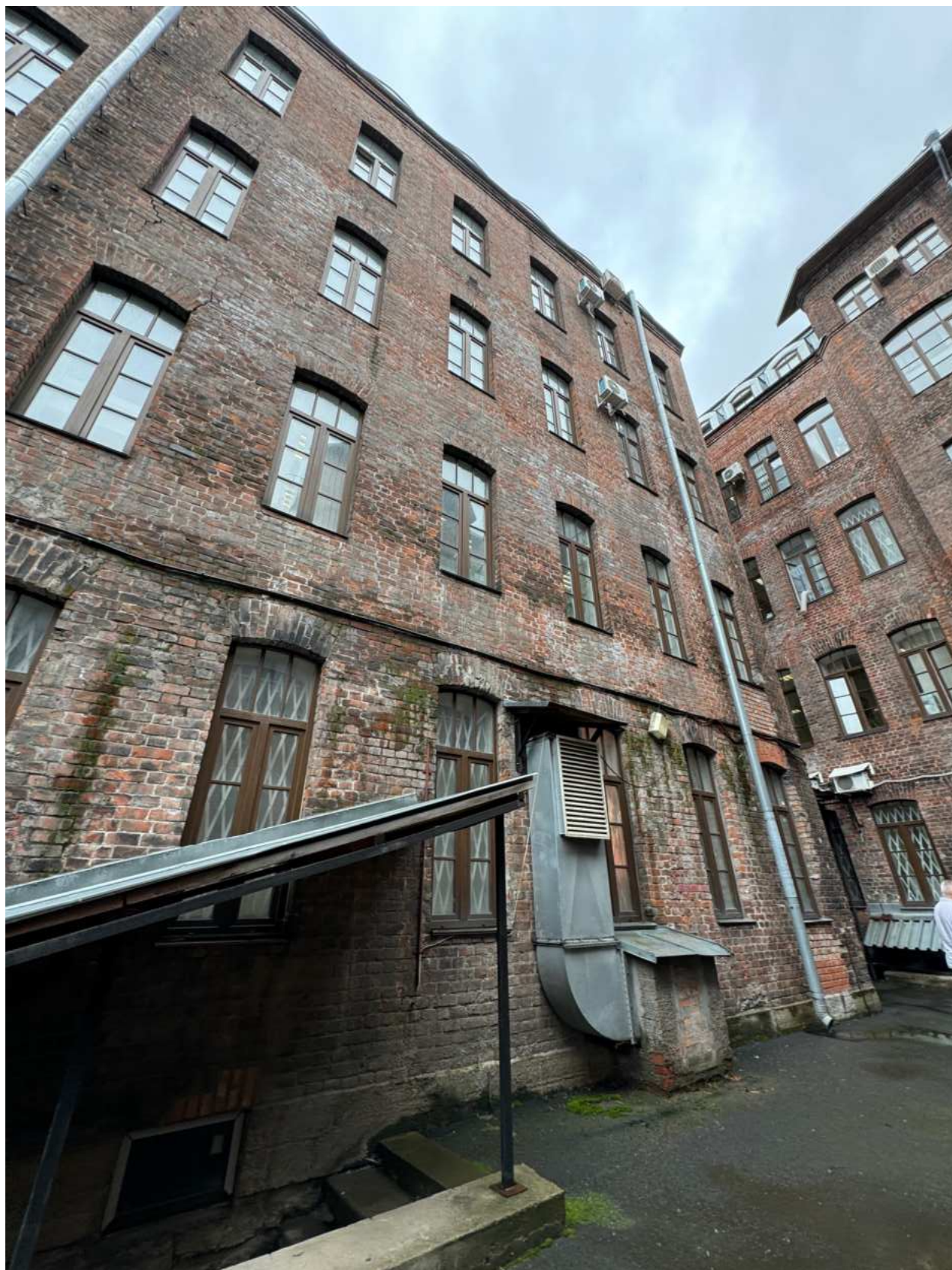
Фото 13. Общий вид дворовых фасадов объекта культурного наследия.
