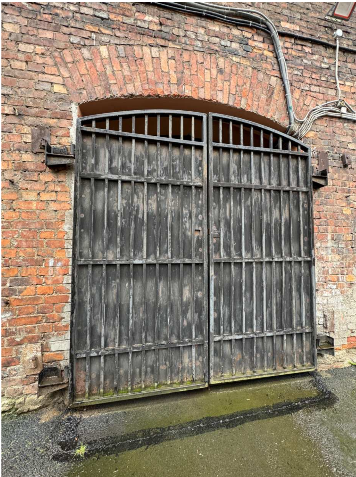
Фото 5. Воротное заполнение в части брандмауэрной стены объекта культурного наследия с проезда от Бобруйской улицы.
