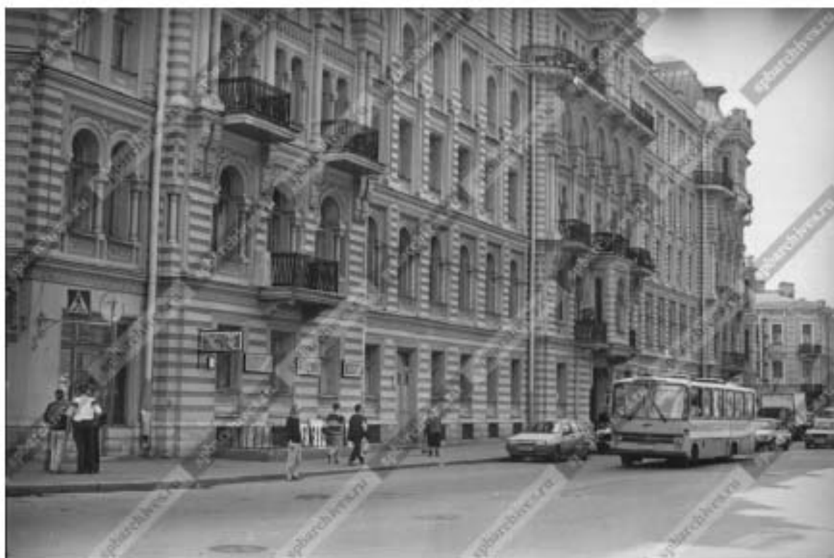
35. Вид на главный фасад Дома Мурузи (Литейный проспект, 24) со стороны ул. Пестеля, 1996 г. Источник: ЦГАКФФД СПб. Описание 1АР-204. Ед.хр.264803
