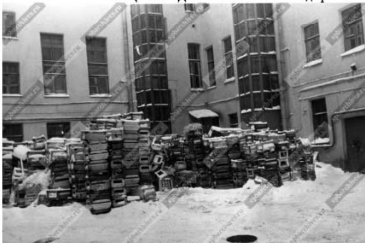
32. Вид части территории черного двора-колодца дома Мурузи (ул.Пестеля 27, угол Литейного пр.,24), где жил поэт И.Ф. Бродский. Дата: 1968 г. Источник: ЦГАКФФД СПб. Описание 1АР-151. Ед.хр.208720
