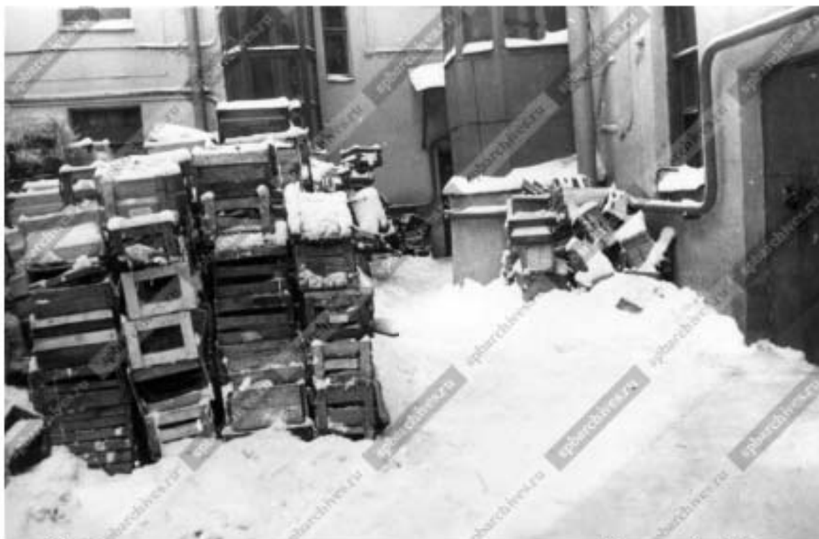
31. Один из уголков черного двора-колодца дома Мурузи (ул.Пестеля 27, угол Литейного пр.,24), где жил поэт И.А.Бродский. Дата: 1968 г. Источник: ЦГАКФФД СПб. Описание 1АР-151. Ед.хр.208722
