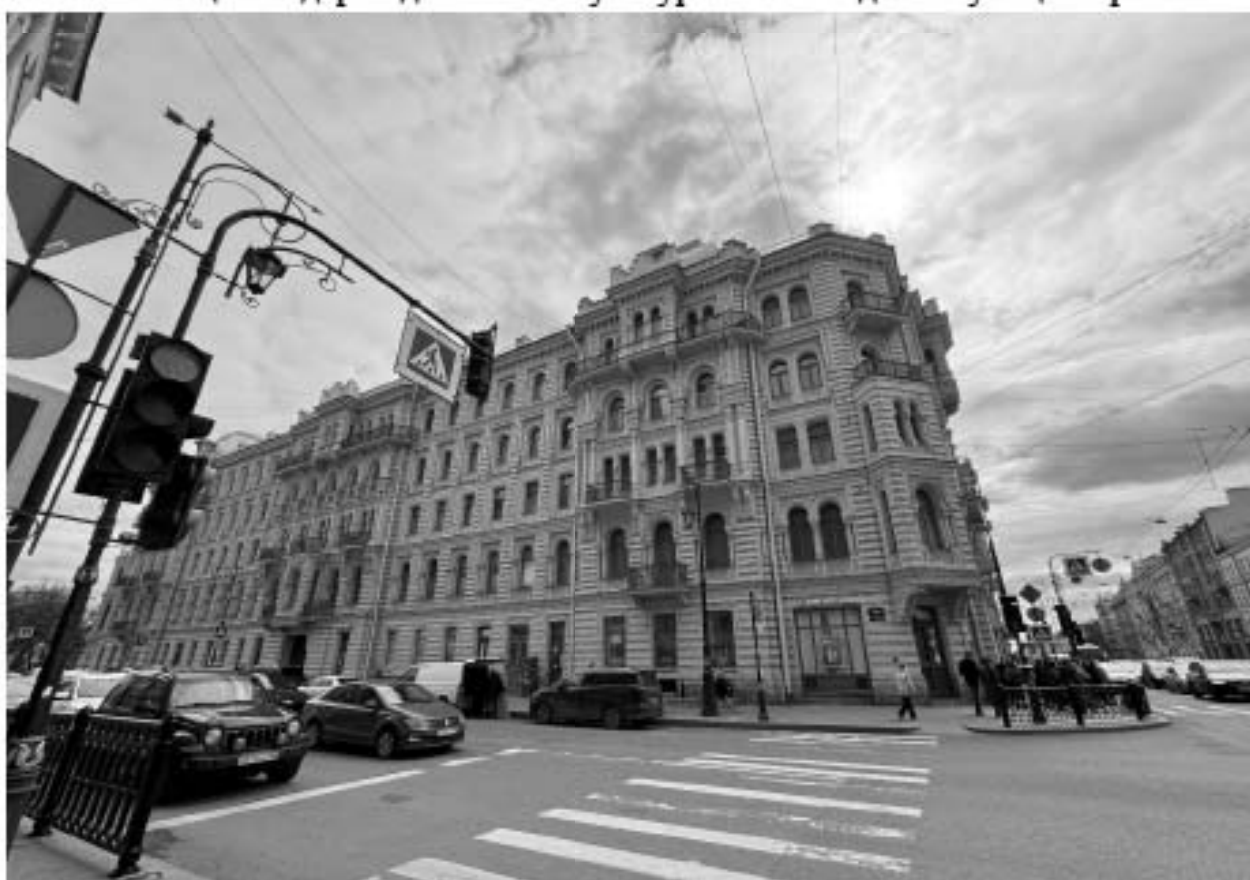
Фото 4. Общий вид фасада объекта культурного наследия по улице Пестеля.
