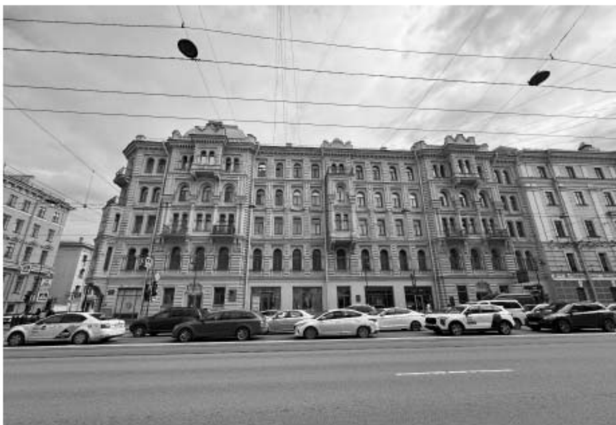
Фото 5. Общий вид фасада объекта культурного наследия по Литейному проспекту.
