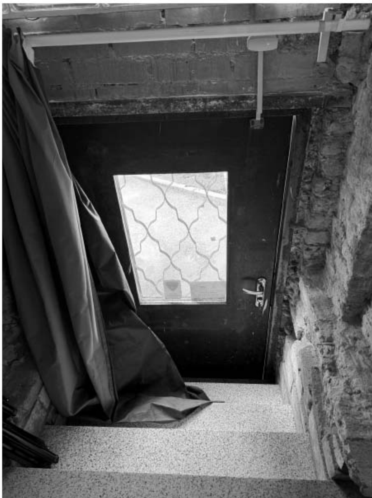
Фото 9. Вход со двора в помещение 35-Н объекта культурного наследия.
