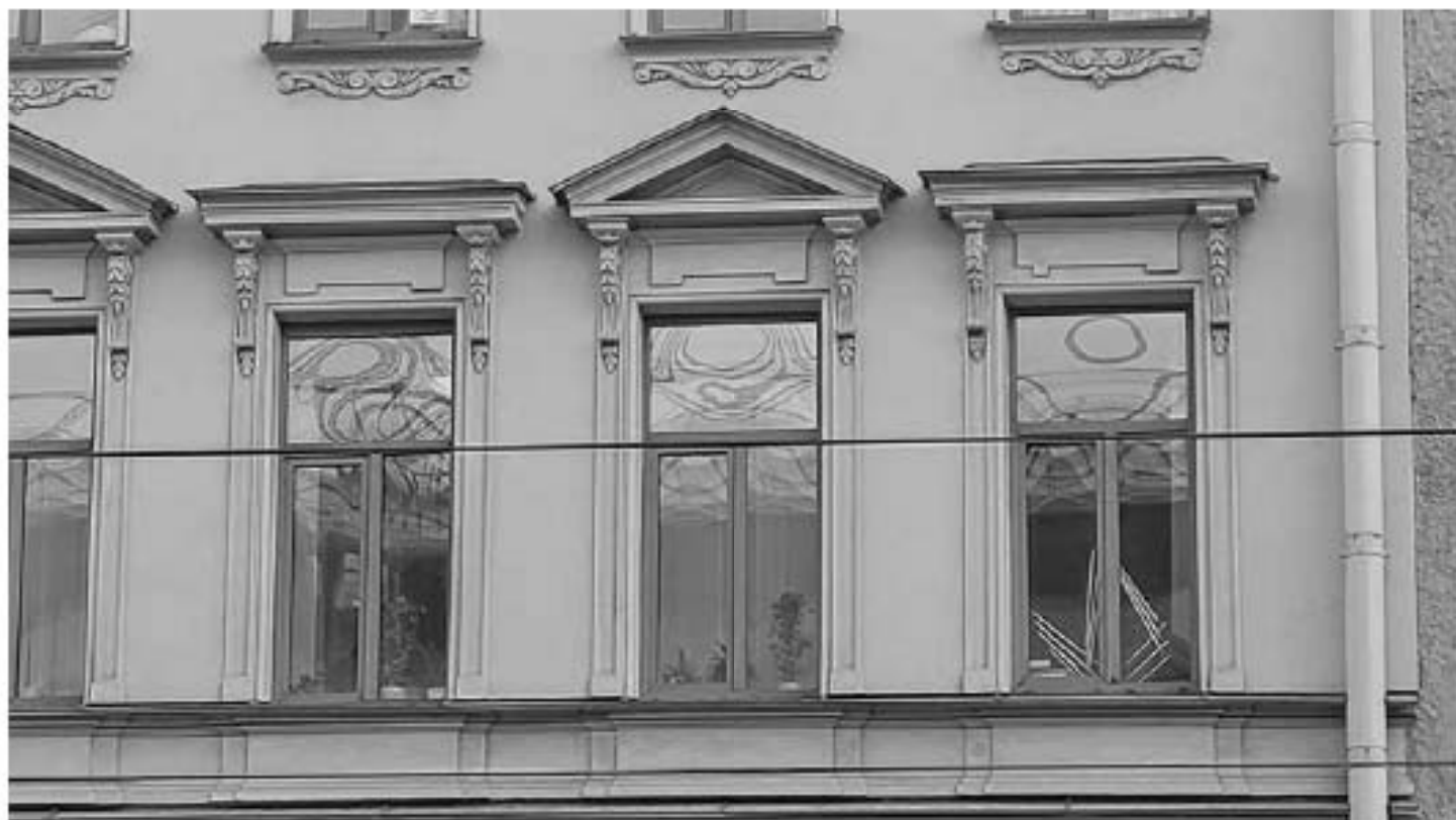
Фото 4. Уровень 3-го этажа лицевого фасада (западного флигеля). Чередующиеся треугольные и линейные сандрики на волютообразных кронштейнах, декорированных лепными растительными элементами. Фрагмент. Дата фотофиксации: 18.03.25
