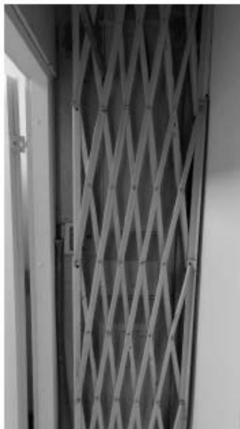
Фото 294. Тамбур между помещением 20 и площадкой лестницы Л1. Фрагмент. Дата фотофиксации: 18.03.25
