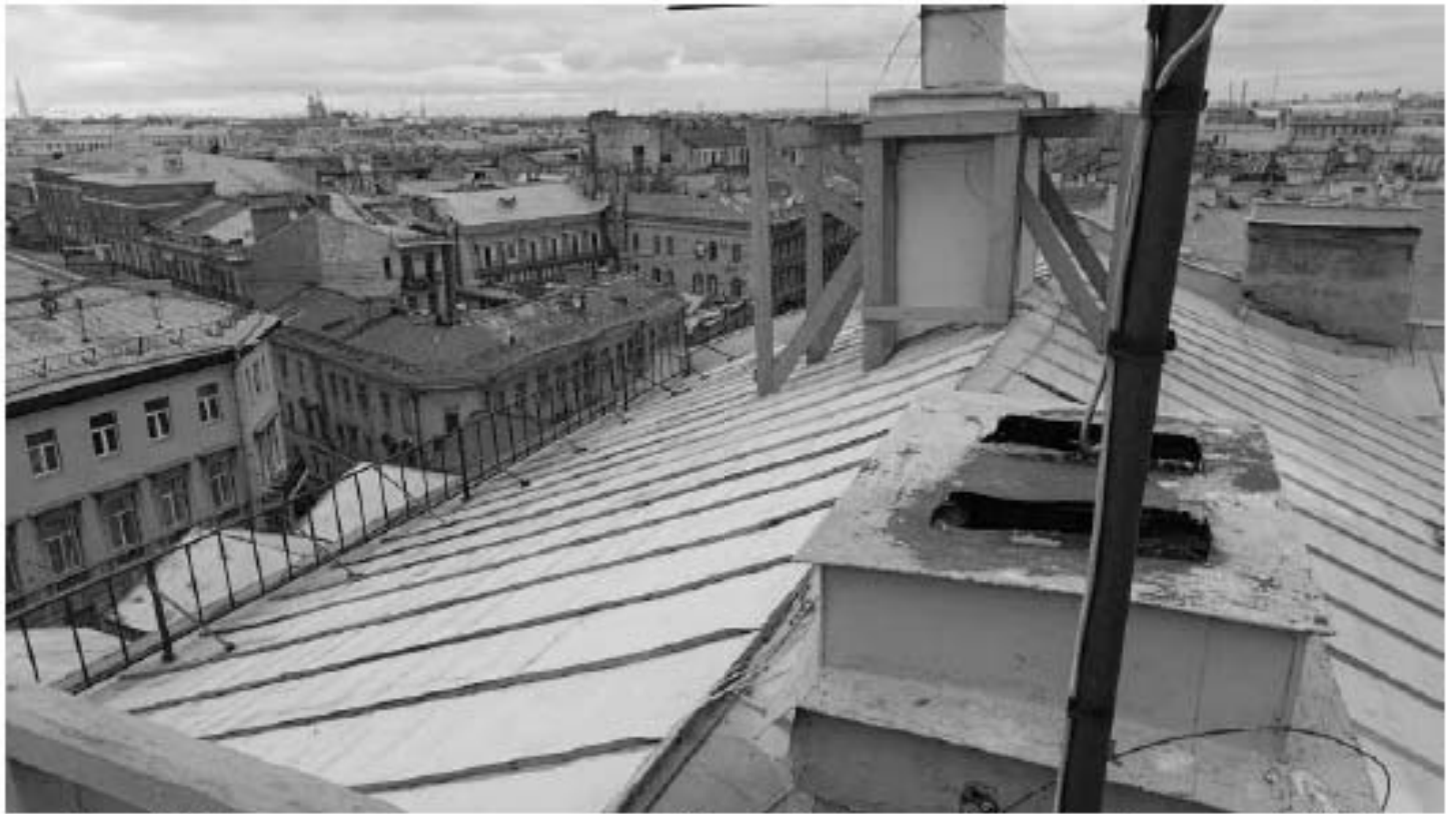
Фото 57. Скатная крыша западного корпуса (флигеля). Фрагмент. Дата фотофиксации: 18.03.25
