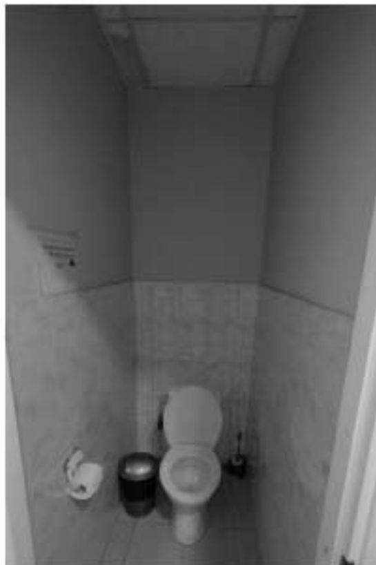
Фото 313. Помещение 27. Общий вид. Дата фотофиксации: 18.03.25
