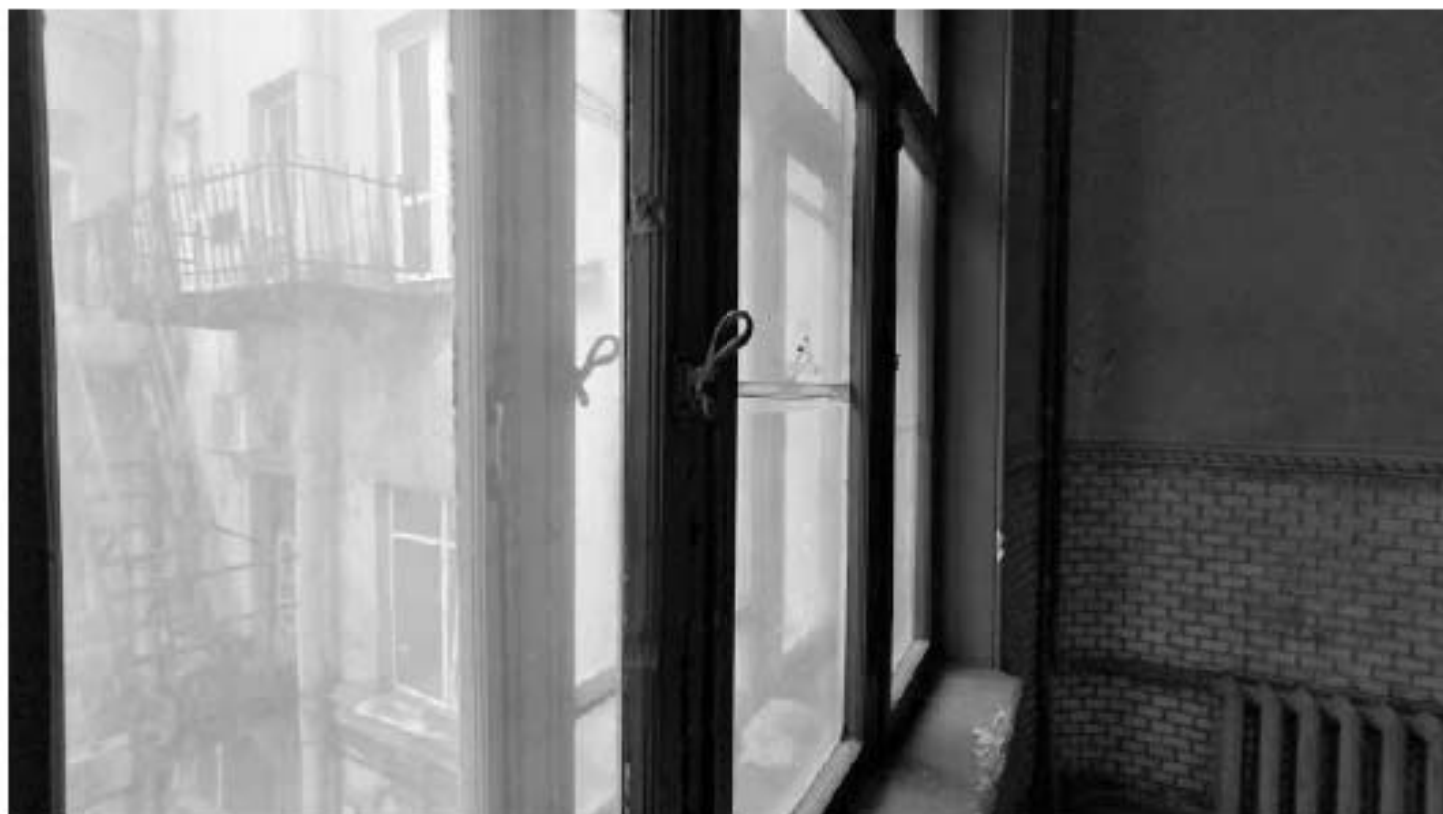
Фото 168. Исторические шпингалеты стержневые в межэтажном пространстве 2-го и 3-го этажей. Фрагмент. Дата фотофиксации: 18.03.25
