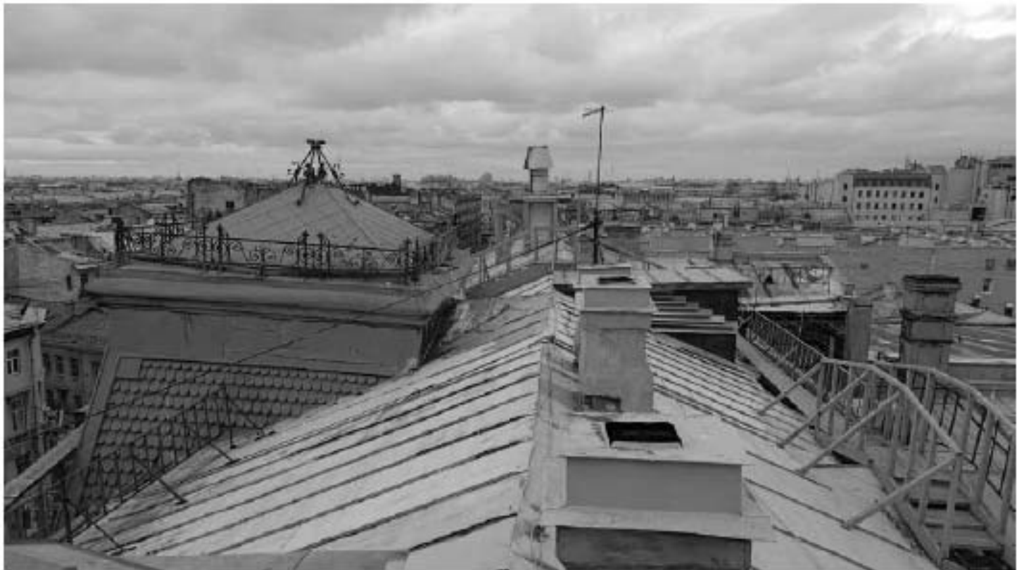
Фото 60. Четырёхскатный шатёр по центральной оси лицевого фасада западного корпуса (флигеля). Фрагмент. Дата фотофиксации: 18.03.25
