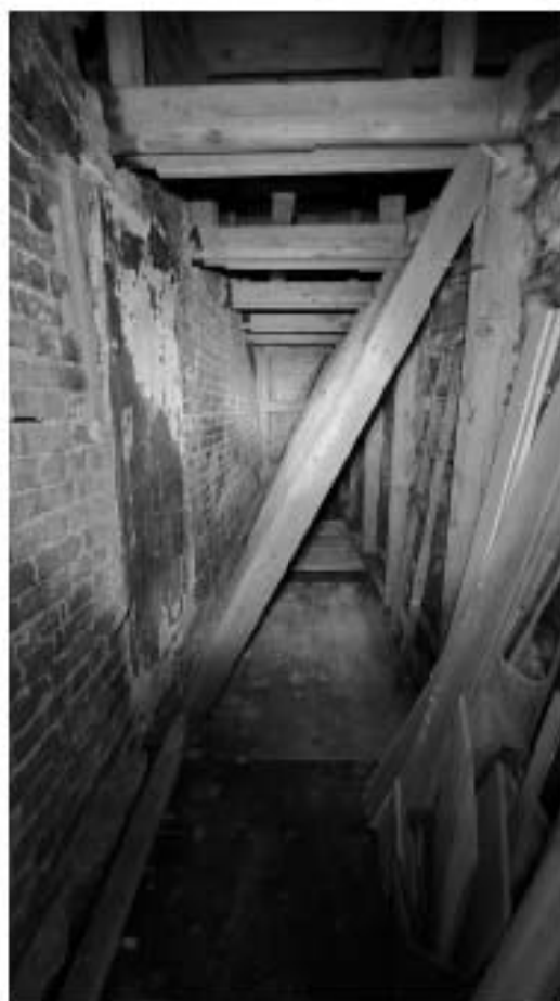
Фото 247. Пространство помещения 18. Фрагмент. Дата фотофиксации: 18.03.25
