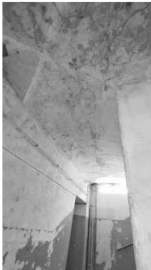
Фото 338. Фрагменты крестовых сводов в уровне 2-го этажа. Дата фотофиксации: 18.03.25
