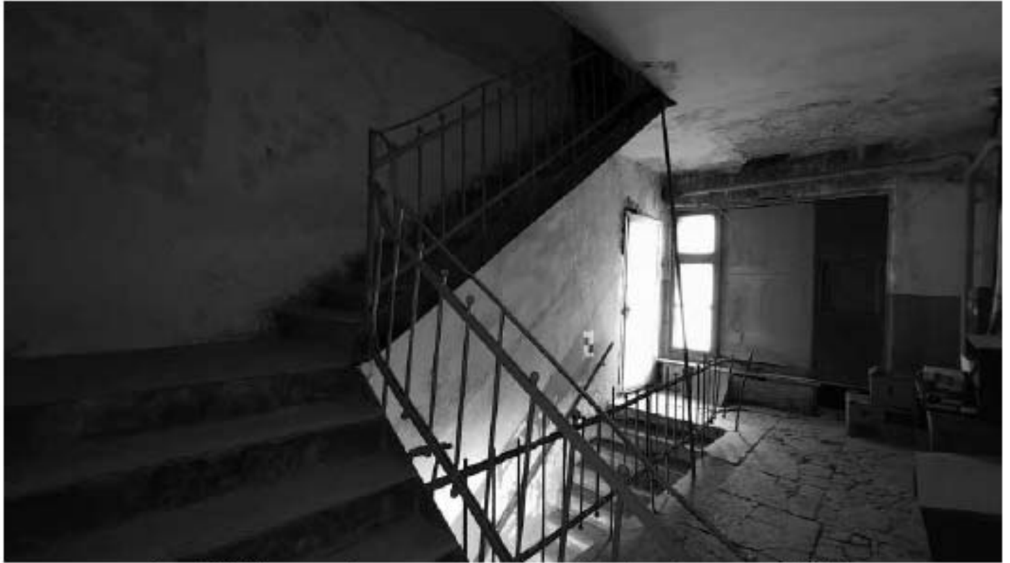
Фото 352. Площадка 4-го этажа. Общий вид. Дата фотофиксации: 18.03.25
