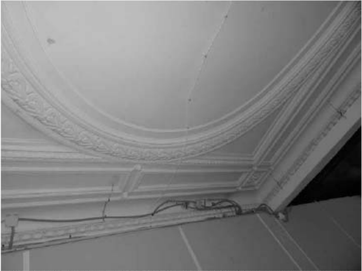
Фото 421. Художественная отделка потолка. Помещение 12 (16-Н). Фрагмент. Дата фотофиксации: 18.03.25
