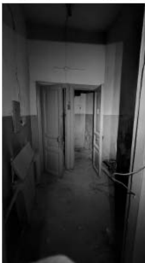
Фото 526. Помещение 5 (41-Н). Общий вид. Дата фотофиксации: 18.03.25
