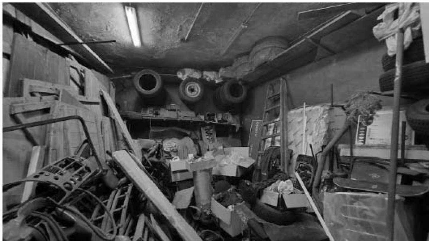
Фото 100. Помещение 2. Общий вид. Дата фотофиксации: 18.03.25
