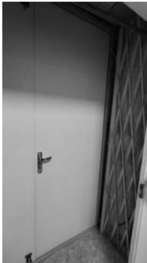
Фото 292. Тамбур между помещением 20 и площадкой лестницы Л1. Фрагмент. Дата фотофиксации: 18.03.25
