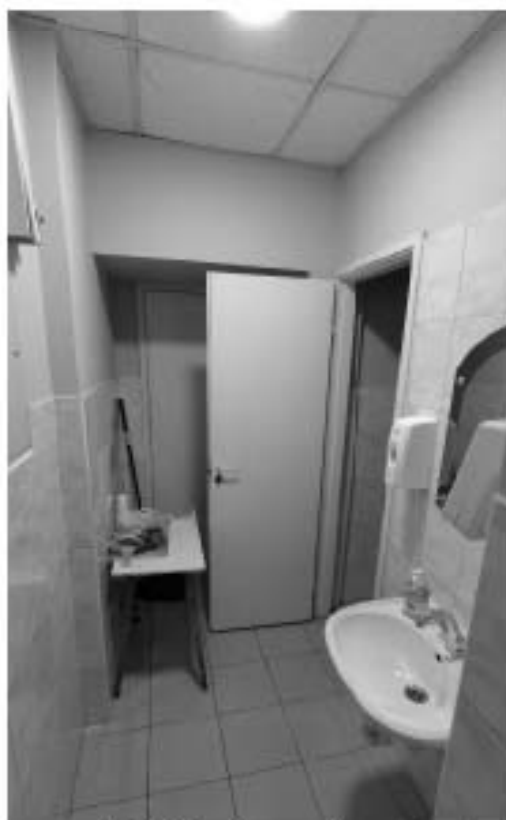
Фото 312. Помещение 24. Общий вид. Дата фотофиксации: 18.03.25
