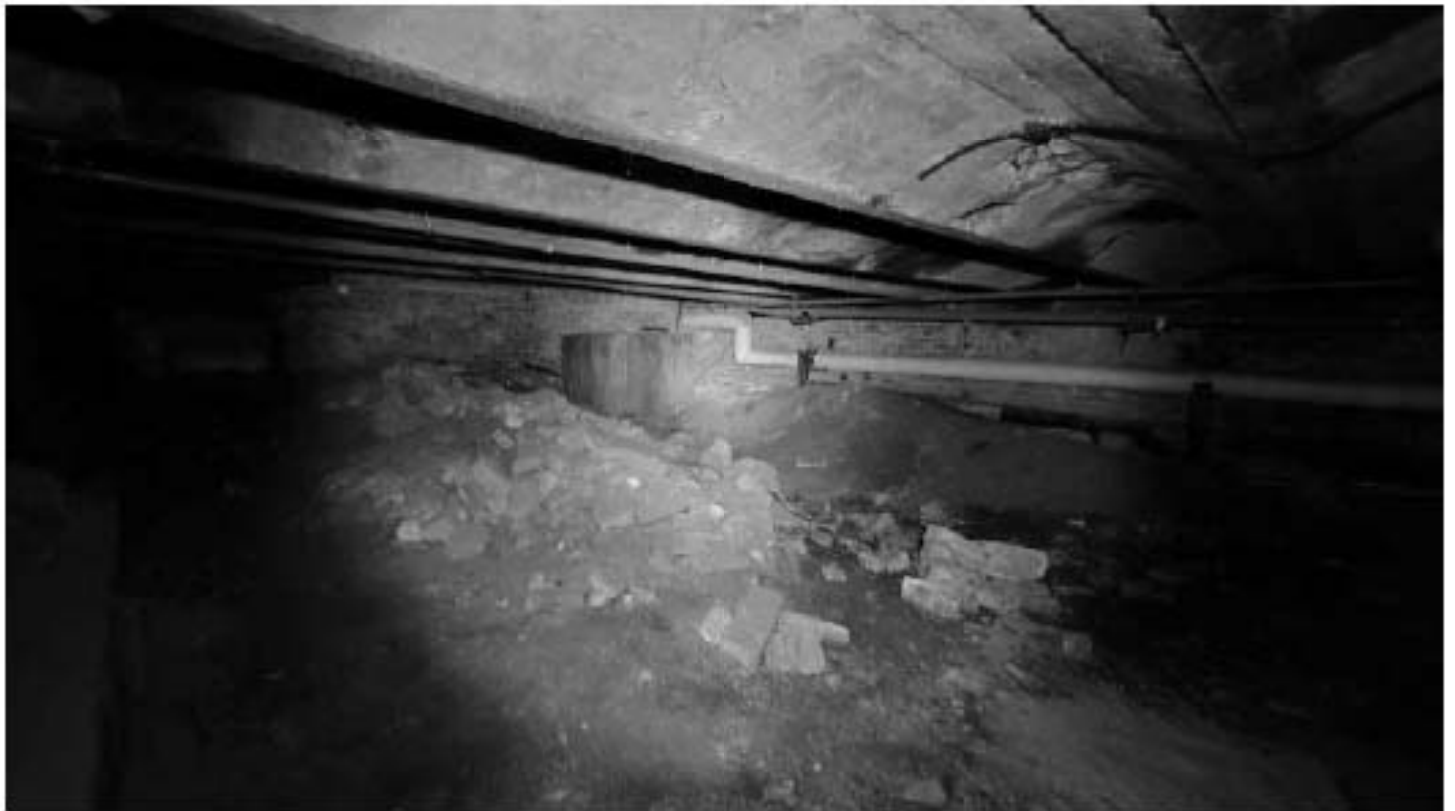
Фото 86. Помещение 1 (33-Н). Прусские своды. Фрагмент. Дата фотофиксации: 14.08.25
