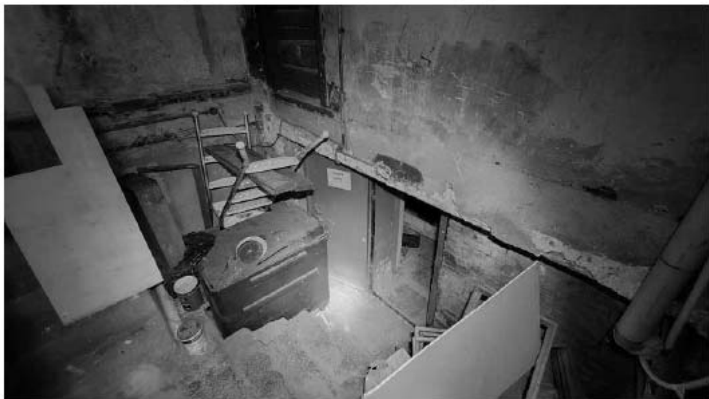
Фото 64. Объем служебной лестницы Л6. Фрагмент. Дата фотофиксации: 18.03.25
