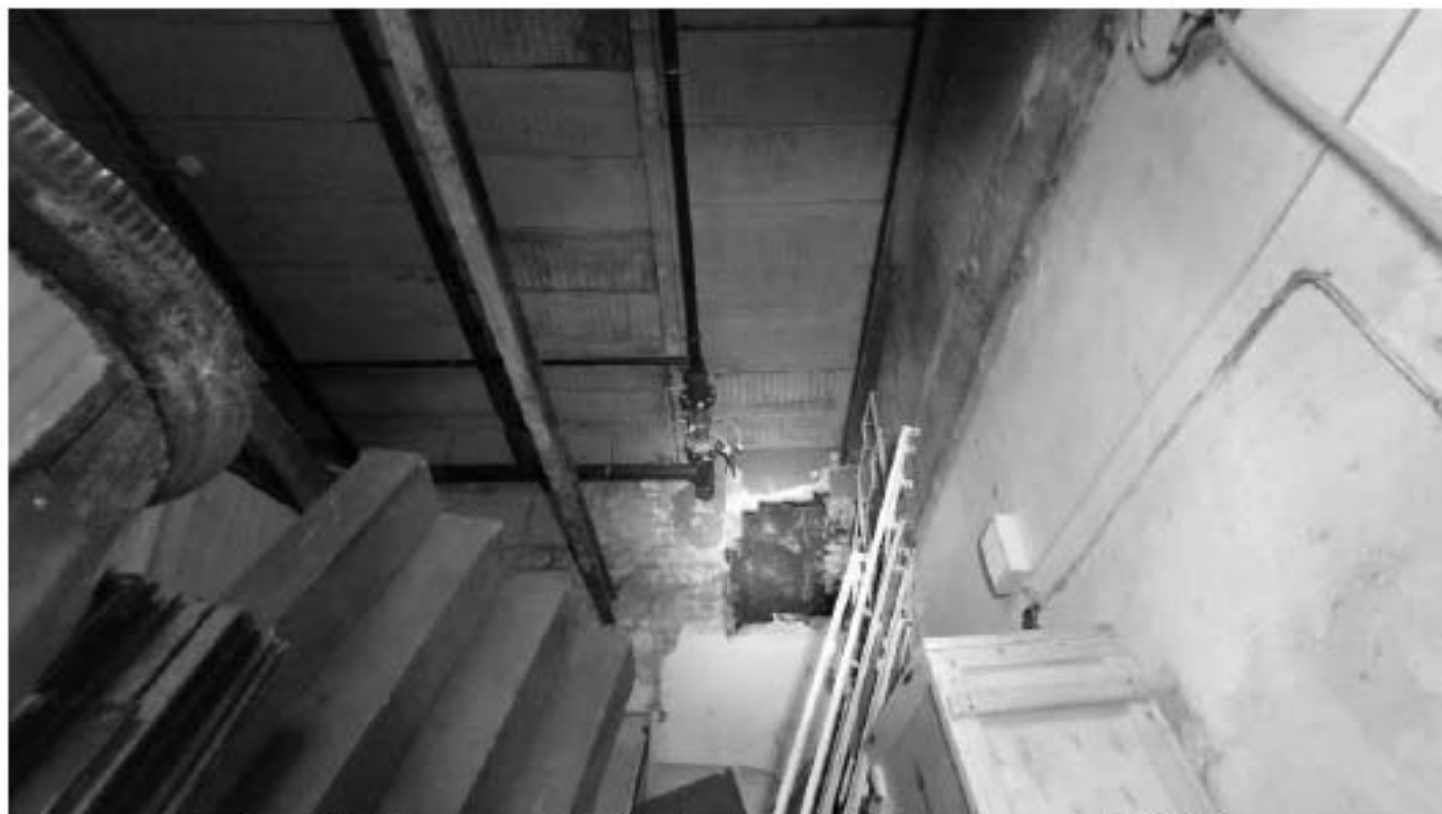
Фото 504. Помещение 1 (45-Н). Фрагмент. Дата фотофиксации: 18.03.25
