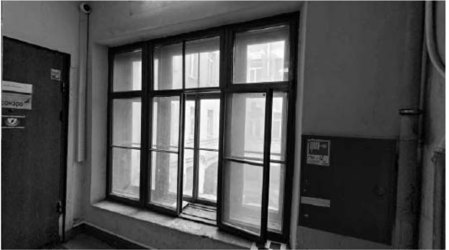
Фото 342. Оконное заполнение в уровне 2-го этажа. Общий вид. Дата фотофиксации: 18.03.25
