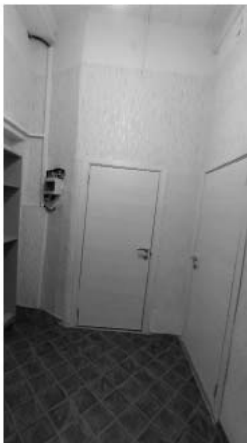
Фото 272. Помещение 4 (26-Н). Общий вид. Дата фотофиксации: 18.03.25
