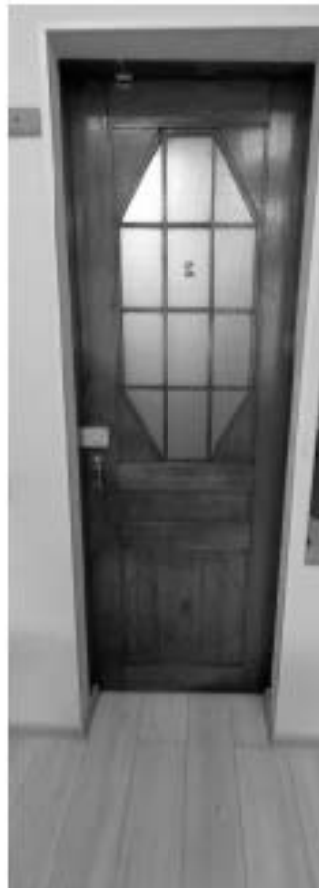
Фото 315. Историческое деревянное дверное заполнение в характере модерна: дверь одностворная, полусветлая, в нижней части глухая филенка с усеченными углами с овальной розеткой в технике маркетри. Общий вид со стороны помещения 18 (21-Н). Дата фотофиксации: 18.03.25
