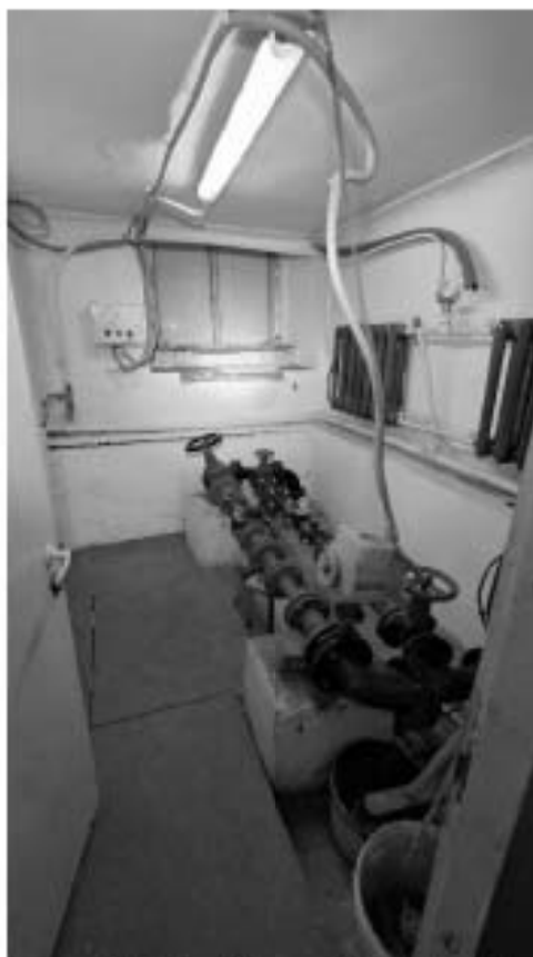
Фото 73. Помещение 6. Общий вид. Дата фотофиксации: 18.03.25
