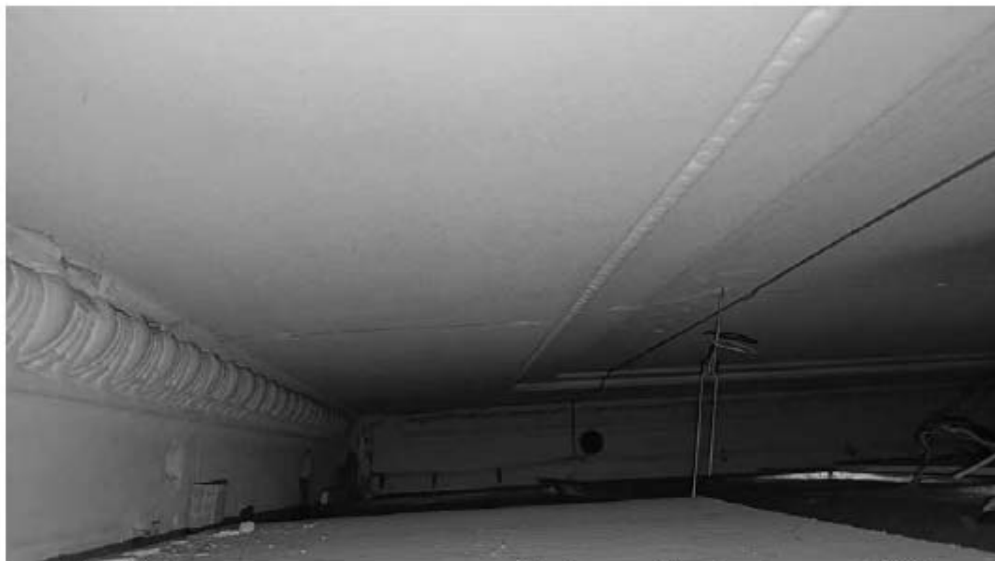
Фото 303. Тяги с лепным декором в помещении 17. Фрагмент. Дата фотофиксации: 18.03.25
