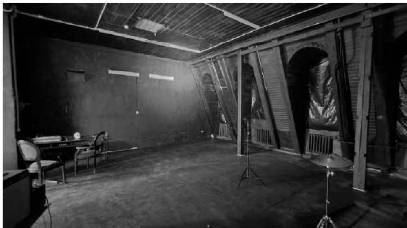
Фото 264. Помещение 2. Фрагмент. Дата фотофиксации: 18.03.25
