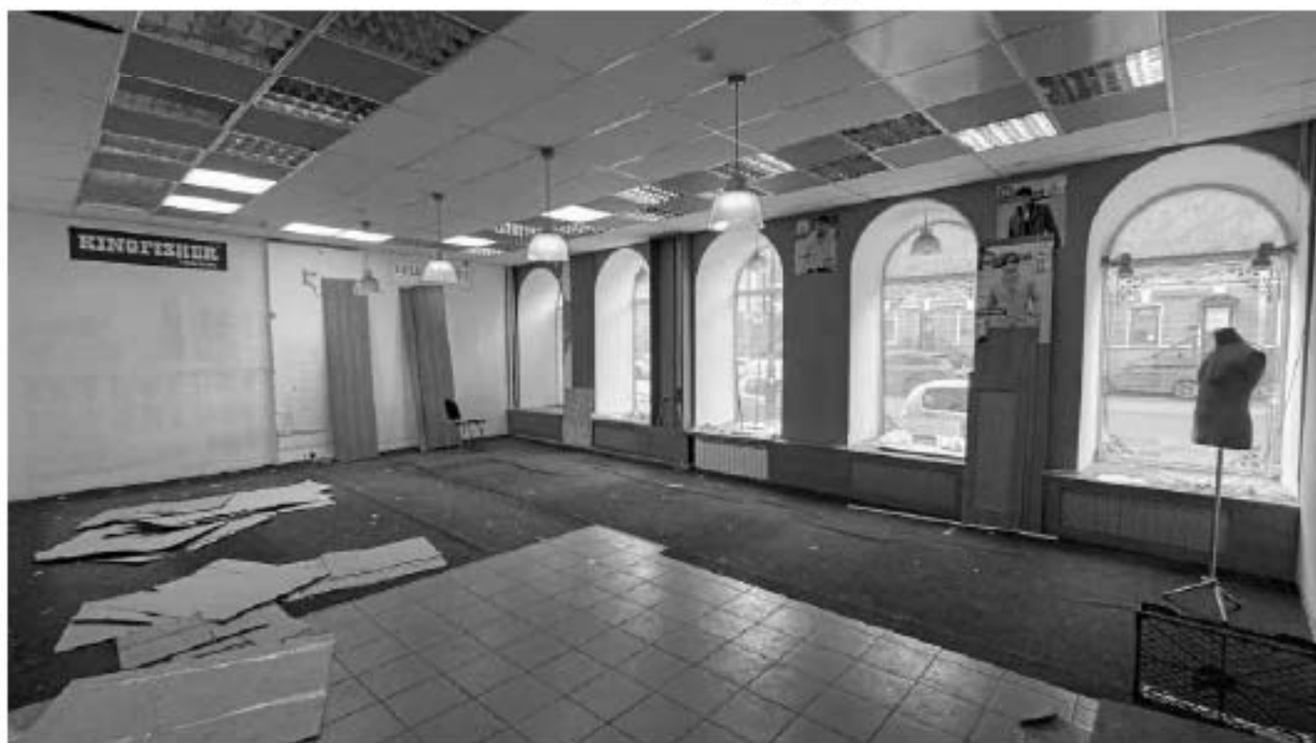
Фото 91. Помещение 1. Общий вид. Дата фотофиксации: 18.03.25
