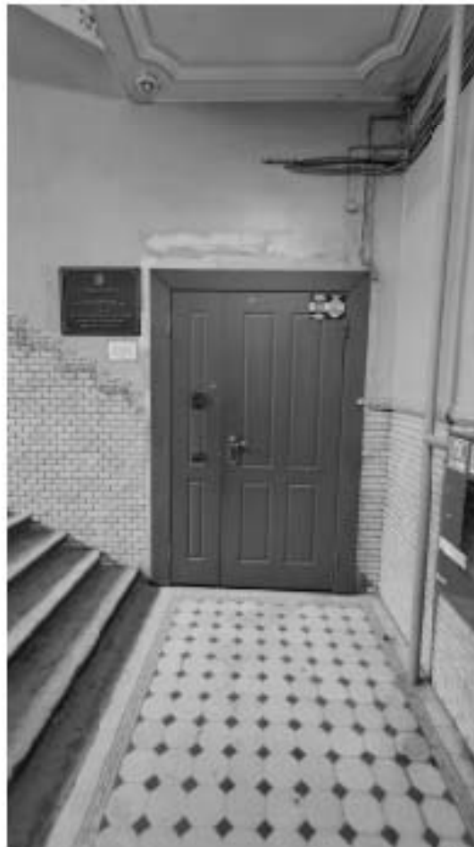
Фото 172. Современное дверное заполнение в уровне 3-го этажа. Общий вид. Дата фотофиксации: 18.03.25
