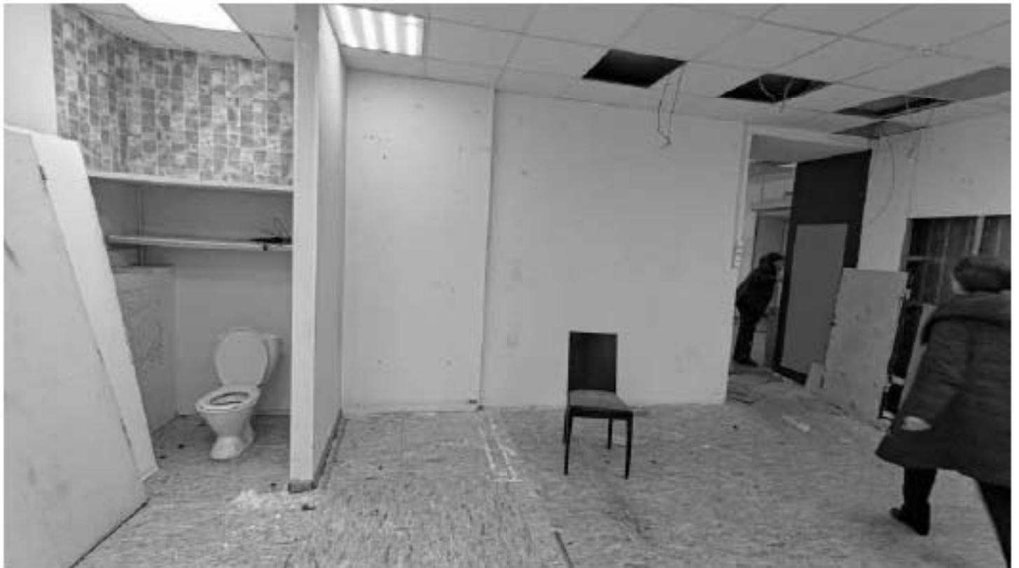
Фото 93. Помещение 2. Фрагмент. Дата фотофиксации: 18.03.25
