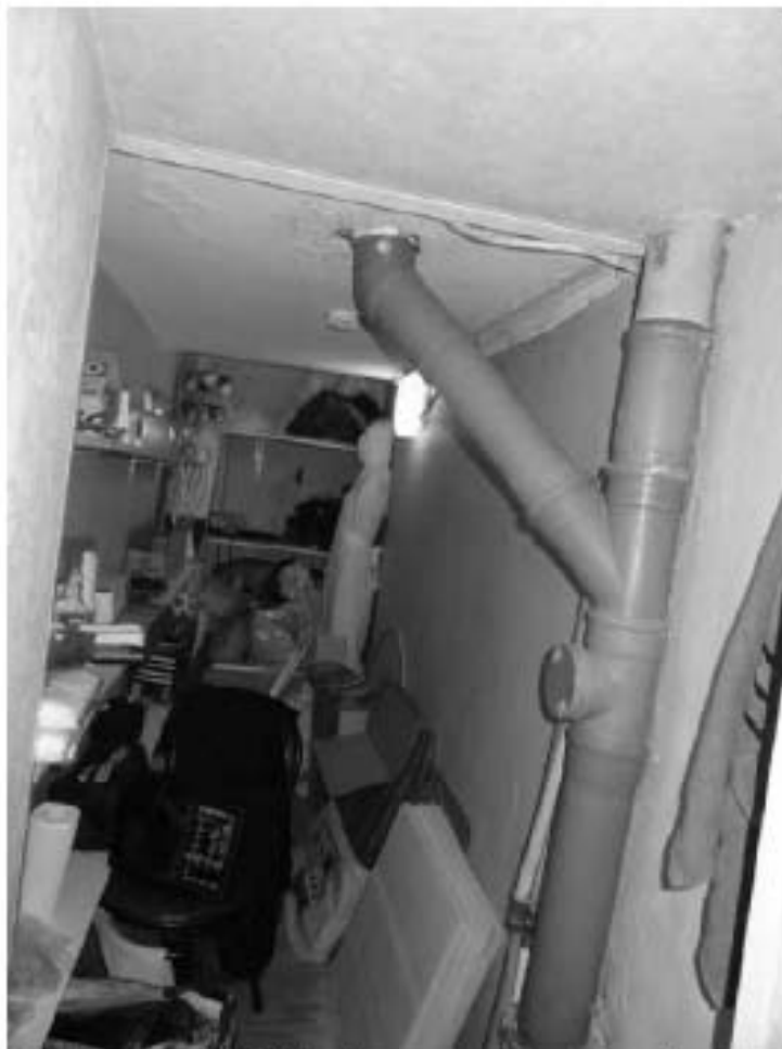
Фото 431. Помещение 6 (16-Н). Фрагмент. Дата фотофиксации: 18.03.25
