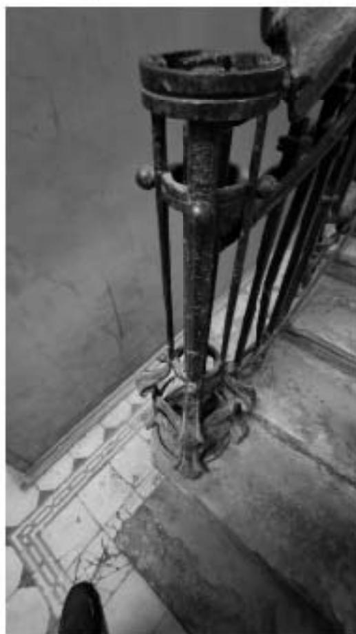
Фото 156. Круглая стойка с растительными деталями в уровне 1-го этажа. Дата фотофиксации: 18.03.25
