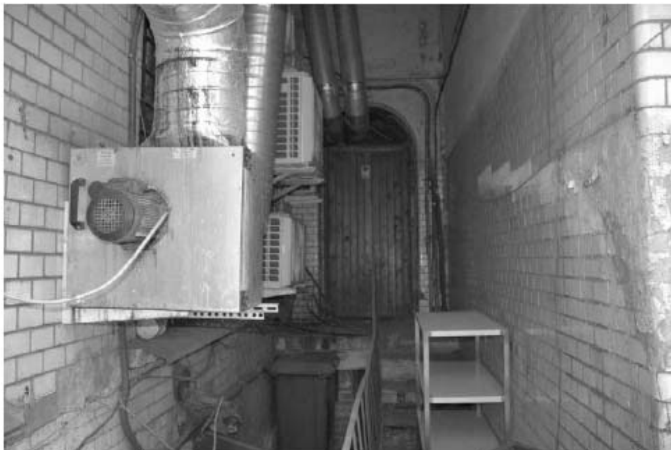
Фото 35. Дверной портал в кармане дворового фасада северного флигеля. Общий вид. Дата фотофиксации: 14.08.25
