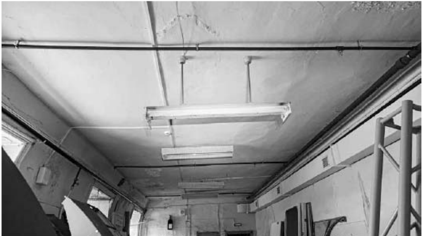
Фото 524. Помещение 3 (41-Н). Фрагмент. Дата фотофиксации: 18.03.25
