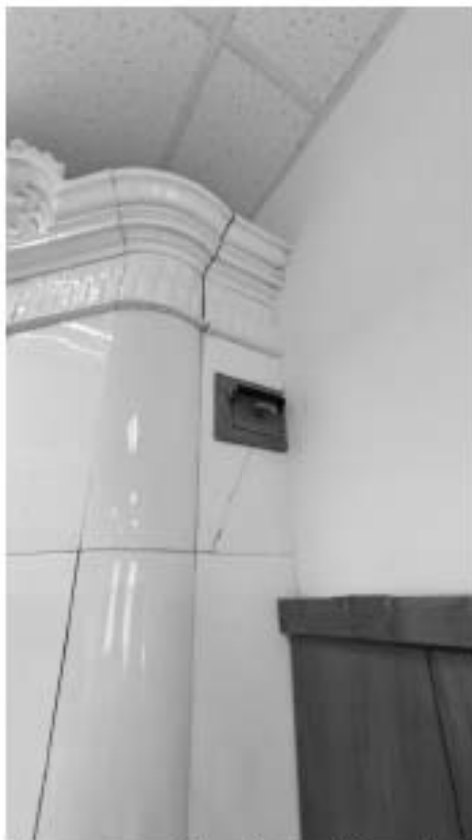
Фото 215. Латунные душники. Общий вид. Дата фотофиксации: 18.03.25
