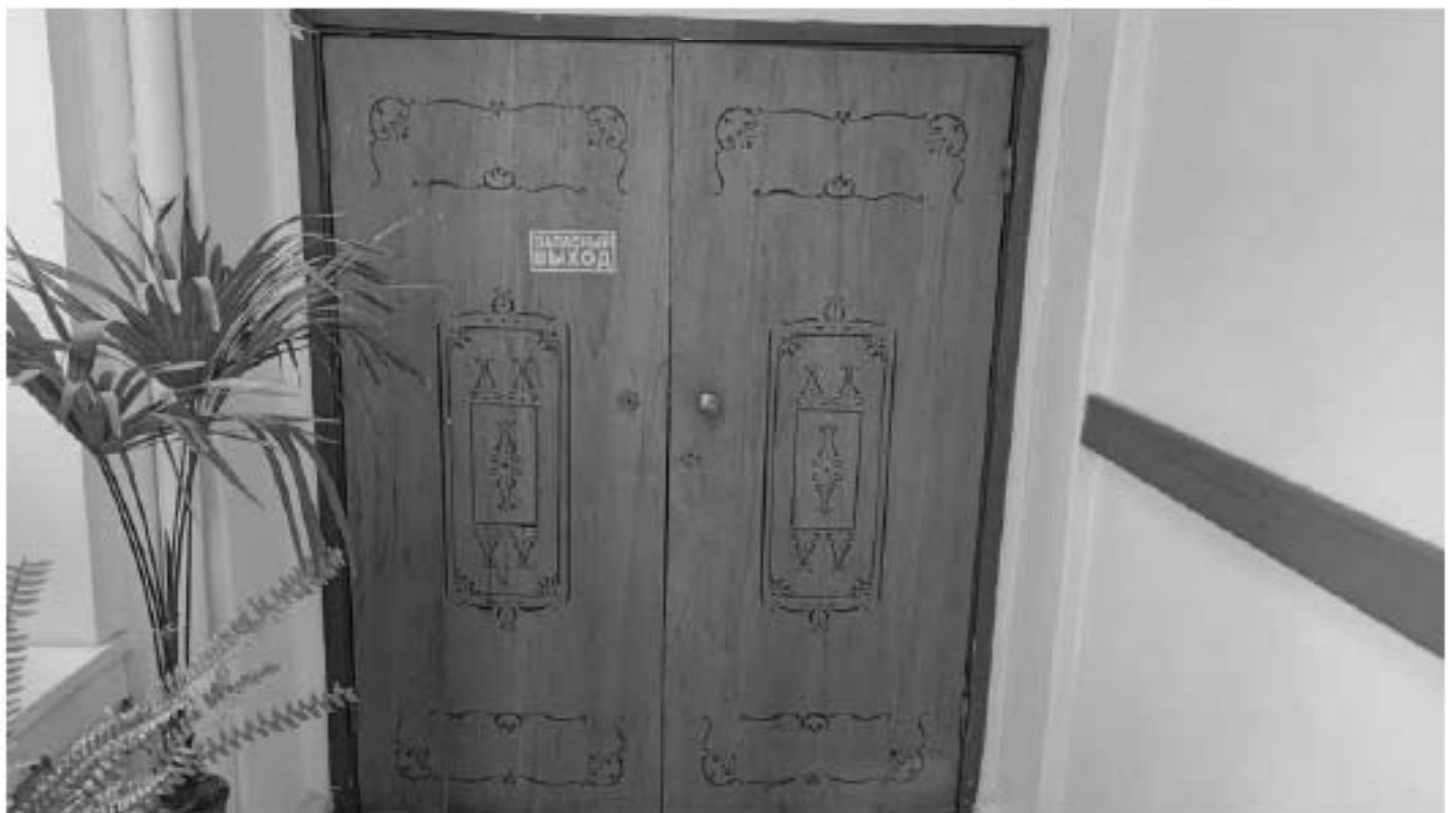
Фото 324. Дверное заполнение между помещениями 4 и 3 (21-Н). Общий вид. Дата фотофиксации: 18.03.25
