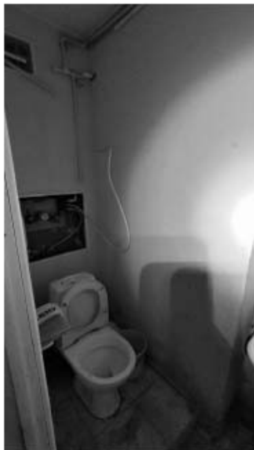
Фото 111. Помещение 9. Фрагмент. Дата фотофиксации: 18.03.25
