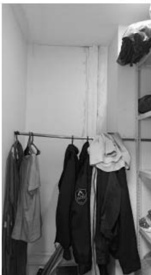
Фото 322. Помещение 8. Общий вид. Дата фотофиксации: 18.03.25
