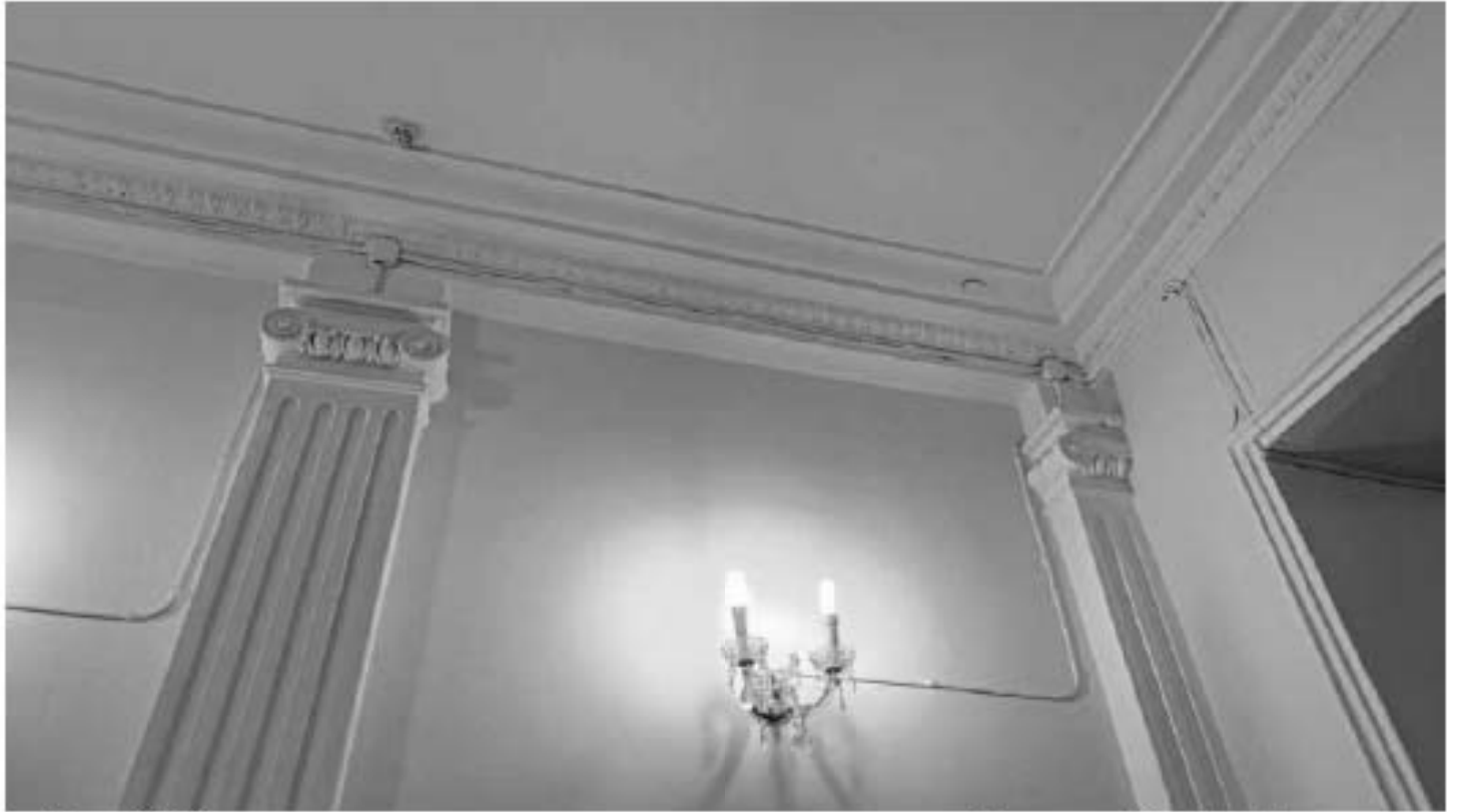
Фото 333. Каннелированные пилястры с ионическими капителями. Фрагмент. Дата фотофиксации: 18.03.25
