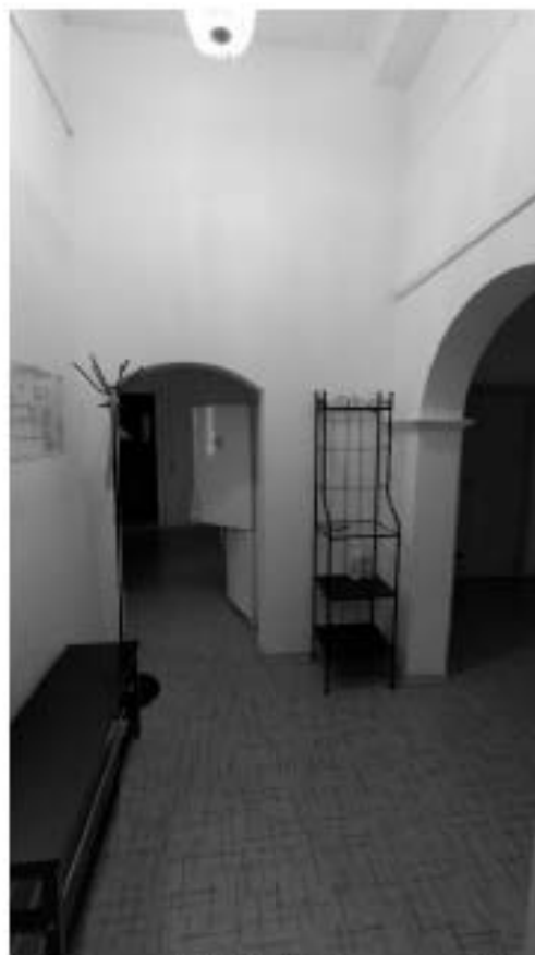
Фото 265. Пространство помещения 1 (26-Н). Фрагмент. Дата фотофиксации: 18.03.25
