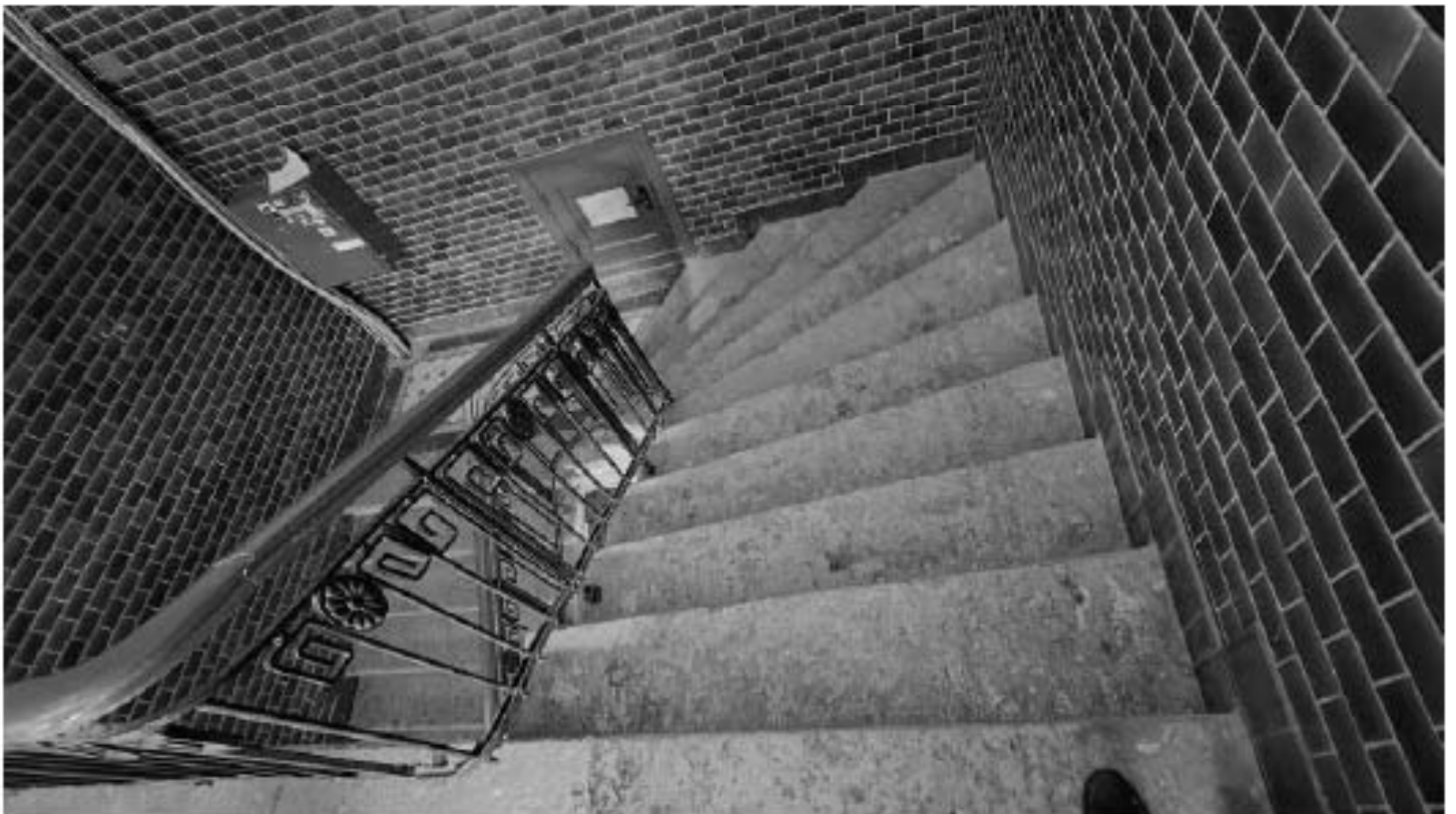
Фото 384. Забежные ступени и межэтажное пространство 3-го и 2-го этажей лестницы Л5. Общий вид. Дата фотофиксации: 18.03.25
