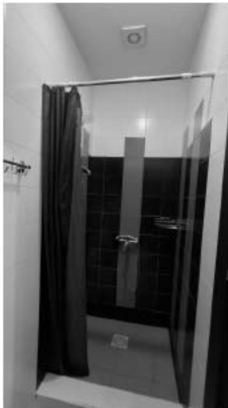
Фото 459. Пространство помещения 5. Фрагмент. Дата фотофиксации: 18.03.25
