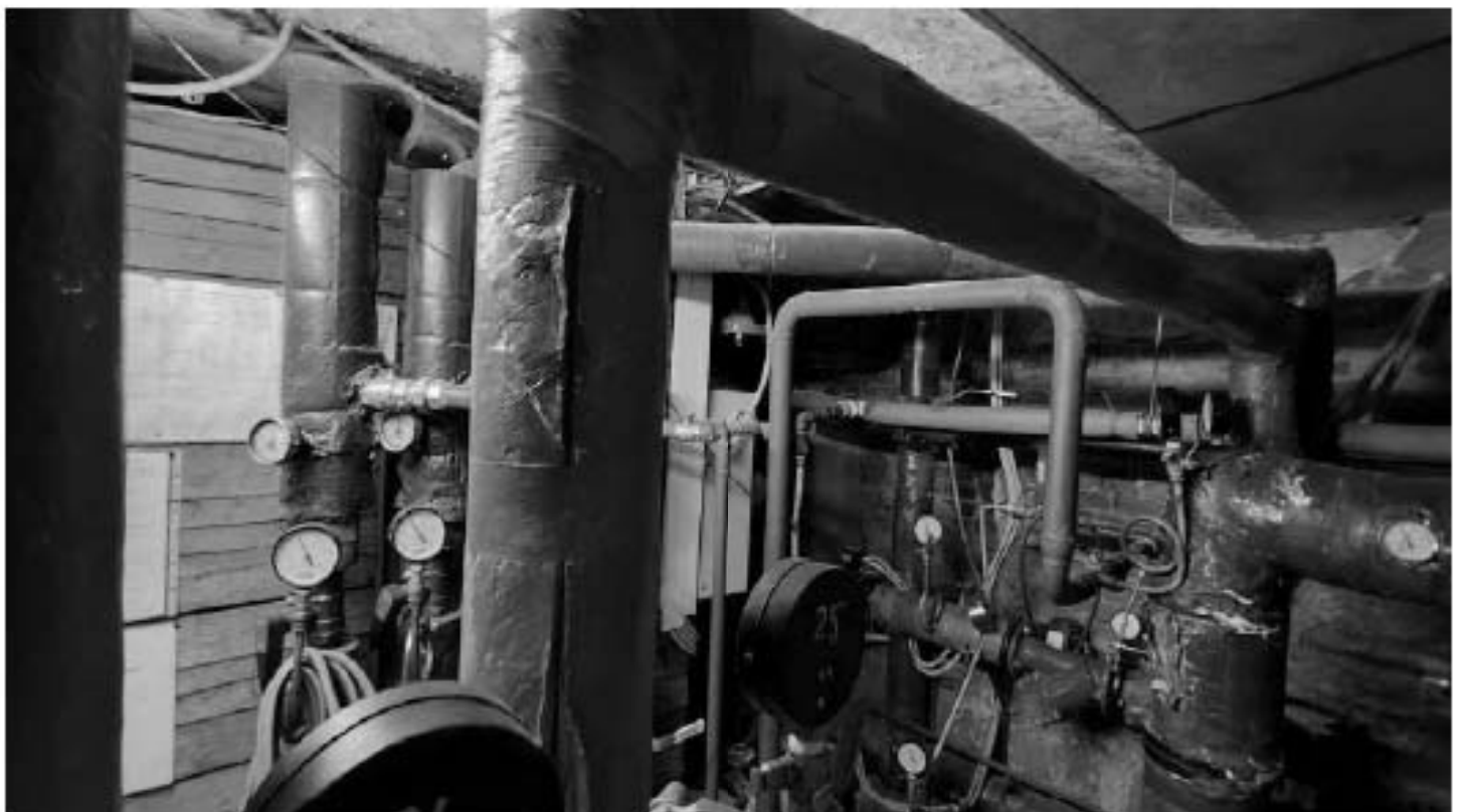
Фото 84. Пространство помещений 2 и 3 (2-Н). Фрагмент. Дата фотофиксации: 18.03.25
