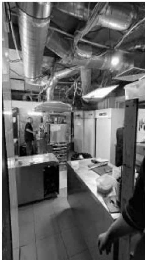
Фото 127. Пространство помещения 3. Фрагмент. Дата фотофиксации: 18.03.25
