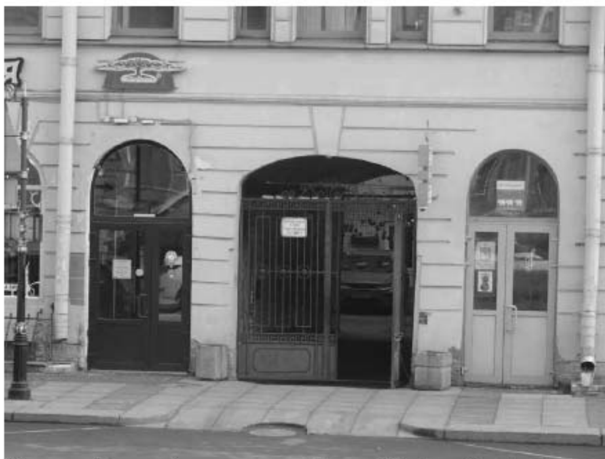
Фото 12 Исторический воротный проезд в западном флигеле. Общий вид. Дата фотофиксации: 18.03.25
