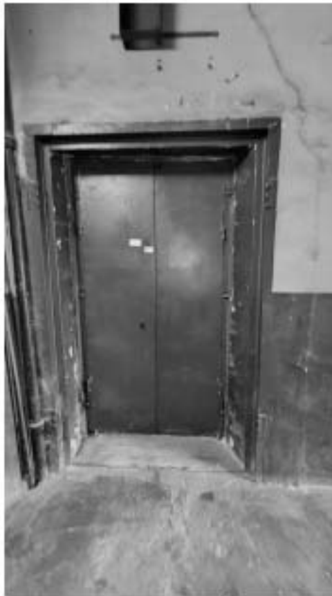
Фото 377. Современное дверное заполнение в уровне 5-го этажа лестницы Л2. Общий вид. Дата фотофиксации: 18.03.25
