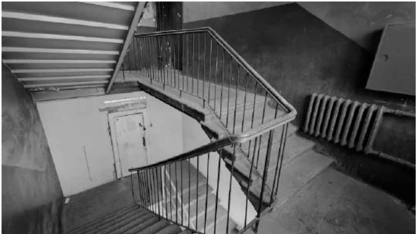
Фото 374. Лестница Л2. Общий вид со стороны межэтажного пространства 4-го и 5-го этажей. Дата фотофиксации: 18.03.25
