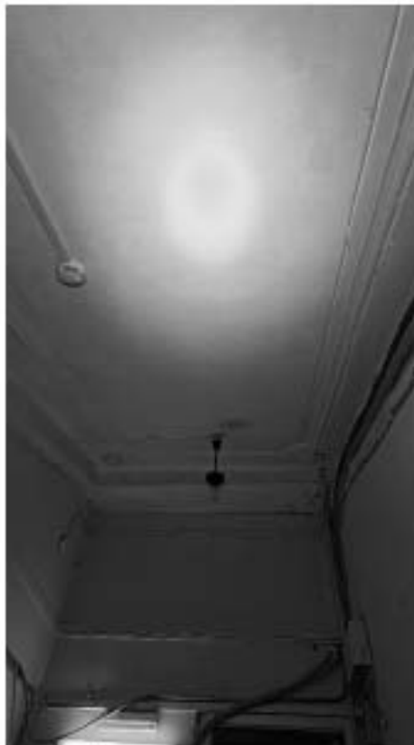
Фото 146. Помещение под лестницей. Косоуры с лепным декором. Фрагмент. Дата фотофиксации: 18.03.25
