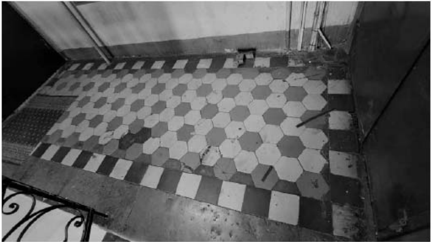
Фото 187. Метлахская плитка на площадке мансарды. Общий вид. Дата фотофиксации: 18.03.25
