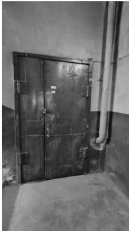
Фото 376. Современное дверное заполнение в уровне 5-го этажа лестницы Л2. Общий вид. Дата фотофиксации: 18.03.25
