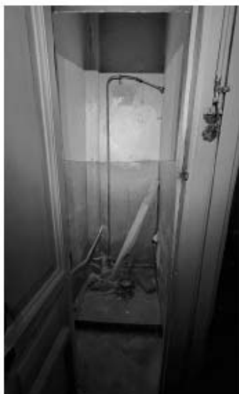
Фото 528. Помещение 6 (41-Н). Общий вид. Дата фотофиксации: 18.03.25
