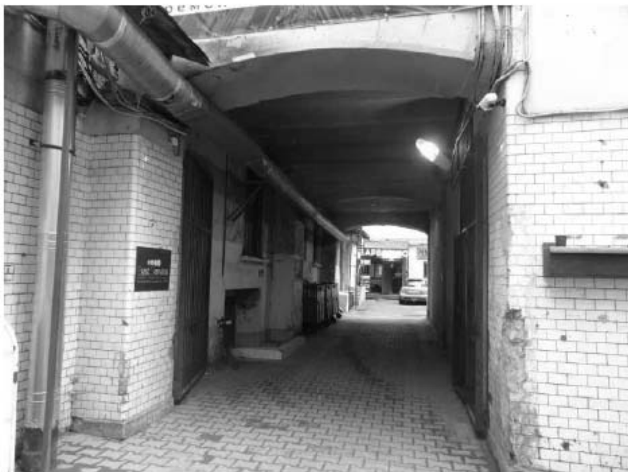
Фото 37. Воротный проезд в северной части поперечного флигеля. Общий вид. Дата фотофиксации: 18.03.25
