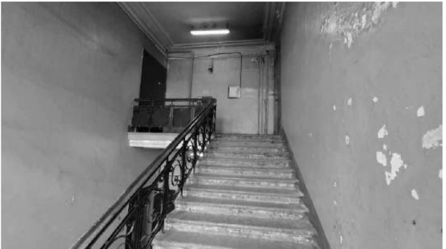
Фото 186. Парадная лестница Л1. Общий вид со стороны межэтажного пространства 5-го этажа и мансарды. Дата фотофиксации: 18.03.25
