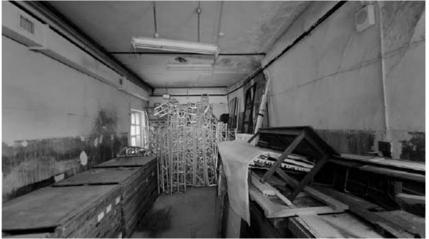
Фото 523. Помещение 3 (41-Н). Фрагмент. Дата фотофиксации: 18.03.25
