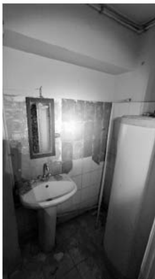
Фото 110. Помещение 9. Фрагмент. Дата фотофиксации: 18.03.25
