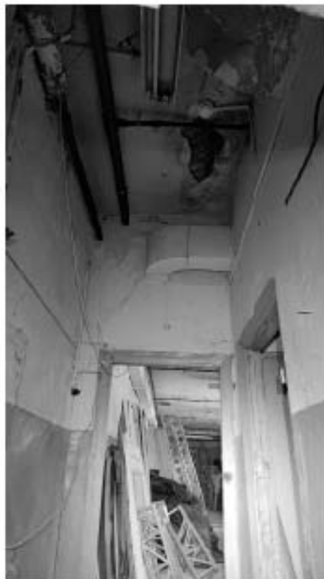
Фото 519. Помещение 1 (41-Н). Фрагмент. Дата фотофиксации: 18.03.25
