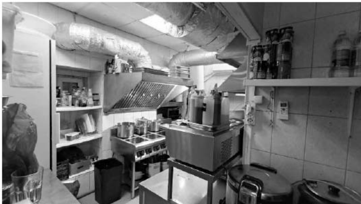
Фото 137. Пространство помещения 9. Фрагмент. Дата фотофиксации: 18.03.25
