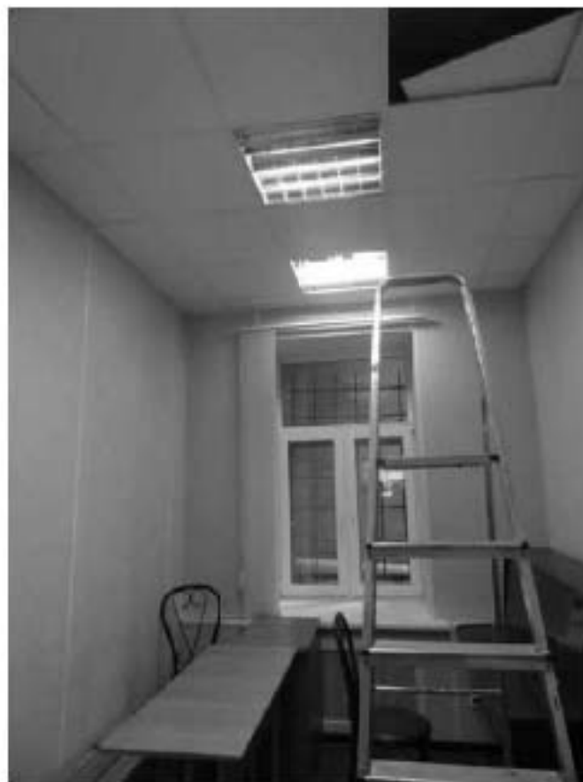
Фото 434. Помещение 2 (16-Н). Общий вид. Дата фотофиксации: 18.03.25
