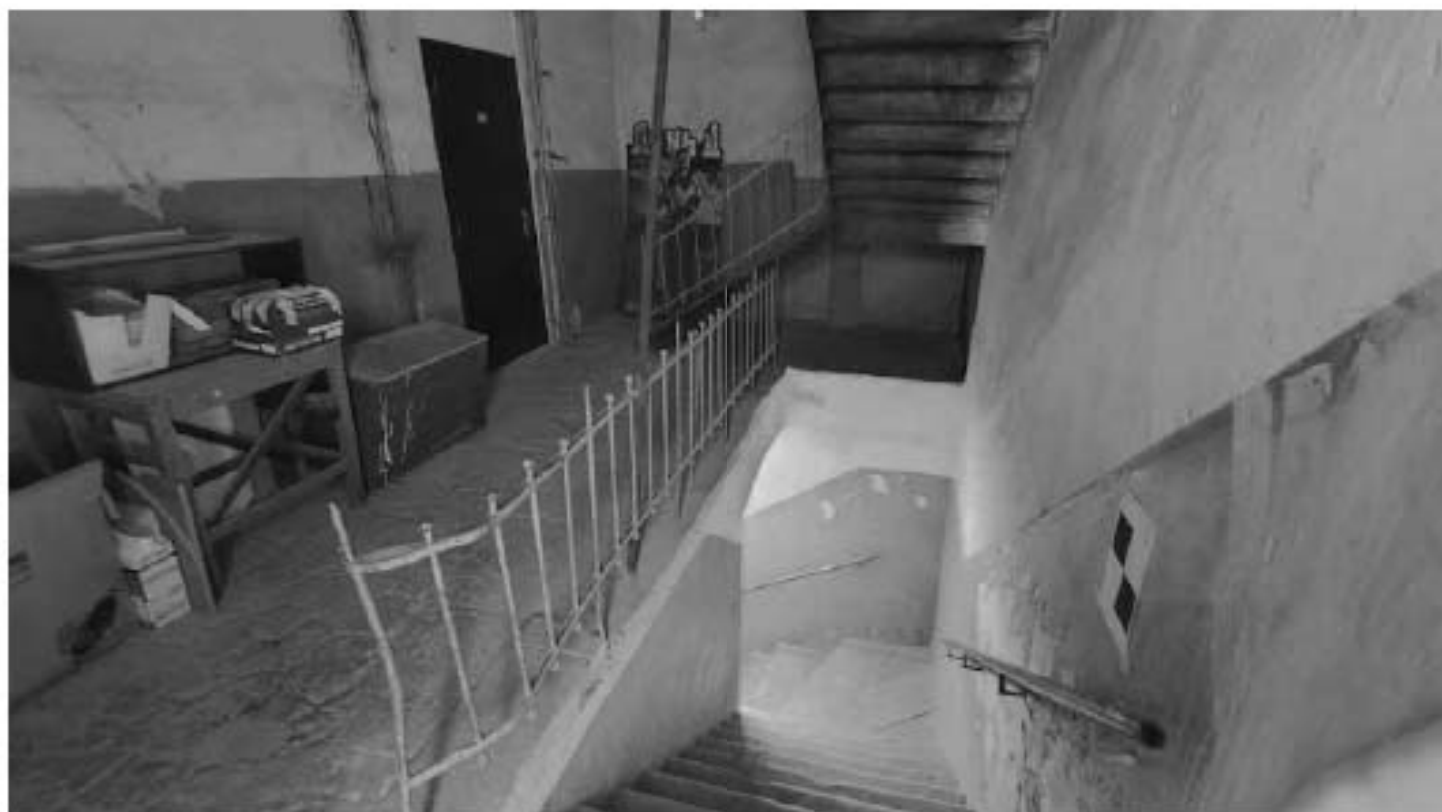
Фото 351. Площадка 4-го этажа. Общий вид. Дата фотофиксации: 18.03.25
