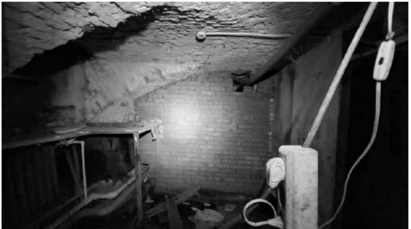
Фото 75. Пространство помещения 5. Цилиндрические с распалубками своды. Фрагмент. Дата фотофиксации: 18.03.25
