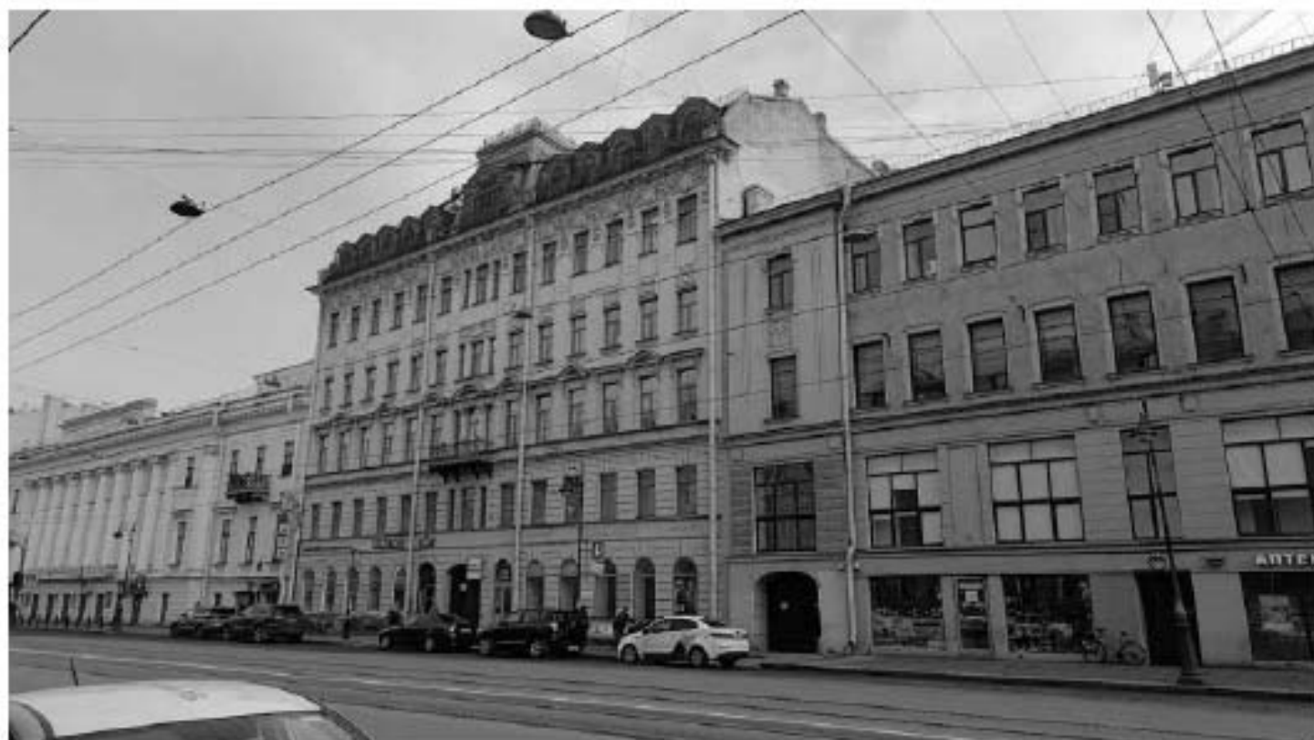
Фото 1. Лицевой корпус (западный флигель). Общий вид. Дата фотофиксации: 18.03.25
