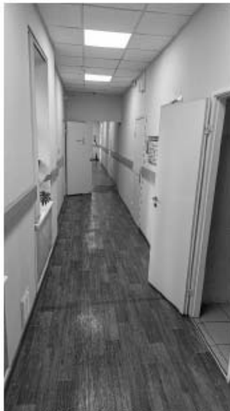
Фото 354. Пространство помещений 41 и 38 (23-Н). Общий вид. Дата фотофиксации: 18.03.25
