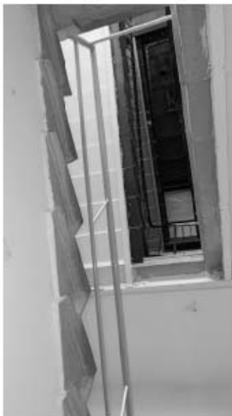
Фото 371. Косоуры современной части лестницы Л2. Фрагмент. Дата фотофиксации: 18.03.25
