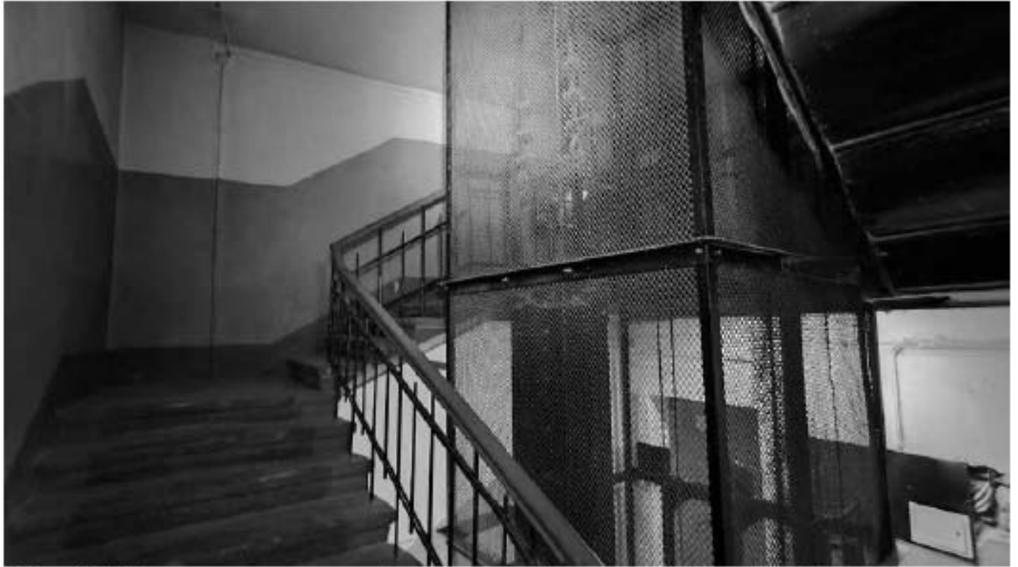
Фото 499. Межэтажное пространство 4-го и 5-го этажей лестницы Л4. Фрагмент. Дата фотофиксации: 18.03.25
