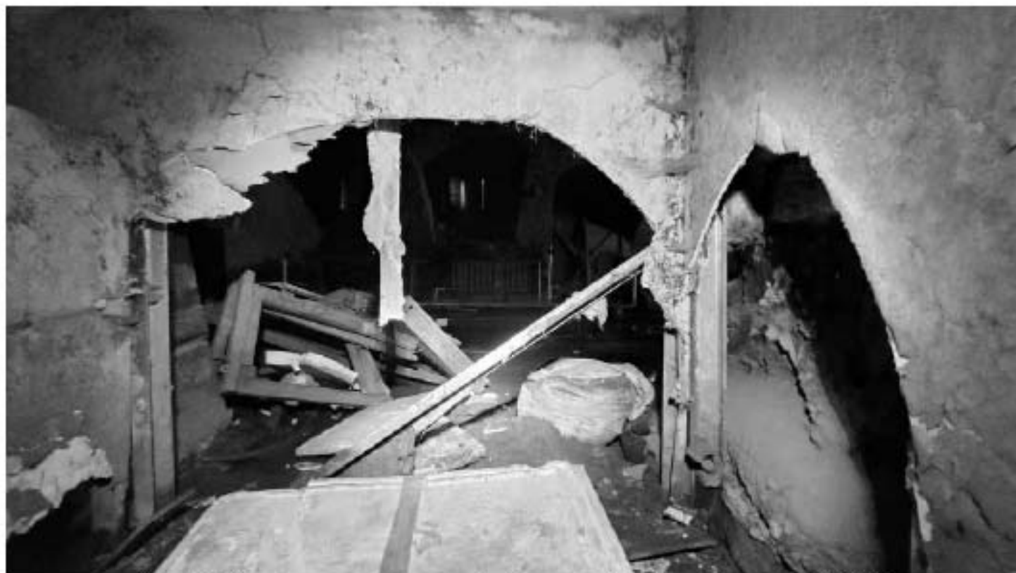
Фото 78. Пространство помещения 1. Фрагмент. Дата фотофиксации: 18.03.25
