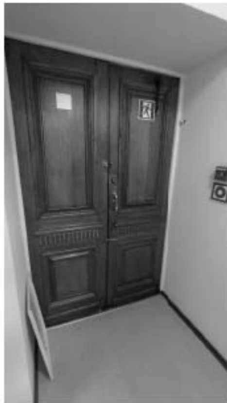
Фото 178. Историческое дверное заполнение в уровне 4-го этажа. Общий вид со стороны помещения 4 (22-Н). Дата фотофиксации: 18.03.25
