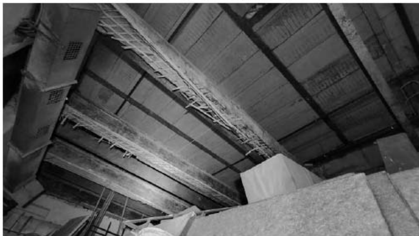
Фото 505. Помещение 1 (45-Н). Фрагмент. Дата фотофиксации: 18.03.25
