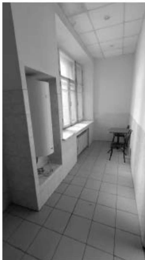
Фото 259. Помещение 2. Общий вид. Дата фотофиксации: 18.03.25
