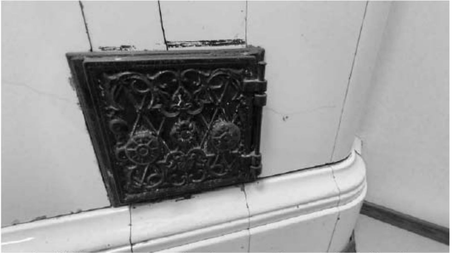
Фото 208. Дверца опочного проема (чугун) с декоративной композицией. Общий вид. Дата фотофиксации: 18.03.25
