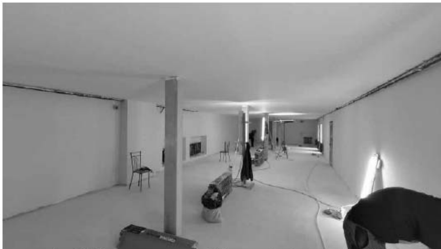
Фото 246. Пространство помещения 18. Фрагмент. Дата фотофиксации: 18.03.25
