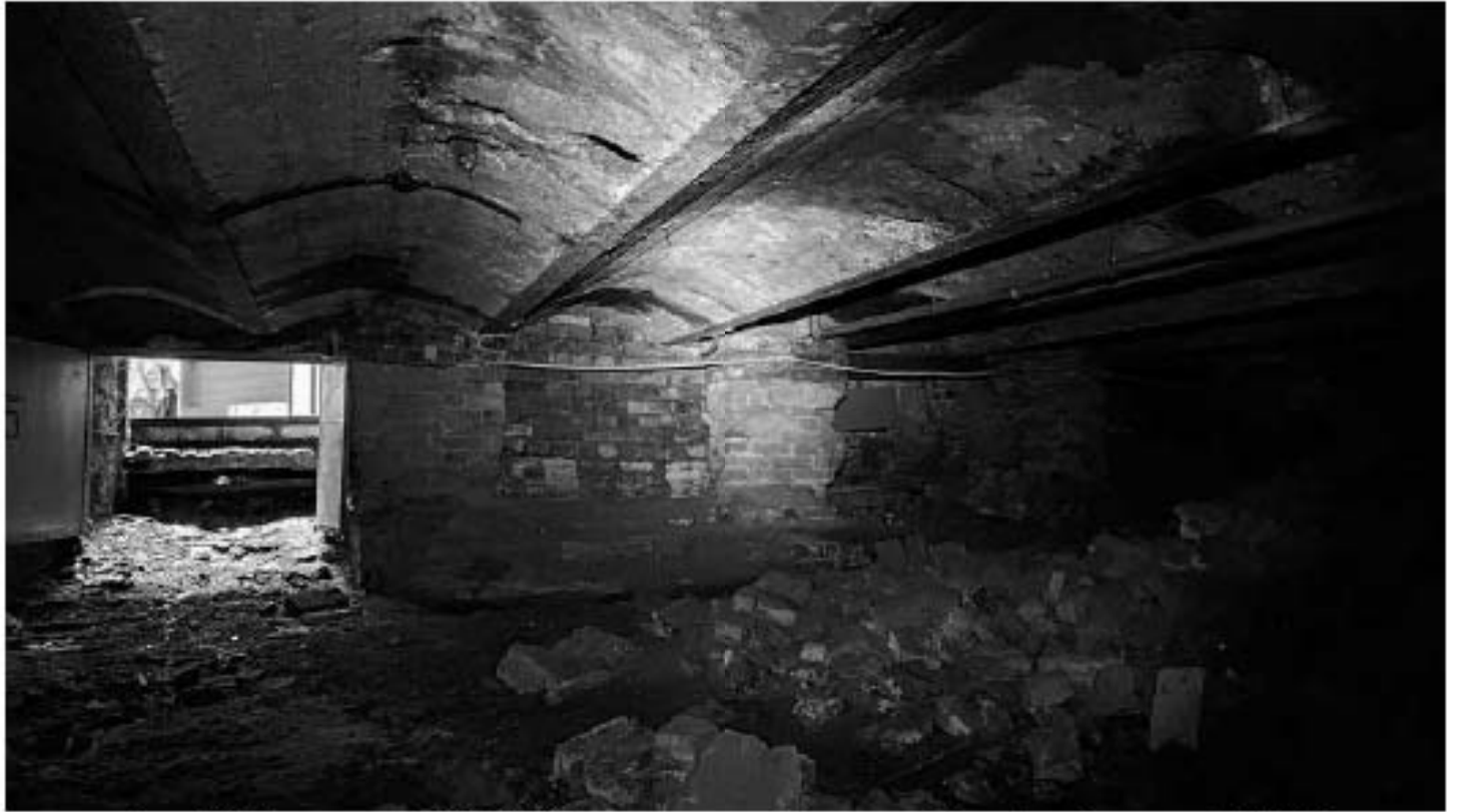
Фото 89. Помещение 1 (33-Н). Прусские своды. Фрагмент. Дата фотофиксации: 14.08.25
