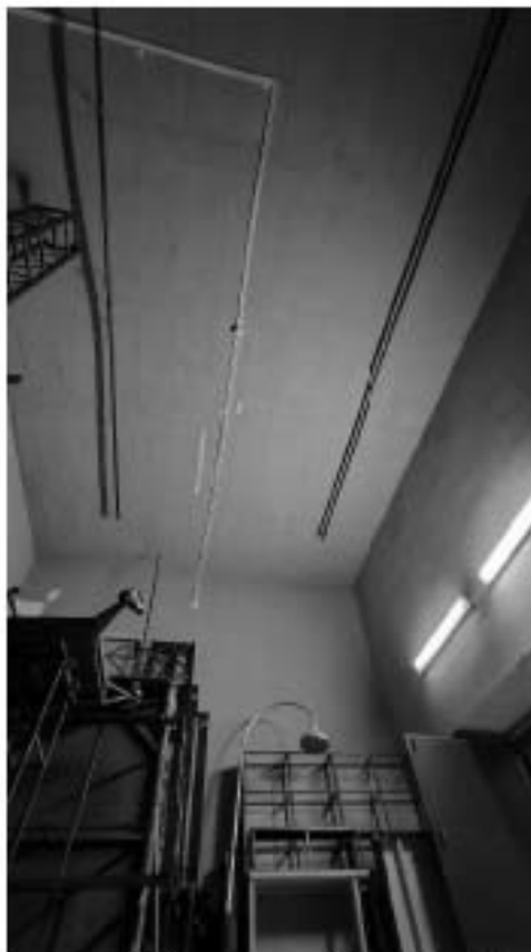
Фото 472. Помещение 1. Фрагмент. Дата фотофиксации: 18.03.25
