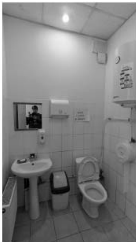
Фото 194. Помещение 12. Общий вид. Дата фотофиксации: 18.03.25
