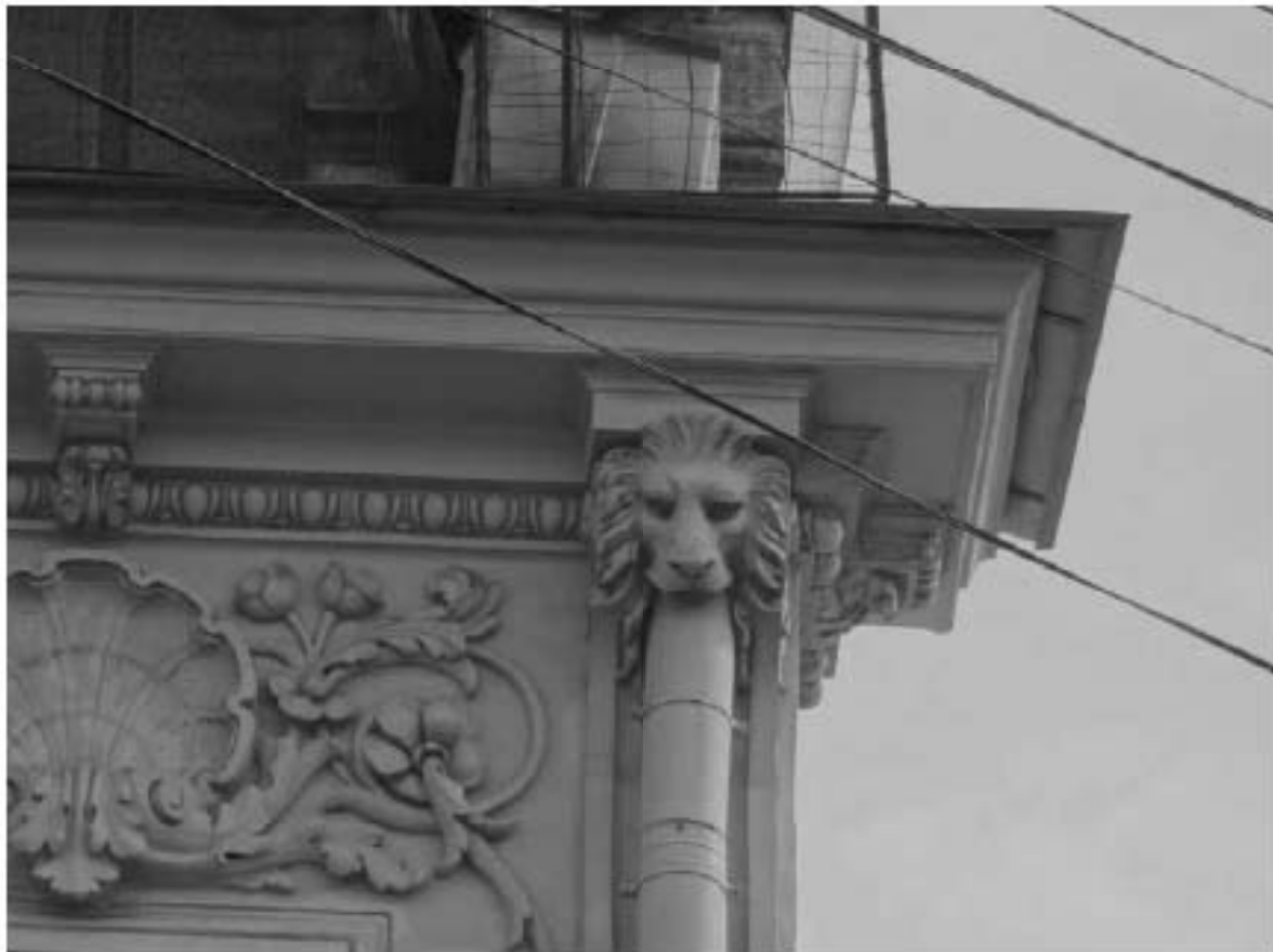
Фото 16. Водослив, оформленный в виде горельефной головы рычащего льва со стилизованными волкучами на боковых сторонах. Общий вид. Дата фотофиксации: 18.03.25
