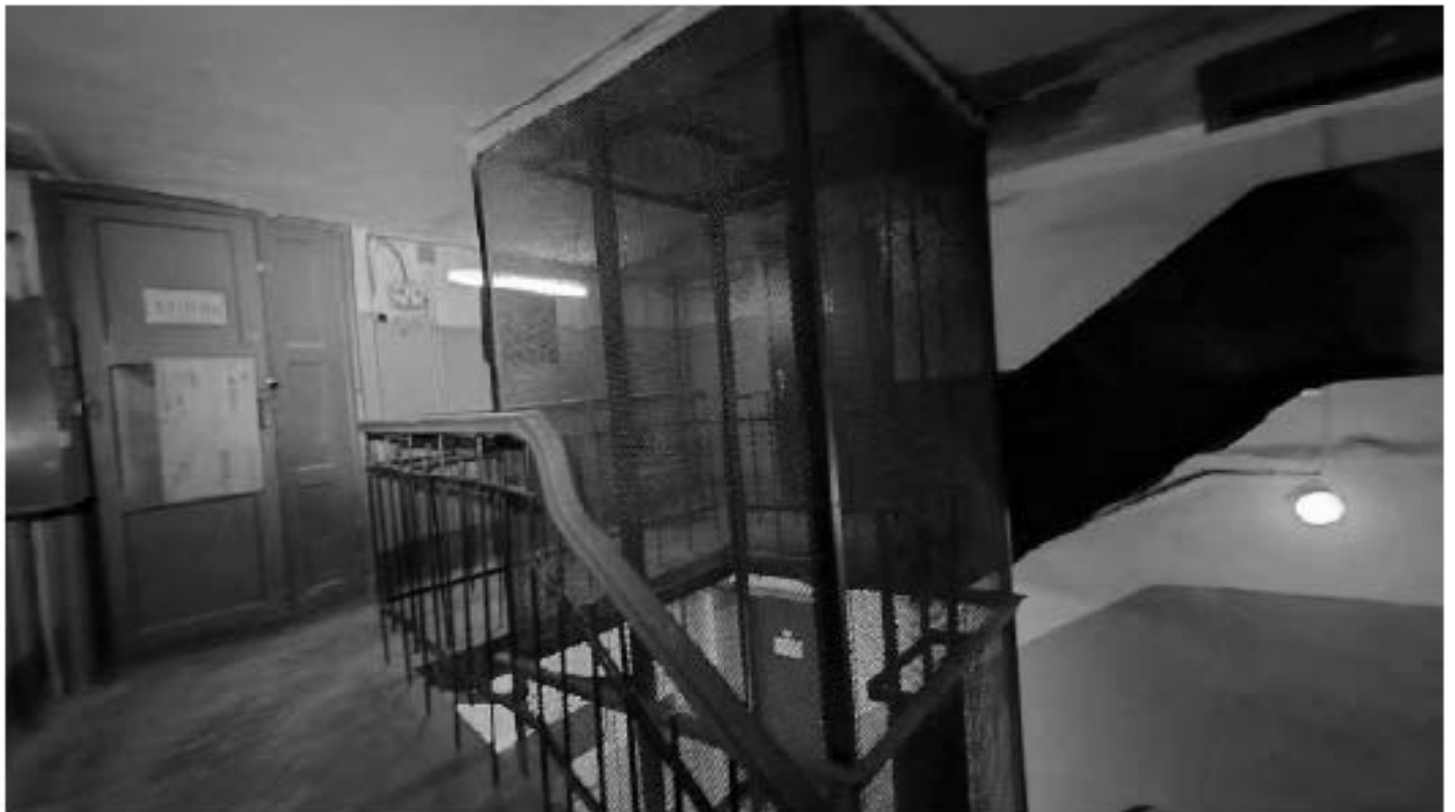
Фото 500. Площадка 5-го этажа. Общий вид. Дата фотофиксации: 18.03.25
