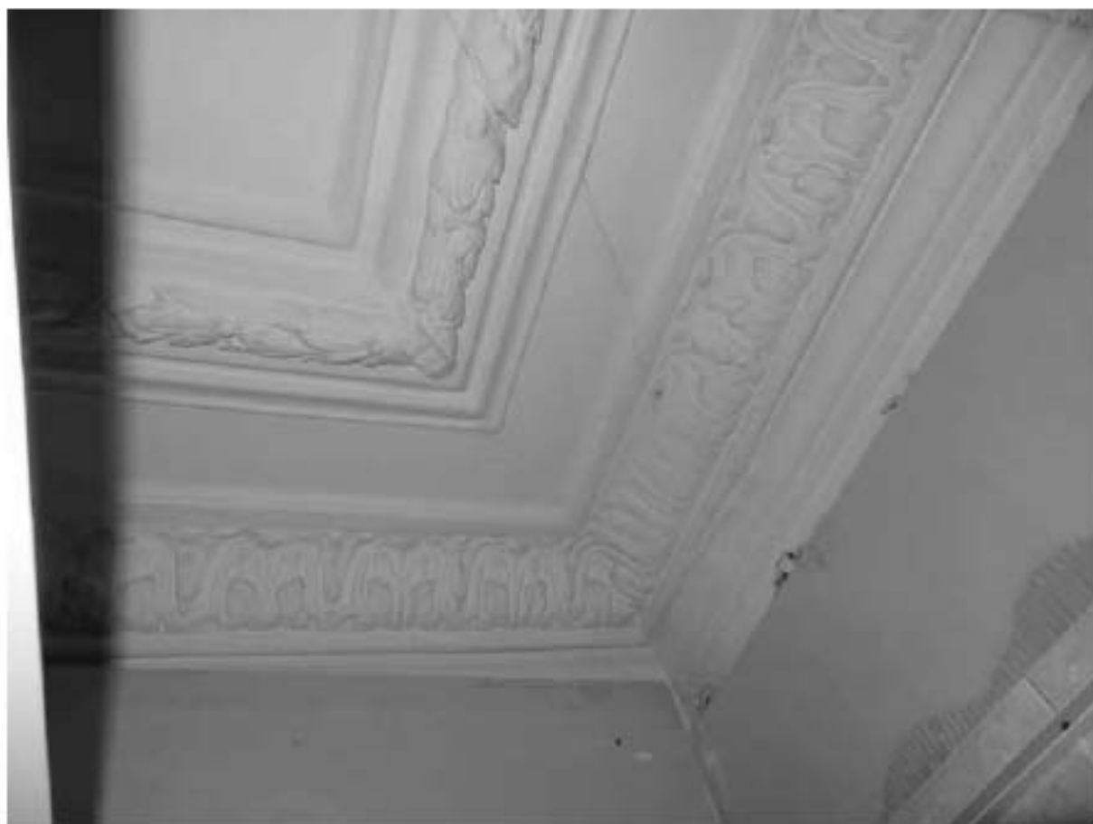
Фото 428. Лепные порезки и тяги в помещениях 8, 7 (16-Н). Фрагмент. Дата фотофиксации: 18.03.25
