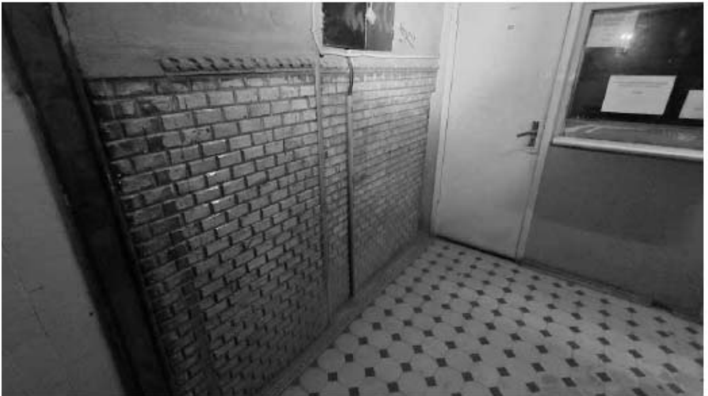
Фото 151. Декоративная облицовка нижней части стен лестничной клетки керамической плиткой светло-серого цвета («кабанчик») в уровне первого этажа. Фрагмент. Дата фотофиксации: 18.03.25
