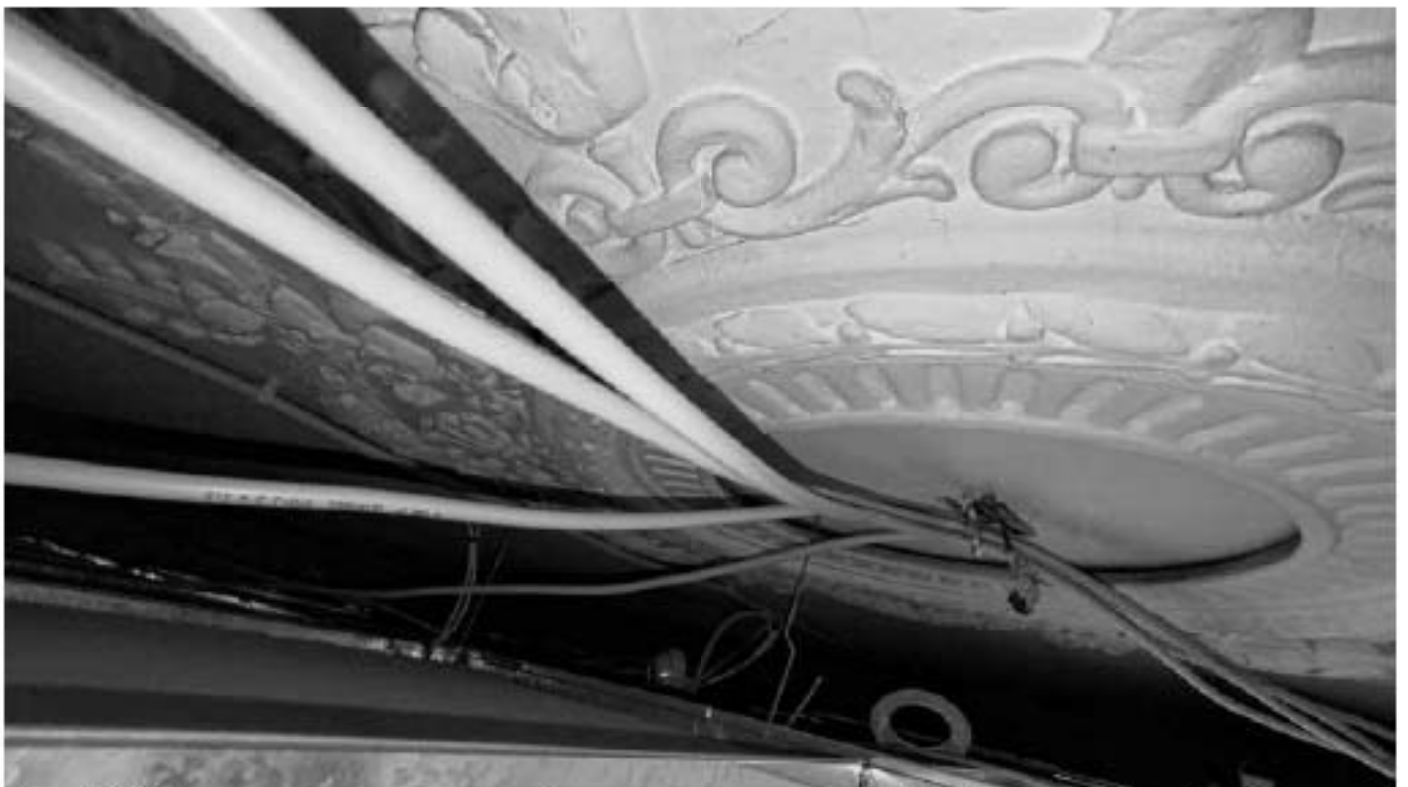
Фото 300. Розетка с декорированным оформлением в помещении 17. Фрагмент. Дата фотофиксации: 18.03.25
