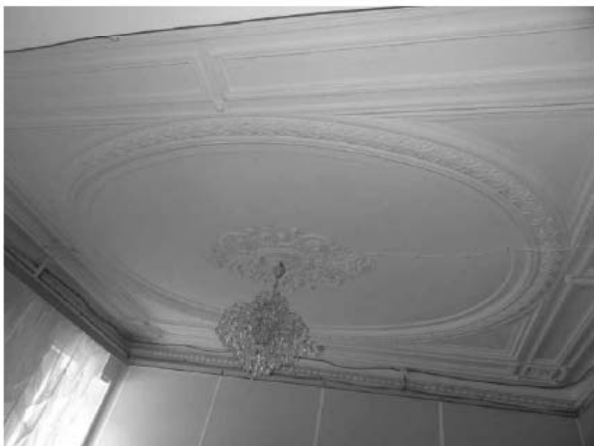
Фото 418. Художественная отделка потолка. Помещение 12 (16-Н). Общий вид. Дата фотофиксации: 18.03.25
