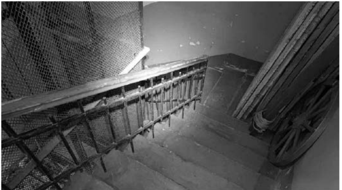
Фото 486. Межэтажное пространство 2-го и 1-го этажей лестницы Л4. Фрагмент. Дата фотофиксации: 18.03.25
