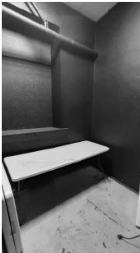
Фото 240. Помещение 11. Общий вид. Дата фотофиксации: 18.03.25
