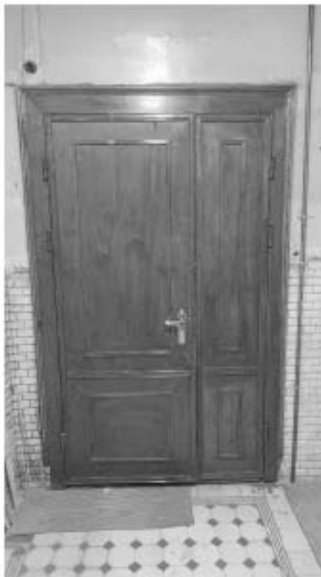
Фото 179. Современное дверное заполнение в уровне 4-го этажа. Общий вид. Дата фотофиксации: 18.03.25
