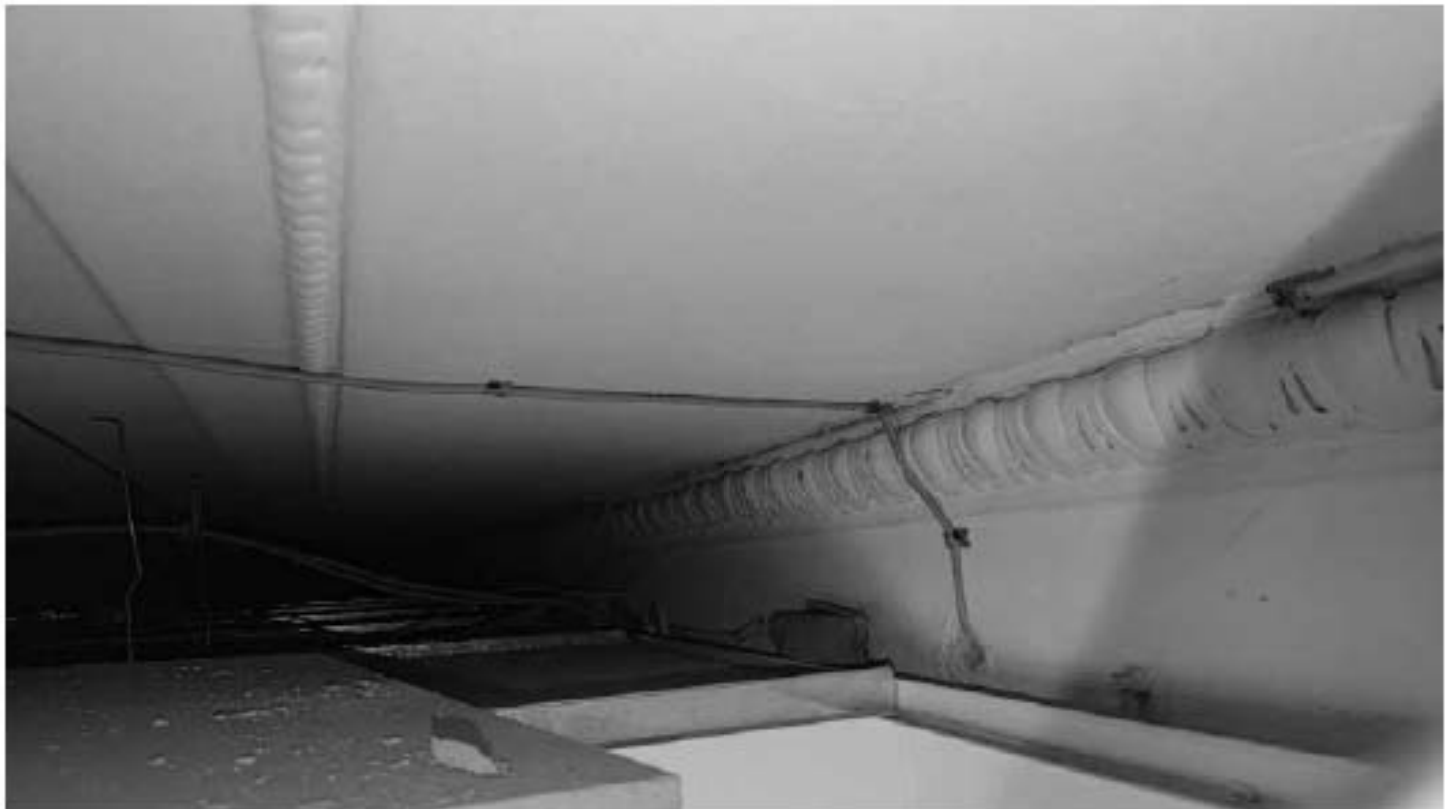
Фото 302. Тяги с лепным декором в помещении 17. Фрагмент. Дата фотофиксации: 18.03.25
