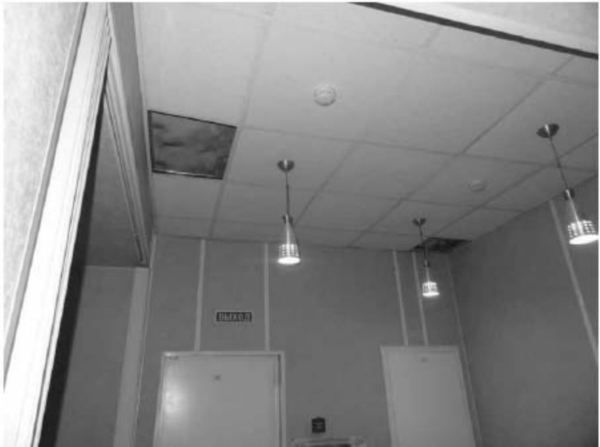
Фото 433. Помещение 5 (16-Н). Фрагмент. Дата фотофиксации: 18.03.25
