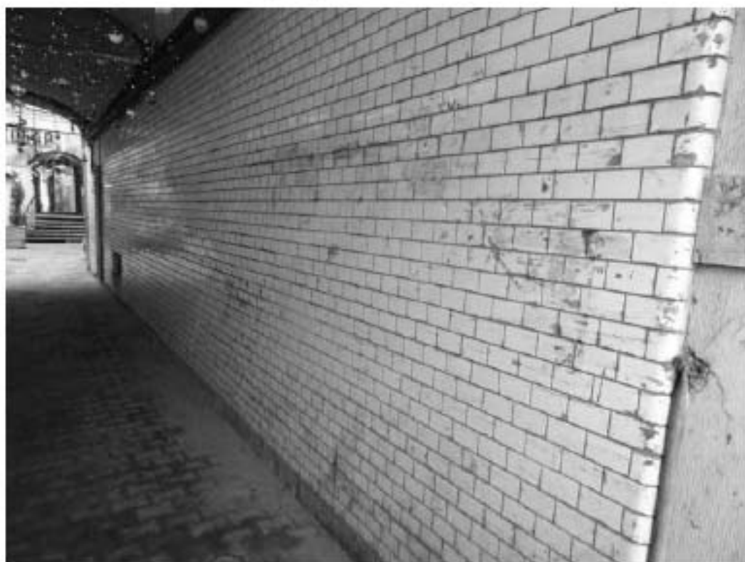
Фото 24. Отделка воротного проезда – керамическая глазурованная плитка («кабанчик») бежевого цвета. Общий вид. Дата фотофиксации: 18.03.25
