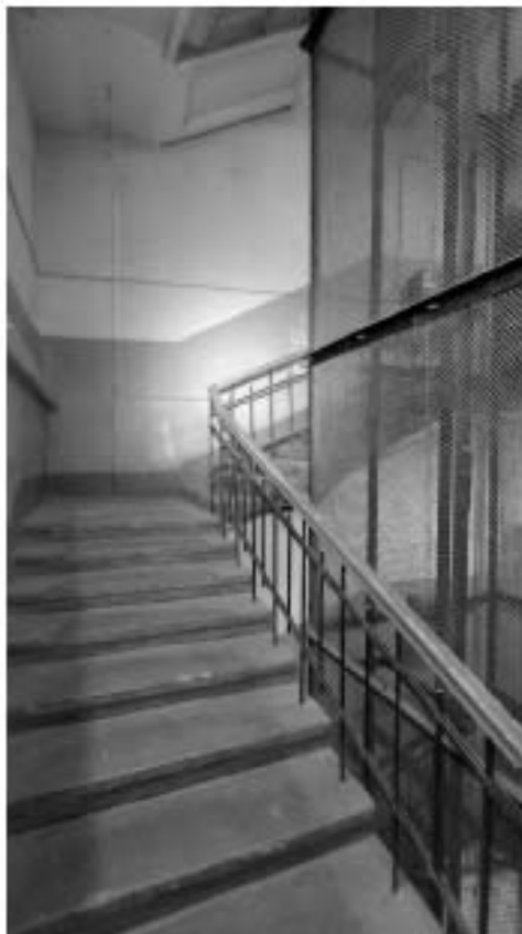
Фото 496. Межэтажное пространство 3-го и 4-го этажей лестницы Л4. Фрагмент. Дата фотофиксации: 18.03.25
