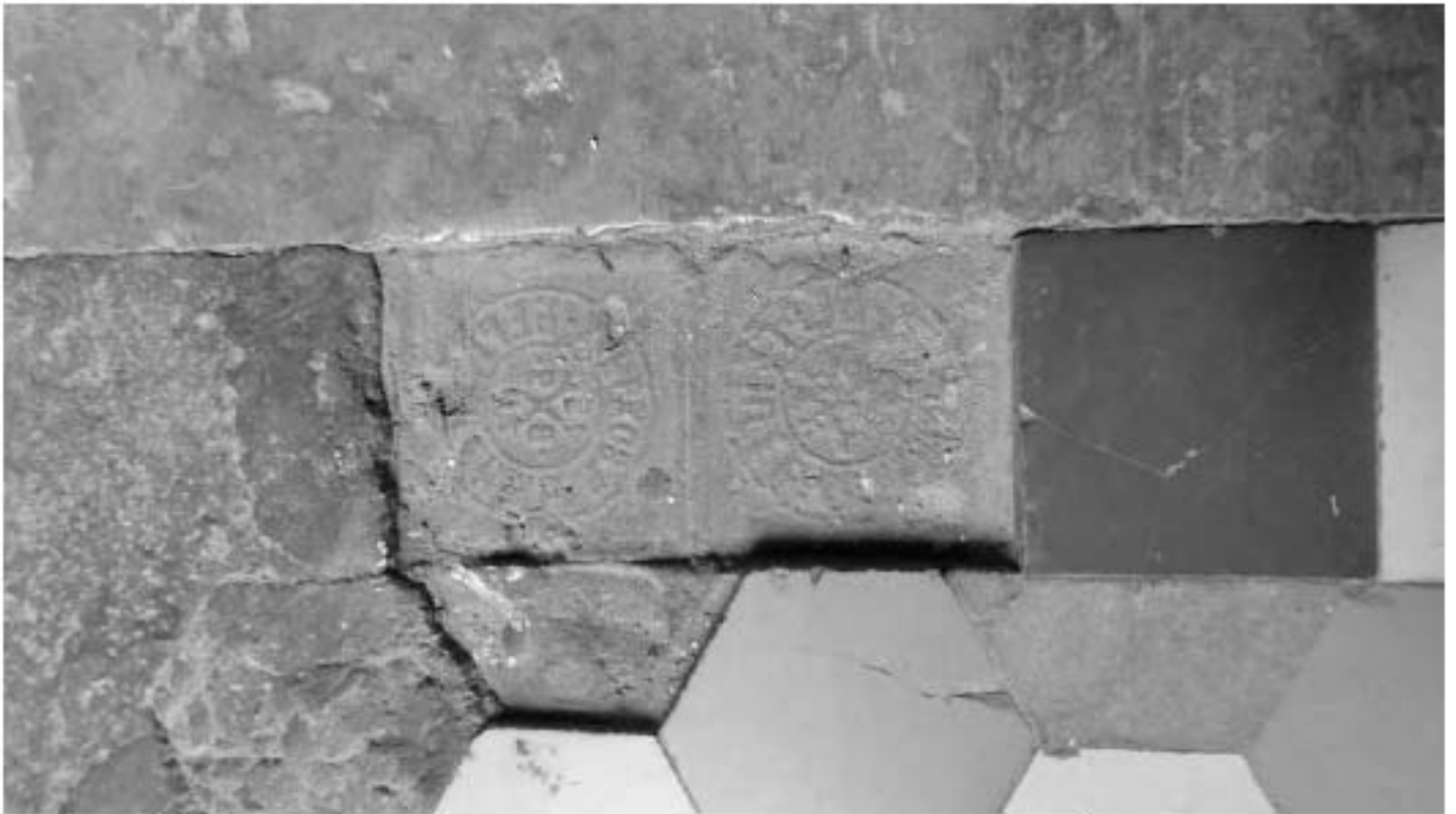
Фото 185. Сохранившаяся фактурная плитка в межэтажном пространстве 5-го этажа и мансарды. Фрагмент. Дата фотофиксации: 18.03.25
