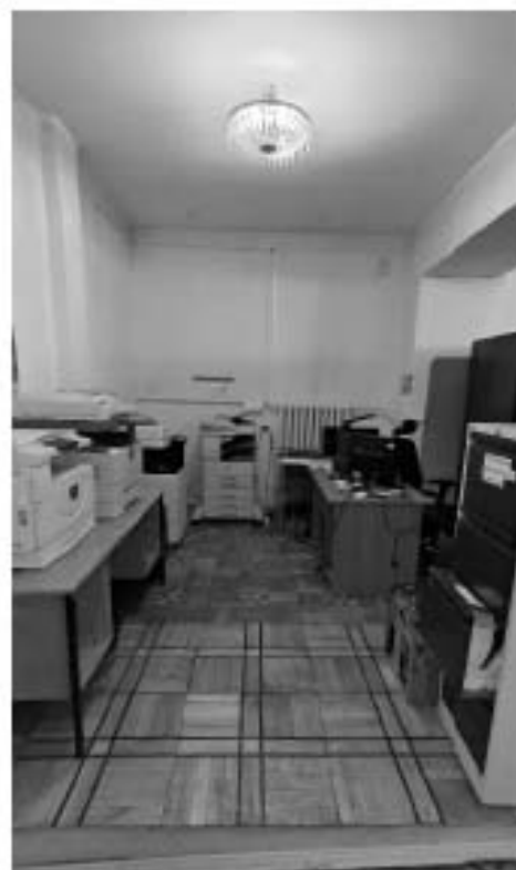
Фото 328. Помещение 1 (21-Н). Фрагмент. Дата фотофиксации: 18.03.25
