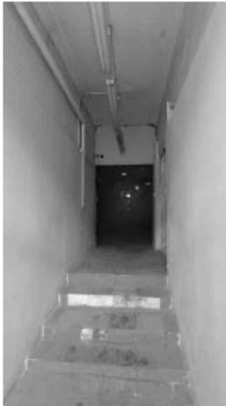
Фото 145. Вестибюль перед парадной лестницей Л1. Общий вид. Дата фотофиксации: 18.03.25
