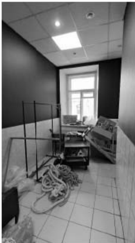
Фото 254. Помещение 4. Фрагмент. Дата фотофиксации: 18.03.25
