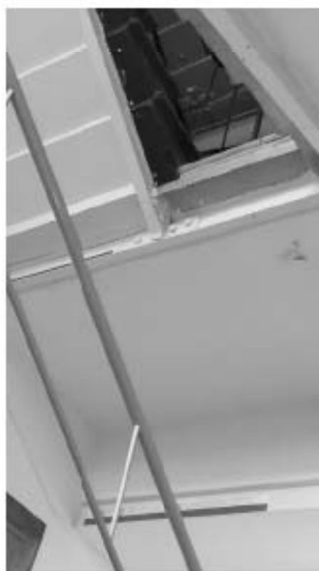
Фото 372. Косоуры современной части лестницы Л2. Фрагмент. Дата фотофиксации: 18.03.25
