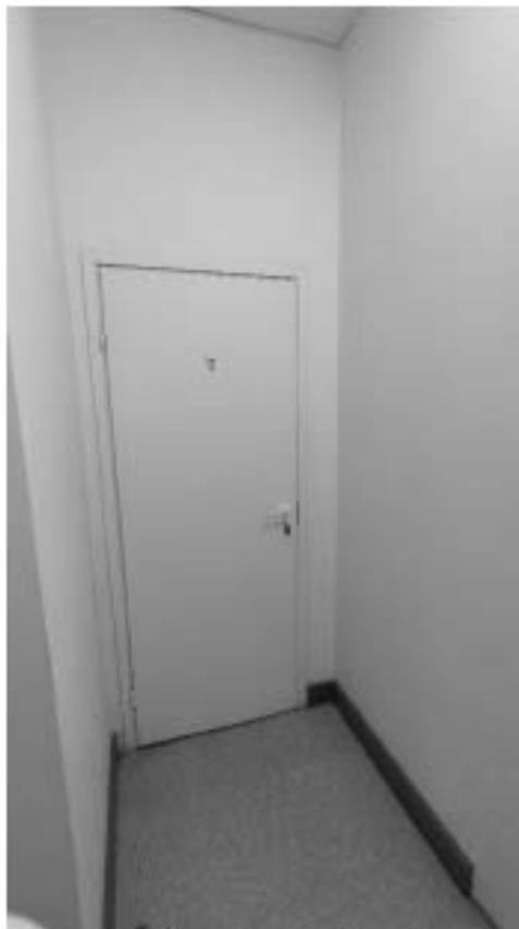
Фото 321. Помещение 10. Общий вид. Дата фотофиксации: 18.03.25
