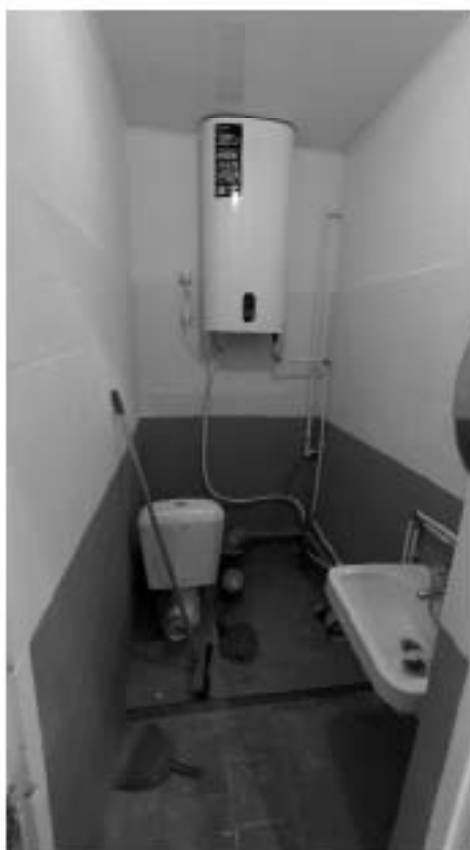
Фото 241. Помещение 16. Общий вид. Дата фотофиксации: 18.03.25
