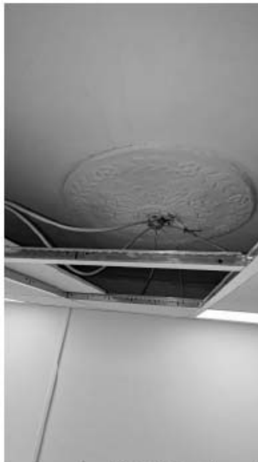
Фото 204. Розетка. Пространство помещений 6 и 7. Общий вид. Дата фотофиксации: 18.03.25
