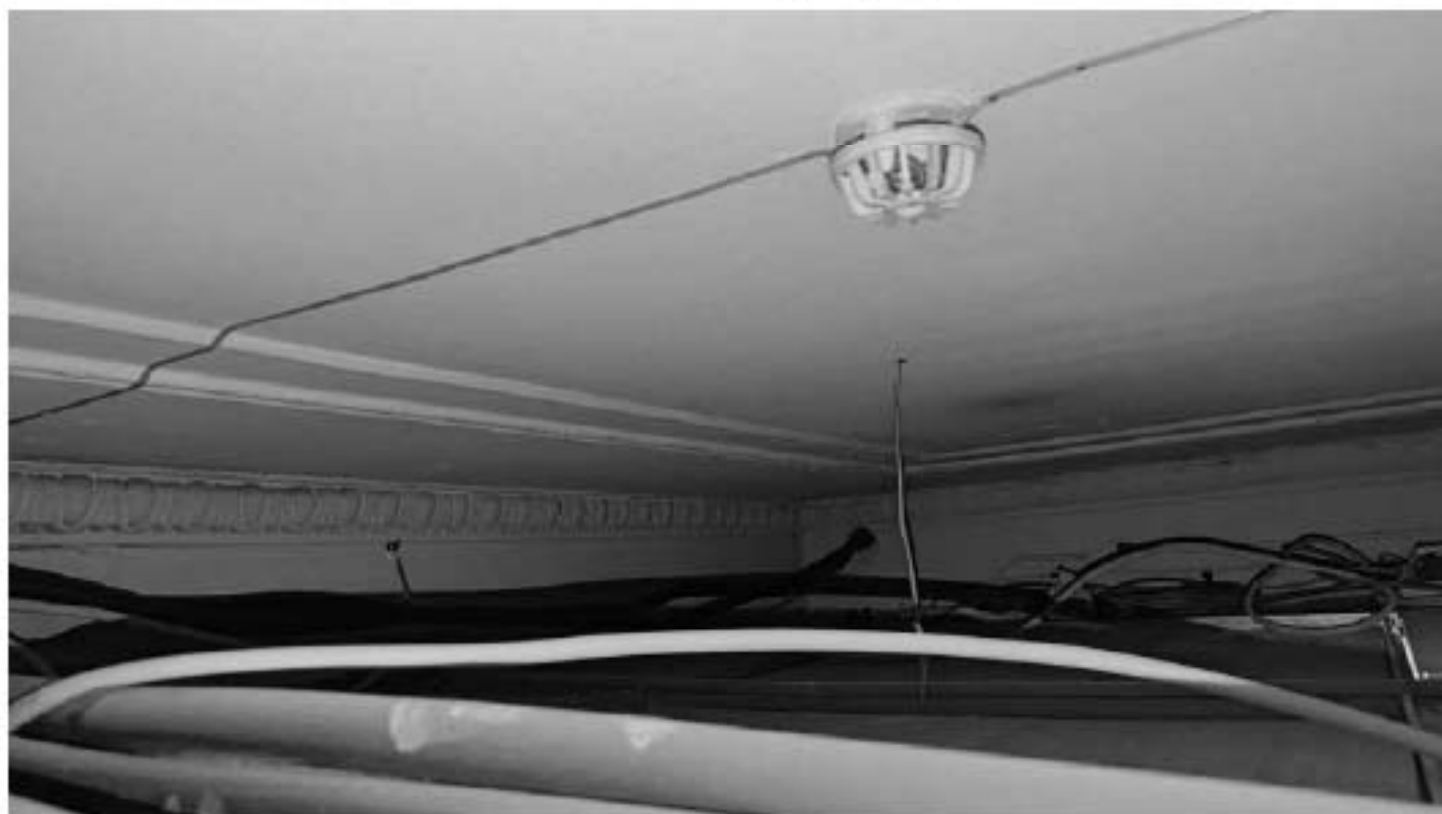
Фото 306. Тяги с лепным декором в помещении 31. Фрагмент. Дата фотофиксации: 18.03.25
