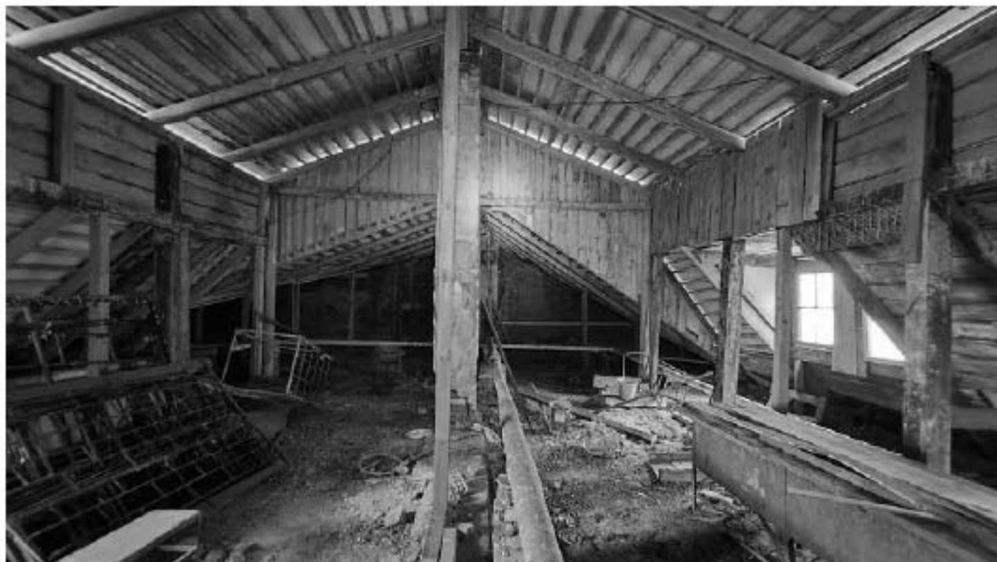
Фото 250. Объем чердака. Фрагмент. Дата фотофиксации: 18.03.25
