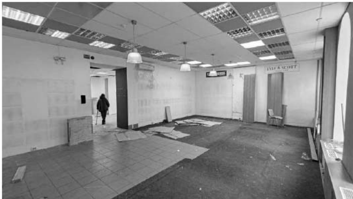
Фото 90. Помещение 1. Общий вид. Дата фотофиксации: 18.03.25
