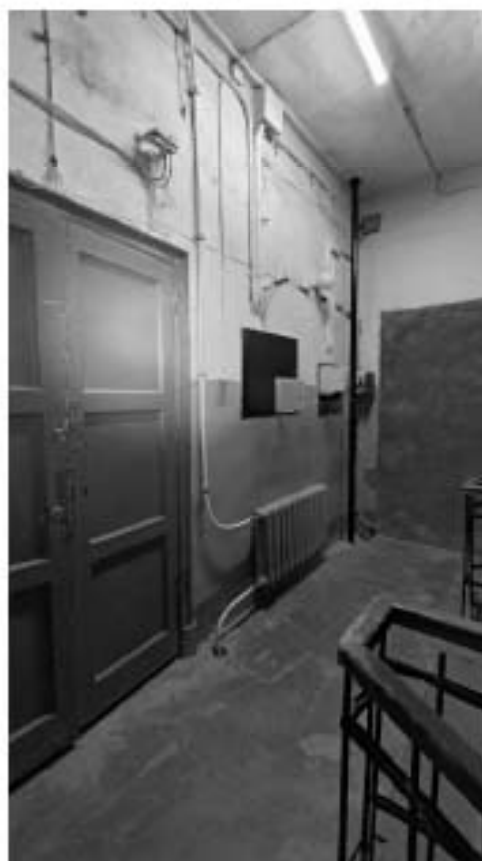
Фото 494. Площадка 3-го этажа. Фрагмент. Дата фотофиксации: 18.03.25
