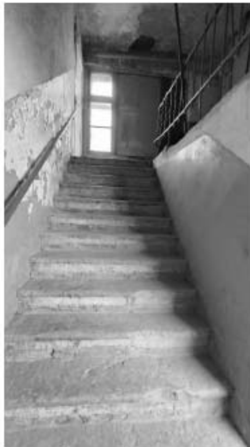
Фото 350. Лестница ЛЗ. Вид на площадку 4-го этажа со стороны объёма лестницы. Дата фотофиксации: 18.03.25
