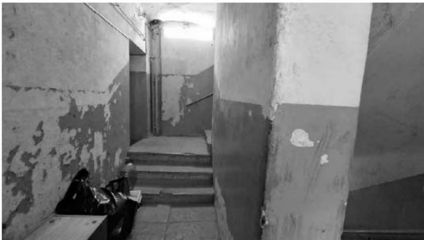
Фото 337. Площадка 3-го этажа лестницы ЛЗ. Фрагмент. Дата фотофиксации: 18.03.25
