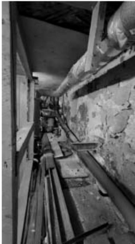
Фото 81. Пространство помещений 2 и 3 (2-Н). Фрагмент. Дата фотофиксации: 18.03.25
