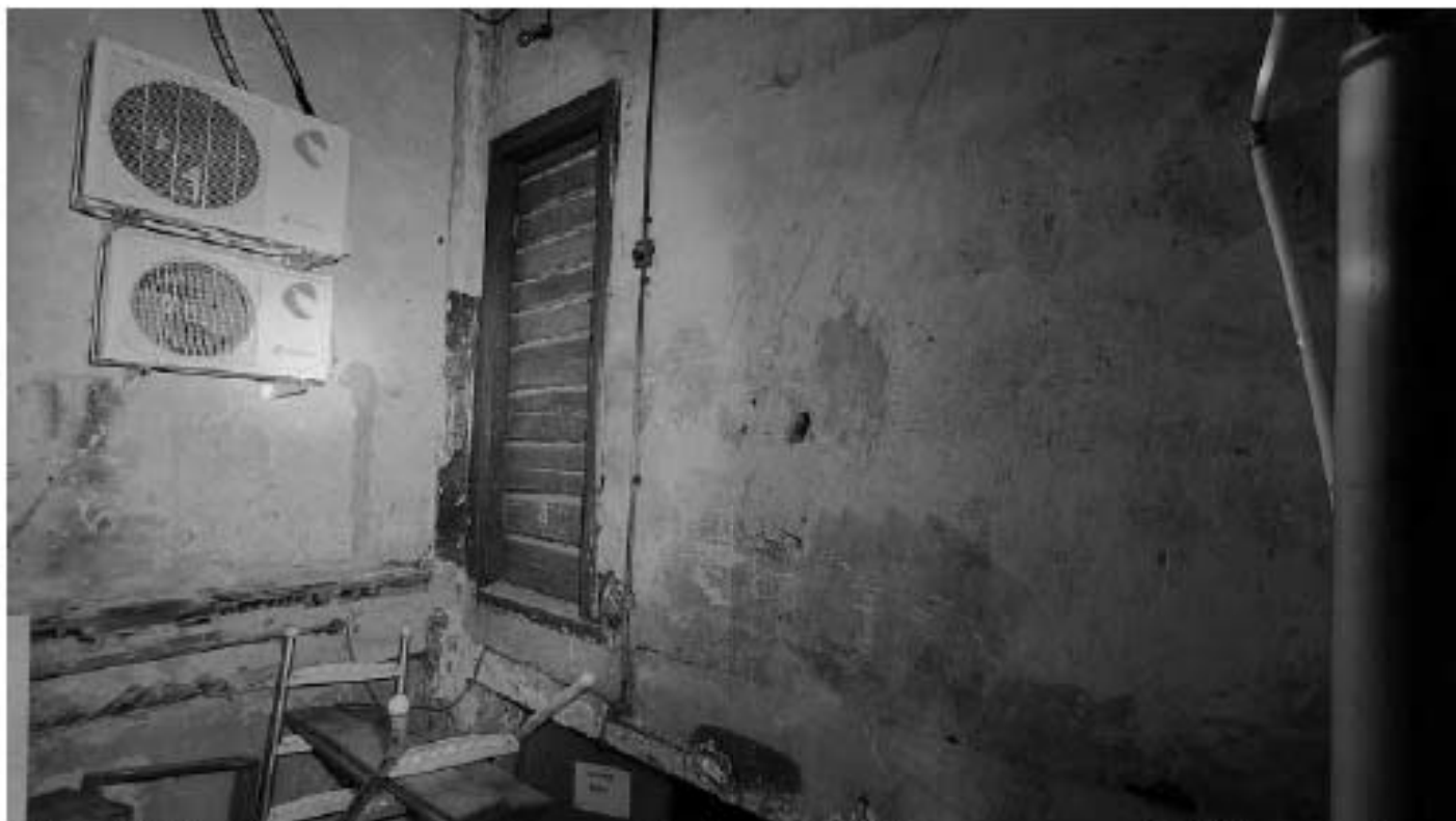
Фото 65. Заложенный портал между служебной лестницей Л6 и помещением 2, 2-Н (уровень 1-го этажа). Общий вид. Дата фотофиксации: 18.03.25
