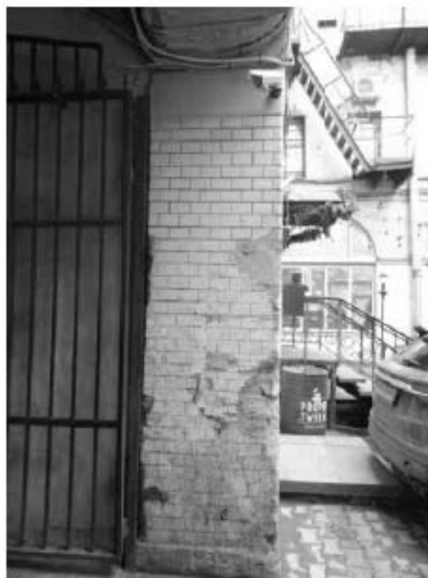
Фото 38. Отделка воротного проезда поперечного флигеля – керамическая глазурованная плитка («кабанчик») бежевого цвета. Фрагмент. Дата фотофиксации: 18.03.25
