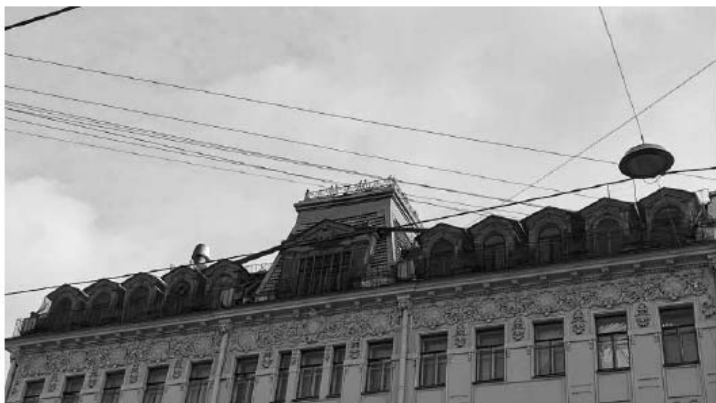
Фото 2. Объёмы мансарды. Общий вид. Дата фотофиксации: 18.03.25
