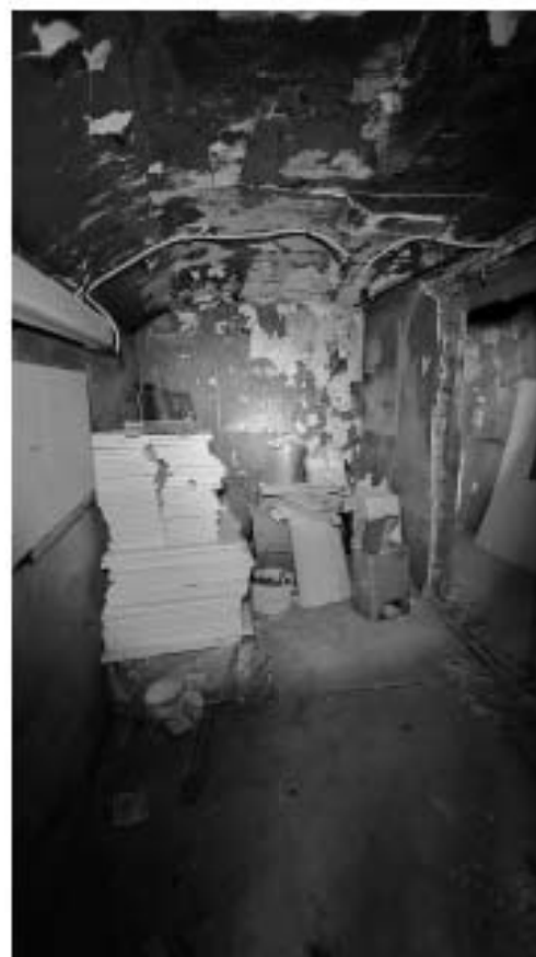
Фото 249. Объём чердака. Фрагмент. Дата фотофиксации: 18.03.25
