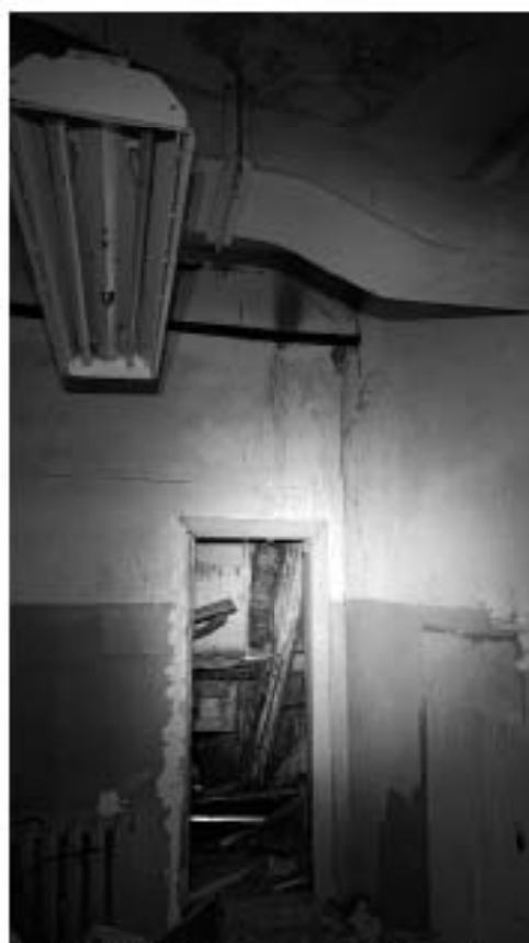
Фото 520. Помещение 2 (41-Н). Общий вид. Дата фотофиксации: 18.03.25
