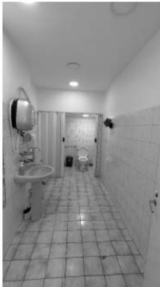
Фото 323. Помещение 6. Общий вид. Дата фотофиксации: 18.03.25
