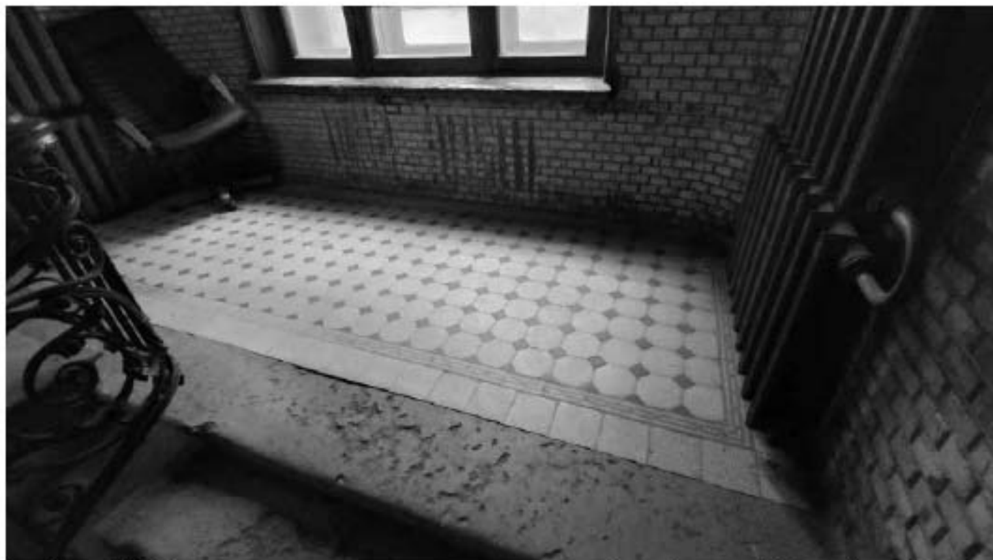
Фото 157. Метлахская плитка в межэтажном пространстве 1-го и 2-го этажей. Общий вид. Дата фотофиксации: 18.03.25
