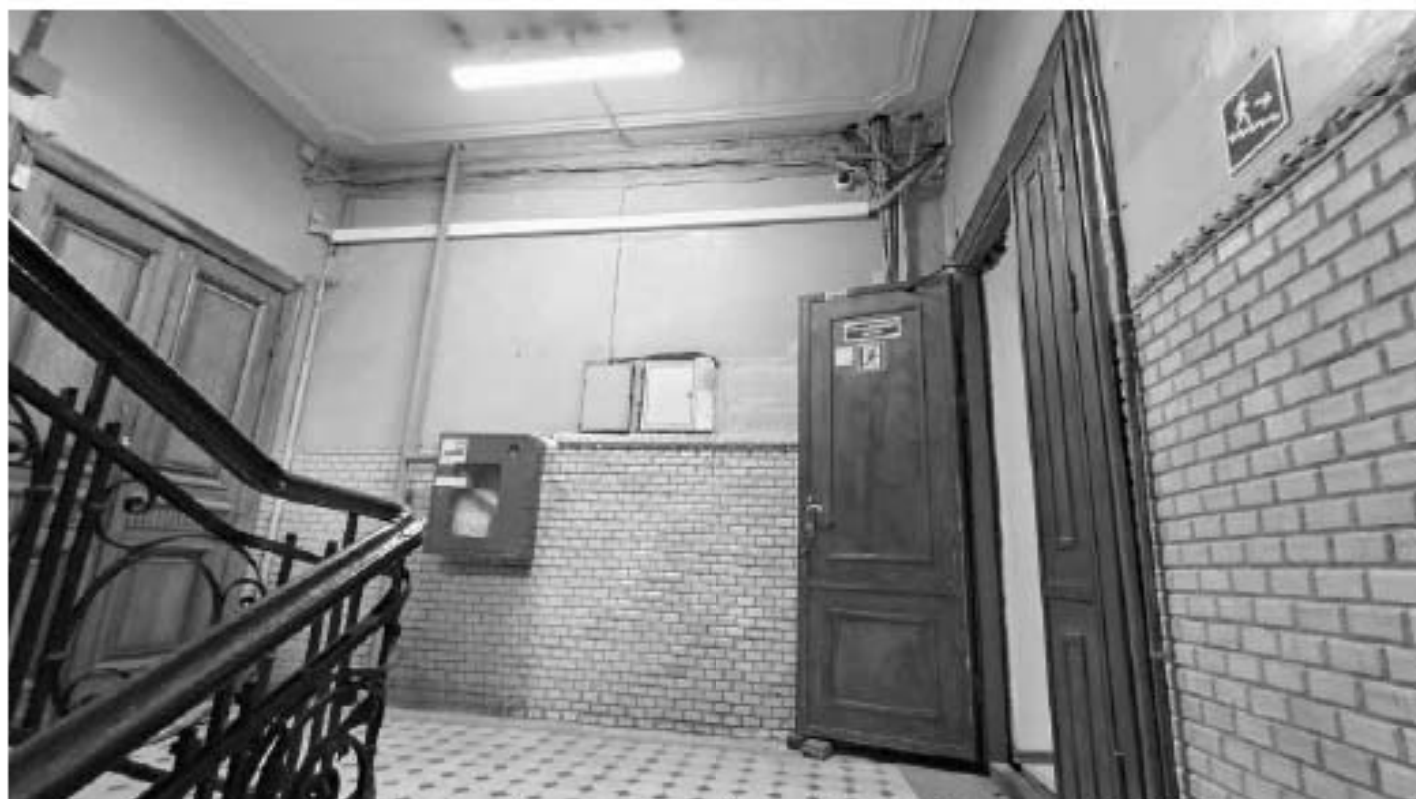
Фото 180. Площадка 4 этажа. Общий вид. Дата фотофиксации: 18.03.25
