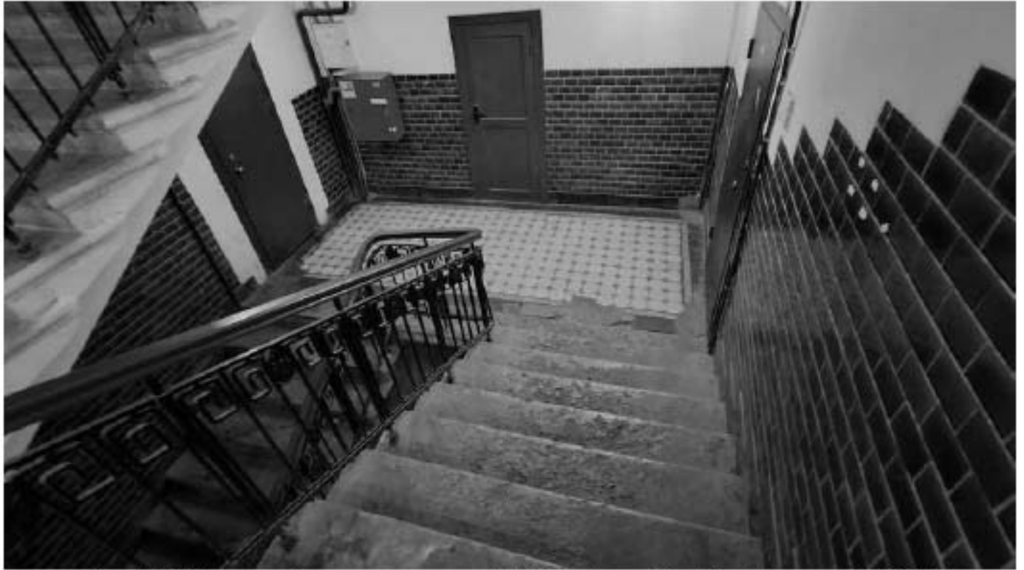
Фото 395. Площадка 2-го этажа лестницы Л5. Общий вид. Дата фотофиксации: 18.03.25
