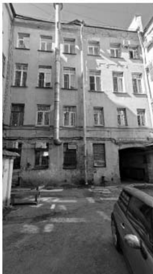
Фото 46. Поперечный флигель. Общий вид со стороны объёма дворового фасада восточного флигеля. Дата фотофиксации: 14.08.25
