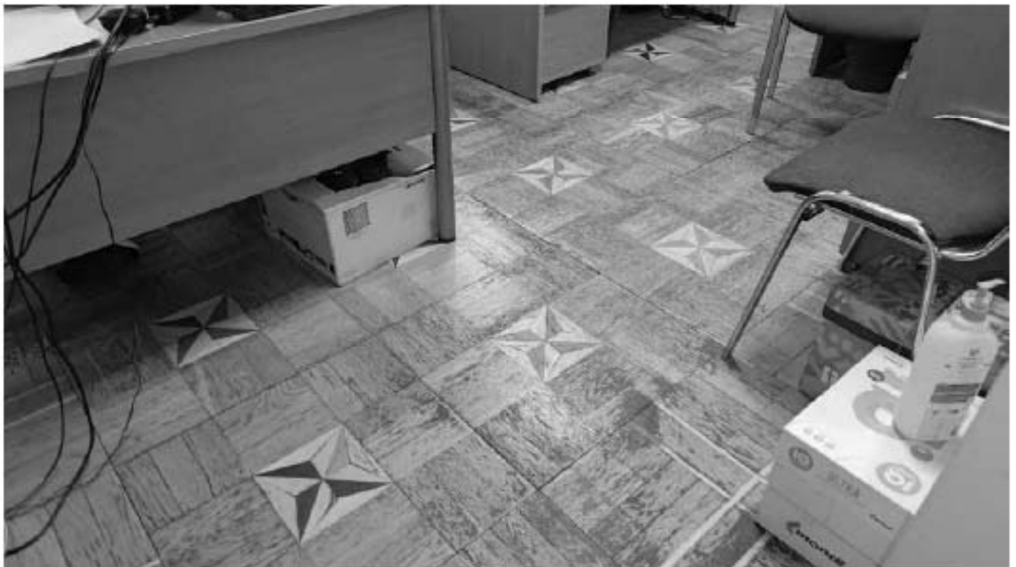
Фото 318. Помещение 18 (21-Н). Исторический паркет из ценных пород дерева (дуб, бук, орех), с рисунком «корзина» и вставками в виде 4-х конечных звезд меньшего размера. Фрагмент. Дата фотофиксации: 18.03.25
