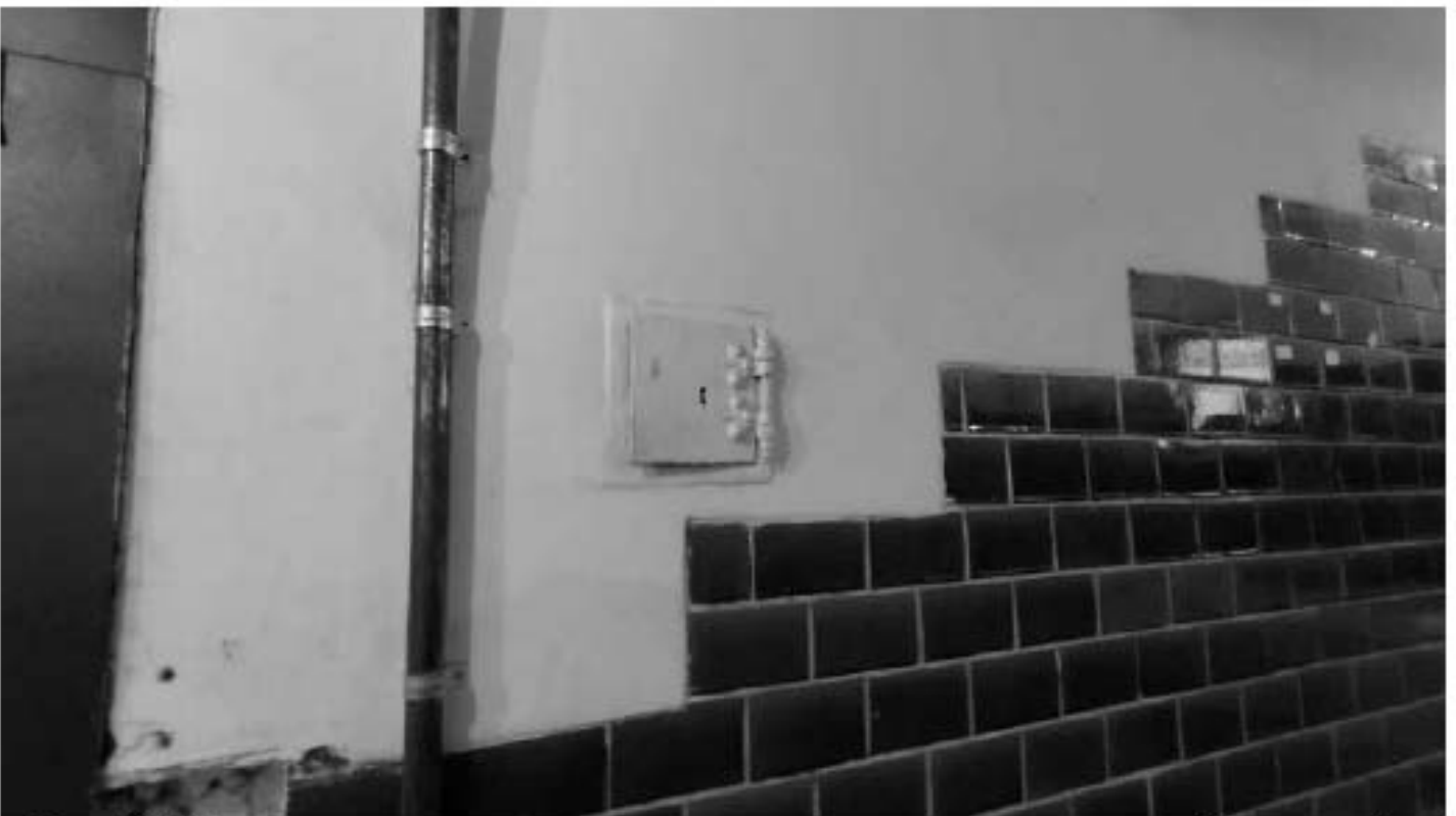
Фото 398. Историческая металлическая дверца слухового отверстия с исторической фурнитурой в уровне 1-го этажа лестницы Л5. Общий вид. Дата фотофиксации: 18.03.25
