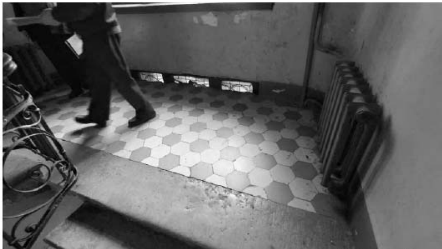
Фото 181. Метлахская плитка в межэтажном пространстве 4-го и 5-го этажей. Общий вид. Дата фотофиксации: 18.03.25
