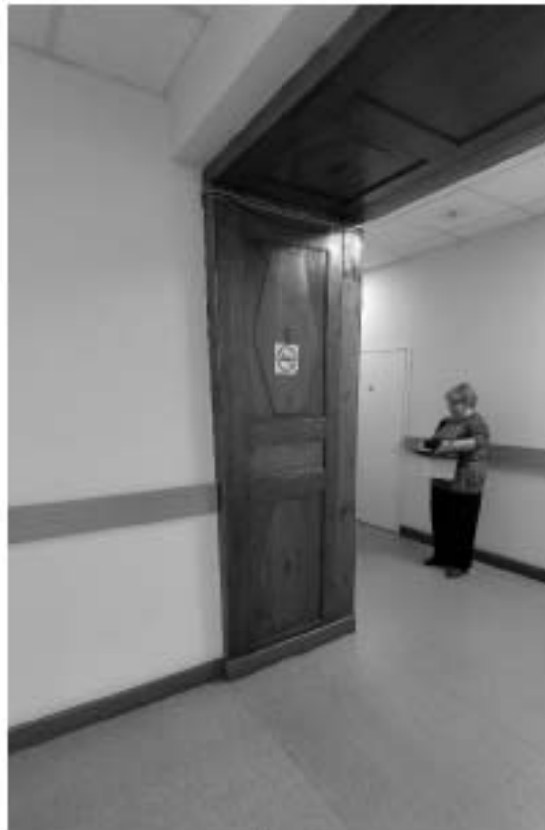
Фото 291. Оформление проема деревянными филленчатыми панелями с усеченными ромбами в филленках с овальной розеткой по центру в технике маркетри. Фрагмент. Дата фотофиксации: 18.03.25
