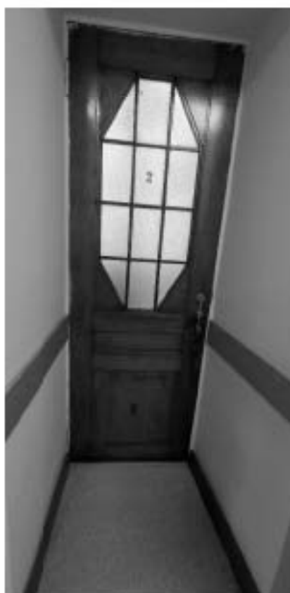
Фото 314. Историческое деревянное дверное заполнение в характере модерна: дверь одностворная, полусветлая, в ниж-ней части глухая филенка с усеченными углами с овальной розеткой в технике маркетри. Общий вид. Дата фотофиксации: 18.03.25
