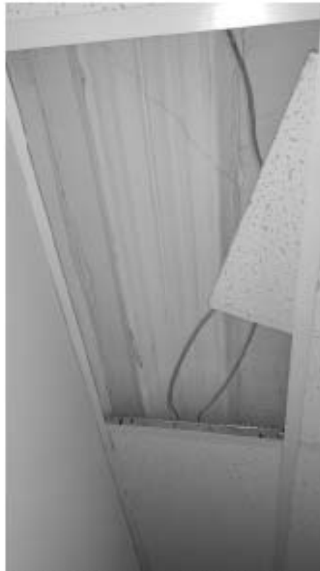
Фото 206. Пространство помещений 6 и 7. Тяги. Фрагмент. Дата фотофиксации: 18.03.25
