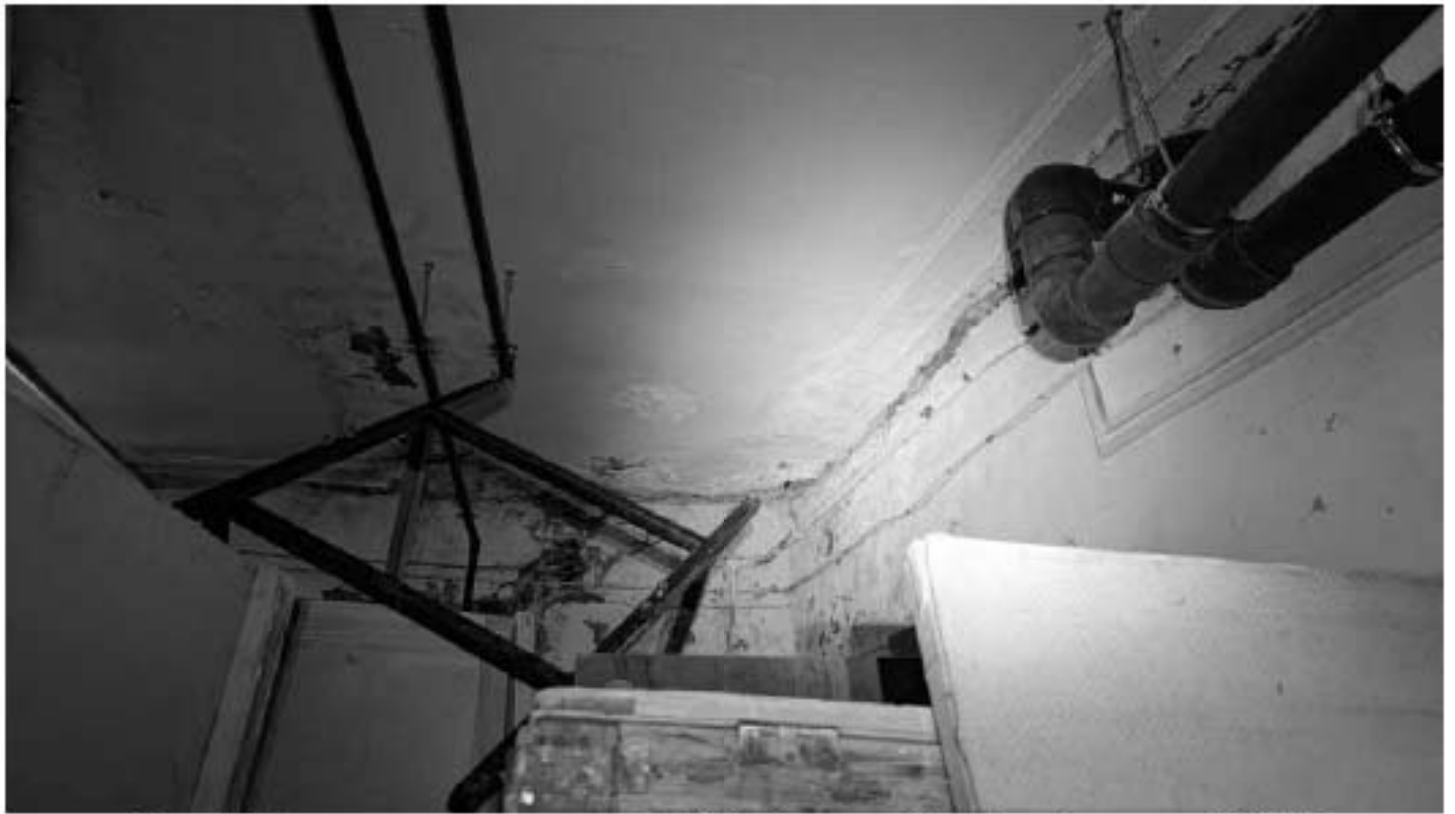
Фото 506. Пространство помещения 4 (40-Н). Фрагмент. Дата фотофиксации: 18.03.25
