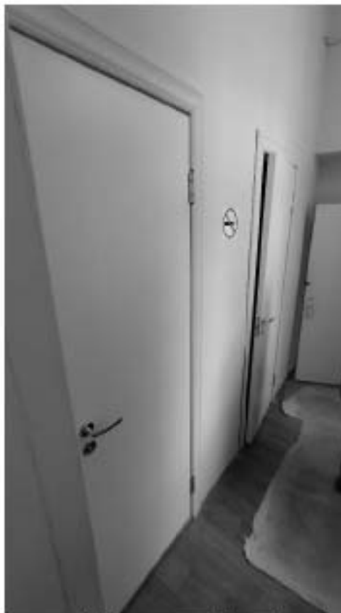
Фото 242. Помещение 15. Фрагмент. Дата фотофиксации: 18.03.25
