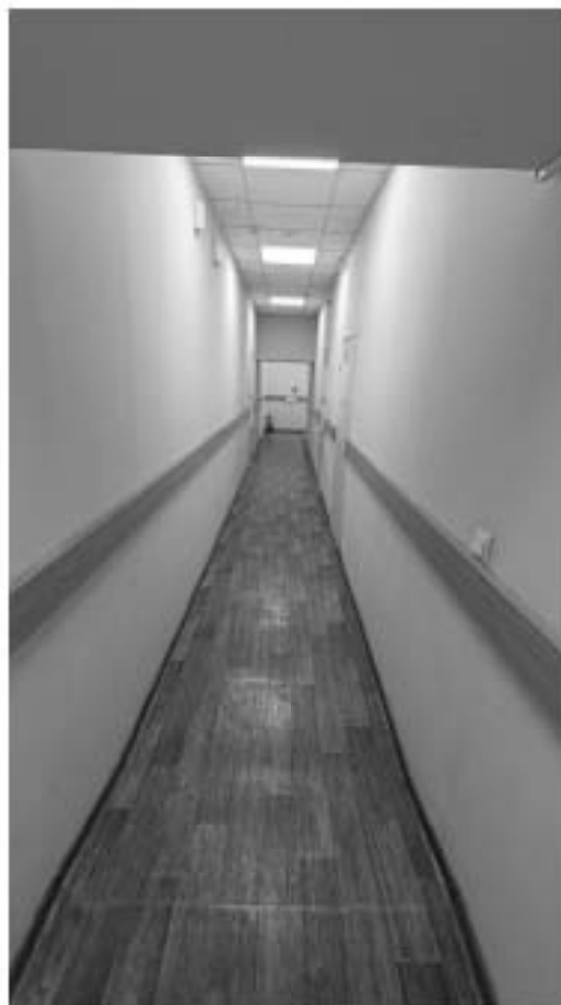
Фото 357. Пространство помещения 31 (23-Н). Общий вид. Дата фотофиксации: 18.03.25
