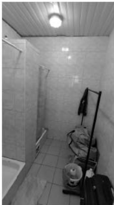
Фото 256. Помещение 5. Общий вид. Дата фотофиксации: 18.03.25
