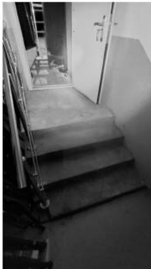
Фото 480. Современная лестница в помещении 6. Общий вид. Дата фотофиксации: 18.03.25
