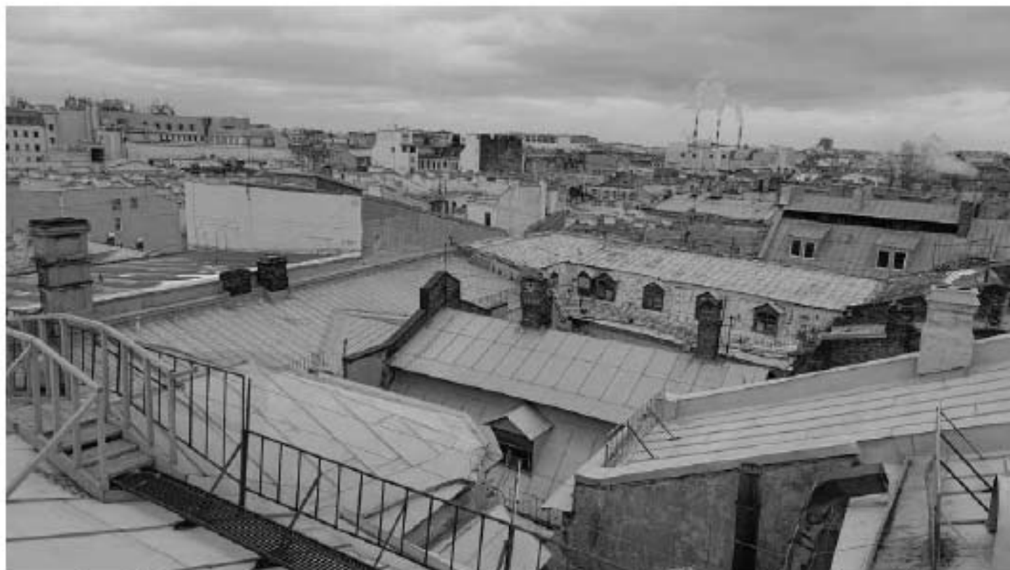
Фото 61. Исторические дымовые трубы поперечного корпуса (флигеля). Общий вид. Дата фотофиксации: 18.03.25
