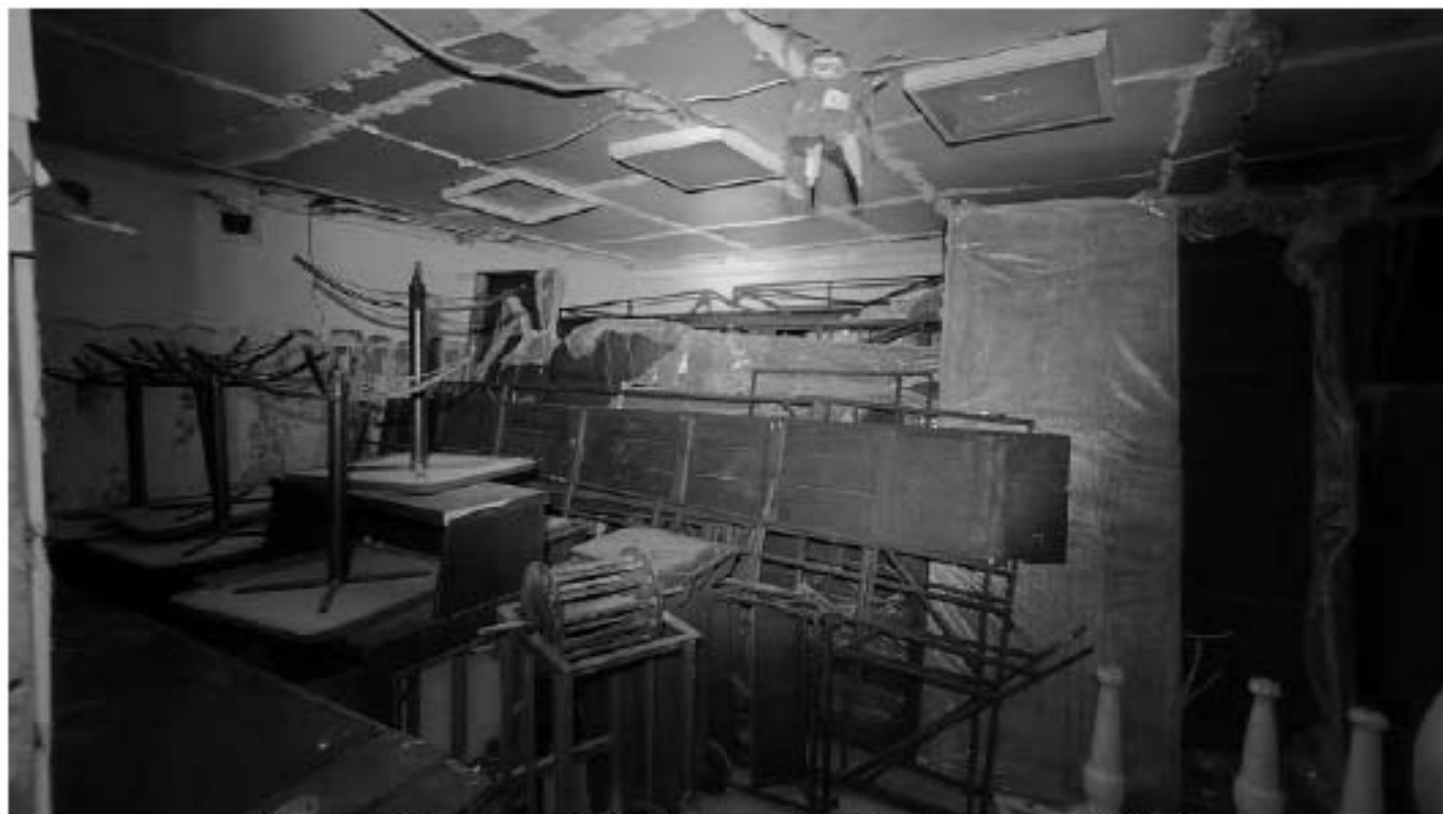
Фото 115. Помещение 12. Общий вид. Дата фотофиксации: 18.03.25
