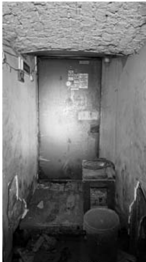
Фото 74. Современное дверное заполнение цоколя 1-Н. Вид со стороны интерьера. Дата фотофиксации: 18.03.25
