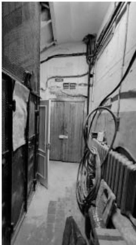
Фото 489. Площадка 1-го этажа. Общий вид. Дата фотофиксации: 18.03.25
