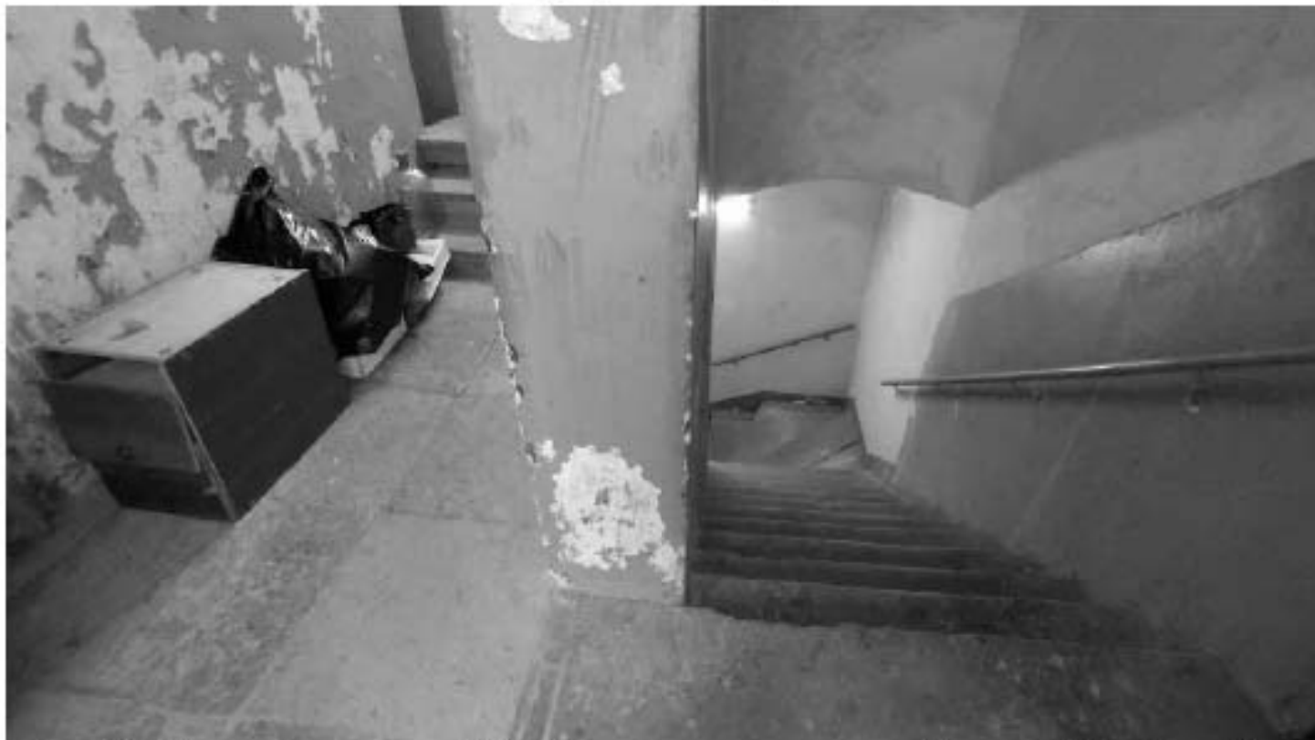
Фото 336. Средистенная лестница ЛЗ с забежными ступенями в уровне 3-го этажа. Общий вид. Дата фотофиксации: 18.03.25
