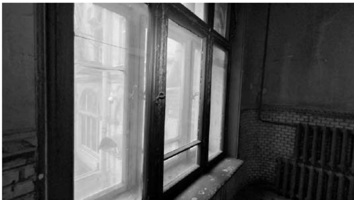
Фото 160. Оконное заполнение в межэтажном пространстве 1-го и 2-го этажей. Общий вид. Дата фотофиксации: 18.03.25
