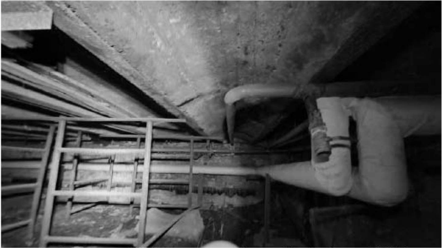
Фото 87. Помещение 1 (33-Н). Прусские своды. Фрагмент. Дата фотофиксации: 14.08.25
