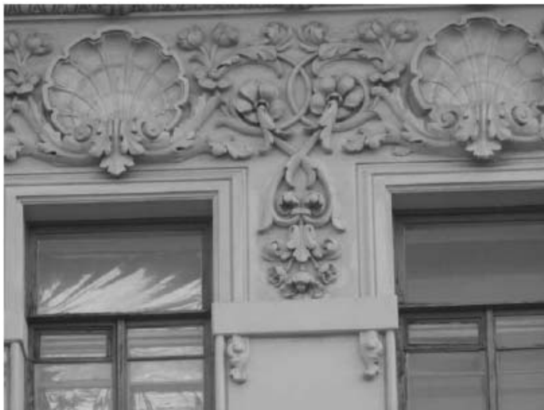
Фото 17. Широкий декоративный лепной фриз в виде перевитых растительных побегов с цветами и листьями, провисающими в межоконные простенки в виде лизенн, с крупными раковинами над оконными проемами в уровне 4-го этажа. Фрагмент. Дата фотофиксации: 18.03.25
