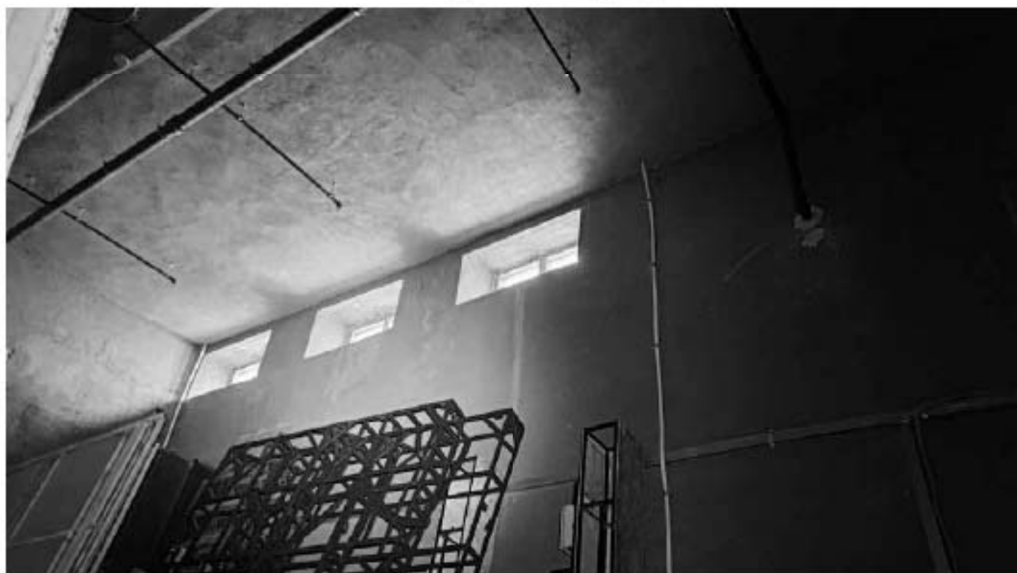
Фото 475. Помещение 4. Фрагмент. Дата фотофиксации: 18.03.25
