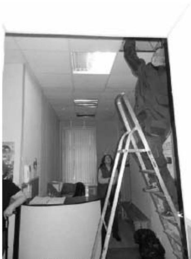
Фото 443. Помещение 35 (16-Н). Фрагмент. Дата фотофиксации: 18.03.25
