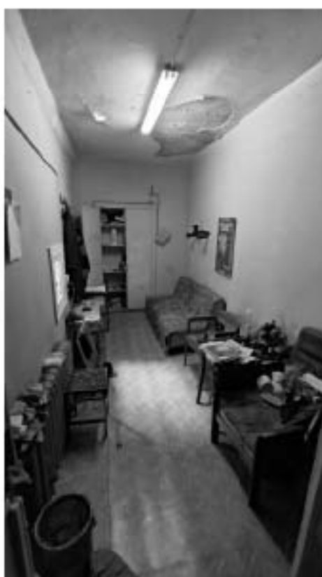
Фото 477. Помещение 2. Общий вид. Дата фотофиксации: 18.03.25
