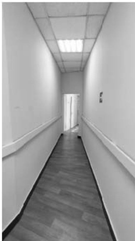
Фото 238. Помещение 9 (24-Н). Фрагмент. Дата фотофиксации: 18.03.25
