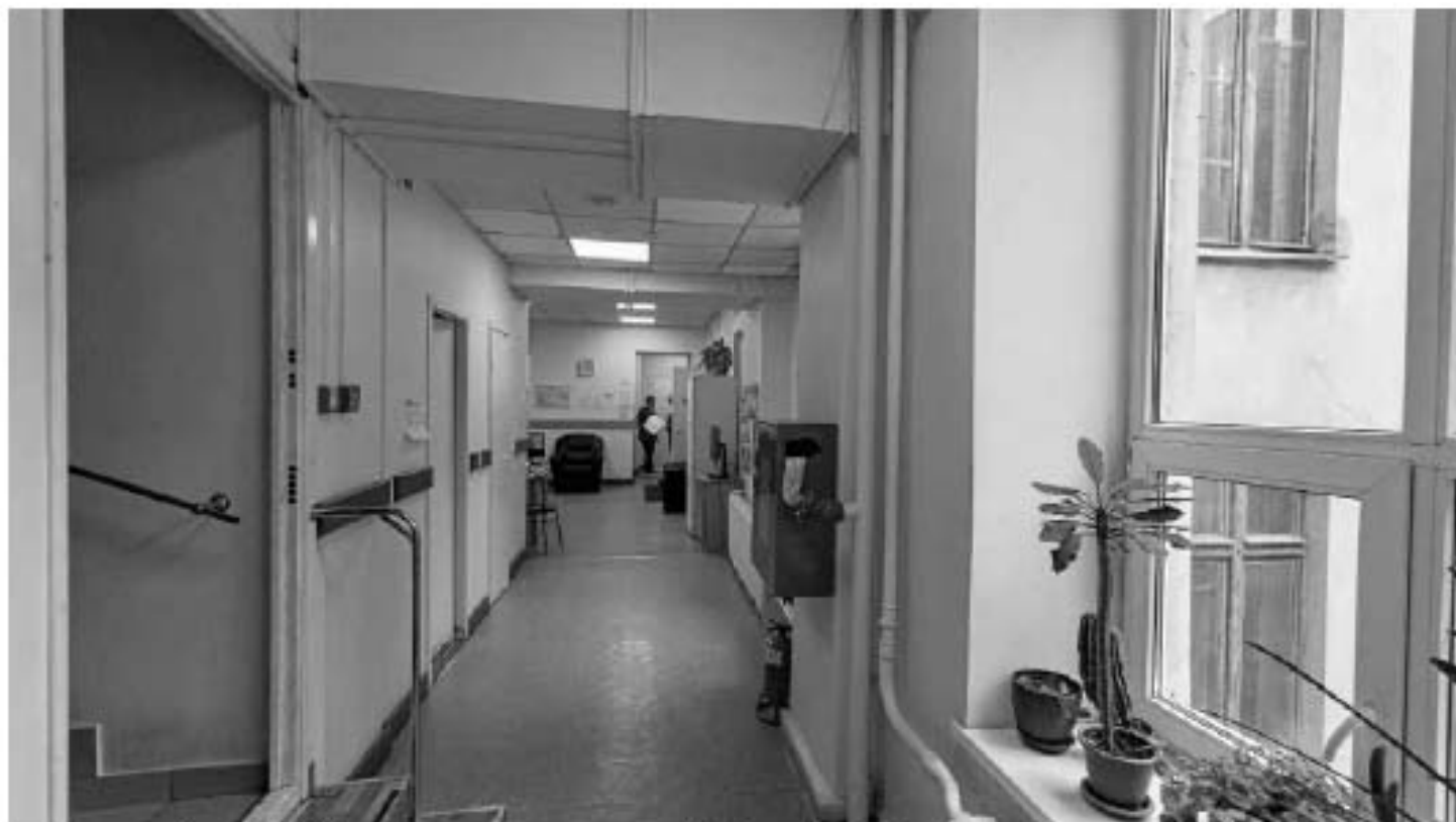
Фото 279. Пространство помещения 4. Общий вид. Дата фотофиксации: 18.03.25
