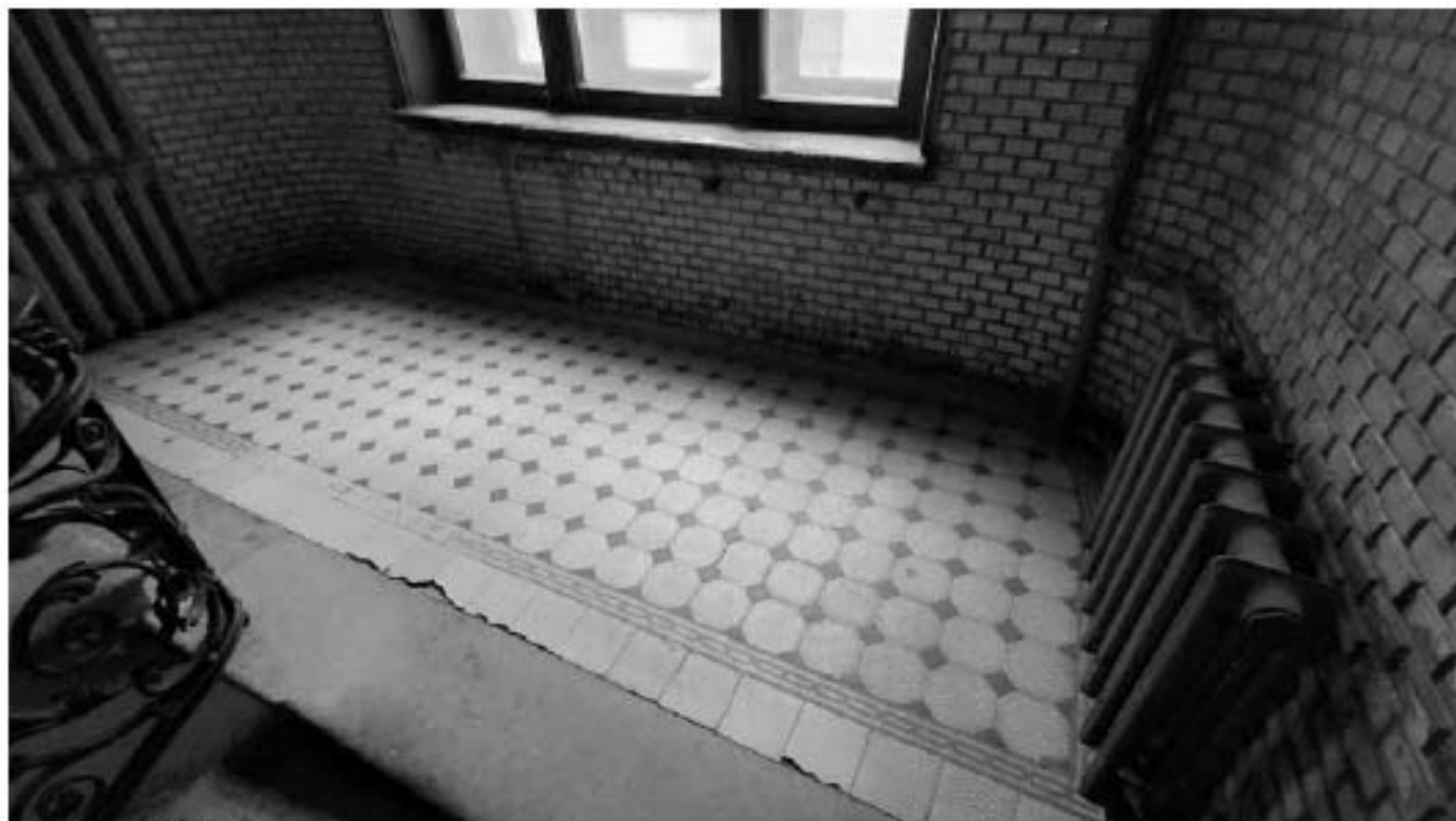
Фото 167. Метлахская плитка в межэтажном пространстве 2-го и 3-го этажей. Общий вид. Дата фотофиксации: 18.03.25
