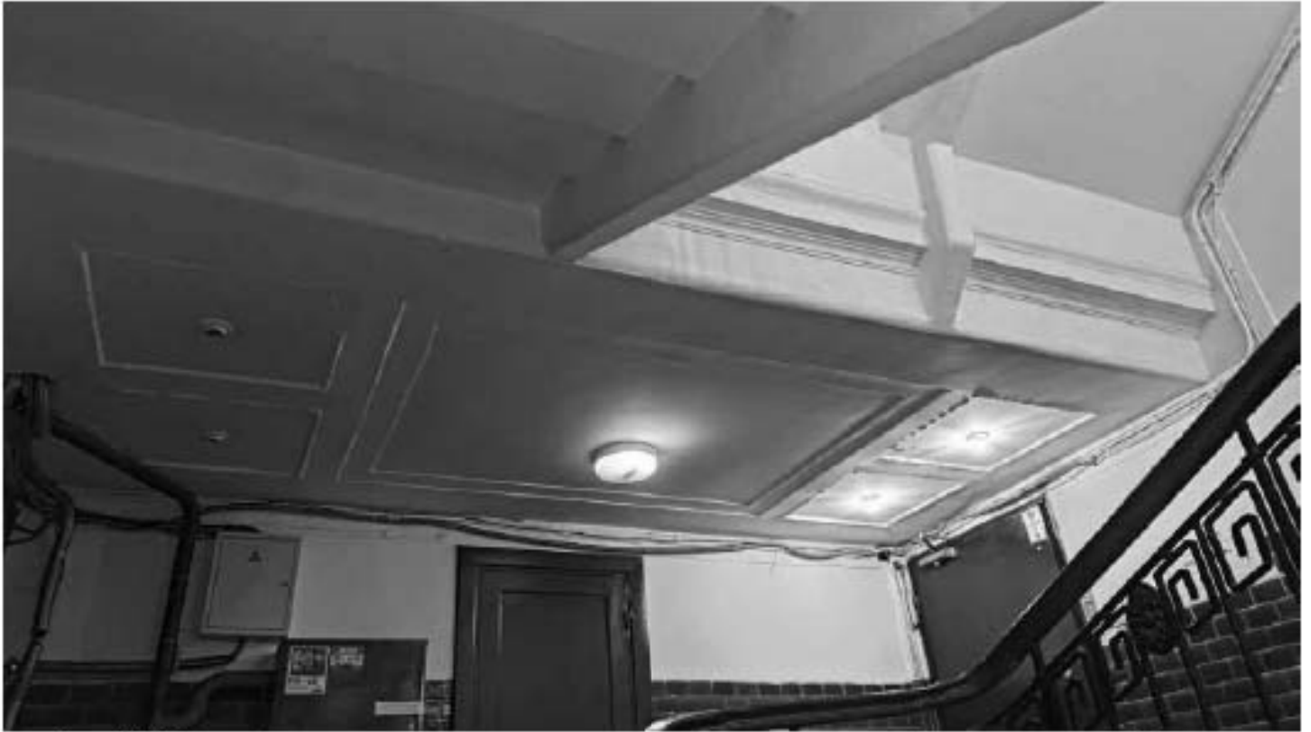
Фото 393. Разноформатные кассоны, в центре с уступчатым краем, в обрамлении лепной порезки «бусь» на площадке 2-го этажа лестницы Л5. Общий вид. Дата фотофиксации: 18.03.25
