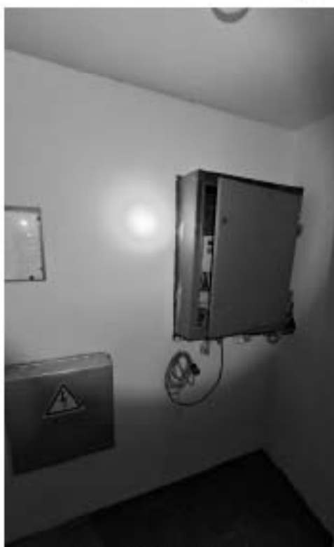
Фото 490. Пространство помещений 1 и 2 (13-Н). Фрагмент. Дата фотофиксации: 18.03.25
