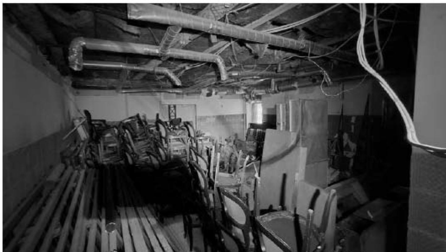
Фото 108. Помещение 4. Фрагмент. Дата фотофиксации: 18.03.25
