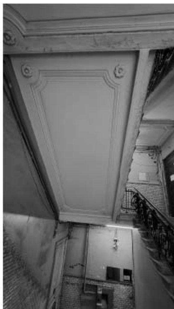
Фото 158. Косоуры с лепным декором. Общий вид. Дата фотофиксации: 18.03.25
