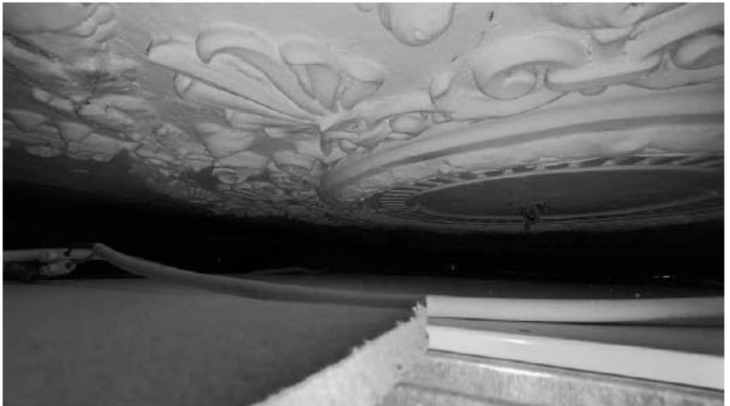
Фото 284. Розетка с декоративным оформлением в пространстве помещений 12 и 13 (21-Н). Фрагмент. Дата фотофиксации: 18.03.25
