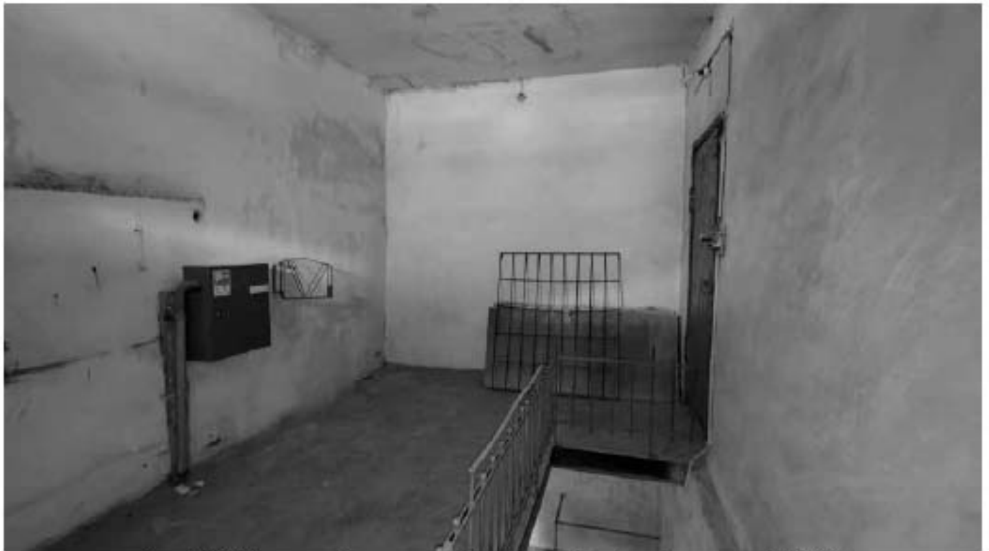
Фото 353. Площадка 5-го этажа. Общий вид. Дата фотофиксации: 18.03.25
