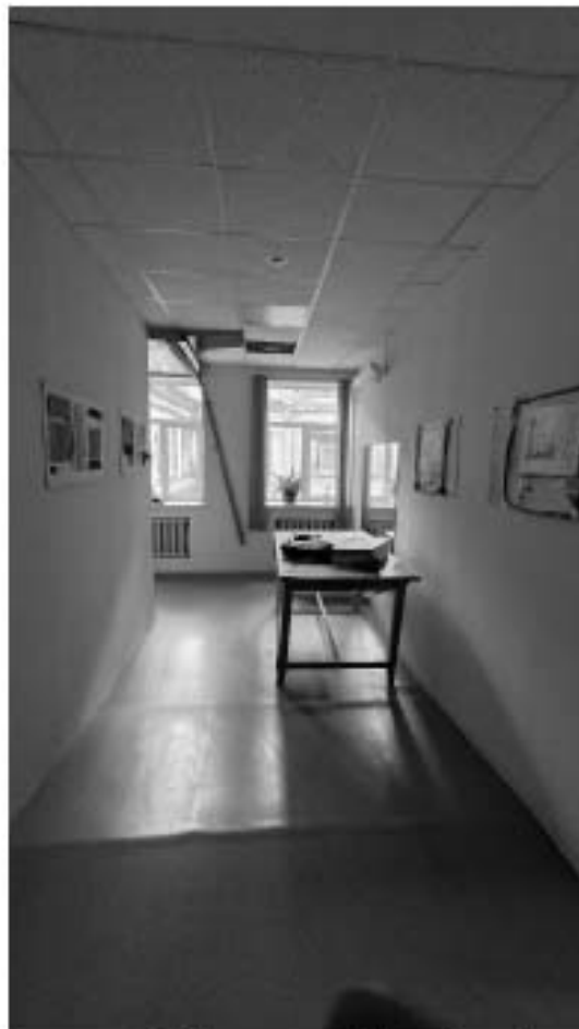
Фото 232. Помещение 22. Фрагмент. Дата фотофиксации: 18.03.25
