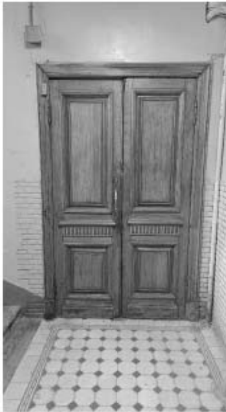
Фото 177. Историческое дверное заполнение в уровне 4-го этажа. Общий вид. Дата фотофиксации: 18.03.25
