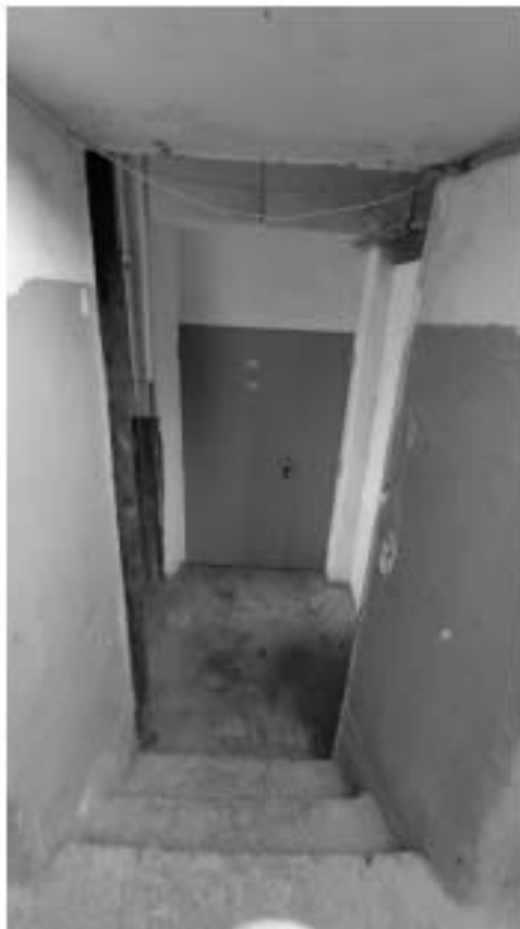
Фото 348. Помещение 8 (38-Н). Фрагмент. Дата фотофиксации: 18.03.25
