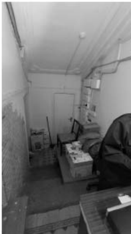
Фото 147. Объем под лестницей. Общий вид. Дата фотофиксации: 18.03.25
