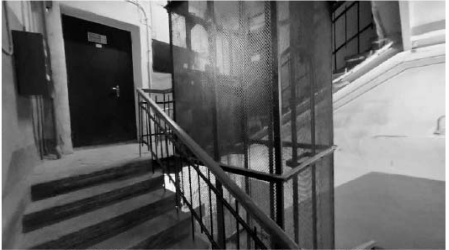
Фото 497. Площадка 4-го этажа. Фрагмент. Дата фотофиксации: 18.03.25
