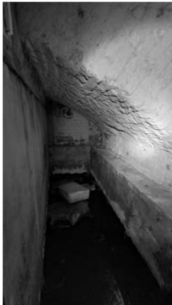
Фото 77. Пространство помещений 3 и 7. Цилиндрические с распалубками своды. Фрагмент. Дата фотофиксации: 18.03.25
