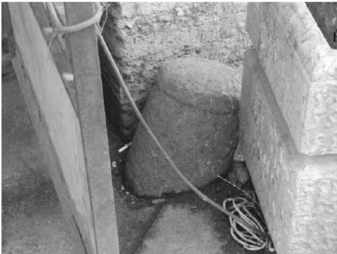
Фото 13. Историческая отбойная тумба в правой части воротного проезда. Общий вид. Дата фотофиксации: 18.03.25
