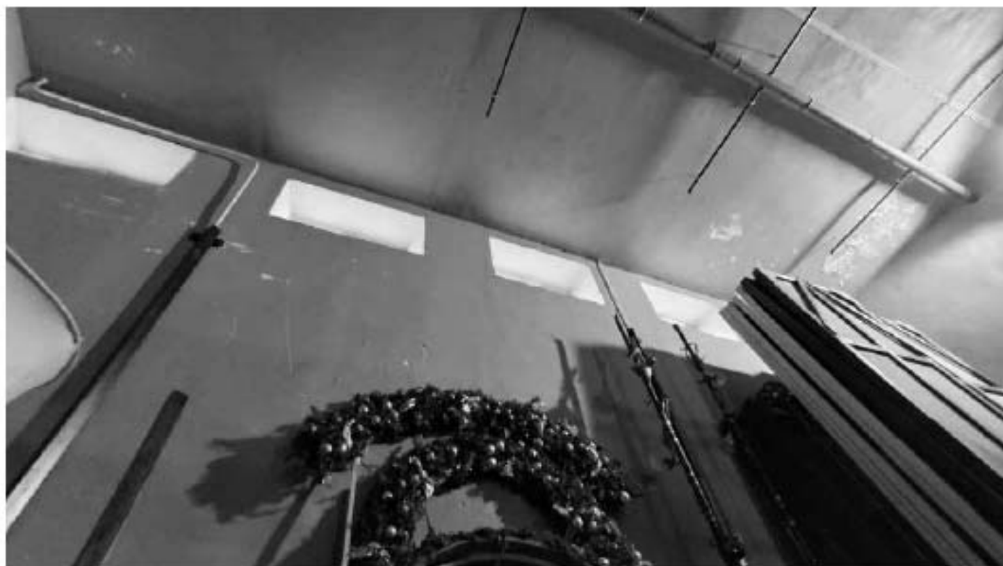
Фото 479. Помещение 5. Фрагмент. Дата фотофиксации: 18.03.25
