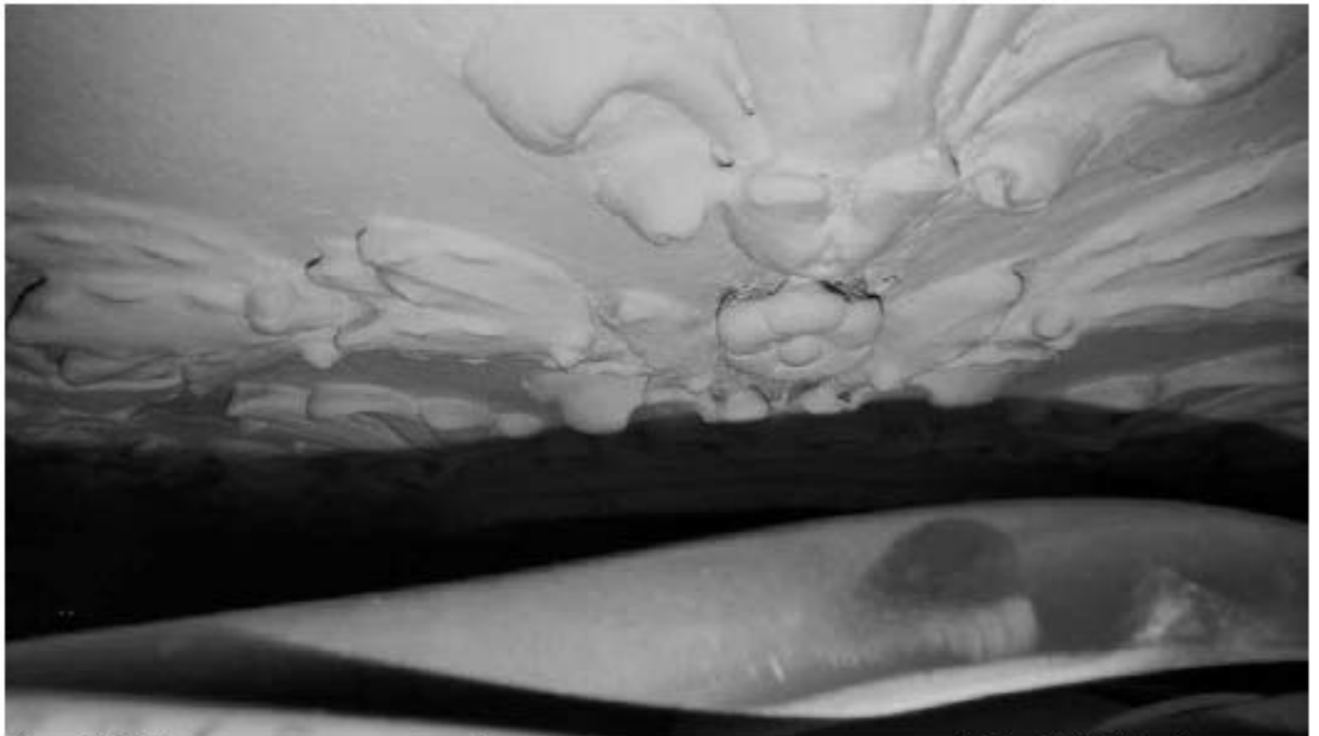
Фото 285. Розетка с декоративным оформлением в пространстве помещений 12 и 13 (21-Н). Фрагмент. Дата фотофиксации: 18.03.25
