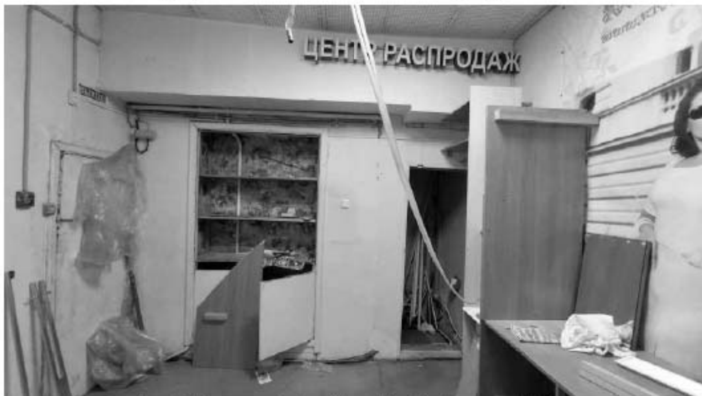
Фото 95. Помещение 3. Общий вид. Дата фотофиксации: 18.03.25
