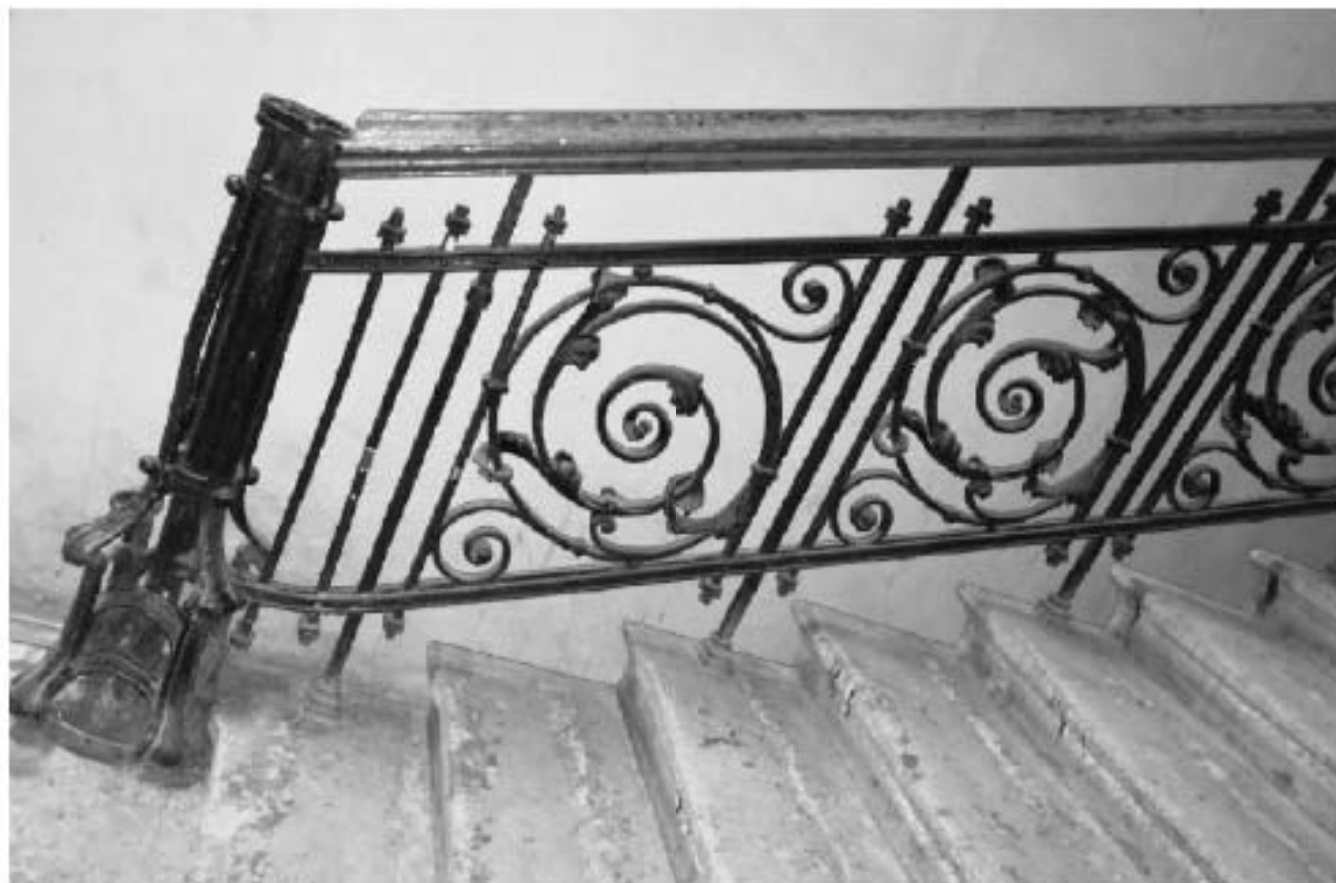
Илл. 30. Ограждение парадной лестницы.
