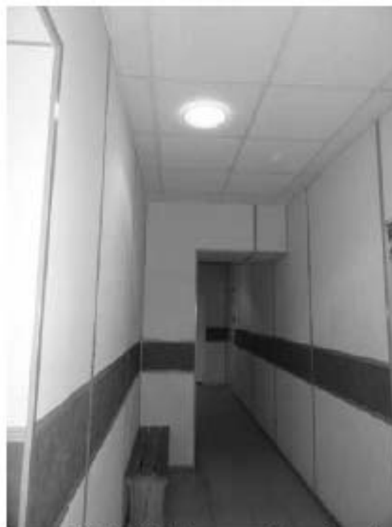
Фото 444. Помещение 31 (16-Н). Фрагмент. Дата фотофиксации: 18.03.25
