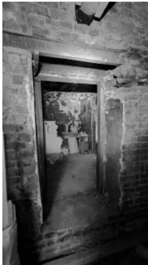
Фото 248. Портал в чердачный объём. Общий вид. Дата фотофиксации: 18.03.25
