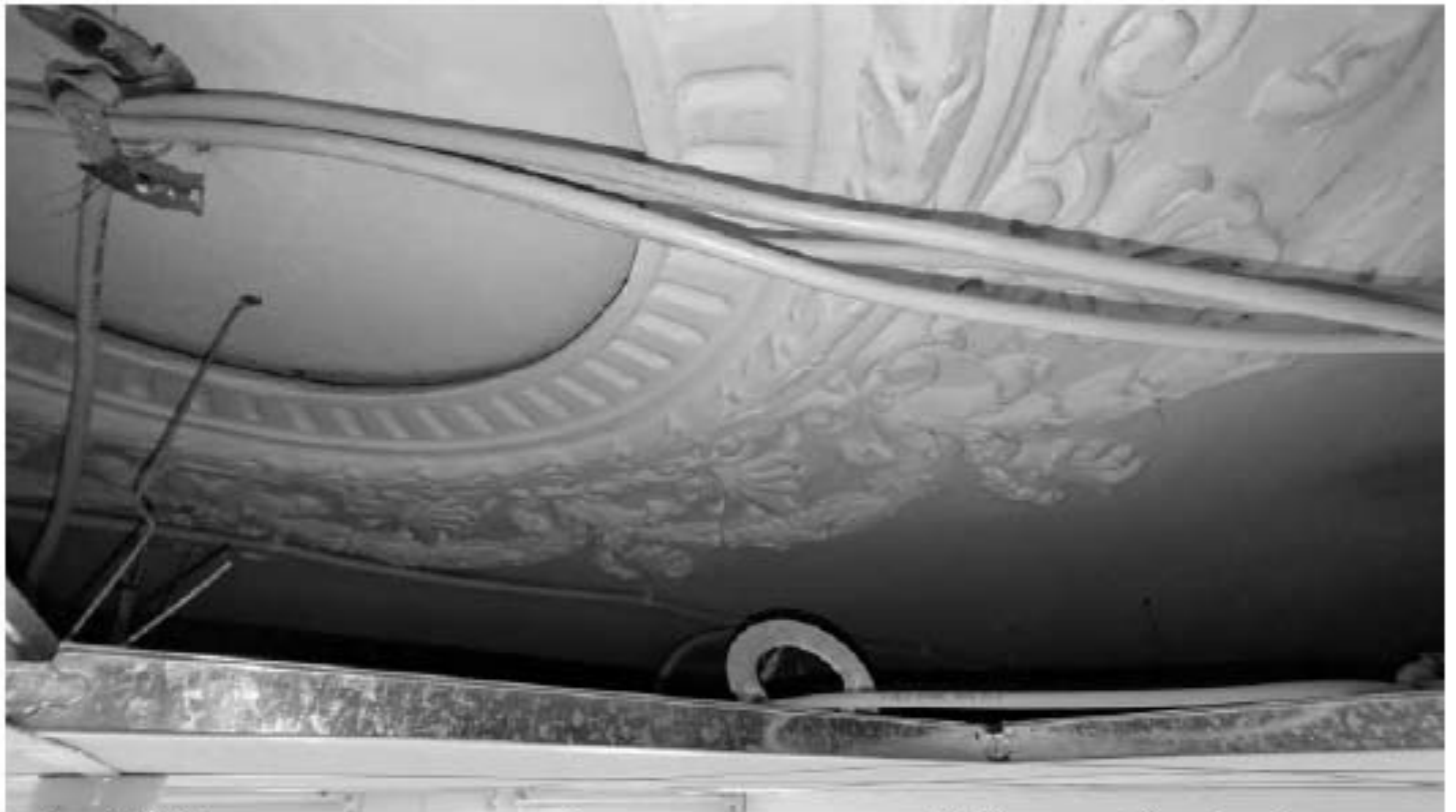
Фото 299. Розетка с декорированным оформлением в помещении 17. Фрагмент. Дата фотофиксации: 18.03.25
