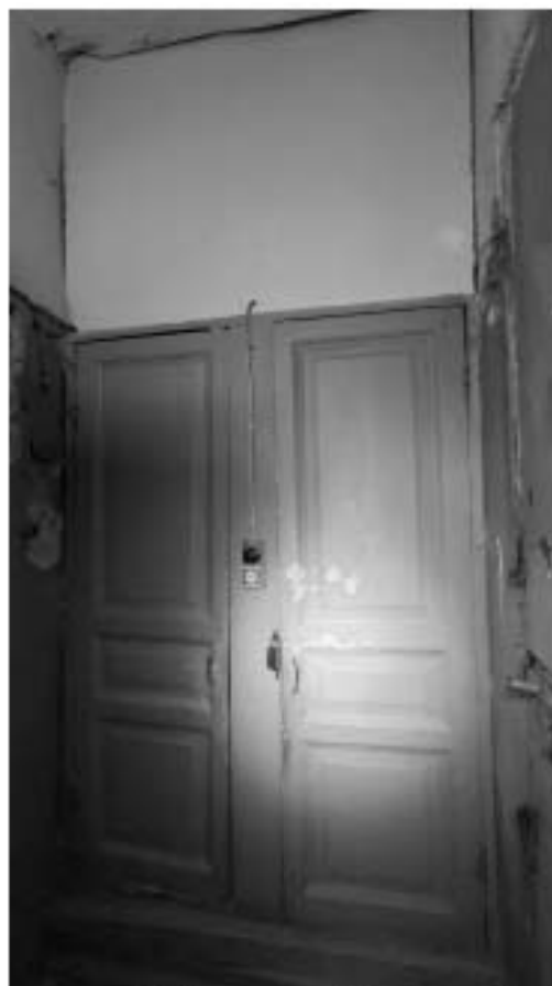
Фото 514. Помещение 1. Фрагмент. Дата фотофиксации: 18.03.25
