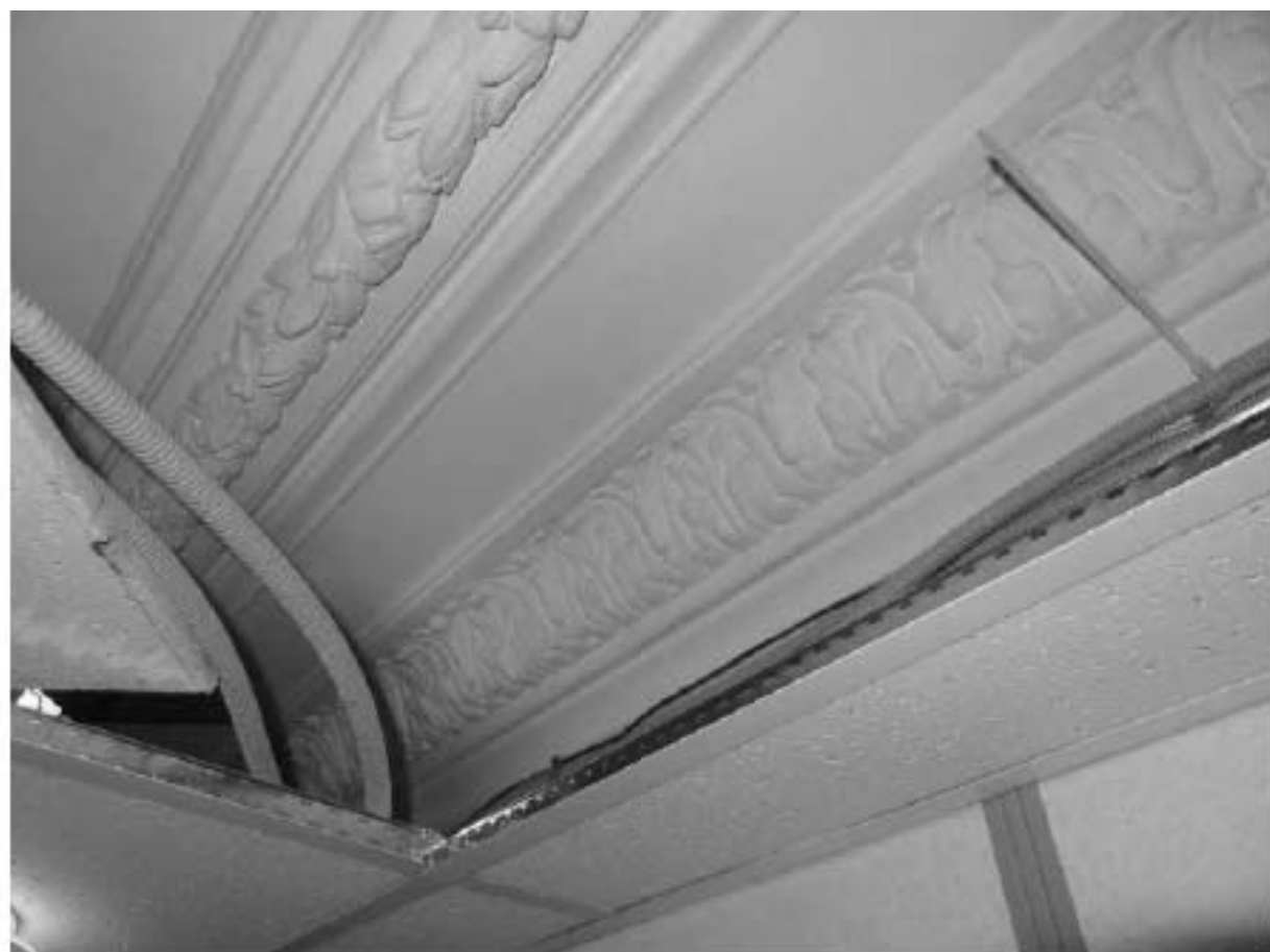
Фото 424. Лепные порезки и тяги в помещениях 1, 2 (16-Н). Фрагмент. Дата фотофиксации: 18.03.25
