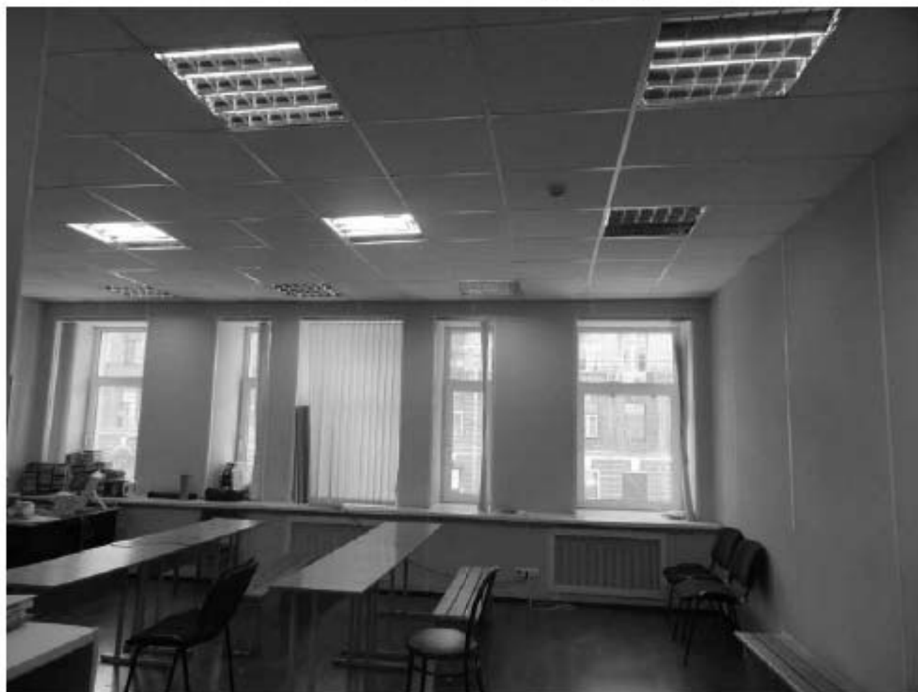
Фото 438. Пространство помещений 15-17. (16-Н). Общий вид. Дата фотофиксации: 18.03.25
