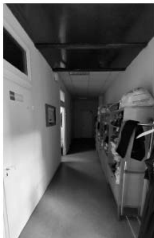
Фото 233. Помещение 22. Фрагмент. Дата фотофиксации: 18.03.25
