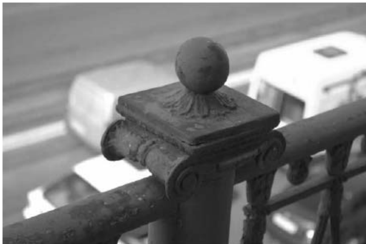
Фото 11. Завершение колонки – гладкий шар. Общий вид. Дата фотофиксации: 14.08.25
