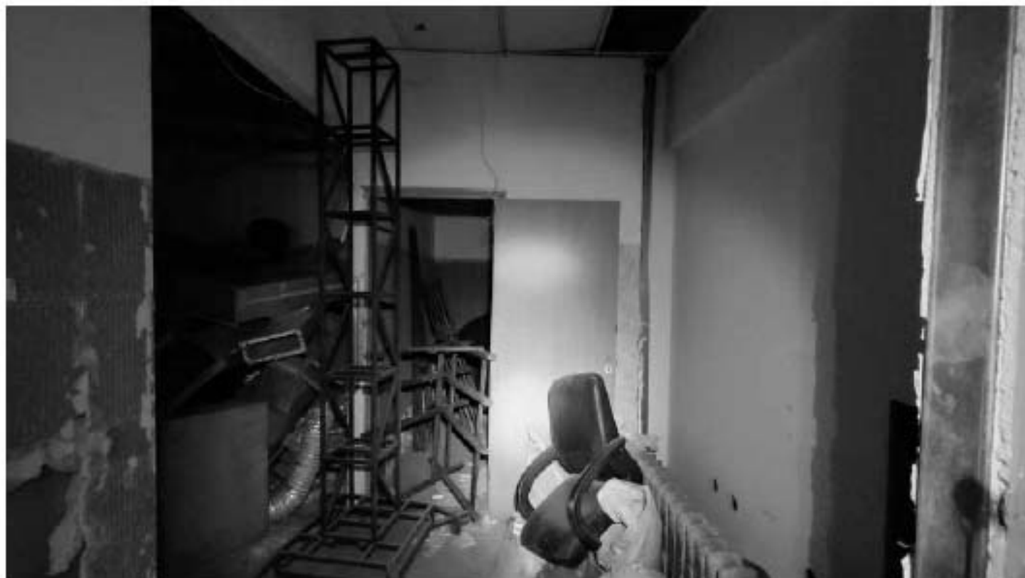
Фото 106. Помещение 4. Фрагмент. Дата фотофиксации: 18.03.25
