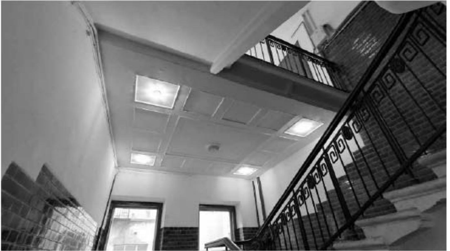
Фото 391. Разноформатные кассоны, в центре с уступчатым краем, в обрамлении лепной порезки «бусь» на площадке межэтажного пространства 1-го и 2-го этажей лестницы Л5. Общий вид. Дата фотофиксации: 18.03.25
