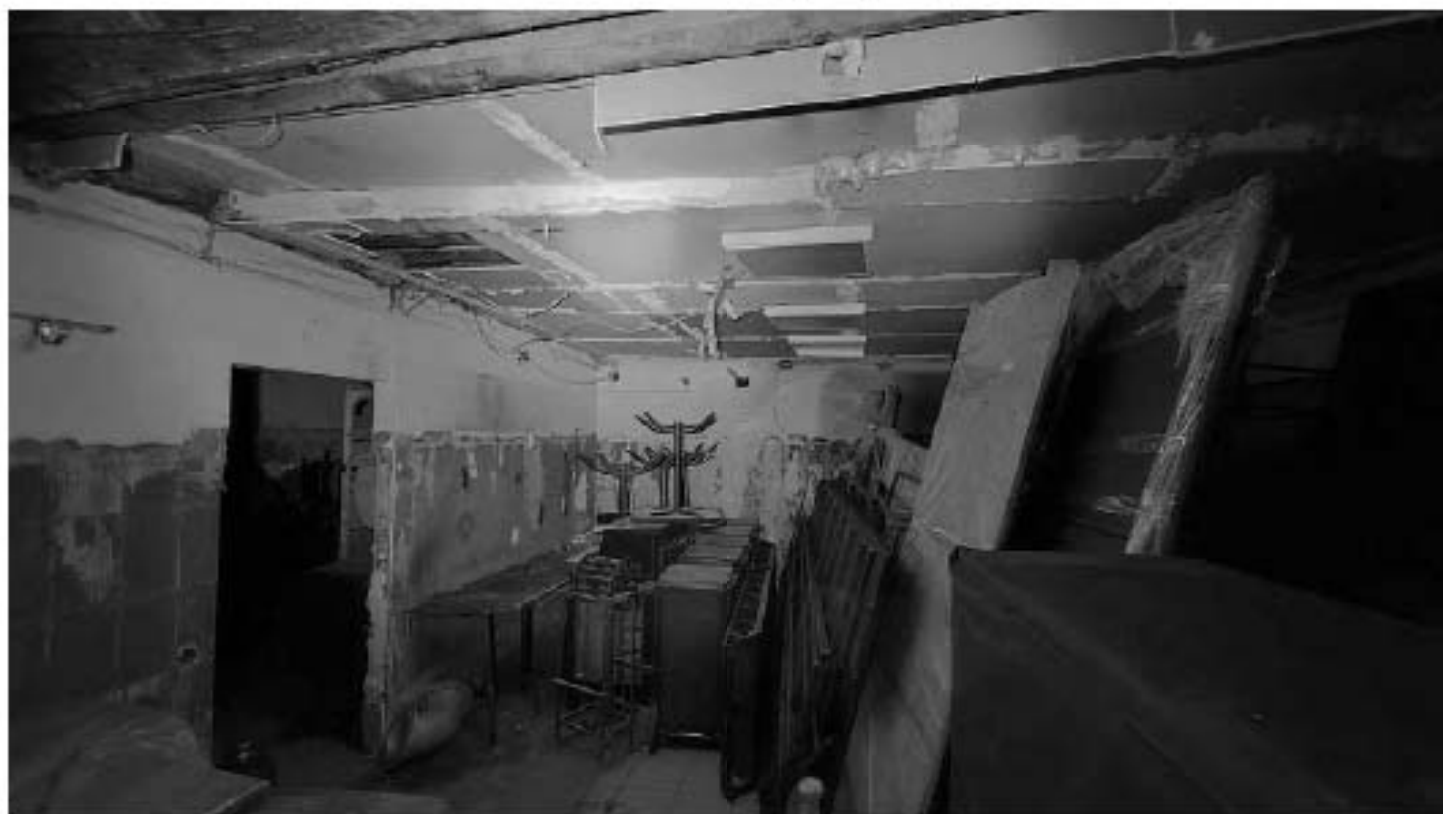
Фото 116. Помещение 12. Фрагмент. Дата фотофиксации: 18.03.25
