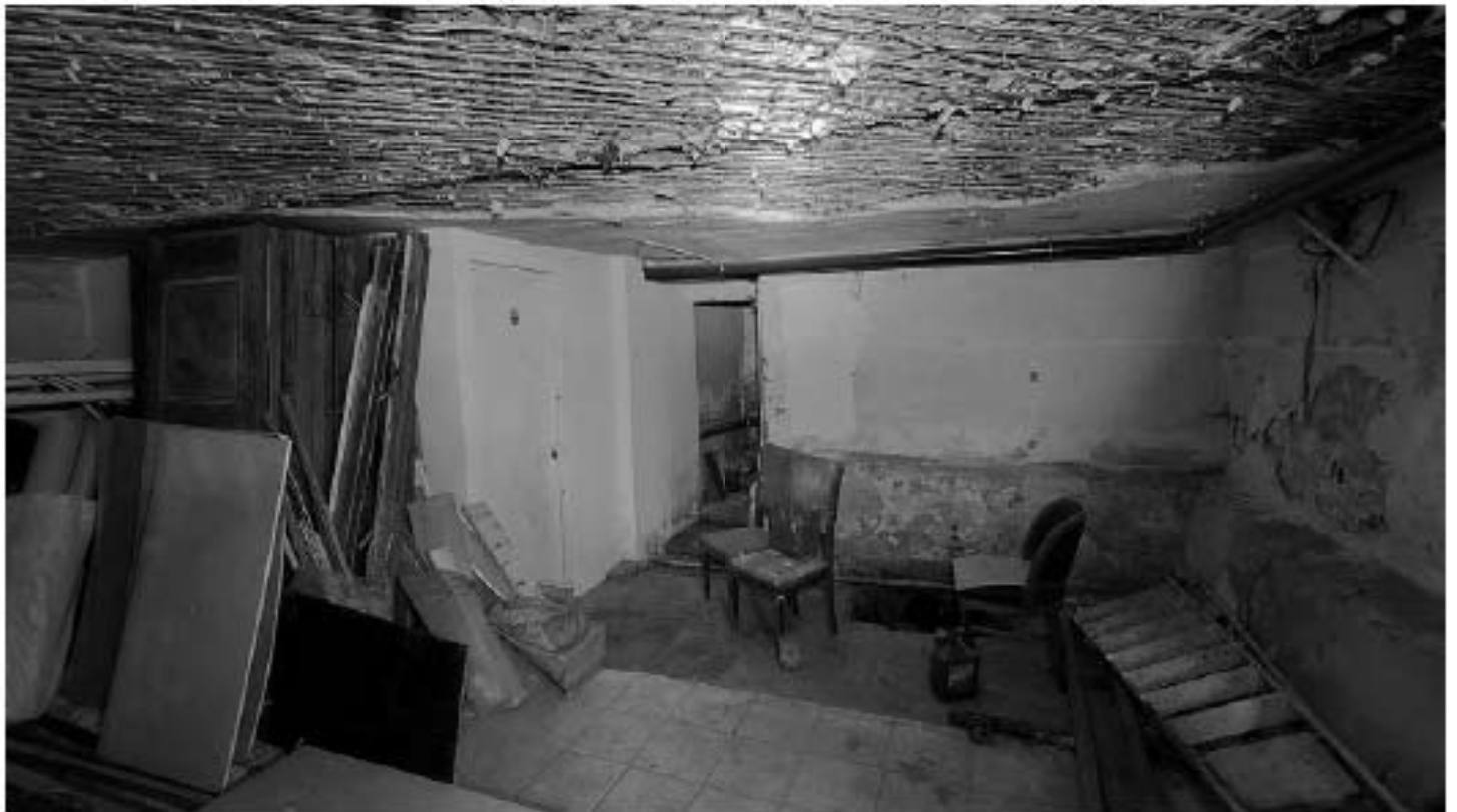
Фото 70. Портал между помещениями 3 и 7. Общий вид. Дата фотофиксации: 18.03.25
