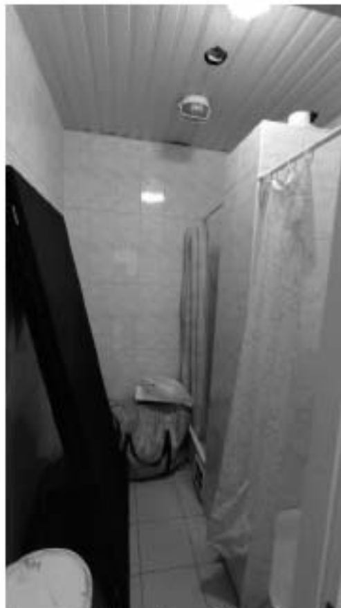
Фото 258. Помещение 3. Общий вид. Дата фотофиксации: 18.03.25
