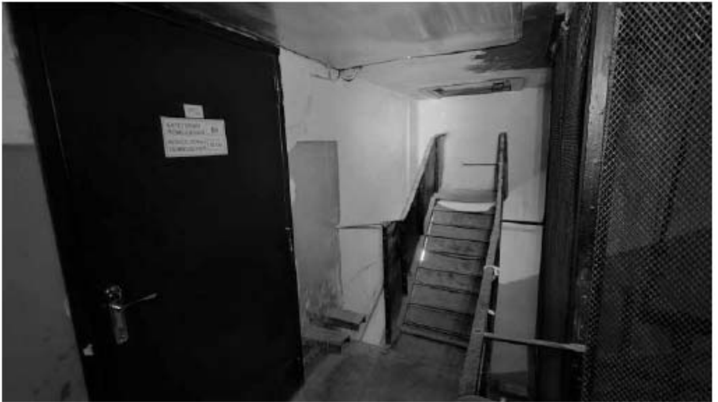
Фото 501. Ступени в антресоль на площадке 5-го этажа. Общий вид. Дата фотофиксации: 18.03.25
