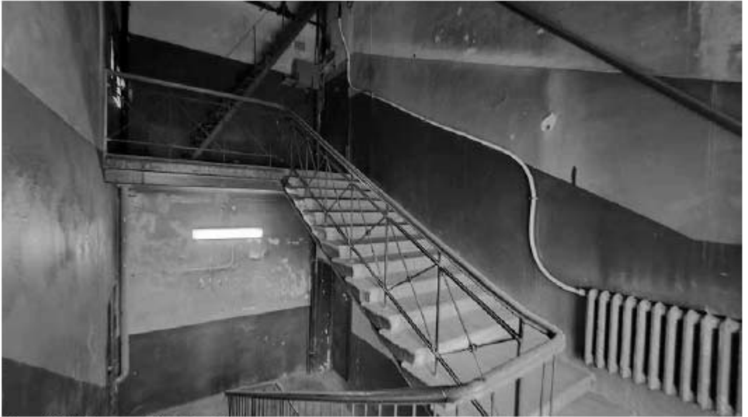
Фото 379. Лестница Л2. Общий вид со стороны межэтажного пространства 5-го этажа и мансарды. Дата фотофиксации: 18.03.25
