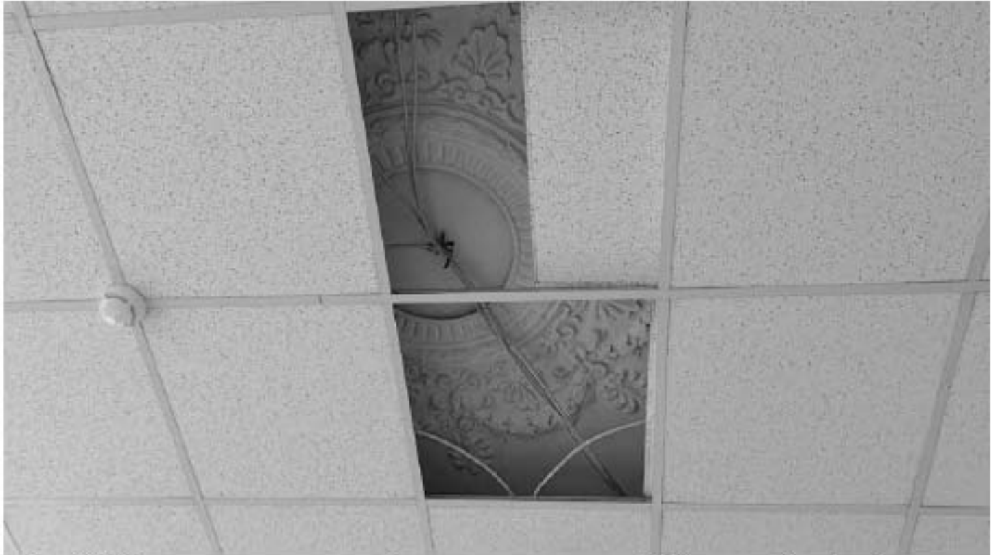
Фото 297. Розетка с декорированным оформлением в помещении 17. Фрагмент. Дата фотофиксации: 18.03.25
