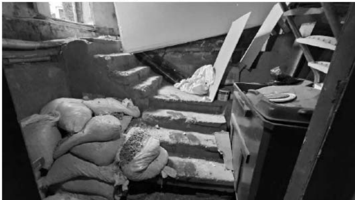
Фото 63. Служебная лестница Л6. Общий вид. Дата фотофиксации: 14.08.25
