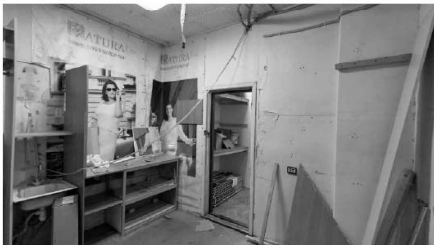
Фото 97. Помещение 3. Общий вид. Дата фотофиксации: 18.03.25
