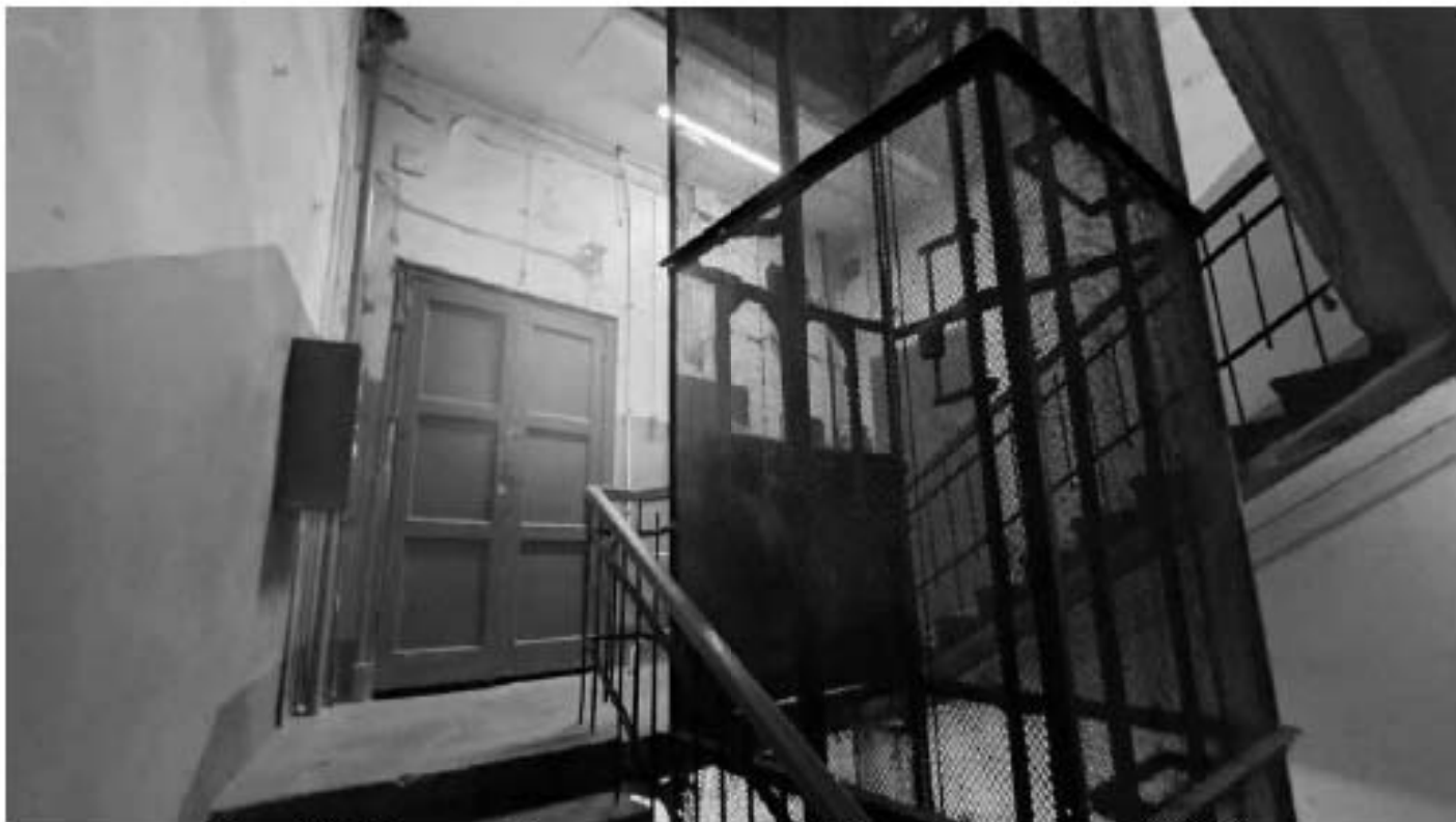
Фото 493. Площадка 3-го этажа. Фрагмент. Дата фотофиксации: 18.03.25
