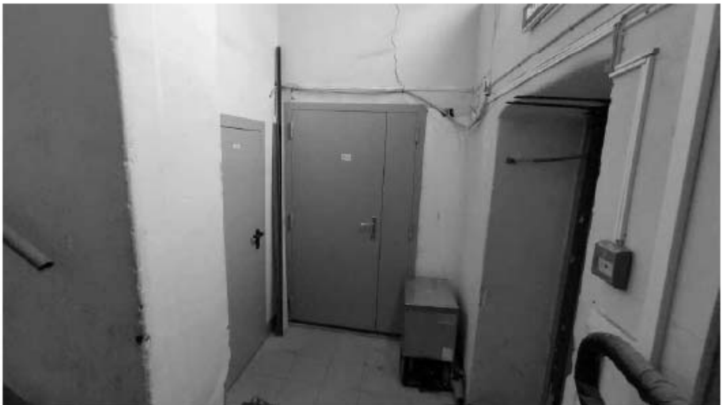
Фото 347. Площадка 1-го этажа лестницы ЛЗ. Общий вид. Дата фотофиксации: 18.03.25
