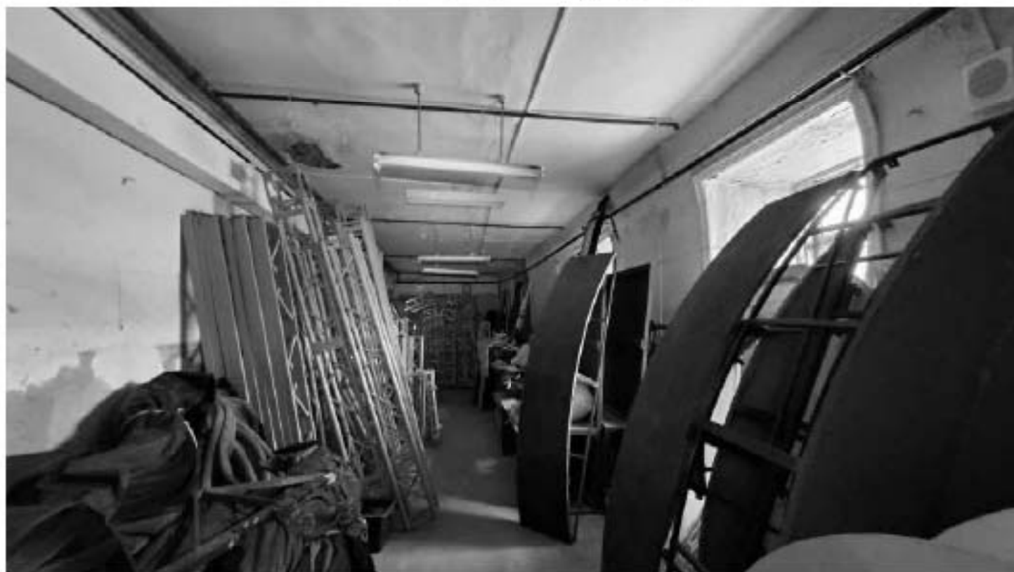
Фото 522. Помещение 3 (41-Н). Фрагмент. Дата фотофиксации: 18.03.25
