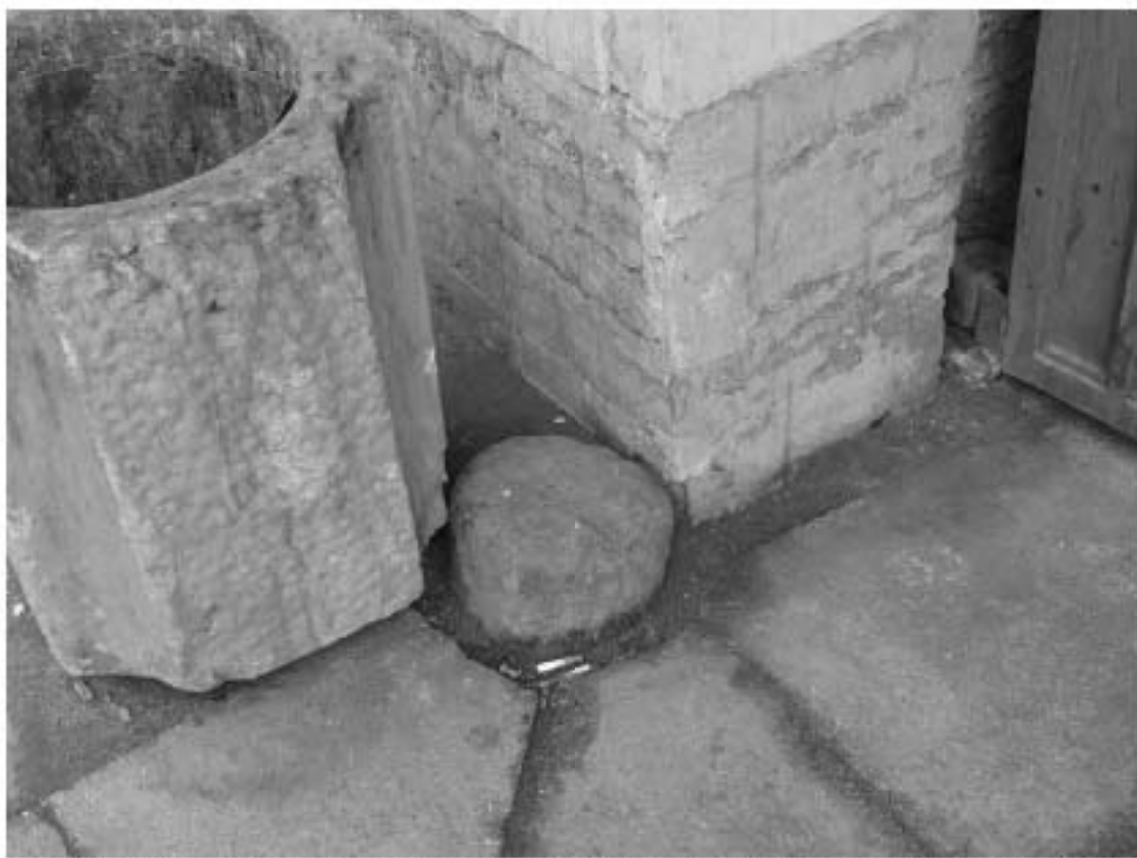
Фото 14. Историческая отбойная тумба в правой части воротного проезда. Общий вид. Дата фотофиксации: 18.03.25
