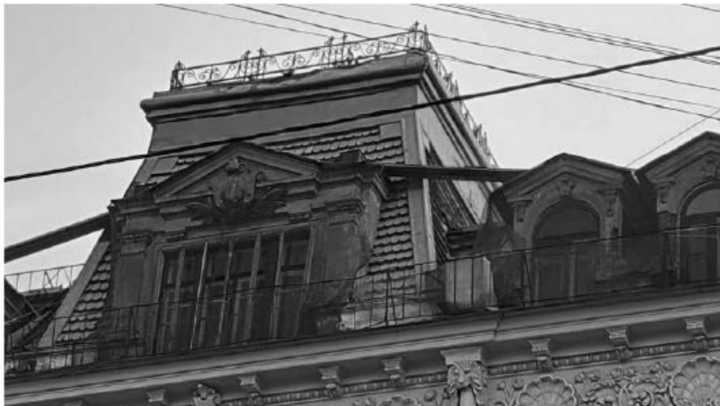
Фото 3. Основной объём мансарды – усечённый четырёхскатный шатёр над центральной осью лицевого корпуса (западного флигеля). Фрагмент. Дата фотофиксации: 18.03.25
