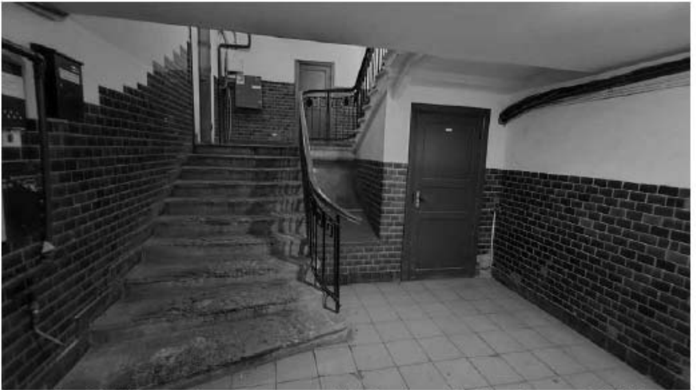
Фото 397. Площадка 1-го этажа лестницы Л5. Общий вид. Дата фотофиксации: 18.03.25
