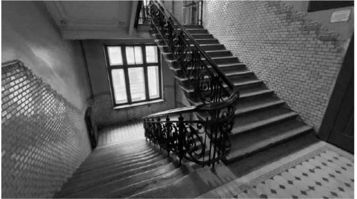
Фото 171. Парадная лестница Л1. Общий вид в уровне 3-го этажа. Дата фотофиксации: 18.03.25
