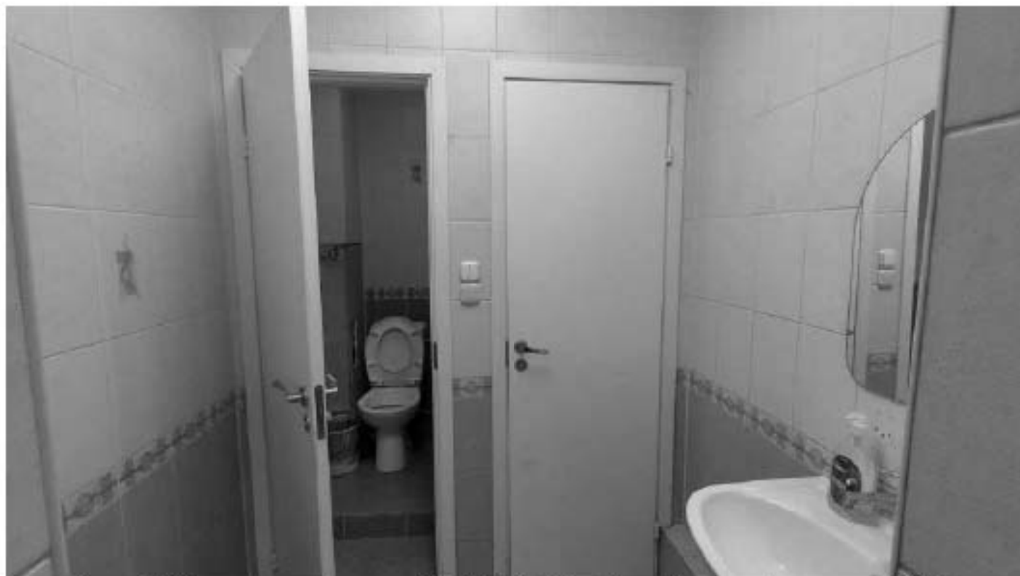
Фото 407. Пространство помещений 2, 3 (18-Н). Общий вид. Дата фотофиксации: 18.03.25
