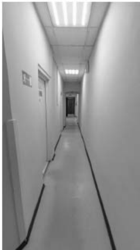
Фото 192. Помещение 9. Фрагмент. Дата фотофиксации: 18.03.25
