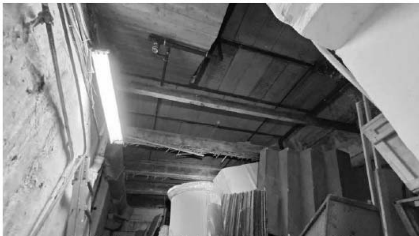
Фото 503. Помещение 1 (45-Н). Фрагмент. Дата фотофиксации: 18.03.25
