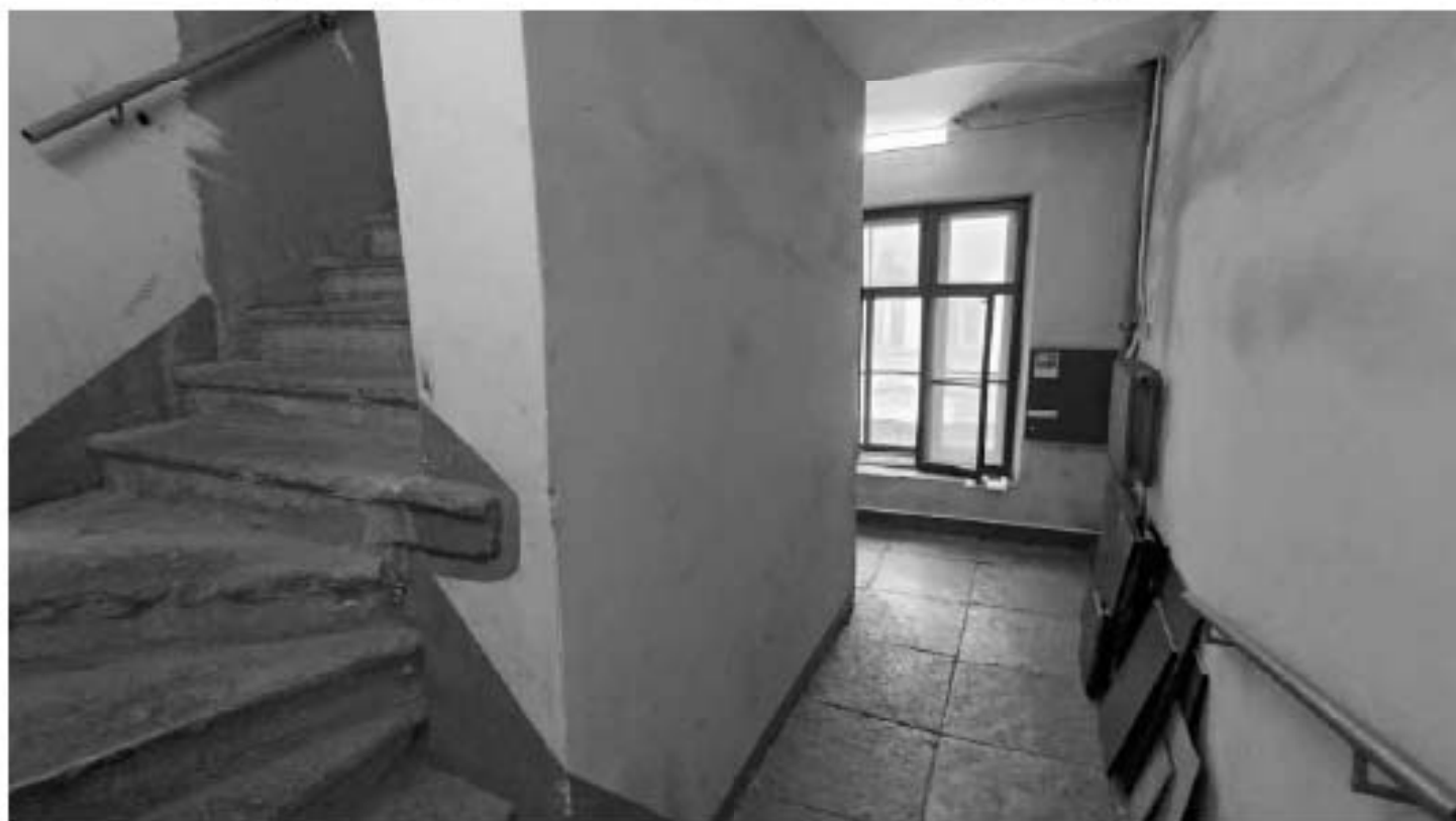
Фото 339. Забежные ступени в уровне 2-го этажа. Фрагмент. Дата фотофиксации: 18.03.25
