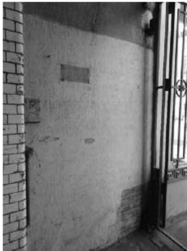
Фото 25. Фрагмент гладкой рустовой штукатурки в воротном проезде. Дата фотофиксации: 18.03.25
