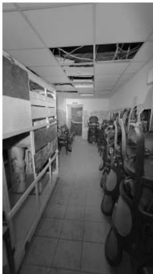
Фото 114. Помещение 1. Общий вид. Дата фотофиксации: 18.03.25
