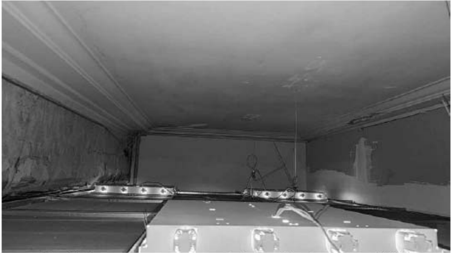
Фото 220. Тяги в пространстве помещения 7. Фрагмент. Дата фотофиксации: 18.03.25
