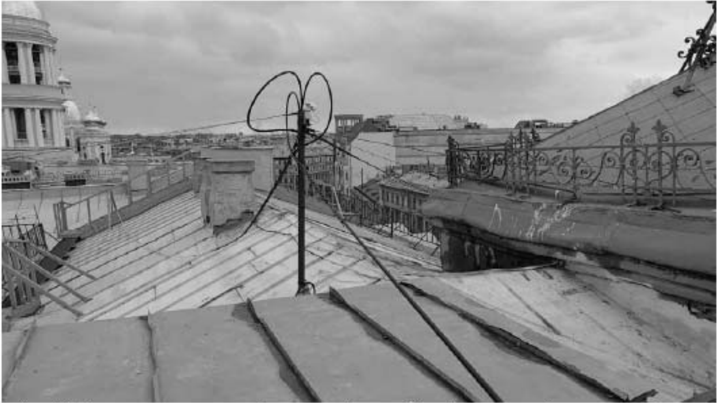
Фото 55. Скатная крыша лицевого фасада четырёхскатный шатёр центральной оси лицевого фасада. Фрагмент. Дата фотофиксации: 18.03.25
