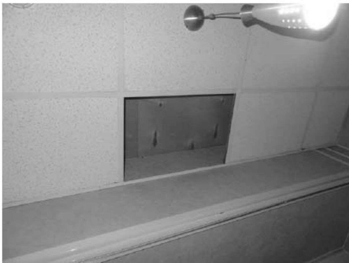
Фото 432. Помещение 5 (16-Н). Фрагмент. Дата фотофиксации: 18.03.25
