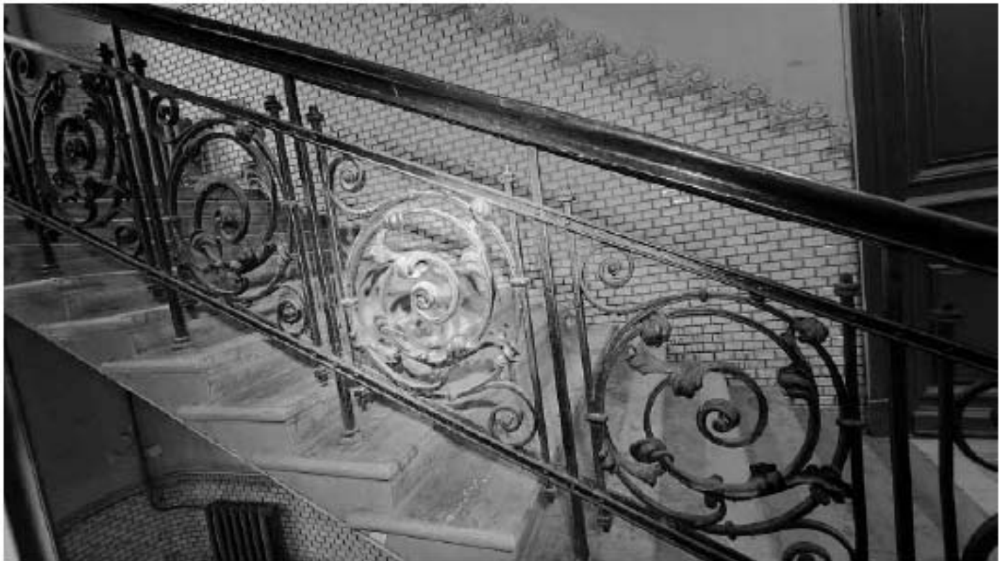
Фото 164. Отражение – кованый металл, вертикальные стойки с перехватами, между ними растительные волотообразные завитки с акантовыми листьями. Фрагмент. Дата фотофиксации: 18.03.25
