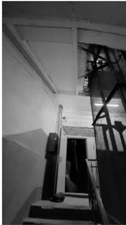
Фото 485. Площадка 2-го этажа лестницы Л4. Фрагмент. Дата фотофиксации: 18.03.25
