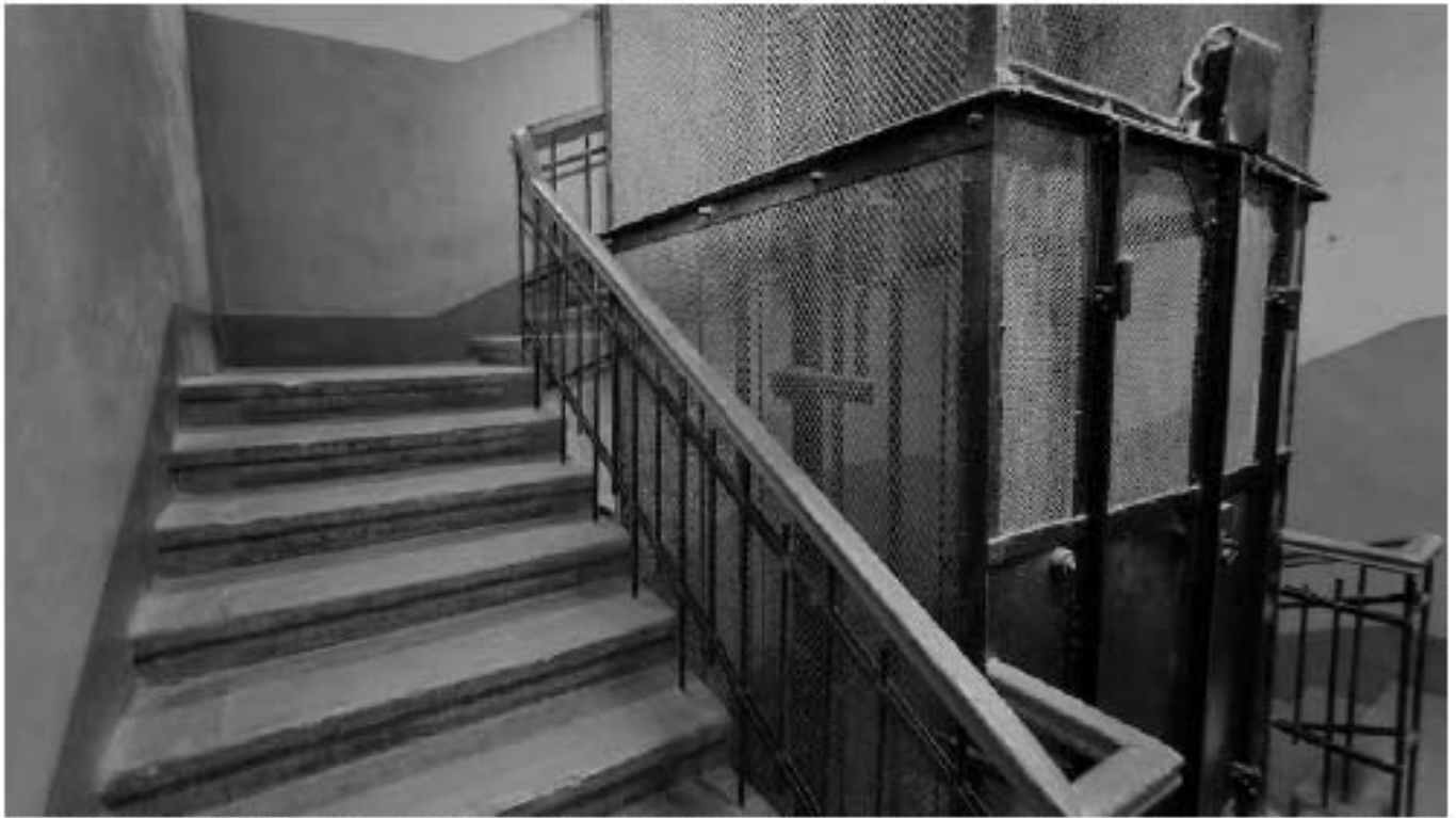
Фото 495. Межэтажное пространство 3-го и 4-го этажей лестницы Л4. Фрагмент. Дата фотофиксации: 18.03.25
