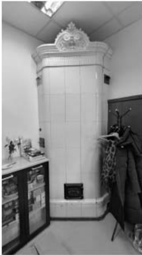
Фото 214. Угловая печь в помещении 5 (22-Н), гладкого белого изразца со скруглёнными углами на высоком профилированном плинте. Общий вид. Дата фотофиксации: 18.03.25
