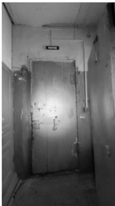
Фото 513. Помещение 1. Фрагмент. Дата фотофиксации: 18.03.25
