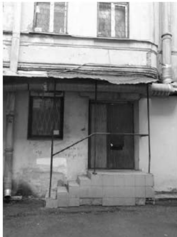
Фото 49. Вход в помещения 6-Н. Северный флигель. Дворовый фасад. Общий вид. Дата фотофиксации: 18.03.25
