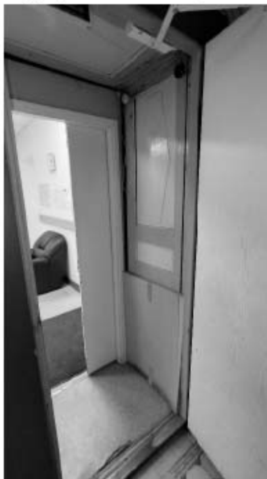
Фото 277. Тамбур между площадкой Лестницы Л1 в уровне 3-го этажа и помещением 5. Фрагмент. Дата фотофиксации: 18.03.25
