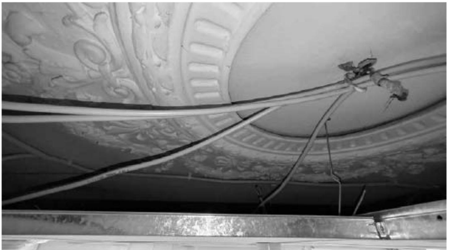
Фото 298. Розетка с декорированным оформлением в помещении 17. Фрагмент. Дата фотофиксации: 18.03.25
