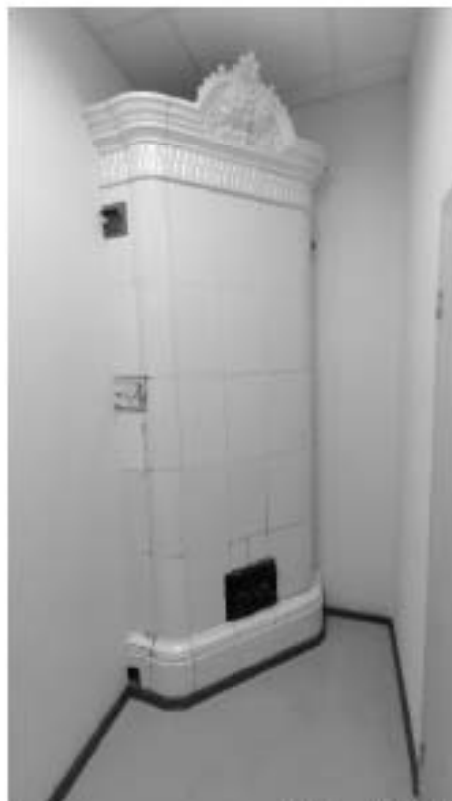
Фото 207. Угловая печь в пространстве помещений 6 и 7 (22-Н), гладкого белого изразца со скруглёнными углами на высоком профилированном плинте. Общий вид. Дата фотофиксации: 18.03.25
