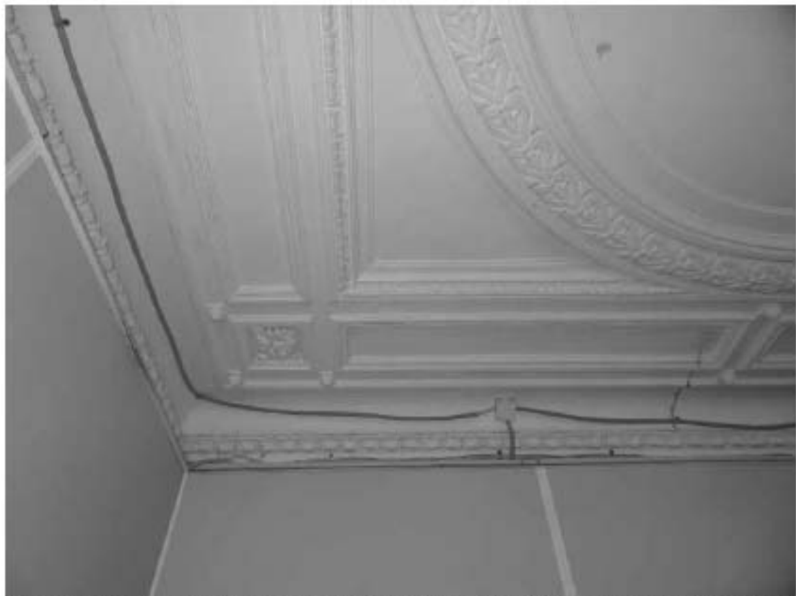
Фото 420. Художественная отделка потолка. Помещение 12 (16-Н). Фрагмент. Дата фотофиксации: 18.03.25
