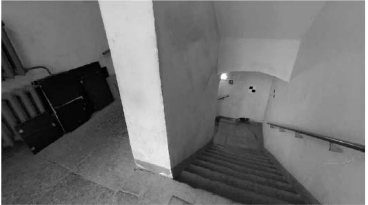
Фото 344. Лестница ЛЗ в уровне 2-го этажа. Общий вид. Дата фотофиксации: 18.03.25
