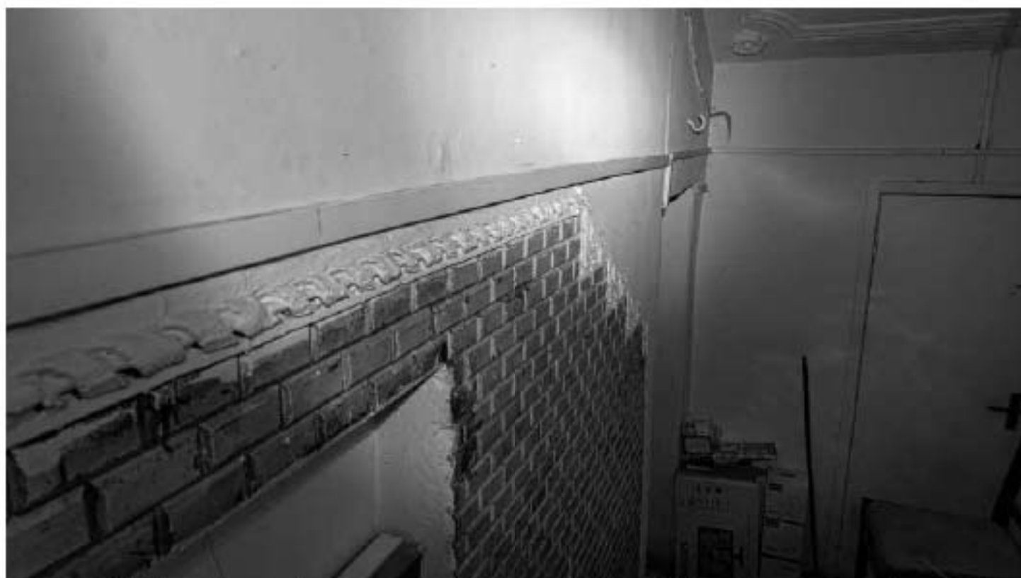
Фото 148. Декоративная облицовка нижней части стен лестничной клетки керамической плиткой светло-серого цвета («кабанчик»). Объем под лестницей. Фрагмент. Дата фотофиксации: 18.03.25
