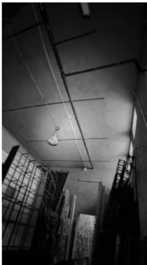
Фото 474. Помещение 4. Фрагмент. Дата фотофиксации: 18.03.25
