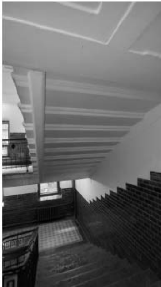
Фото 392. Косоуры лестницы Л5. Фрагмент (уровень межэтажного пространства 1-го и 2-го этажей). Фрагмент. Дата фотофиксации: 18.03.25
