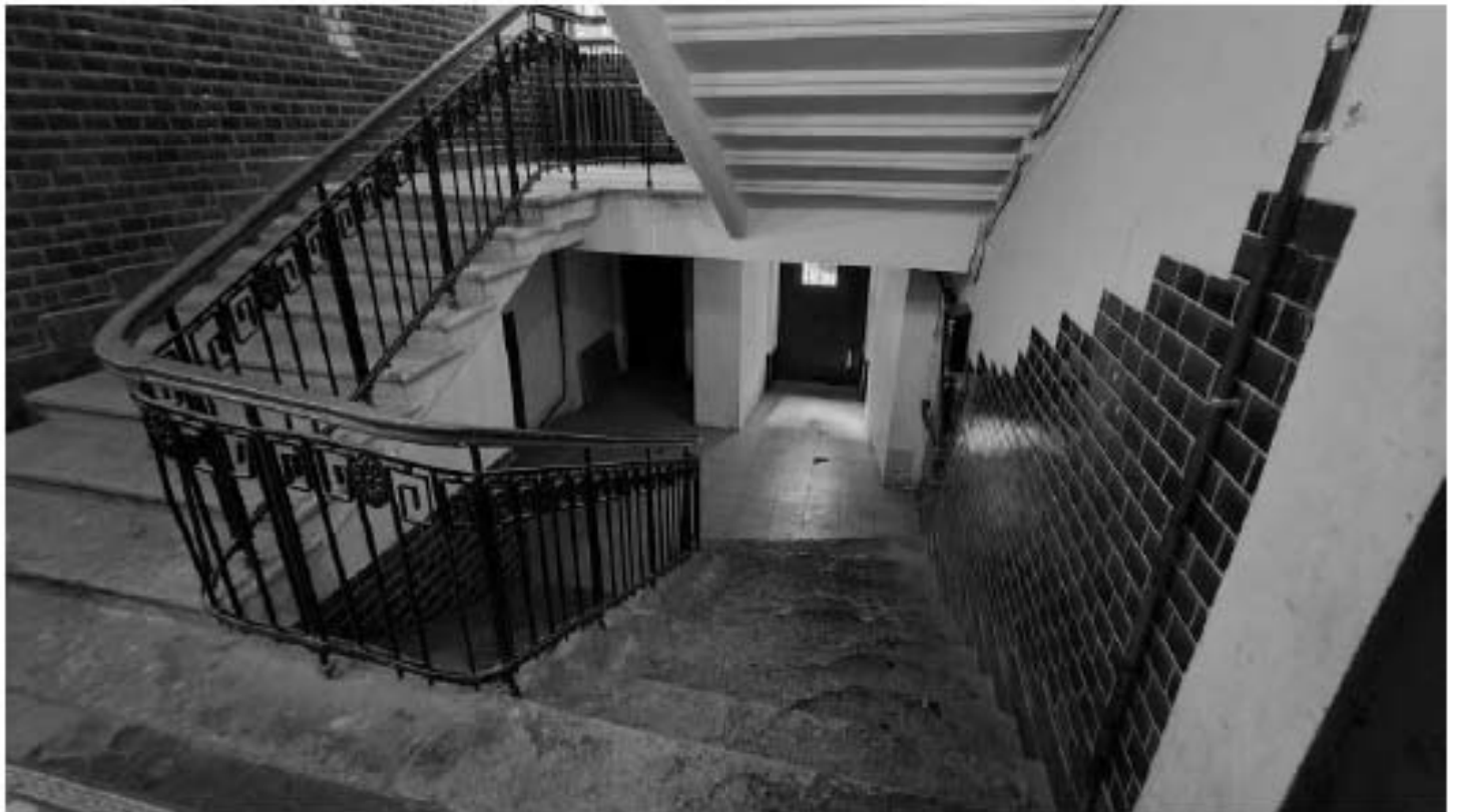
Фото 396. Площадка 1-го этажа лестницы Л5. Общий вид. Дата фотофиксации: 18.03.25
