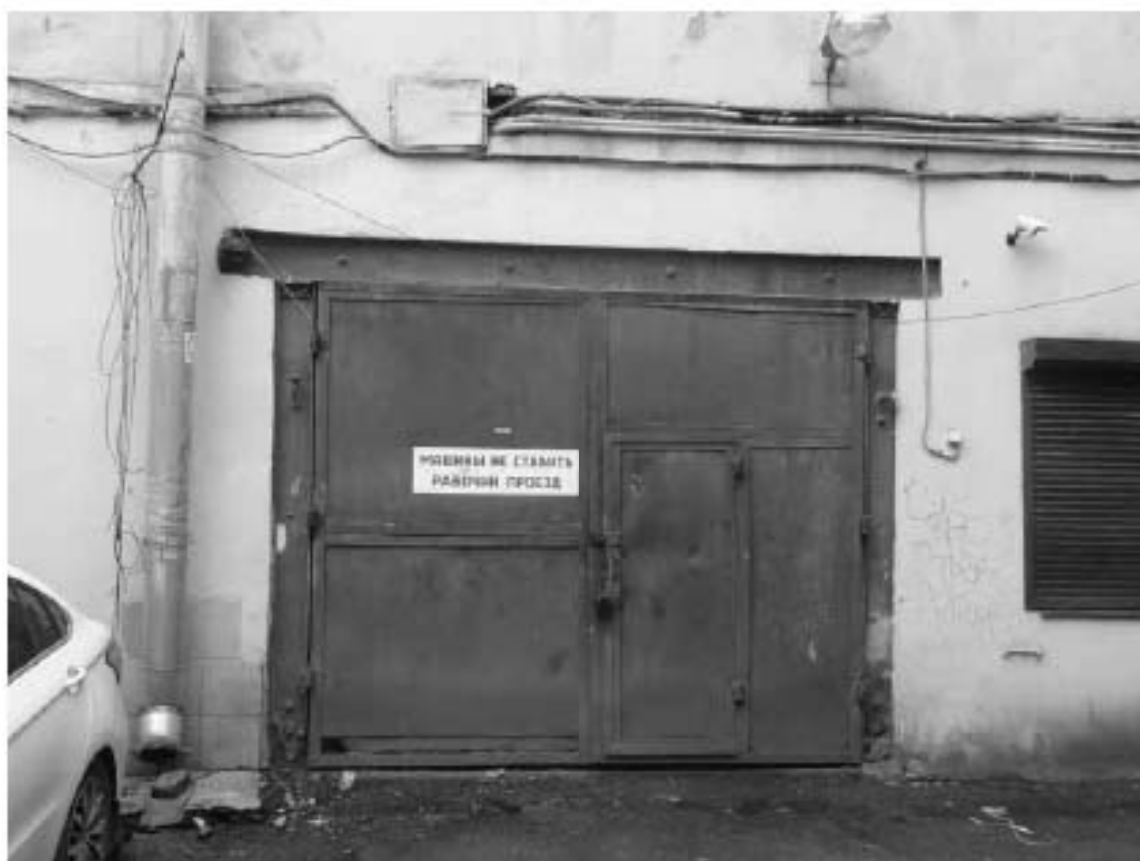
Фото 50. Современное заполнение каретного проезда восточного флигеля. Общий вид. Дата фотофиксации: 18.03.25
