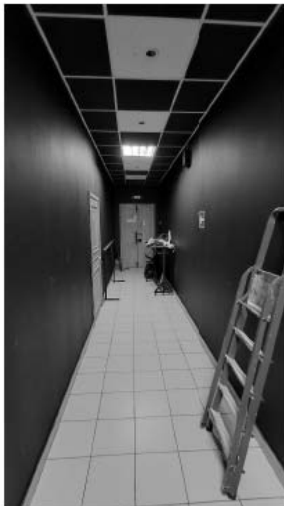
Фото 260. Помещение 1. Фрагмент. Дата фотофиксации: 18.03.25
