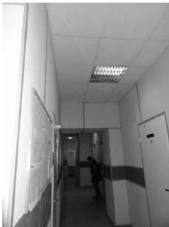
Фото 442. Помещение 33 (16-Н). Фрагмент. Дата фотофиксации: 18.03.25
