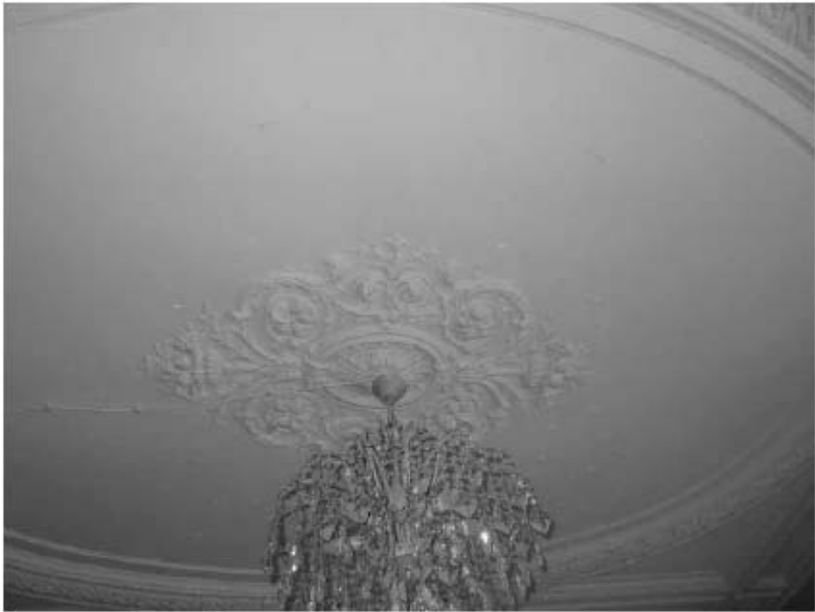
Фото 419. Художественная отделка потолка. Помещение 12 (16-Н). Фрагмент. Дата фотофиксации: 18.03.25
