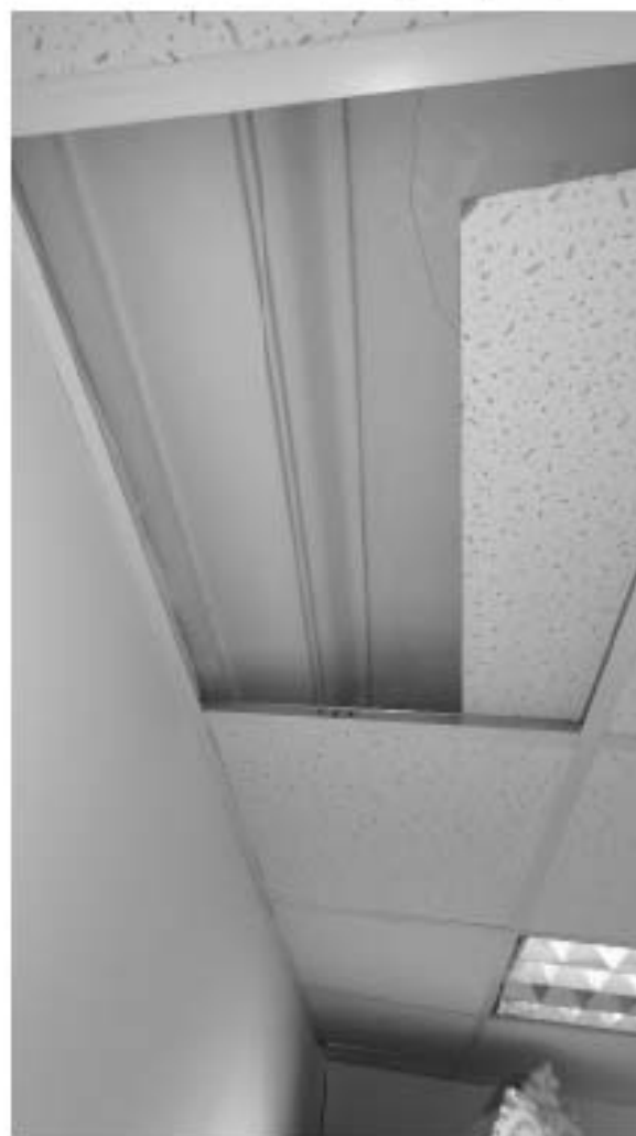
Фото 213. Тяги в помещении 5. Фрагмент. Дата фотофиксации: 18.03.25
