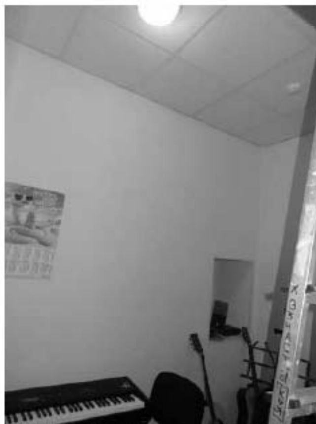
Фото 440. Помещение 23 (16-Н). Фрагмент. Дата фотофиксации: 18.03.25
