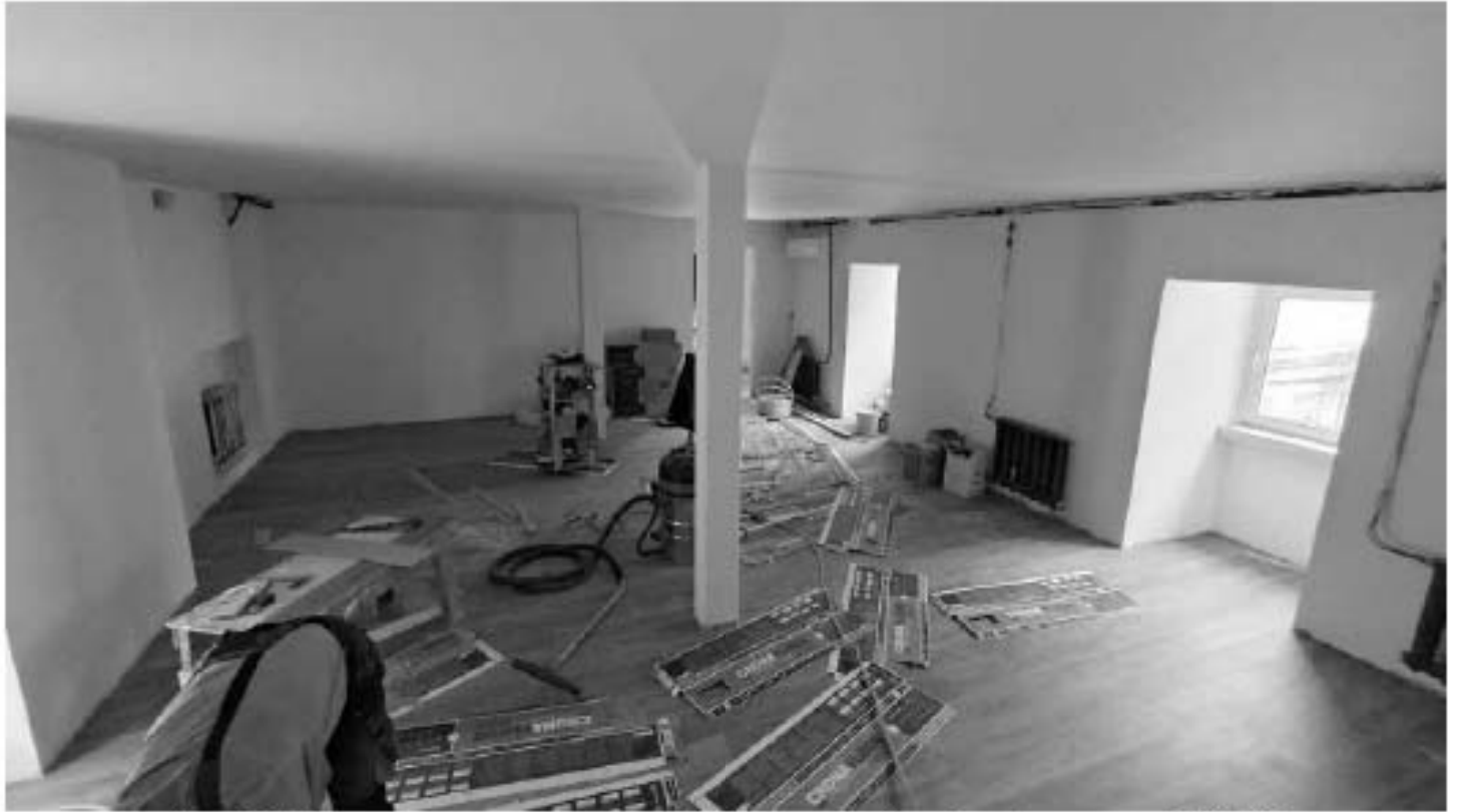
Фото 244. Пространство помещения 18. Фрагмент. Дата фотофиксации: 18.03.25
