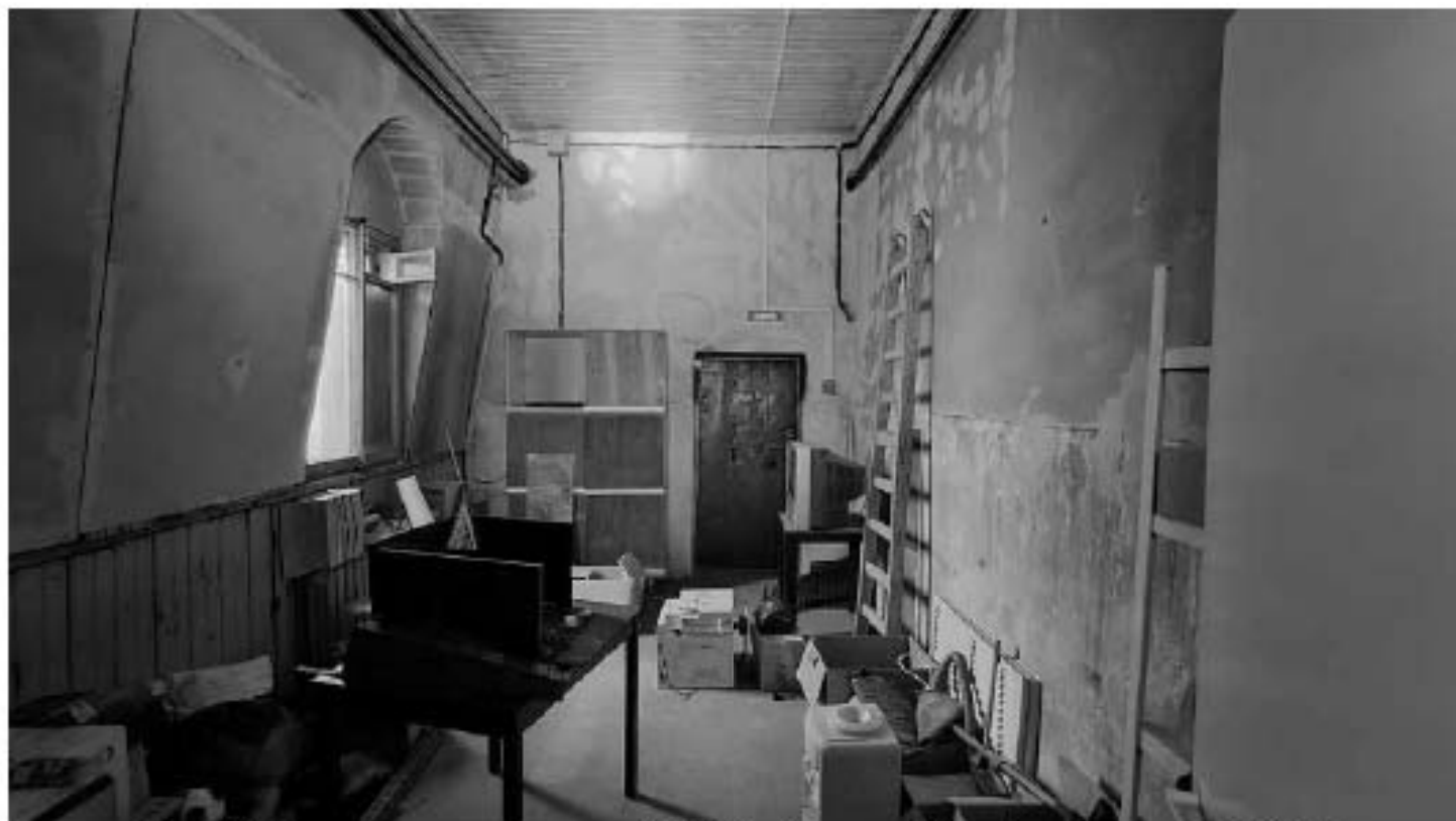
Фото 269. Пространство помещения 2 (26-Н). Фрагмент. Дата фотофиксации: 18.03.25
