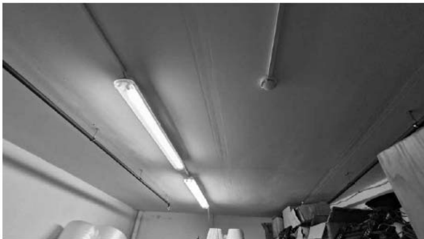
Фото 483. Помещение 7. Фрагмент. Дата фотофиксации: 18.03.25
