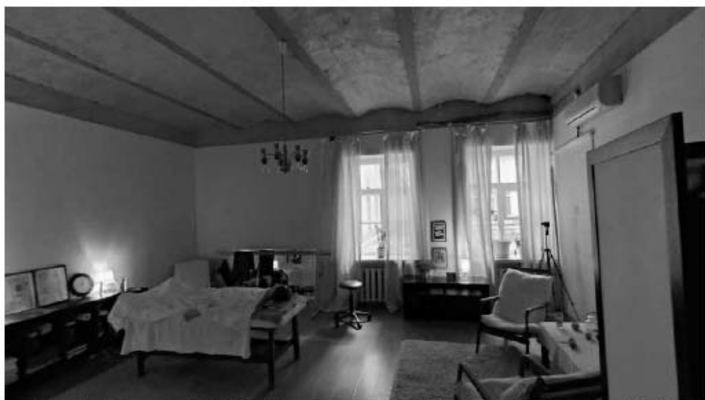
Фото 414. Помещение 21 (18-Н). Прусские своды. Общий вид. Дата фотофиксации: 18.03.25
