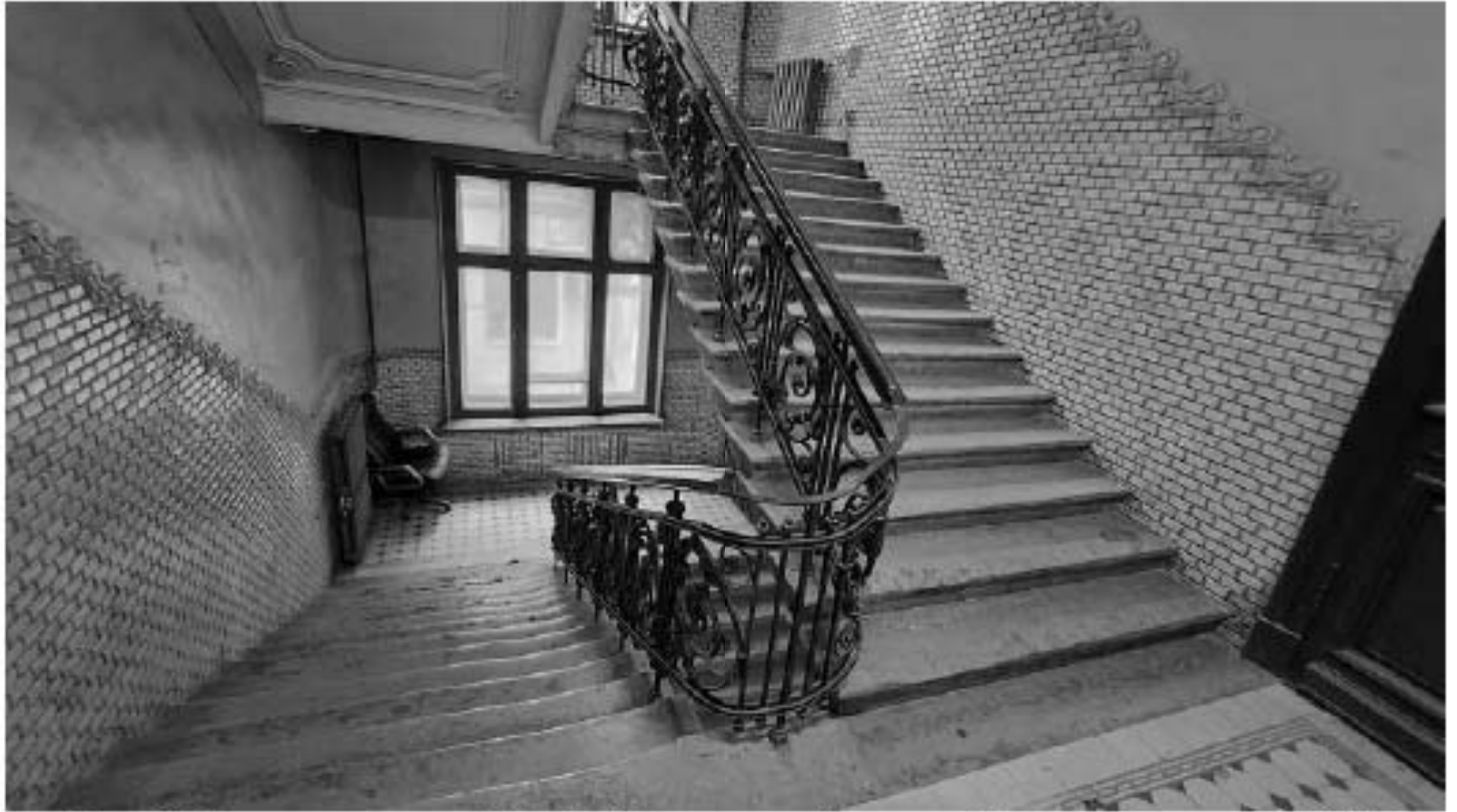
Фото 163. Парадная лестница Л1. Общий вид в уровне 2-го этажа. Дата фотофиксации: 18.03.25
