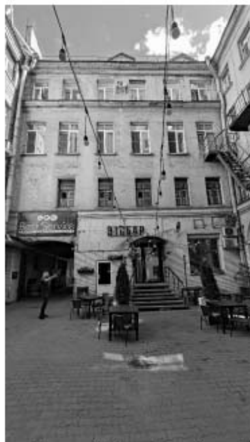
Фото 32. Поперечный флигель. Дворовый фасад. Общий вид. Дата фотофиксации: 14.08.25
