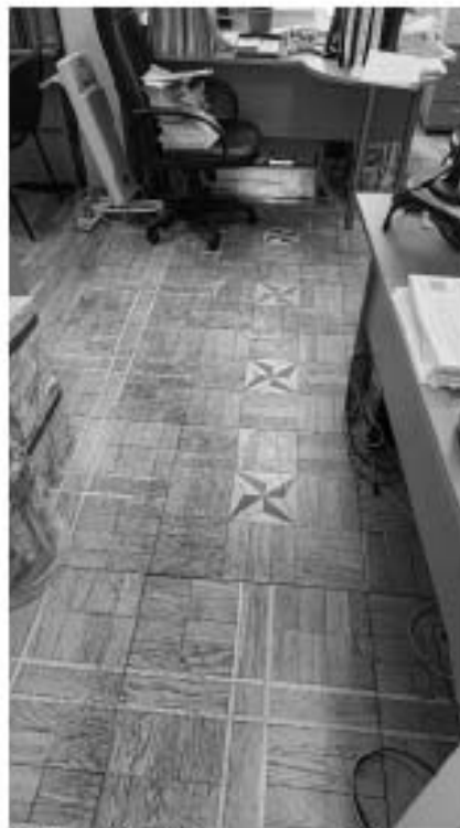
Фото 281. Пространство помещений 12 и 13. Исторический паркет из ценных пород дерева (дуб, бук, орех), с рисунком «корзина» и вставками в виде 4-х конечных звезд меньшего размера. Фрагмент. Дата фотофиксации: 18.03.25
