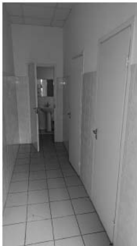
Фото 355. Помещение 43. Общий вид. Дата фотофиксации: 18.03.25
