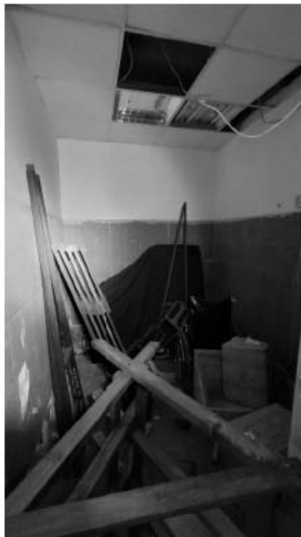
Фото 107. Помещение 6. Общий вид. Дата фотофиксации: 18.03.25
