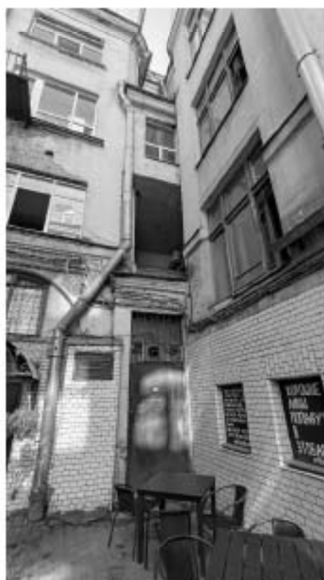
Фото 36. Карман южного флигеля дворового фасада с поздней пристройкой в уровне 3-го этажа. Общий вид. Дата фотофиксации: 14.08.25
