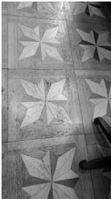
Фото 307. Исторический паркет из ценных пород дерева (дуб, бук, орех), с рисунком в виде 4-х конечных звезд в помещении 31 (21-Н). Фрагмент. Дата фотофиксации: 18.03.25
