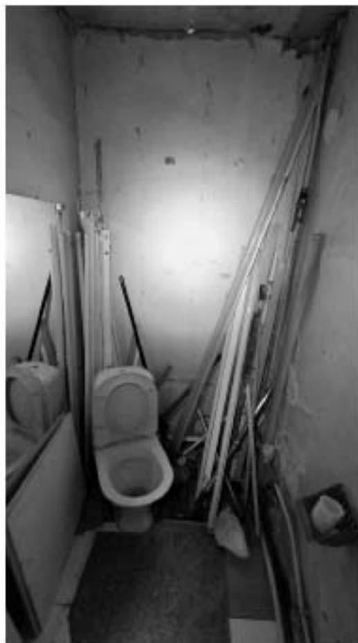
Фото 96. Помещение 4. Общий вид. Дата фотофиксации: 18.03.25
