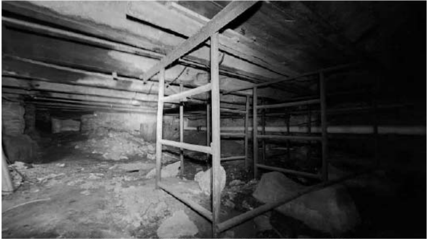
Фото 85. Помещение 1 (33-Н). Общий вид. Дата фотофиксации: 14.08.25
