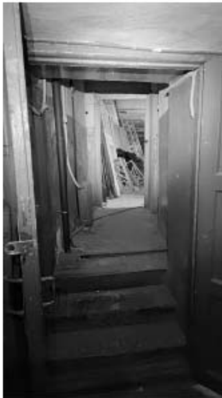
Фото 518. Помещение 1 (41-Н). Общий вид. Дата фотофиксации: 18.03.25
