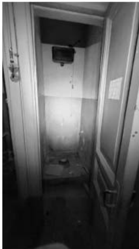
Фото 527. Помещение 7 (41-Н). Общий вид. Дата фотофиксации: 18.03.25
