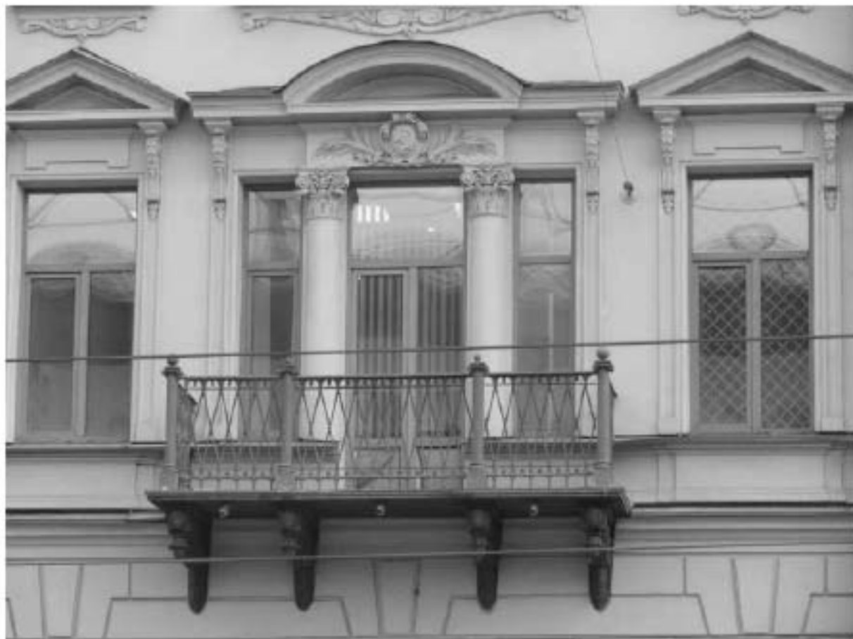
Фото 5. Проём балконной двери в уровне 3-го этажа. Балкон с литым металлическим ограждением в виде трельяжной сетки с перехватами, по верхнему и нижнему краям аркатурные пояса с литыми пишками. Общий вид. Дата фотофиксации: 18.03.25
