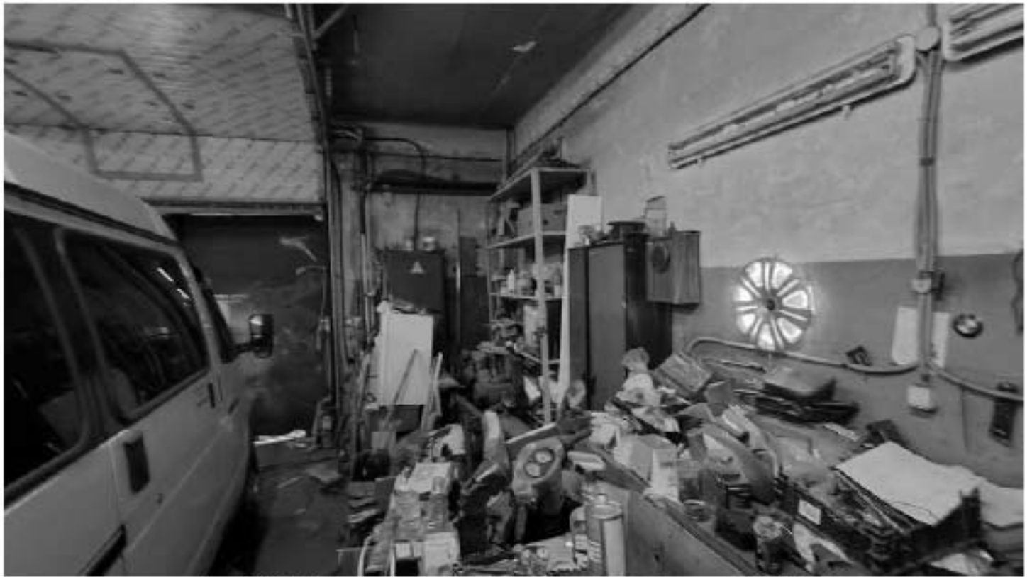
Фото 102. Помещение 1. Фрагмент. Дата фотофиксации: 18.03.25
