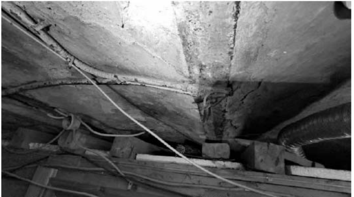
Фото 83. Прусские своды в пространстве помещений 1, 2, 3, 6 (2-Н). Фрагмент. Дата фотофиксации: 18.03.25
