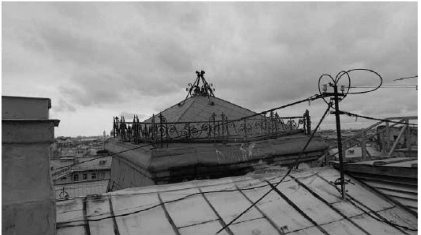
Фото 58. Четырёхскатный шатёр по центральной оси лицевого фасада. Вид со стороны крыши западного корпуса. Дата фотофиксации: 18.03.25
