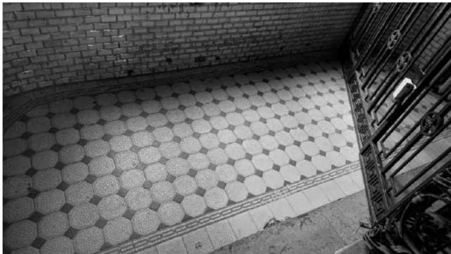
Фото 175. Метлахская плитка в межэтажном пространстве 3-го и 4-го этажей. Фрагмент. Дата фотофиксации: 18.03.25
