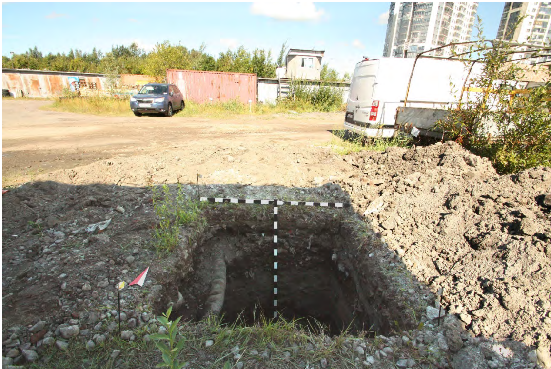
Рис. 21. Санкт-Петербург-2025. Земельный участок по адресу: Мебельная ул., участок 1. Шурф 1. Общий вид шурфа с привязкой на местности. Вид с юга
