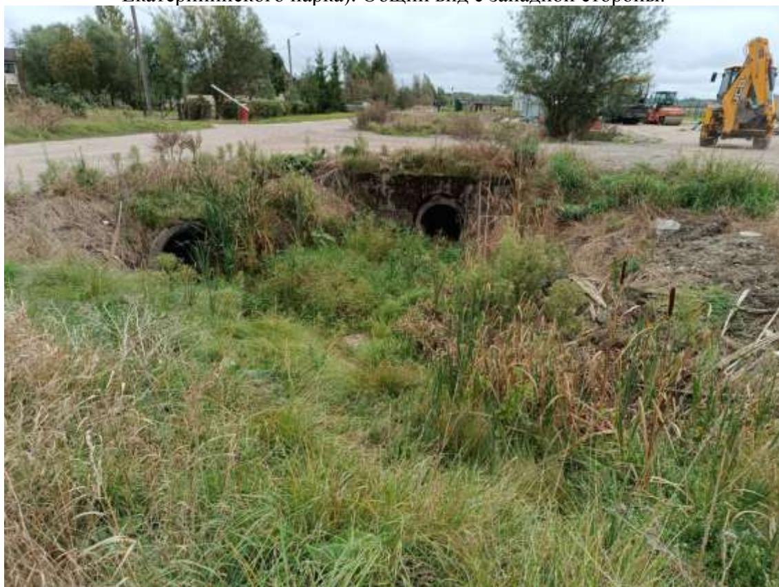
Фото 2. Объект культурного наследия федерального значения «Водовод Виттоловский» (Санкт-Петербург, г. Пушкин, от Виттоловских источников до Екатерининского парка). Общий вид с западной стороны.
