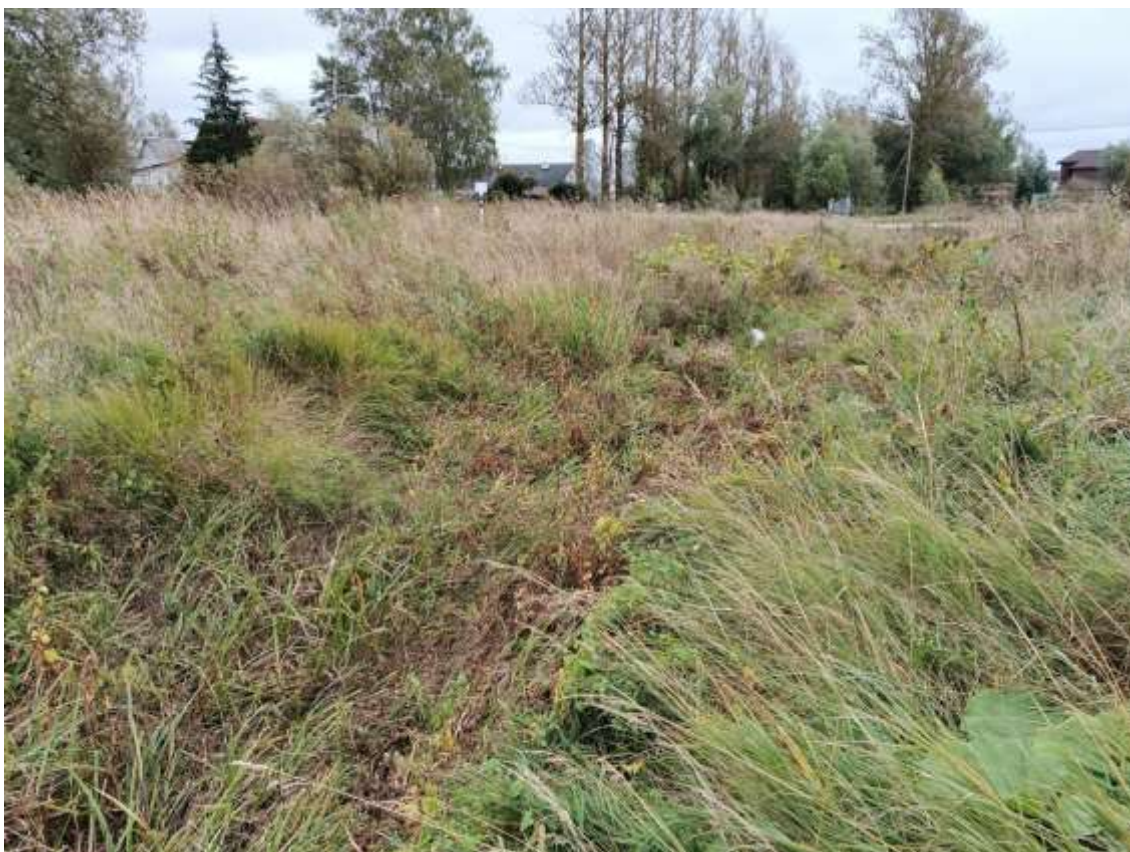
Фото 1. Объект культурного наследия федерального значения «Водовод Виттоловский» (Санкт-Петербург, г. Пушкин, от Виттоловских источников до Екатерининского парка). Общий вид с западной стороны.
