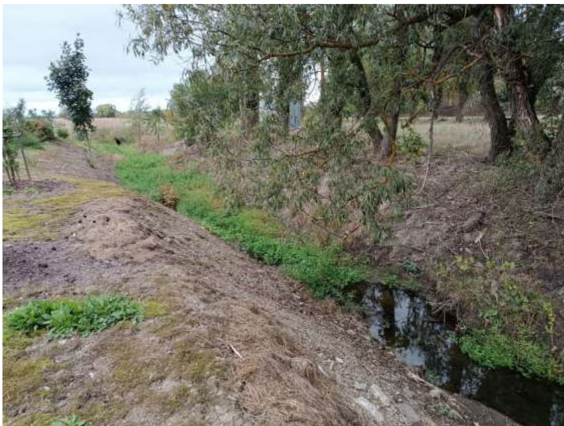
Фото 3. Объект культурного наследия федерального значения «Водовод Виттоловский» (Санкт-Петербург, г. Пушкин, от Виттоловских источников до Екатерининского парка). Общий вид с западной стороны.
