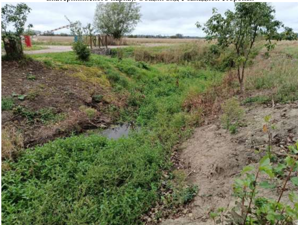
Фото 4. Объект культурного наследия федерального значения «Водовод Виттоловский» (Санкт-Петербург, г. Пушкин, от Виттоловских источников до Екатерининского парка). Общий вид с восточной стороны.
