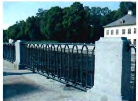
2. Решетка перильного ограждения
