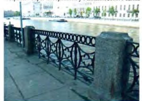
6. Решетка перильного ограждения
