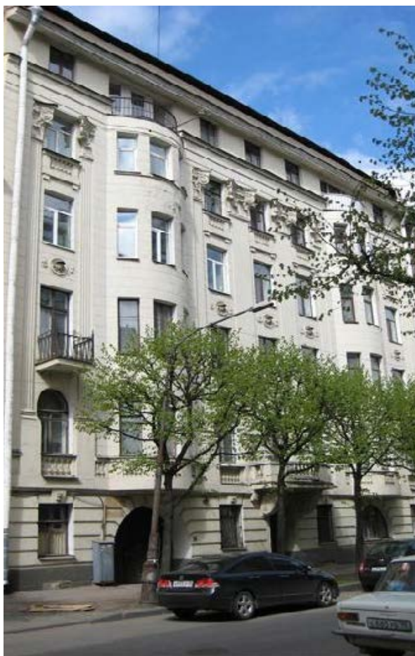
Дата съемки: 04.06.2025. Выявленный ОКН «Дом А.Н. Витцель» (адрес: Санкт-Петербург, Графтио ул., 4А)
