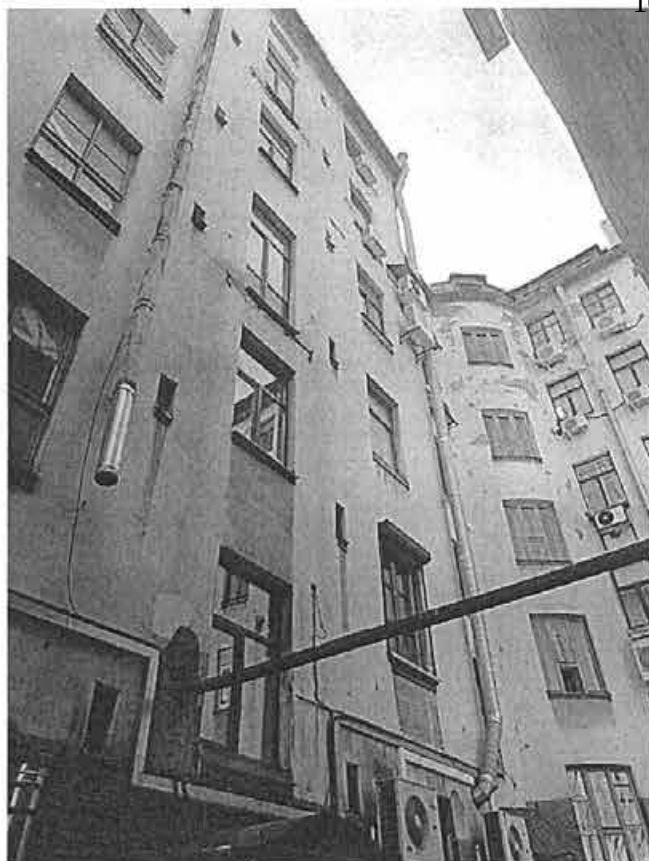
Фото 79. Фрагмент дворового фасада внешнего контура.
