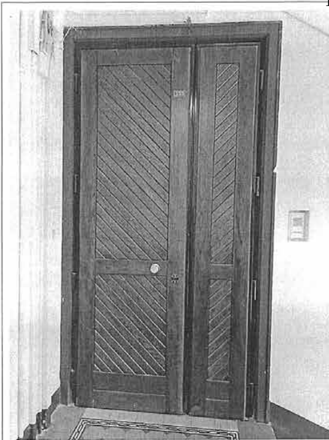
Фото 95. Дверное заполнение квартиры № 555
