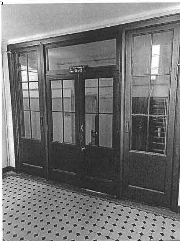
Фото 88. Дверное заполнение квартиры № 409-428
