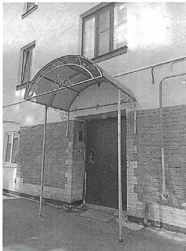
Фото 124. Фрагмент фасада Литера Ц. Вход на лестницу.
