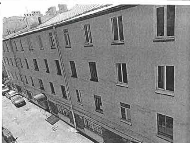
Фото 128. Фасад и кровля литера Ц.
