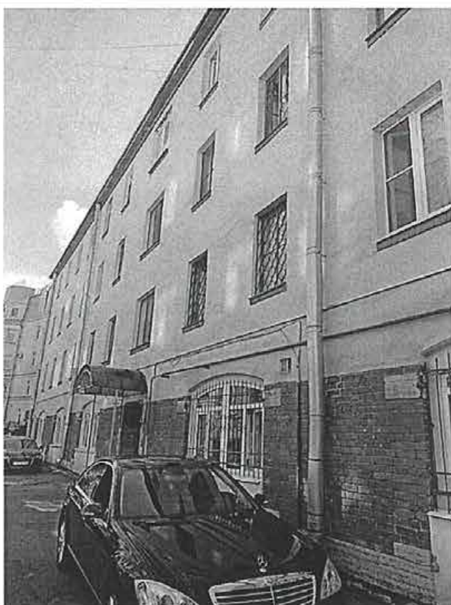
Фото 125. Фрагмент фасада Литера Ц.
