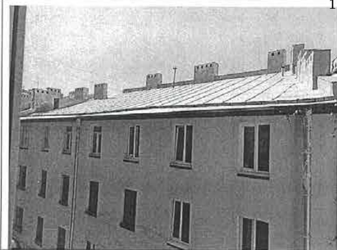
Фото 127. Фасад и кровля литера Ц.
