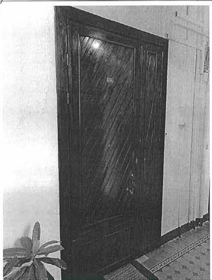
Фото 96. Дверное заполнение квартиры № 556
