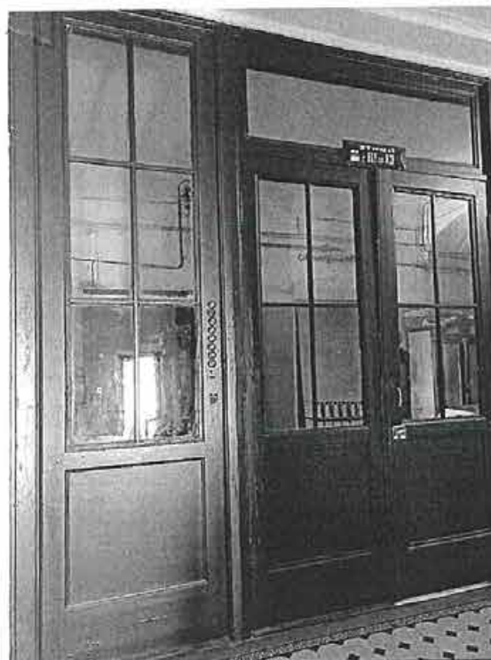
Фото 90. Дверное заполнение квартиры № 609-628
