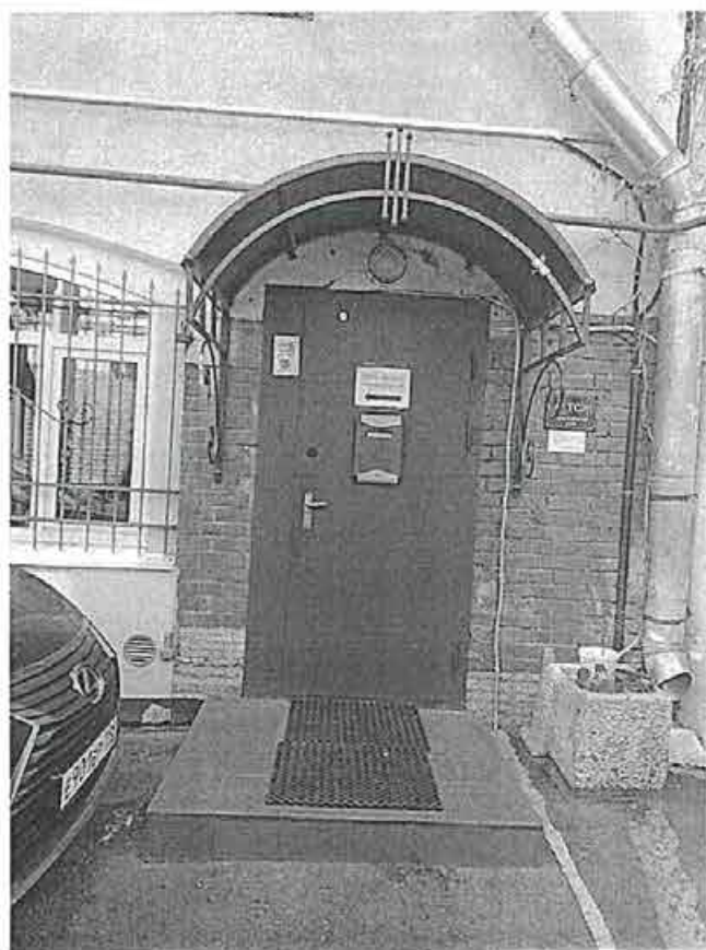
Фото 126. Фрагмент фасада Литера Ц.
