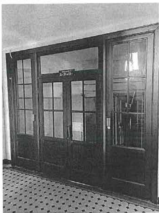
Фото 89. Дверное заполнение квартиры № 509-528
