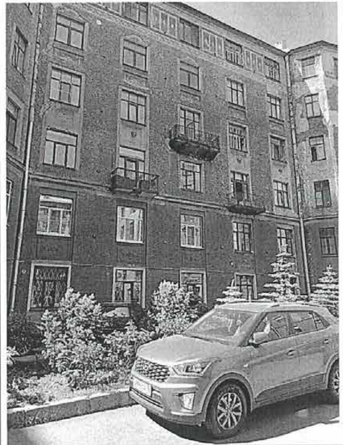
Фото 20. Дворовые фасады внутреннего двора.
