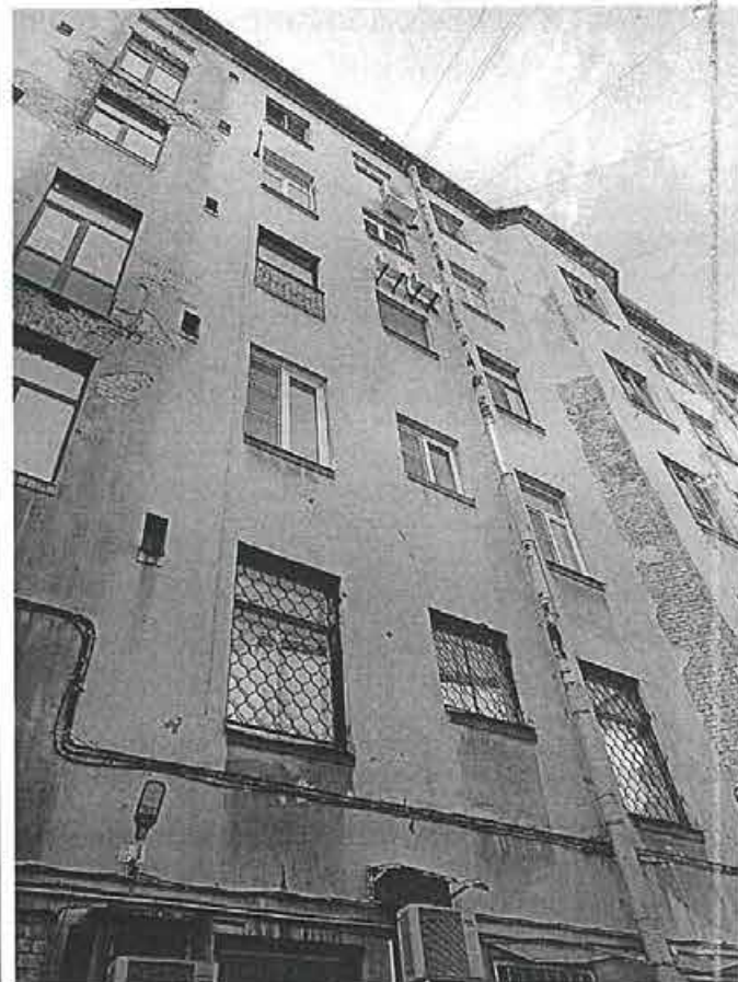
Фото 118. Фрагмент дворового фасада внешнего контура здания. Закладка нижней части оконного проема квартиры № 405
