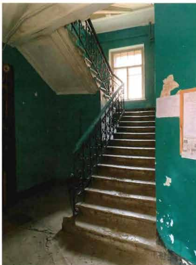
3. Помещение лестницы 3ЛК объекта культурного наследия.
