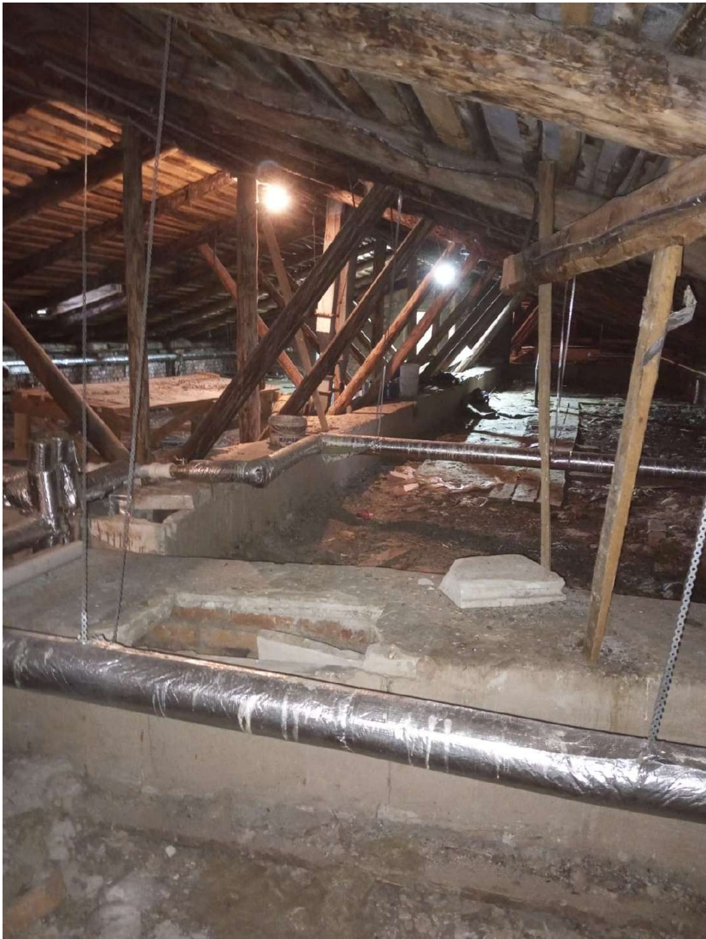
Фото 22. Общий вид чердачного пространства. Дата фотофиксации - 28.09.2024г.
