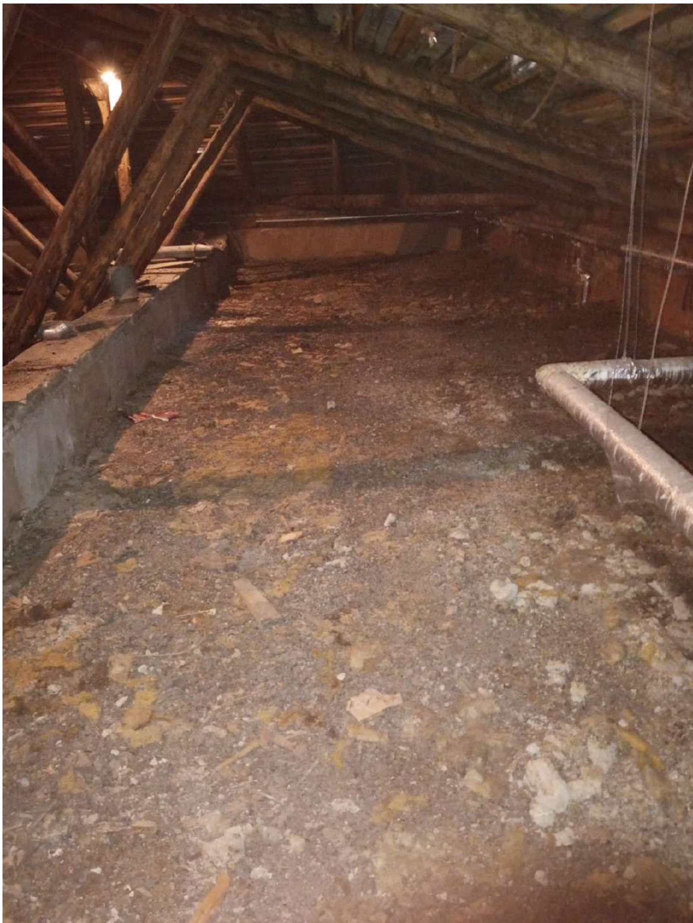
Фото 21. Общий вид чердачного пространства. Дата фотофиксации - 28.09.2024г.
