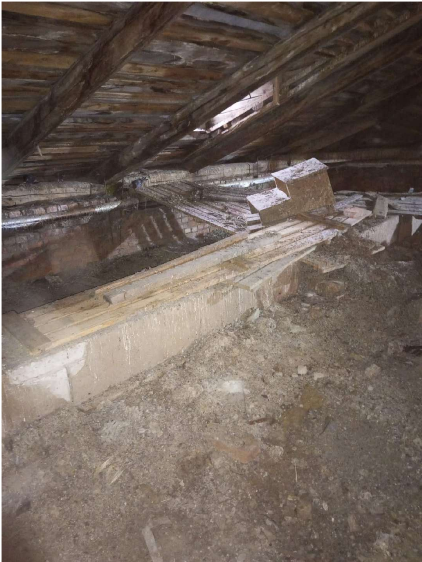
Фото 19. Общий вид чердачного пространства. Дата фотофиксации - 28.09.2024г.
