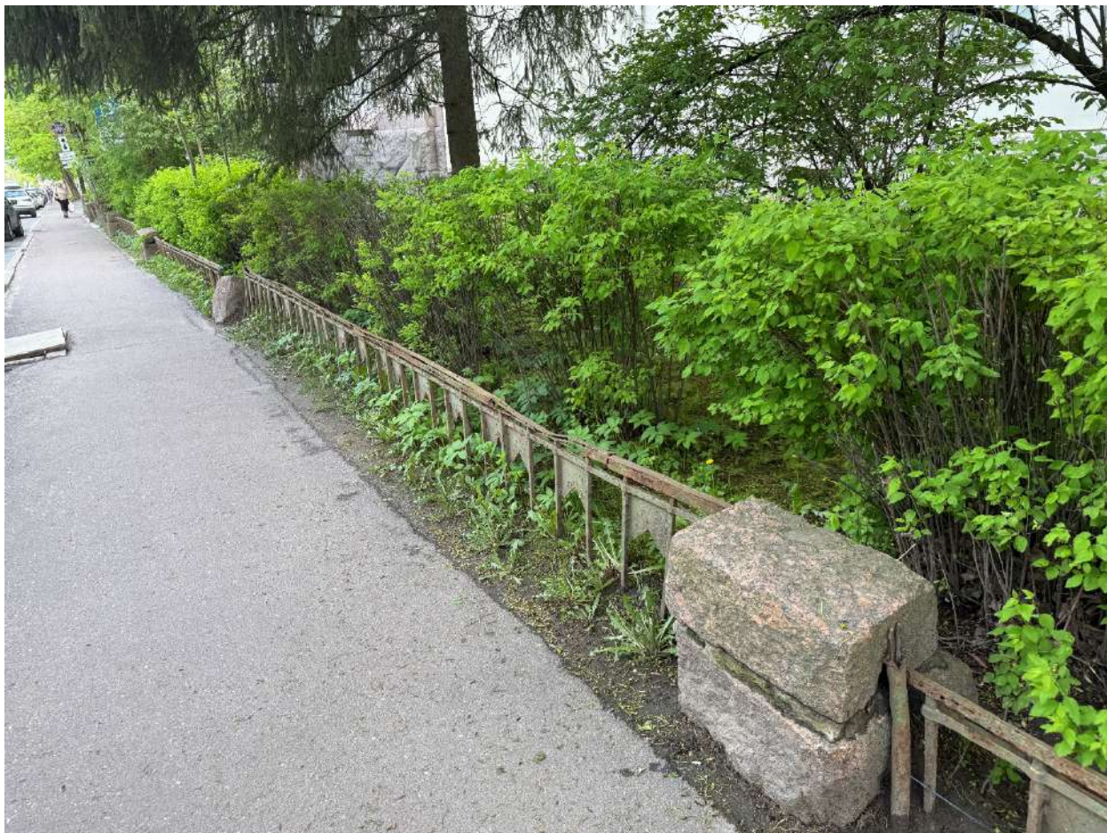
Фото 29. Общий вид на часть ограды. Дата фотофиксации - 19.05.2025г.
