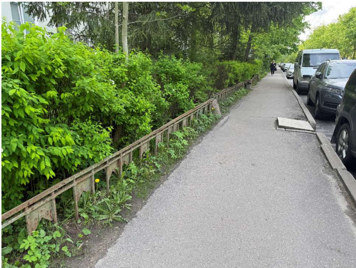
Фото 17. Общий вид на часть ограды. Дата фотофиксации - 19.05.2025г.
