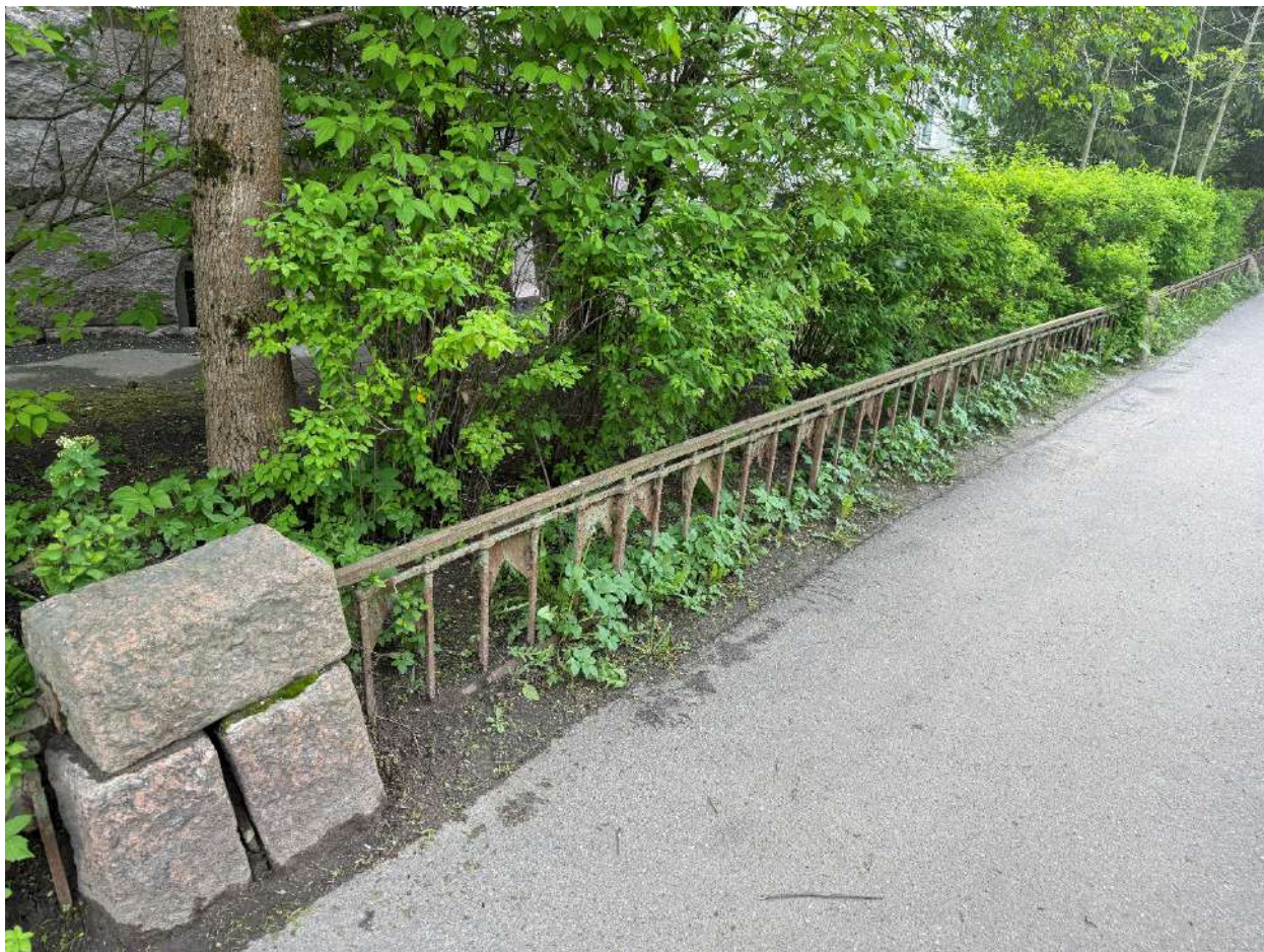
Фото 11. Общий вид на часть ограды. Дата фотофиксации - 19.05.2025г.
