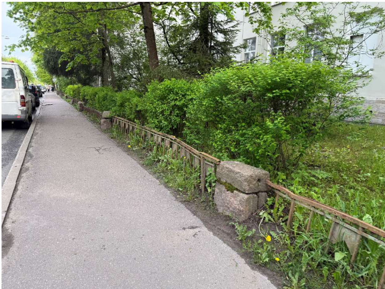
Фото 27. Общий вид на часть ограды. Дата фотофиксации - 19.05.2025г.
