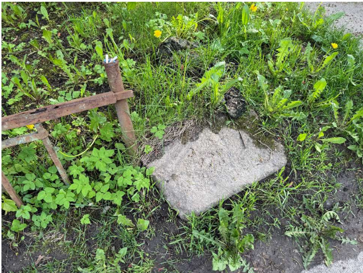
Фото 25. Общий вид на часть ограды. Дата фотофиксации - 19.05.2025г.
