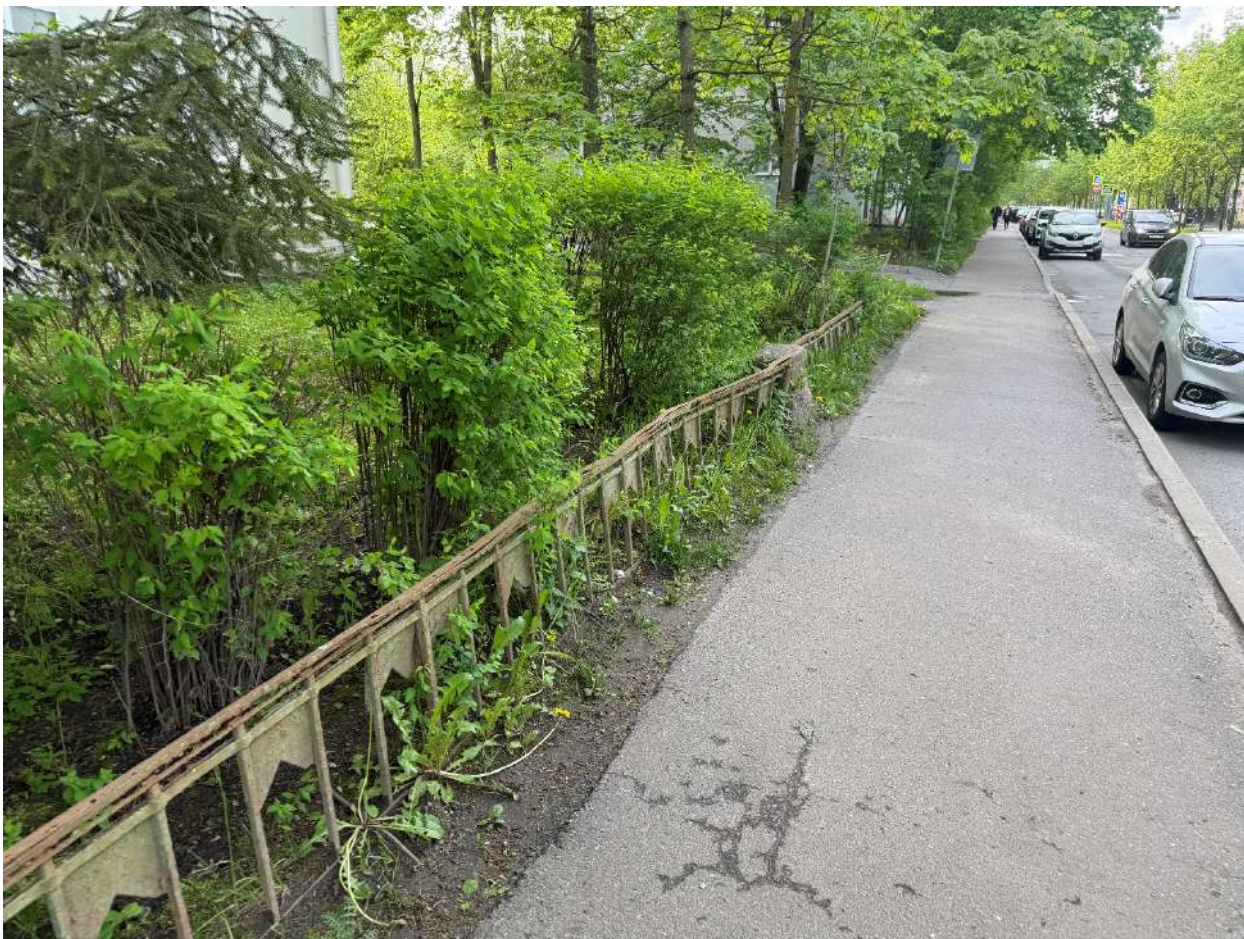
Фото 23. Общий вид на часть ограды. Дата фотофиксации - 19.05.2025г.
