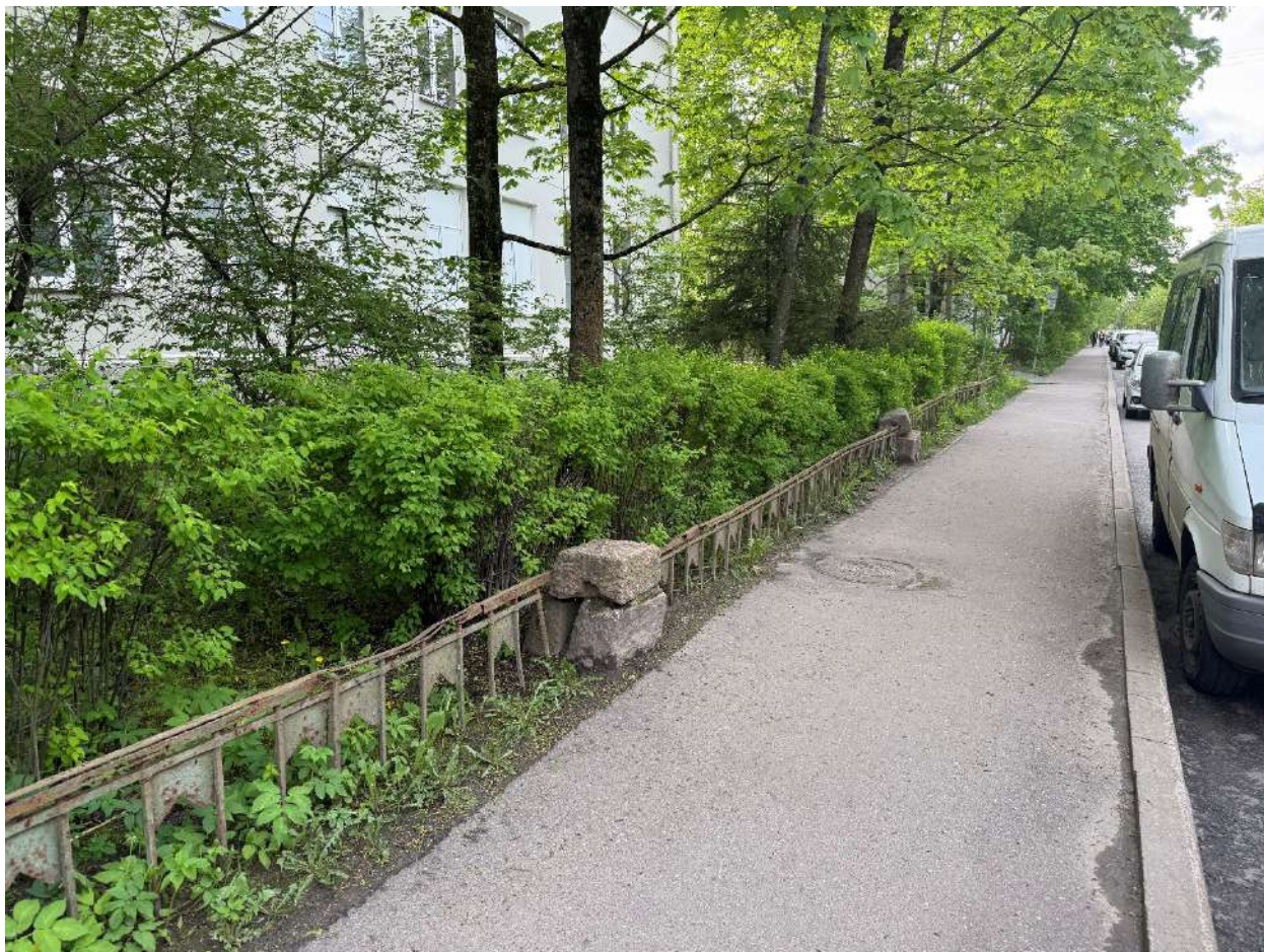
Фото 19. Общий вид на часть ограды. Дата фотофиксации - 19.05.2025г.
