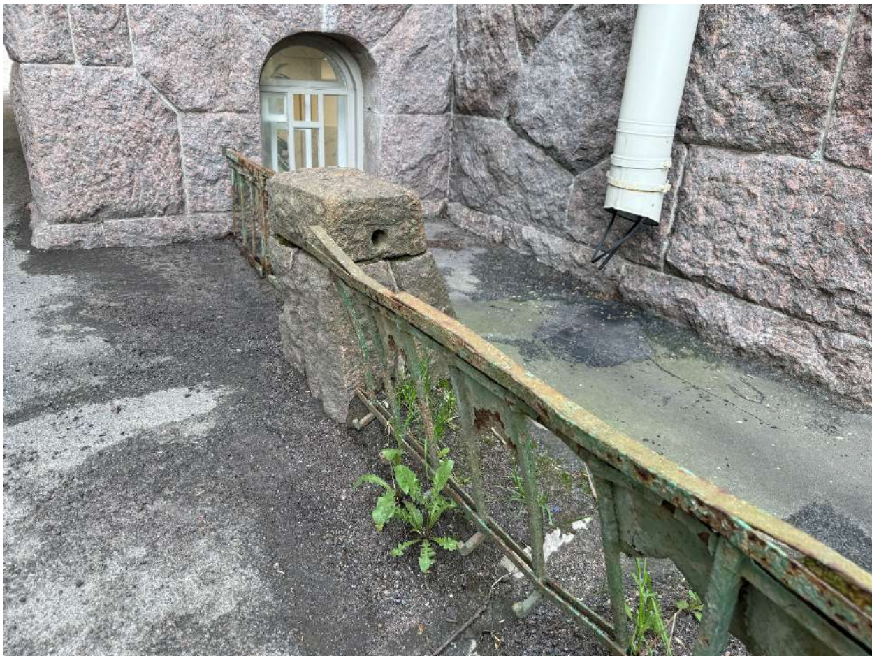
Фото 43. Общий вид на часть ограды. Дата фотофиксации - 19.05.2025г.
