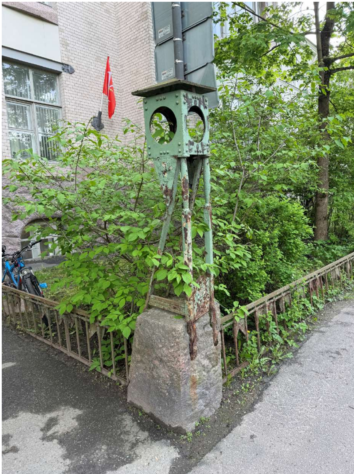
Фото 7. Общий вид на часть ограды. Дата фотофиксации - 19.05.2025г.
