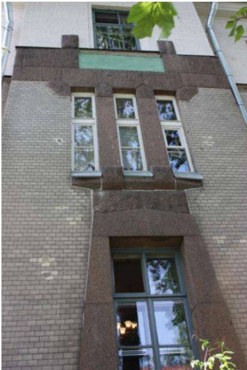
12. Фрагмент ризалита лицевого фасада. Фото 13.06.2009. https://www.citywalls.ru/
