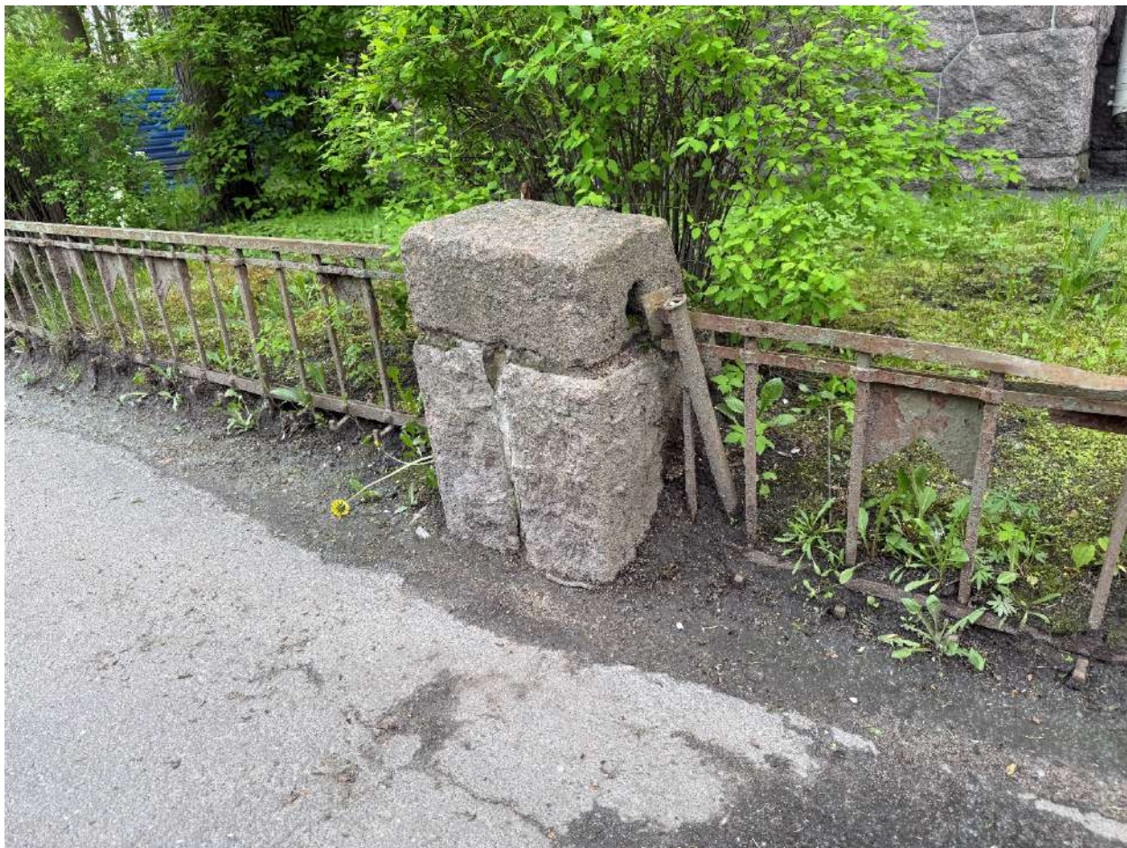
Фото 33. Общий вид на часть ограды. Дата фотофиксации - 19.05.2025г.
