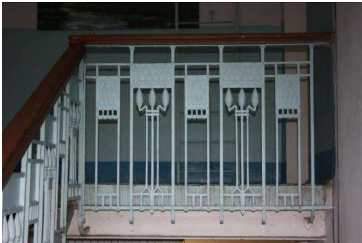
15. Фрагмент ограждения лестницы. Фото 13.06.2009. https://www.citywalls.ru/
