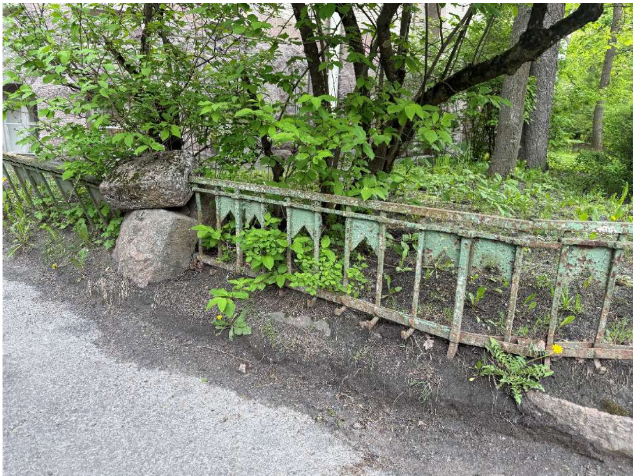
Фото 39. Общий вид на часть ограды. Дата фотофиксации - 19.05.2025г.
