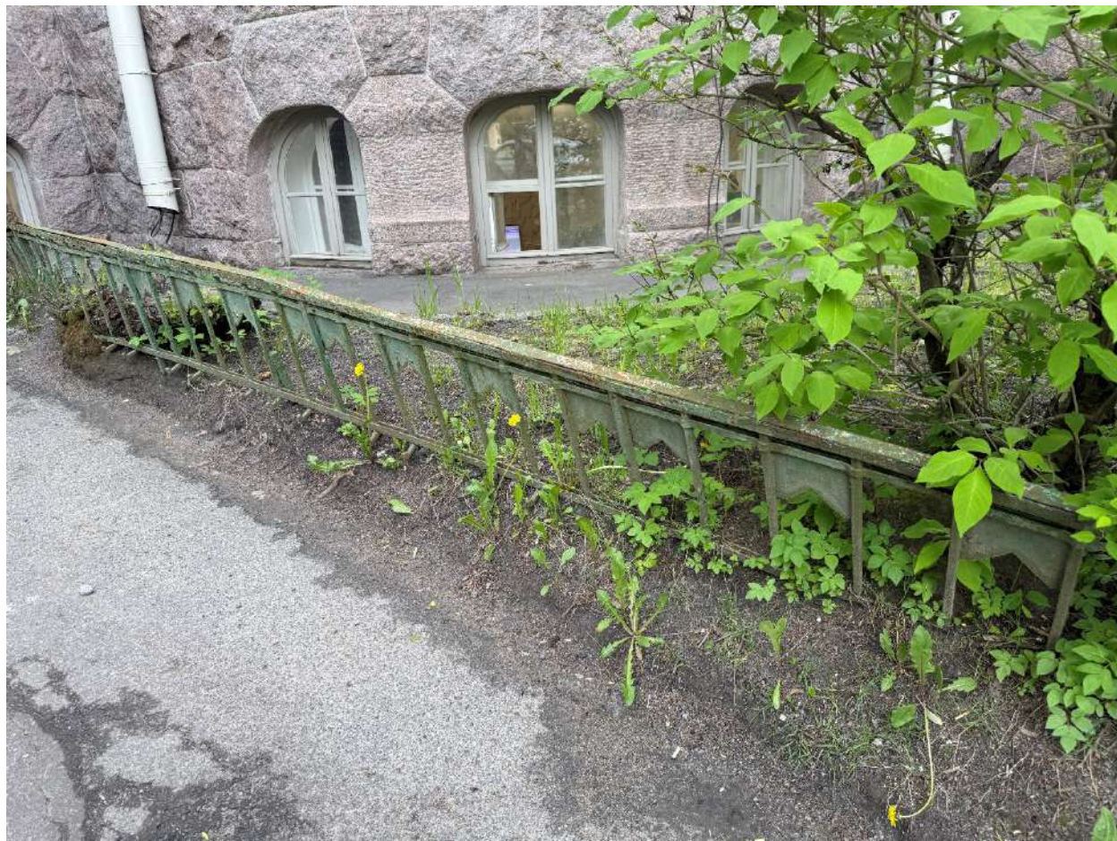
Фото 41. Общий вид на часть ограды. Дата фотофиксации - 19.05.2025г.
