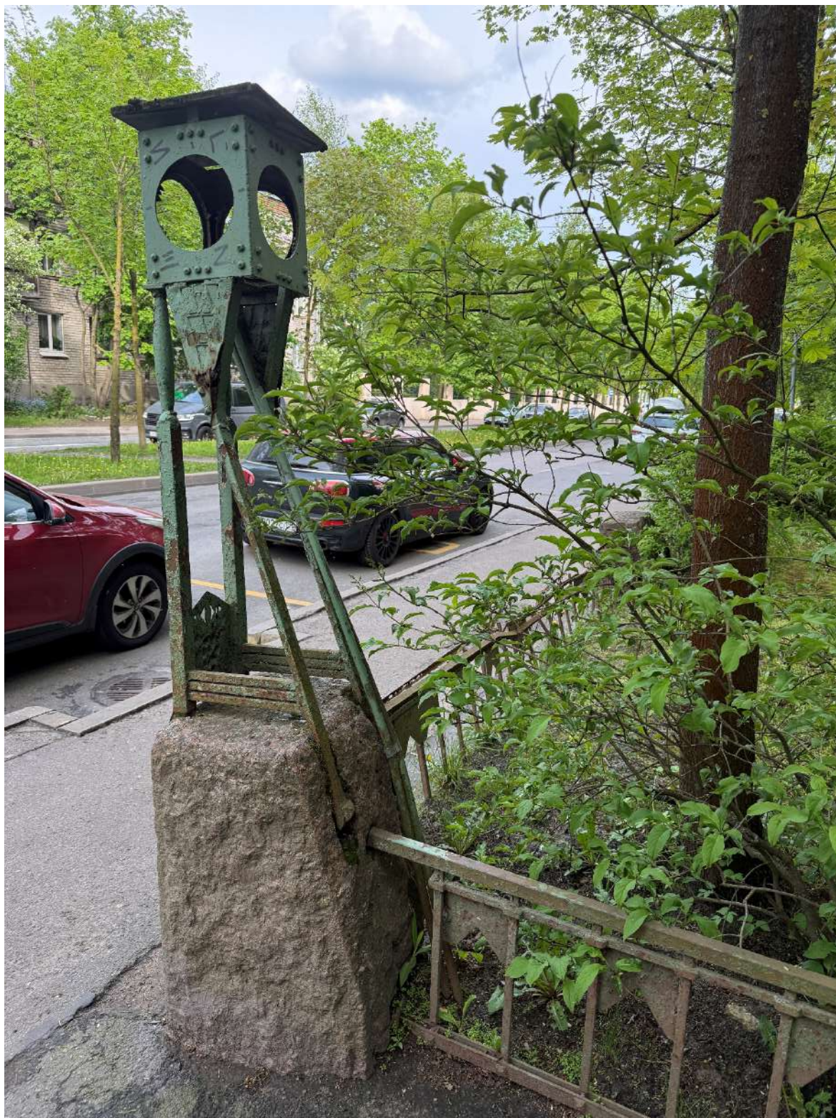
Фото 9. Общий вид на часть ограды. Дата фотофиксации - 19.05.2025г.
