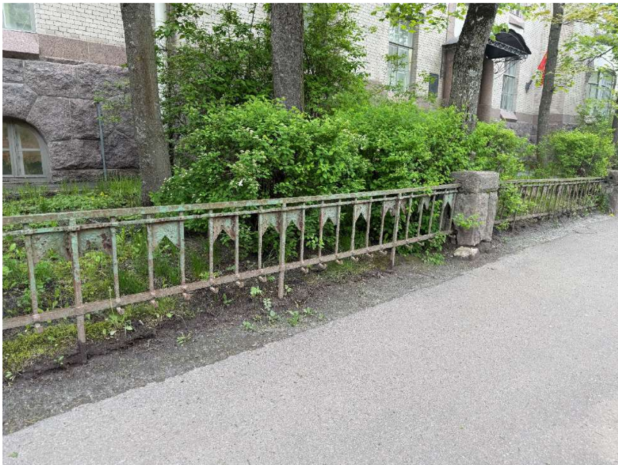
Фото 37. Общий вид на часть ограды. Дата фотофиксации - 19.05.2025г.
