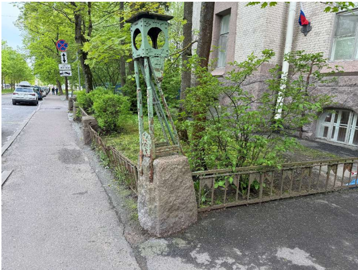
Фото 5. Общий вид на дворовой фасад объекта. Дата фотофиксации - 19.05.2025г.
