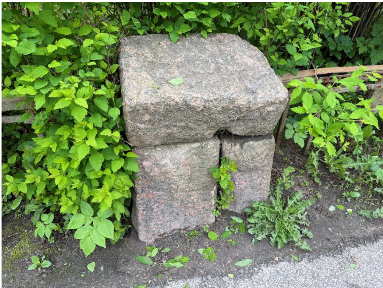
Фото 15. Общий вид на часть ограды. Дата фотофиксации - 19.05.2025г.
