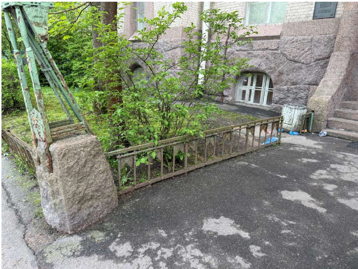
Фото 31. Общий вид на часть ограды. Дата фотофиксации - 19.05.2025г.
