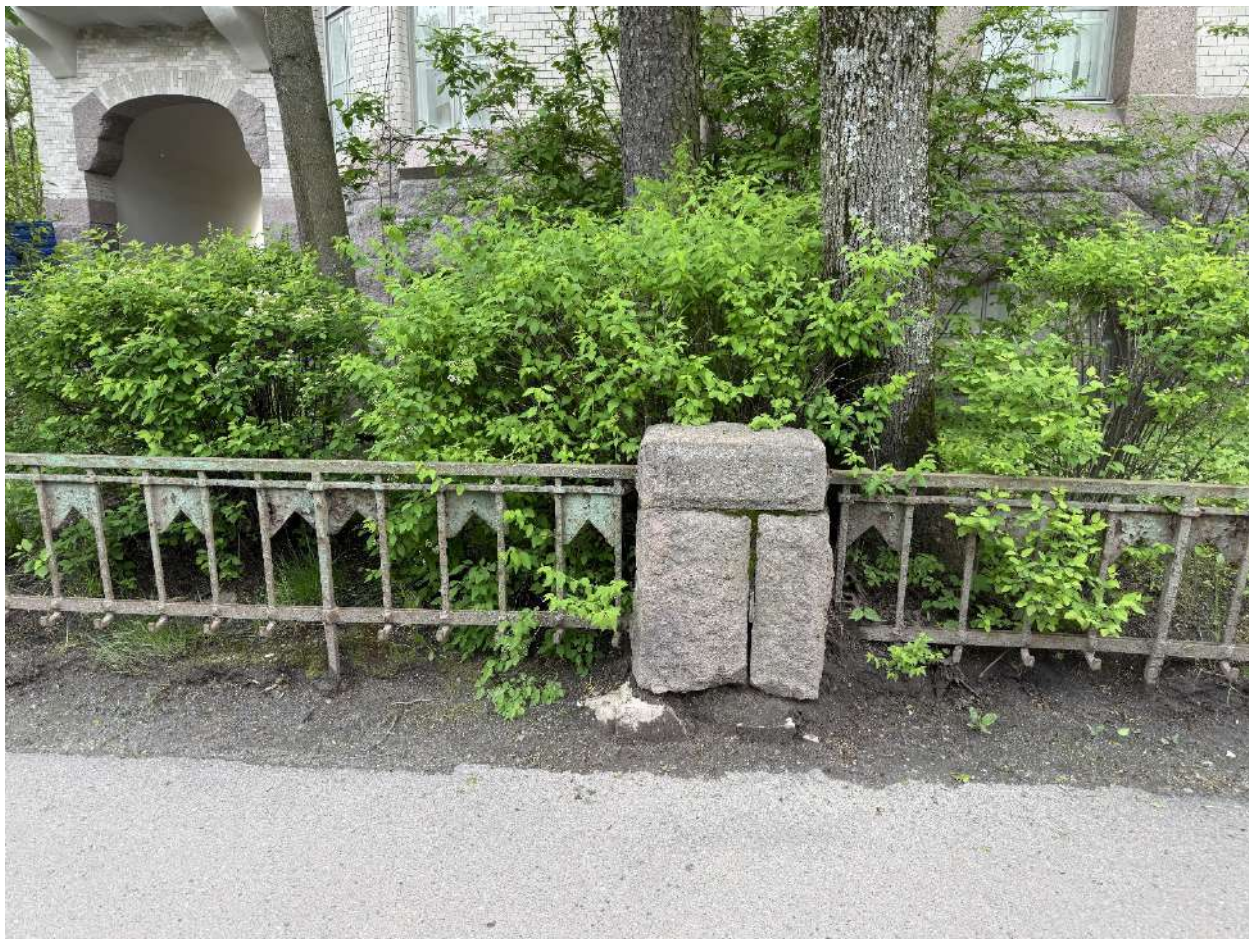
Фото 35. Общий вид на часть ограды. Дата фотофиксации - 19.05.2025г.
