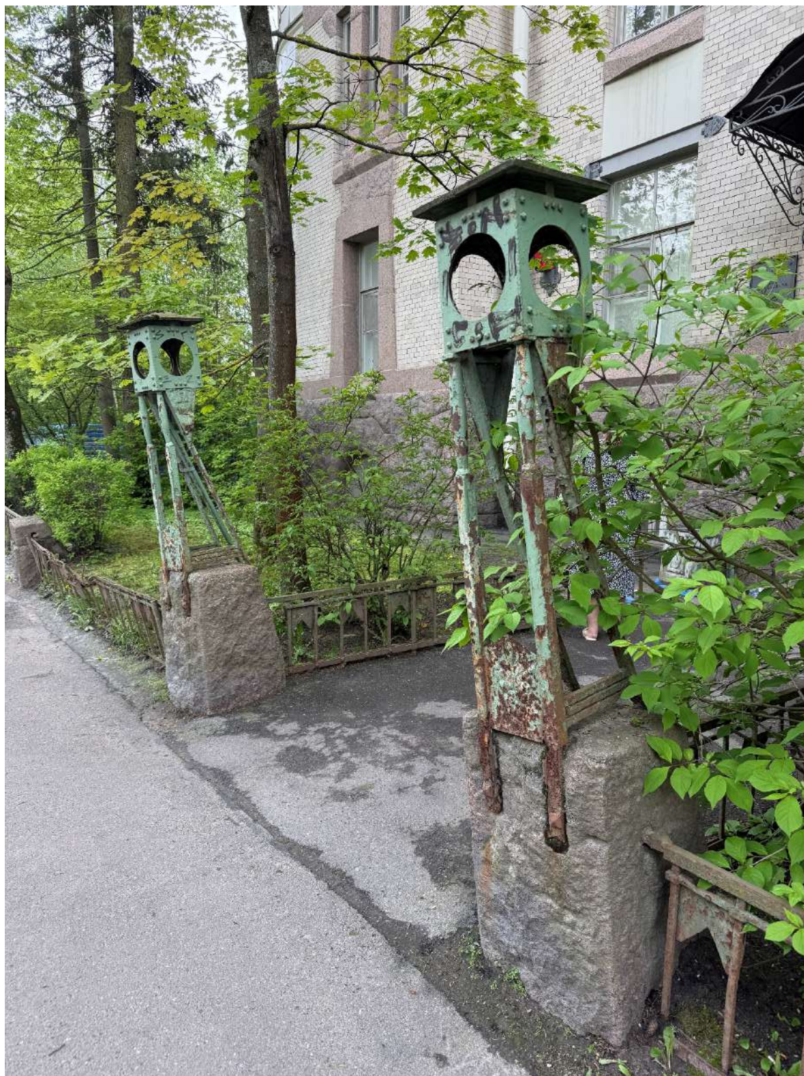
Фото 8. Общий вид на часть ограды. Дата фотофиксации - 19.05.2025г.
