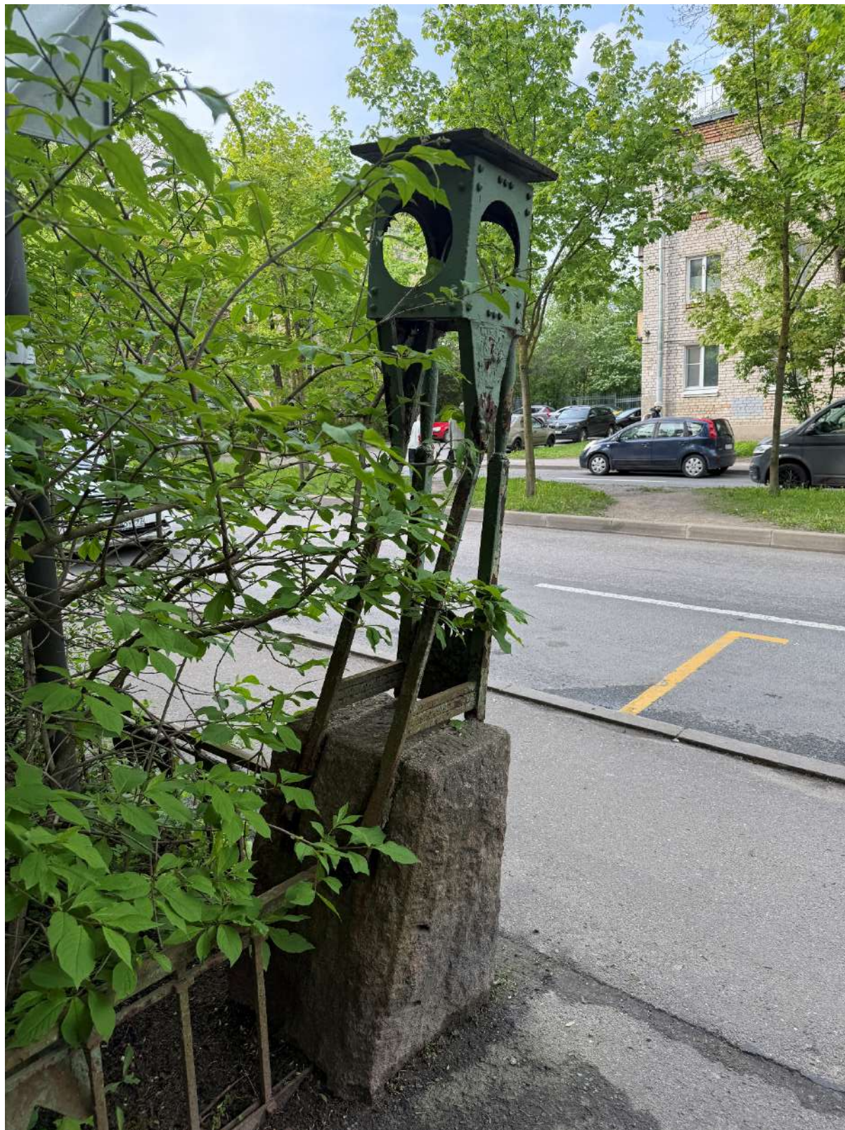
Фото 10. Общий вид на часть ограды. Дата фотофиксации - 19.05.2025г.
