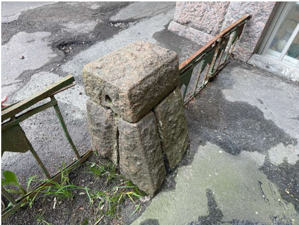
Фото 45. Общий вид на часть ограды. Дата фотофиксации - 19.05.2025г.
