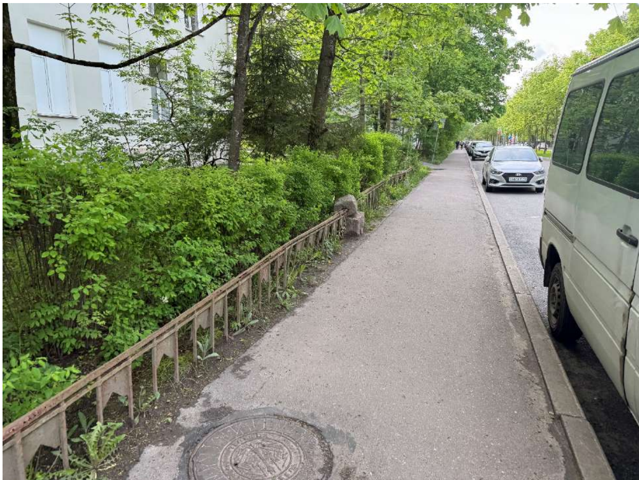
Фото 21. Общий вид на часть ограды. Дата фотофиксации - 19.05.2025г.
